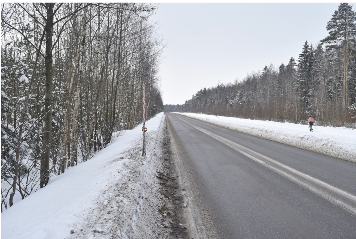
Рис. 58. Ленинградская обл., Сосновый Бор-2026. Точка фотофиксации-7. Вид с востока. Для масштаба использована рейка длиной 2 м.
