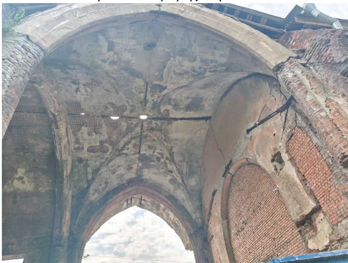
22. Фрагмент интерьера руинированной части
