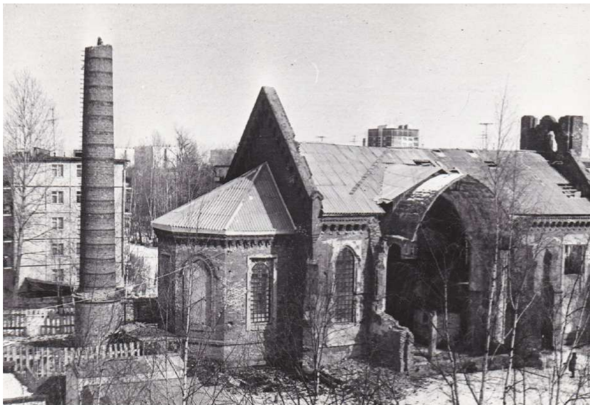
28. Разбор трубы у храма. 1997 г. [Электронный ресурс] URL: https://vk.com/photo-16277449_353264131
