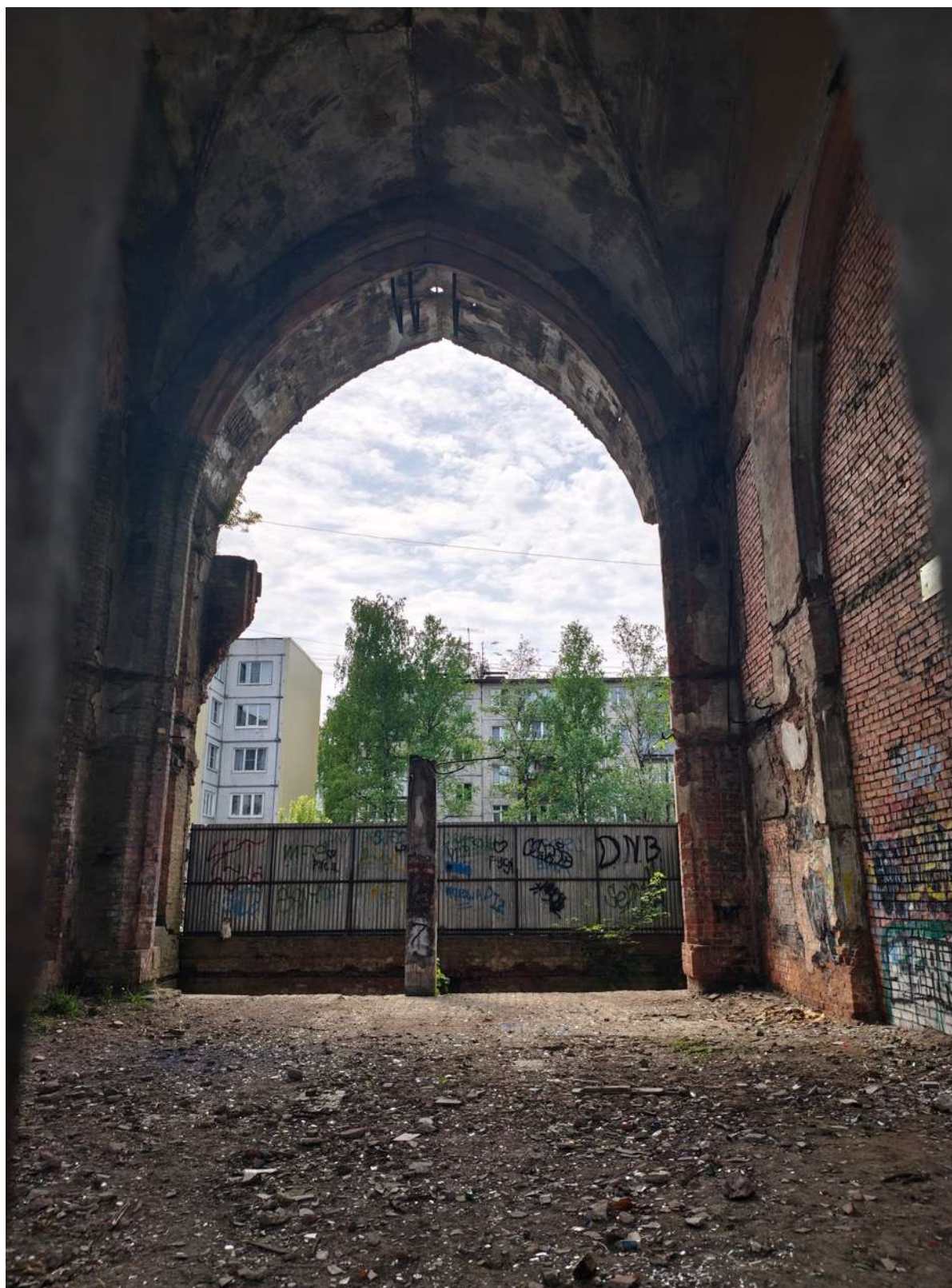
20. Фрагмент интерьера руинированной части
