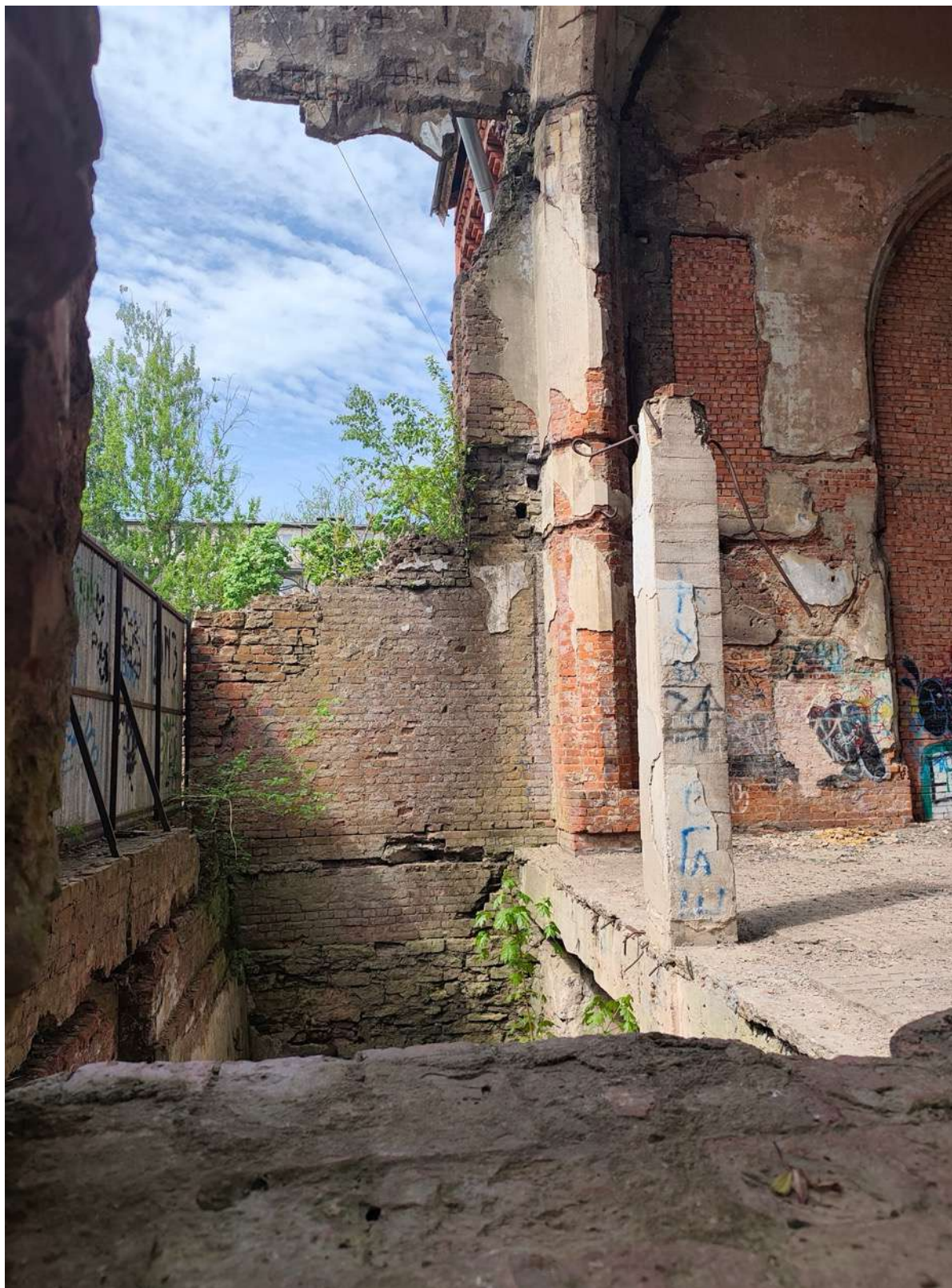
24. Фрагмент интерьера руинированной части
