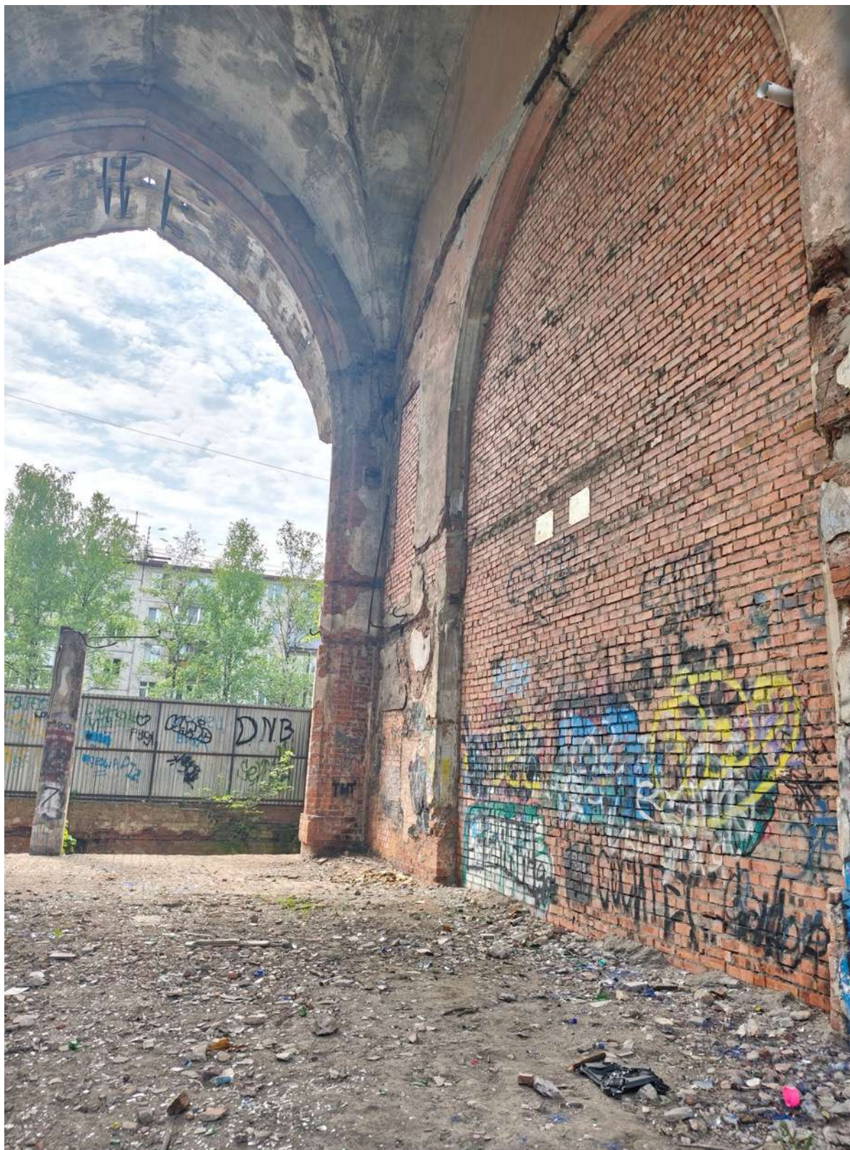
23. Фрагмент интерьера руинированной части
