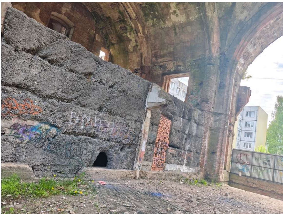
21. Фрагмент интерьера руинированной части
