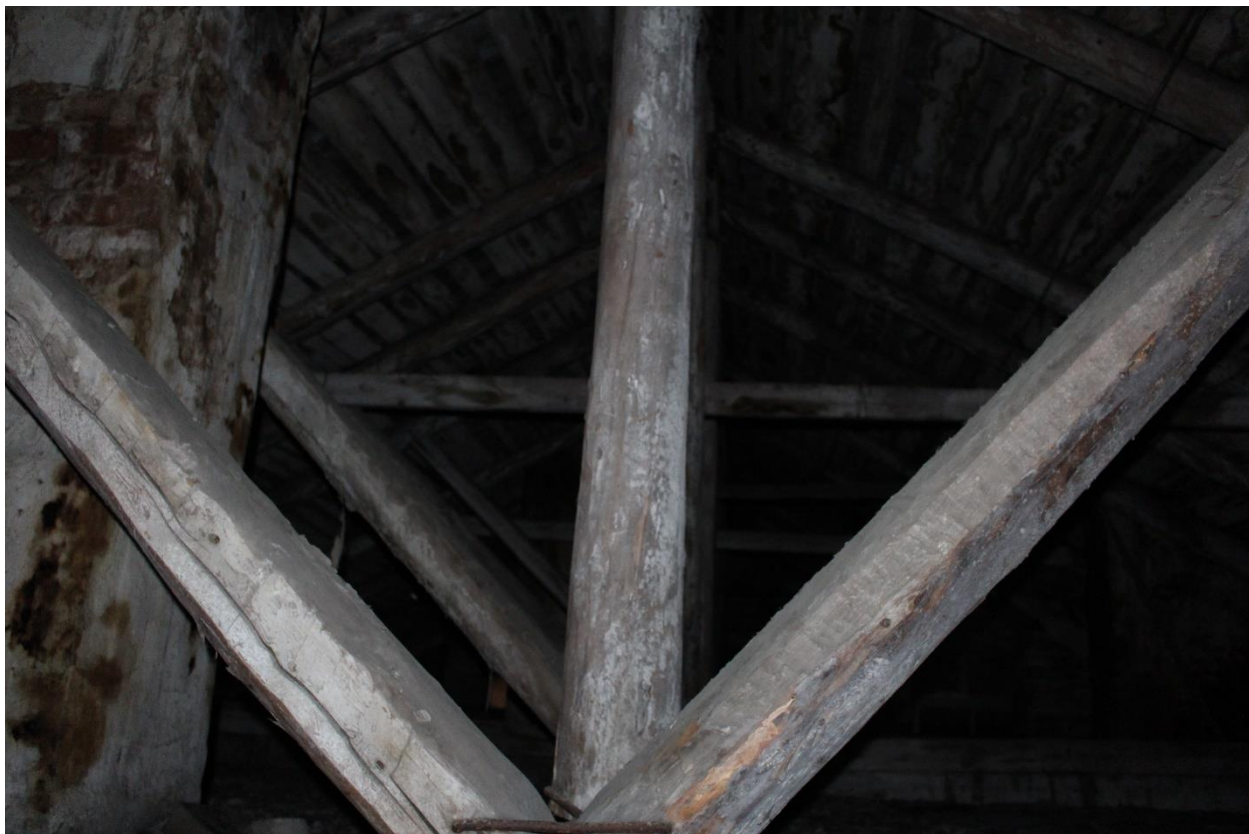
24. Вид на стропила чердака.
