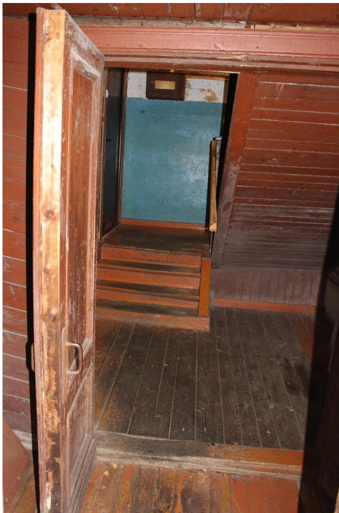
28. Тамбур северной лестницы.
