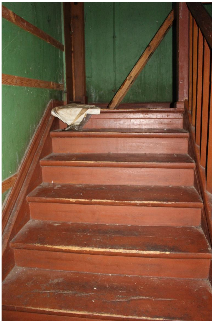
22. Марш лестницы на второй этаж.
