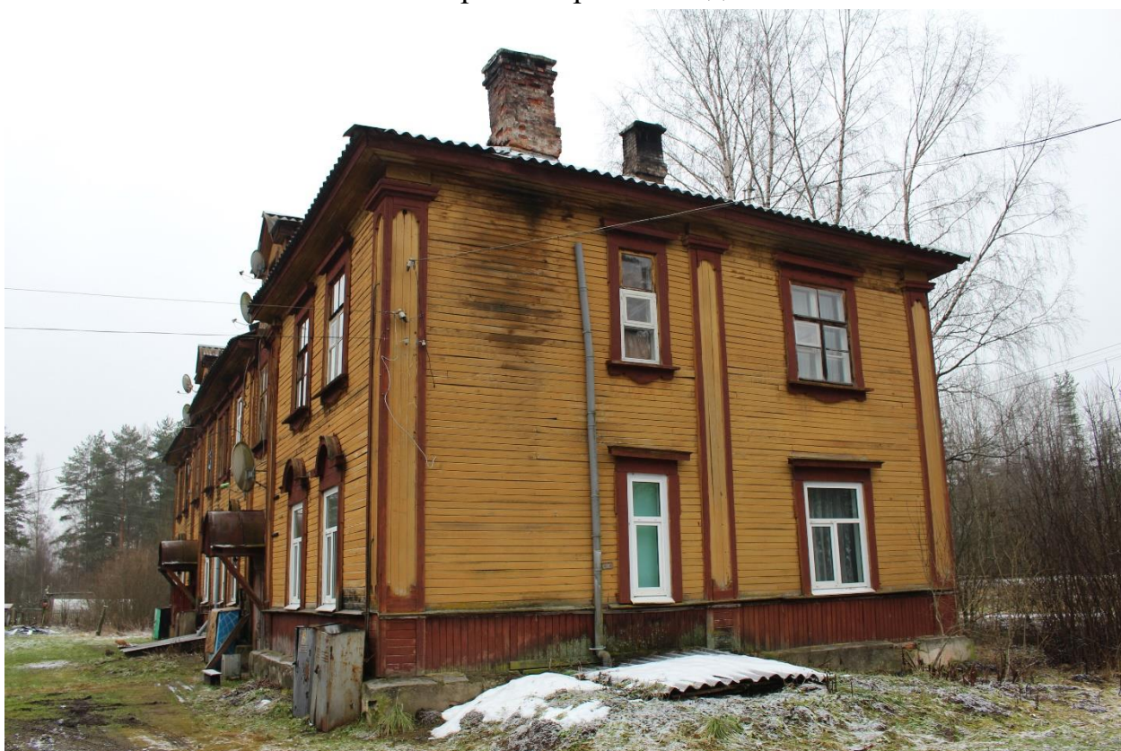
17. Общий вид объекта с востока.
