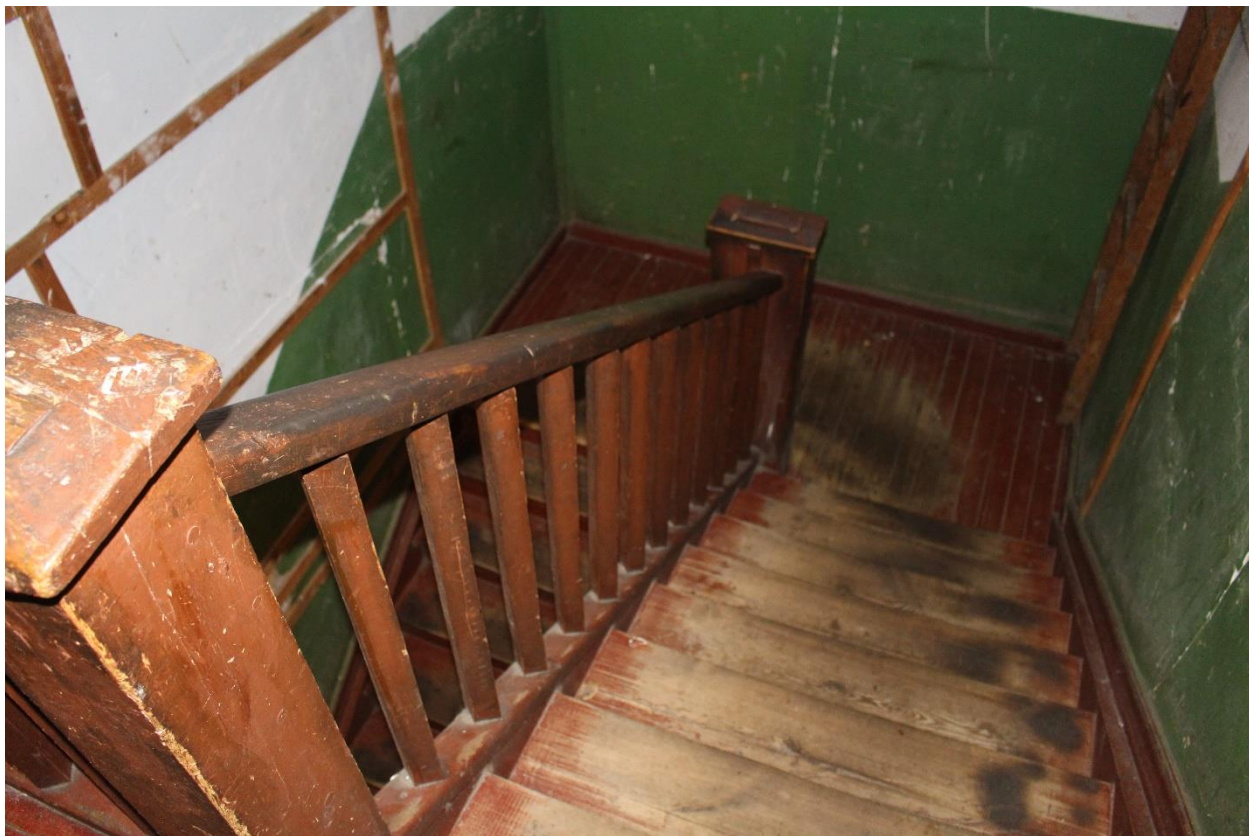
32. Лестница и ограждение.
