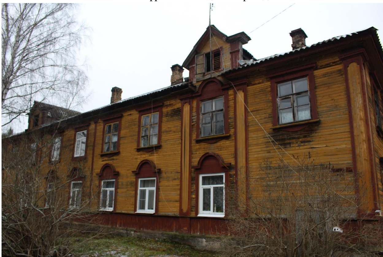
8. Общий вид объекта с запада.
