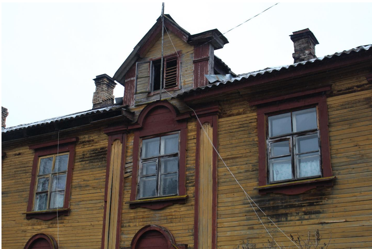
9. Фрагмент южной части лицевого фасада.
