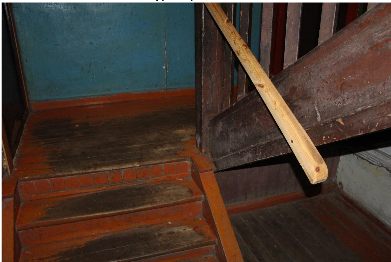
29. Лестница на 1 этаже.
