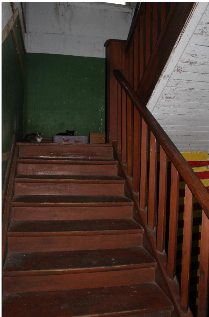
20. Марш лестницы на междуэтажную площадку.
