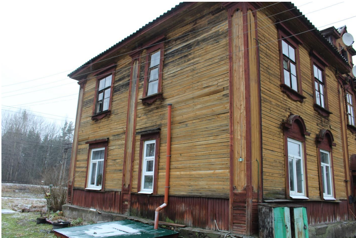
11. Общий вид объекта с юга.
