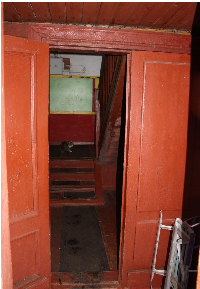
18. Тамбур южной лестницы.
