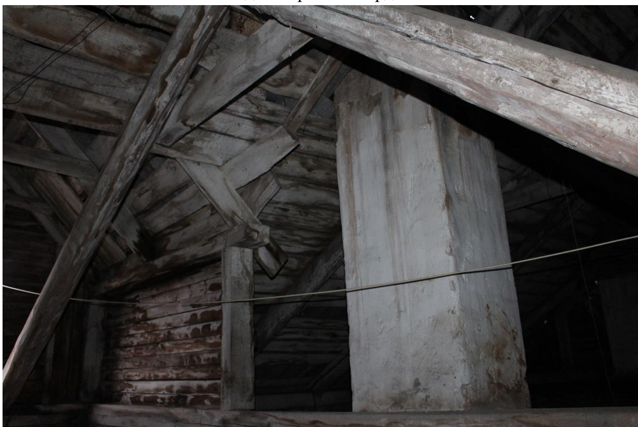
25. Вид на чердаке, дымовая труба.
