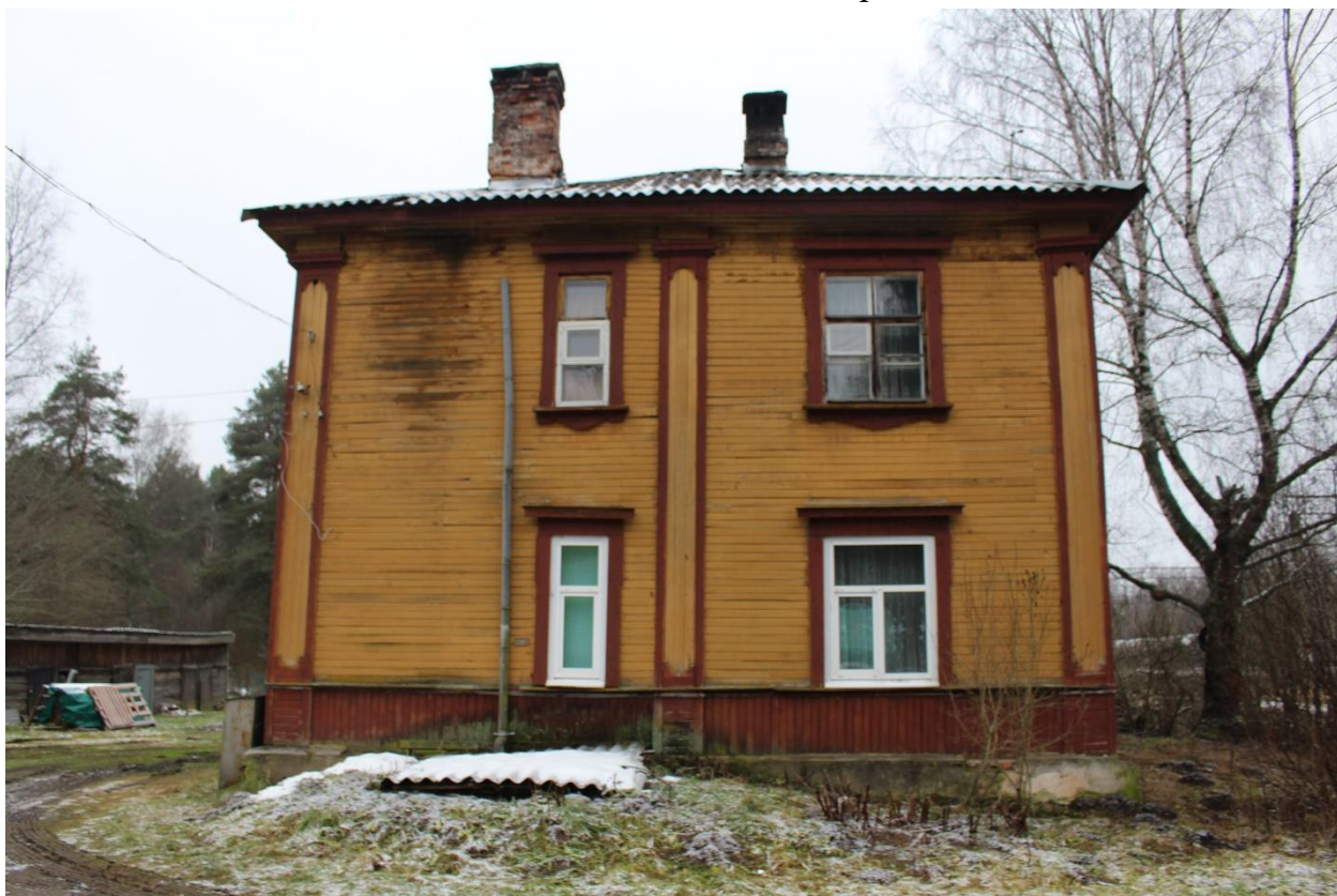
2. Северо-восточный торцевой фасад.
