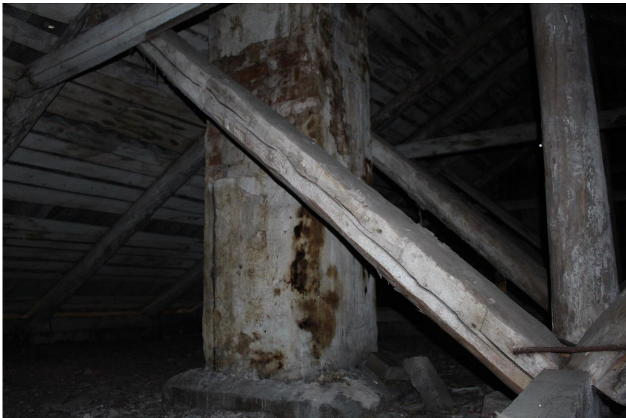
26. Фрагмент чердака, дымовая труба.
