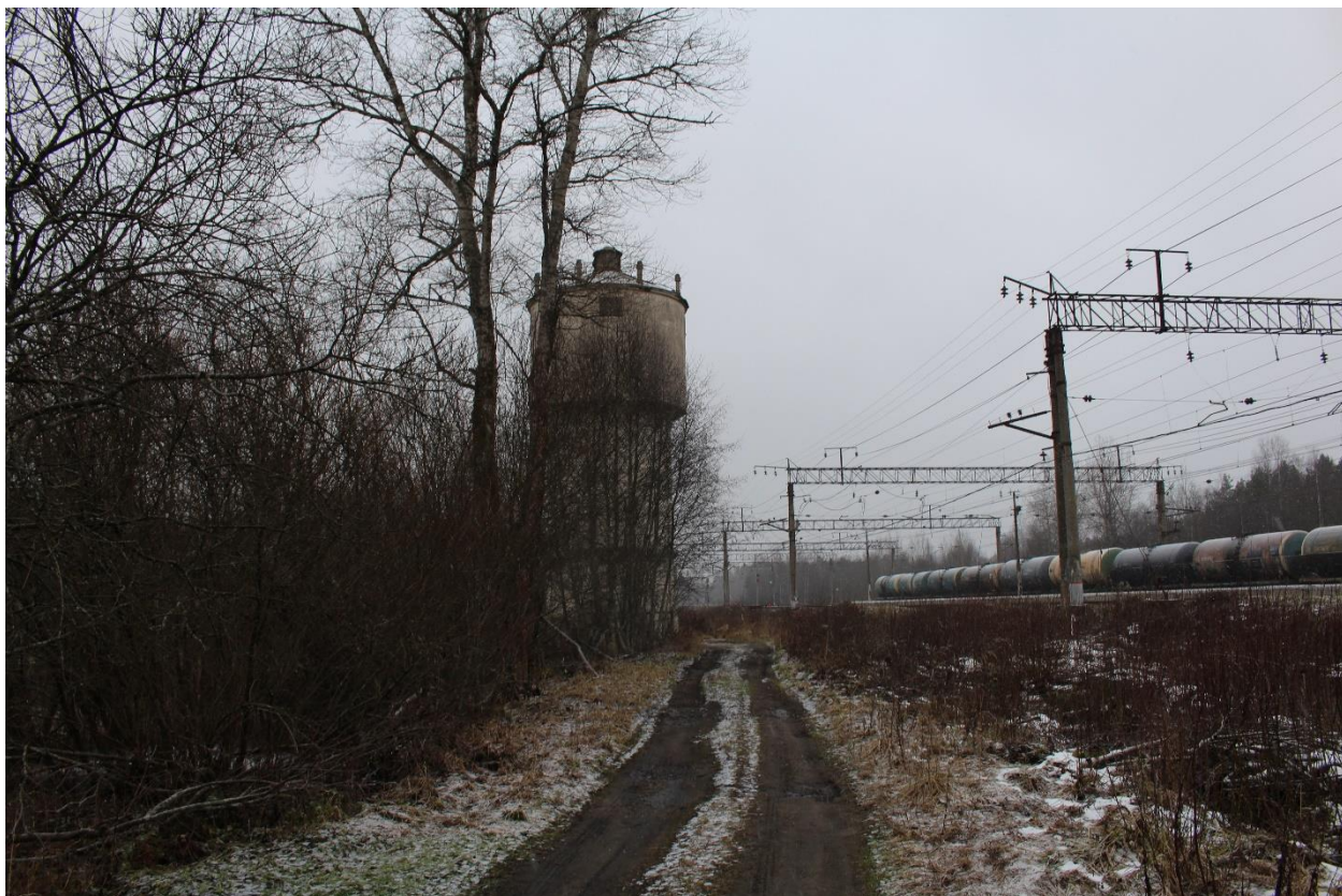
1. Общий вид объекта с северо-востока.
