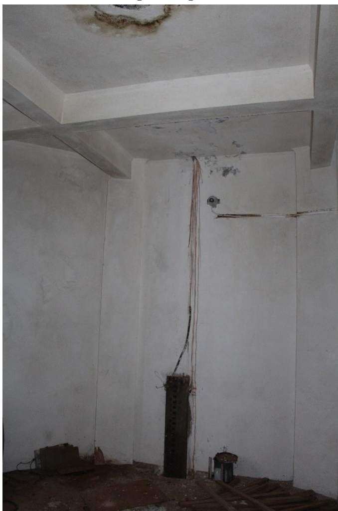
18. Второй ярус вид с лестницы.
