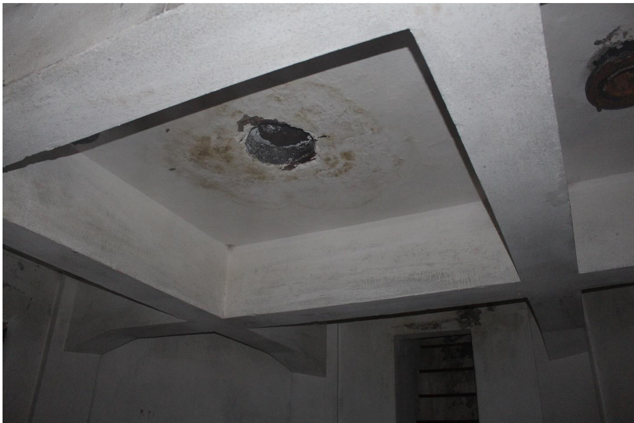
23. Перекрытие третьего яруса.
