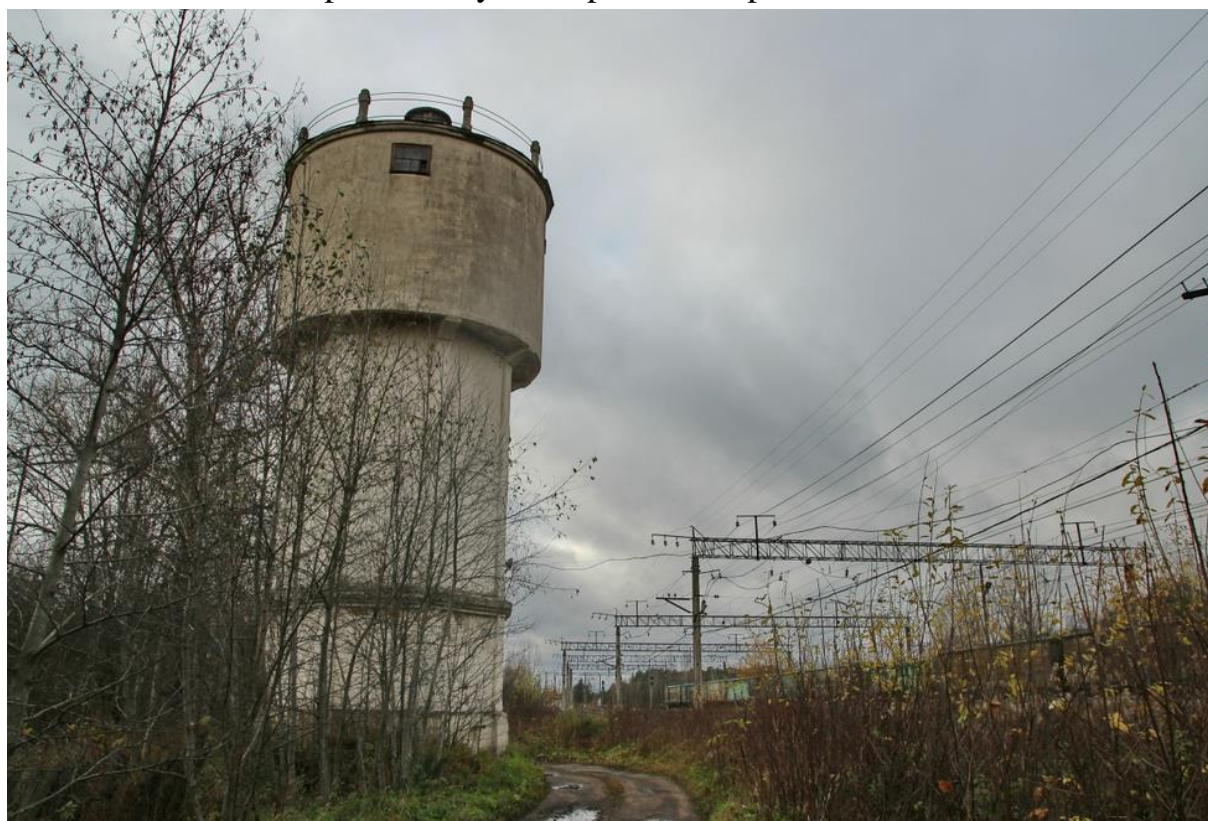
Илл. 60. Водонапорная башня на станции Паша. 19.10.2021 г. [Электронный ресурс] // URL: https://vk.com/photo-2701359_457268158 .
