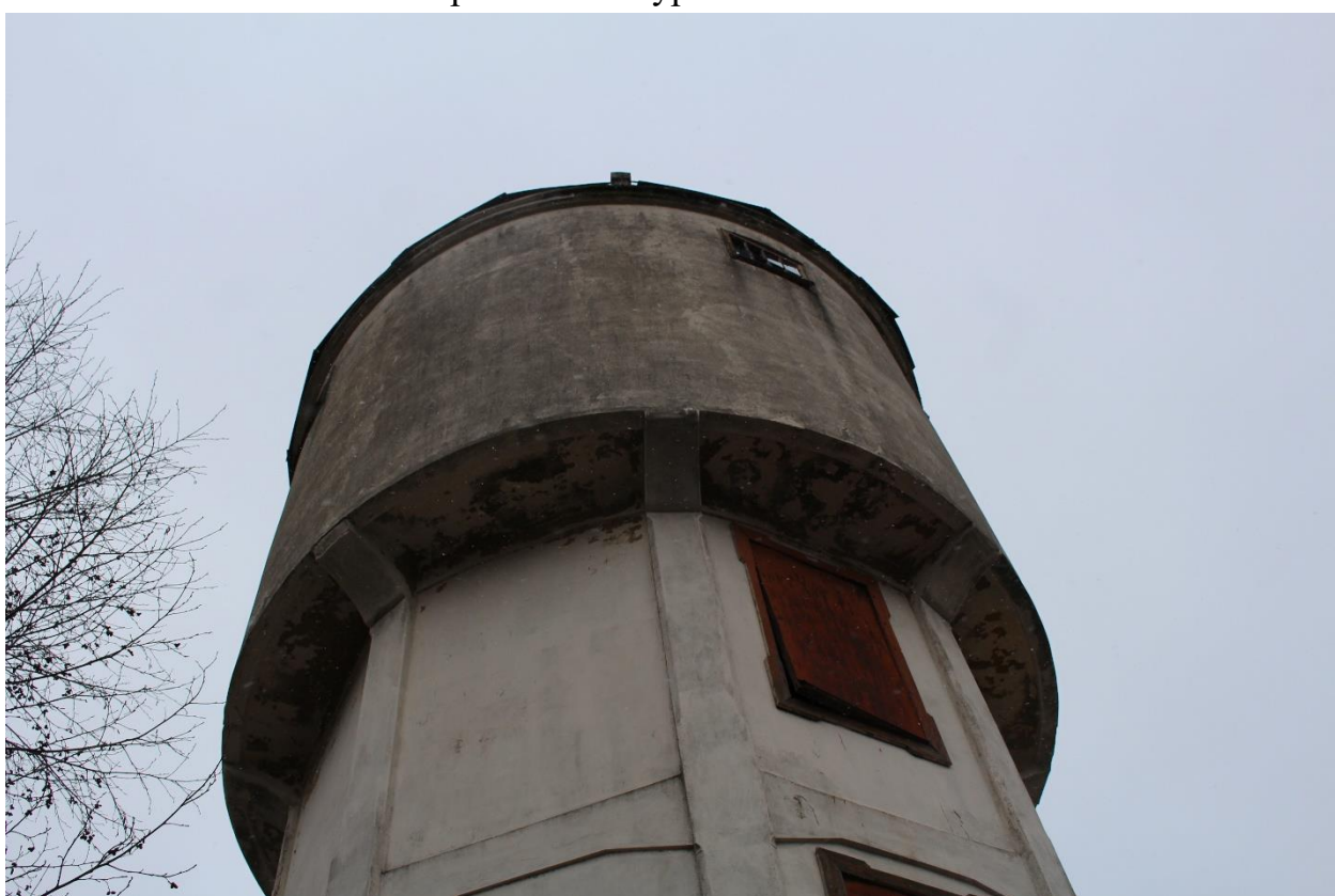
5. Виз накопительного бака
