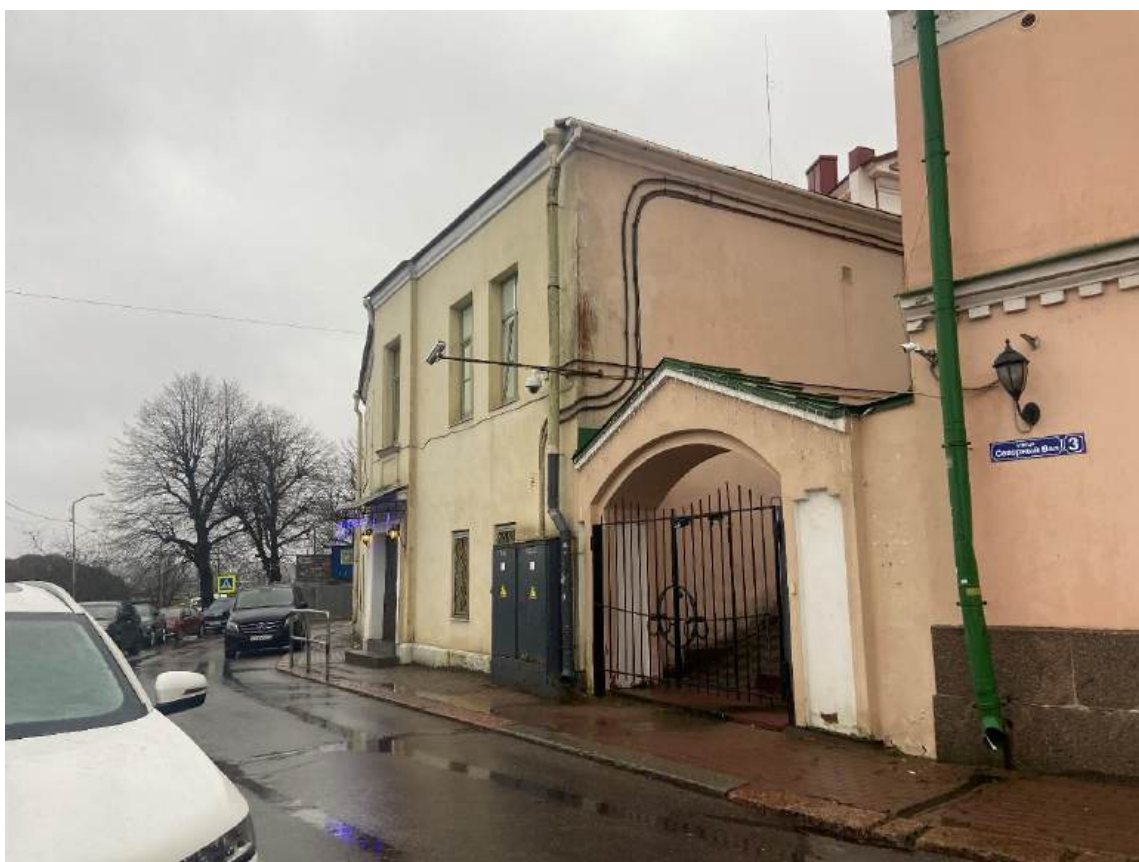
Фото 8. Вид на здание с востока.
