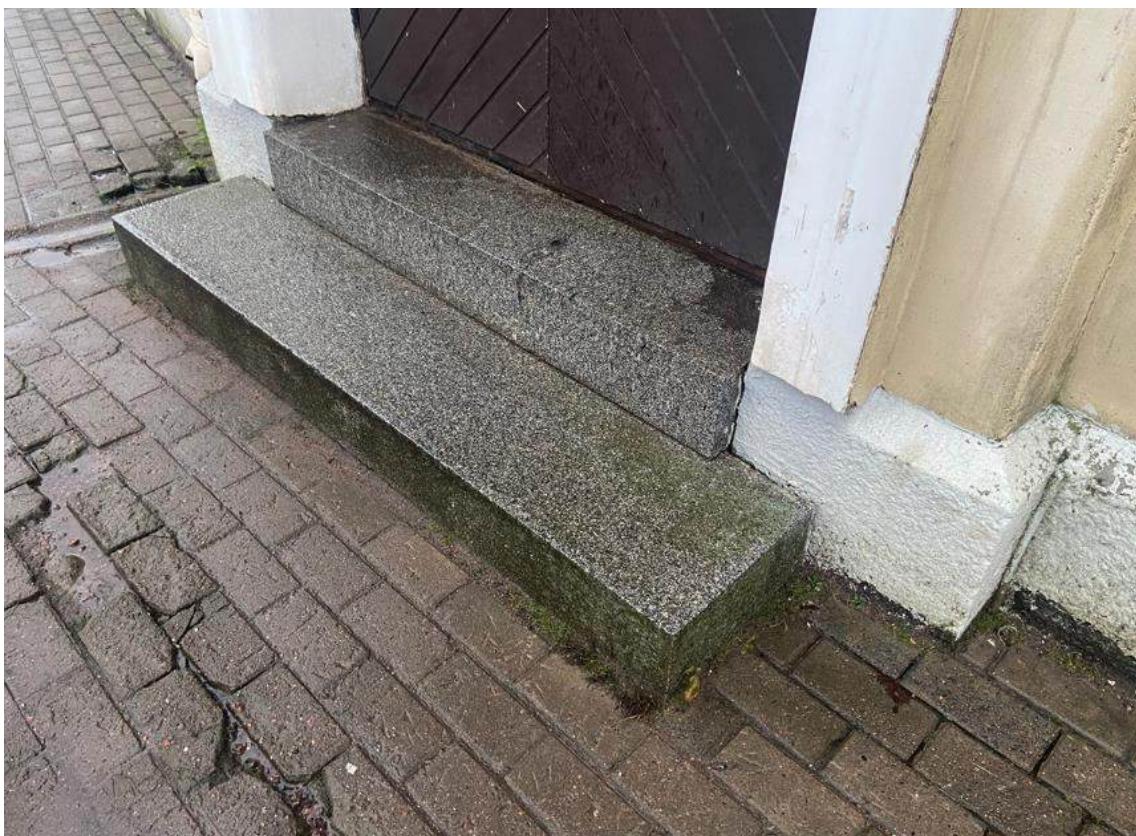
Фото 7. Вид на ступени при входе в здание.
