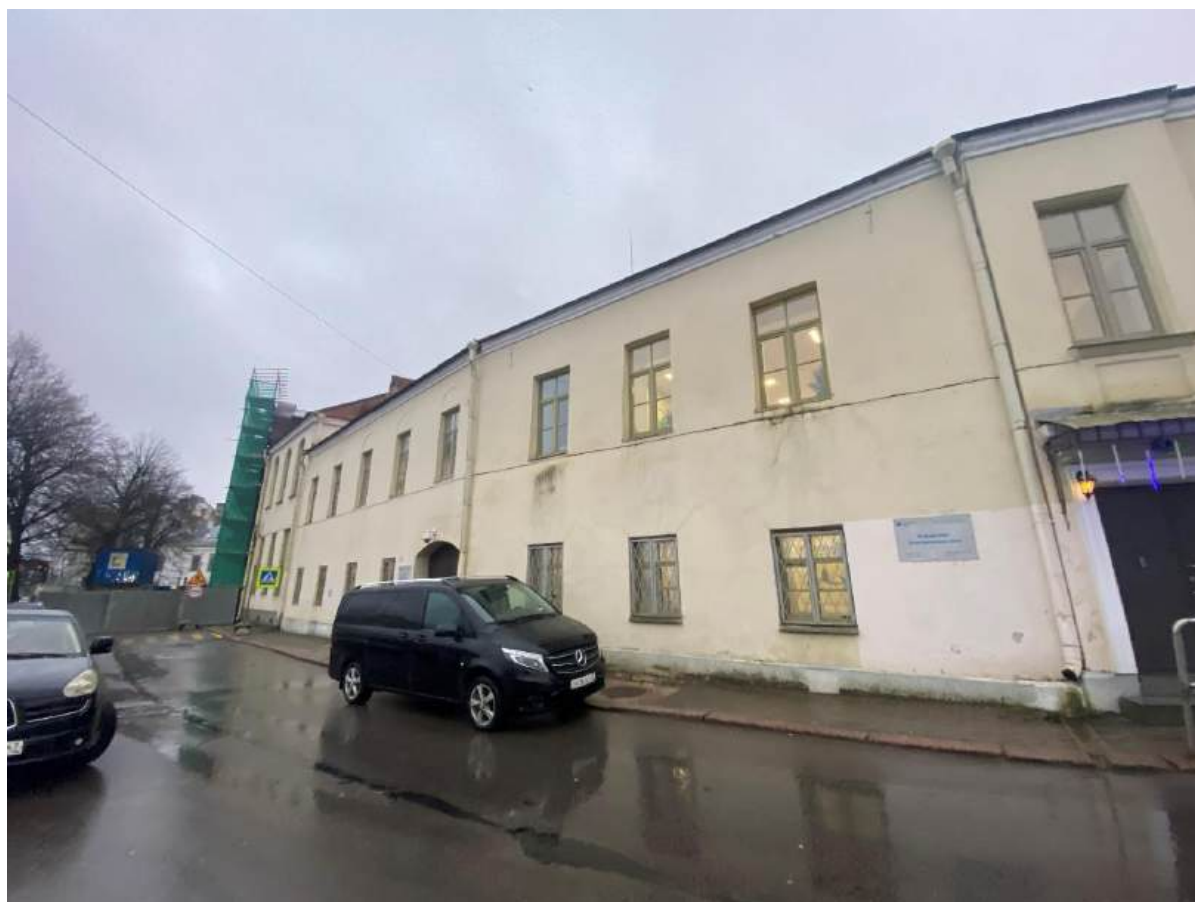
Фото 4. Вид на здание с запада.
