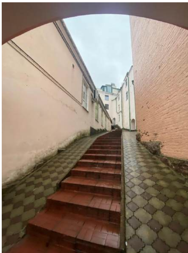
Фото 9. Вид на западный фасад западного корпуса.
