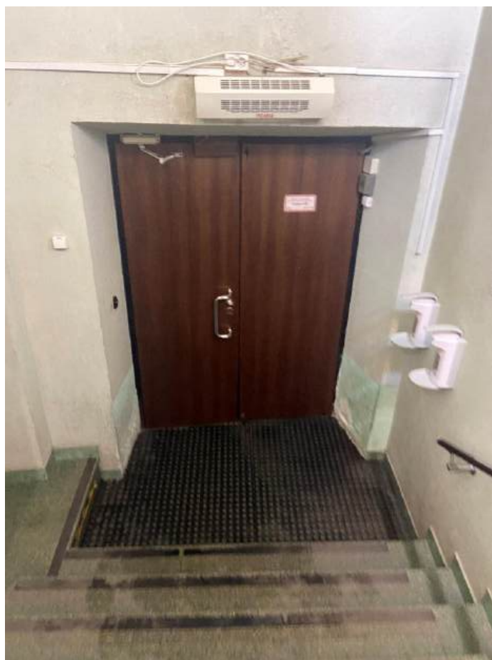
Фото 10. Вид на выход из здания.
