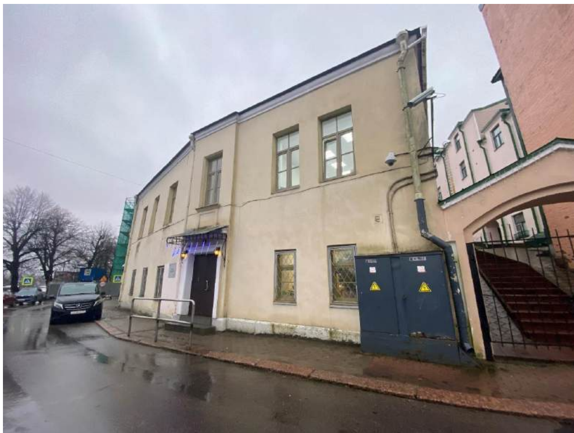
Фото 6. Вид на западный корпус.
