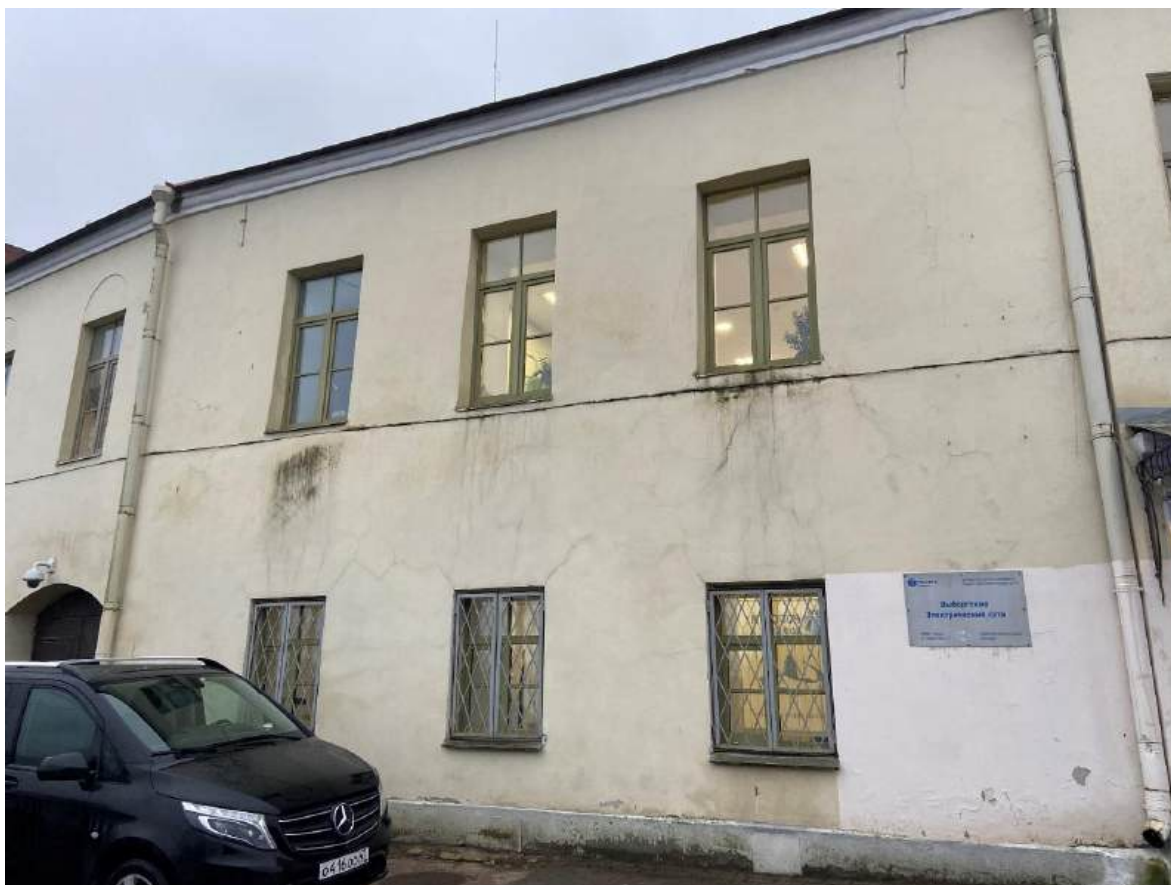
Фото 3. Вид на часть лицевого западного фасада.
