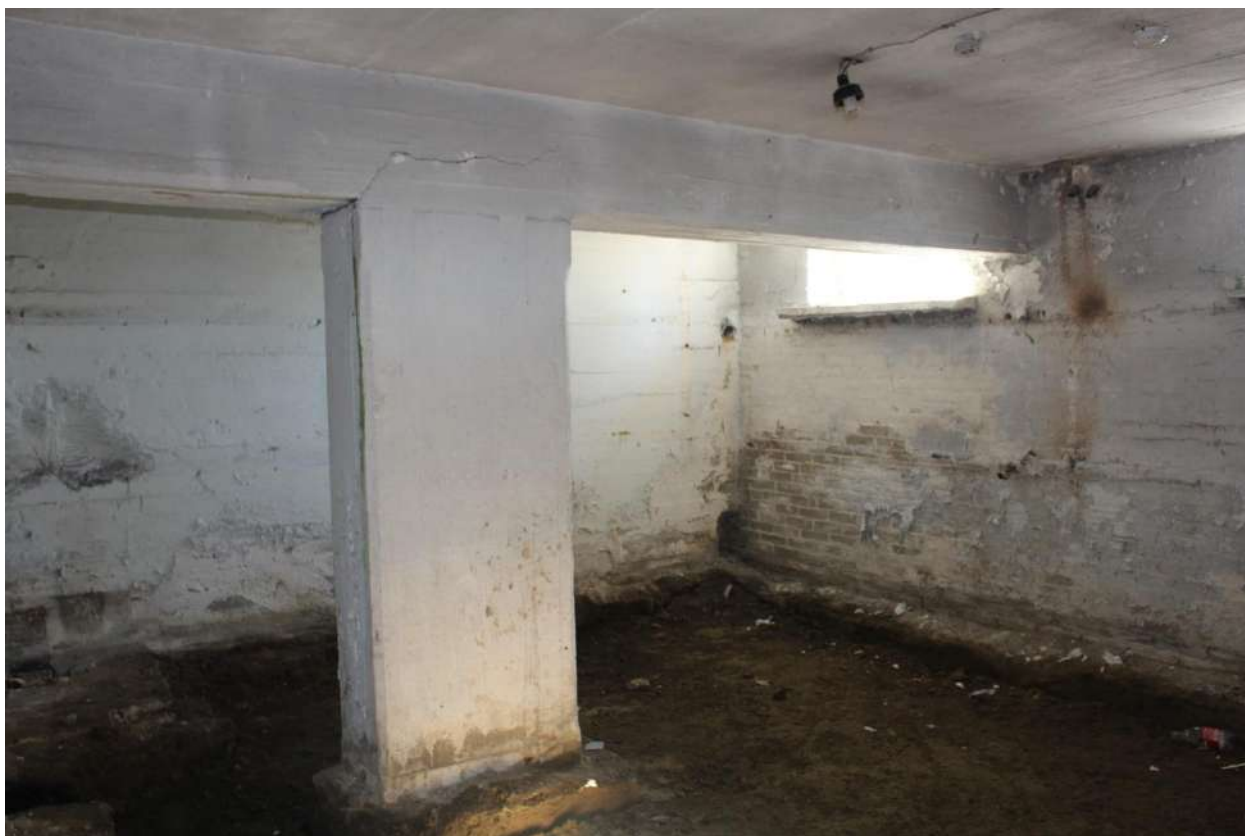
Фото 141. Выявленный объект культурного наследия «Здание школы». Внутренние помещения цокольного этажа.
