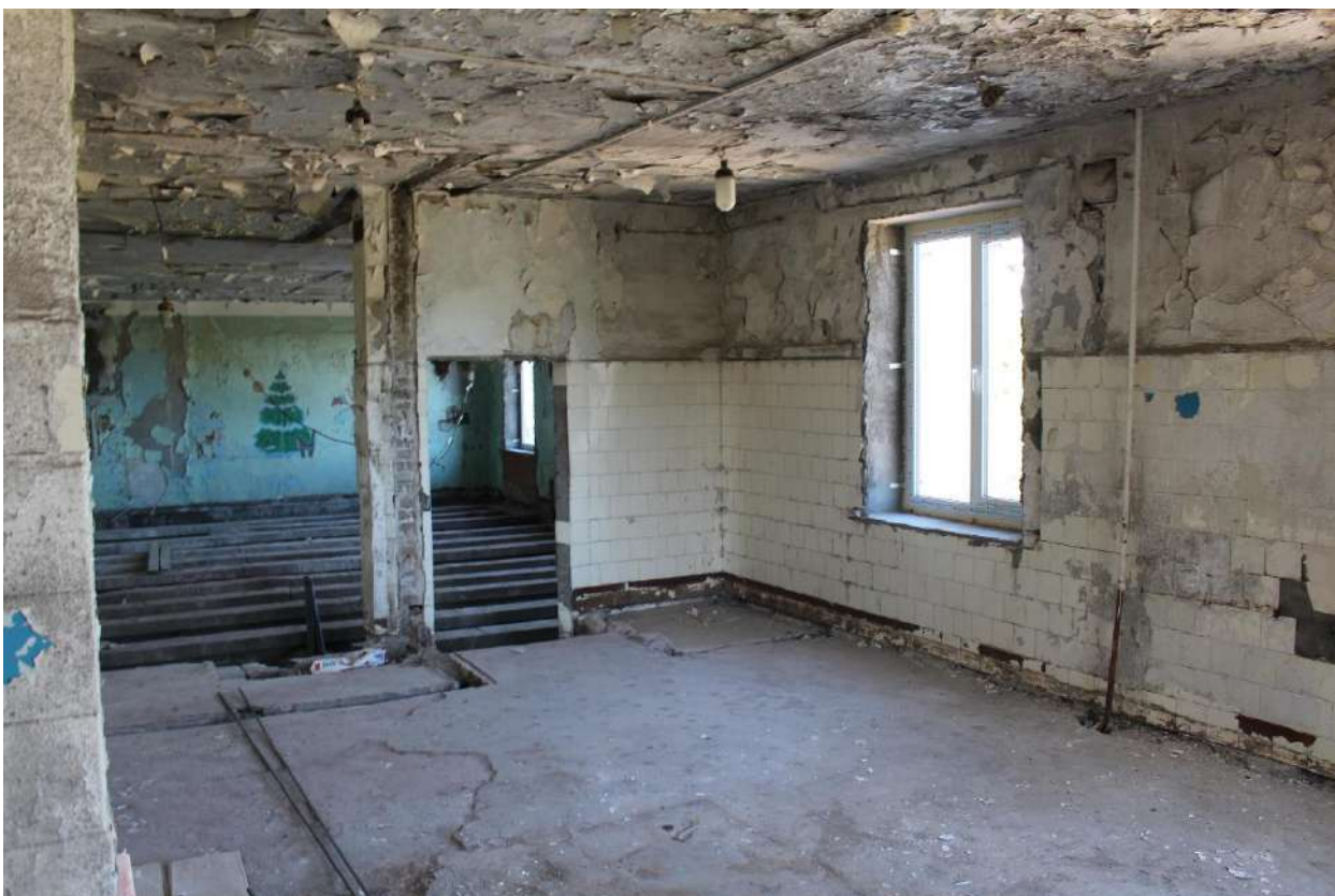
Фото 116. Выявленный объект культурного наследия «Здание школы». Внутренние помещения 1-го этажа.
