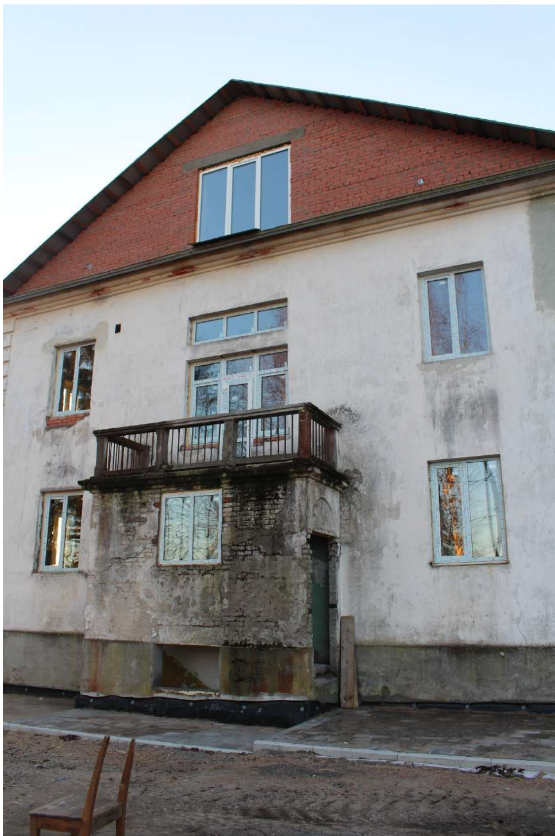
Фото 8. Вид на северный фасад выявленного объекта культурного наследия «Здание школы».
