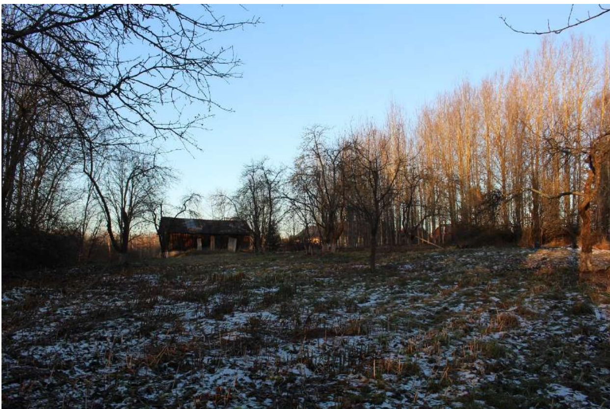
Фото 54. Вид на центральную часть выявленного объекта культурного наследия «Пришкольный участок (4 га)».
