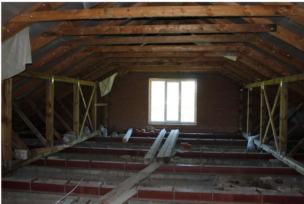
Фото 207. Выявленный объект культурного наследия «Здание школы». Внутренние помещения мансардного этажа.
