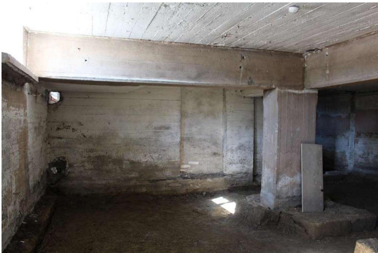
Фото 149. Выявленный объект культурного наследия «Здание школы». Внутренние помещения цокольного этажа.
