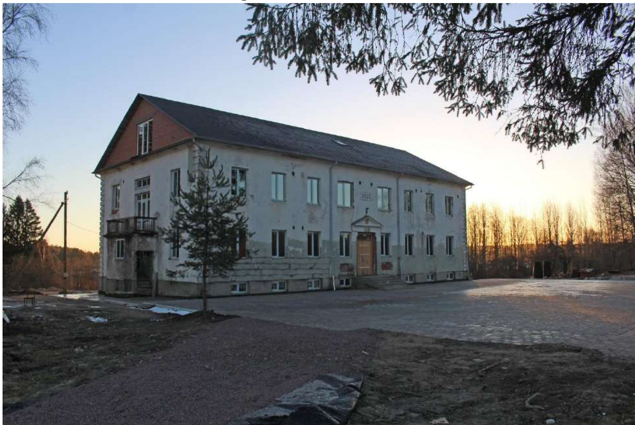
Фото 1. Общий вид выявленного объекта культурного наследия «Здание школы».
