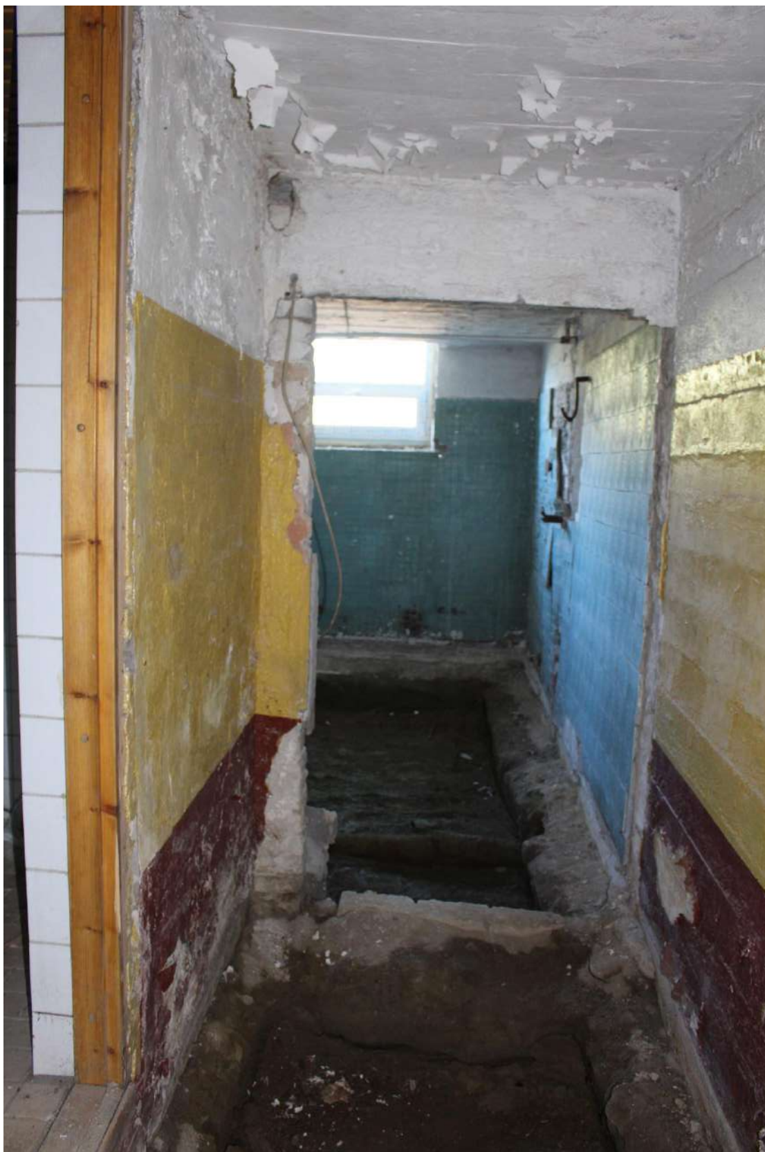
Фото 152. Выявленный объект культурного наследия «Здание школы». Внутренние помещения цокольного этажа.
