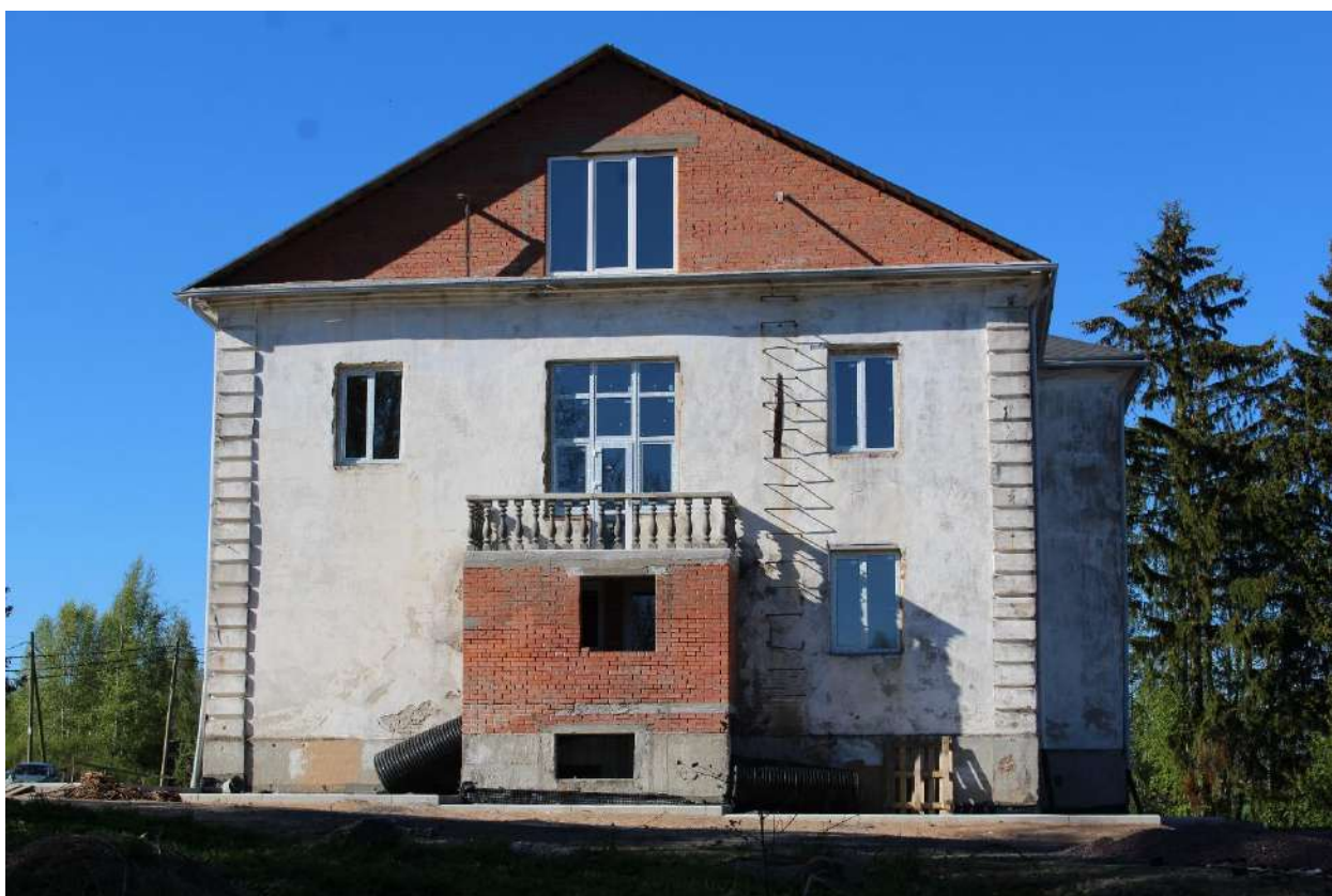
Фото 103. Вид на южный фасад выявленного объекта культурного наследия «Здание школы».
