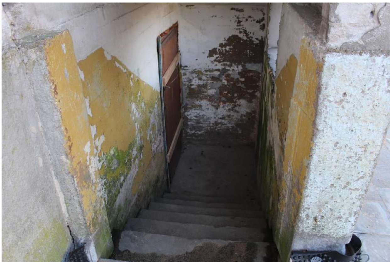
Фото 10. Вид на тамбур северного фасада выявленного объекта культурного наследия «Здание школы».
