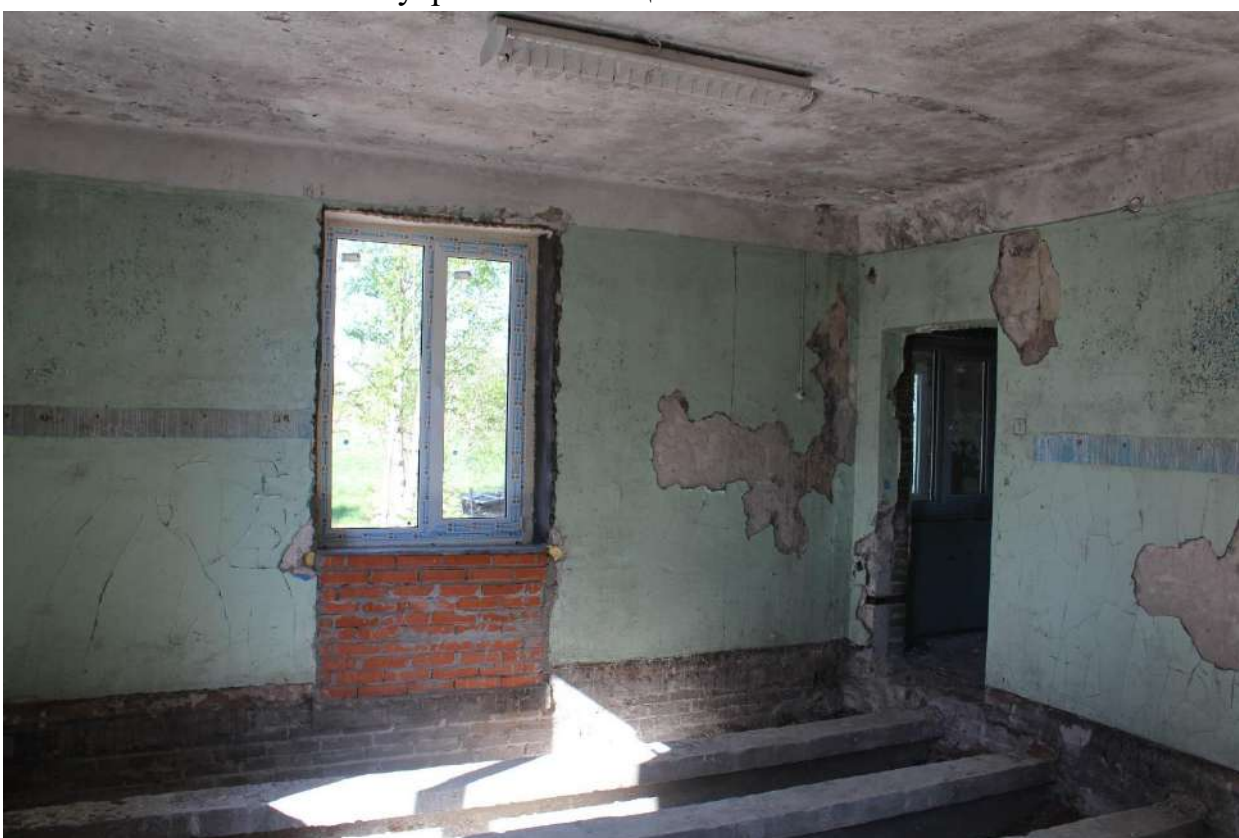
Фото 127. Выявленный объект культурного наследия «Здание школы». Внутренние помещения 1-го этажа.
