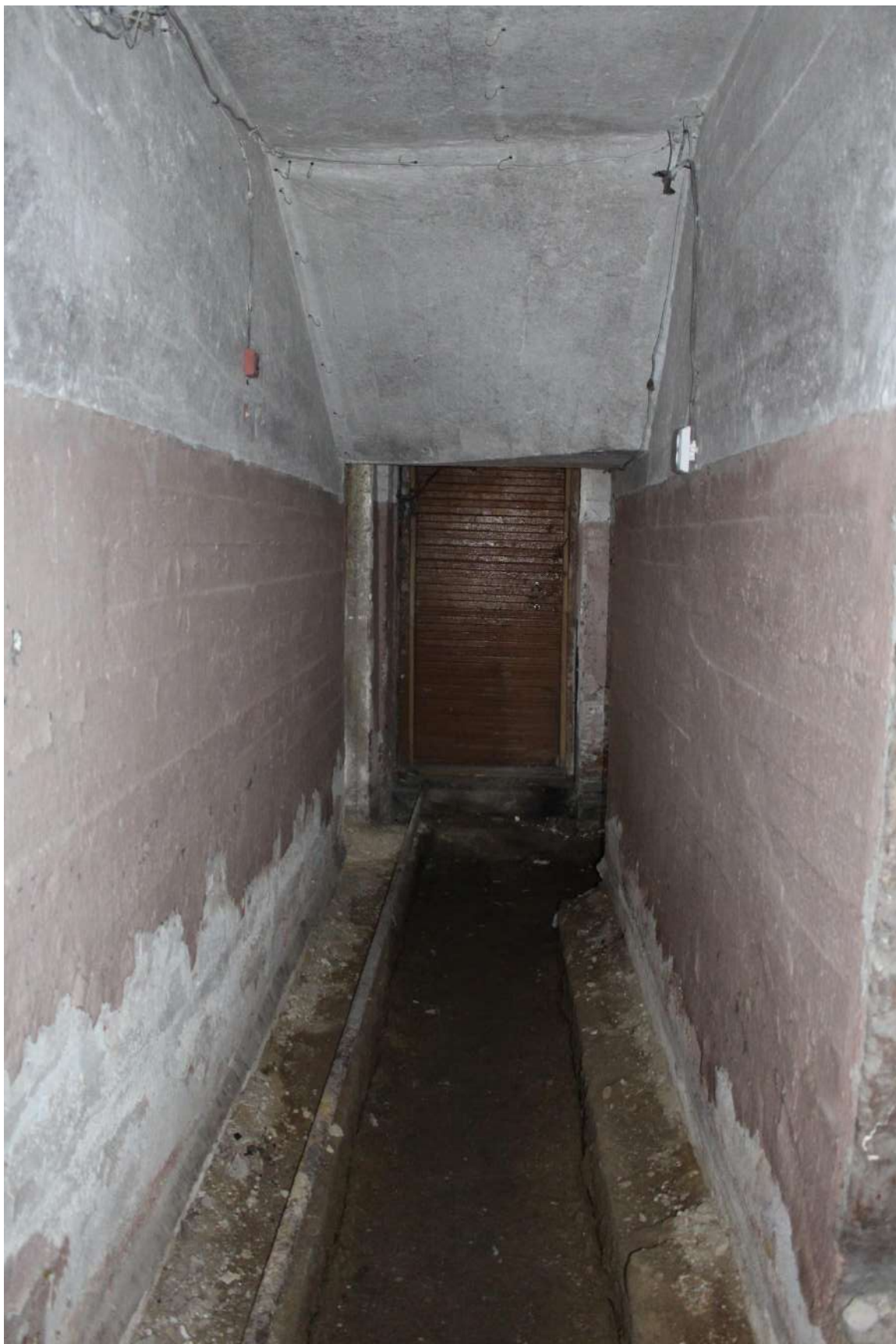
Фото 139. Выявленный объект культурного наследия «Здание школы». Внутренние помещения цокольного этажа.
