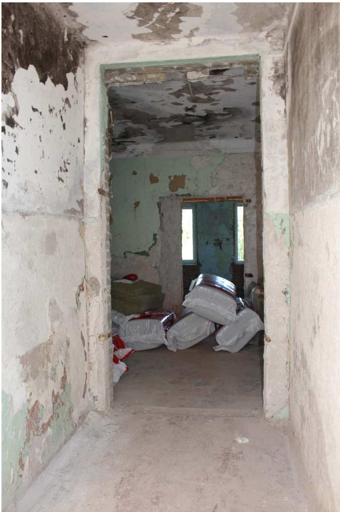
Фото 104. Выявленный объект культурного наследия «Здание школы». Внутренние помещения 1-го этажа.
