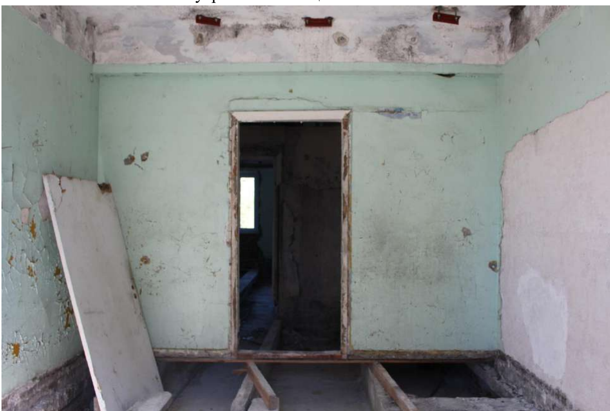
Фото 182. Выявленный объект культурного наследия «Здание школы». Внутренние помещения 2-го этажа.
