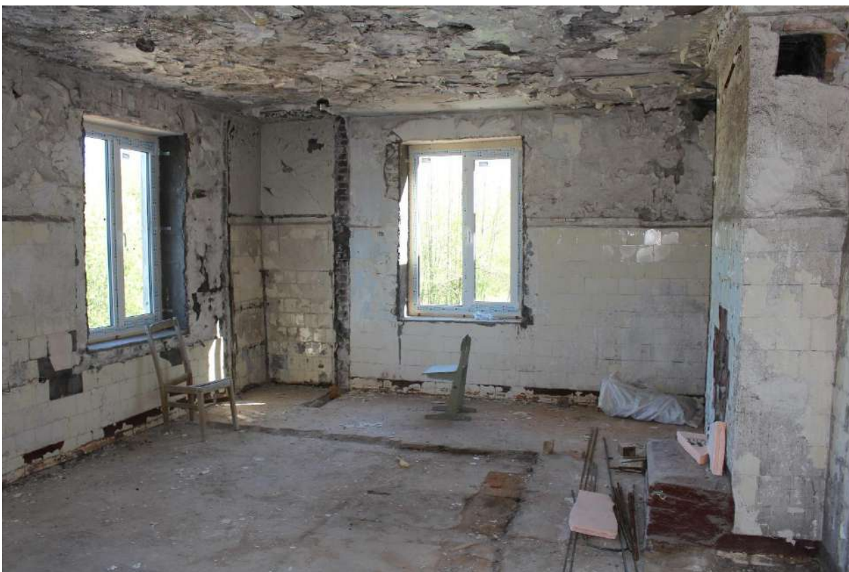
Фото 118. Выявленный объект культурного наследия «Здание школы». Внутренние помещения 1-го этажа.
