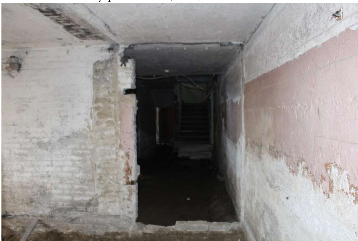
Фото 150. Выявленный объект культурного наследия «Здание школы». Внутренние помещения цокольного этажа.
