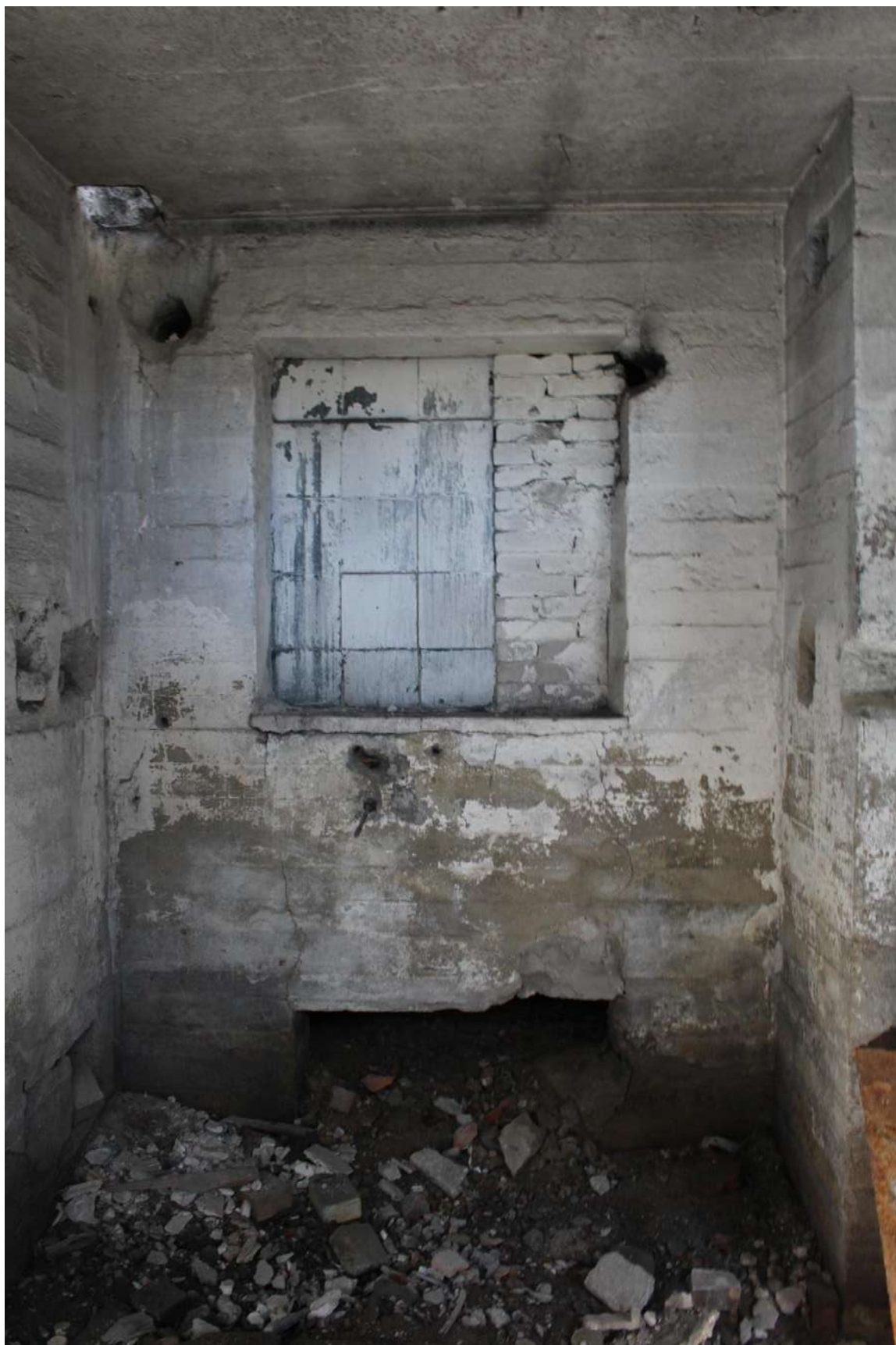
Фото 146. Выявленный объект культурного наследия «Здание школы». Внутренние помещения цокольного этажа.
