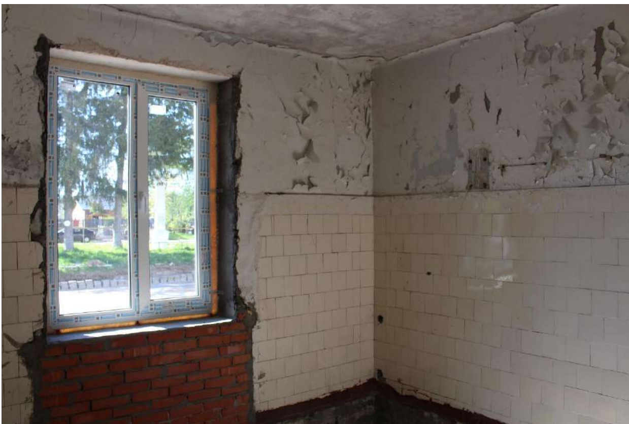
Фото 114. Выявленный объект культурного наследия «Здание школы». Внутренние помещения 1-го этажа.
