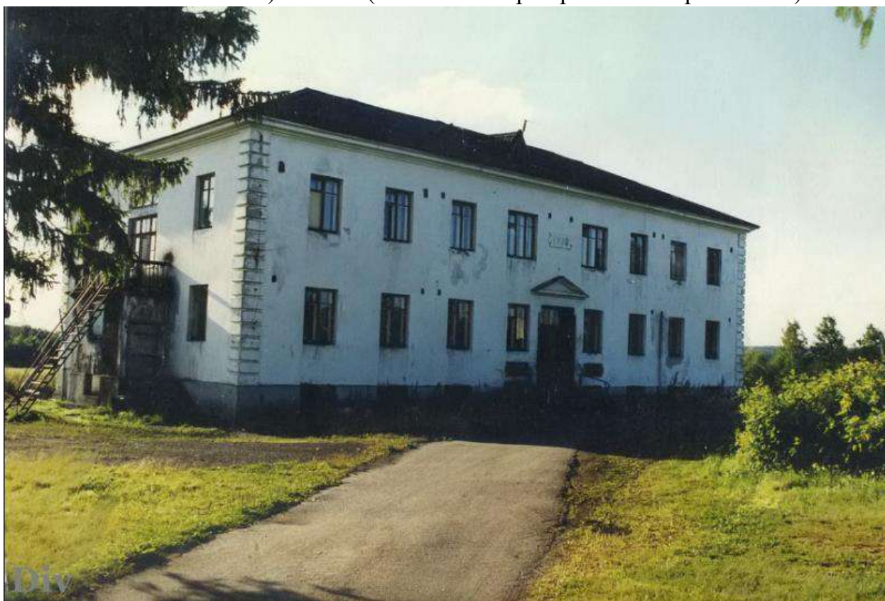
Илл. 22. Заброшенное здание школы-интерната в поселке Новинка. 2013 г. (источник: http://www.hiddenside.ru/photos/industrial/lo/zabroshennaya_vspomogatelnaya_shkola-internat_gromovo_2013.htm ).
