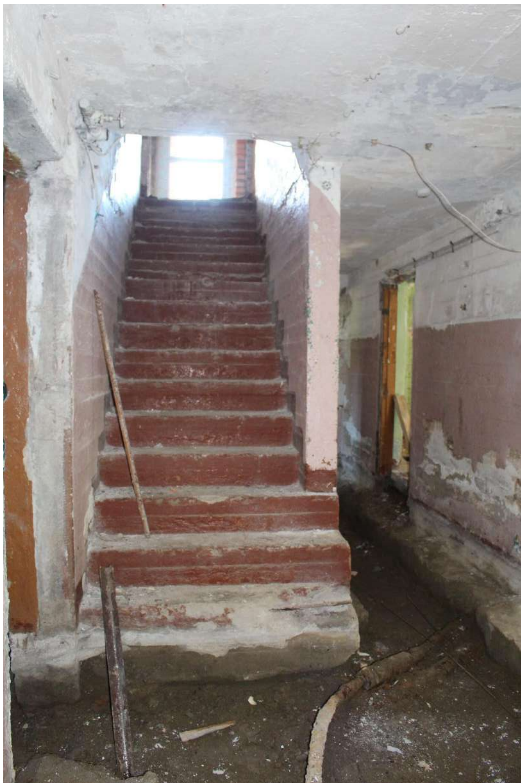
Фото 151. Выявленный объект культурного наследия «Здание школы». Внутренние помещения цокольного этажа.
