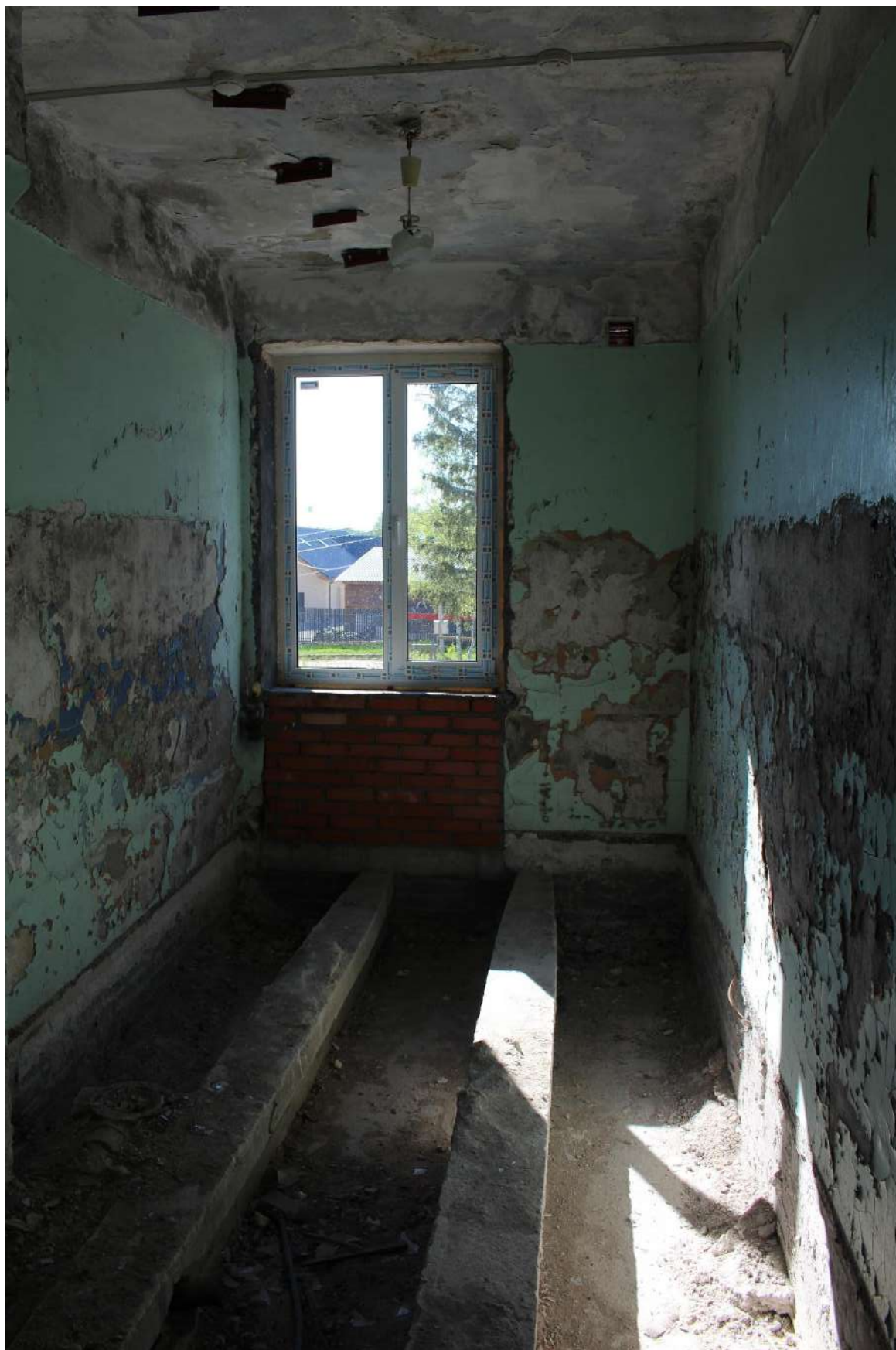
Фото 177. Выявленный объект культурного наследия «Здание школы». Внутренние помещения 2-го этажа.
