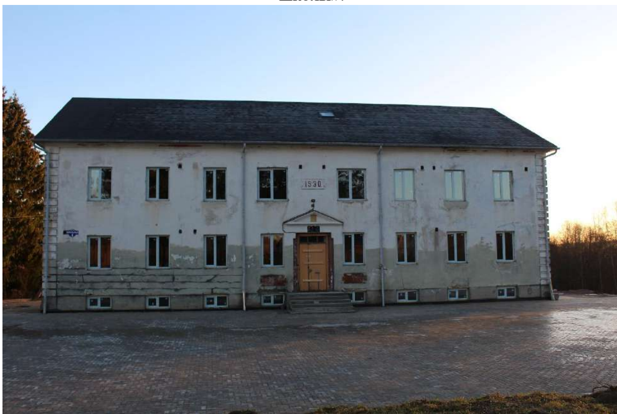
Фото 2. Вид на западный фасад выявленного объекта культурного наследия «Здание школы».
