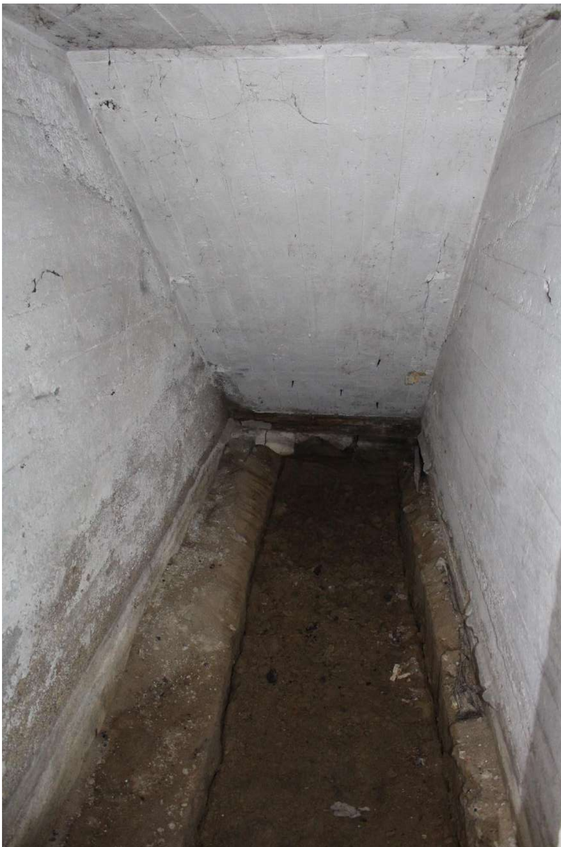
Фото 140. Выявленный объект культурного наследия «Здание школы». Внутренние помещения цокольного этажа.
