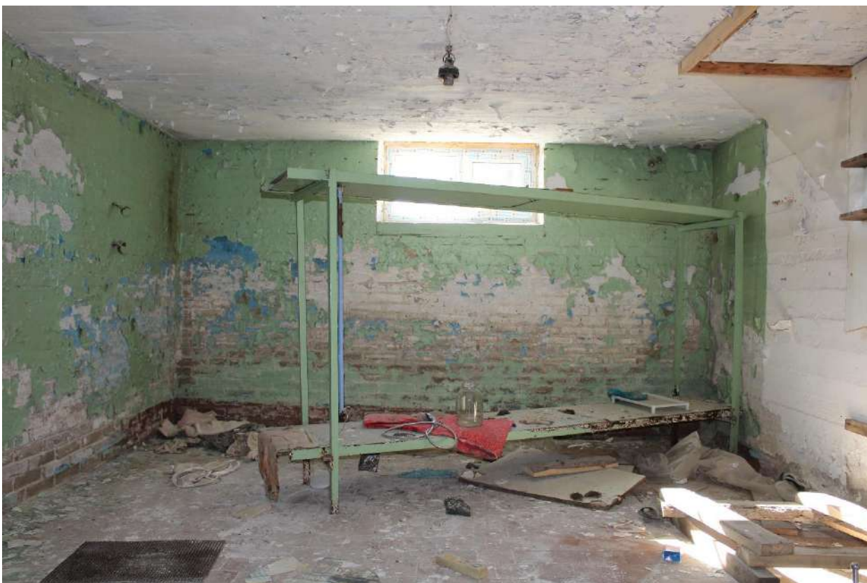
Фото 165. Выявленный объект культурного наследия «Здание школы». Внутренние помещения цокольного этажа.
