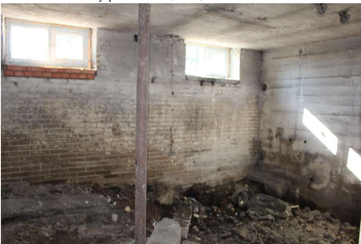
Фото 144. Выявленный объект культурного наследия «Здание школы». Внутренние помещения цокольного этажа.
