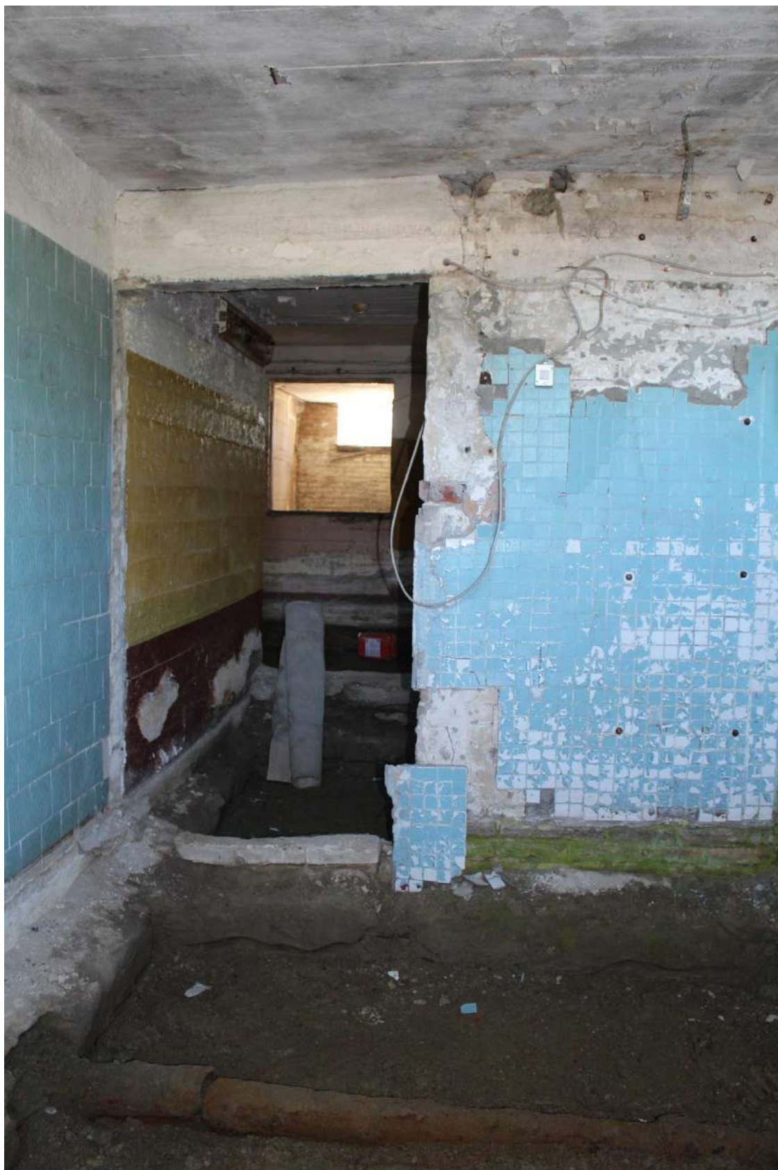
Фото 158. Выявленный объект культурного наследия «Здание школы». Внутренние помещения цокольного этажа.
