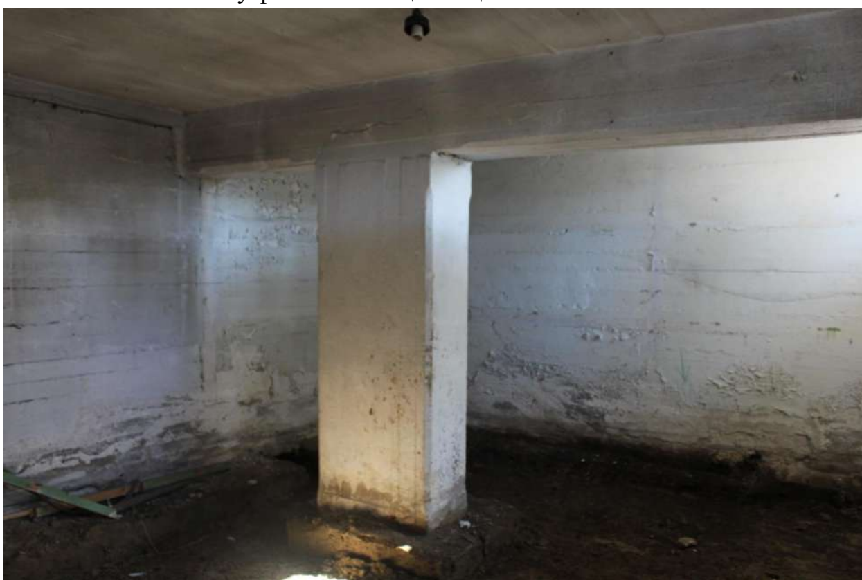
Фото 142. Выявленный объект культурного наследия «Здание школы». Внутренние помещения цокольного этажа.
