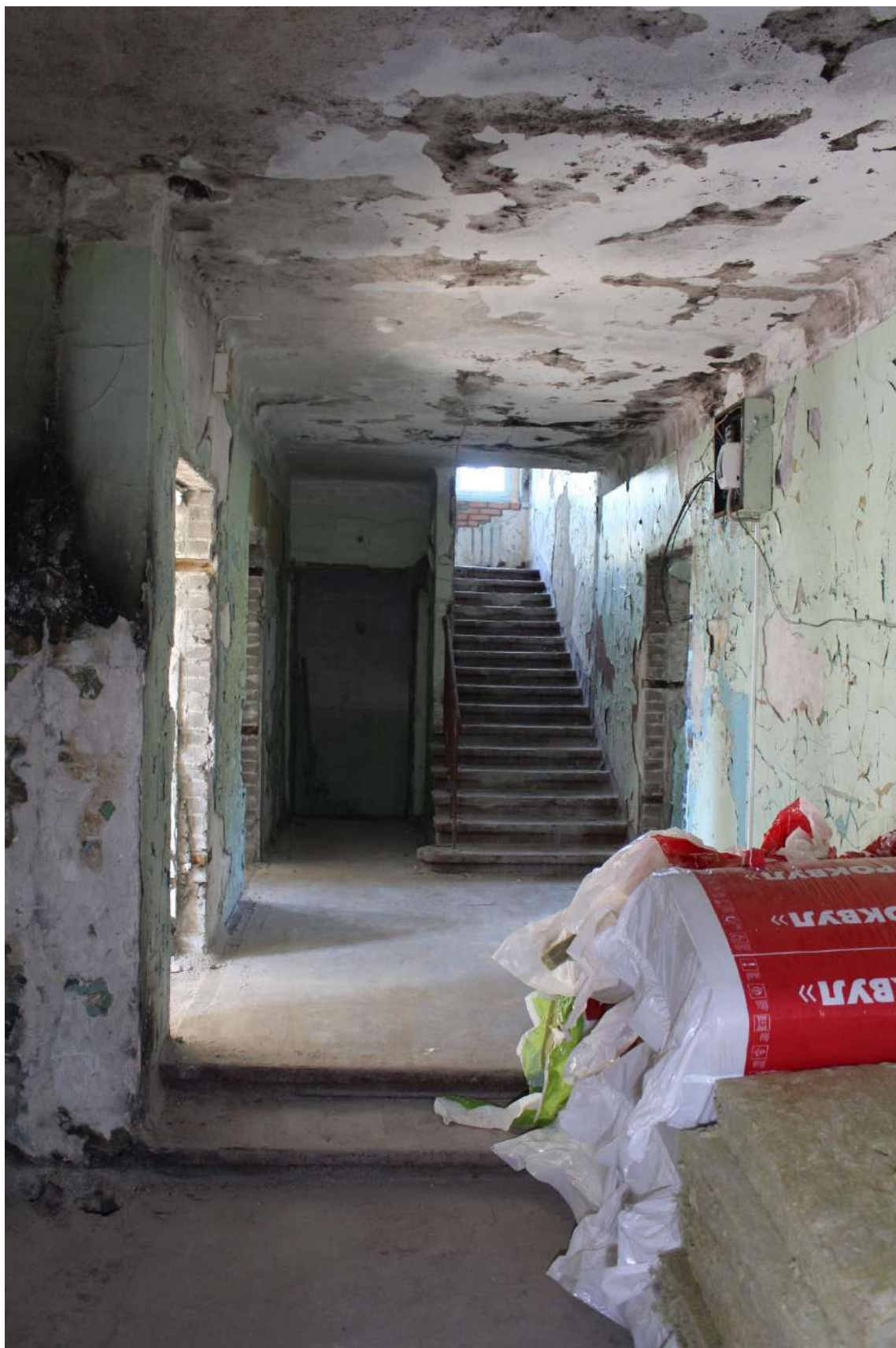
Фото 107. Выявленный объект культурного наследия «Здание школы». Внутренние помещения 1-го этажа.
