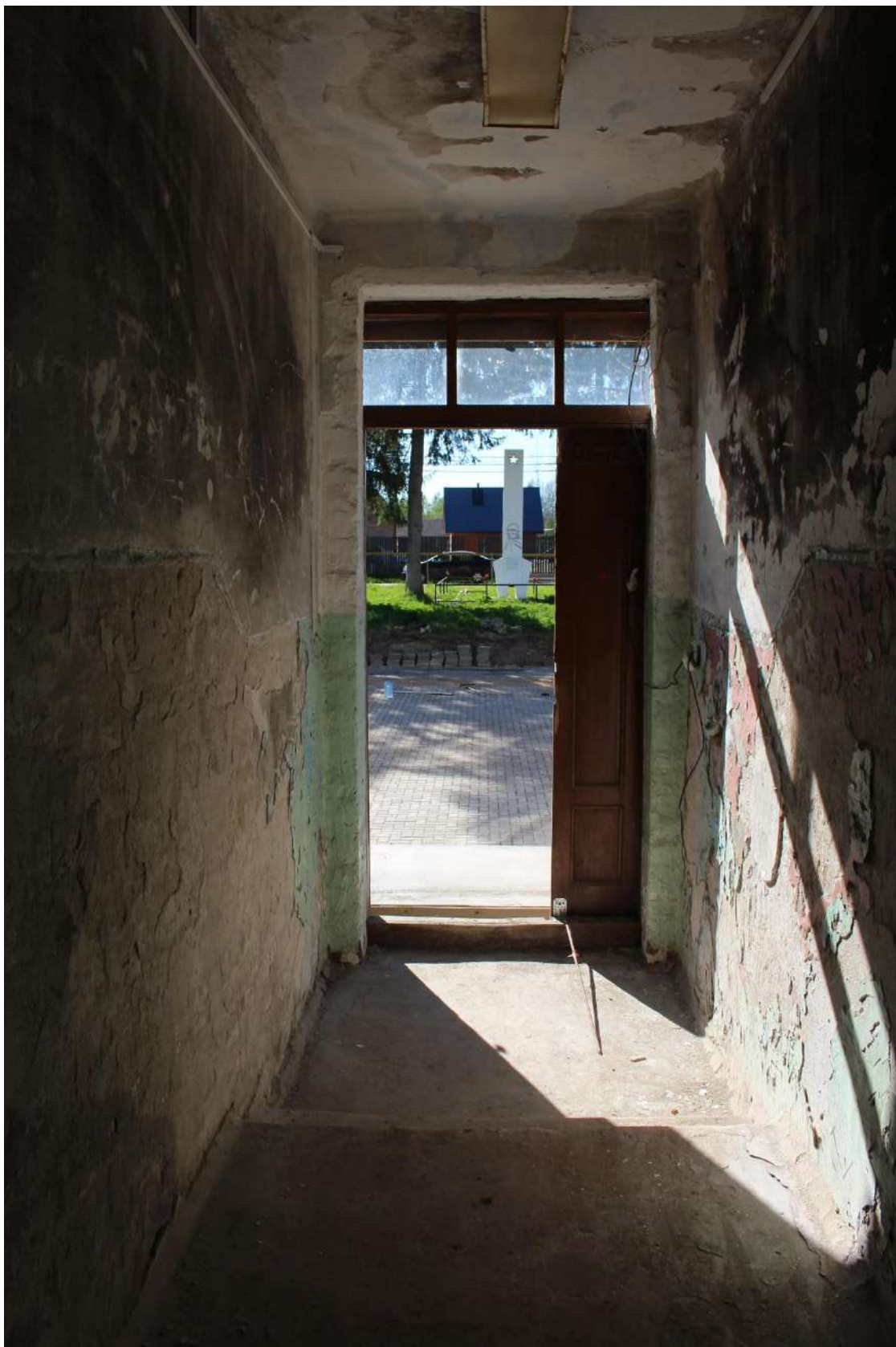
Фото 105. Выявленный объект культурного наследия «Здание школы». Внутренние помещения 1-го этажа.
