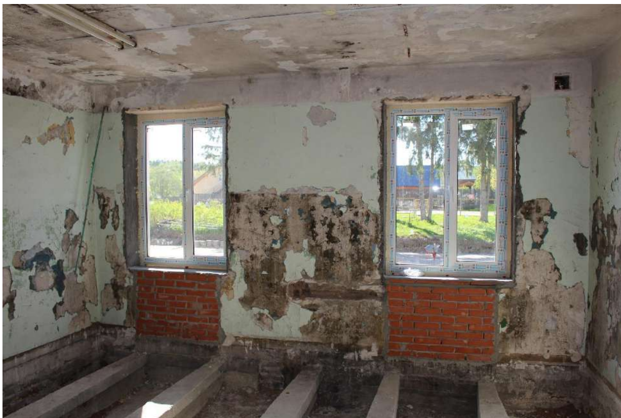
Фото 128. Выявленный объект культурного наследия «Здание школы». Внутренние помещения 1-го этажа.
