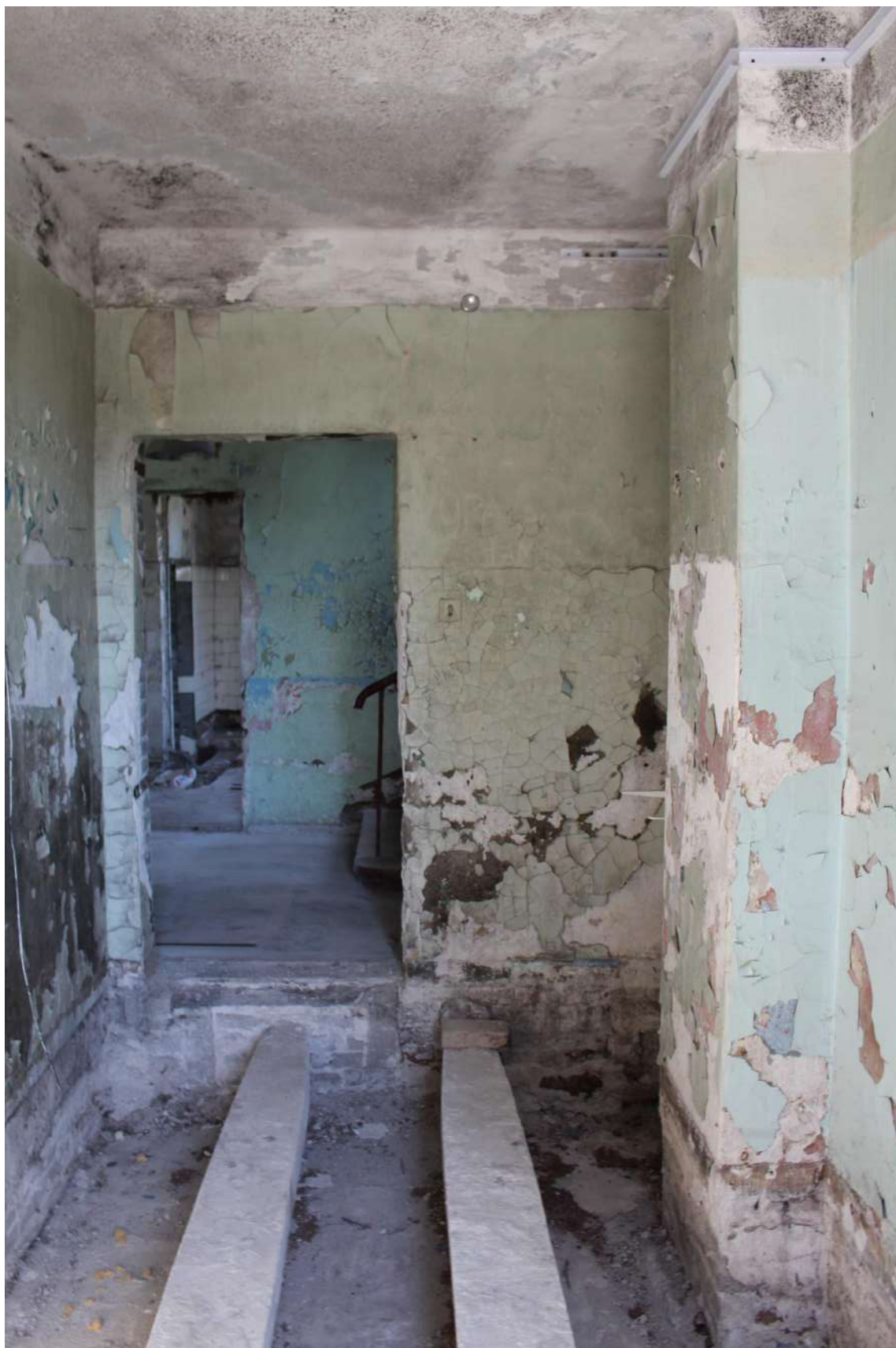
Фото 111. Выявленный объект культурного наследия «Здание школы». Внутренние помещения 1-го этажа.
