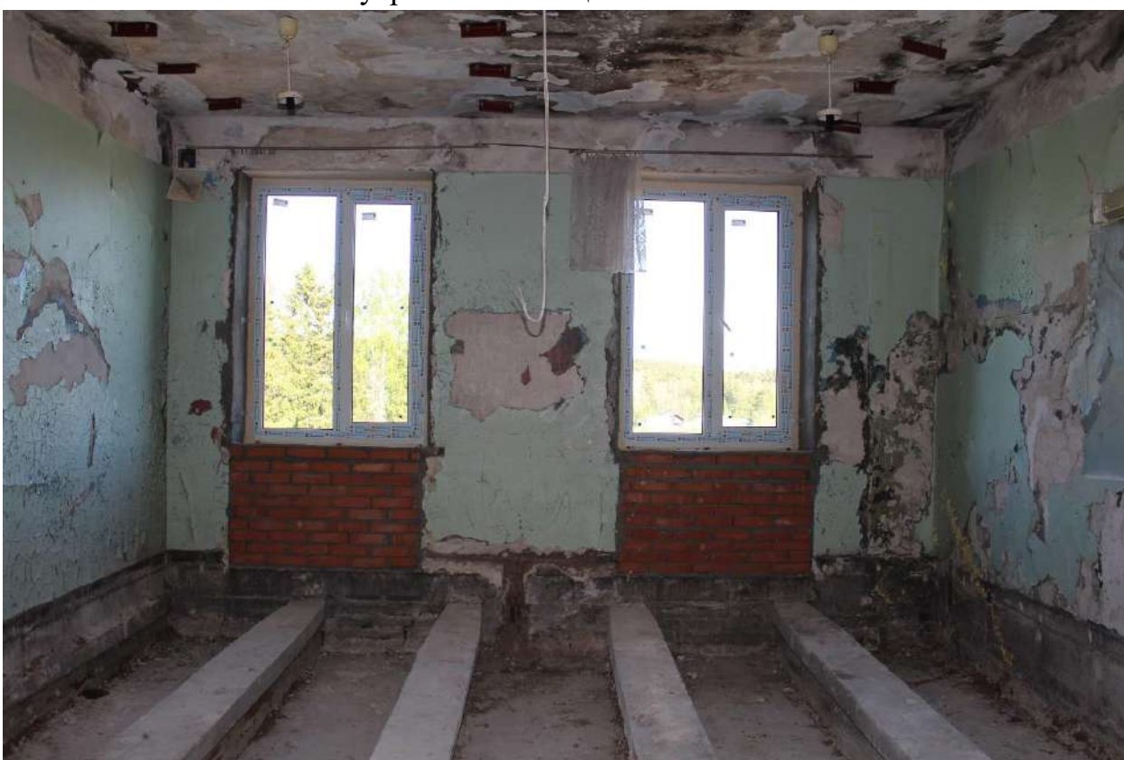
Фото 200. Выявленный объект культурного наследия «Здание школы». Внутренние помещения 2-го этажа.
