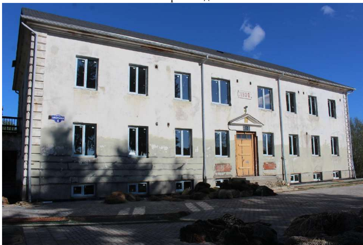
Фото 76. Вид на западный фасад выявленного объекта культурного наследия «Здание школы».
