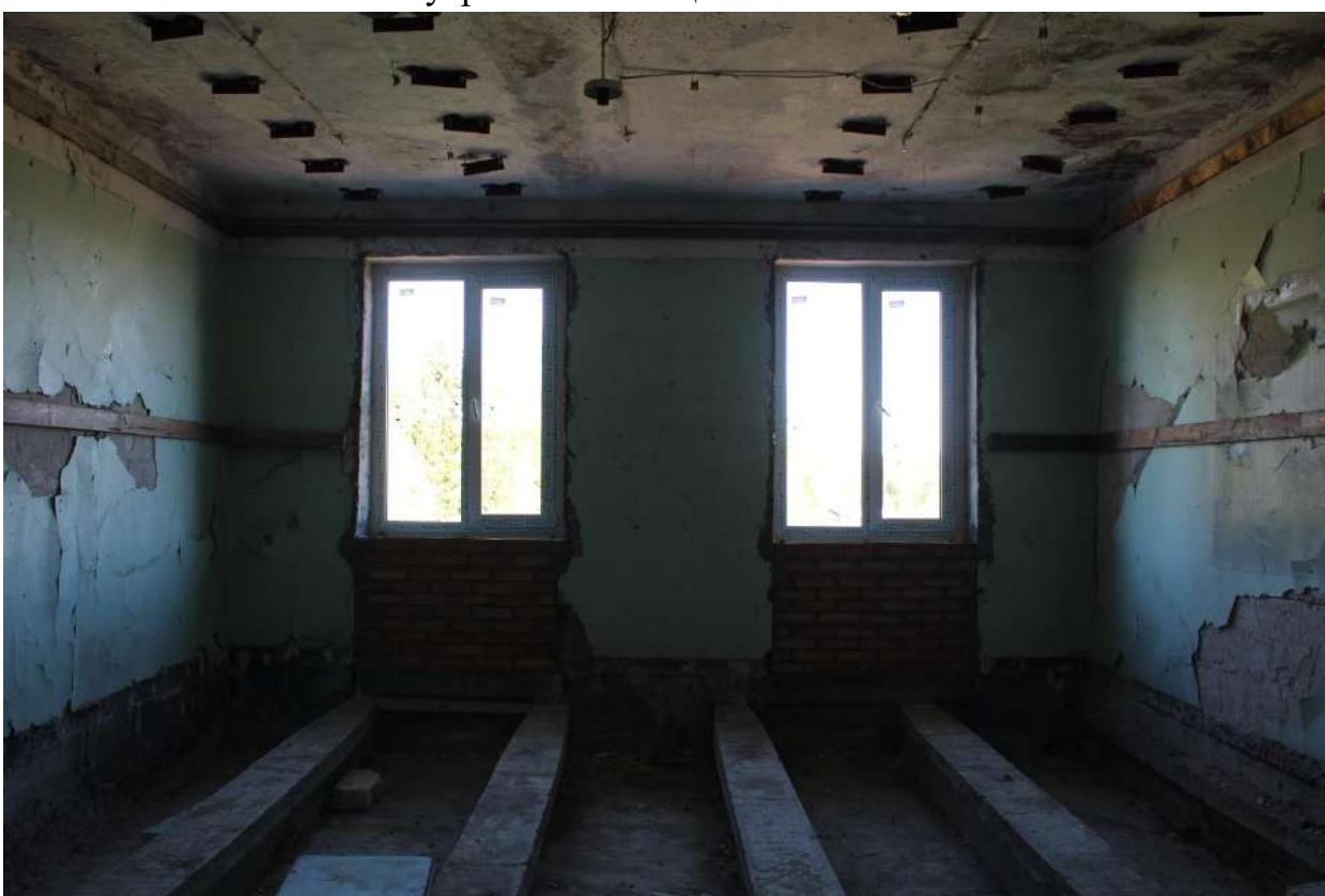
Фото 198. Выявленный объект культурного наследия «Здание школы». Внутренние помещения 2-го этажа.
