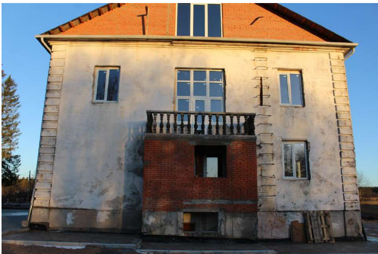
Фото 5. Вид на южный фасад выявленного объекта культурного наследия «Здание школы».
