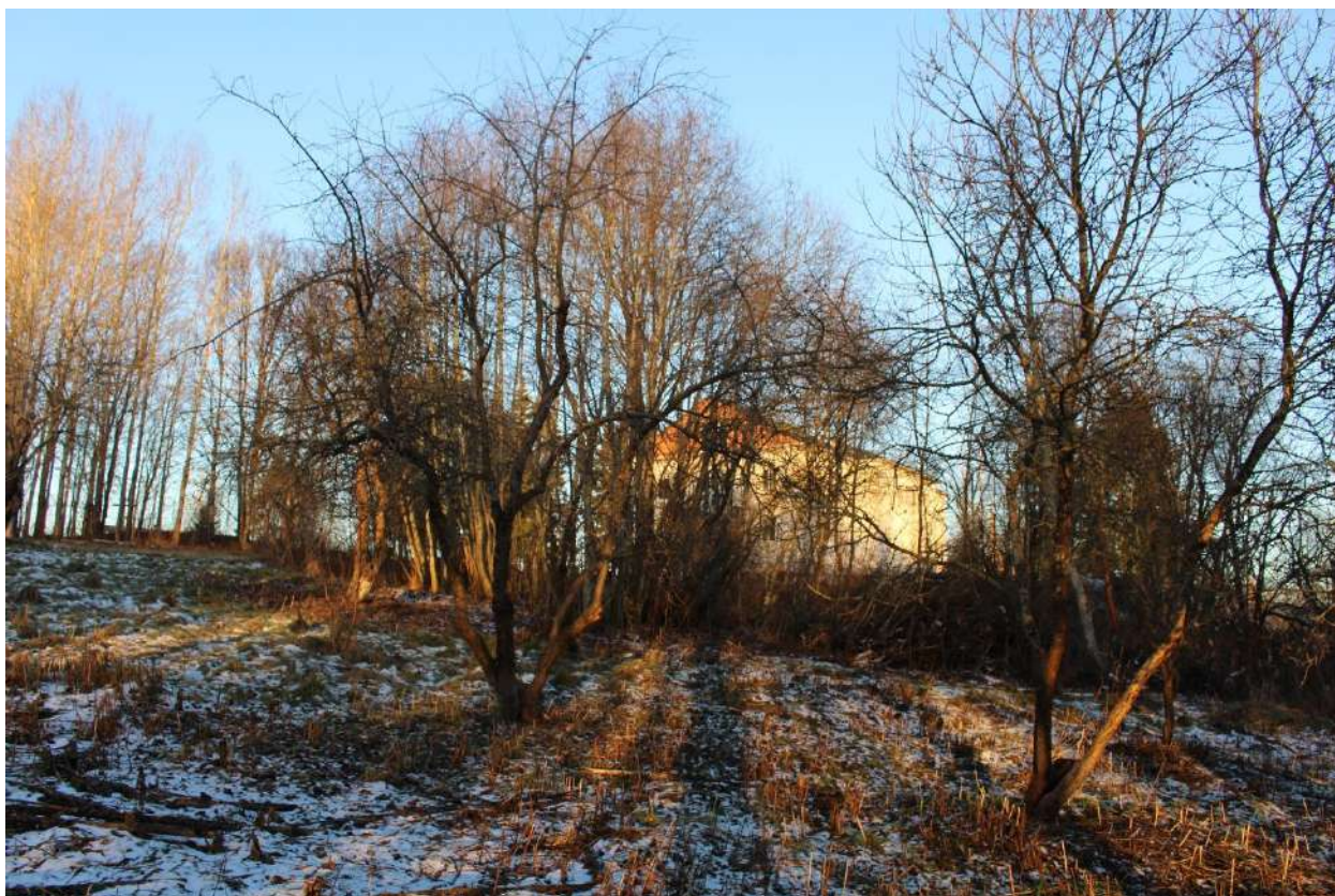
Фото 48. Вид на центральную часть выявленного объекта культурного наследия «Пришкольный участок (4 га)».
