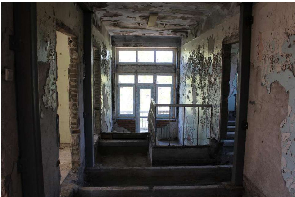
Фото 183. Выявленный объект культурного наследия «Здание школы». Внутренние помещения 2-го этажа.
