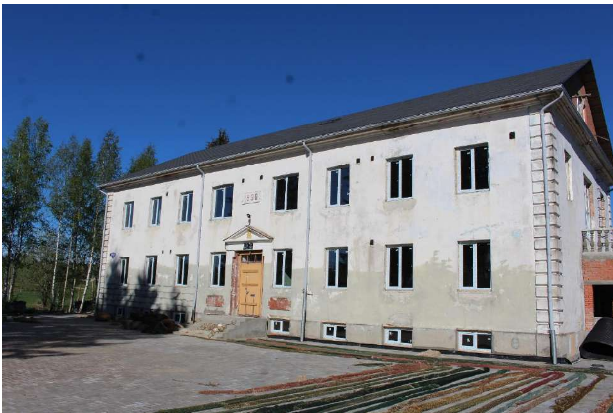
Фото 77. Вид на западный фасад выявленного объекта культурного наследия «Здание школы».
