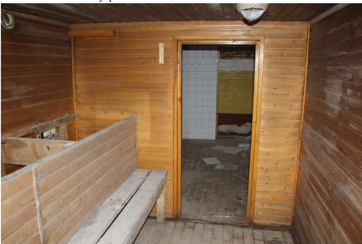
Фото 155. Выявленный объект культурного наследия «Здание школы». Внутренние помещения цокольного этажа.
