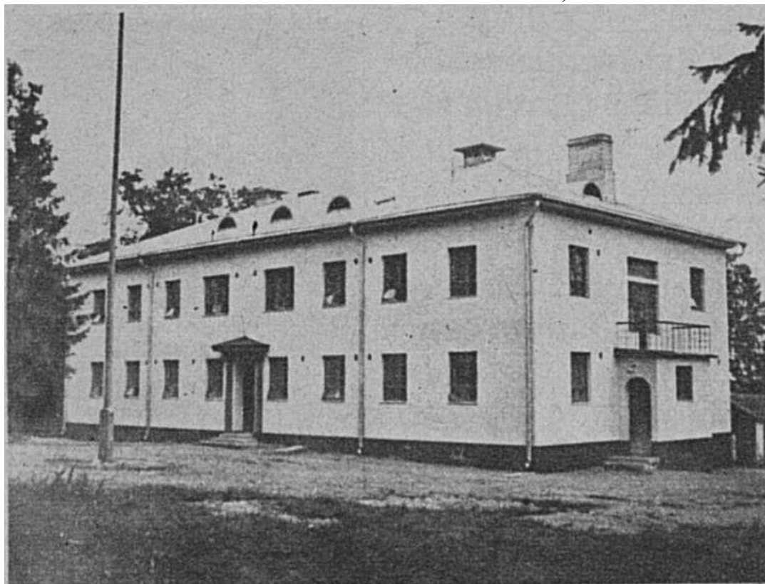
Илл. 20. Дом для престарелых и неимущих волости Уусикиркко. 1932 г. (источник: https://terijoki.spb.ru/photos/picture.php?/116513/tags/811-сельская_архитектура_1918_1944 ).
