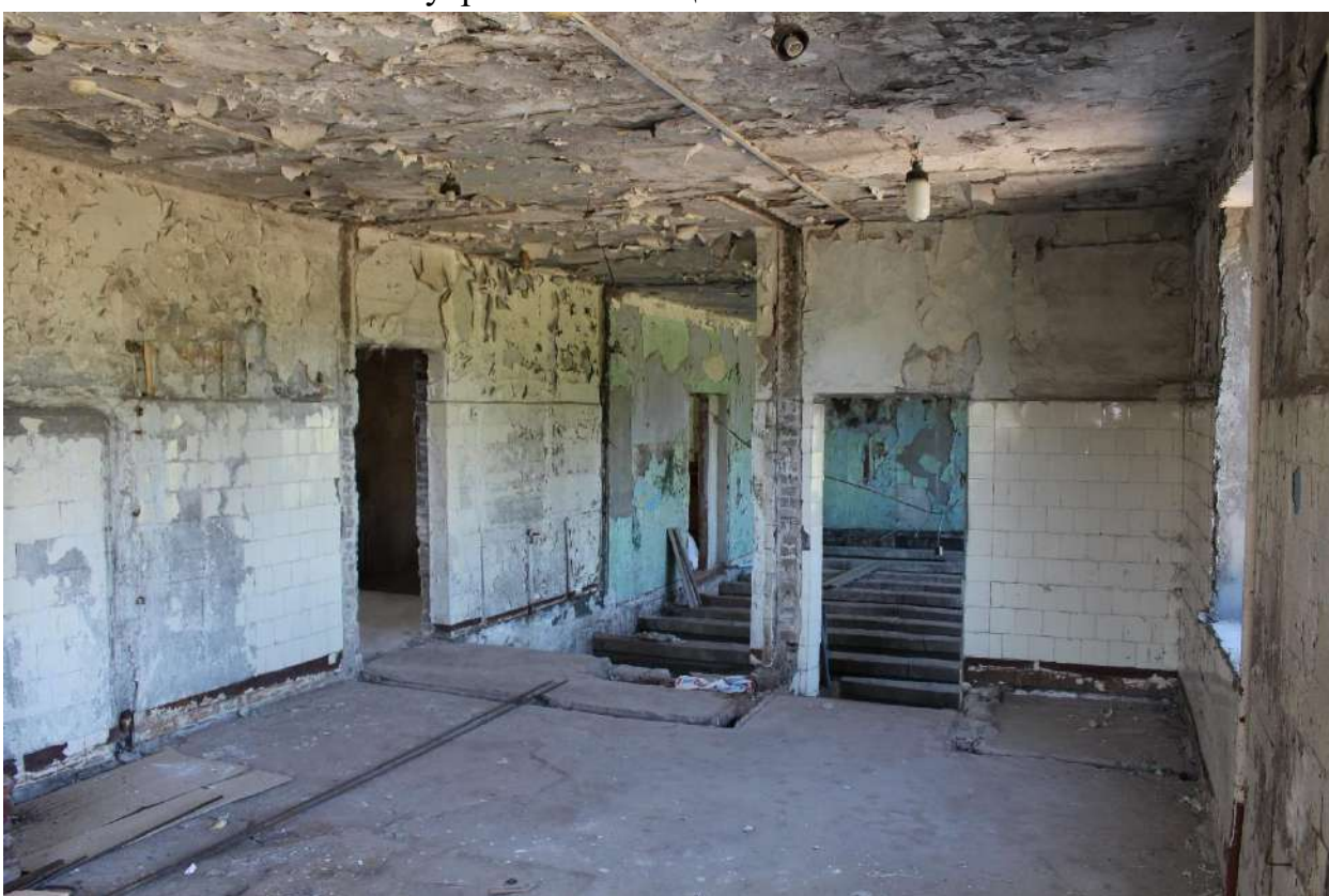
Фото 117. Выявленный объект культурного наследия «Здание школы». Внутренние помещения 1-го этажа.
