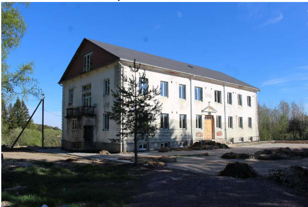
Фото 75. Вид на выявленный объект культурного наследия «Здание школы» с северо-запада.
