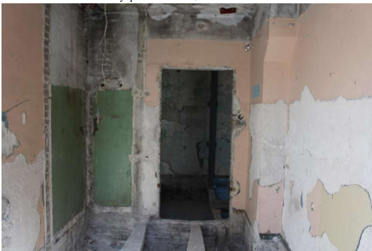
Фото 186. Выявленный объект культурного наследия «Здание школы». Внутренние помещения 2-го этажа.
