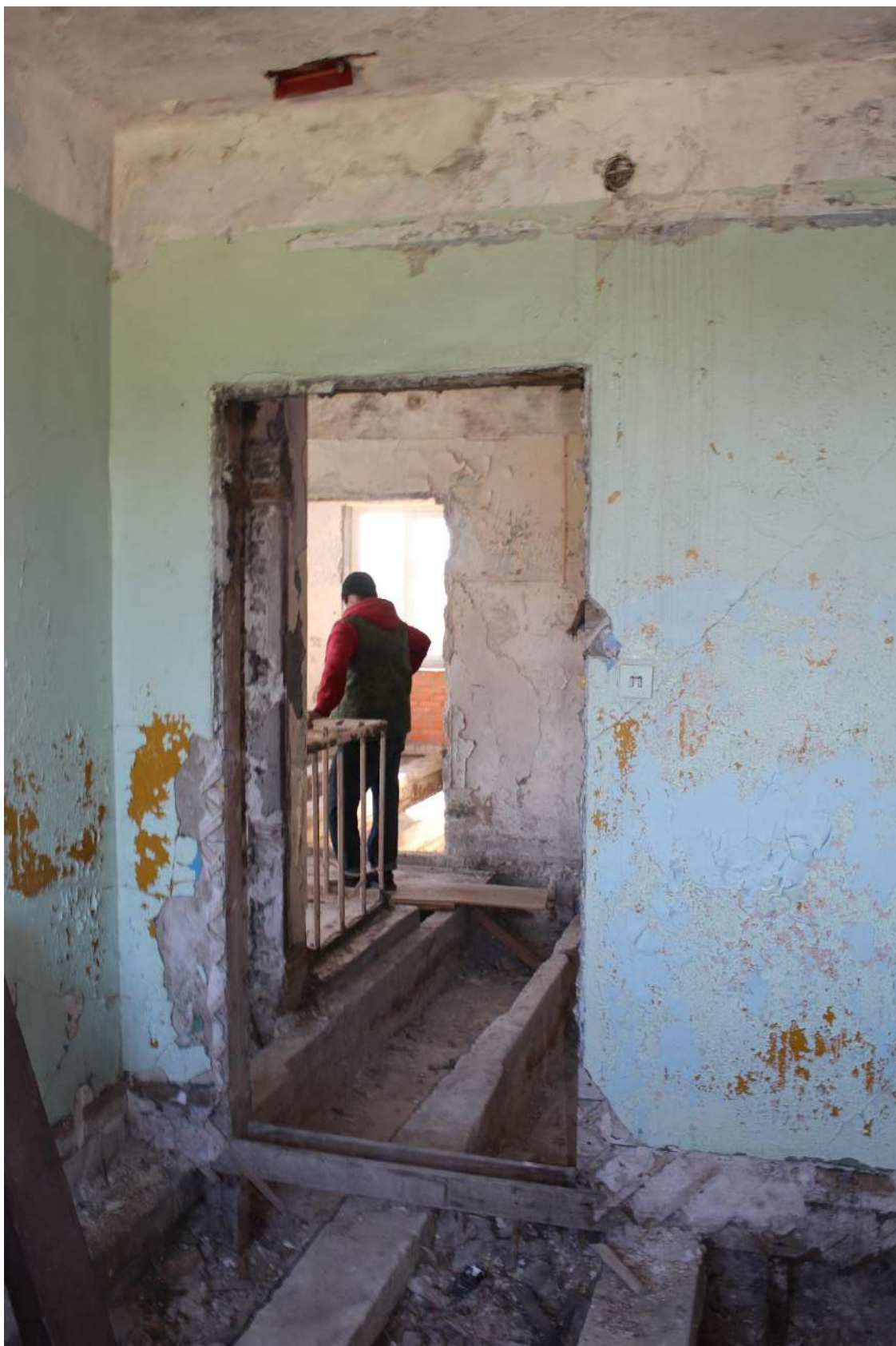
Фото 205. Выявленный объект культурного наследия «Здание школы». Внутренние помещения 2-го этажа.
