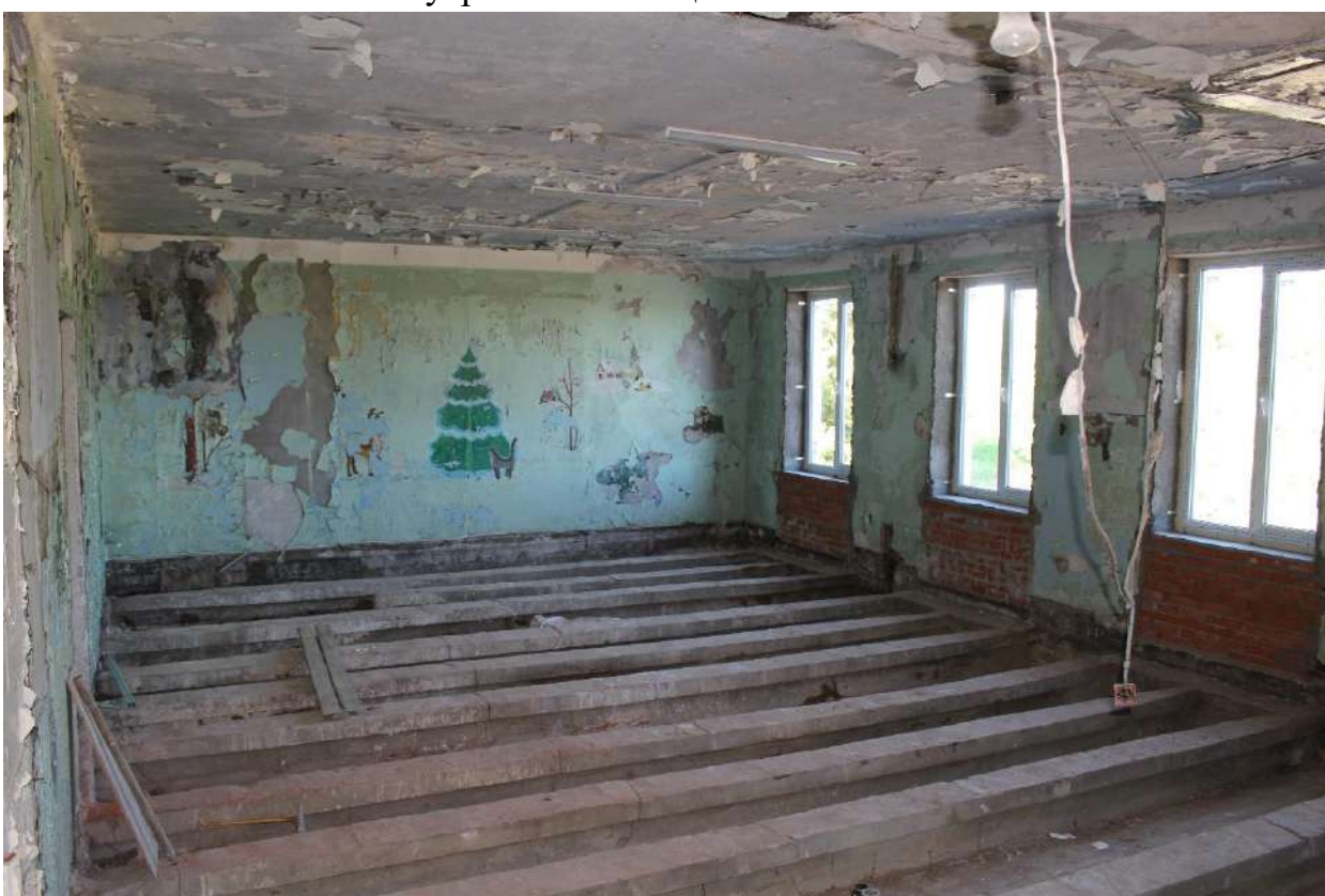
Фото 119. Выявленный объект культурного наследия «Здание школы». Внутренние помещения 1-го этажа.
