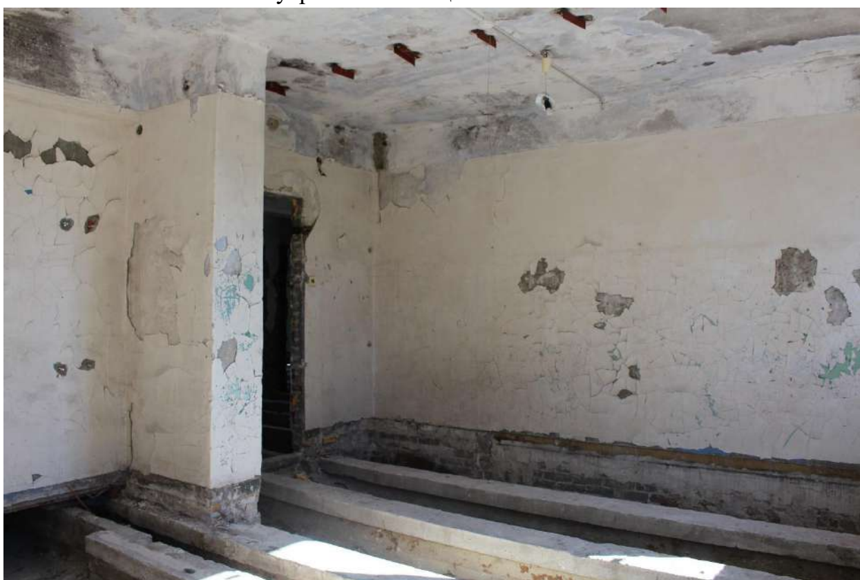
Фото 180. Выявленный объект культурного наследия «Здание школы». Внутренние помещения 2-го этажа.
