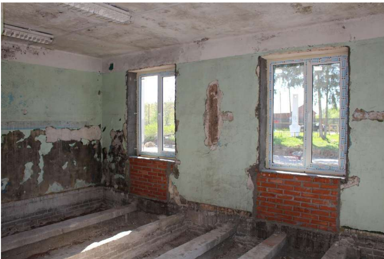
Фото 126. Выявленный объект культурного наследия «Здание школы». Внутренние помещения 1-го этажа.
