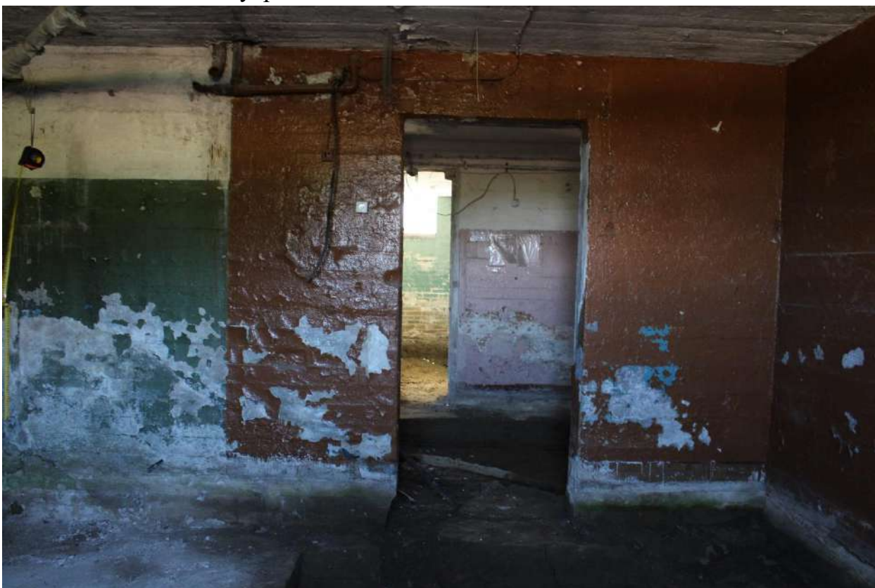
Фото 162. Выявленный объект культурного наследия «Здание школы». Внутренние помещения цокольного этажа.
