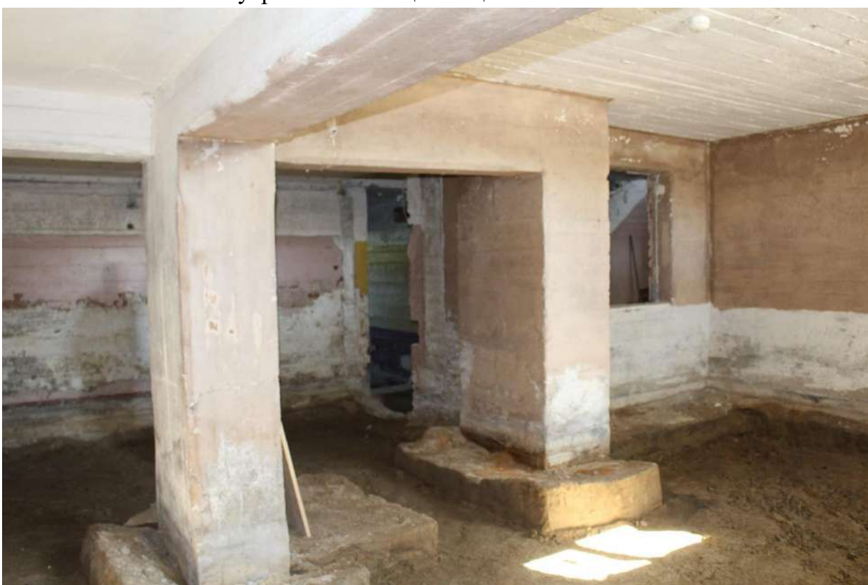
Фото 148. Выявленный объект культурного наследия «Здание школы». Внутренние помещения цокольного этажа.
