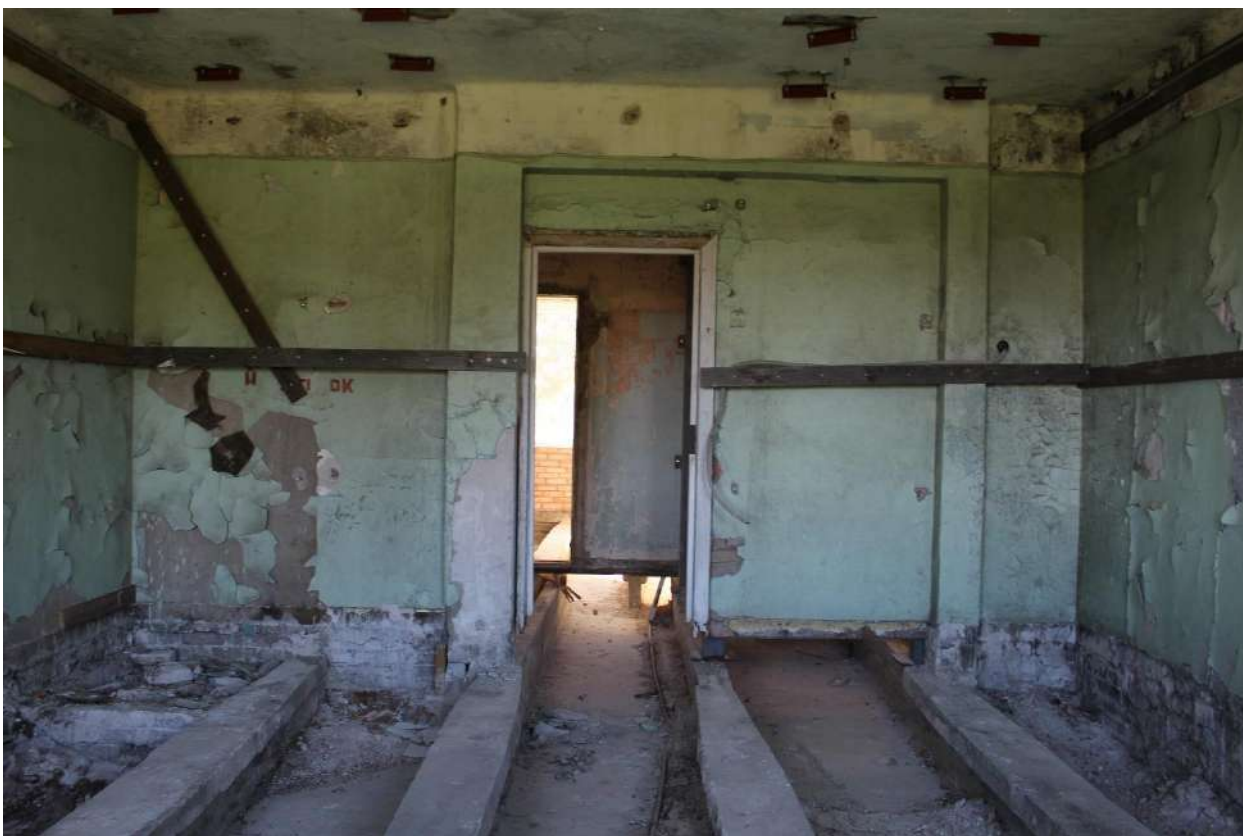
Фото 199. Выявленный объект культурного наследия «Здание школы». Внутренние помещения 2-го этажа.
