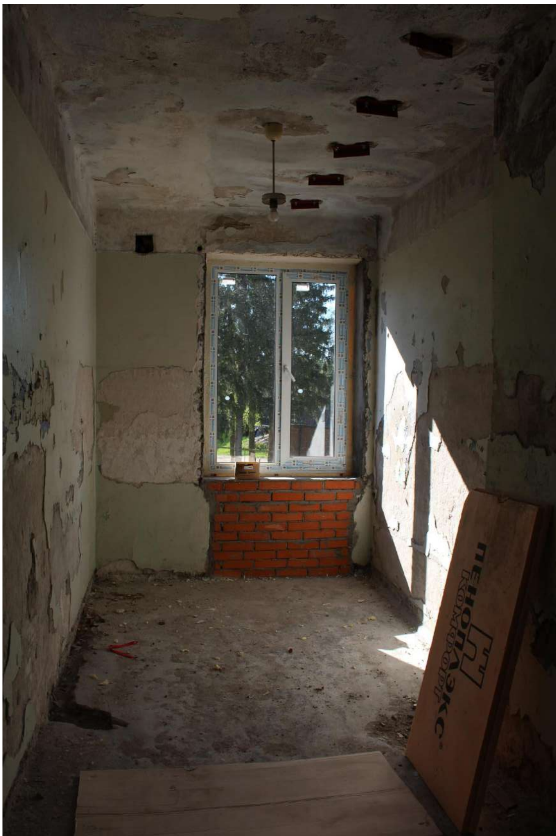
Фото 187. Выявленный объект культурного наследия «Здание школы». Внутренние помещения 2-го этажа.
