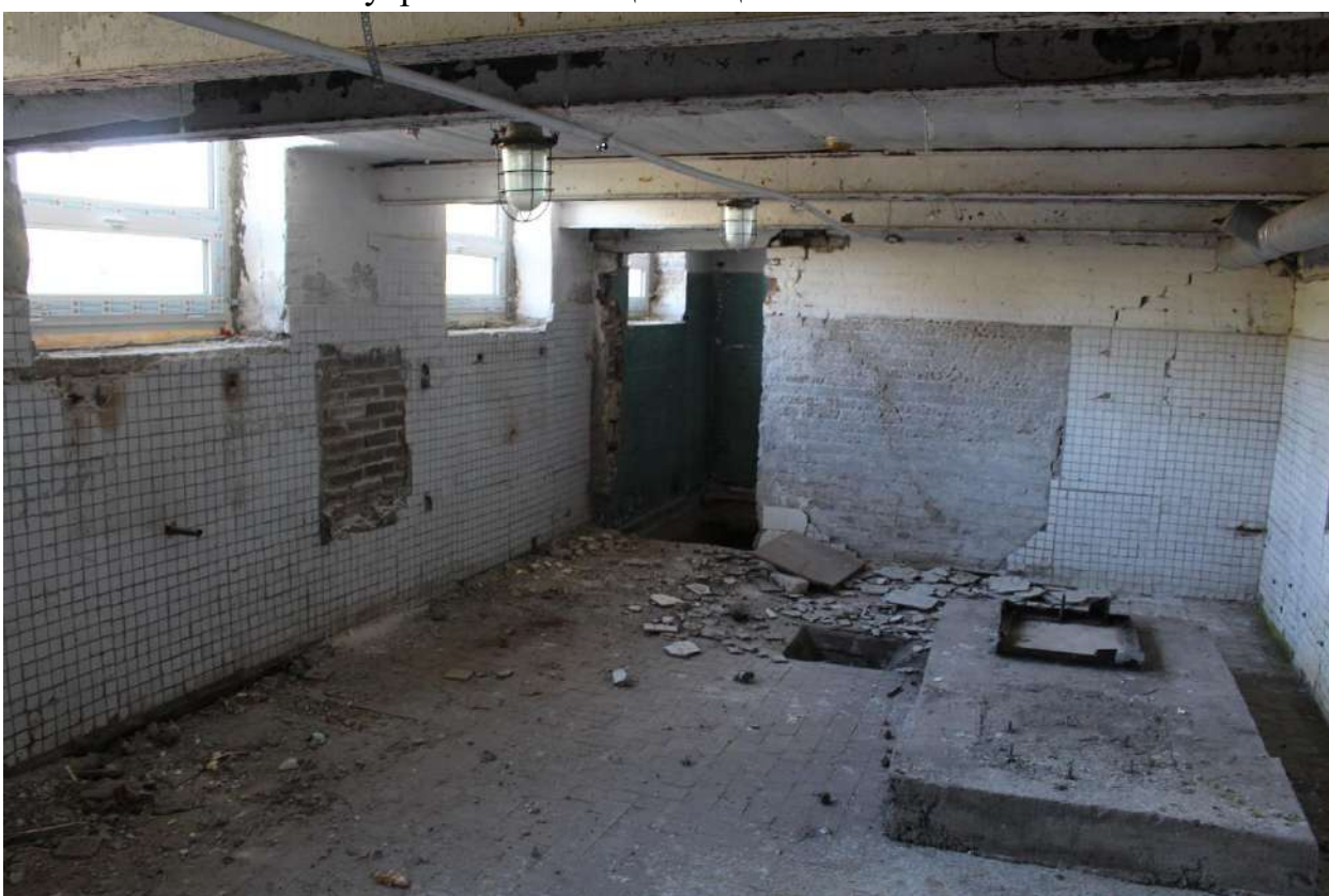
Фото 160. Выявленный объект культурного наследия «Здание школы». Внутренние помещения цокольного этажа.
