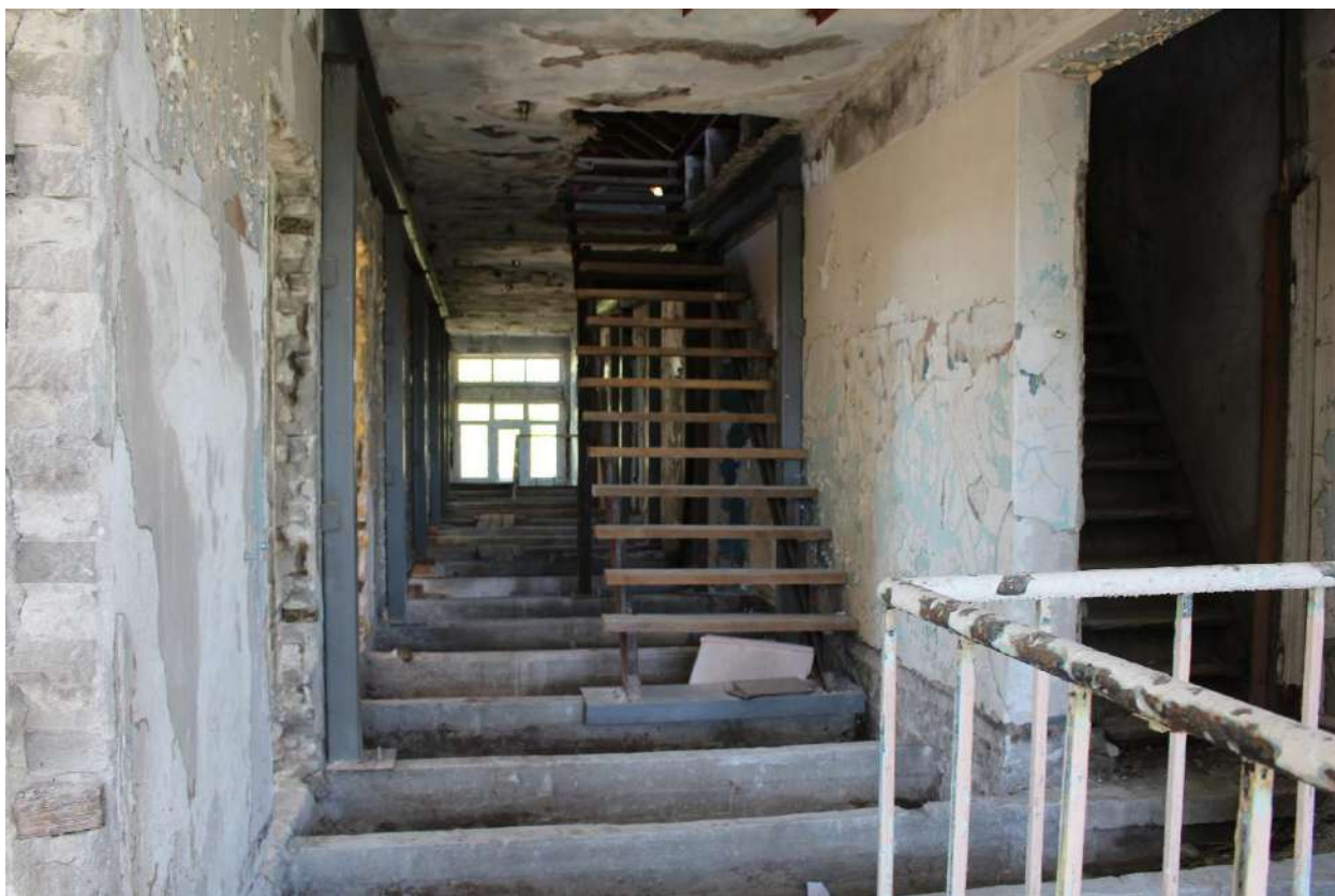
Фото 173. Выявленный объект культурного наследия «Здание школы». Внутренние помещения 2-го этажа.
