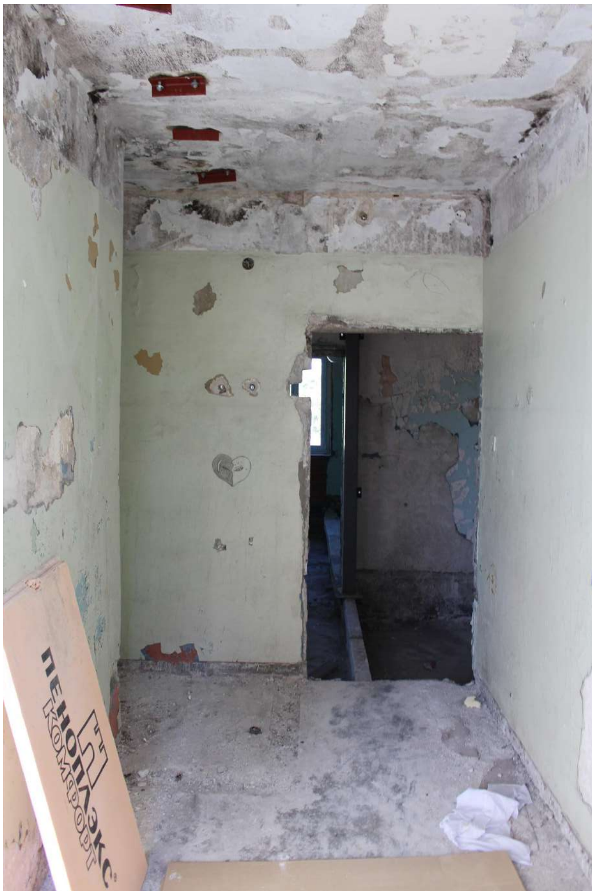
Фото 188. Выявленный объект культурного наследия «Здание школы». Внутренние помещения 2-го этажа.
