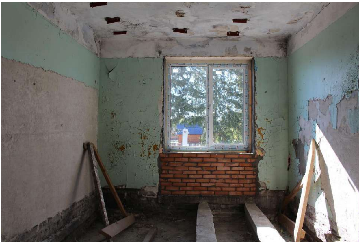
Фото 181. Выявленный объект культурного наследия «Здание школы». Внутренние помещения 2-го этажа.
