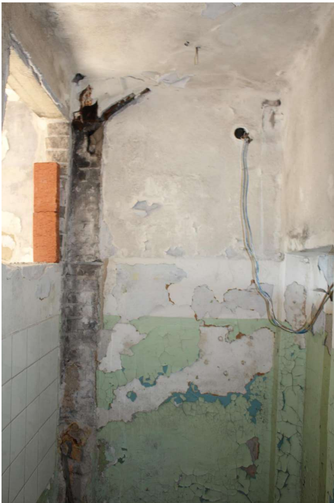
Фото 113. Выявленный объект культурного наследия «Здание школы». Внутренние помещения 1-го этажа.
