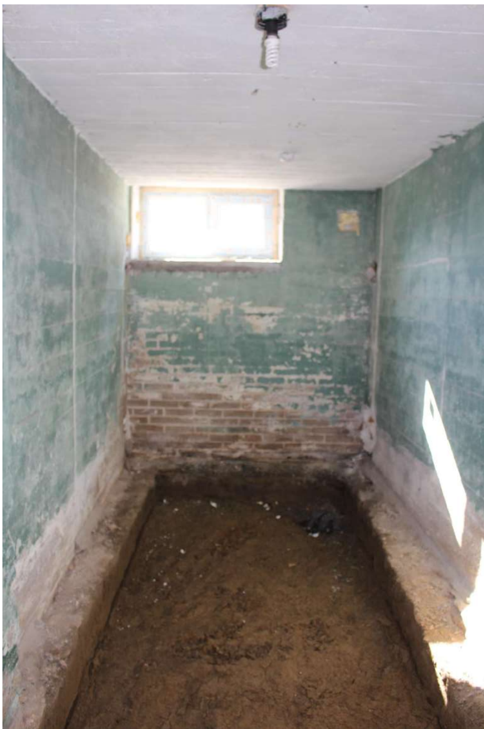
Фото 163. Выявленный объект культурного наследия «Здание школы». Внутренние помещения цокольного этажа.
