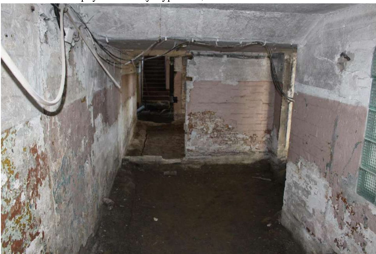
Фото 132. Выявленный объект культурного наследия «Здание школы». Внутренние помещения цокольного этажа.
