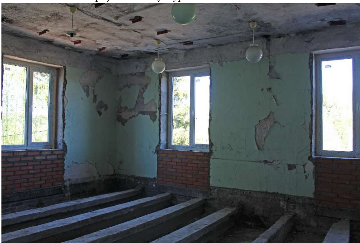
Фото 196. Выявленный объект культурного наследия «Здание школы». Внутренние помещения 2-го этажа.
