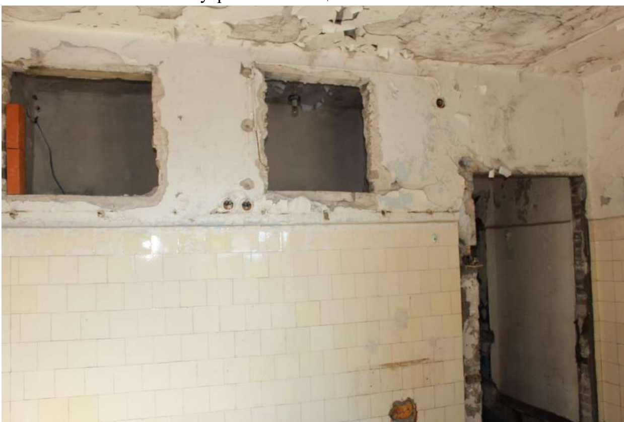
Фото 115. Выявленный объект культурного наследия «Здание школы». Внутренние помещения 1-го этажа.
