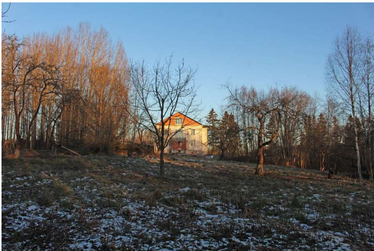
Фото 60. Вид на центральную часть выявленного объекта культурного наследия «Пришкольный участок (4 га)».
