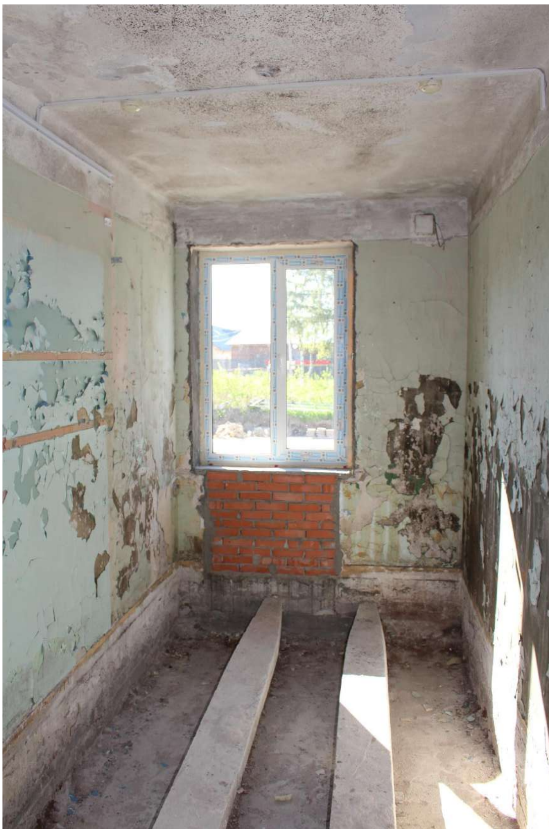
Фото 110. Выявленный объект культурного наследия «Здание школы». Внутренние помещения 1-го этажа.
