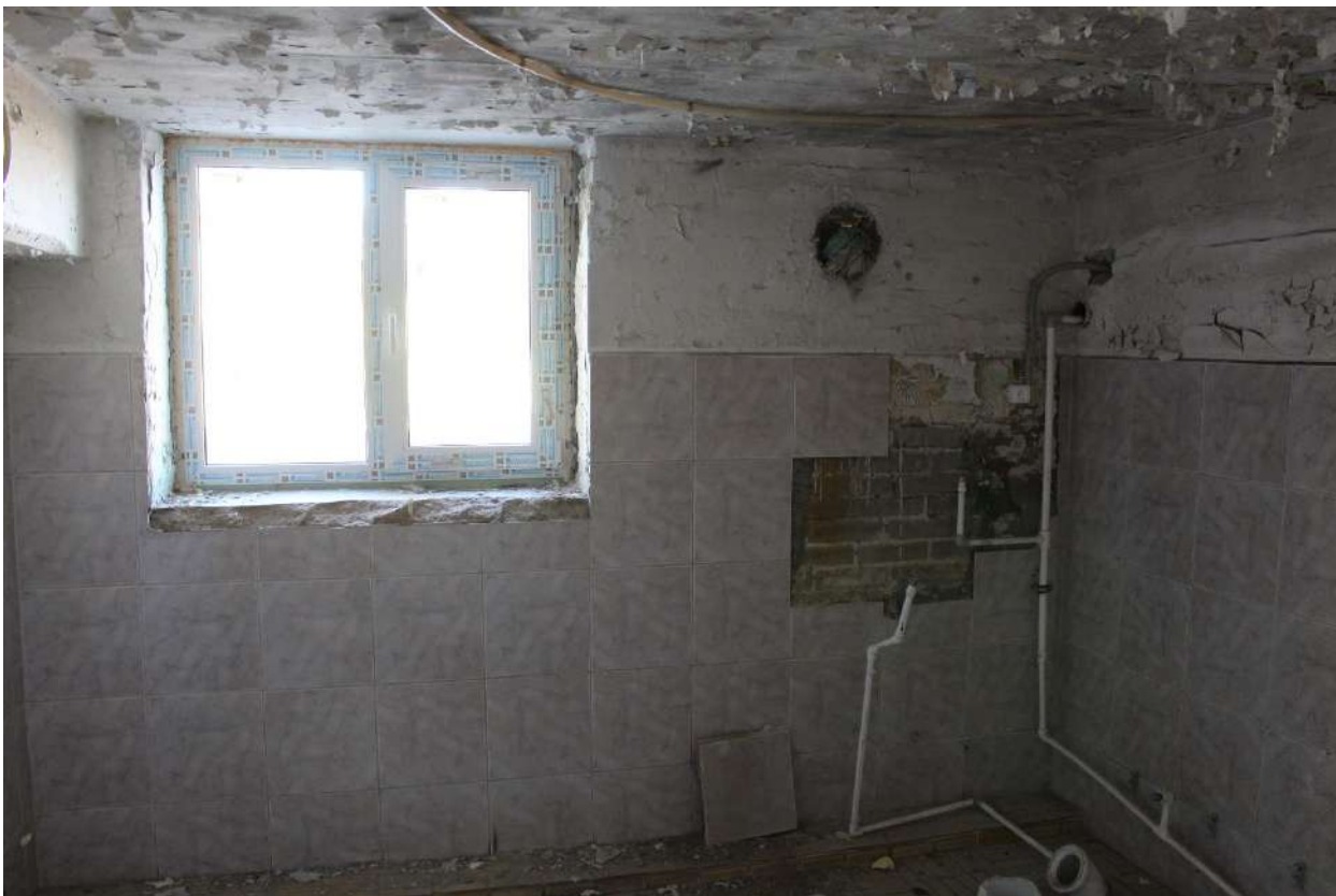
Фото 137. Выявленный объект культурного наследия «Здание школы». Внутренние помещения цокольного этажа.
