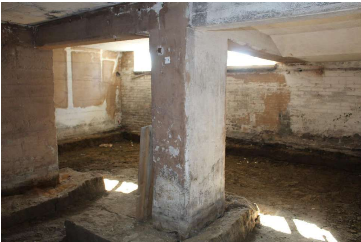
Фото 147. Выявленный объект культурного наследия «Здание школы». Внутренние помещения цокольного этажа.
