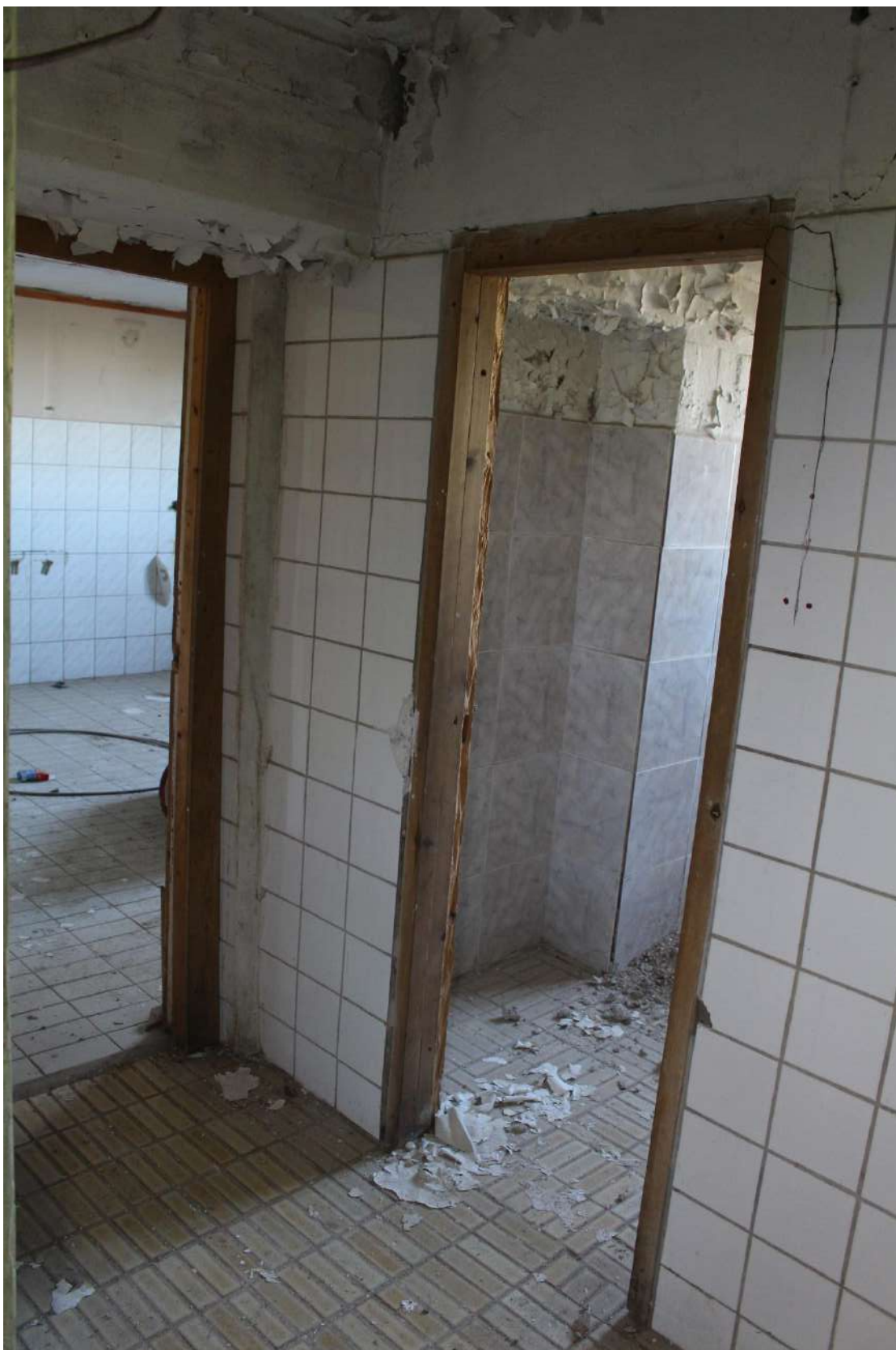
Фото 133. Выявленный объект культурного наследия «Здание школы». Внутренние помещения цокольного этажа.
