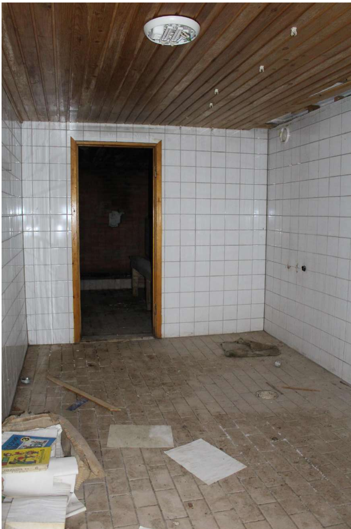
Фото 153. Выявленный объект культурного наследия «Здание школы». Внутренние помещения цокольного этажа.
