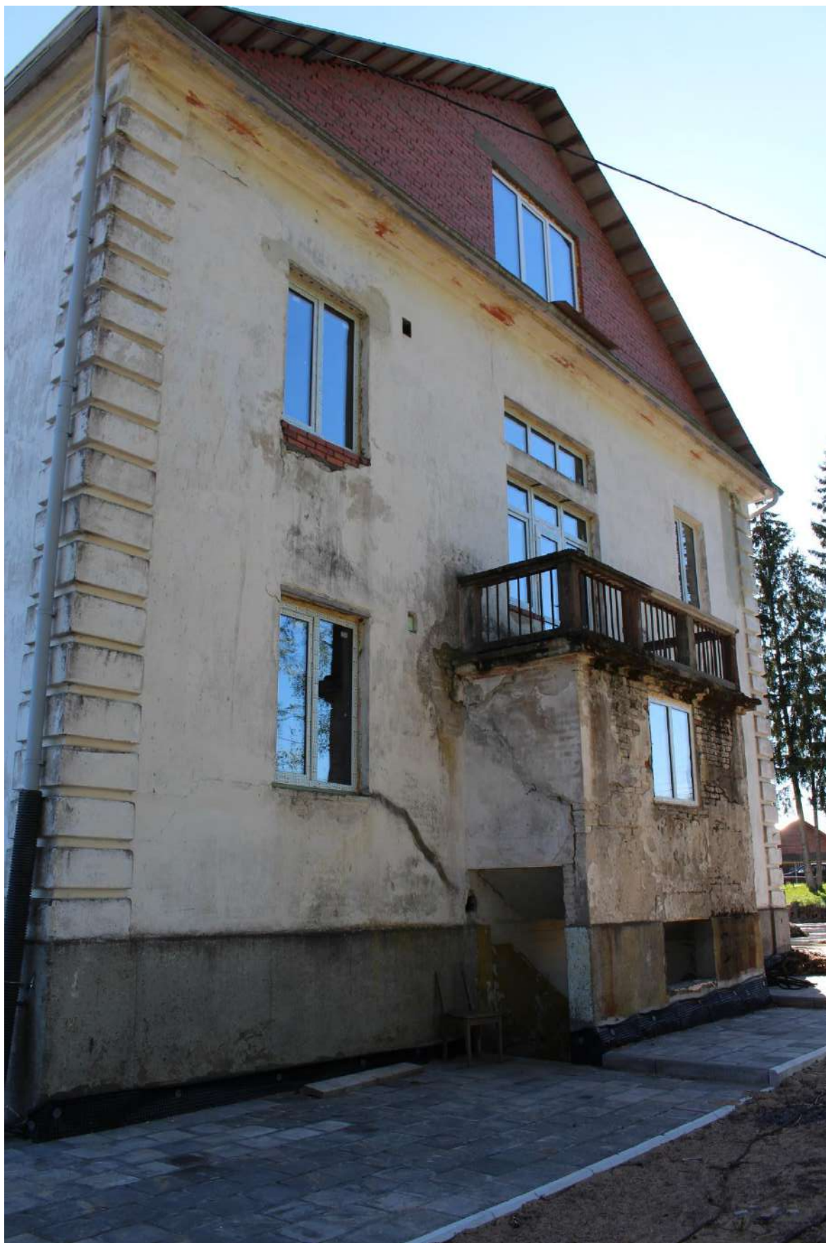
Фото 83. Вид на северный фасад выявленного объекта культурного наследия «Здание школы».
