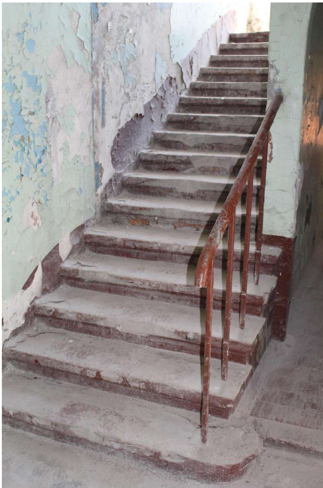
Фото 168. Выявленный объект культурного наследия «Здание школы». Вид на южную лестницу в уровне 1-го этажа.
