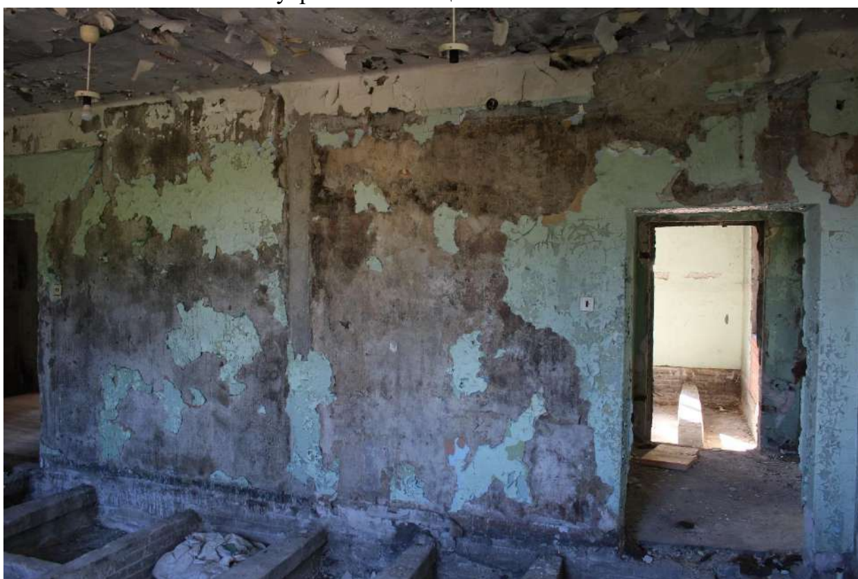
Фото 123. Выявленный объект культурного наследия «Здание школы». Внутренние помещения 1-го этажа.
