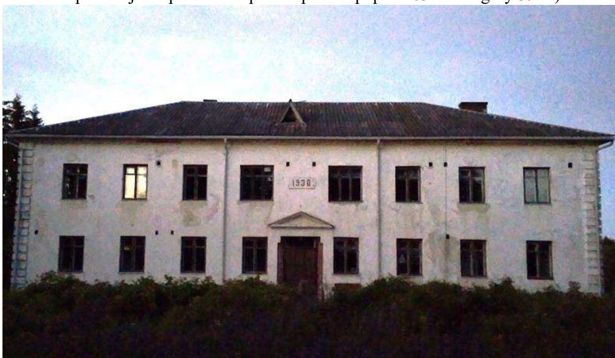
Илл. 31. Бывшее здание школы в поселке Новинка. 2017 г. (источник: https://commons.wikimedia.org/wiki/File:Бывший_муниципальный_дом_Саккола.jpg ).
