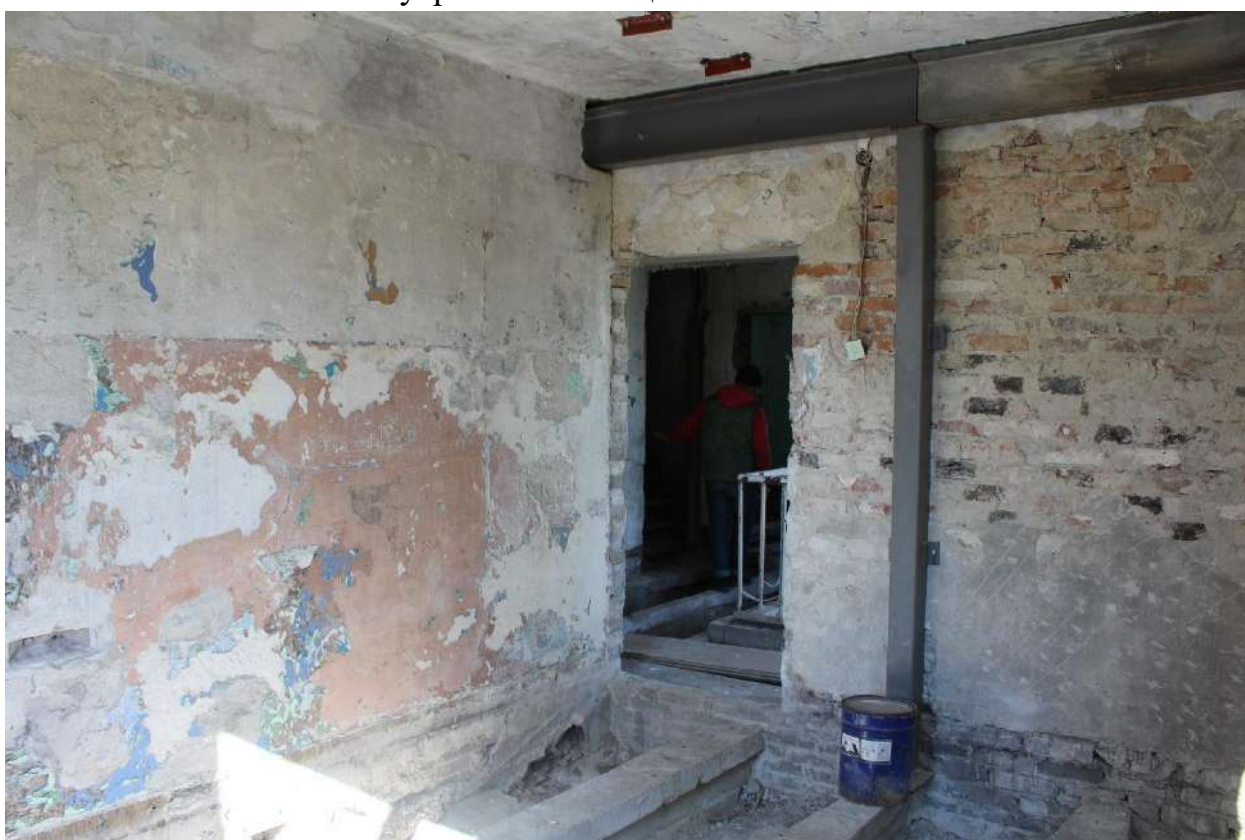
Фото 176. Выявленный объект культурного наследия «Здание школы». Внутренние помещения 2-го этажа.
