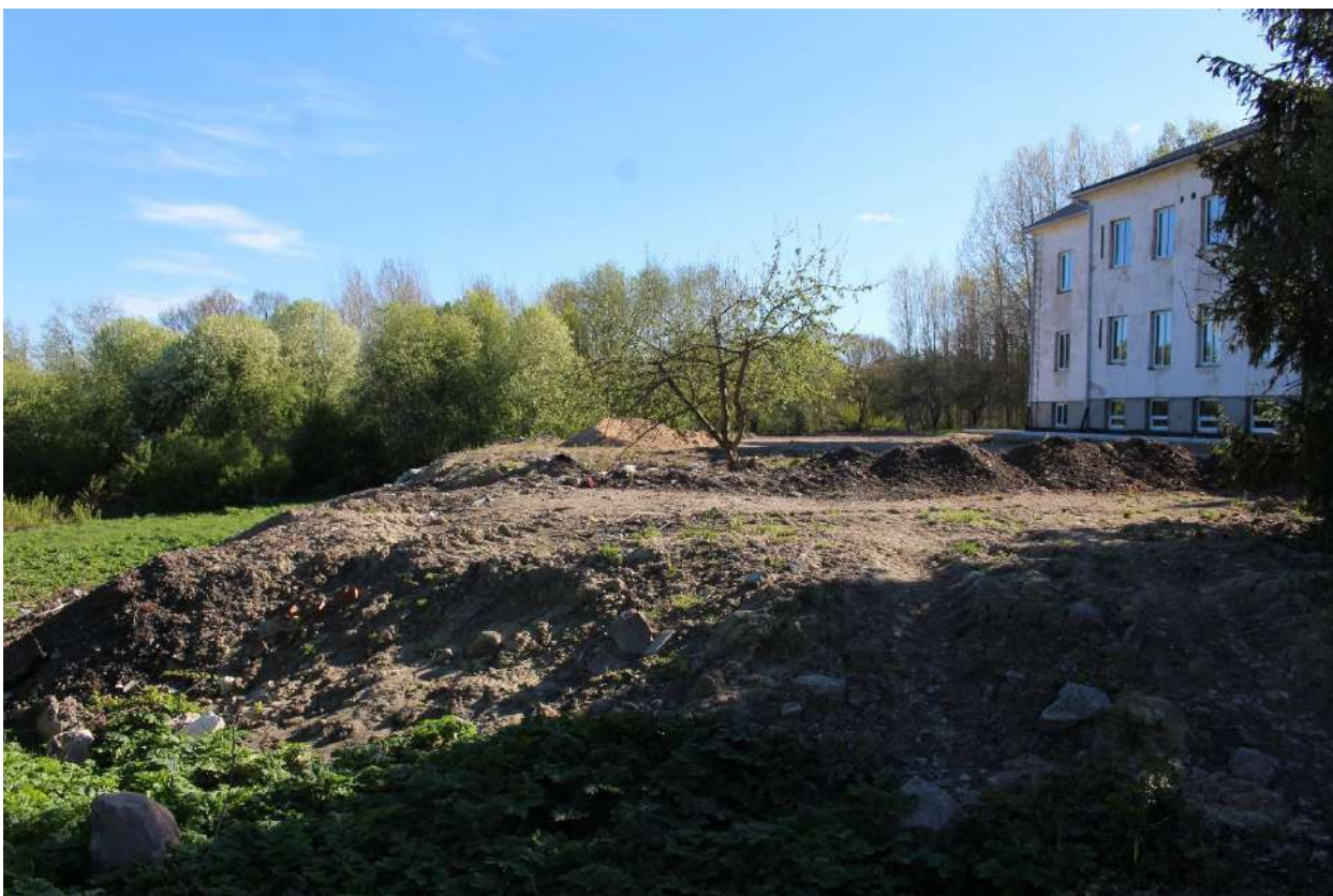
Фото 90. Вид на площадку со стороны восточного фасада выявленного объекта культурного наследия «Здание школы».
