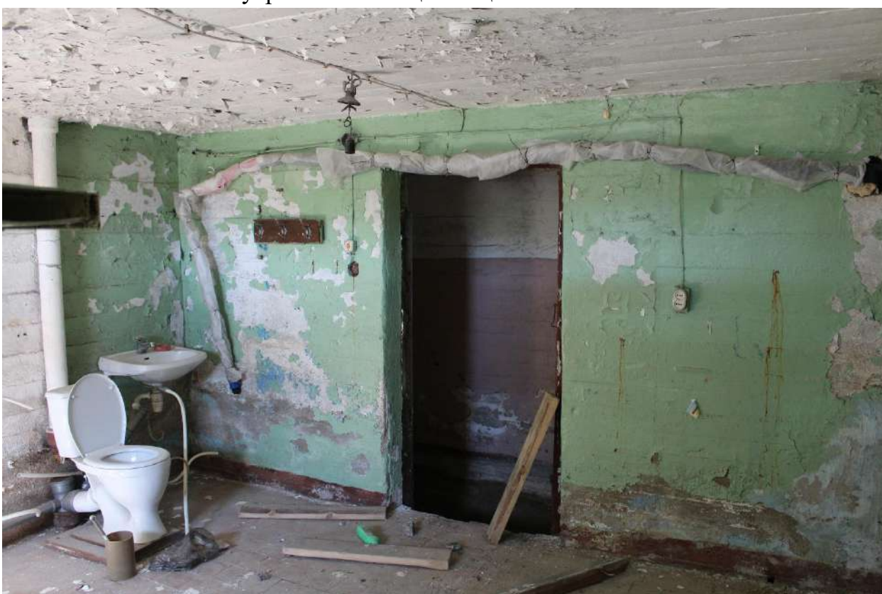
Фото 166. Выявленный объект культурного наследия «Здание школы». Внутренние помещения цокольного этажа.
