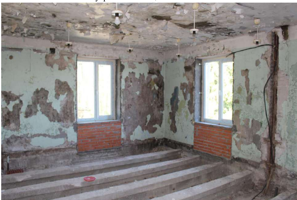
Фото 121. Выявленный объект культурного наследия «Здание школы». Внутренние помещения 1-го этажа.
