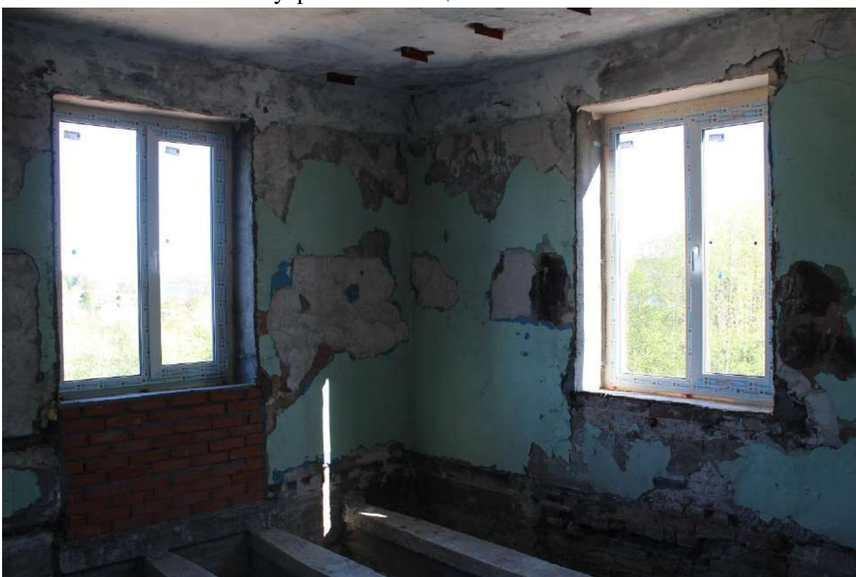
Фото 202. Выявленный объект культурного наследия «Здание школы». Внутренние помещения 2-го этажа.
