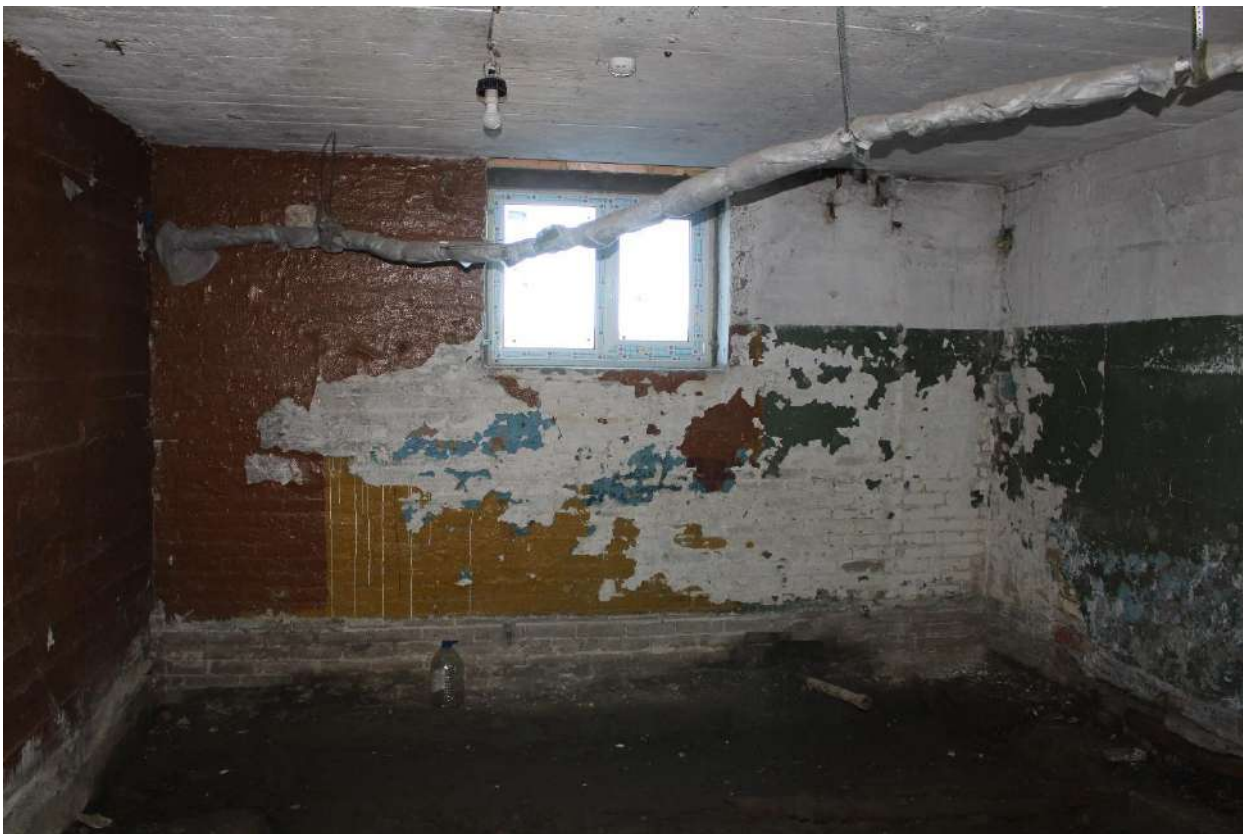
Фото 161. Выявленный объект культурного наследия «Здание школы». Внутренние помещения цокольного этажа.
