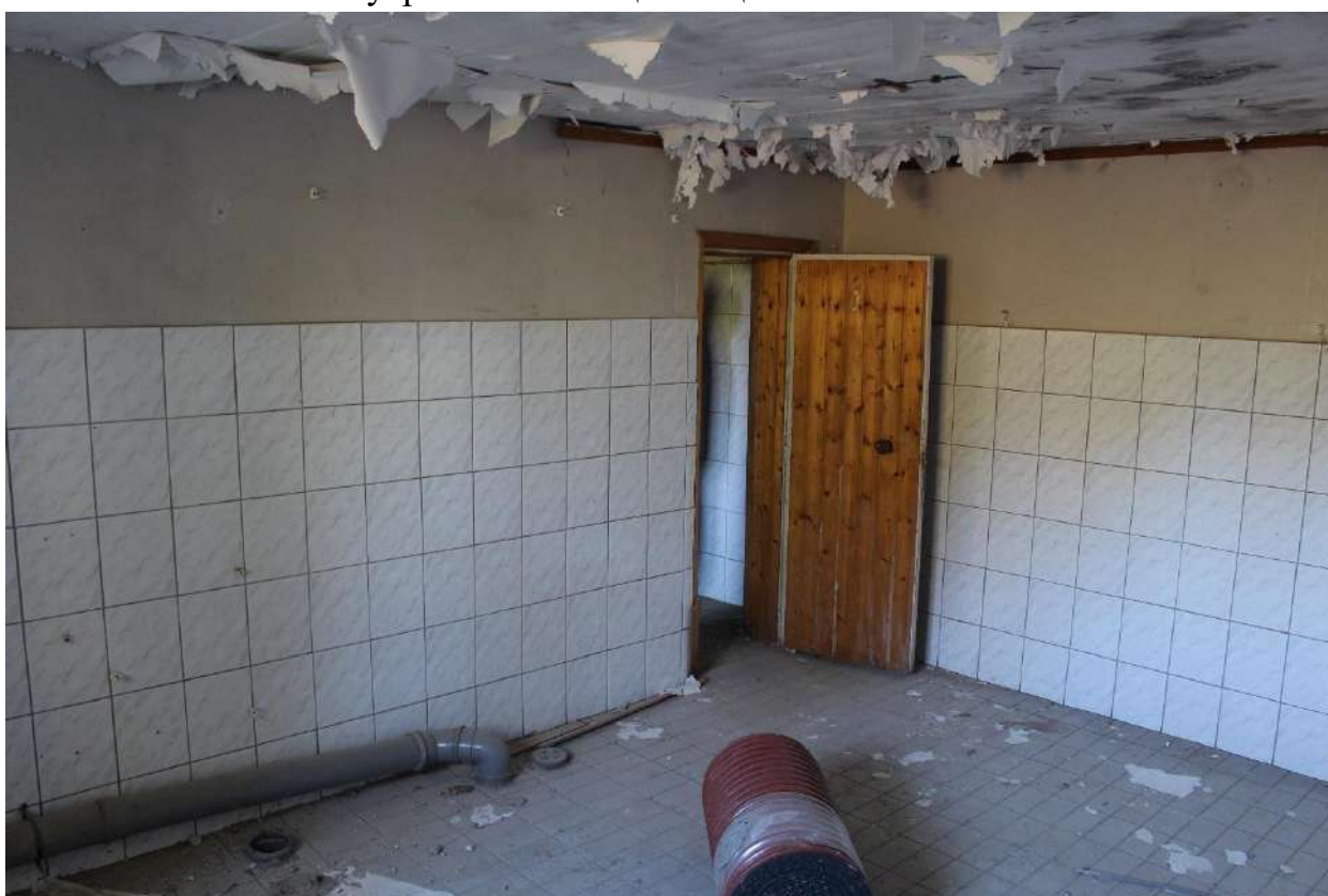
Фото 135. Выявленный объект культурного наследия «Здание школы». Внутренние помещения цокольного этажа.
