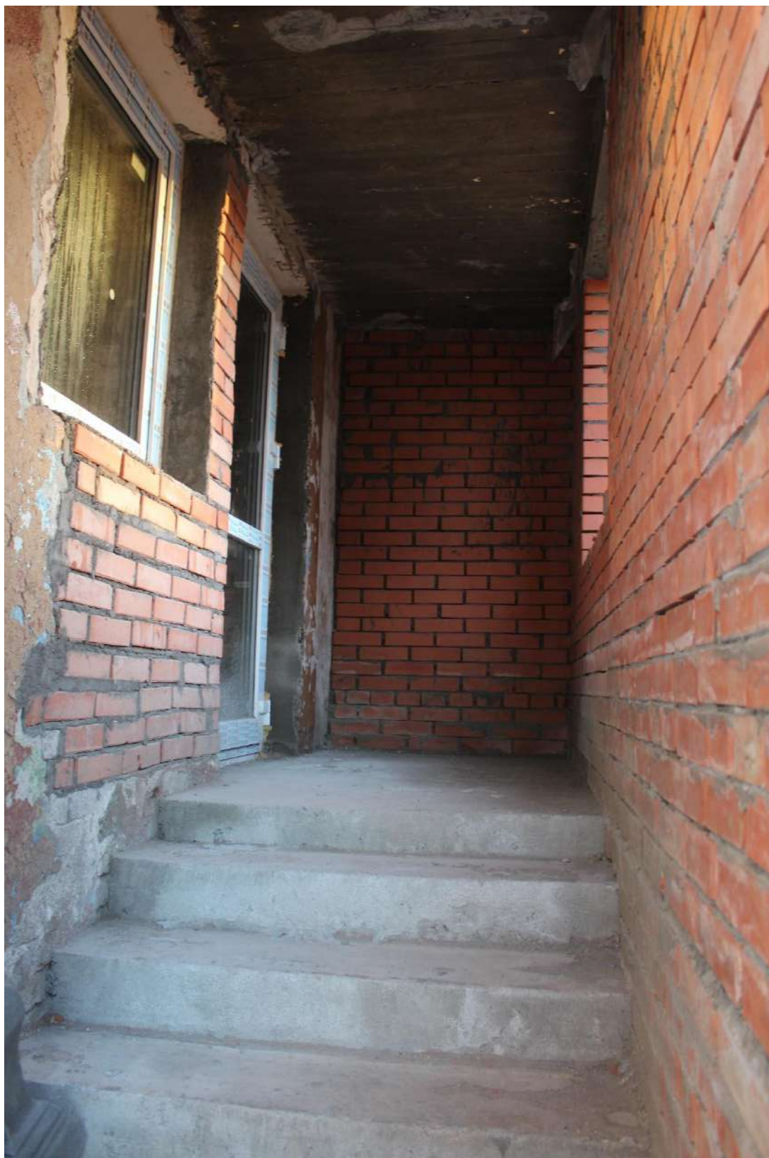
Фото 4. Вид на тамбур южного фасада выявленного объекта культурного наследия «Здание школы».
