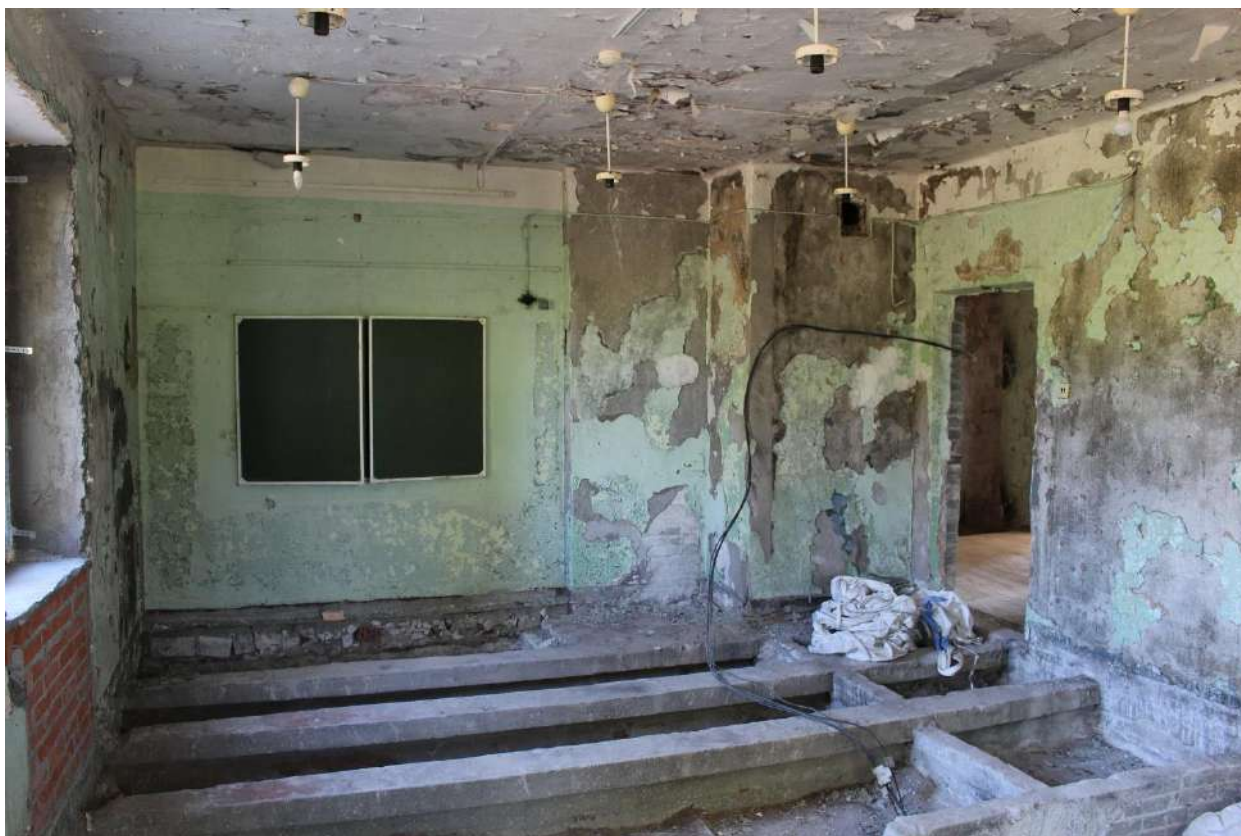
Фото 122. Выявленный объект культурного наследия «Здание школы». Внутренние помещения 1-го этажа.
