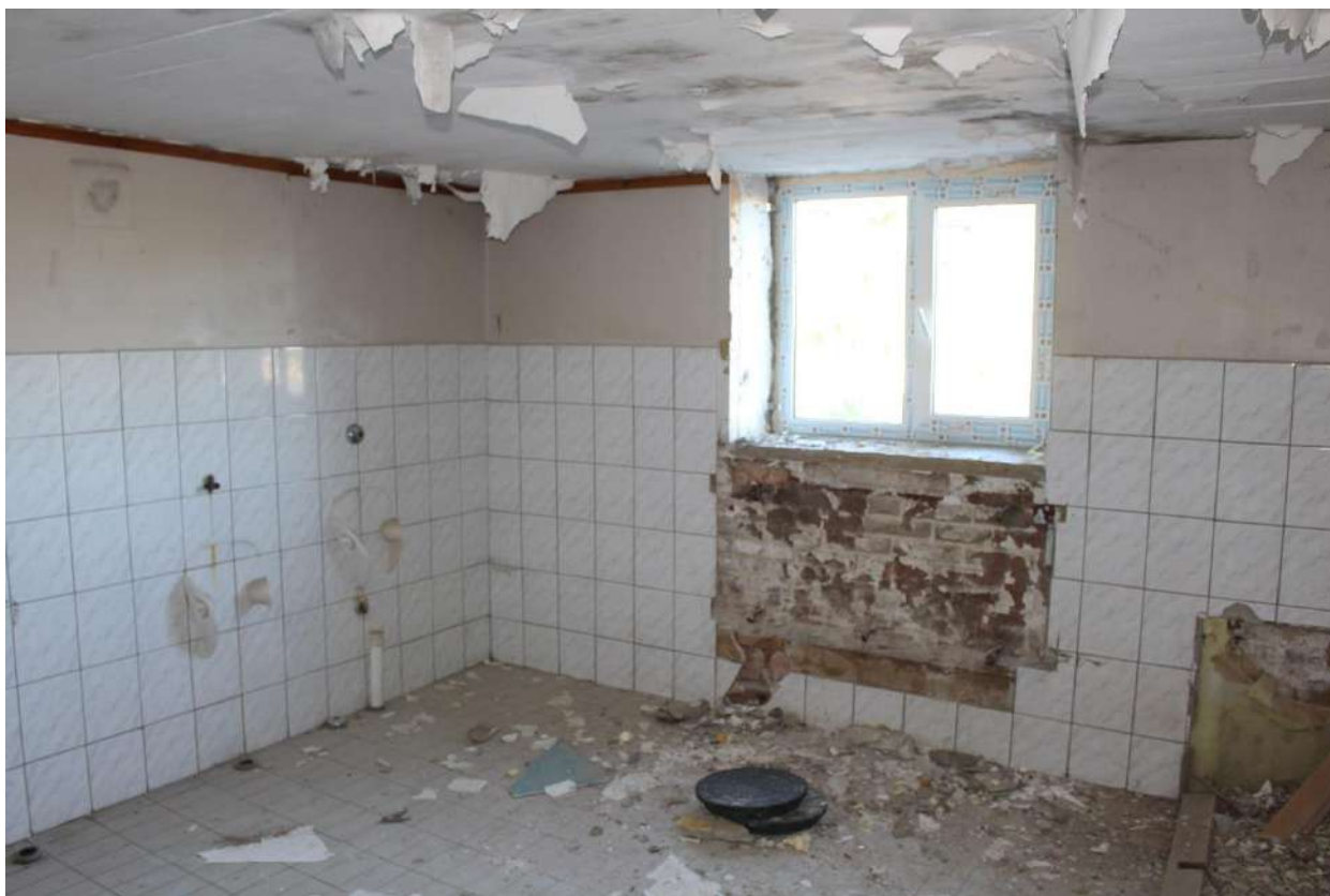
Фото 134. Выявленный объект культурного наследия «Здание школы». Внутренние помещения цокольного этажа.
