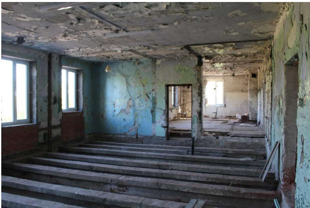
Фото 120. Выявленный объект культурного наследия «Здание школы». Внутренние помещения 1-го этажа.
