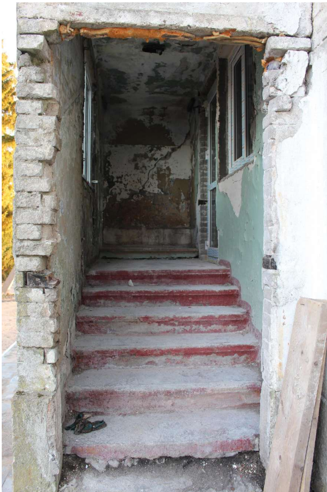
Фото 9. Вид на тамбур северного фасада выявленного объекта культурного наследия «Здание школы».
