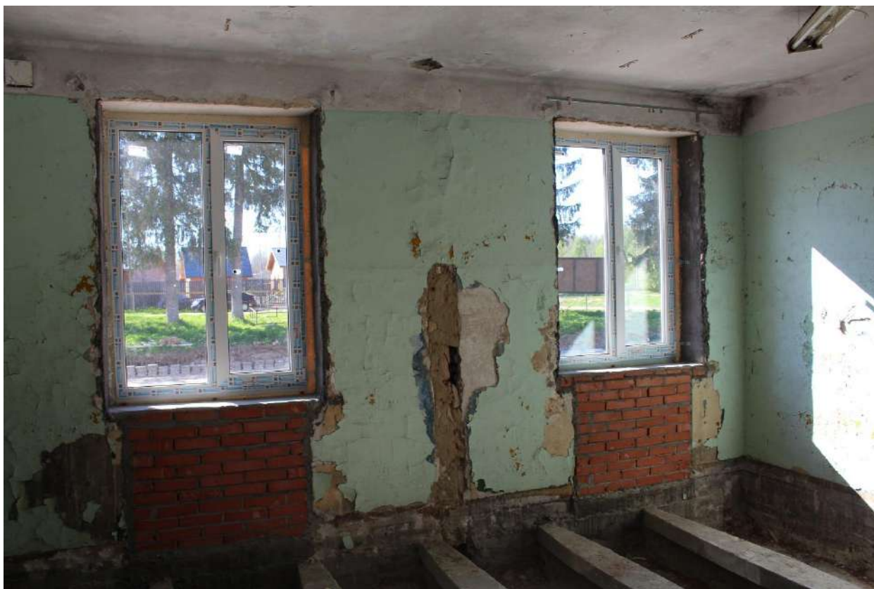
Фото 108. Выявленный объект культурного наследия «Здание школы». Внутренние помещения 1-го этажа.
