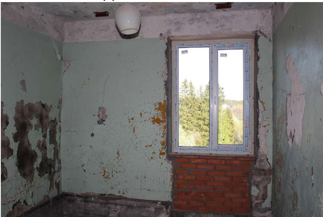
Фото 204. Выявленный объект культурного наследия «Здание школы». Внутренние помещения 2-го этажа.
