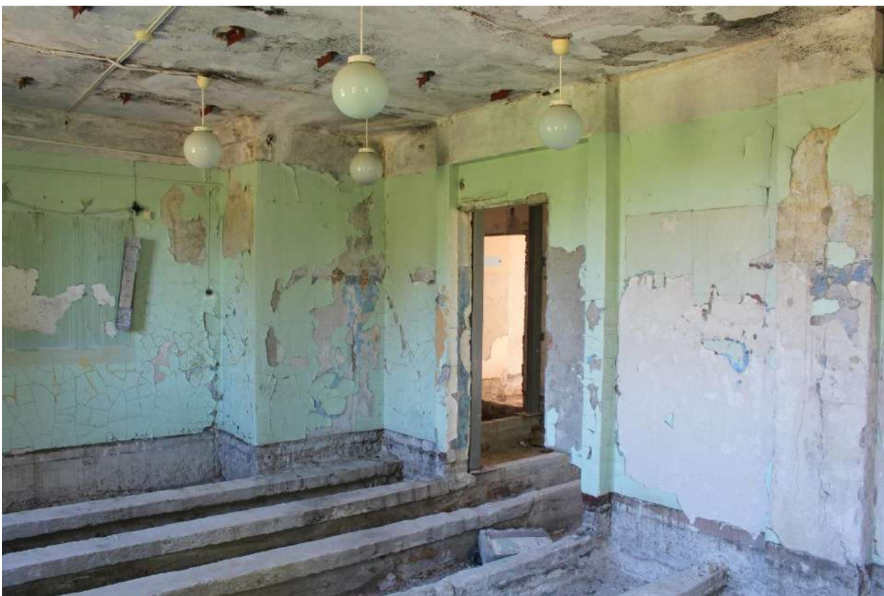
Фото 197. Выявленный объект культурного наследия «Здание школы». Внутренние помещения 2-го этажа.
