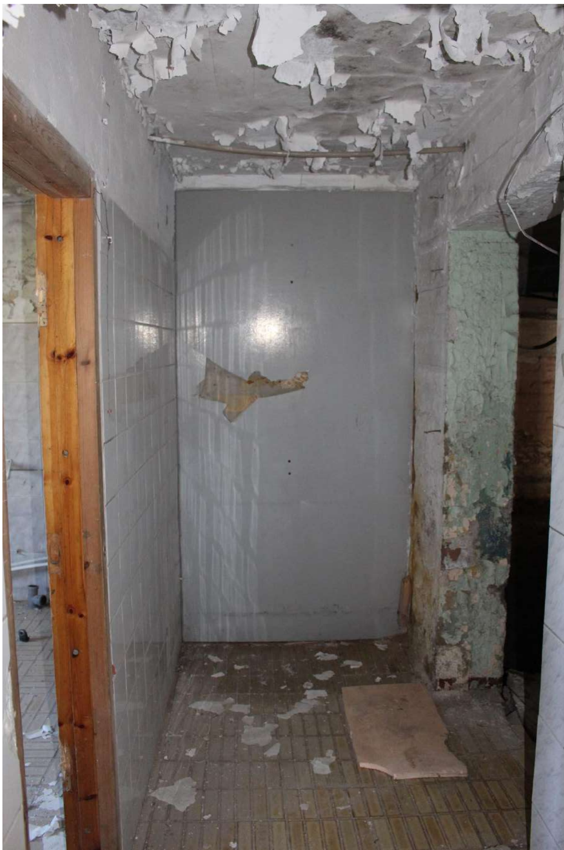
Фото 136. Выявленный объект культурного наследия «Здание школы». Внутренние помещения цокольного этажа.
