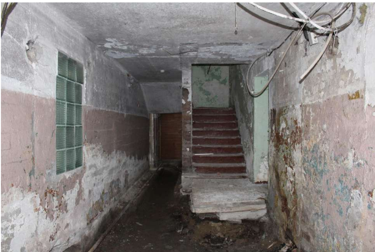
Фото 143. Выявленный объект культурного наследия «Здание школы». Внутренние помещения цокольного этажа.
