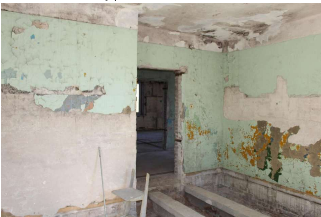
Фото 109. Выявленный объект культурного наследия «Здание школы». Внутренние помещения 1-го этажа.
