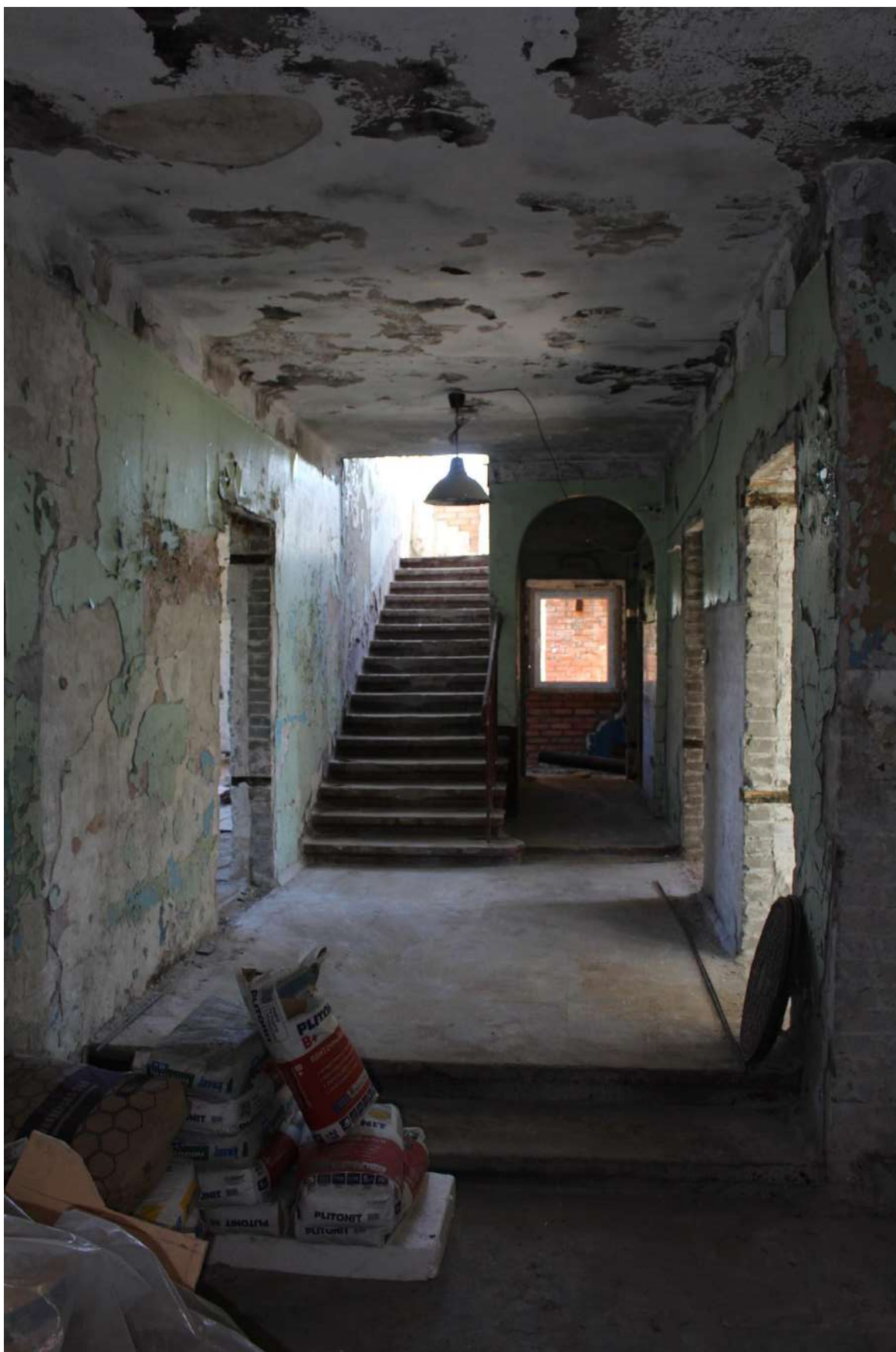
Фото 106. Выявленный объект культурного наследия «Здание школы». Внутренние помещения 1-го этажа.
