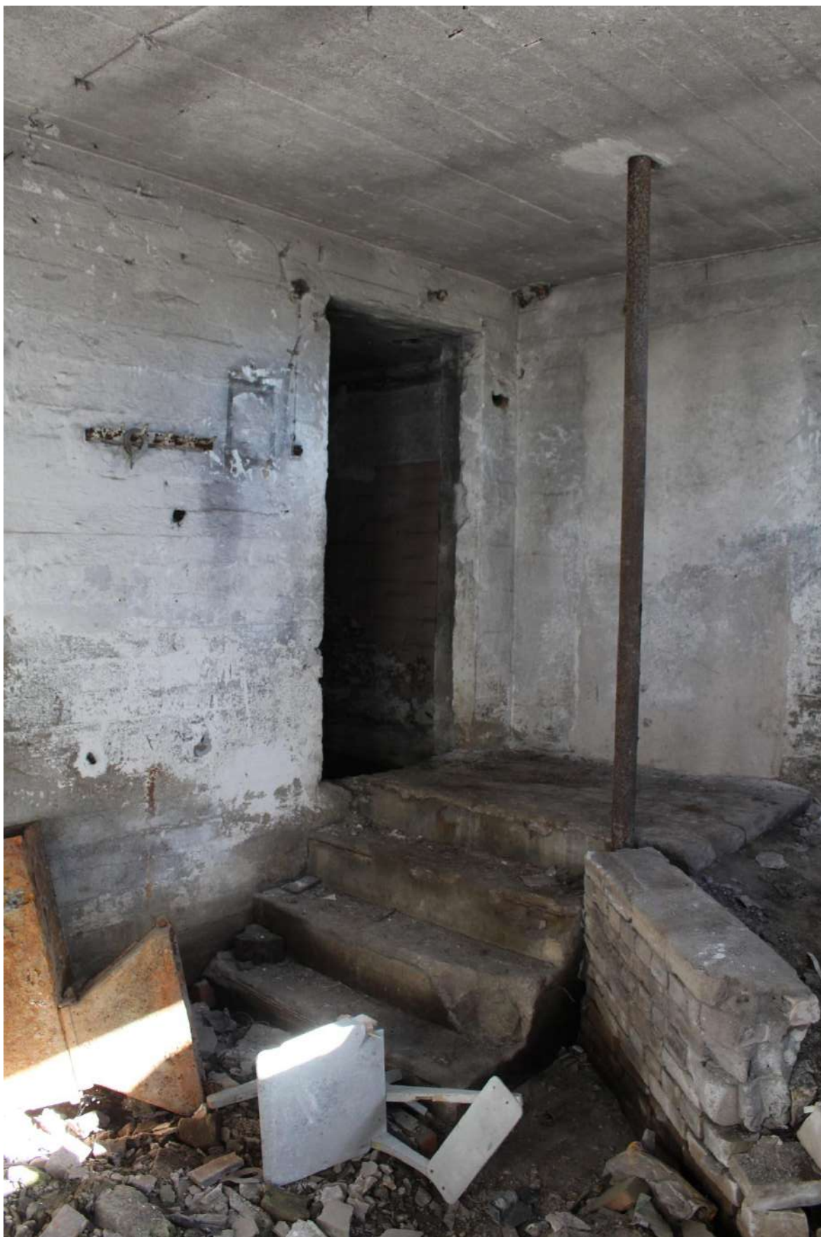
Фото 145. Выявленный объект культурного наследия «Здание школы». Внутренние помещения цокольного этажа.
