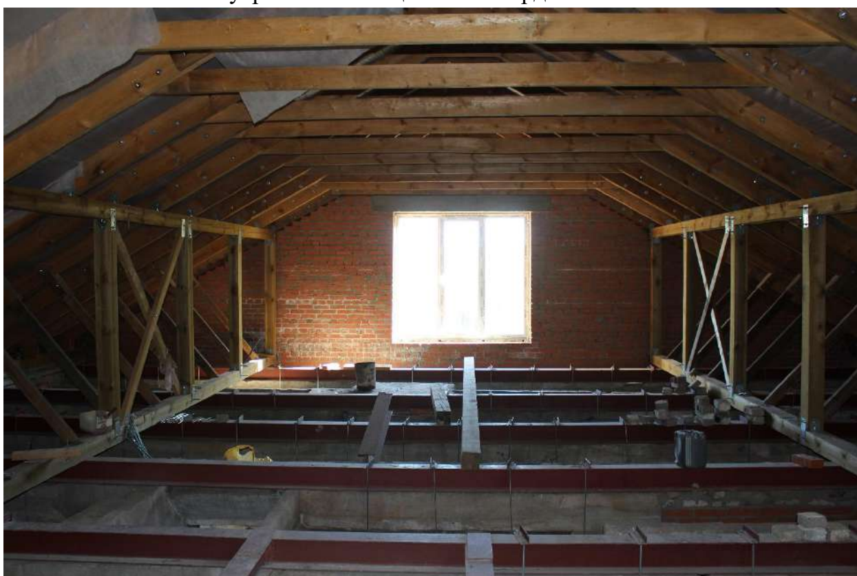
Фото 208. Выявленный объект культурного наследия «Здание школы». Внутренние помещения мансардного этажа.
