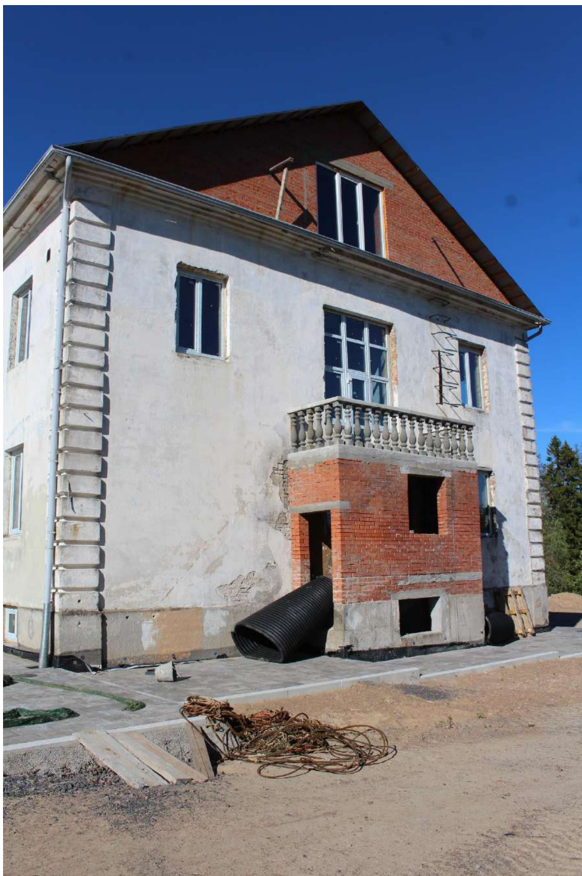
Фото 78. Вид на южный фасад выявленного объекта культурного наследия «Здание школы».
