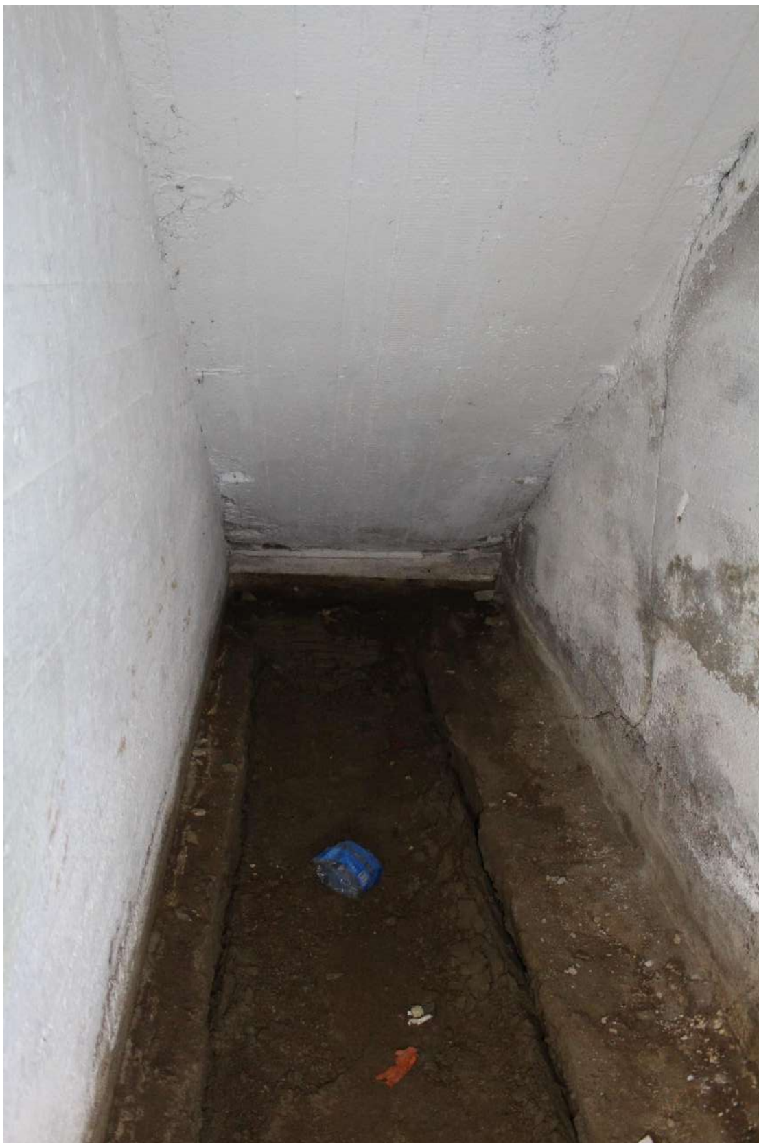
Фото 167. Выявленный объект культурного наследия «Здание школы». Внутренние помещения цокольного этажа.
