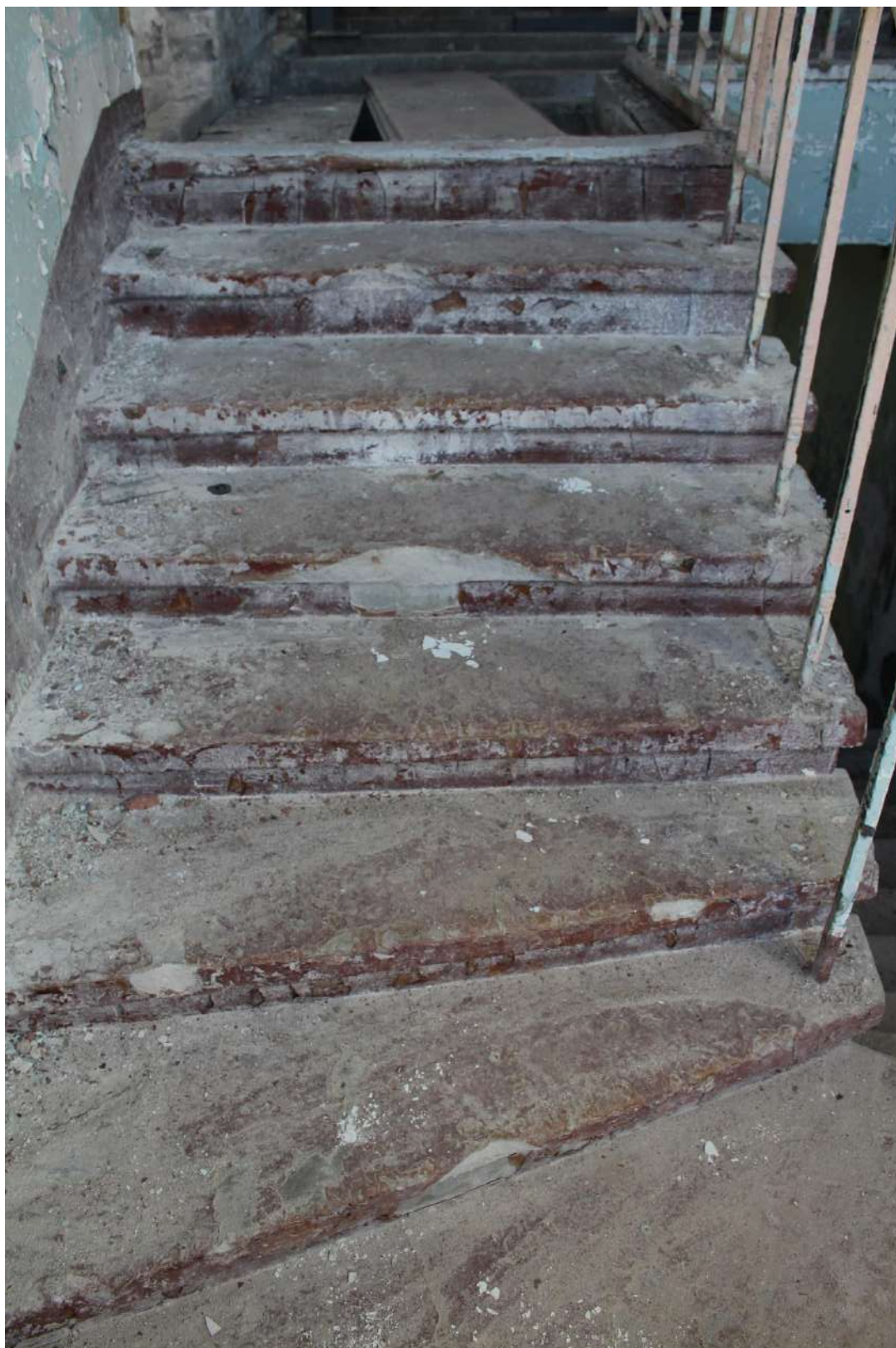
Фото 172. Выявленный объект культурного наследия «Здание школы». Вид на южную лестницу в уровне 1-го – 2-го этажей.
