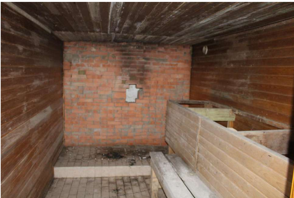
Фото 154. Выявленный объект культурного наследия «Здание школы». Внутренние помещения цокольного этажа.
