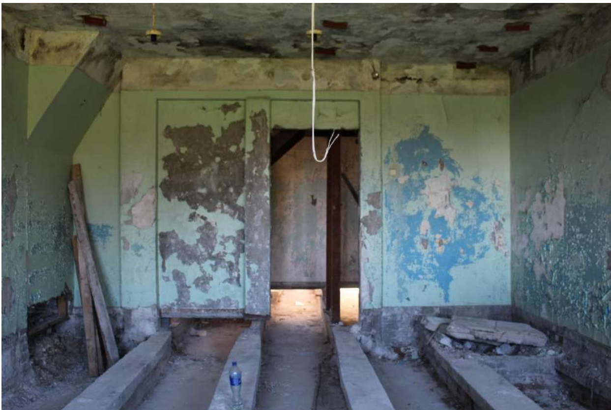
Фото 201. Выявленный объект культурного наследия «Здание школы». Внутренние помещения 2-го этажа.
