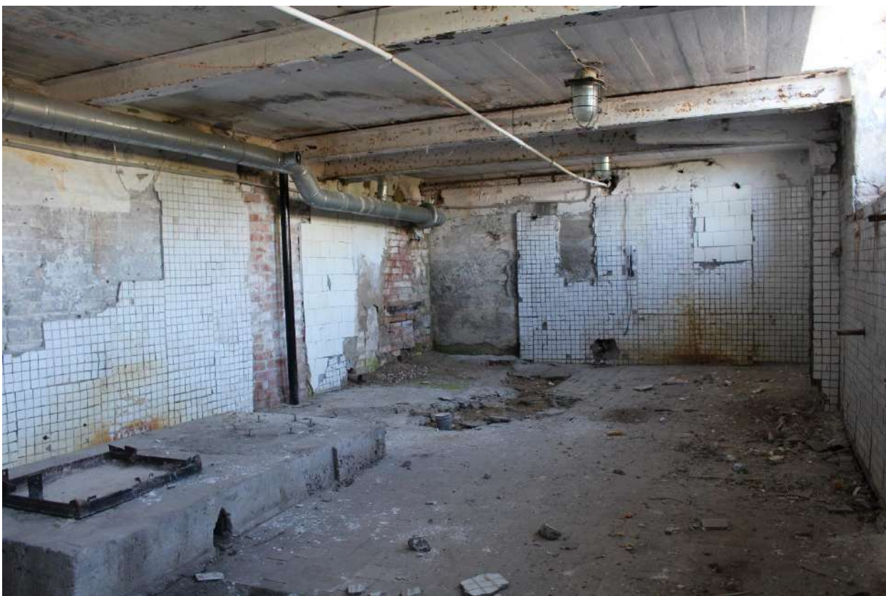
Фото 159. Выявленный объект культурного наследия «Здание школы». Внутренние помещения цокольного этажа.
