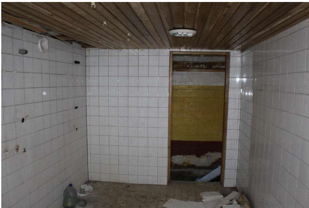
Фото 156. Выявленный объект культурного наследия «Здание школы». Внутренние помещения цокольного этажа.
