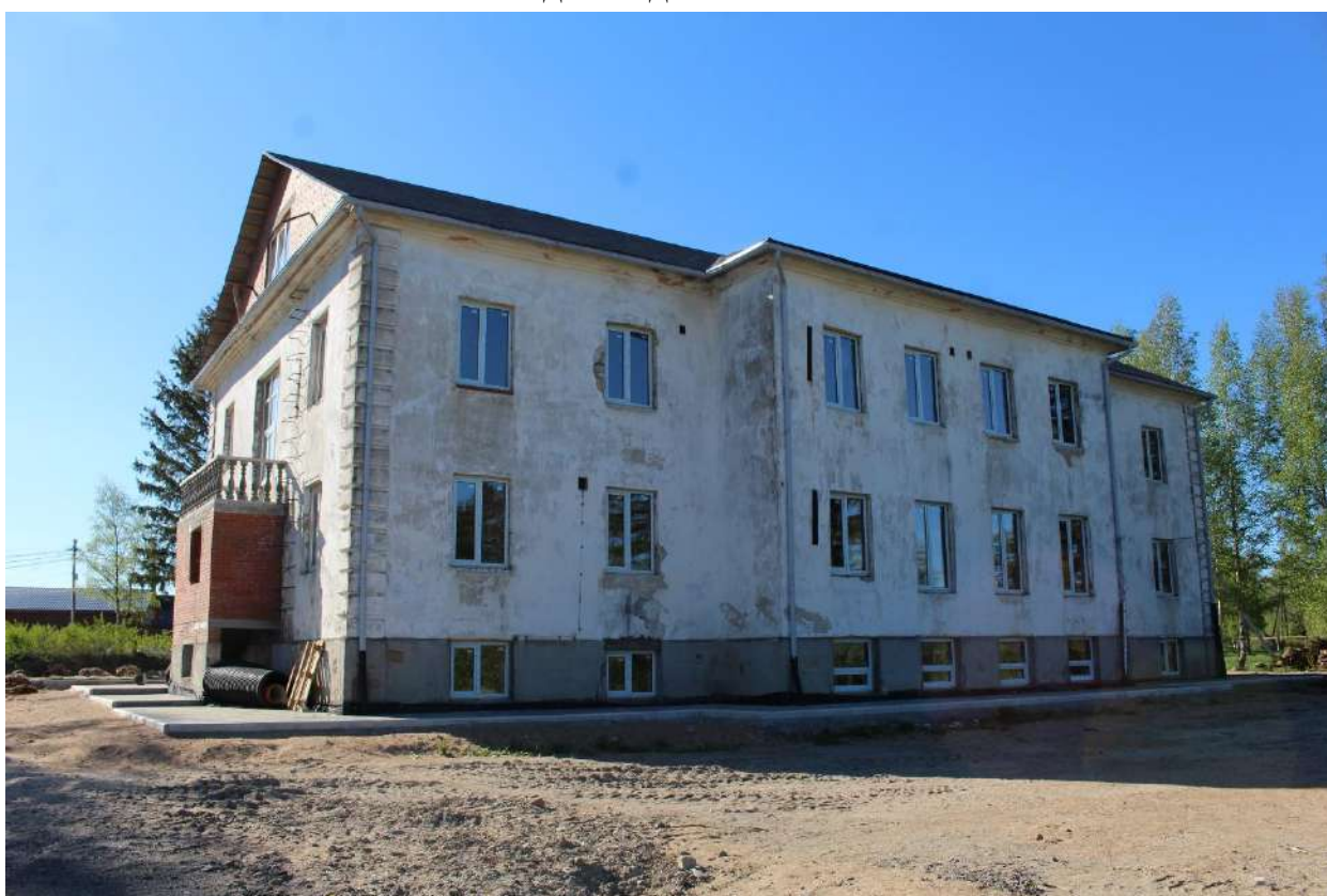
Фото 81. Вид на восточный фасад выявленного объекта культурного наследия «Здание школы».
