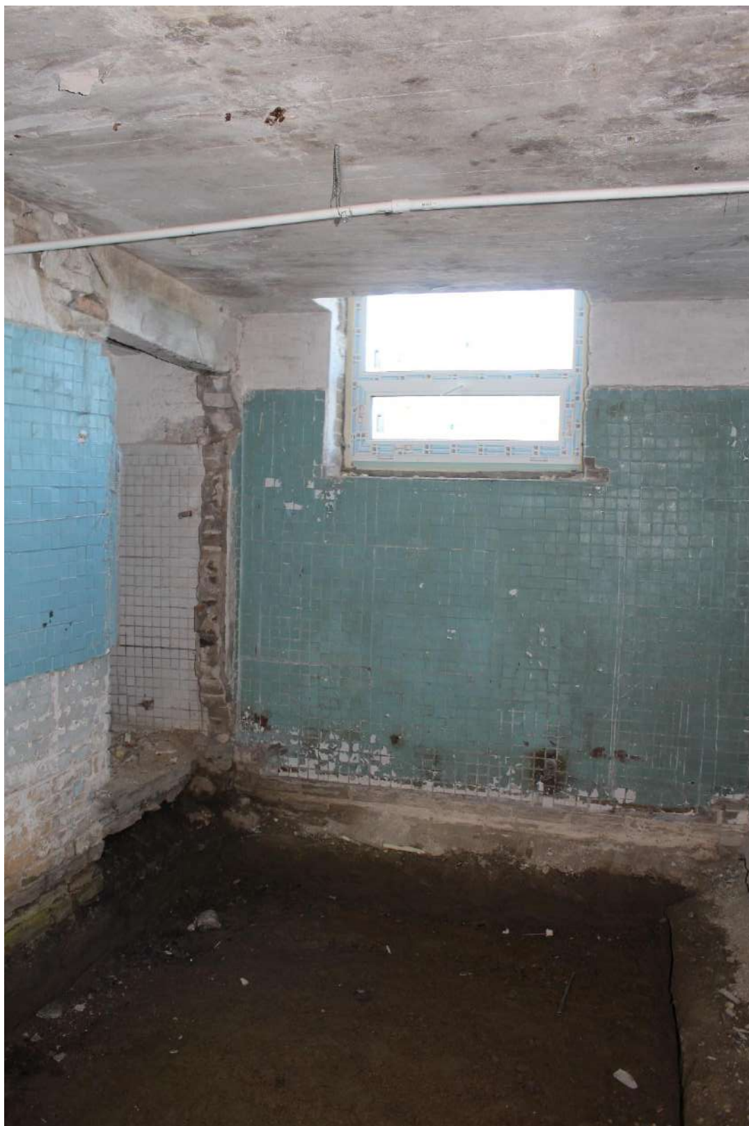
Фото 157. Выявленный объект культурного наследия «Здание школы». Внутренние помещения цокольного этажа.
