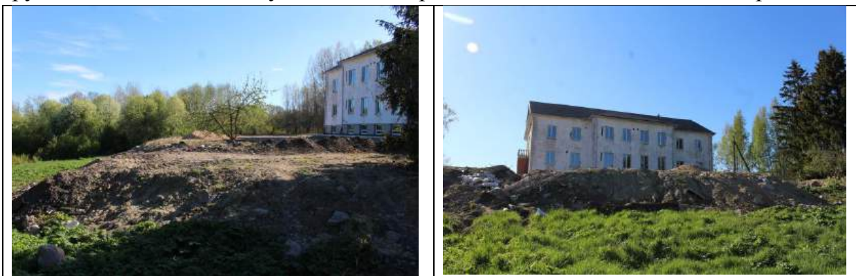
Вид на насыпную площадку по восточной границы участка 47:03:0807001:94 к востоку от здания. Фото от 14.05.2026 г.
