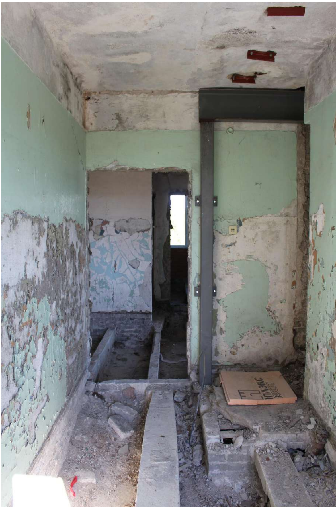
Фото 178. Выявленный объект культурного наследия «Здание школы». Внутренние помещения 2-го этажа.
