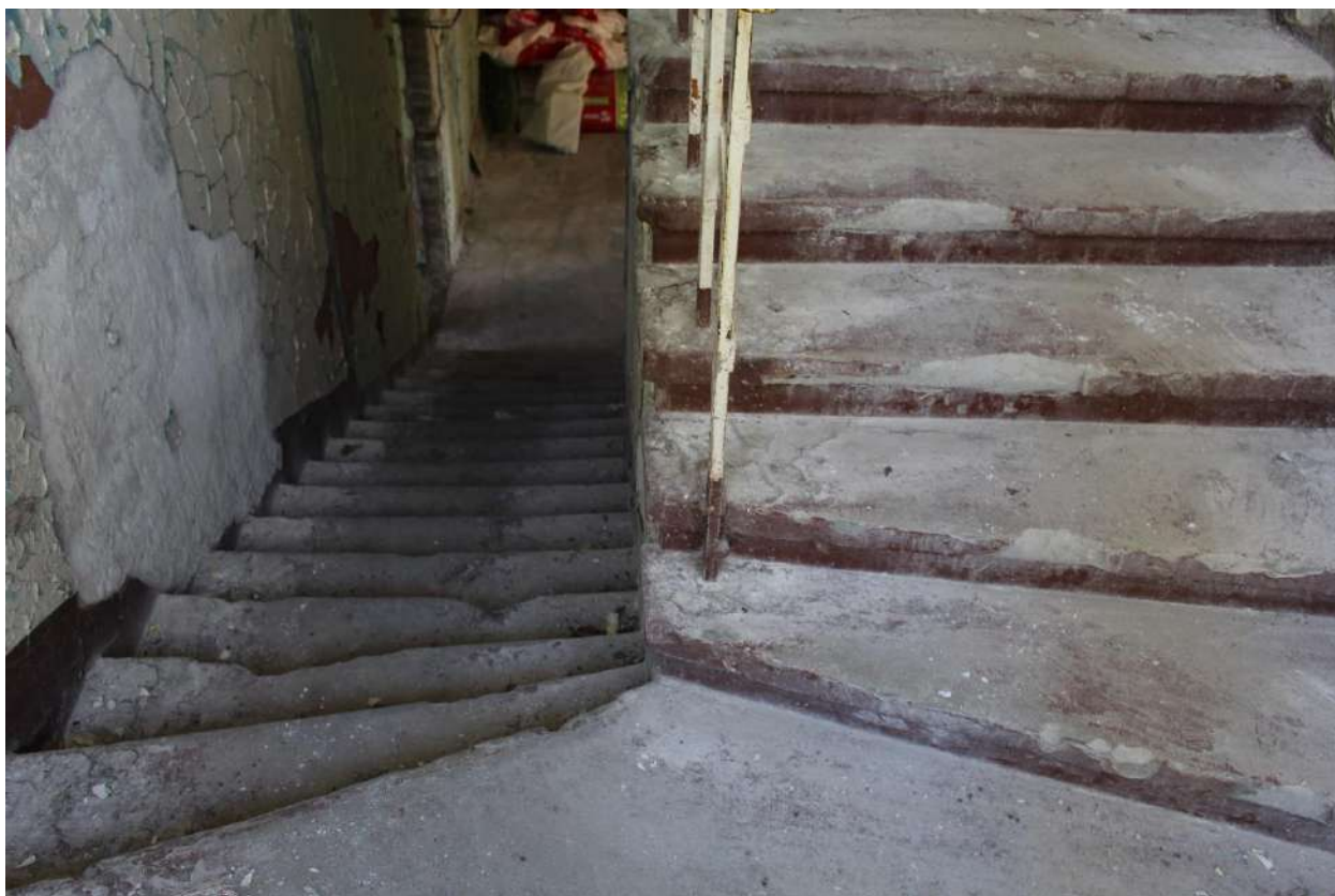
Фото 195. Выявленный объект культурного наследия «Здание школы». Вид на северную лестницу в уровне 1-го - 2-го этажей.
