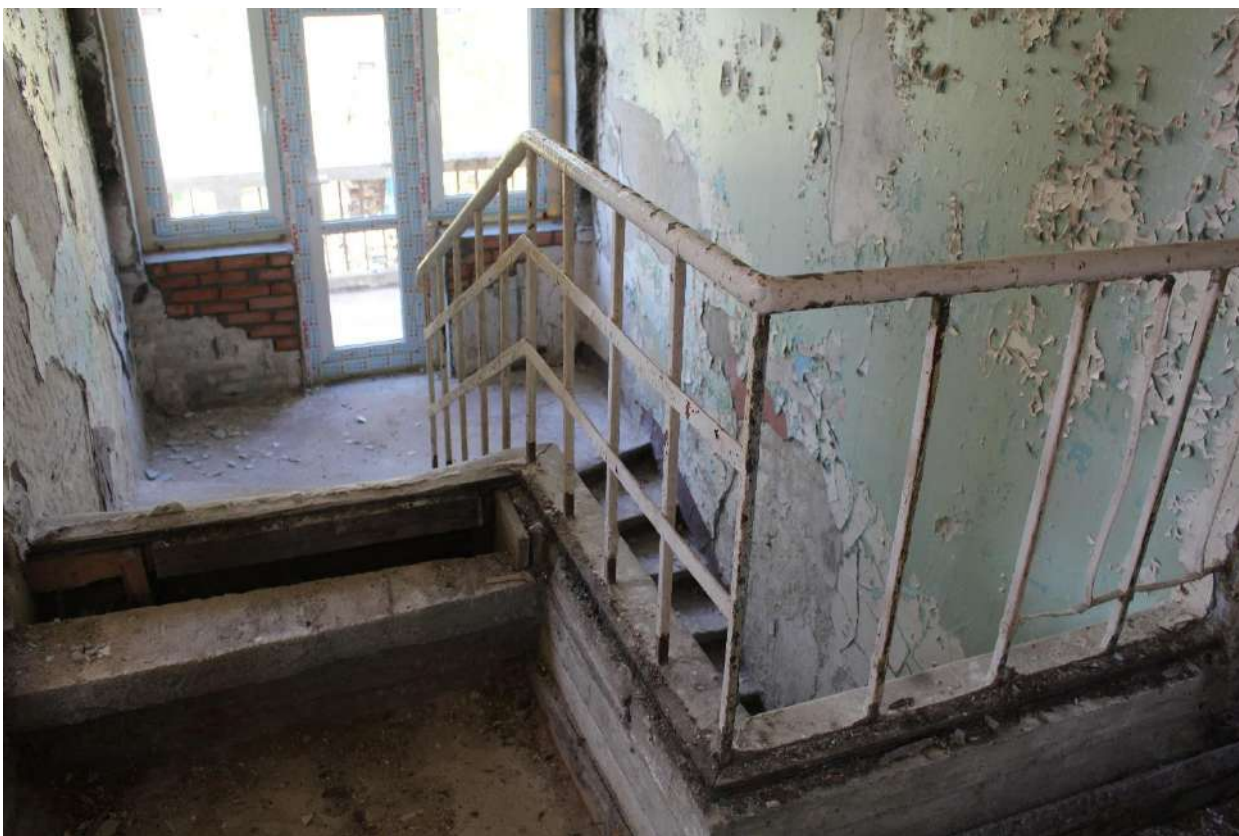
Фото 191. Выявленный объект культурного наследия «Здание школы». Вид на северную лестницу в уровне 2-го этажа.
