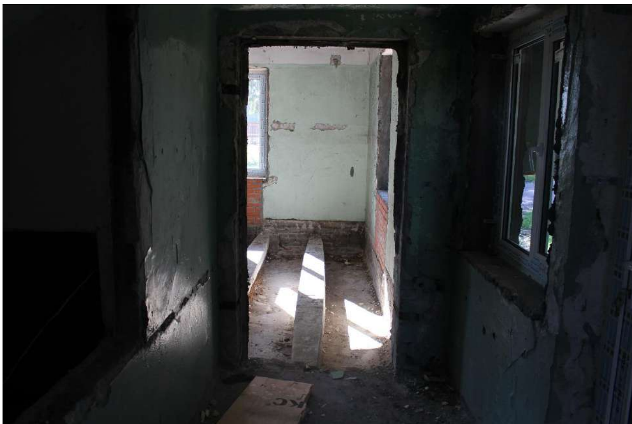
Фото 124. Выявленный объект культурного наследия «Здание школы». Внутренние помещения 1-го этажа.
