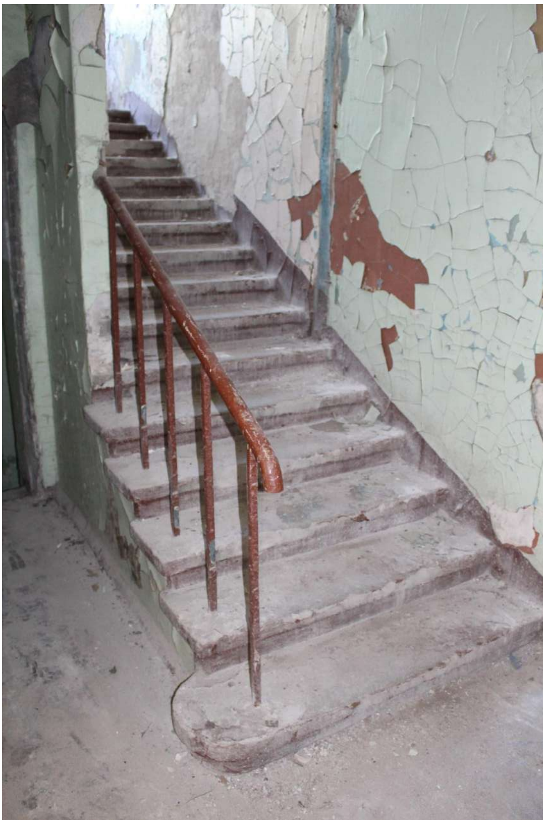
Фото 129. Выявленный объект культурного наследия «Здание школы». Внутренние помещения 1-го этажа. Вид на северную лестницу в уровне 1-го этажа.
