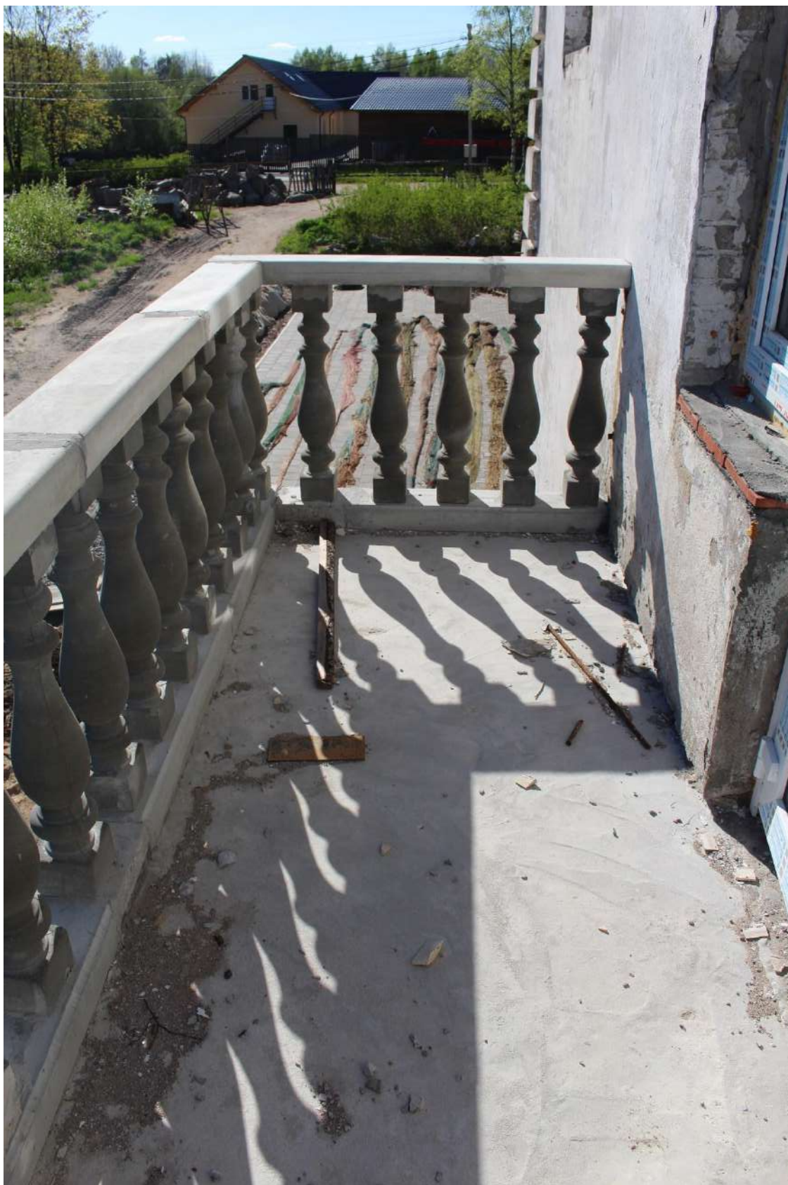
Фото 170. Выявленный объект культурного наследия «Здание школы». Вид на южный балкон.
