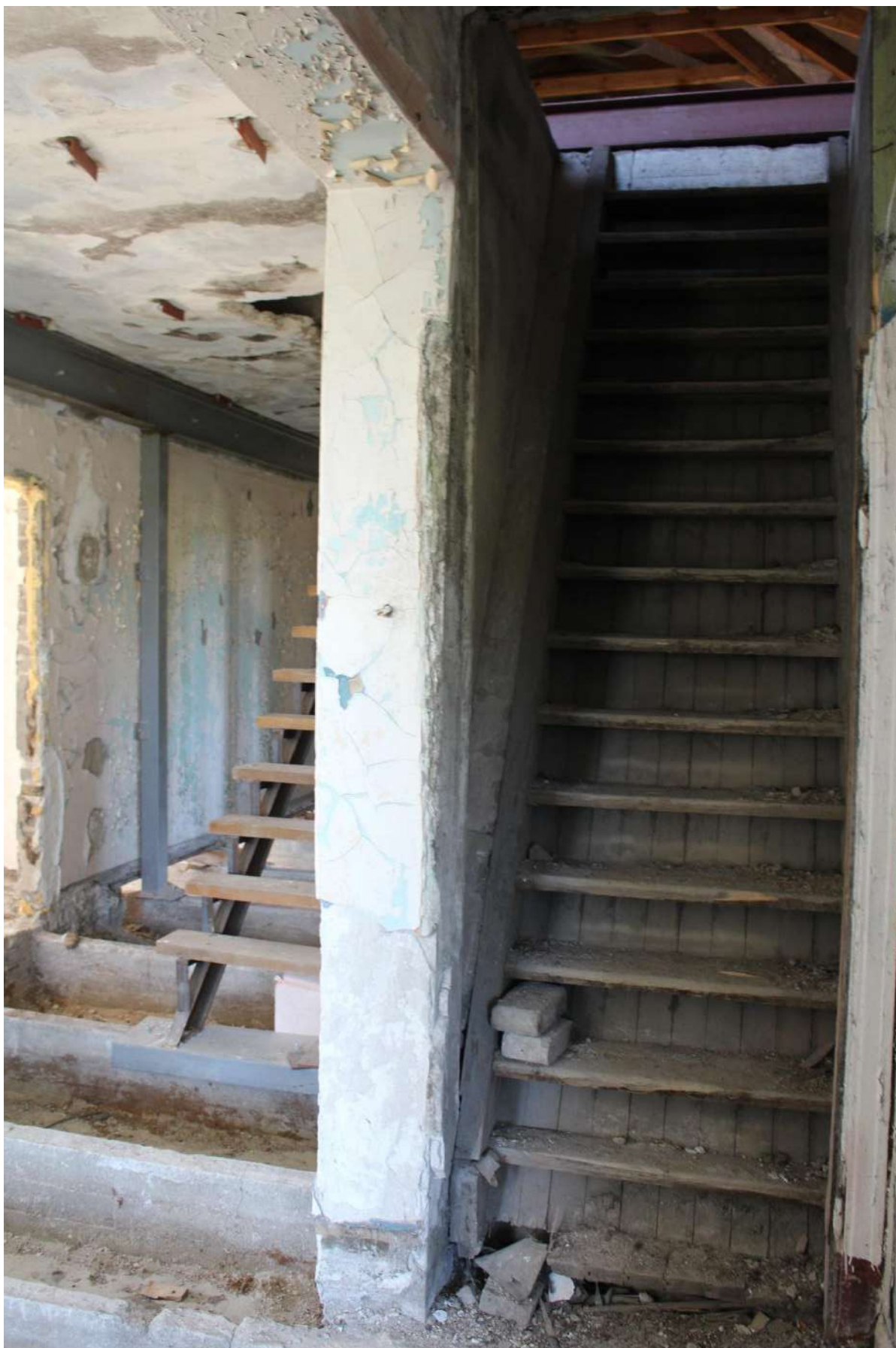
Фото 206. Выявленный объект культурного наследия «Здание школы». Внутренние помещения 2-го этажа.
