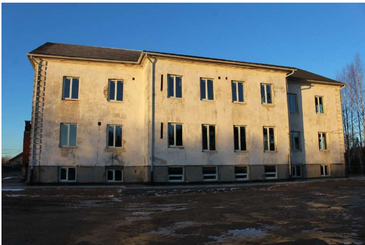
Фото 6. Вид на восточный фасад выявленного объекта культурного наследия «Здание школы».
