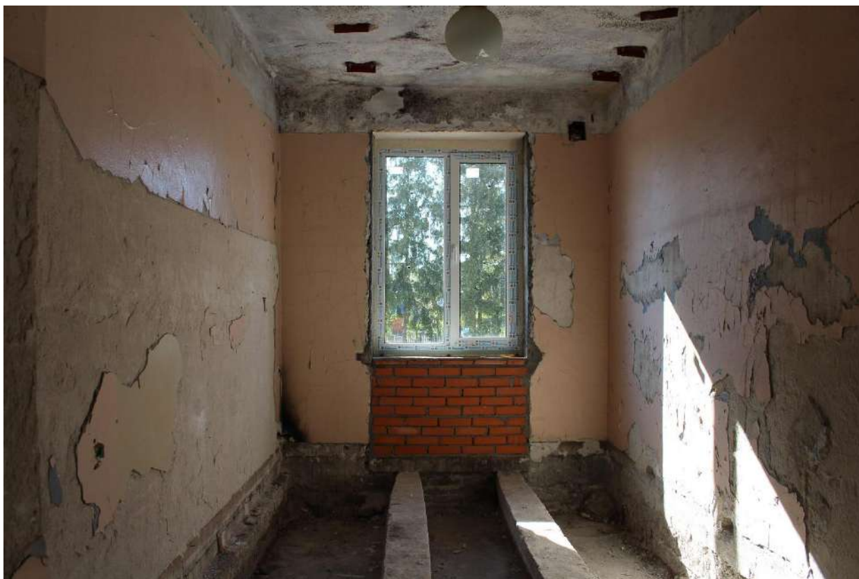
Фото 185. Выявленный объект культурного наследия «Здание школы». Внутренние помещения 2-го этажа.
