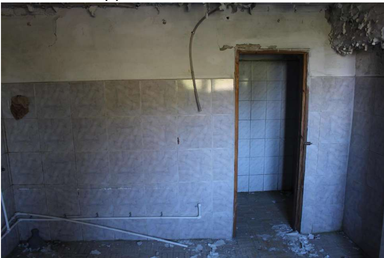
Фото 138. Выявленный объект культурного наследия «Здание школы». Внутренние помещения цокольного этажа.
