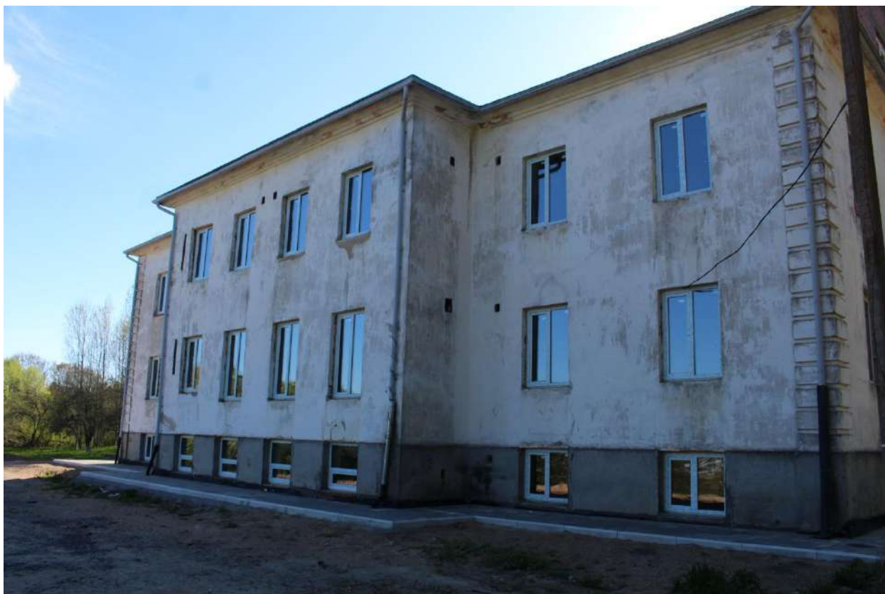
Фото 82. Вид на восточный фасад выявленного объекта культурного наследия «Здание школы».
