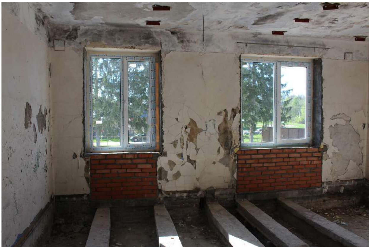
Фото 179. Выявленный объект культурного наследия «Здание школы». Внутренние помещения 2-го этажа.
