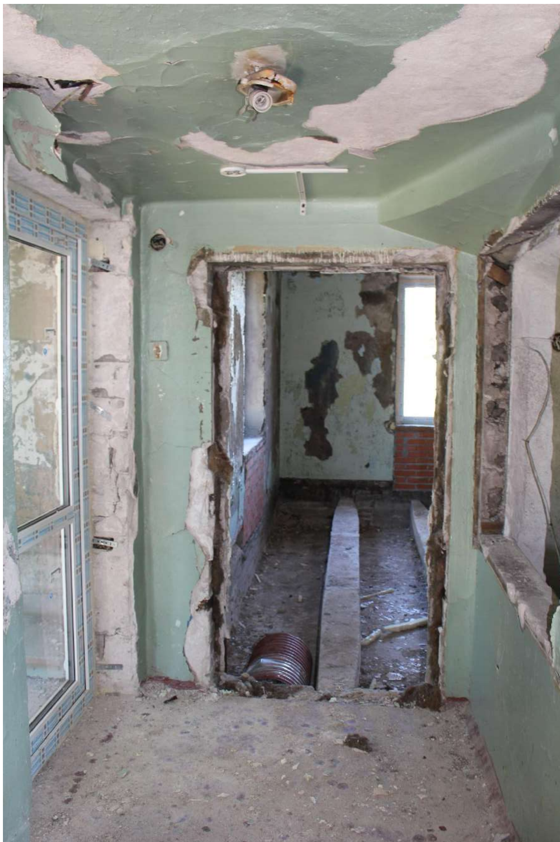
Фото 125. Выявленный объект культурного наследия «Здание школы». Внутренние помещения 1-го этажа.
