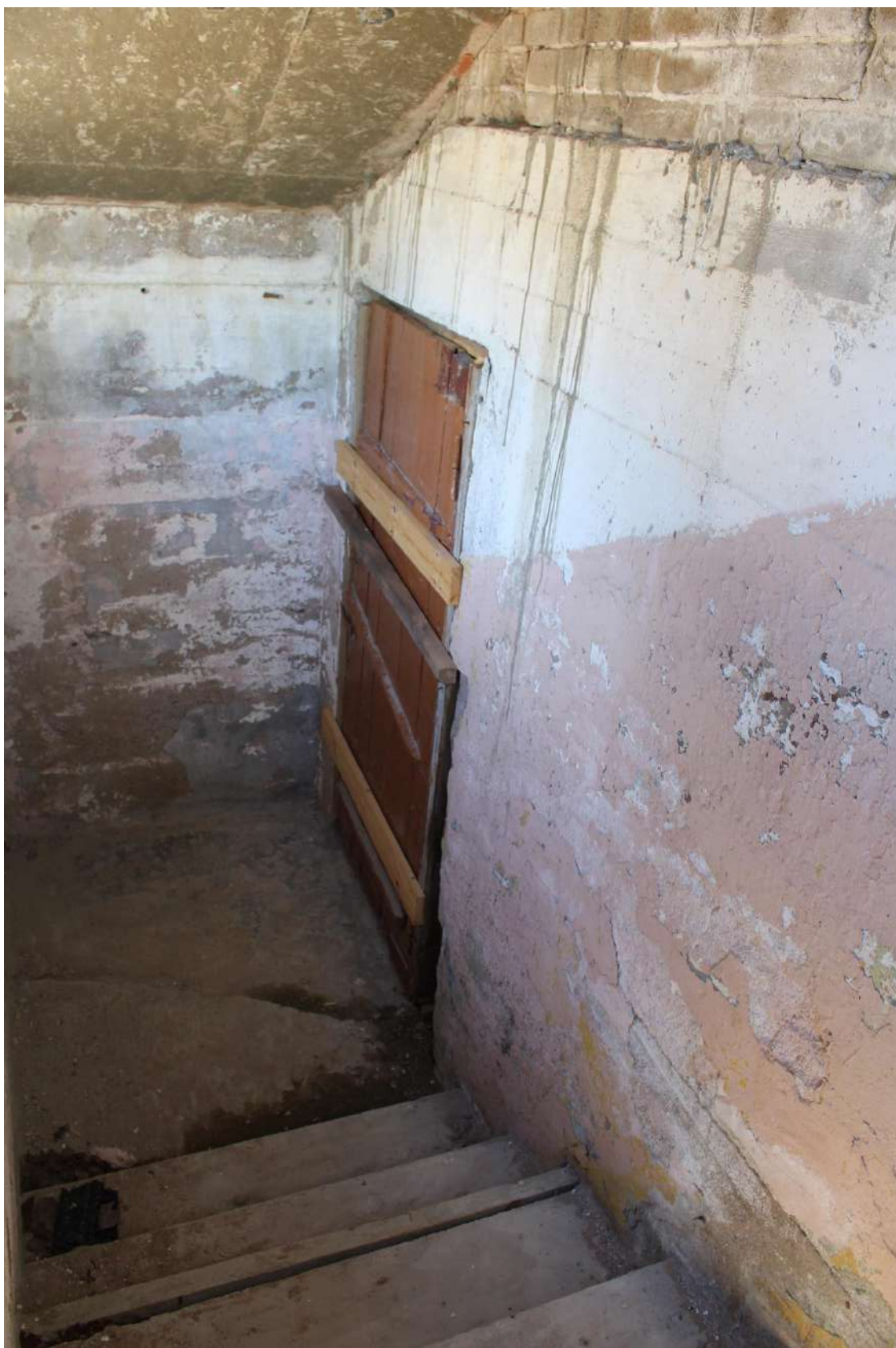
Фото 79. Вид на тамбур южного фасада выявленного объекта культурного наследия «Здание школы».
