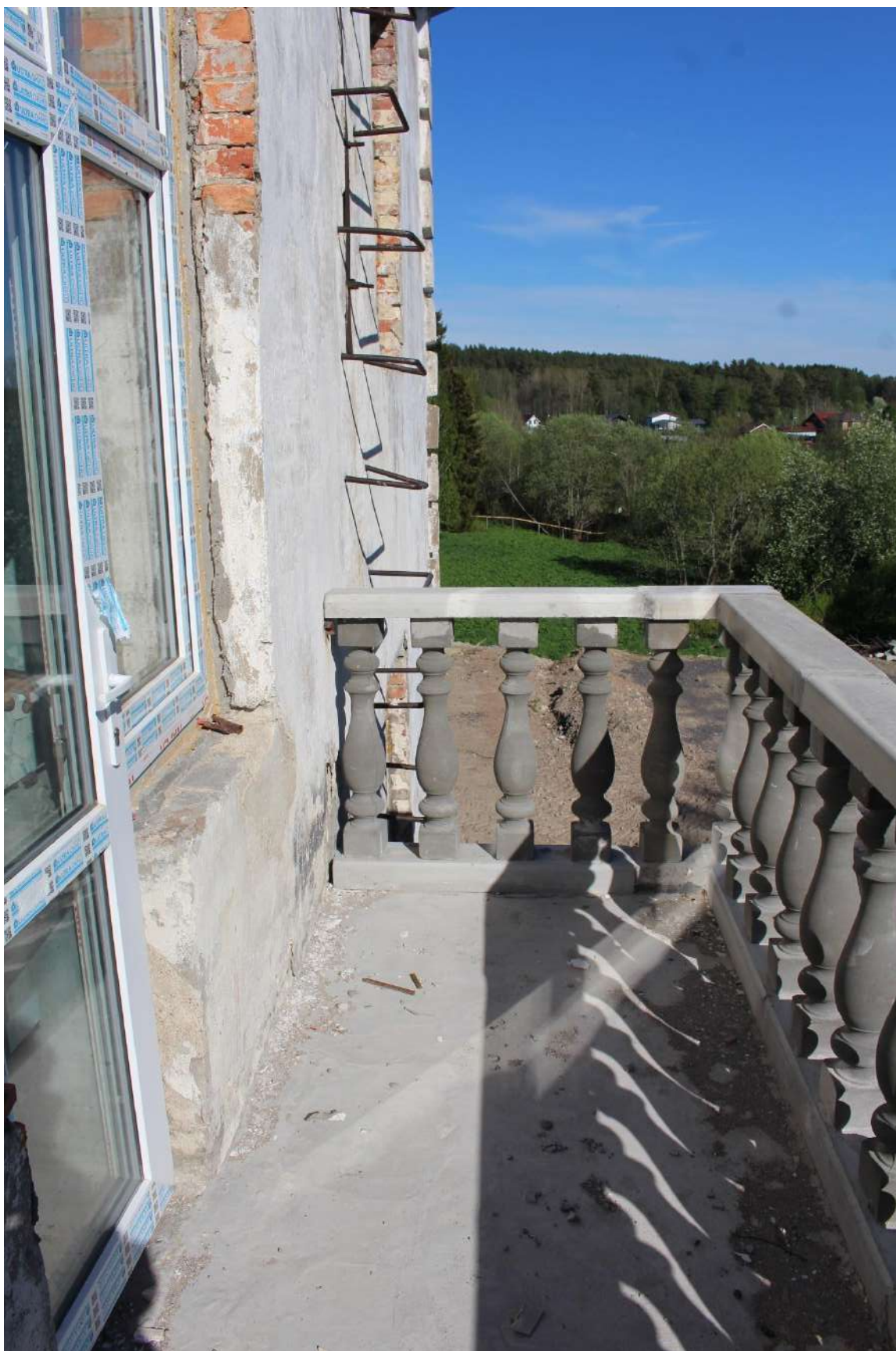
Фото 171. Выявленный объект культурного наследия «Здание школы». Вид на южный балкон.
