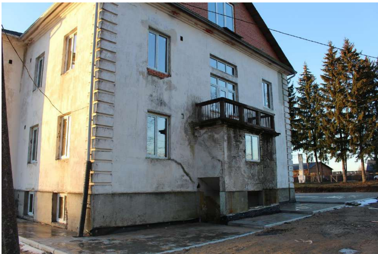
Фото 7. Вид на северный фасад выявленного объекта культурного наследия «Здание школы».
