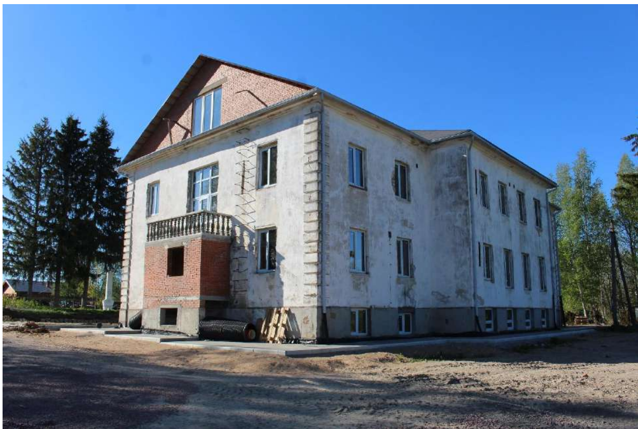
Фото 80. Вид на южный и восточный фасады выявленного объекта культурного наследия «Здание школы».
