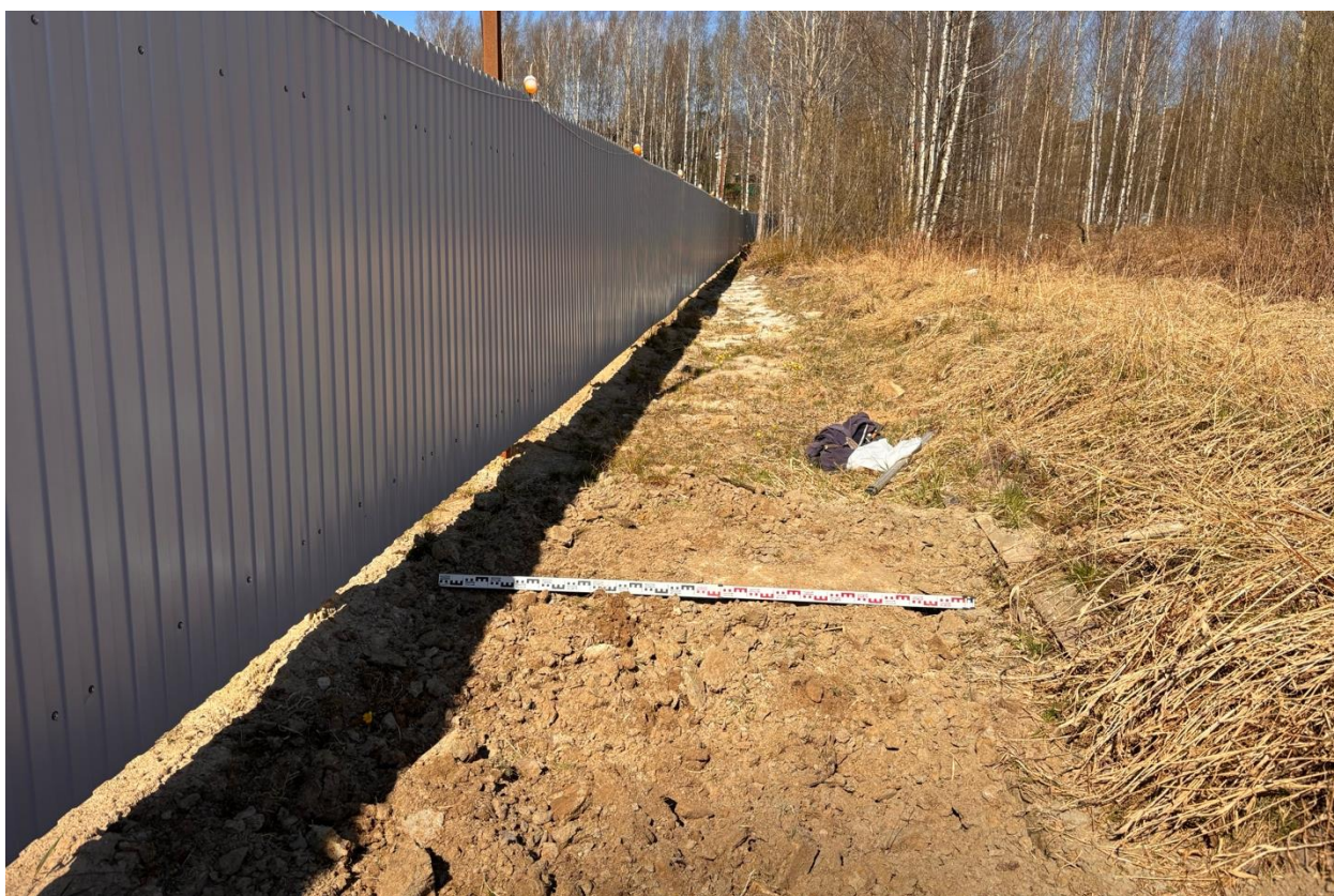
Рис. 40. ЛО-2026. Всеволожский район, дер. Порошкино. Шурф № 5. Общий вид после рекультивации. Вид с юга.
