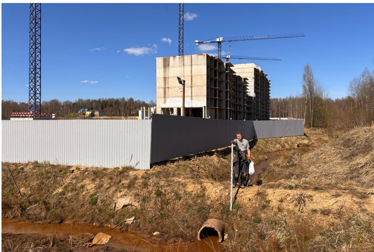
Рис. 18. ЛО-2026. Всеволожский район, дер. Порошкино. Общий вид обследуемого участка. Точка фотофиксации №7. Вид с юга.
