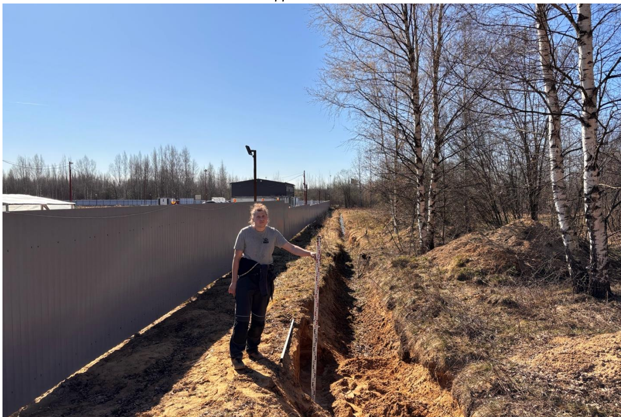
Рис. 11. ЛО-2026. Всеволожский район, дер. Порошкино. Общий вид обследуемого участка. Точка фотофиксации №2. Вид с севера.
