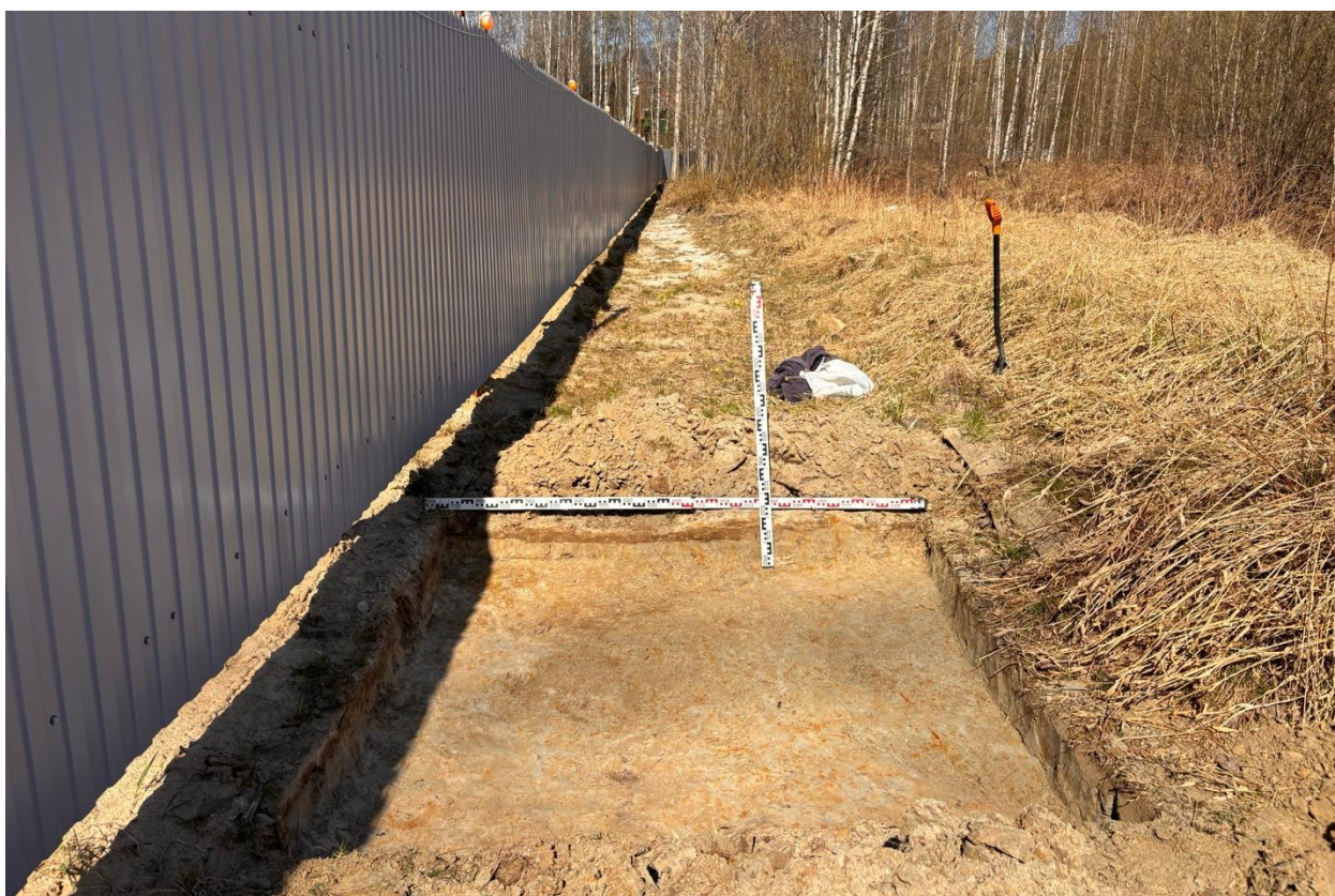
Рис. 38. ЛО-2026. Всеволожский район, дер. Порошкино. Шурф № 5. Общий вид выкопанного шурфа. Вид с юга.
