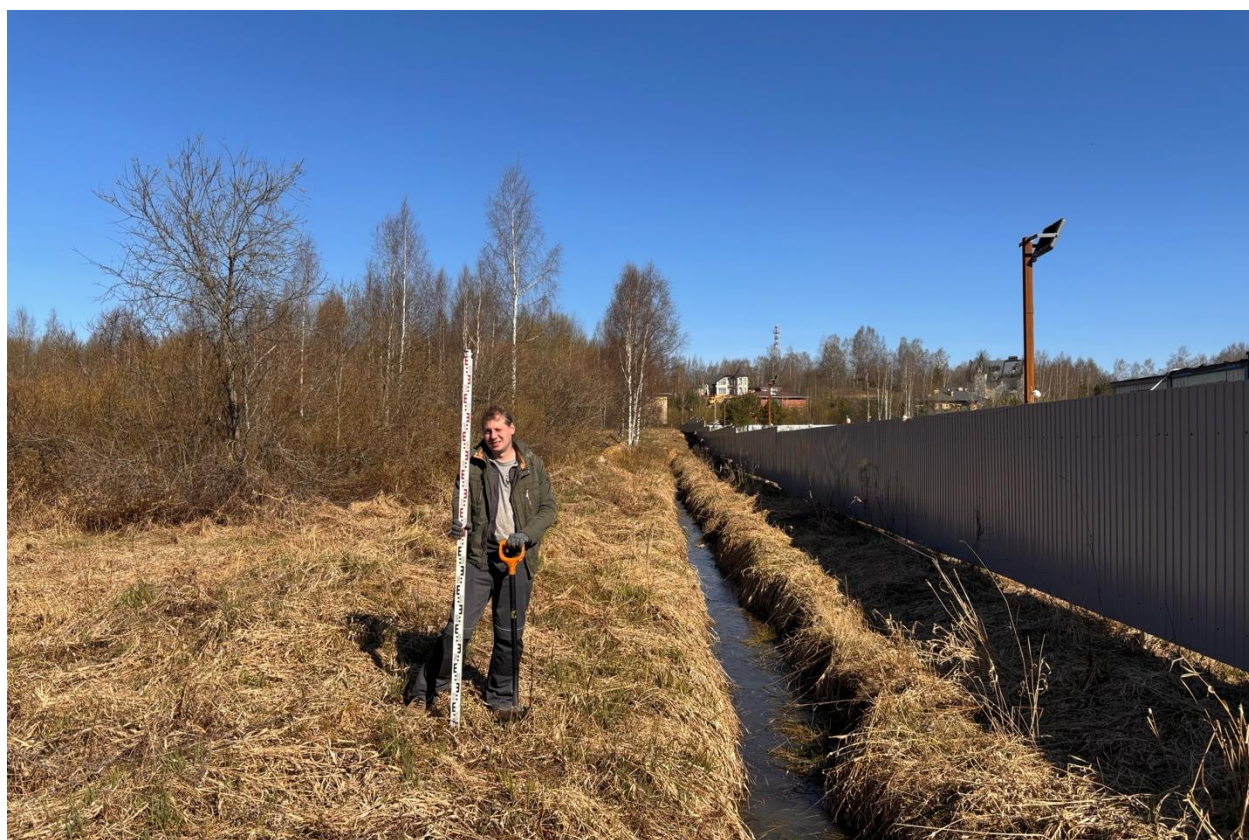
Рис. 10. ЛО-2026. Всеволожский район, дер. Порошкино. Общий вид обследуемого участка. Точка фотофиксации №1. Вид с юга.
