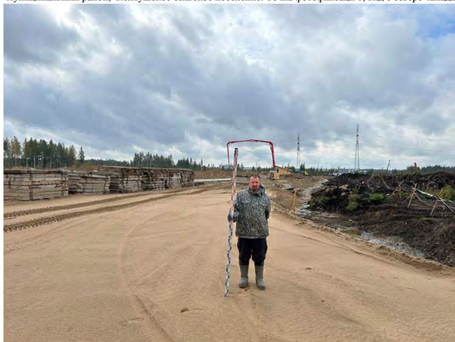
Рис. 13 Земельный участок с к/н 47:07:1047003:846 по адресу Ленинградская область, Всеволожский муниципальный район, Колтушское сельское поселение. Точка фотофиксации 2, вид с севера.
