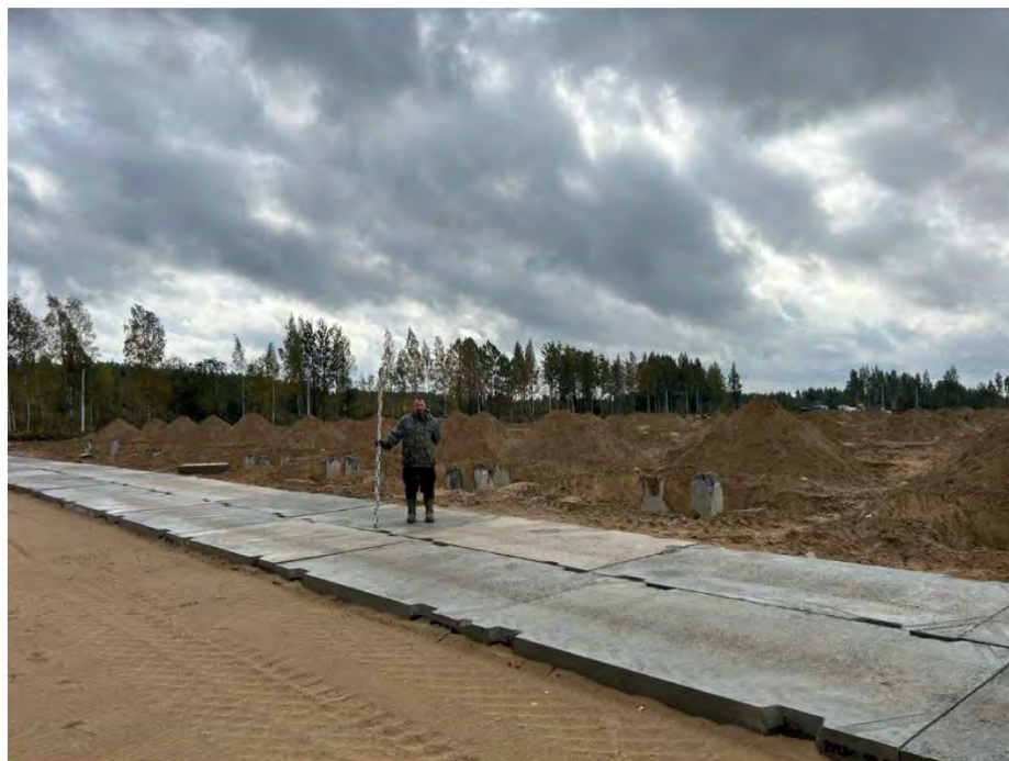
Рис. 14. Земельный участок с к/н 47:07:1047003:846 по адресу Ленинградская область, Всеволожский муниципальный район, Колтушское сельское поселение. Точка фотофиксации 3, Вид с юго-запада.
