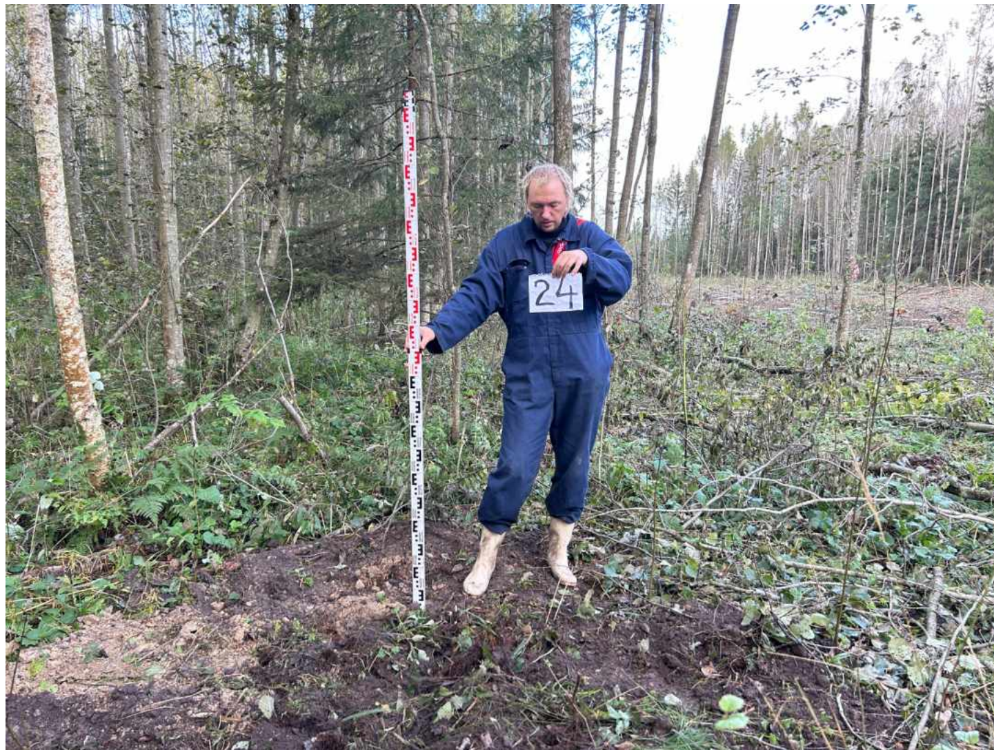
Илл. 112. Ленинградская обл., Тосненский р-н. – 2025 г. Участок работ по объекту «Строительство завода по производству типовых железобетонных балок пролетных строений “Пионер”». Шурф 24. Видовая фотография закопанного шурфа. Фото с Ю.
