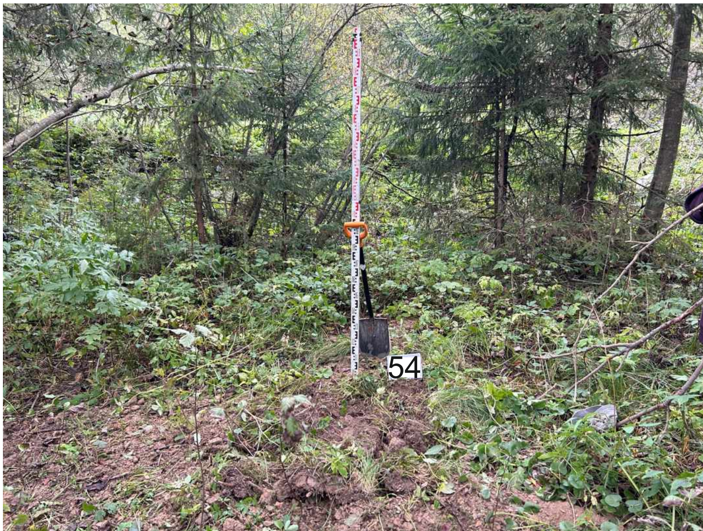
Илл. 202. Ленинградская обл., Тосненский р-н. – 2025 г. Участок работ по объекту «Строительство завода по производству типовых железобетонных балок пролетных строений “Пионер”». Шурф 54. Видовая фотография закопанного шурфа. Фото с Ю.
