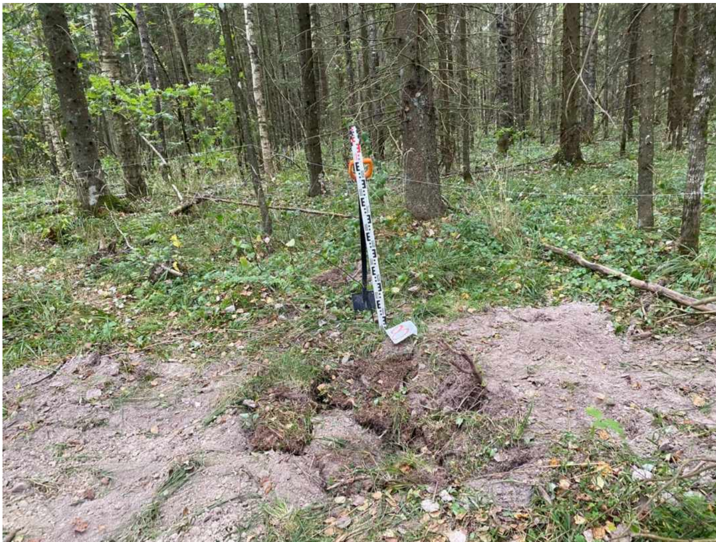
Илл. 64. Ленинградская обл., Тосненский р-н. – 2025 г. Участок работ по объекту «Строительство завода по производству типовых железобетонных балок пролетных строений “Пионер”». Шурф 8. Видовая фотография закопанного шурфа. Фото с Ю.
