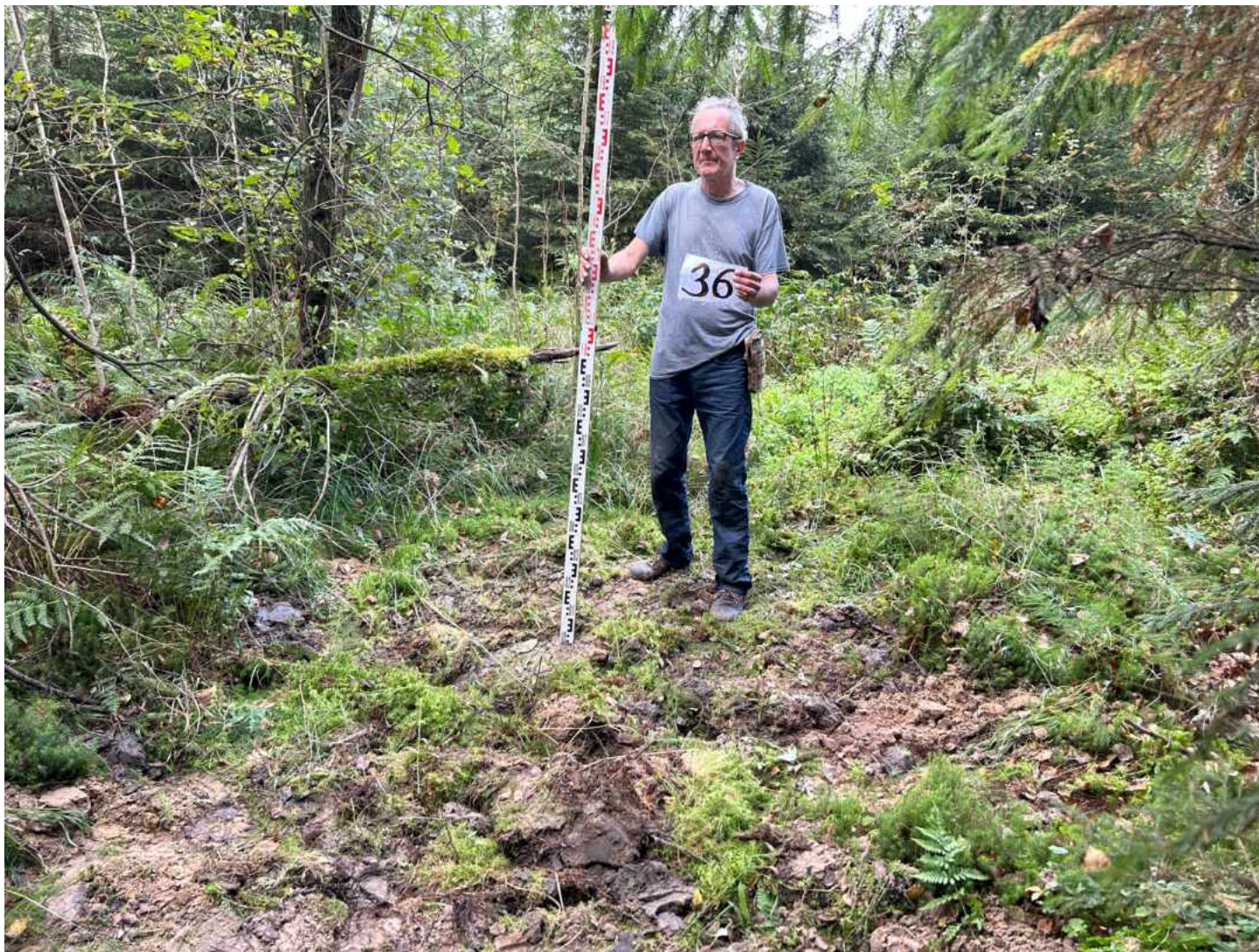
Илл. 148. Ленинградская обл., Тосненский р-н. – 2025 г. Участок работ по объекту «Строительство завода по производству типовых железобетонных балок пролетных строений “Пионер”». Шурф 36. Видовая фотография закопанного шурфа. Фото с Ю.
