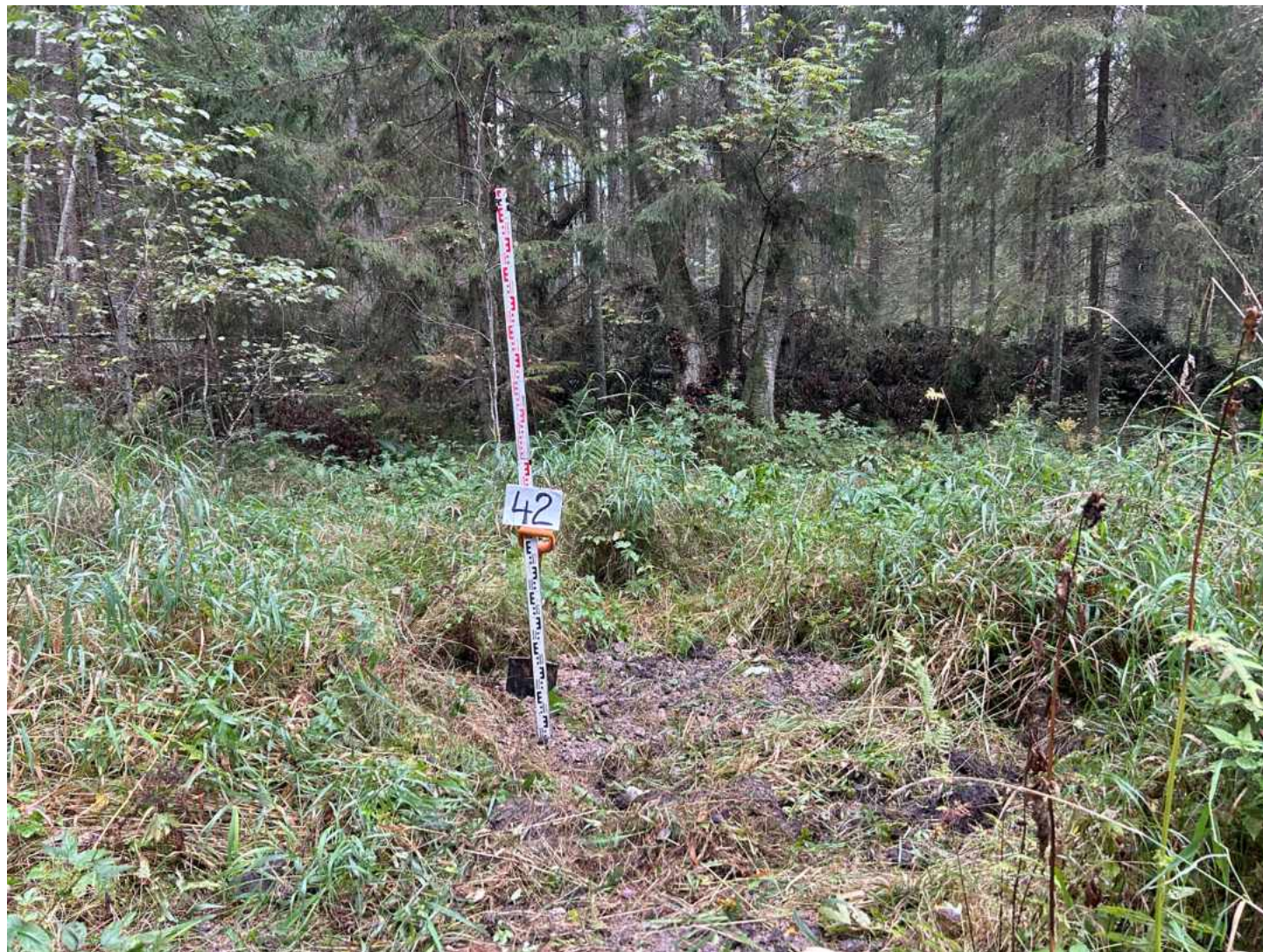
Илл. 166. Ленинградская обл., Тосненский р-н. – 2025 г. Участок работ по объекту «Строительство завода по производству типовых железобетонных балок пролетных строений “Пионер”». Шурф 42. Видовая фотография закопанного шурфа. Фото с Ю.
