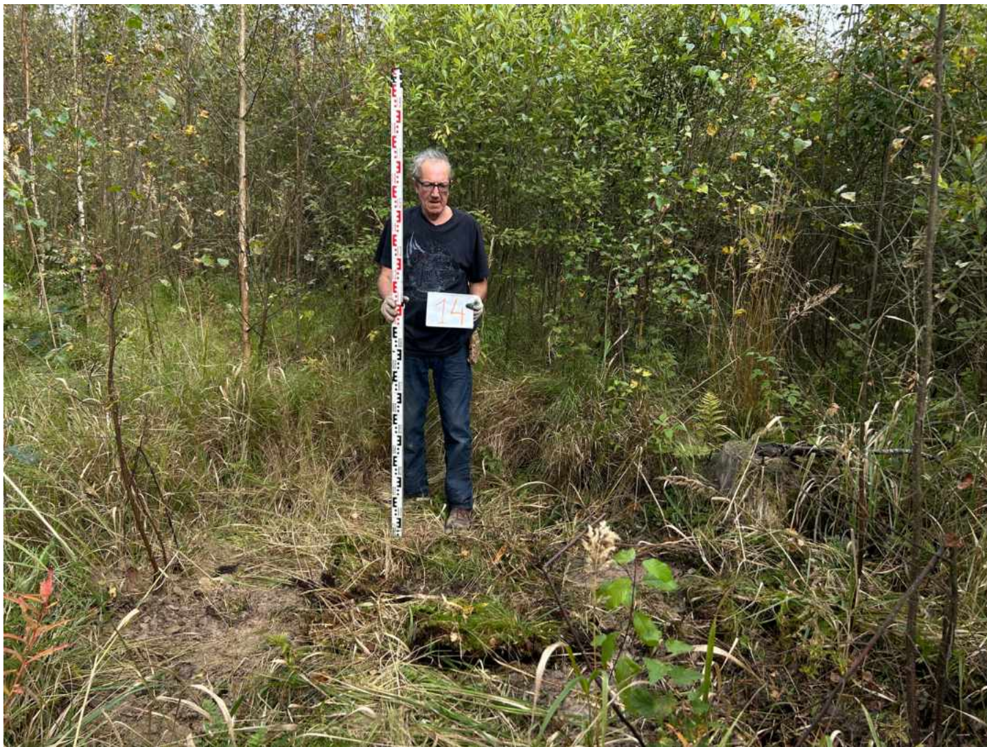
Илл. 82. Ленинградская обл., Тосненский р-н. – 2025 г. Участок работ по объекту «Строительство завода по производству типовых железобетонных балок пролетных строений “Пионер”». Шурф 14. Видовая фотография закопанного шурфа. Фото с Ю.
