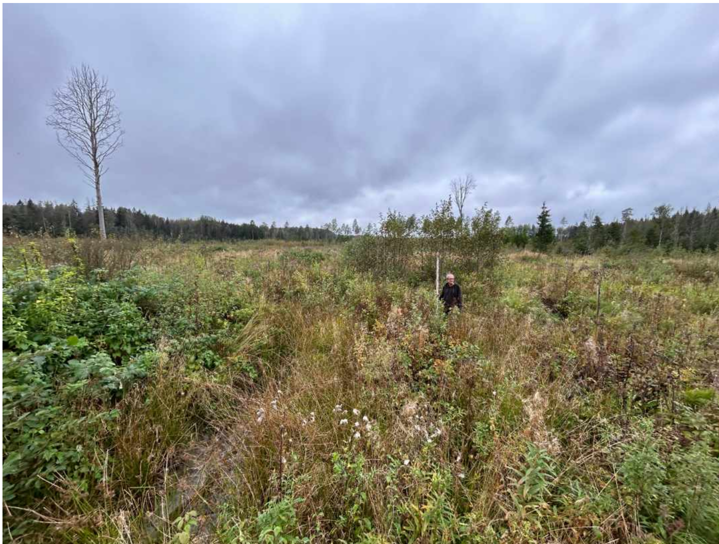
Илл. 46. Ленинградская обл., Тосненский р-н. – 2025 г. Участок работ по объекту «Строительство завода по производству типовых железобетонных балок пролетных строений “Пионер”». Точка фотофиксации 19. Фото с С.
