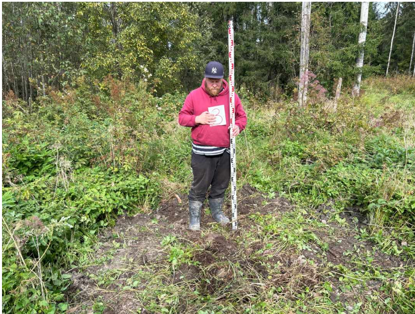
Илл. 30. Ленинградская обл., Тосненский р-н. – 2025 г. Участок работ по объекту «Строительство завода по производству типовых железобетонных балок пролетных строений “Пионер”». Шурф 3. Видовая фотография закопанного шурфа. Фото с Ю.
