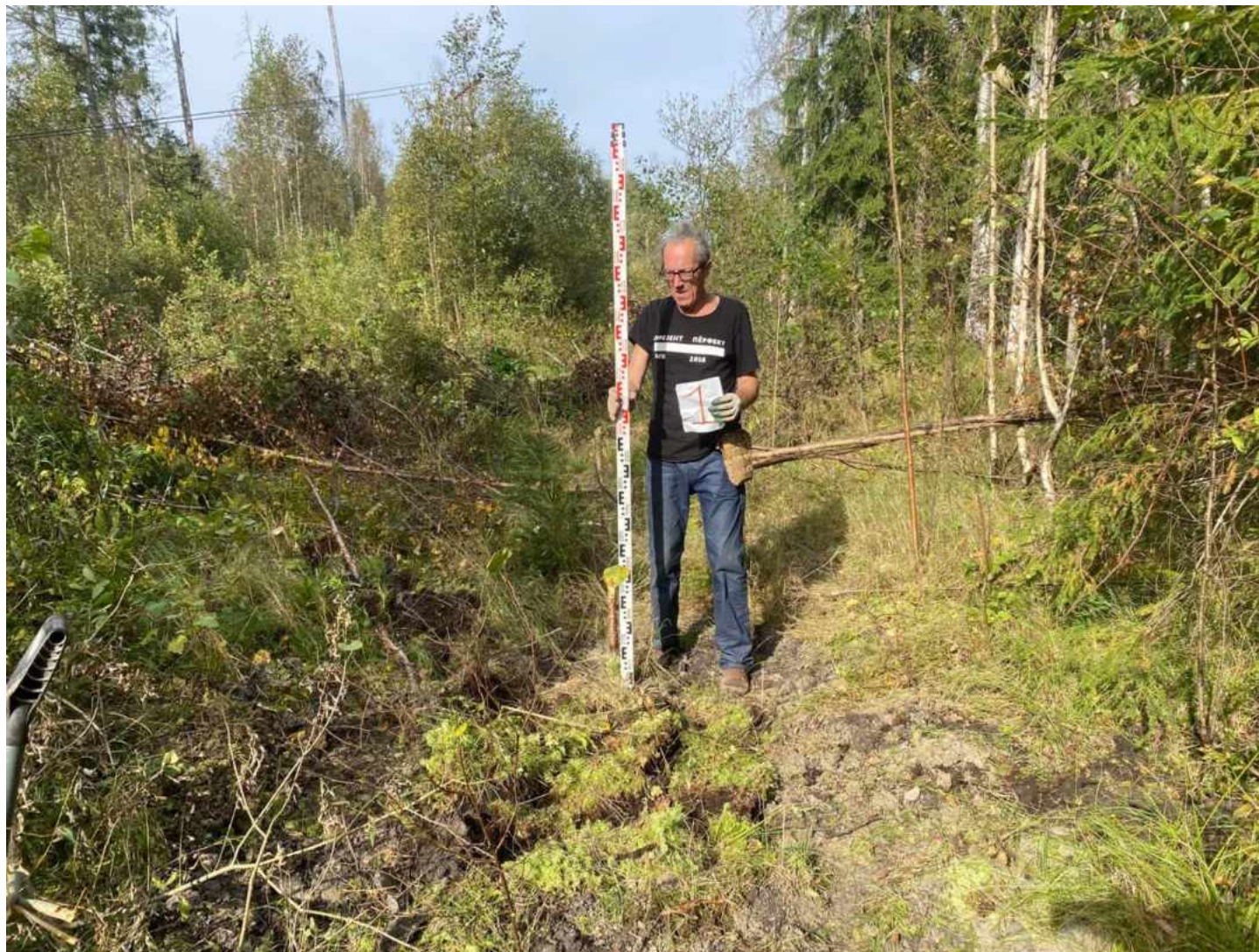
Илл. 24. Ленинградская обл., Тосненский р-н. – 2025 г. Участок работ по объекту «Строительство завода по производству типовых железобетонных балок пролетных строений “Пионер”». Шурф 1. Видовая фотография закопанного шурфа. Фото с Ю.
