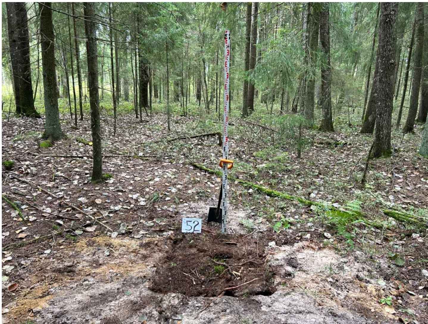
Илл. 196. Ленинградская обл., Тосненский р-н. – 2025 г. Участок работ по объекту «Строительство завода по производству типовых железобетонных балок пролетных строений “Пионер”». Шурф 52. Видовая фотография закопанного шурфа. Фото с Ю.
