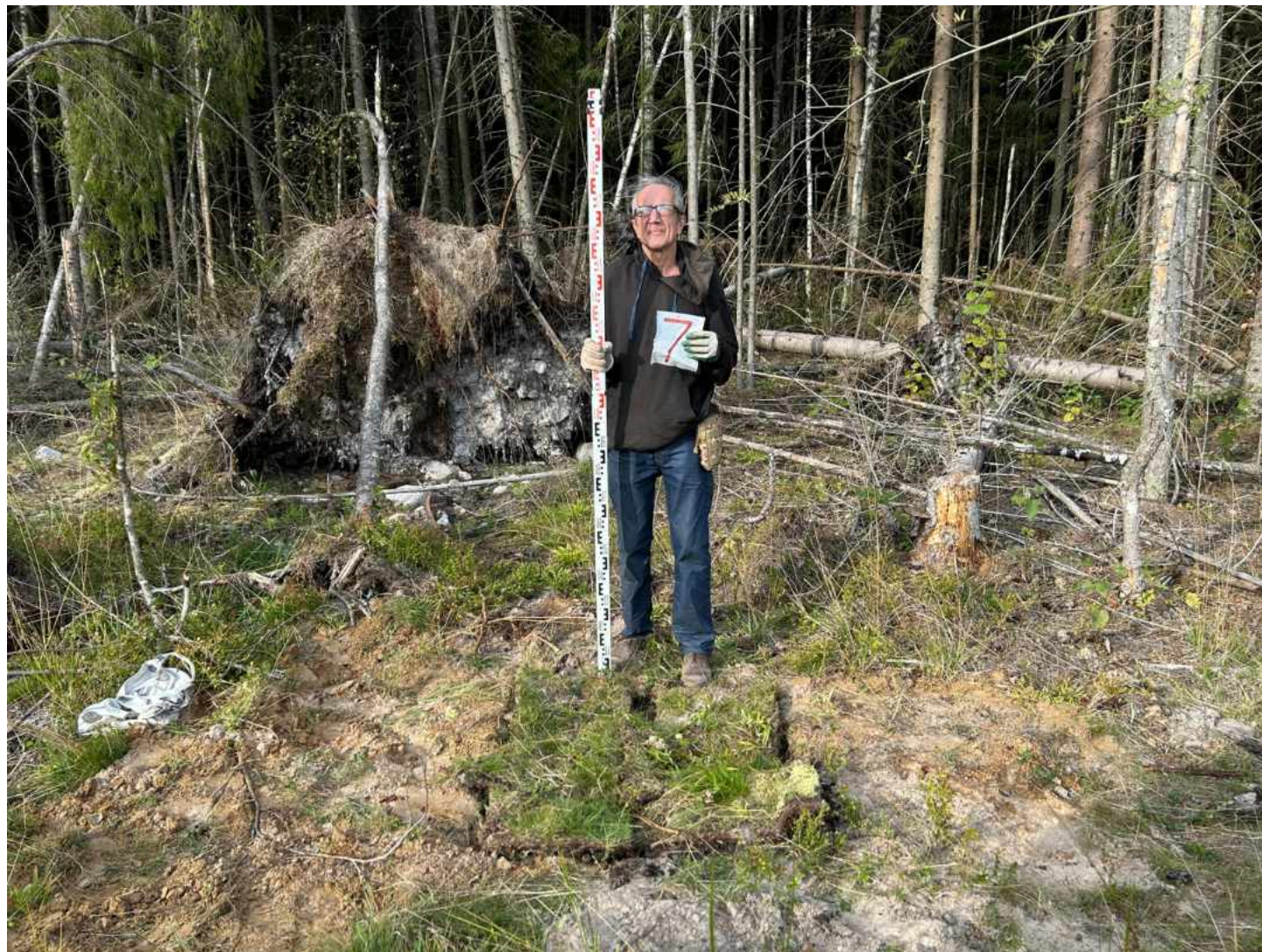
Илл. 61. Ленинградская обл., Тосненский р-н. – 2025 г. Участок работ по объекту «Строительство завода по производству типовых железобетонных балок пролетных строений “Пионер”». Шурф 7. Видовая фотография закопанного шурфа. Фото с Ю.
