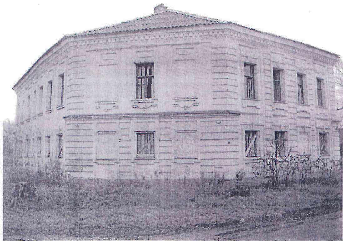
«Начальное училище» 1770-90 гг. Вид с северо – востока, на главный (скошенный) фасад здания. Фасады на ул. МОПРа и ул.Красную
