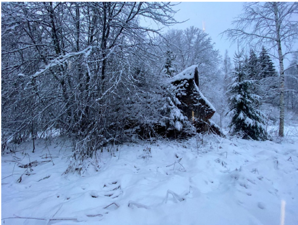
23. Общий вид с востока.
