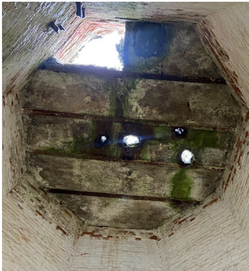
14. Перекрытие основного яруса.
