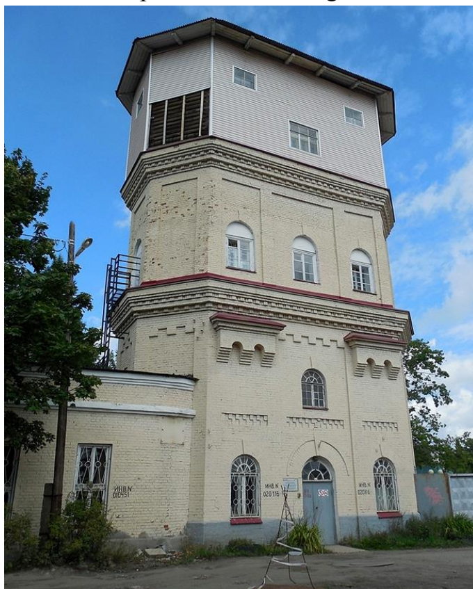
Илл. 40. Водонапорная башня. Званка (Волховстрой). Август 2014 г. [Электронный ресурс] // URL: https://yrjonpoika.livejournal.com/photo/album/52291/?mode=view&id=941095 .
