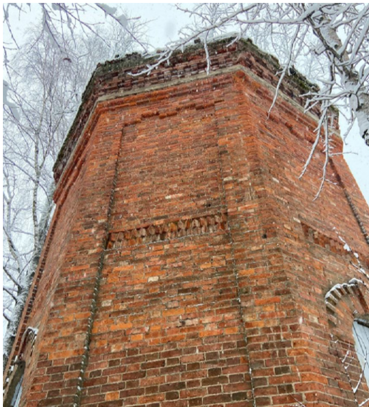
6. Фрагмент юго-восточного фасада.
