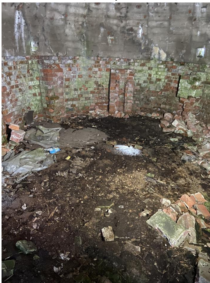
33. Грунтовый пол и цокольная часть.
