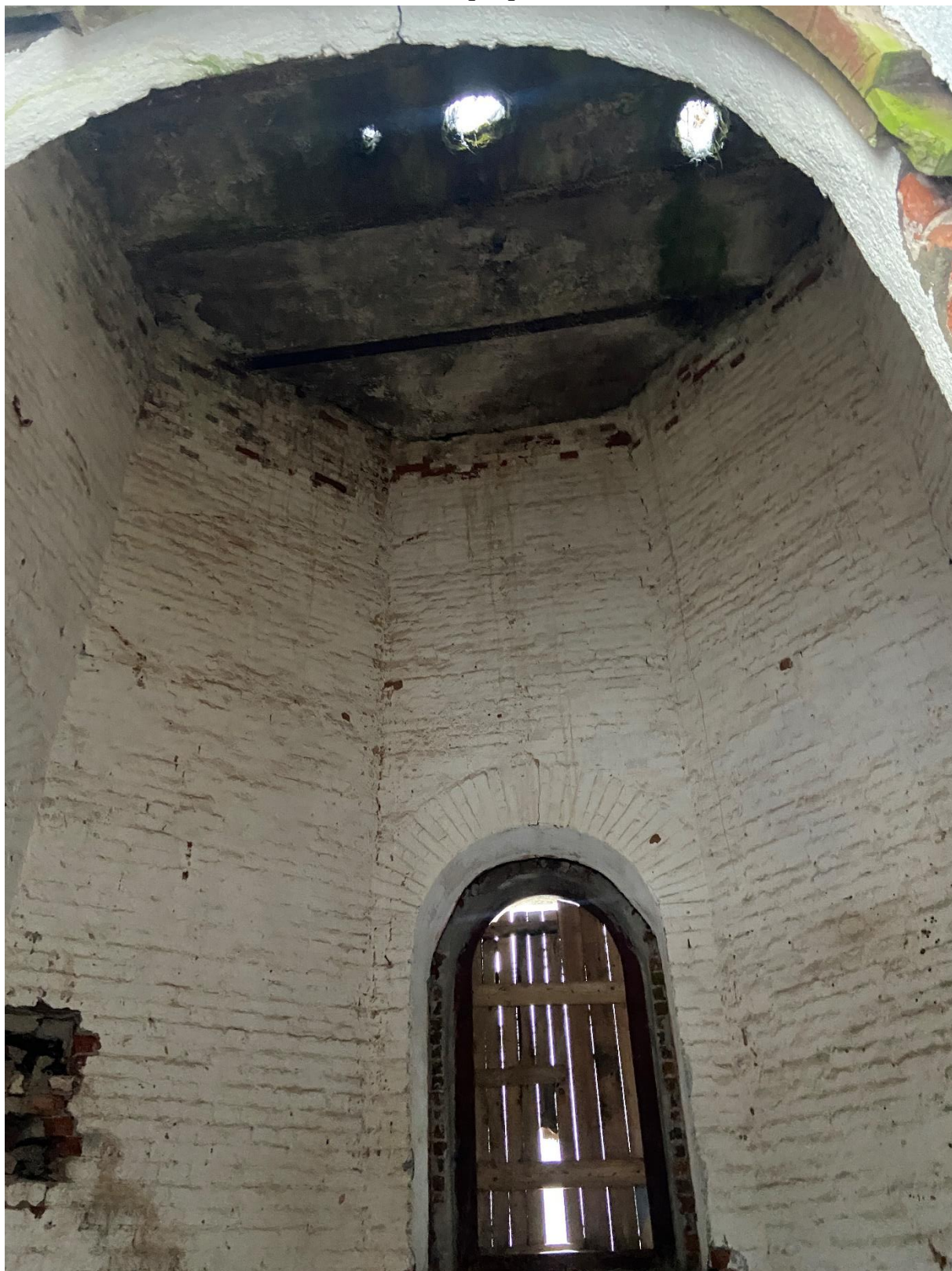
13. Общий вид помещения.
