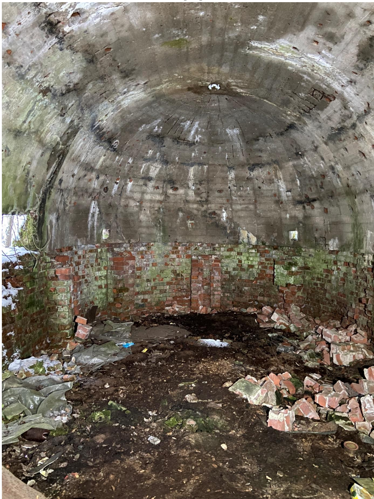
27. Общий вид помещения.
