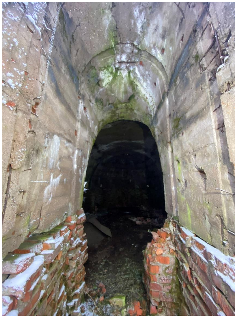
28. Вид входной части.
