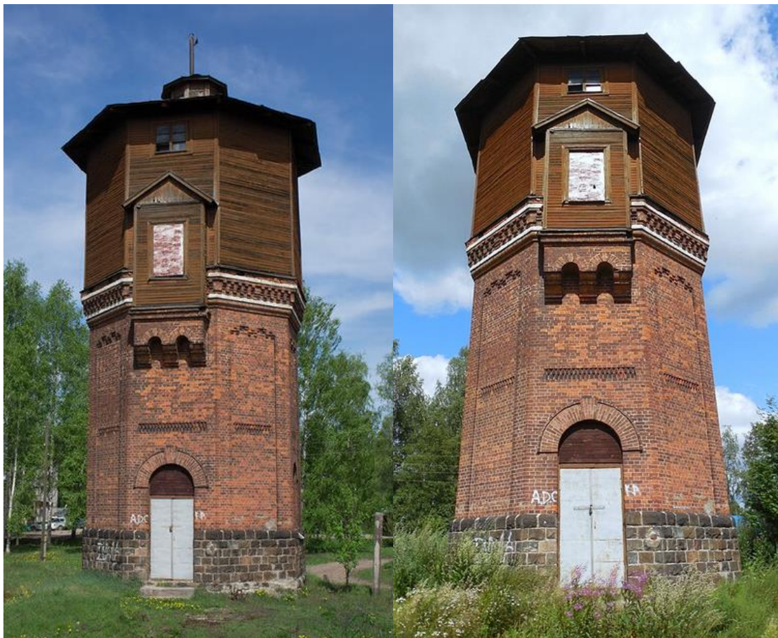
Илл. 39. Водонапорная башня на станции Кадуи. 2013 г. [Электронный ресурс] // URL: https://newsvo.ru/blogovo/70107 .
