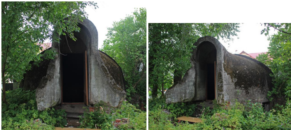
Илл. 45. Дореволюционный погреб-ледник 1900-е на железнодорожной станции Мга. 2019 г. [Электронный ресурс] // URL: https://vk.com/wall327458_33569 . Сооружение было построено в 1900-е годы. Предназначалось в том числе для хранения льда в теплые сезоны. Лёд использовался для вагонов-ледников, которые перевозили скоропортящиеся грузы.
