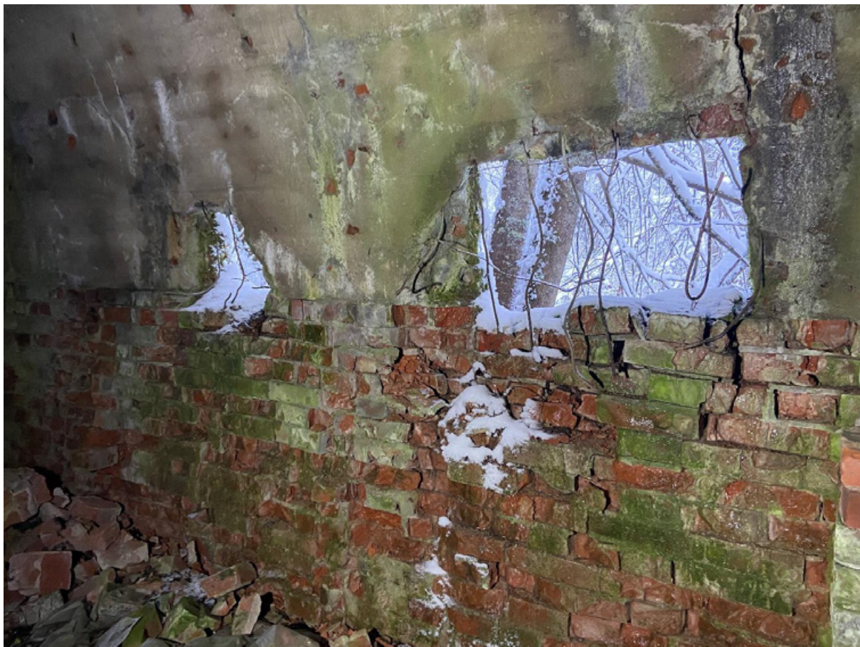
30. Проемы в цокольной части.
