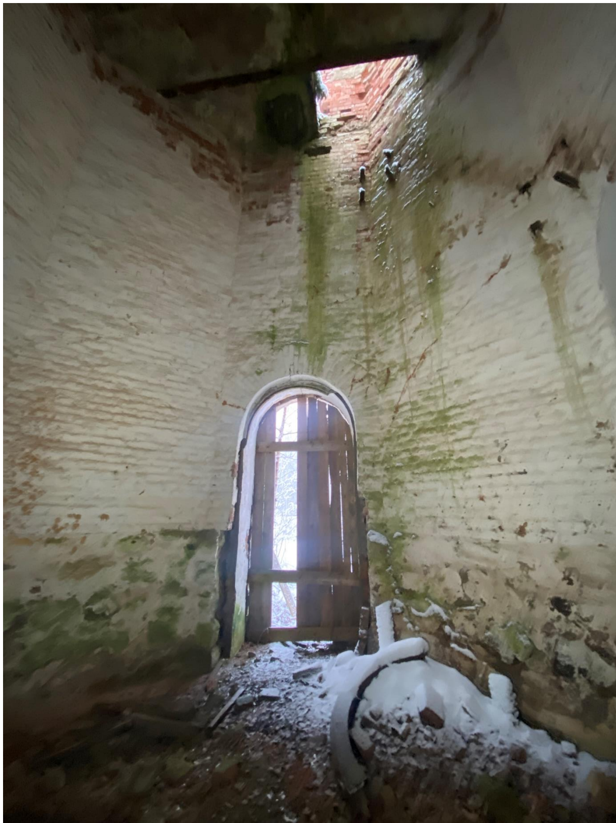
18. Вид на вход и перекрытие.
