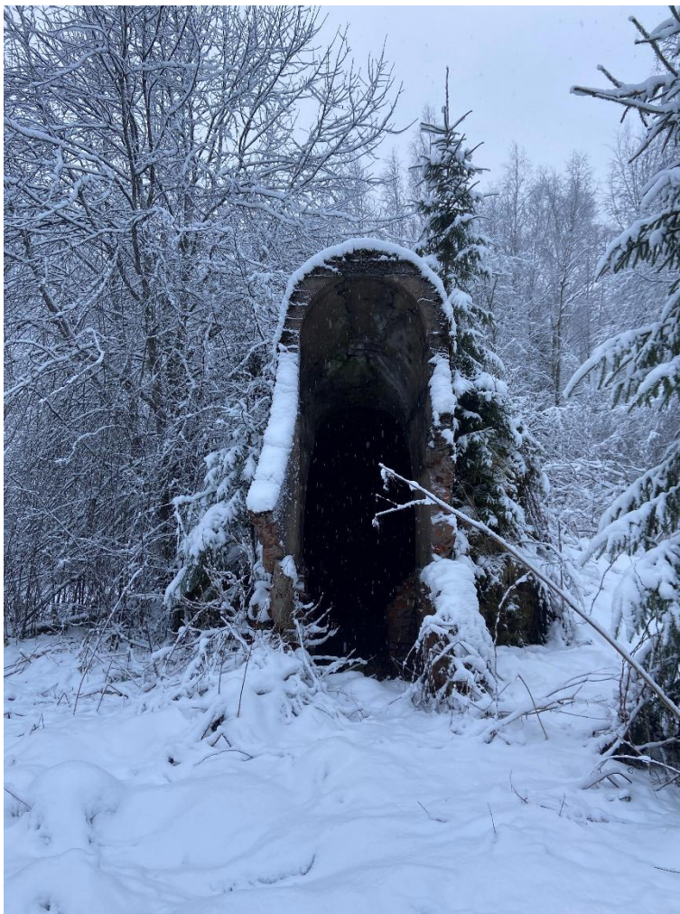
20. Северный фасад, вход.
