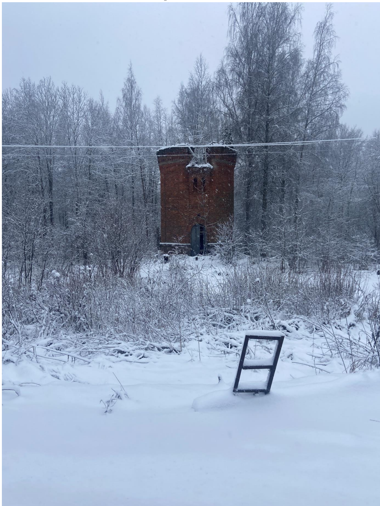
1. Общий вид водонапорной башни от линий ж.д. и территории рядом с ней.
