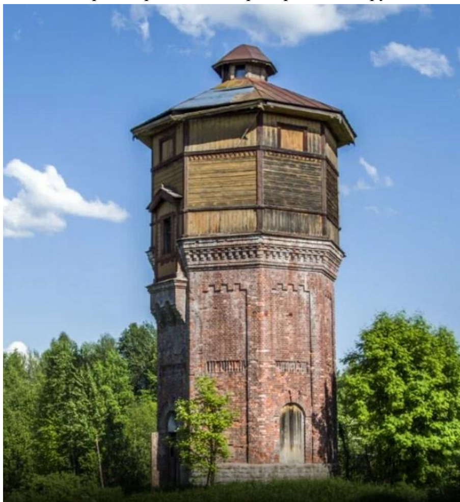
Илл. 46. Станция Быстряги, Кировская обл. 2024 г. [Электронный ресурс] // URL: https://yandex.ru/maps
