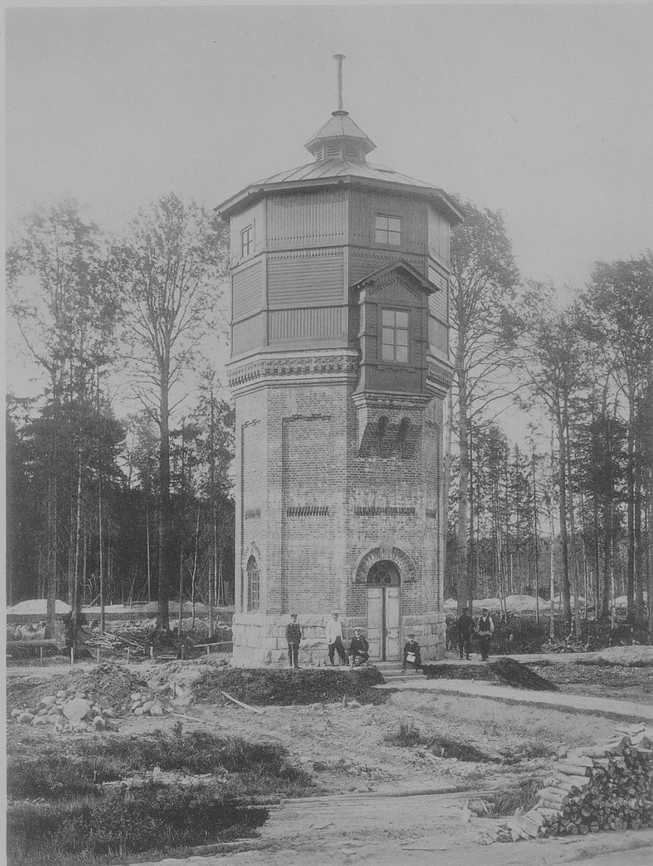
Водоемное здание на 1 бакъ (кирпичное).
