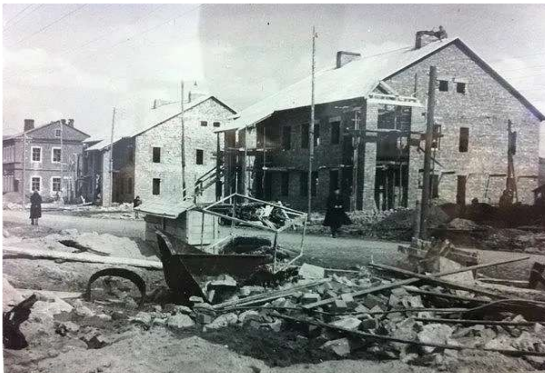
17. Строительство домов на улице Новая. 1951 г. [Электронный ресурс]
