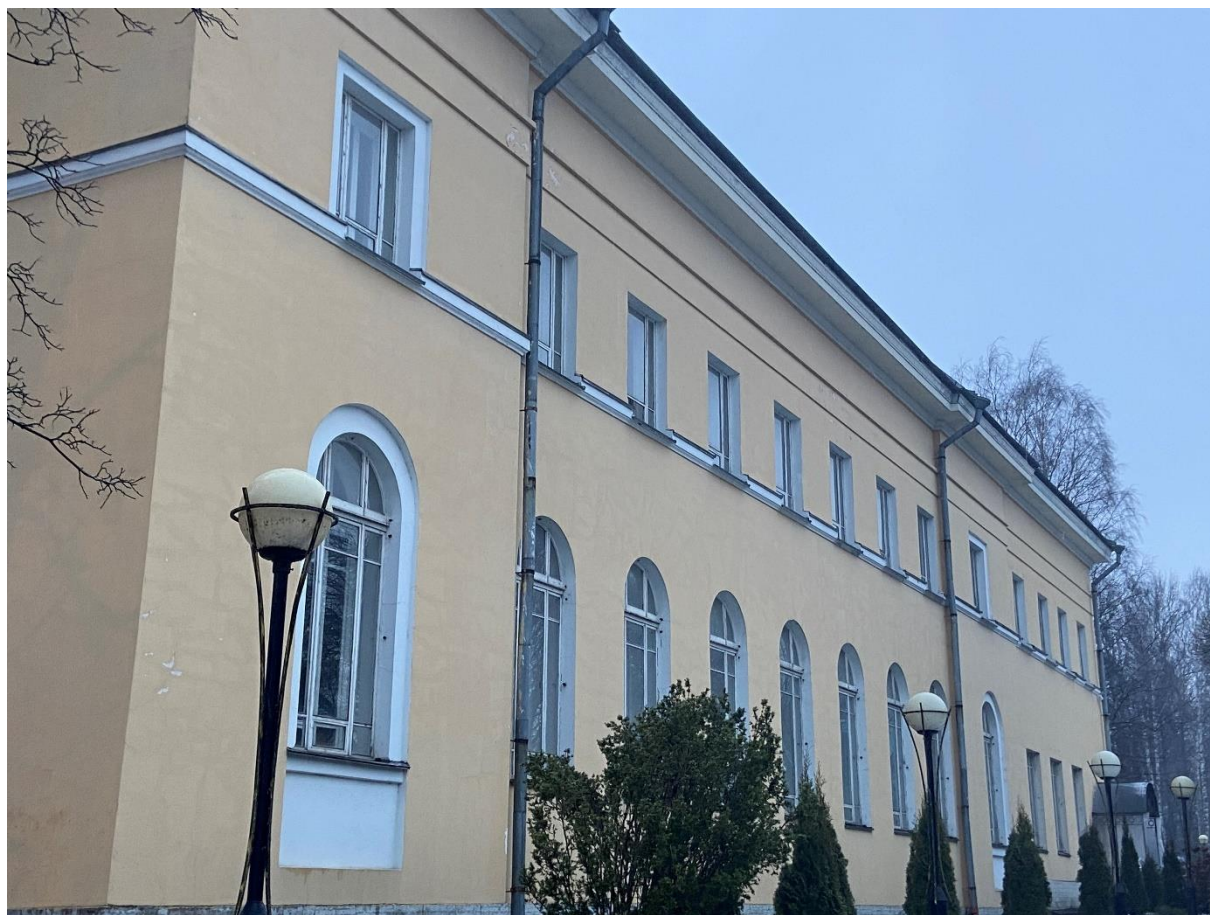
Фото 8. Вид на юго-восточный фасад.
