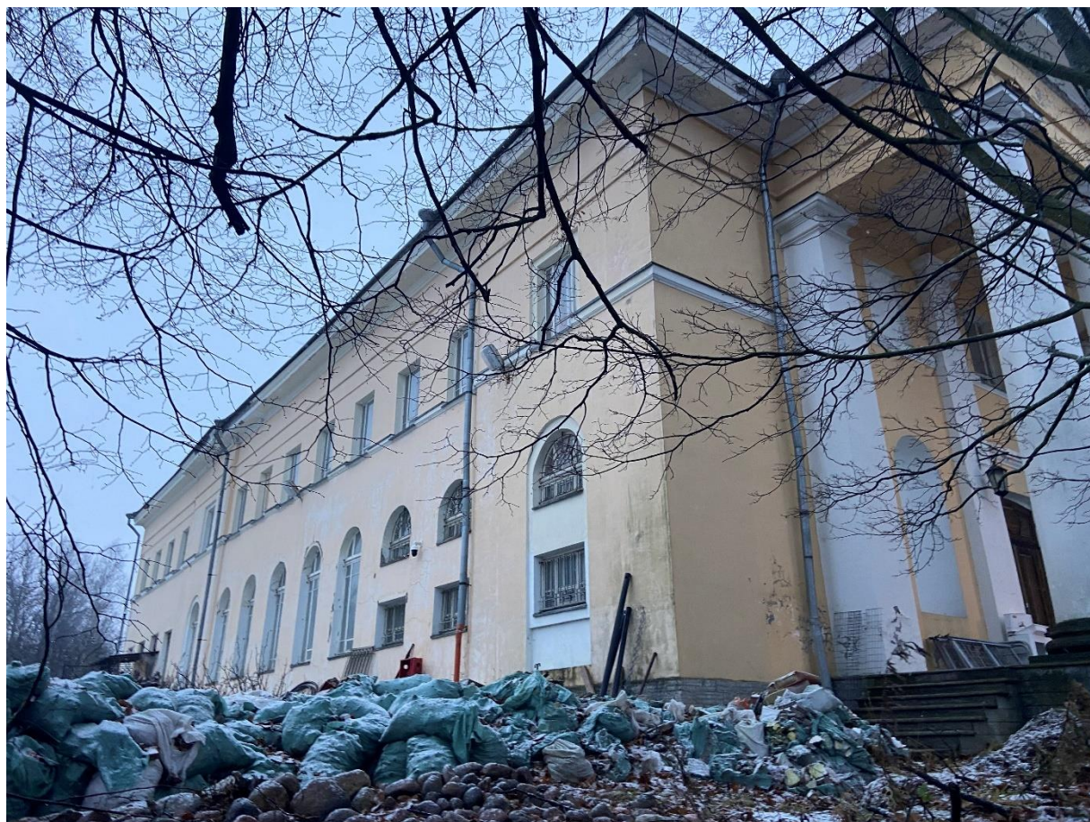
Фото 2. Вид на северо-западный фасад.
