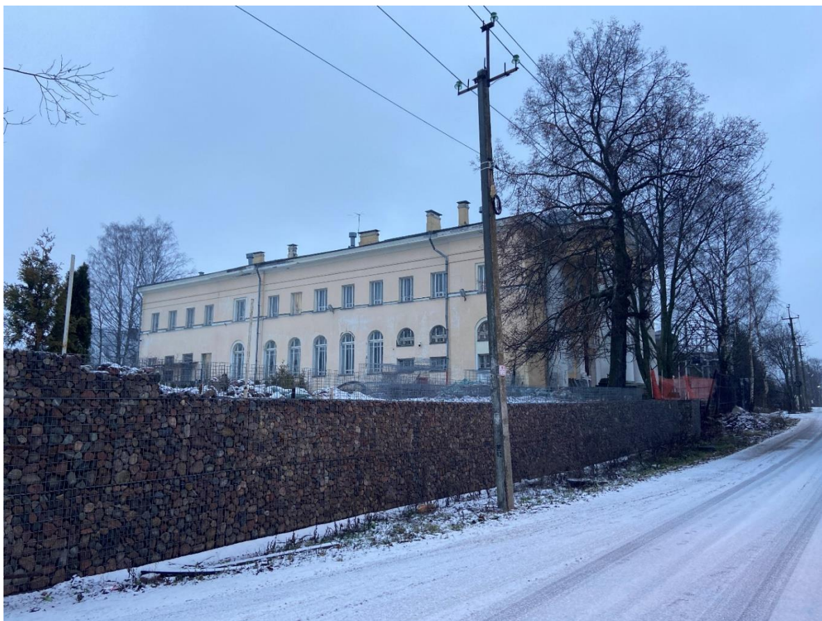
Фото 1. Вид на северо-западный фасад.
