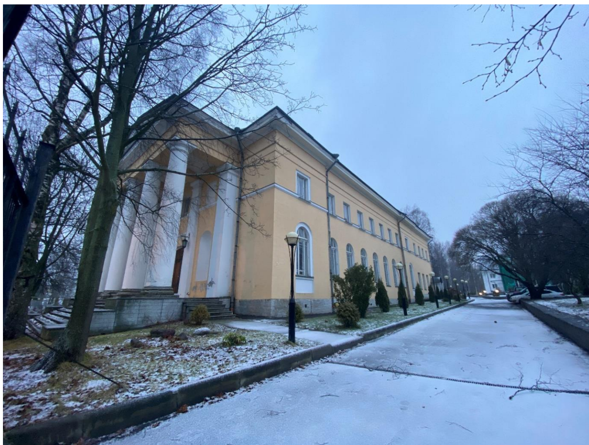
Фото 7. Вид на юго-восточный фасад.
