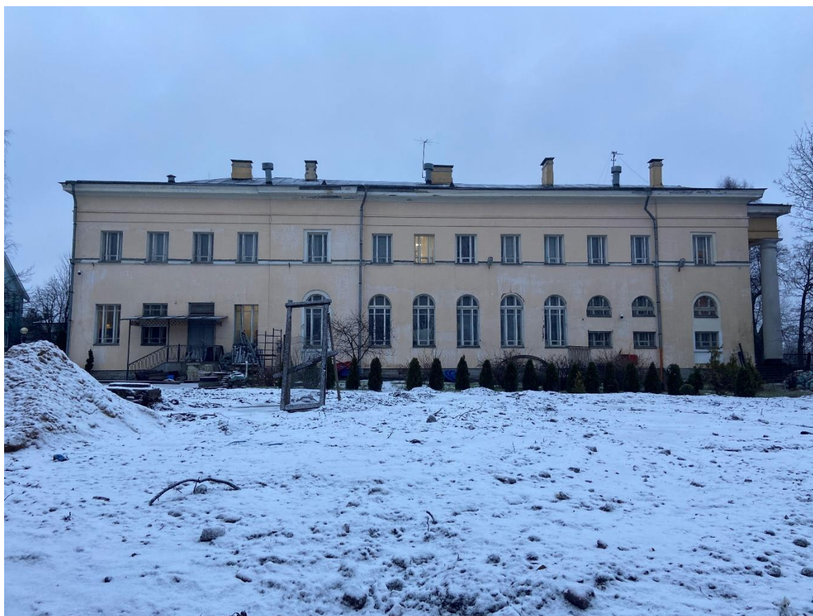
Фото 9. Вид на северо-западный фасад.
