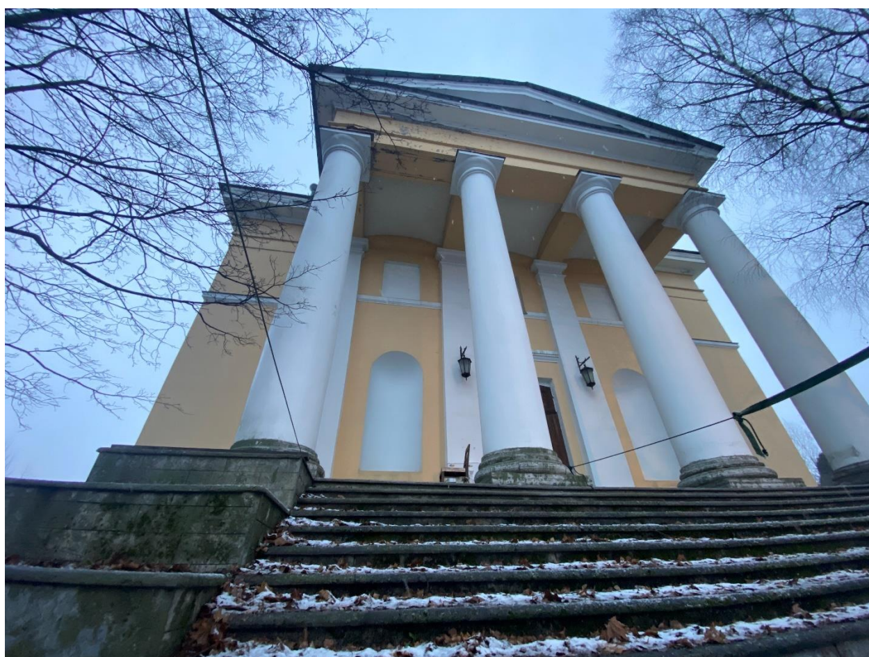
Фото 5. Вид на портик юго-западного фасада.
