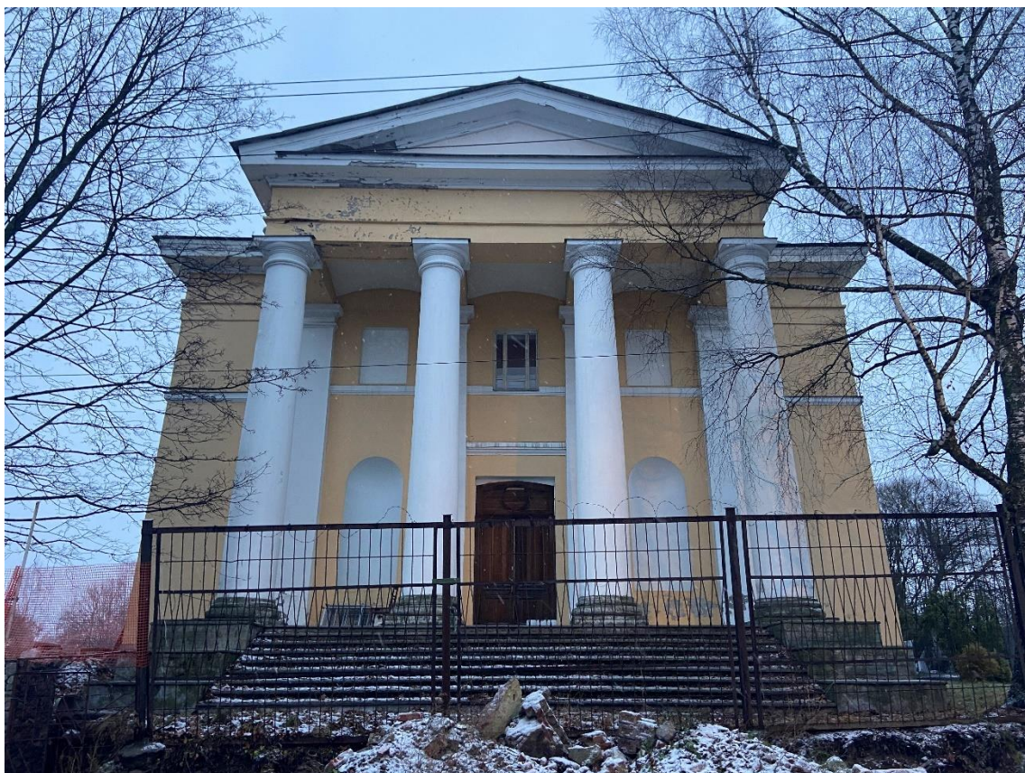
Фото 4. Вид на юго-западный фасад.
