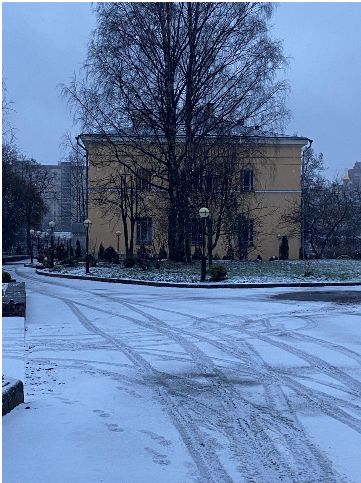
Фото 10. Вид на северо-восточный фасад.
