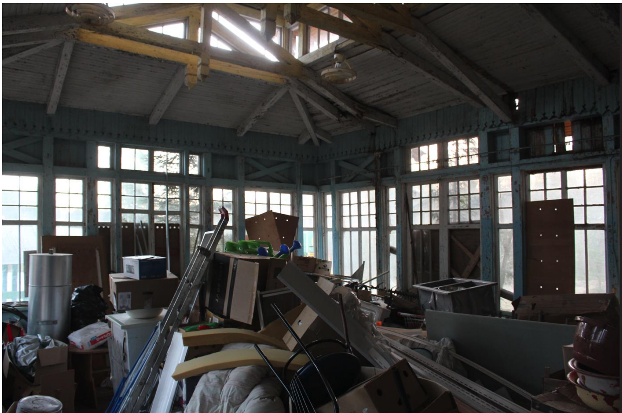
Фото 15. Вид на помещения 1-го этажа исследуемого объекта.
