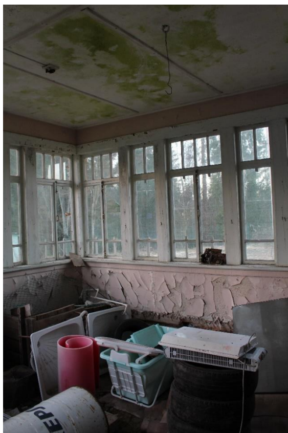
Фото 26. Вид на помещения 1-го этажа исследуемого объекта.
