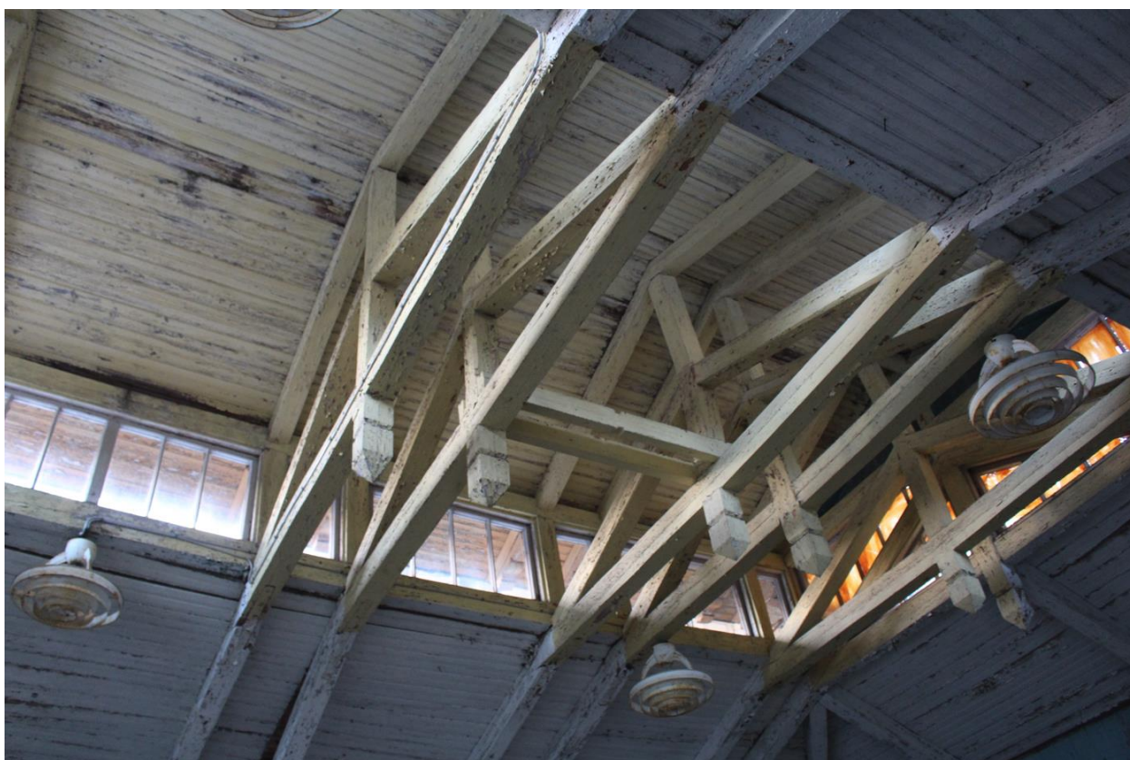
Фото 14. Вид на помещения 1-го этажа исследуемого объекта.
