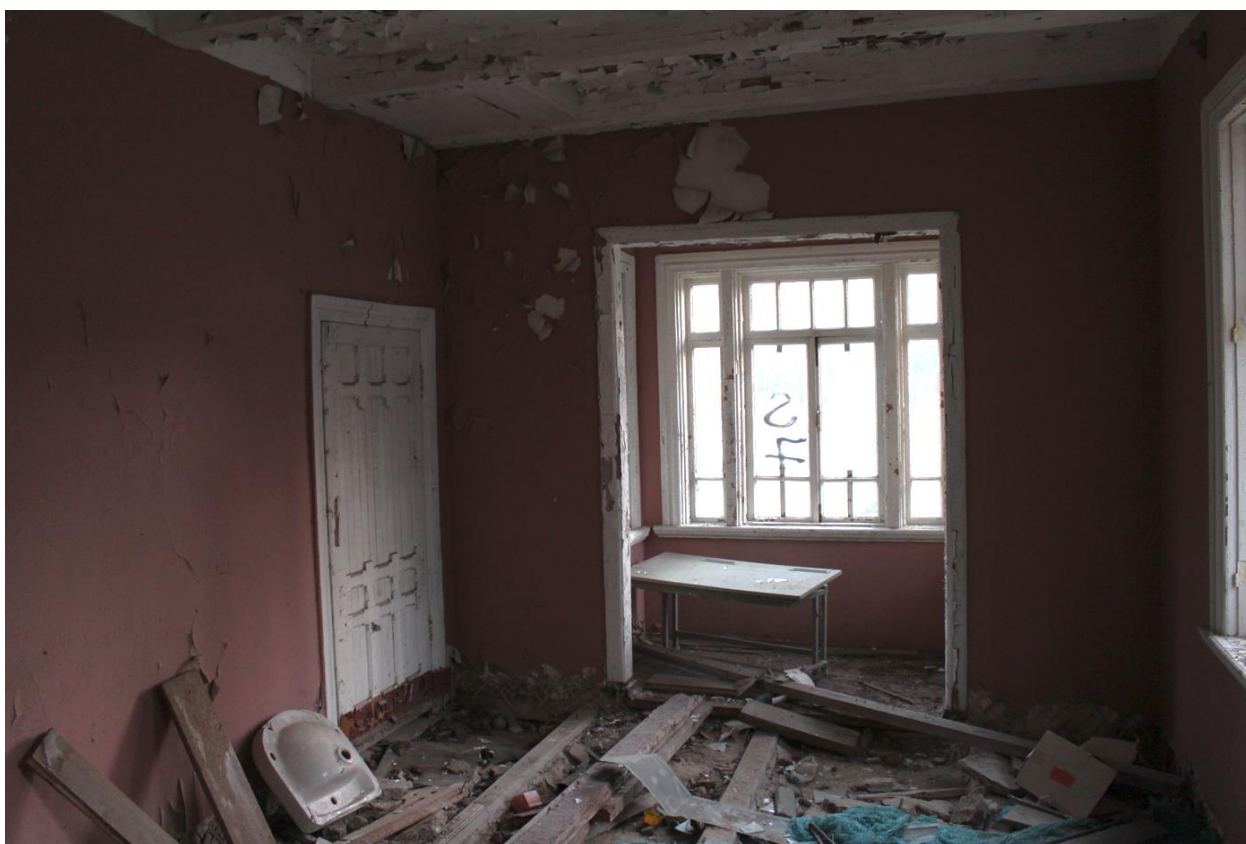
Фото 40. Вид на помещения 1-го этажа исследуемого объекта.
