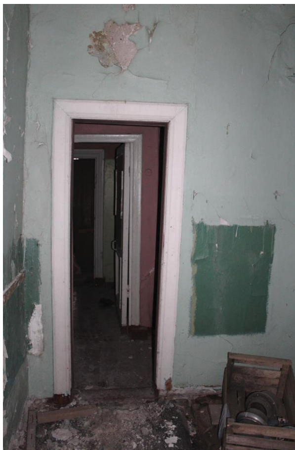
Фото 19. Вид на помещения 1-го этажа исследуемого объекта.
