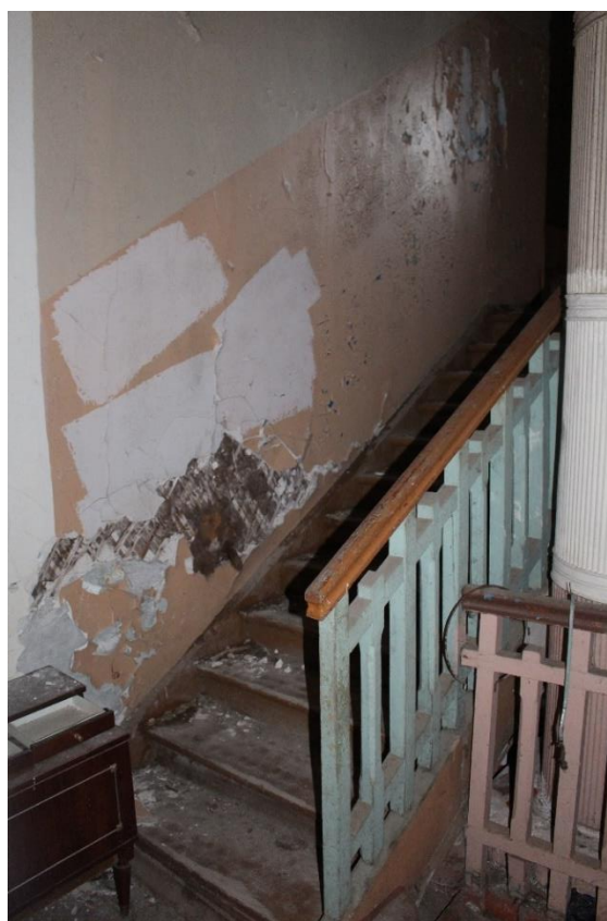
Фото 27. Вид на помещения 1-го этажа исследуемого объекта.
