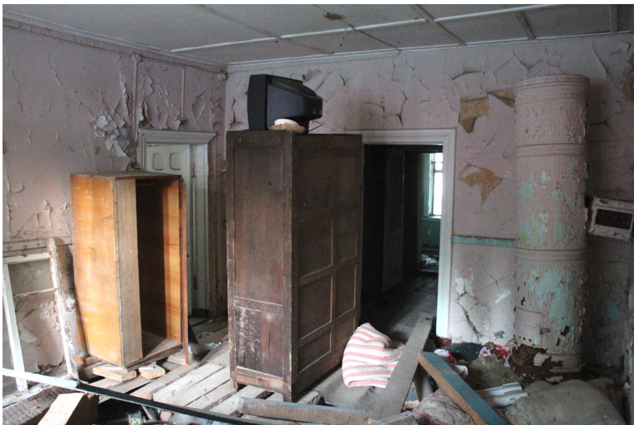
Фото 39. Вид на помещения 1-го этажа исследуемого объекта.
