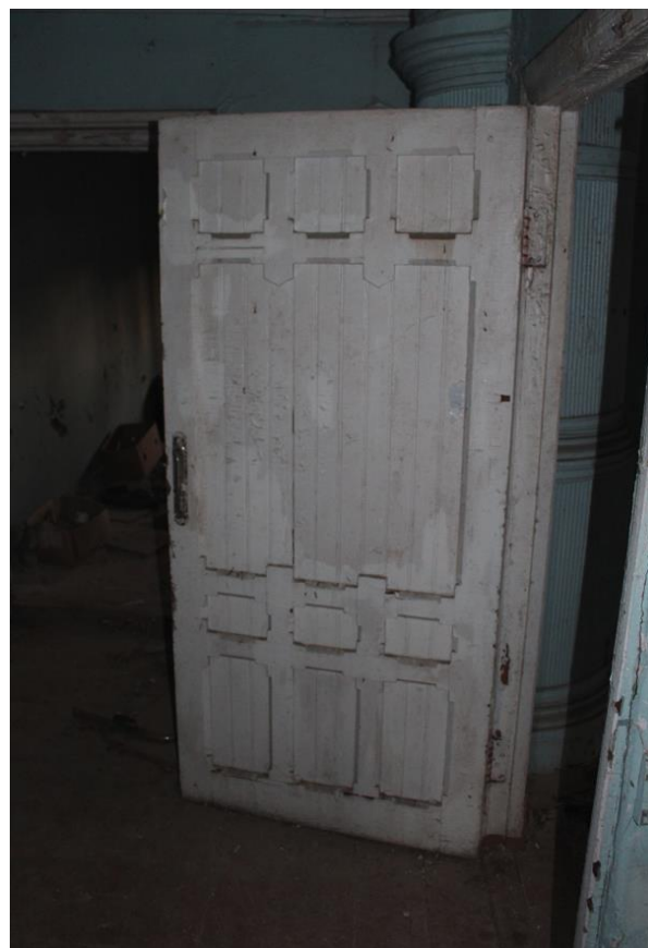
Фото 34. Вид на помещения 2-го этажа исследуемого объекта.
