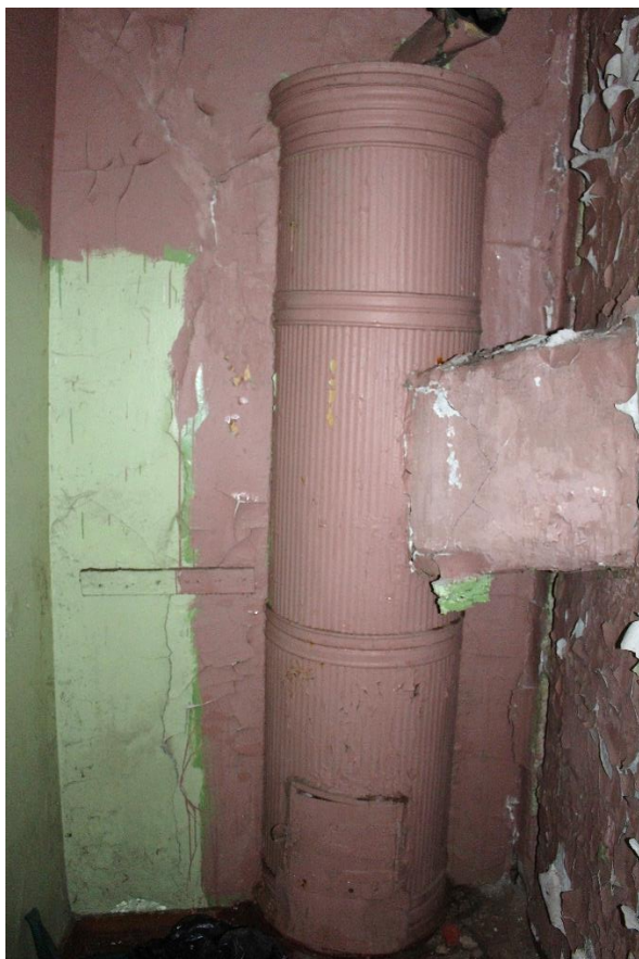
Фото 21. Вид на помещения 1-го этажа исследуемого объекта.
