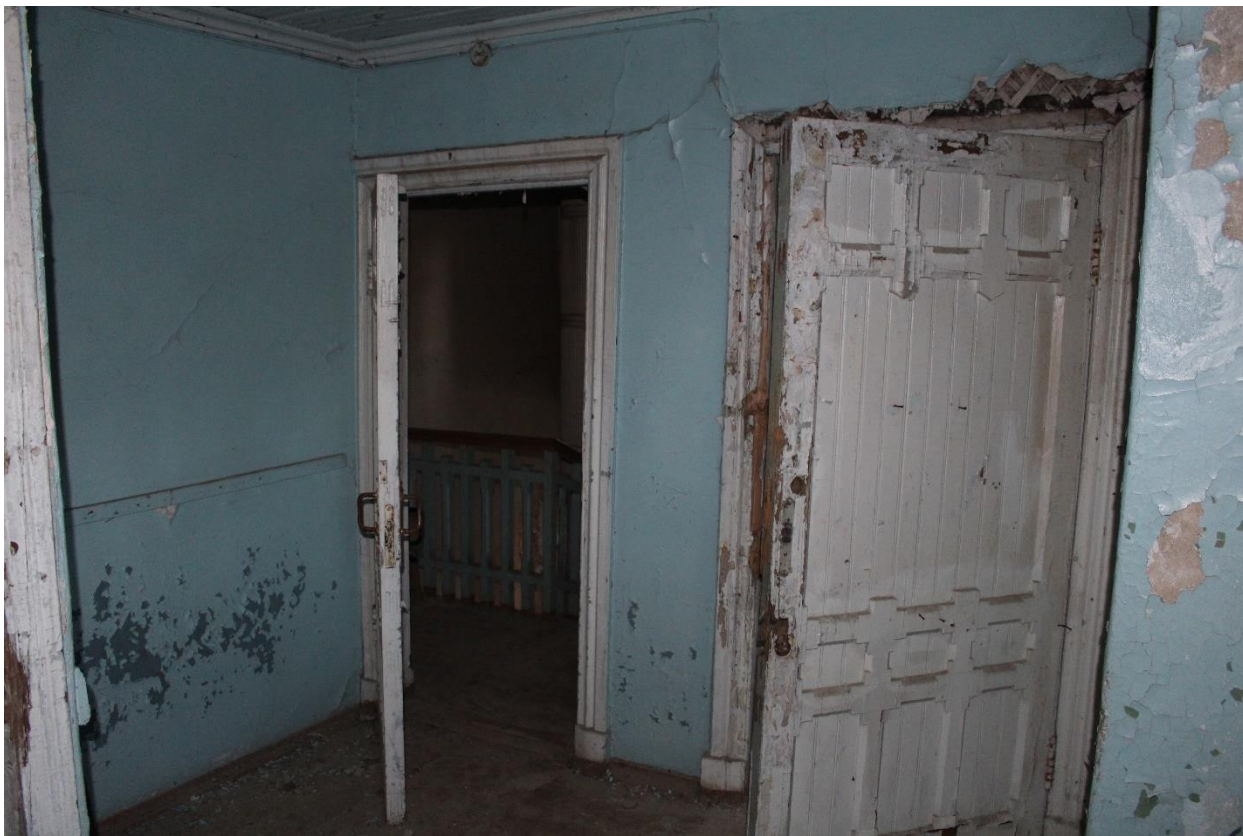
Фото 30. Вид на помещения 2-го этажа исследуемого объекта.
