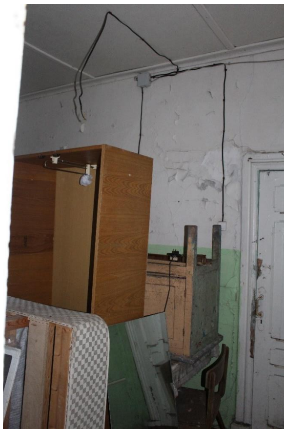
Фото 25. Вид на помещения 1-го этажа исследуемого объекта.
