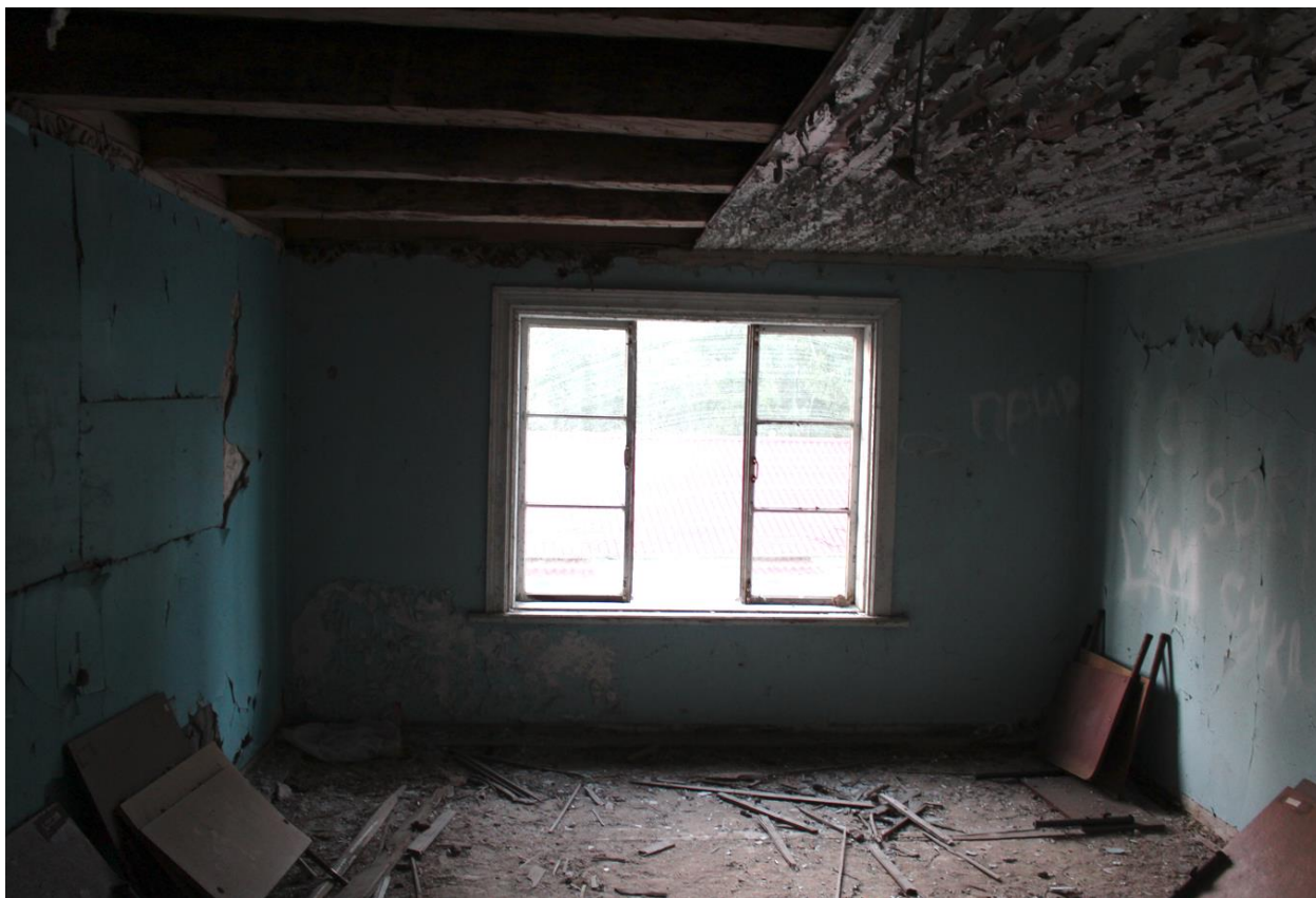
Фото 31. Вид на помещения 2-го этажа исследуемого объекта.
