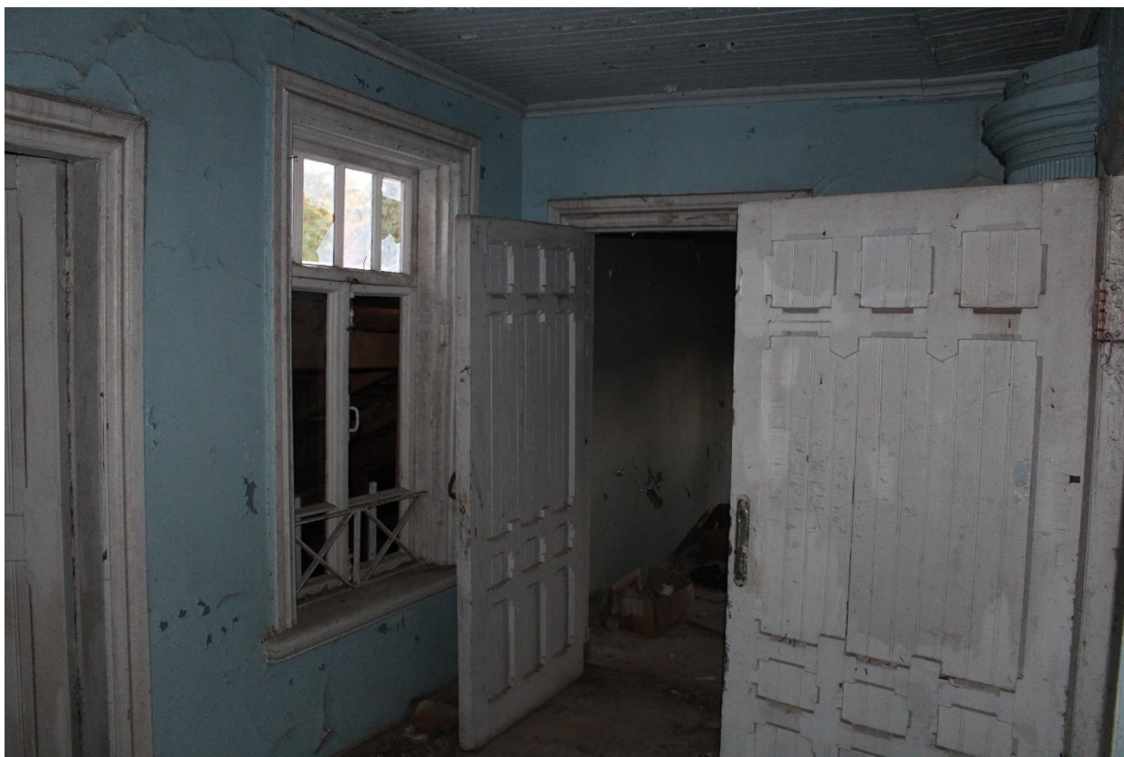
Фото 29. Вид на помещения 2-го этажа исследуемого объекта.
