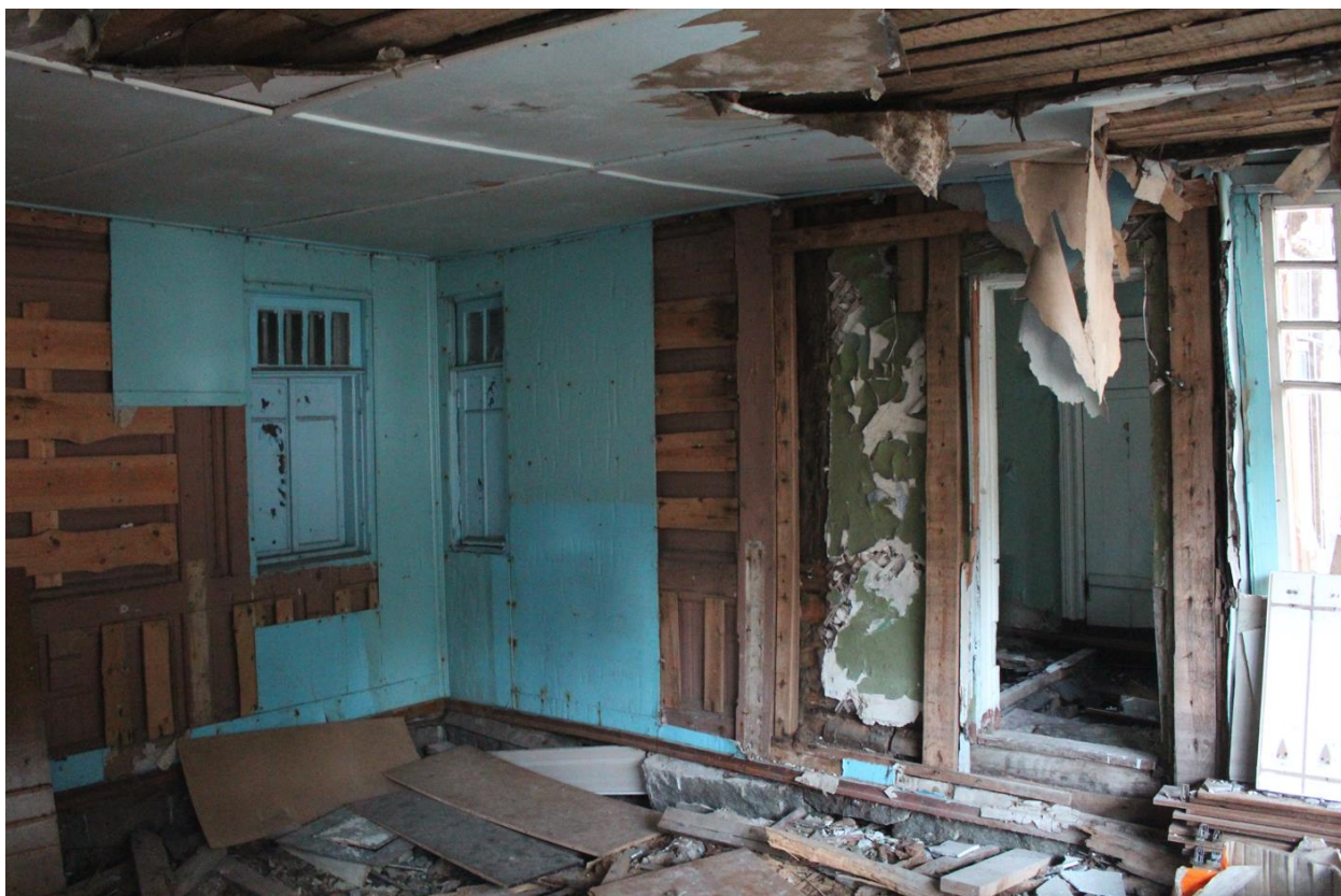
Фото 16. Вид на помещения 1-го этажа исследуемого объекта.
