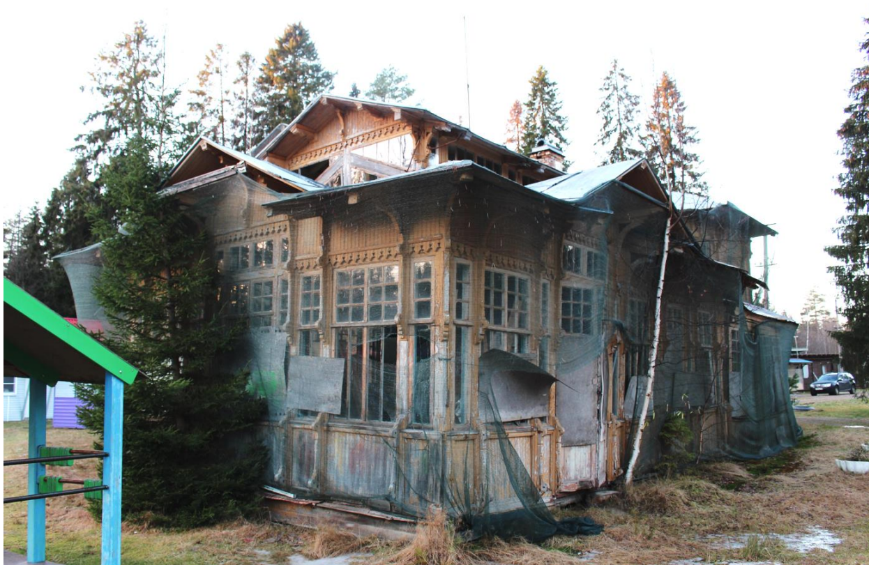
Фото 11. Угол пересечения юго-восточного и северо-восточного фасадов.
