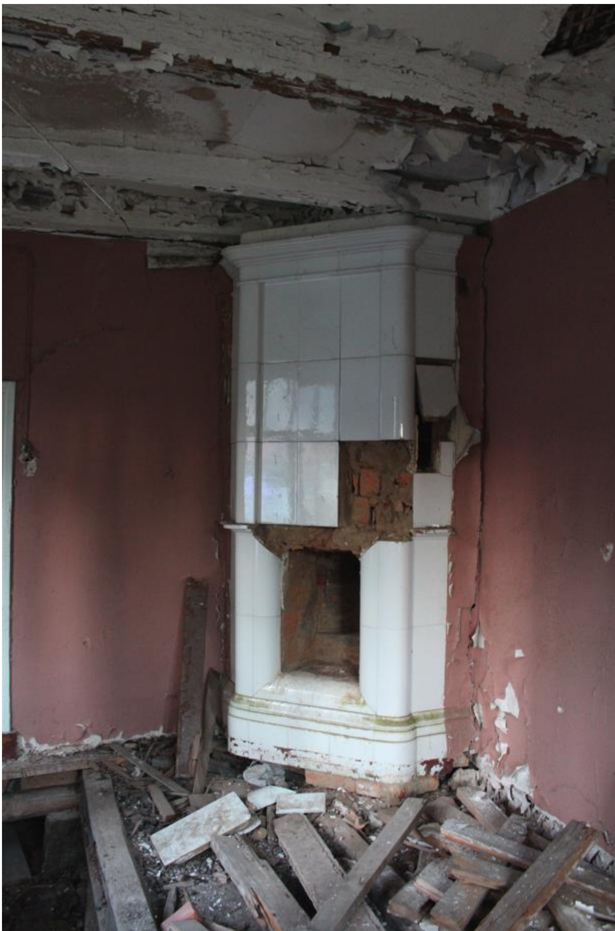
Фото 41. Вид на помещения 1-го этажа исследуемого объекта.
