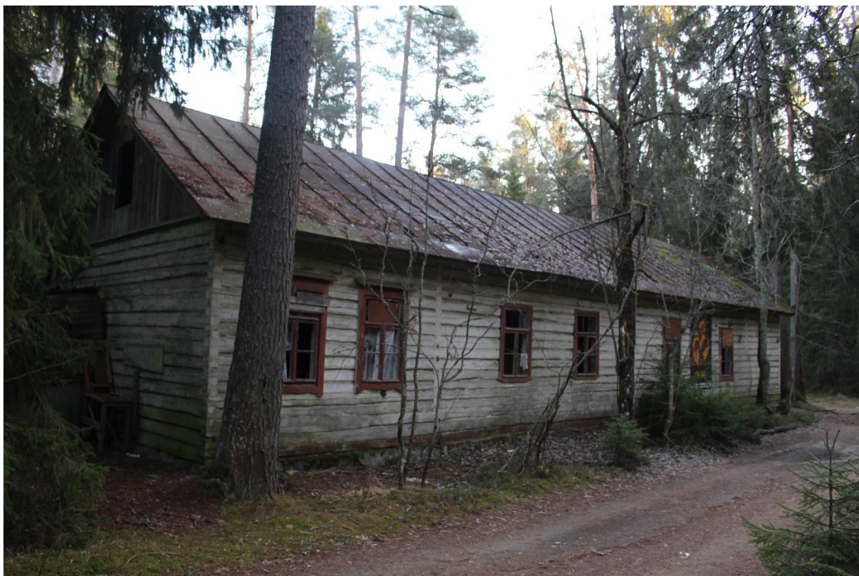
Фото 33. Вид на западный фасад служебного корпуса.
