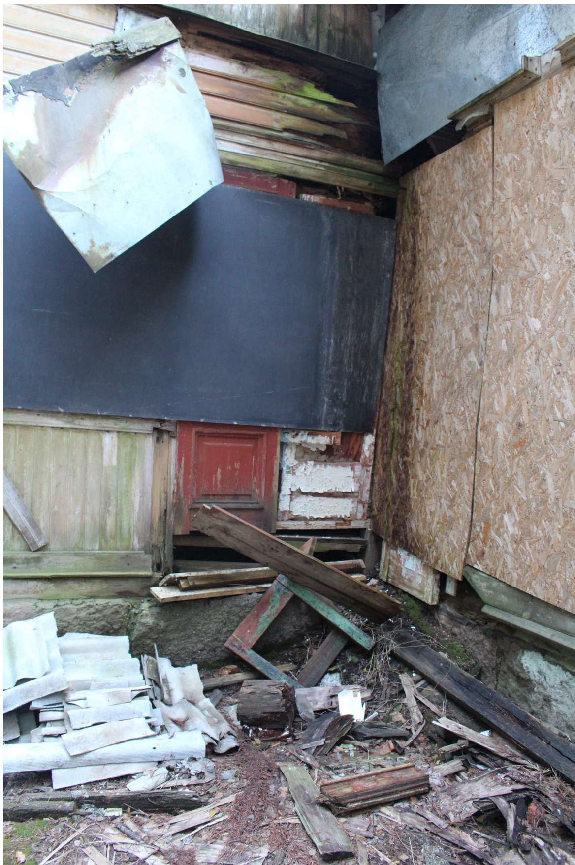
Фото 12. Вид на восточный фасад выявленного объекта культурного наследия «Усадьба Старк».
