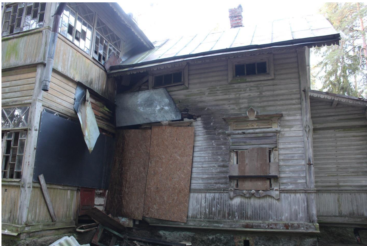
Фото 11. Вид на восточный фасад выявленного объекта культурного наследия «Усадьба Старк».
