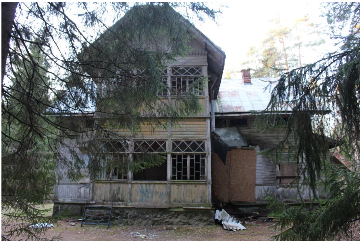
Фото 9. Вид на восточный фасад выявленного объекта культурного наследия «Усадьба Старк».
