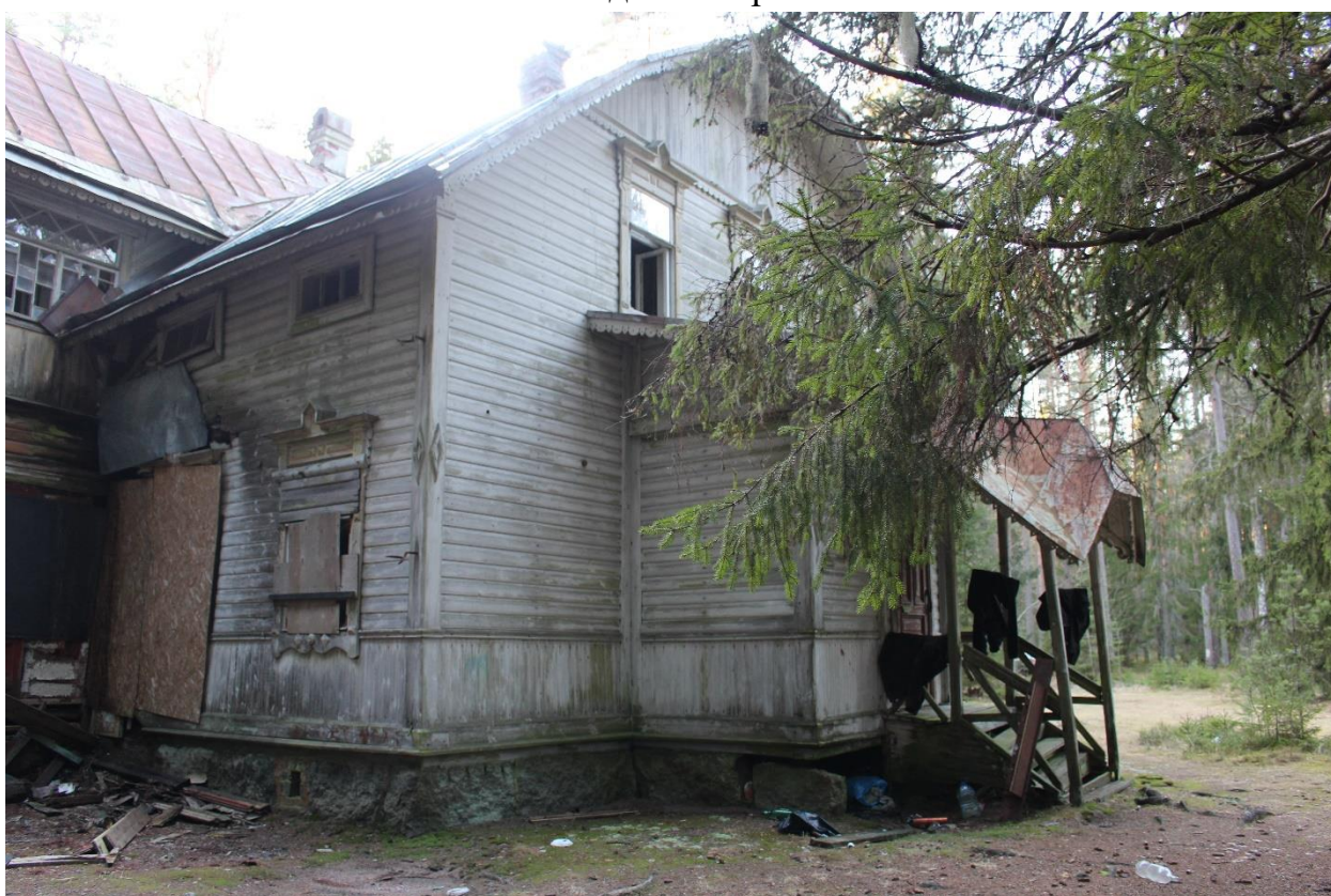
Фото 14. Вид на северный фасад выявленного объекта культурного наследия «Усадьба Старк».
