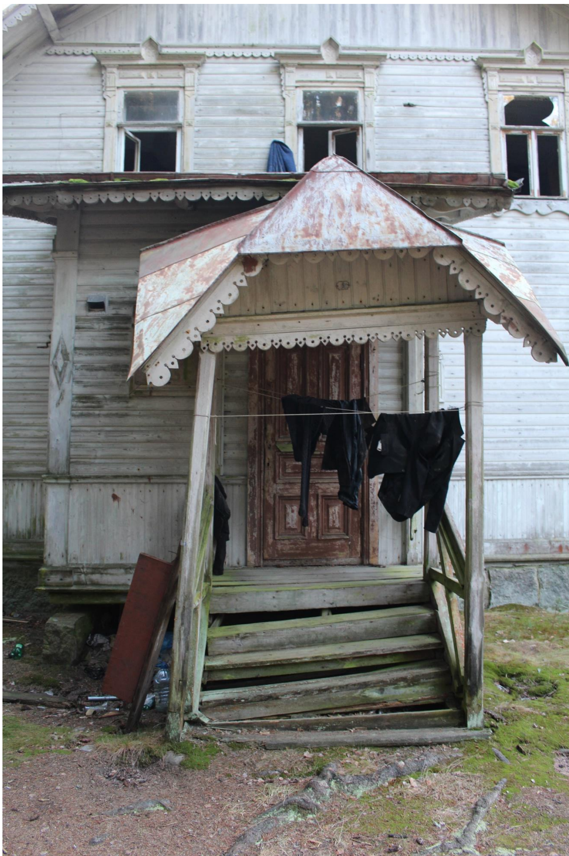
Фото 16. Вид на северный фасад выявленного объекта культурного наследия «Усадьба Старк».
