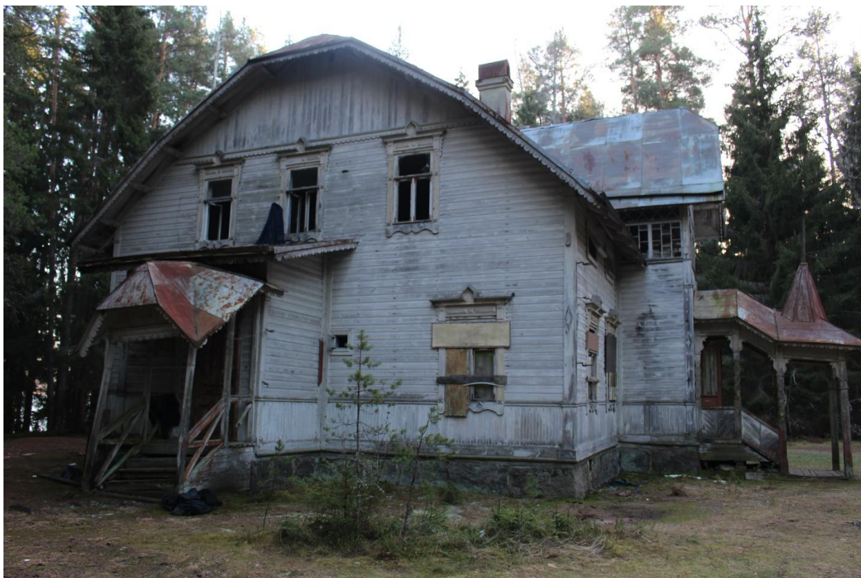
Фото 18. Вид на северный фасад выявленного объекта культурного наследия «Усадьба Старк».
