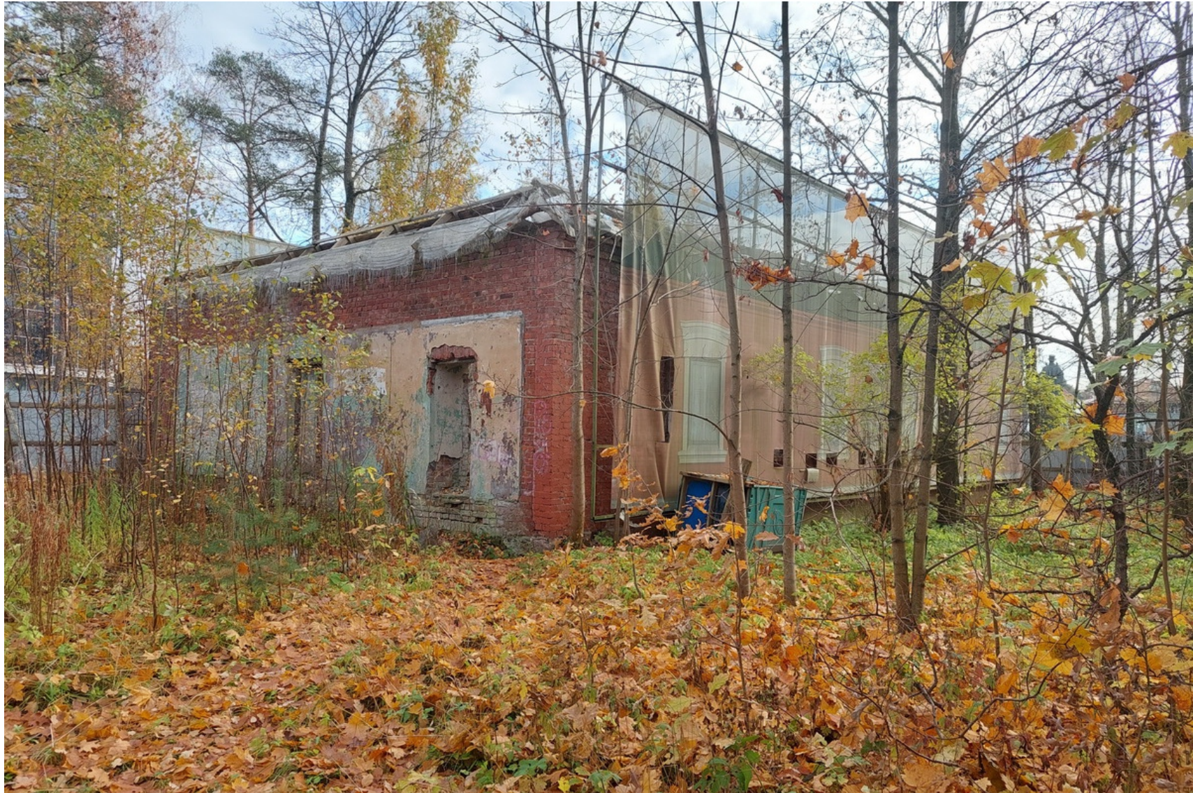
24 ОКН регионального значения "Дом купца Н.Н. Хомякова, нач. XX в.", Ленинградская обл., Всеволожский муниципальный район, г. Всеволожск, Всеволожский пр., 36. Северный и западный фасады. Вид с Заводской ул. Дата съемки: 20.10.2025 г.
