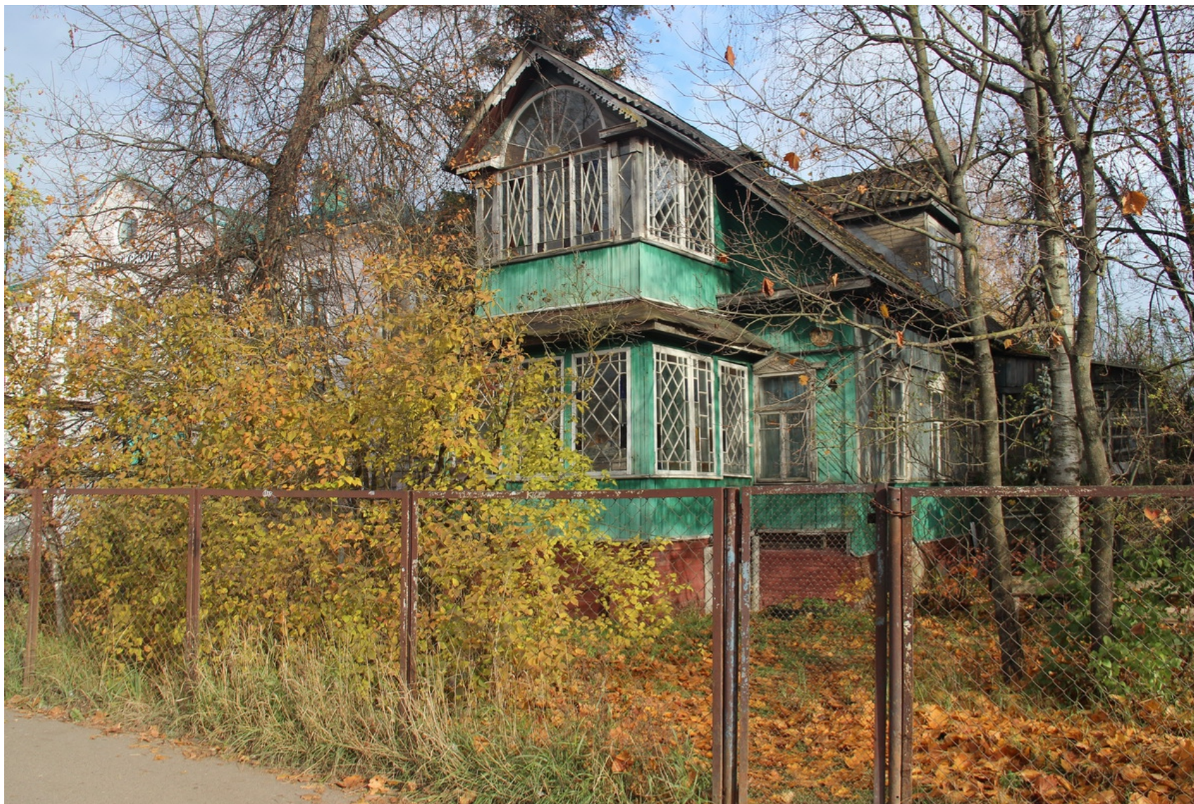
18 Вид на северо-восток на застройку восточной стороны Всеволожского пр. на дом № 31. Дата съемки: 20.10.2025 г.
