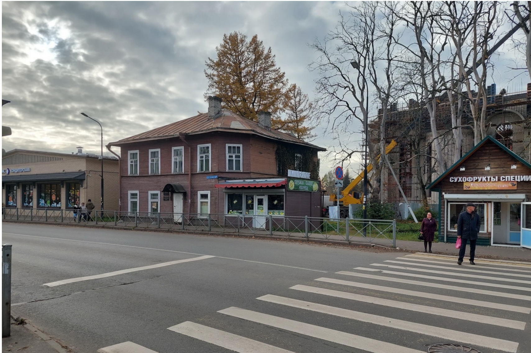
1 ОКН регионального значения "Малый гостиный двор К.Ф. Штейнмейера", кон. XIX в. - нач. XX в. Ленинградская обл., Всеволожский муниципальный район, г. Всеволожск, Всеволожский пр., 44. Восточный и северный фасады. Вид с Всеволожского пр. Дата съемки: 20.10.2025 г.
