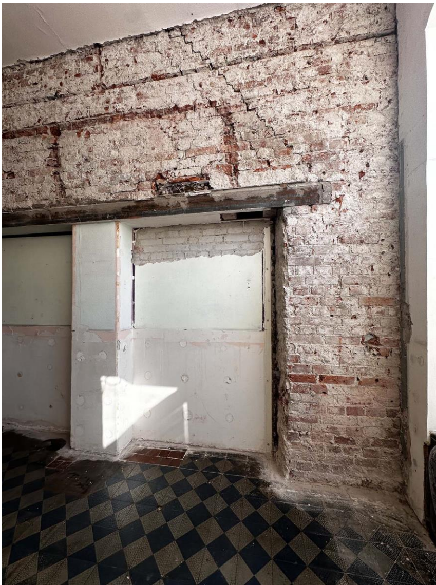
Фото 12. Пом. 1.2. Правый заложный проем, пробитый в послевоенное время. Дата съемки: 17.03.2026 г. Автор съемки: Куваева Ю.П.
