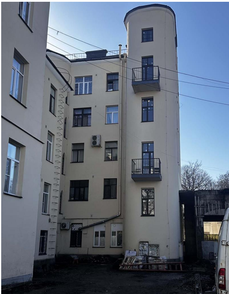
Фото 4. Общий вид правой части северо-восточного дворового фасада здания. Дата съемки: 17.03.2026 г. Автор съемки: Куваева Ю.П.
