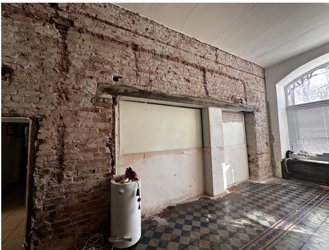
Фото 10. Пом. 1.2. Вид на заложенные проемы, пробитые в послевоенное время. Дата съемки: 17.03.2026 г. Автор съемки: Куваева Ю.П.
