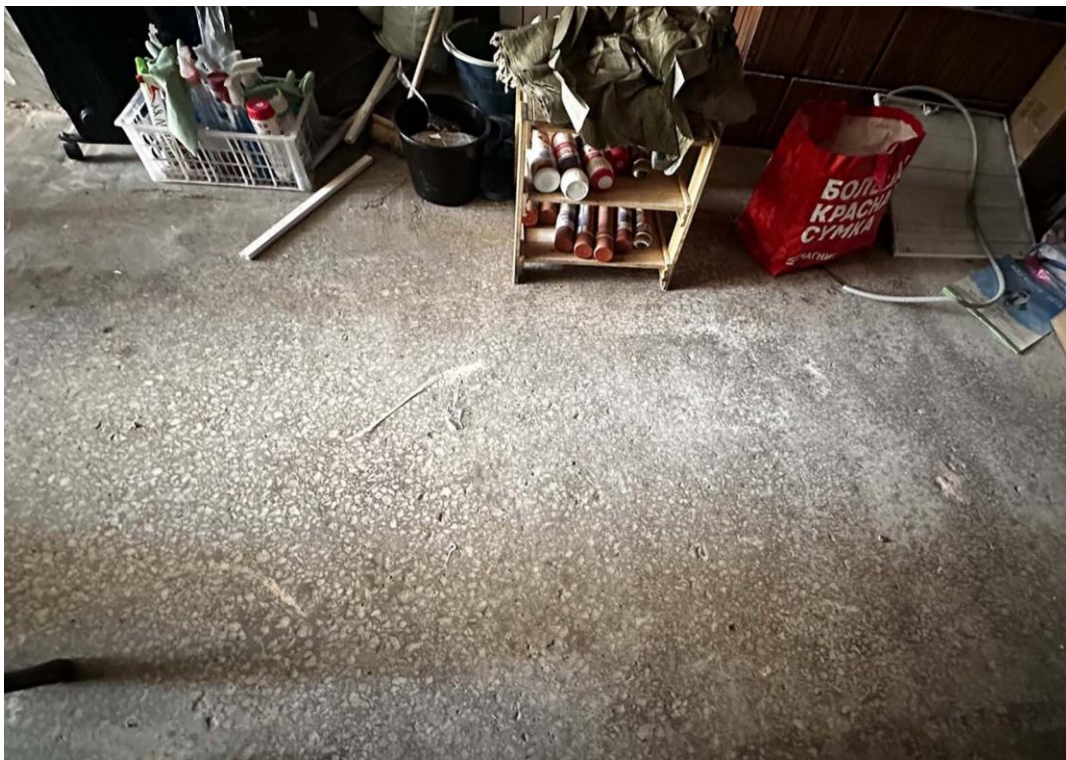
Фото 16. Пом. 1.3. Бетонное мозаичное покрытие пола. Дата съемки: 17.03.2026 г. Автор съемки: Куваева Ю.П.
