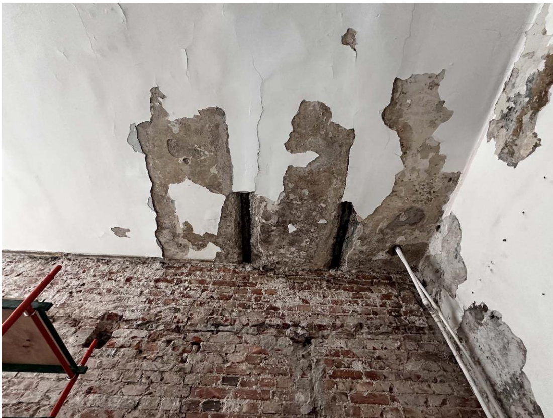
Фото 9. Пом. 1.2. Фрагмент северо-западной наружной стены и перекрытия (замоноличенных кирпичных сводов «монье»). Дата съемки: 17.03.2026 г. Автор съемки: Куваева Ю.П.
