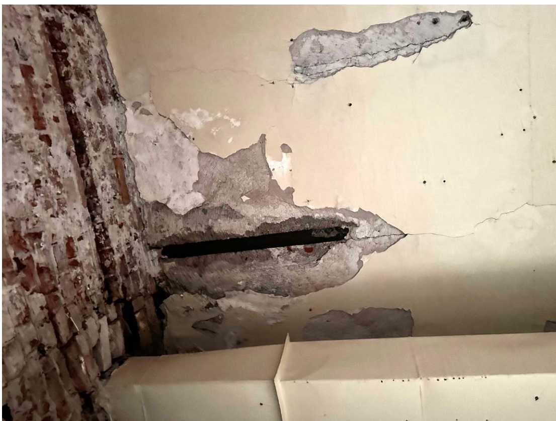
Фото 15. Пом. 1.3. Фрагмент перекрытия в виде замоноличенных кирпичных сводов «монье» в южном углу помещения. Дата съемки: 17.03.2026 г. Автор съемки: Куваева Ю.П.
