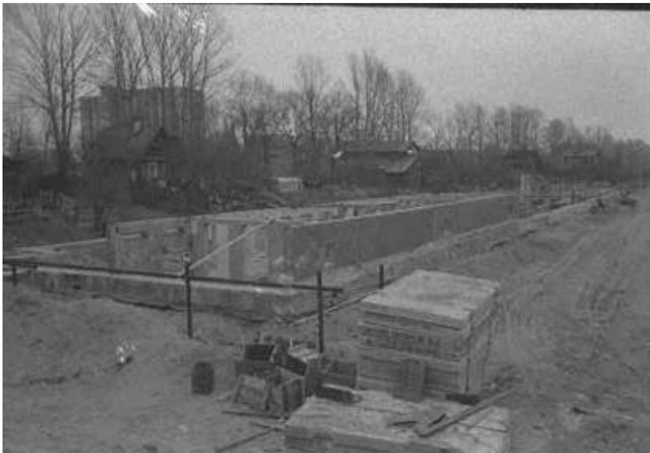
Илл. 2.2.15. Негатив. Строительство дома №14 по Малоневскому каналу. Из комплекта: Гражданское строительство, проводимое Невским заводом, 1983 г. В кадре фундамент дома № 14 по Малоневскому каналу. За ним деревянные одноэтажные жилые дома вдоль канала и голые деревья. На заднем плане девятиэтажное здание общежития Невского ССЗ. Источник: https://goskatalog.ru/portal/#/collections?id=3900218
