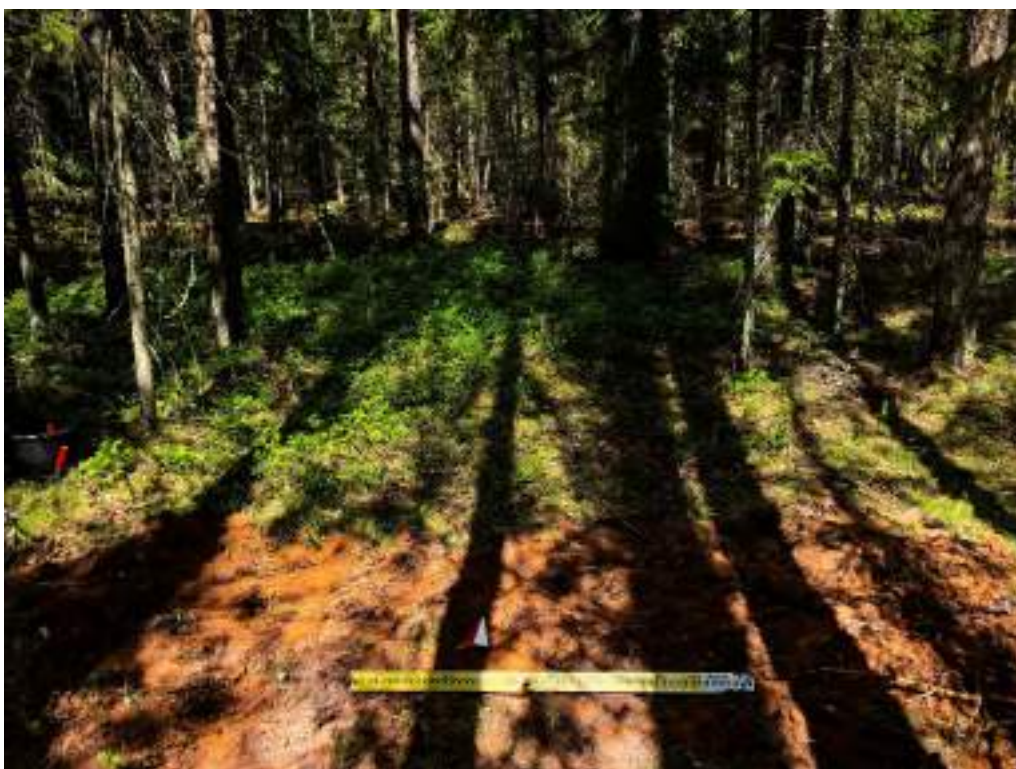
Илл. 555. Ленинградская обл., Тосненский р-он, Шапкинское с.п. – 2026 г. Шурф №77. Засыпка. Вид с Ю.
