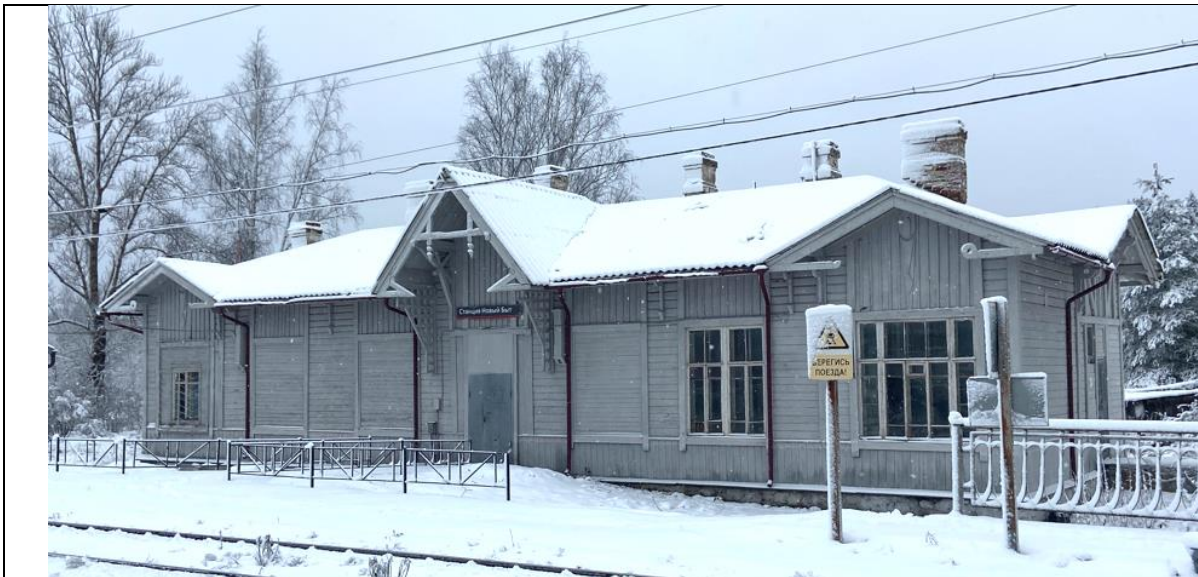
Лицевой фасад железнодорожного вокзала станции Новый Быт.
