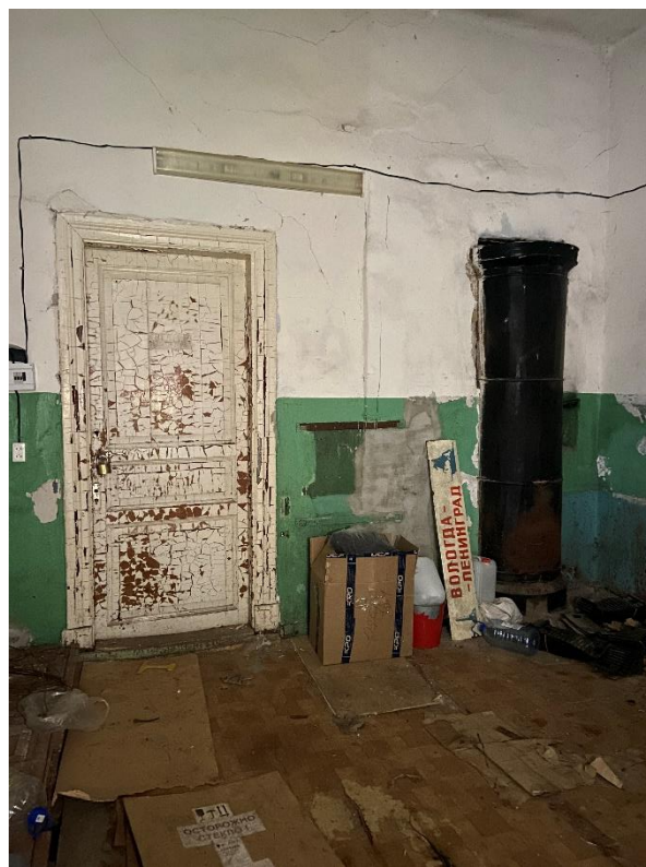
Фото 2. Вид на помещение исследуемого объекта.
