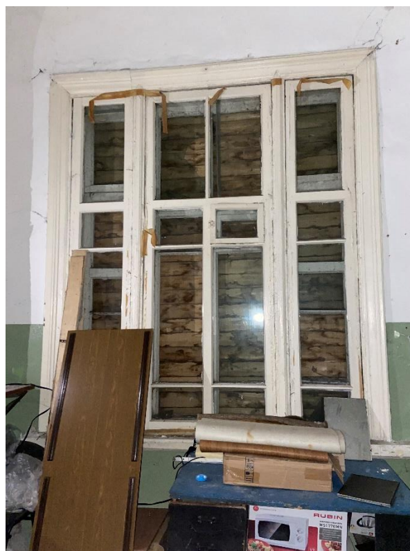
Фото 4. Вид на помещение исследуемого объекта.
