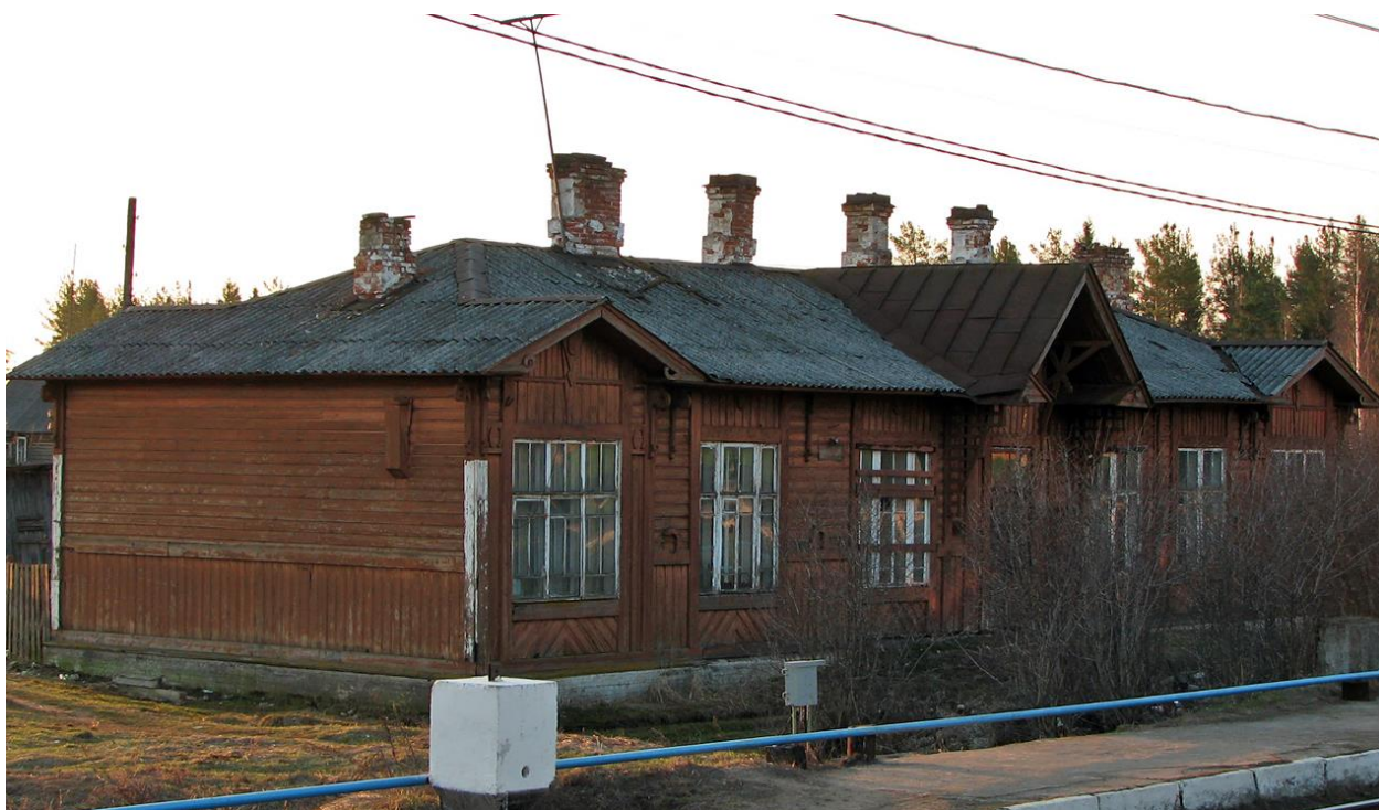
Илл. 12. Вокзал на железнодорожной станции «Валя». Дата: 2006 г. Источник: https://railgallery.ru/photo/237046/?&lang=ru
