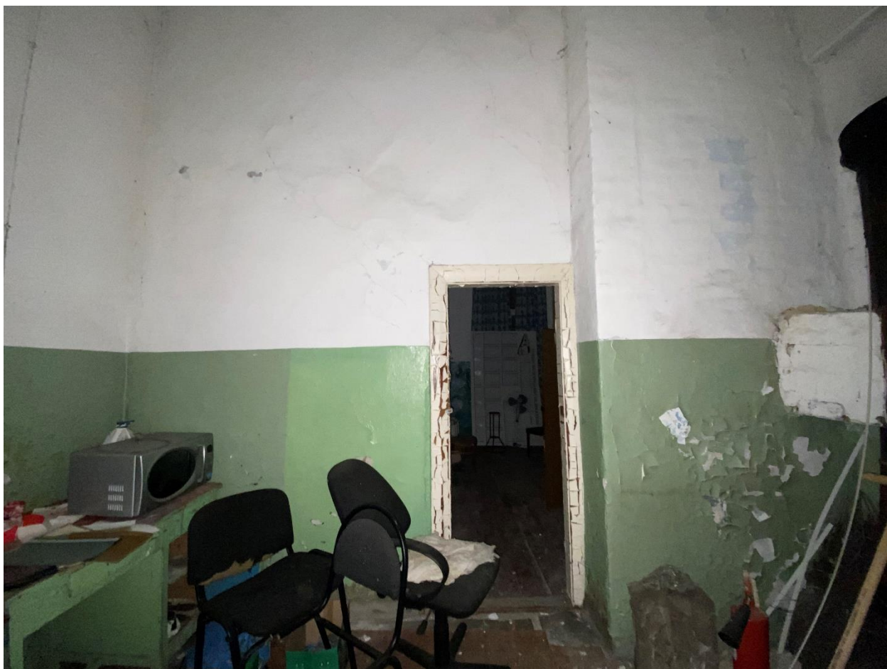
Фото 5. Вид на помещение исследуемого объекта.
