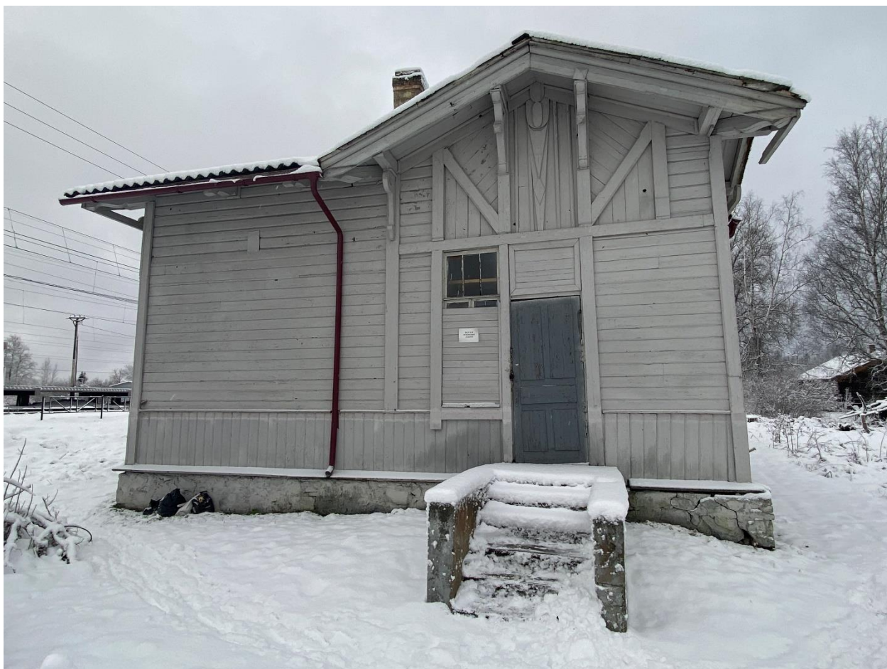
Фото 4. Восточный фасад здания вокзала.
