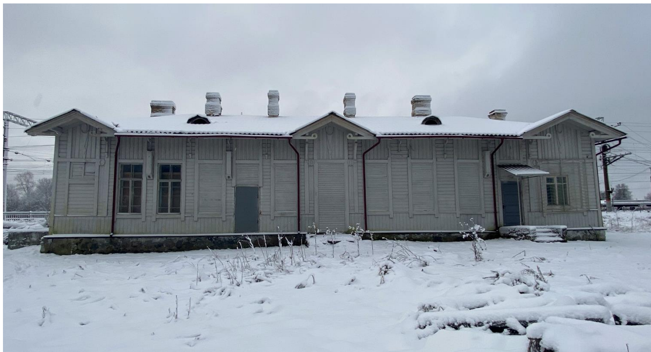
Фото 5. Северный фасад здания вокзала.
