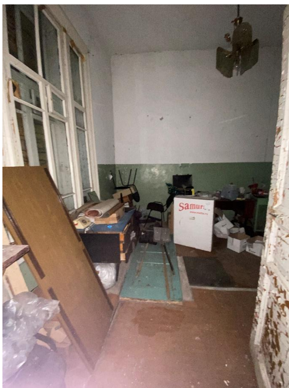
Фото 3. Вид на помещение исследуемого объекта.
