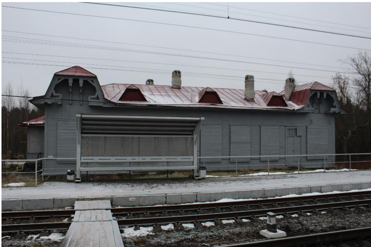
1. Лицевой фасад со стороны платформы.
