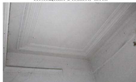
Помещение в северной части
