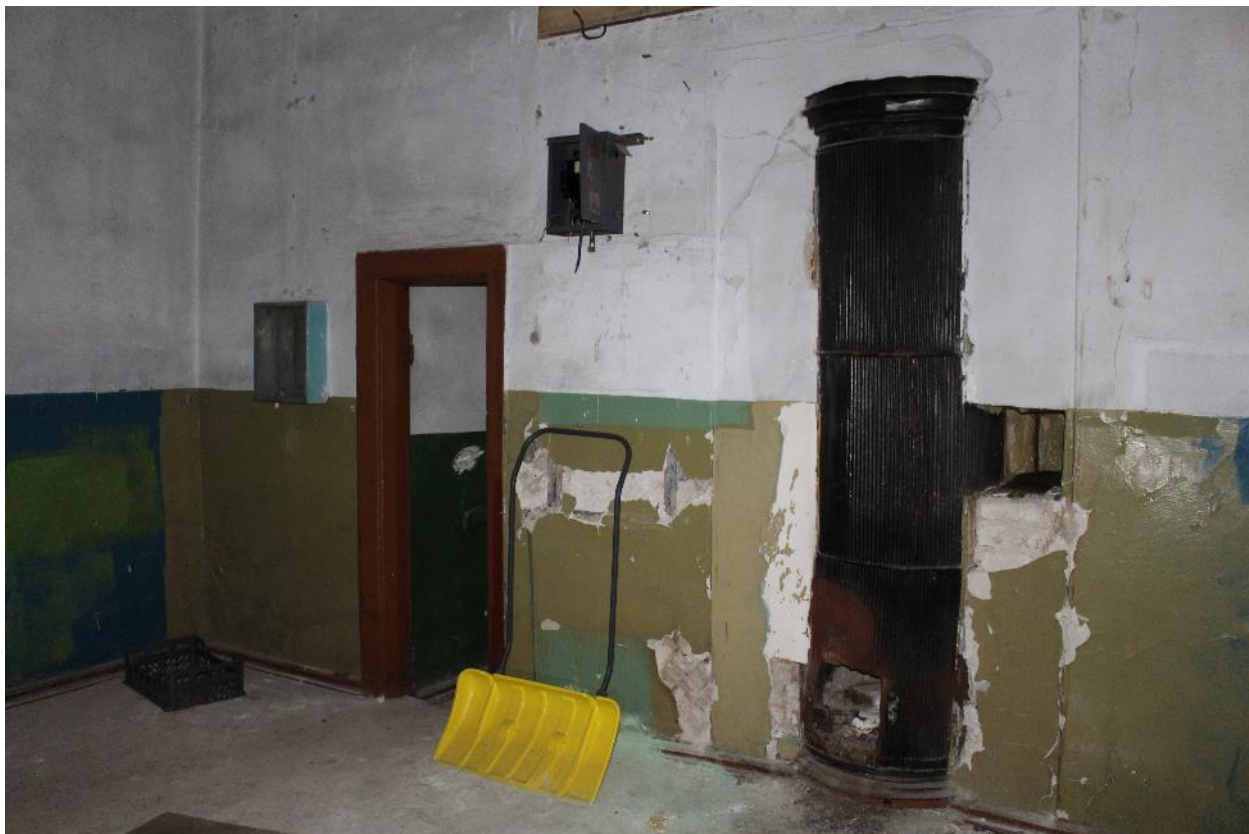
29. Помещение лицевого фасада.
