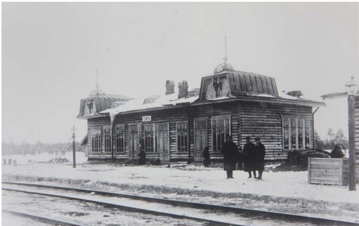
Илл. 38. Типовое здание вокзала на станции Свирь. Датировка — 1910-е гг. В настоящее время снесено. Фотография из фондов национального музея республики Карелия. [Электронный ресурс] // URL: https://vk.com/@8247598-stanciya-pasha .
