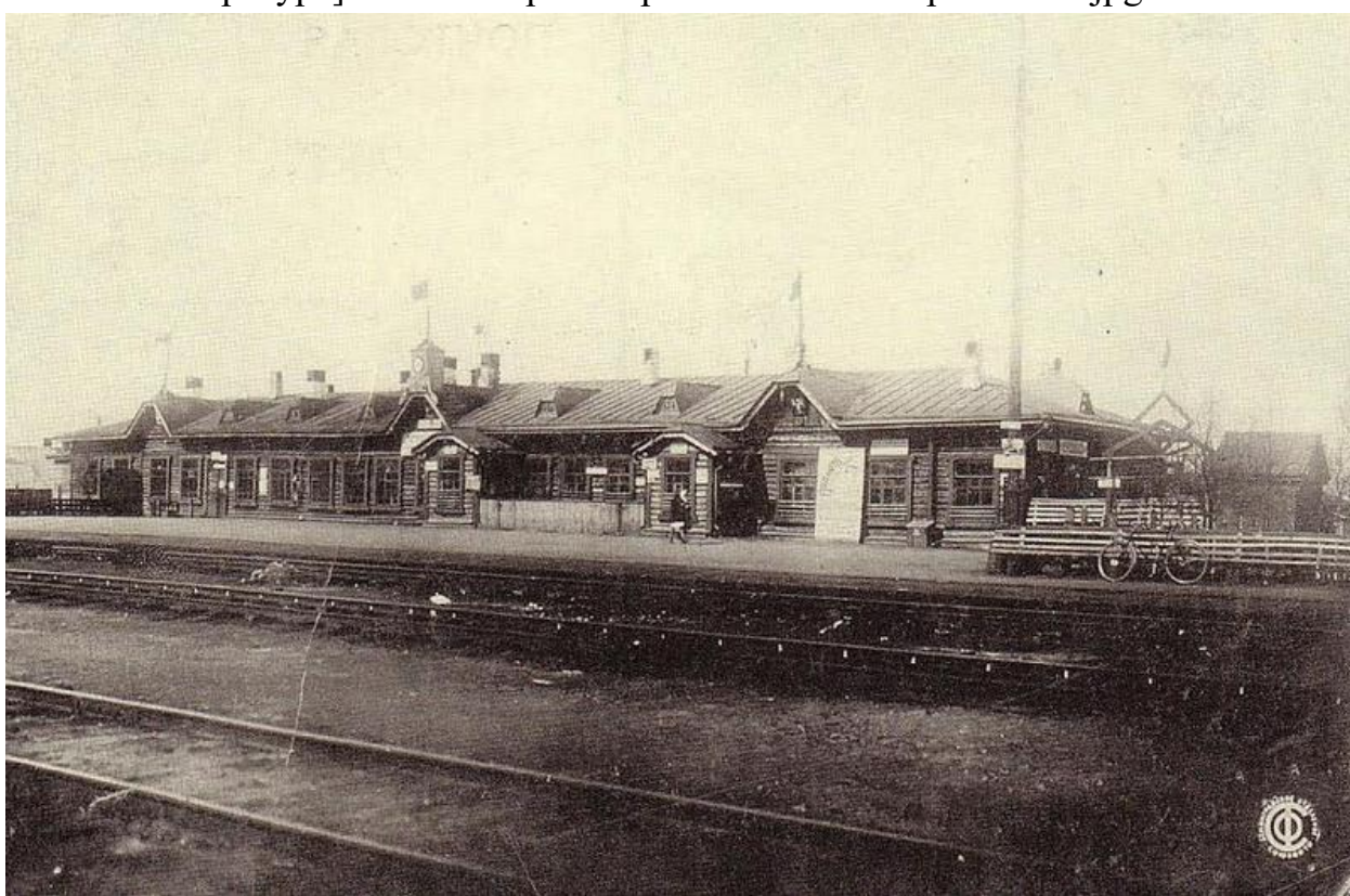
Илл. 41. Вокзал станции Петрозаводск до реконструкции. С открытки 1930-х гг. Город Петрозаводск и железная дорога. Архитектурные взаимоотношения. Ициксон Е. Интернет-журнал «Лицей». 09.03.2016.
