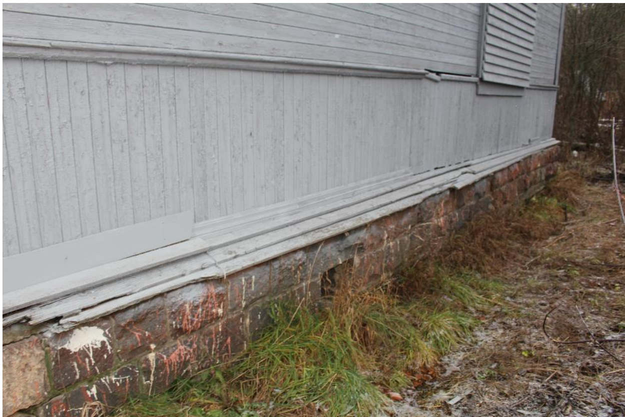
11. Цоколь и отмостка вдоль южного фасада.
