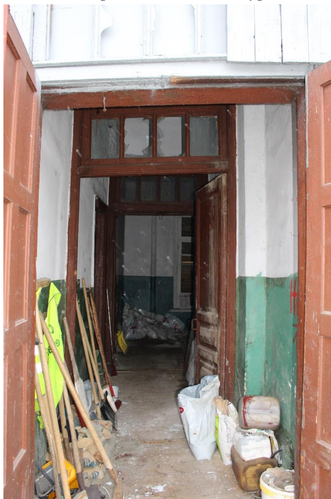
40. Вид помещений при южном входе.
