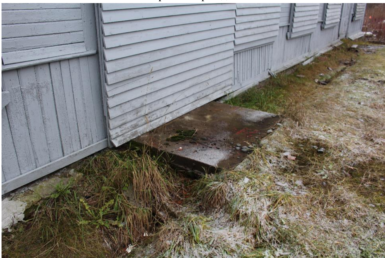
10. Цоколь и вход с западной лицевой стороны.
