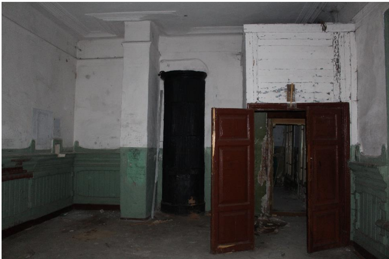
31. Северное помещение и тамбур второго выхода.
