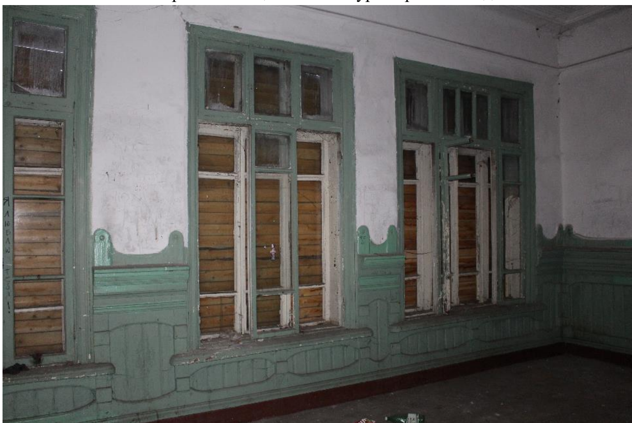
32. Окна лицевого фасада.
