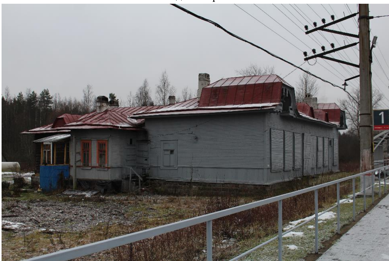
4. Общий вид с севера.
