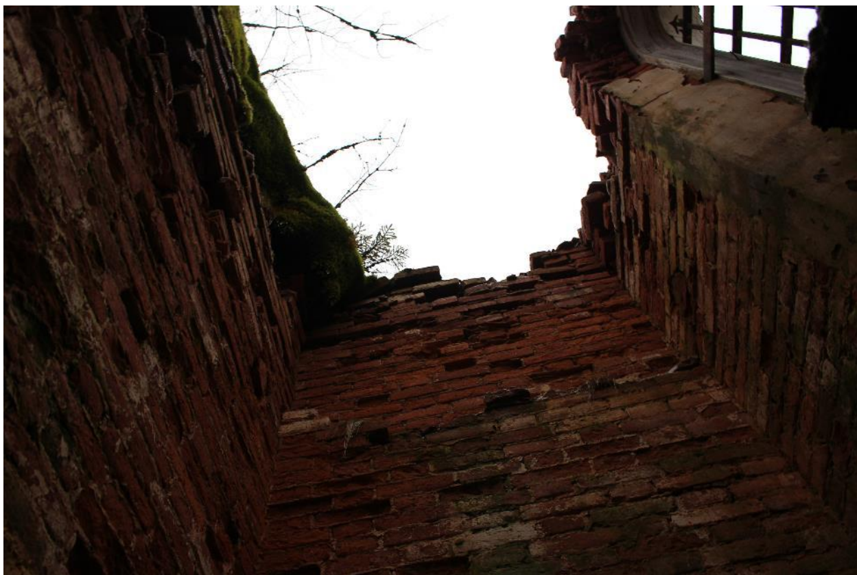
Фото 23. Перекрытие северного помещения у притвора.
