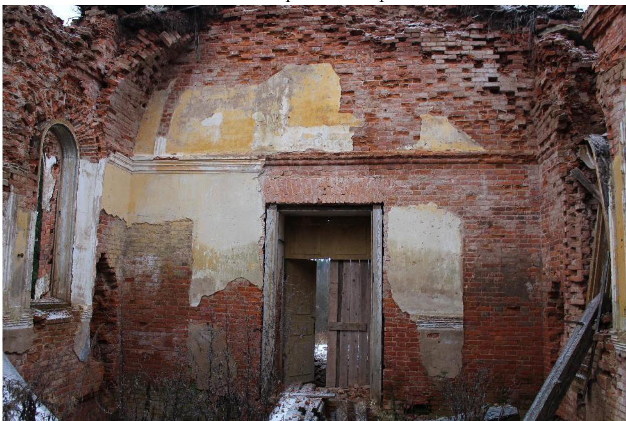
Фото 28. Вид на западную стену трапезной.
