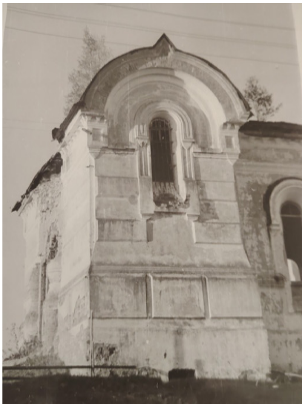
Илл. 28. Крестовоздвиженская церковь, XIX в. Село Часовенское. Вид на юго-западный угол здания, фото арх. Кондратьева. Архив Комитета по сохранению культурного наследия Ленинградской области. Д. 208-6.
