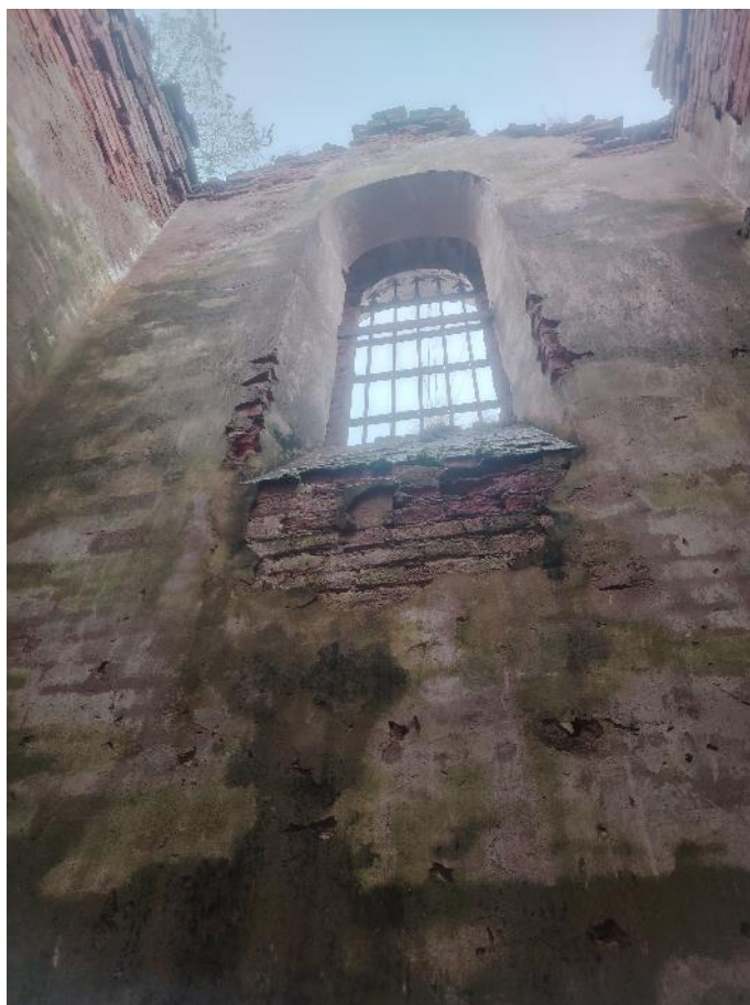
Фото 21. Южное помещение у притвора.
