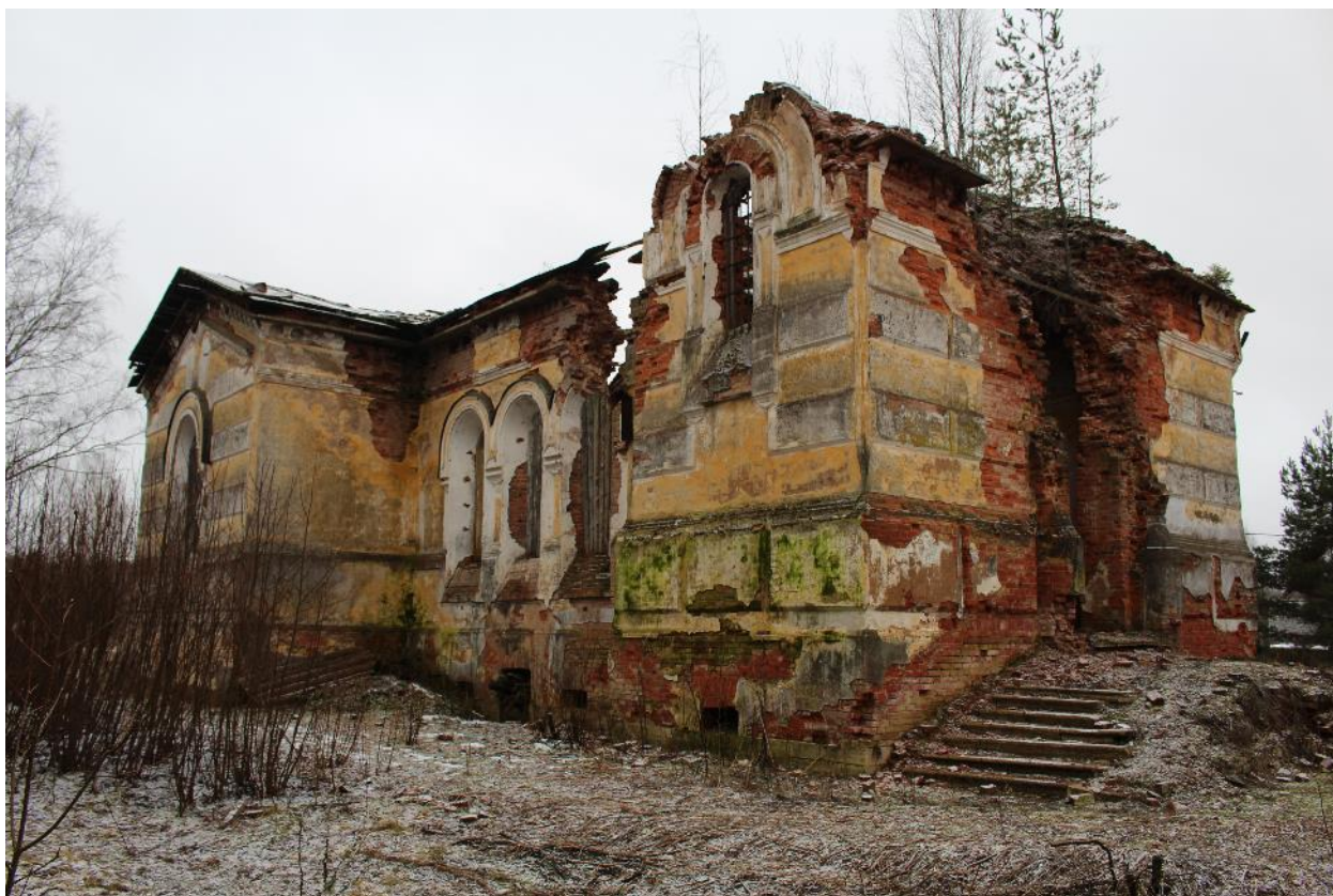
Фото 8. Общий вид с северо-запада.
