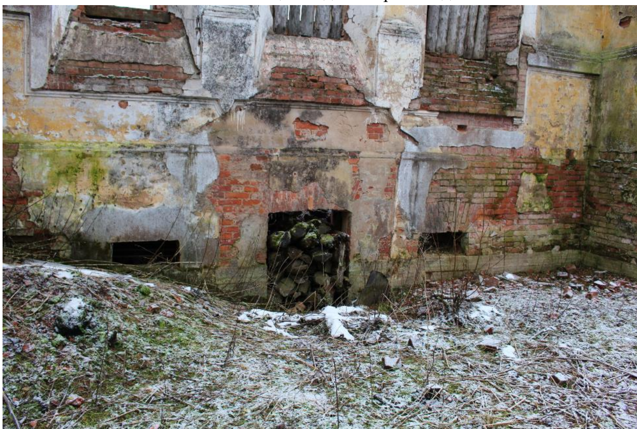
Фото 9. Вход в подвал с севера.
