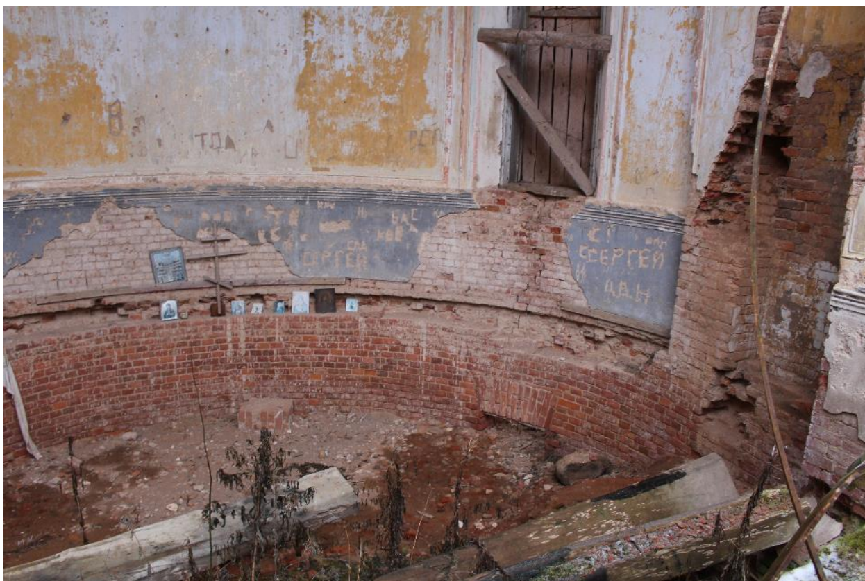
Фото 35. Алтарь, подвальная часть.
