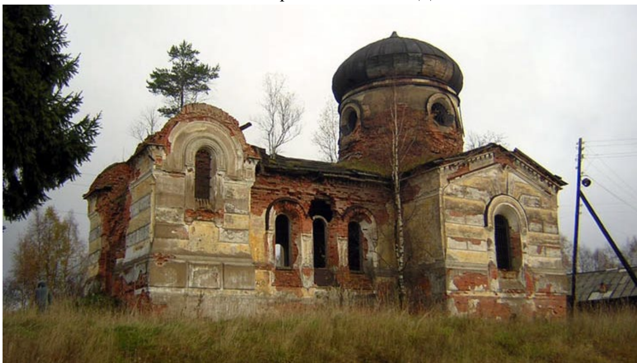
Илл. 41. Церковь Воздвижения Креста Господня, Часовенская, фасады. 2005 г. [Электронный ресурс] // URL: https://sobory.ru/photo/11038 .
