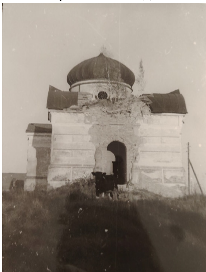
Илл. 31. Крестовоздвиженская церковь, XIX в. Село Часовенское. Западный фасад, фото 1968, арх. Кондратьева. Архив Комитета по сохранению культурного наследия Ленинградской области. Д. 208-9.
