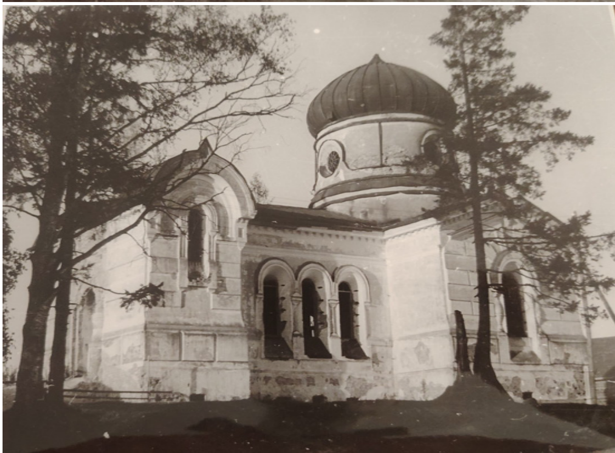
Илл. 32. Крестовоздвиженская церковь, XIX в. Село Часовенское. Южный фасад церкви, фото 1968, арх. Кондратьева. Архив Комитета по сохранению культурного наследия Ленинградской области. Д. 208-10.
