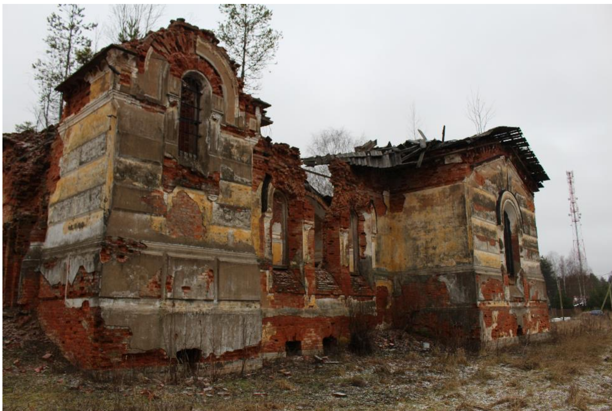
Фото 12. Общий вид с юго-запада.
