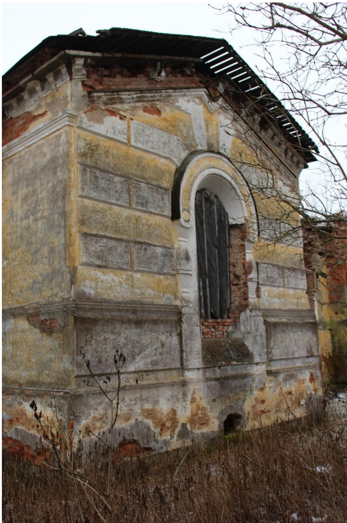
Фото 5. Фрагмент северного фасада.
