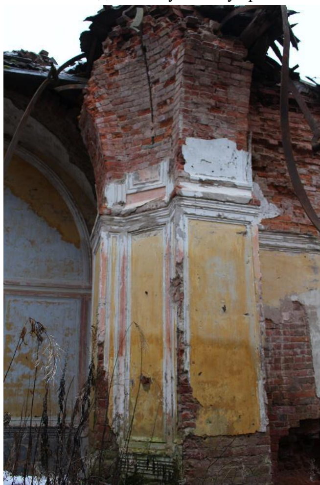
Фото 30. Юго-западная колонна центрального храма.
