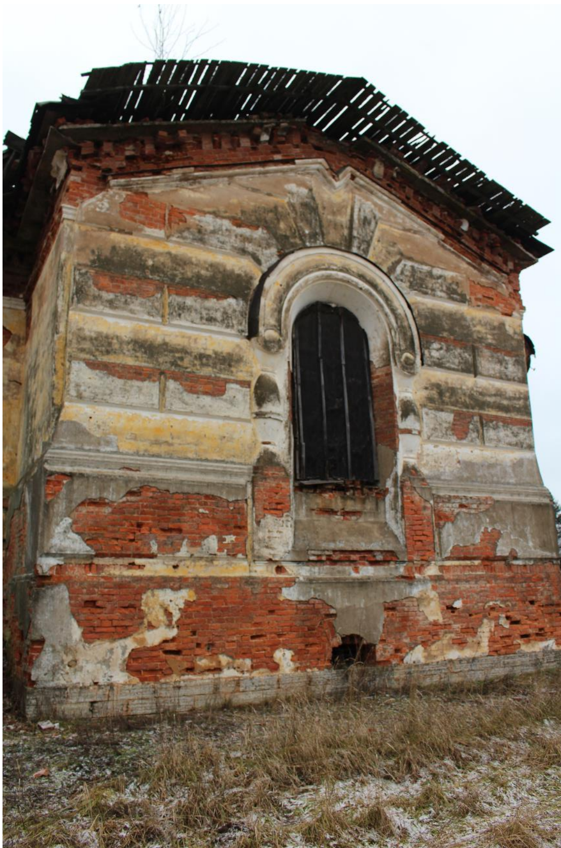
Фото 14. Фрагмент южного фасада.
