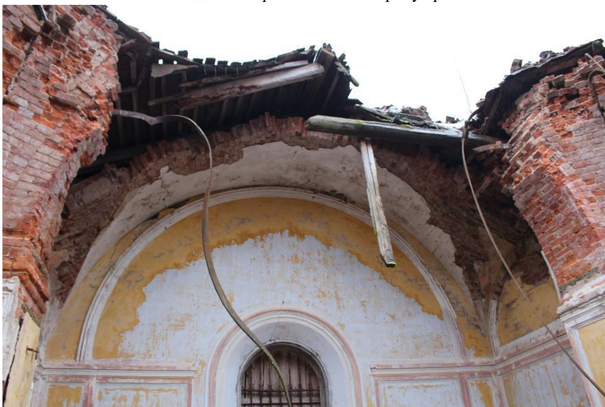
Фото 38. Перекрытие южной части центрального храма.
