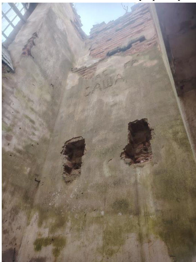
Фото 22. Южное помещение у притвора.
