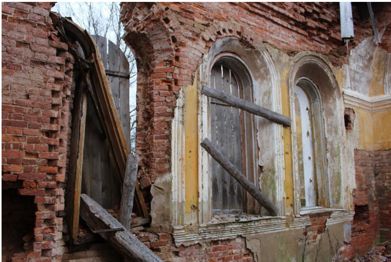
Фото 27. Северная стена трапезной.
