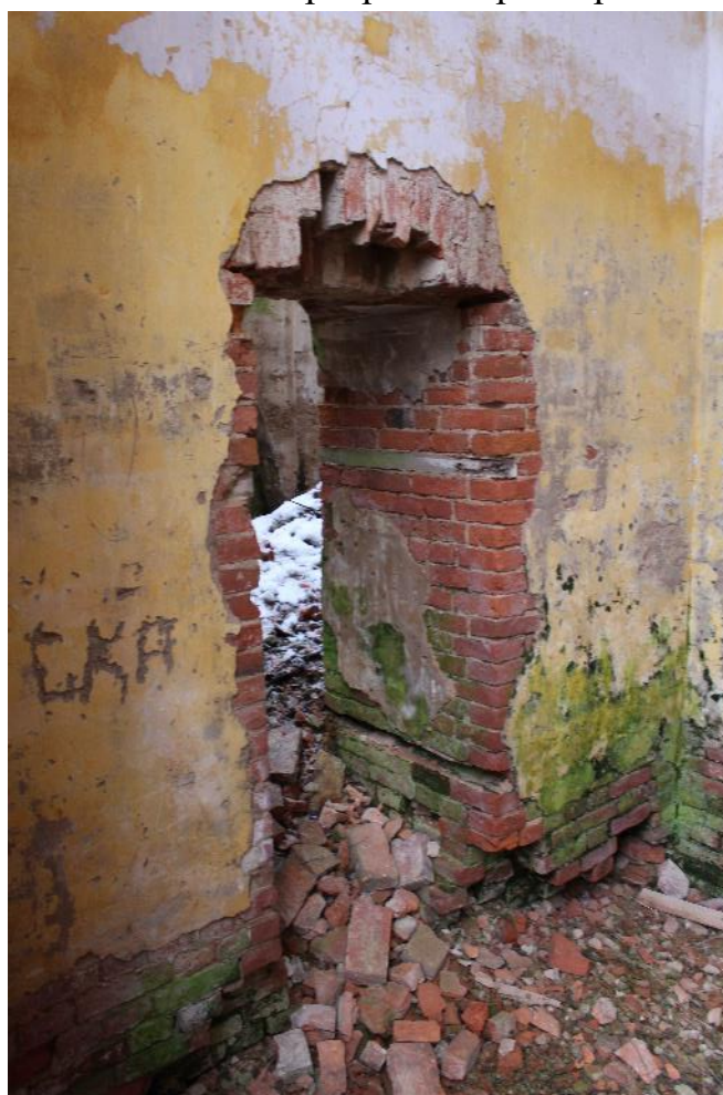
Фото 20. Прорез в южное помещение притвора.
