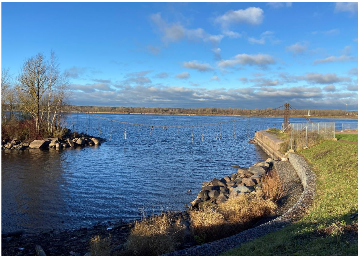
Фото 5. Вид на цепной мост с юго-востока.
