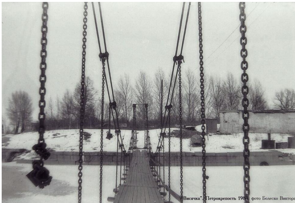
Илл. 15. Вид на висячий мост. Дата: 1984 г. Источник: pastvu.com.
