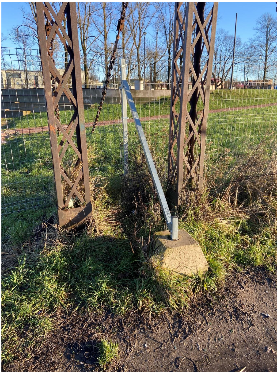
Фото 6. Вид на фрагмент конструкции моста.
