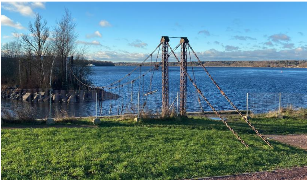
Вид на мост с материковой части. Дата: 14.11.2025.
