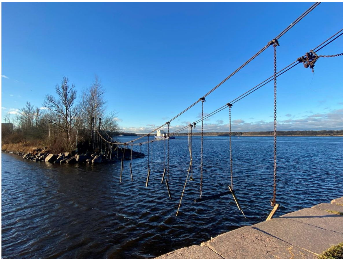
Фото 4. Вид на цепной мост с северо-востока.
