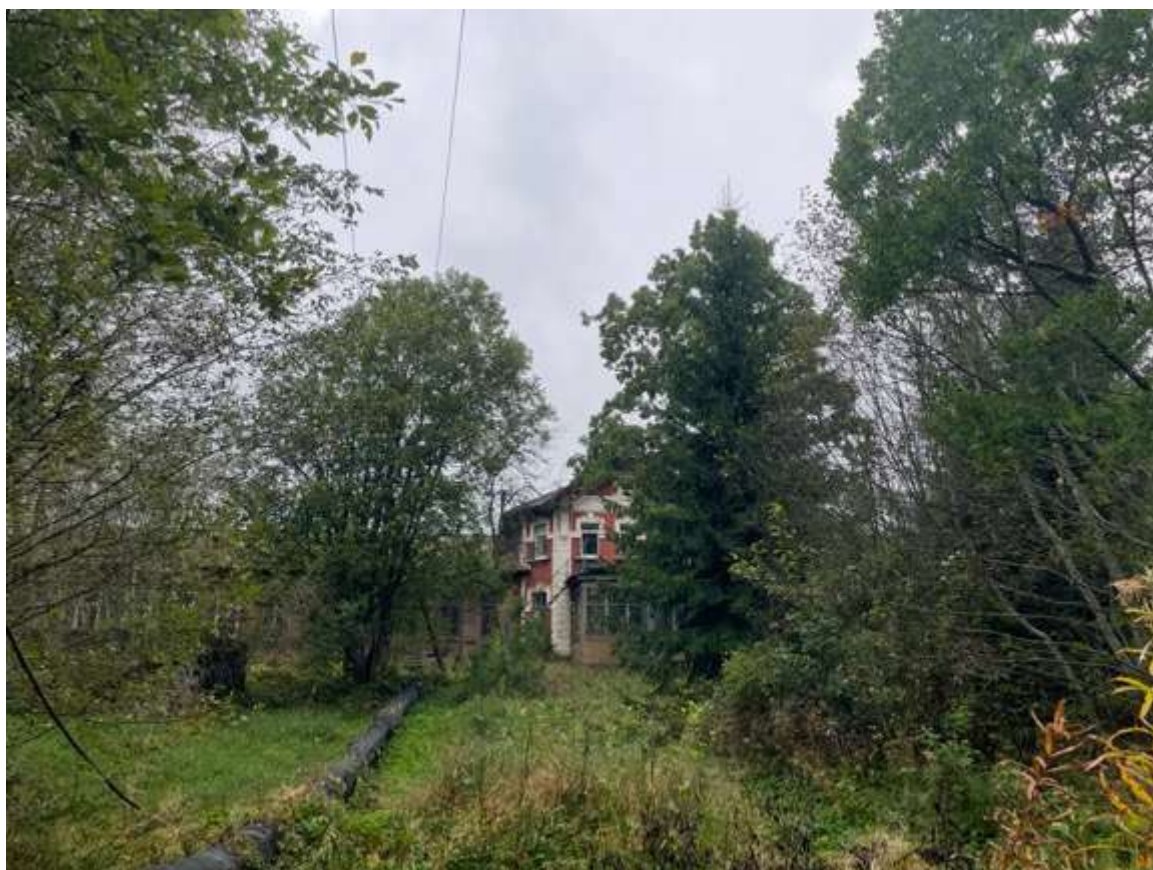
35. Вид восточного фасада
