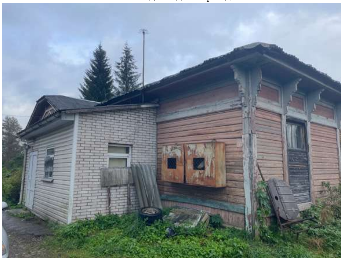
26. Вид северного фасада
