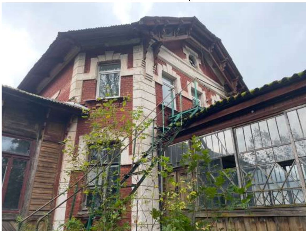
10. Вид восточного фасада
