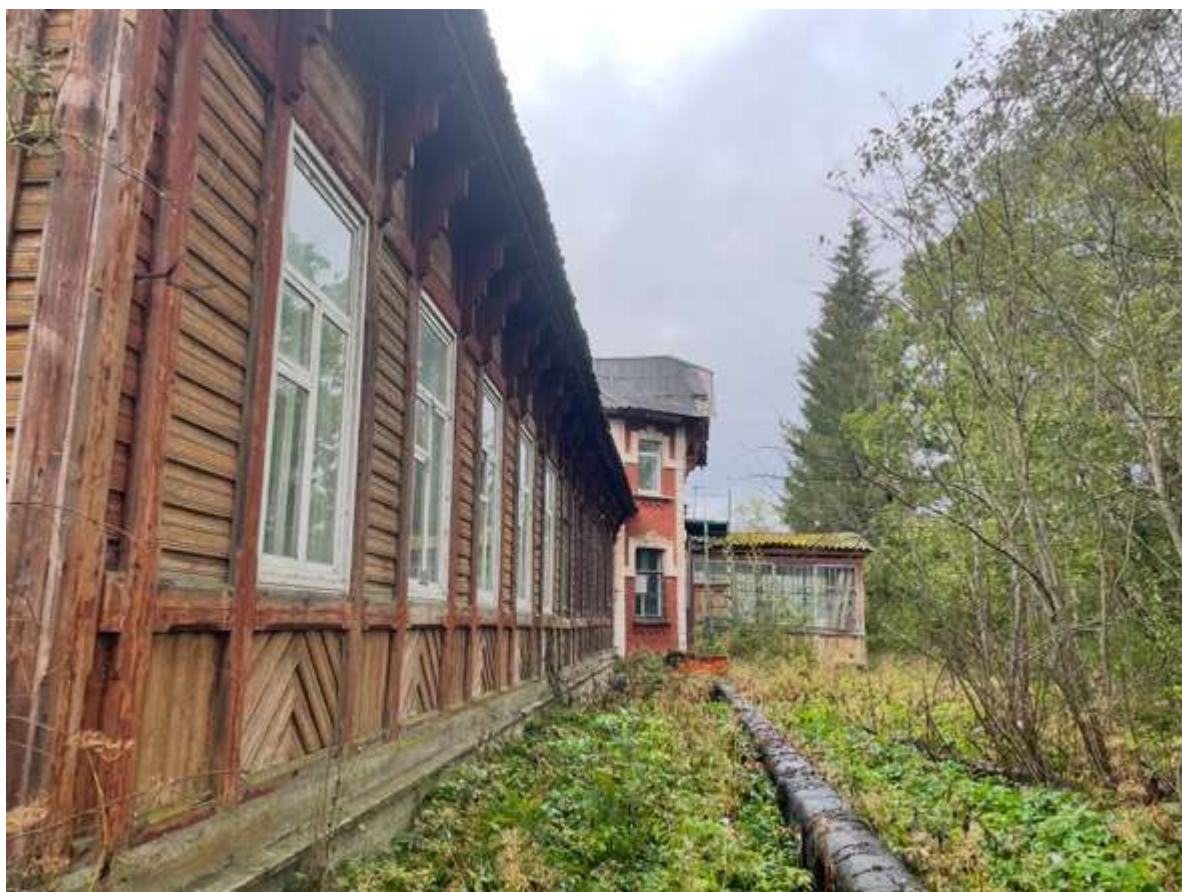
12. Вид восточного фасада
