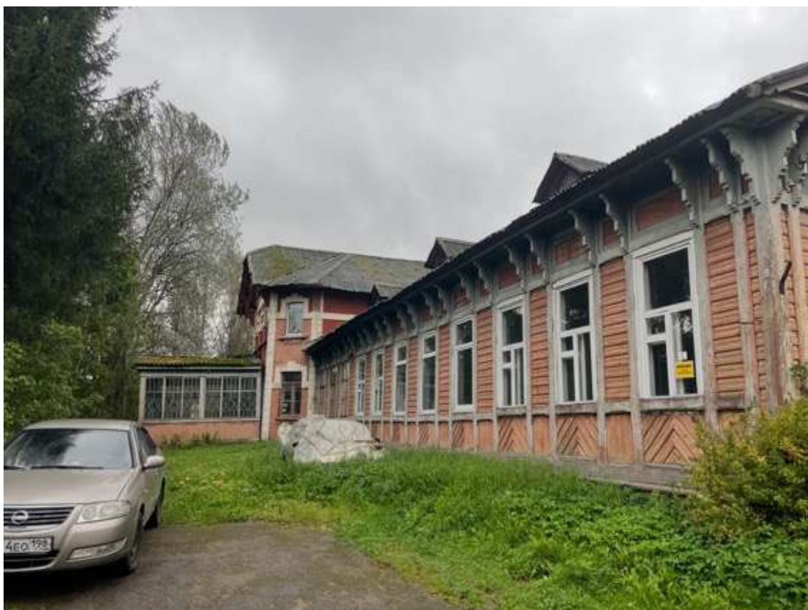
3. Вид восточного фасада
