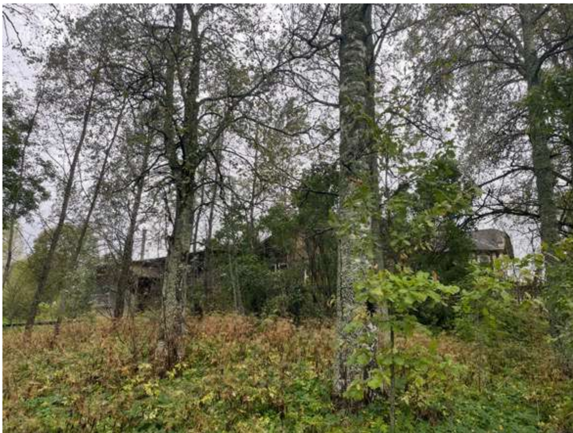
37. Вид северного фасада
