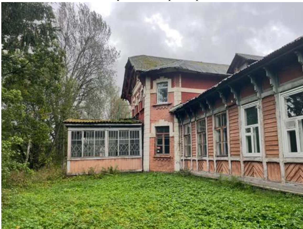
6. Вид восточного фасада
