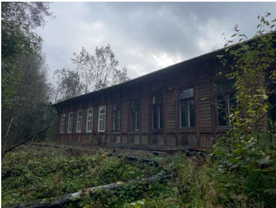
9. Вид восточного фасада
