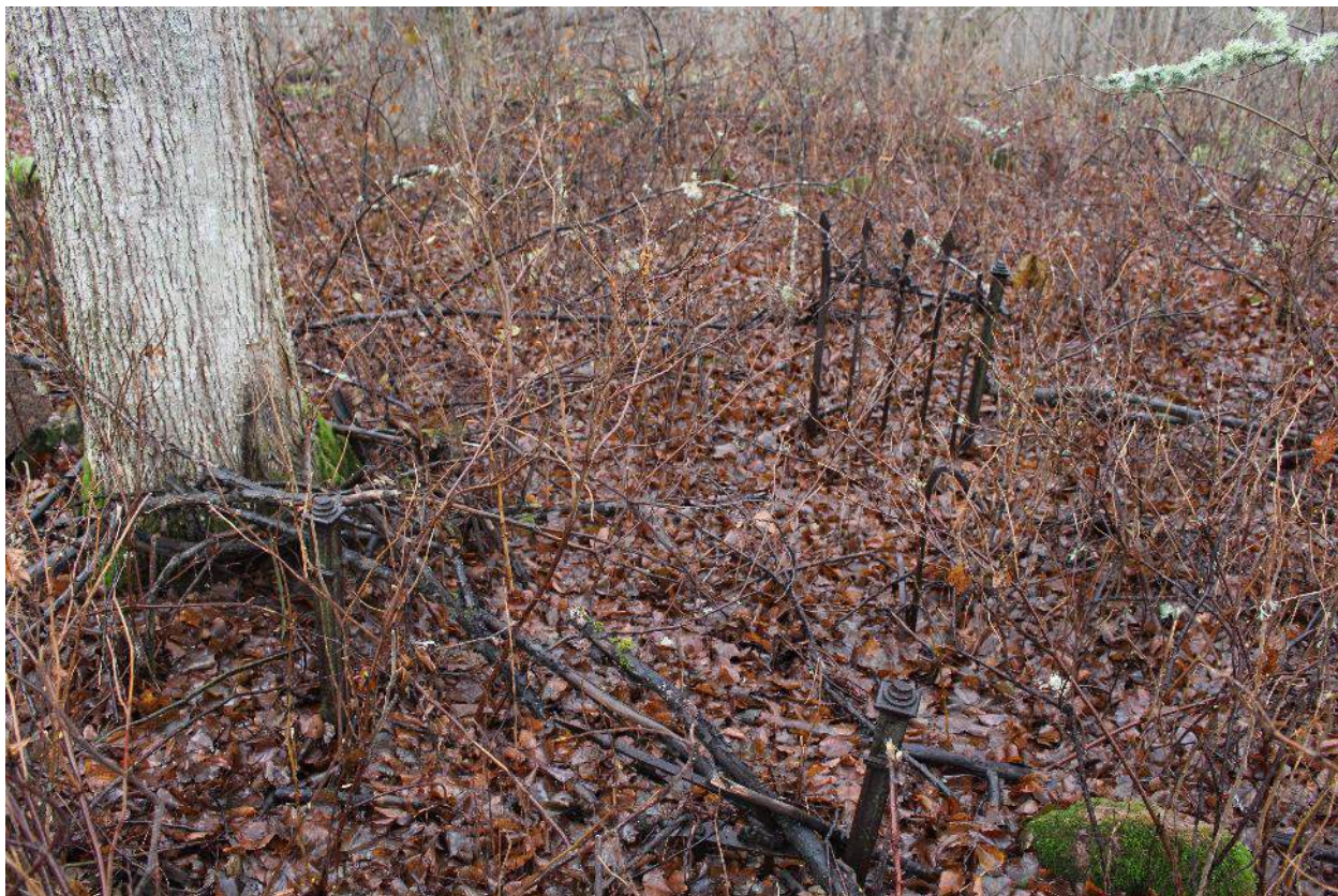
Фото 39. Фрагмент разрушенного ограждения.
