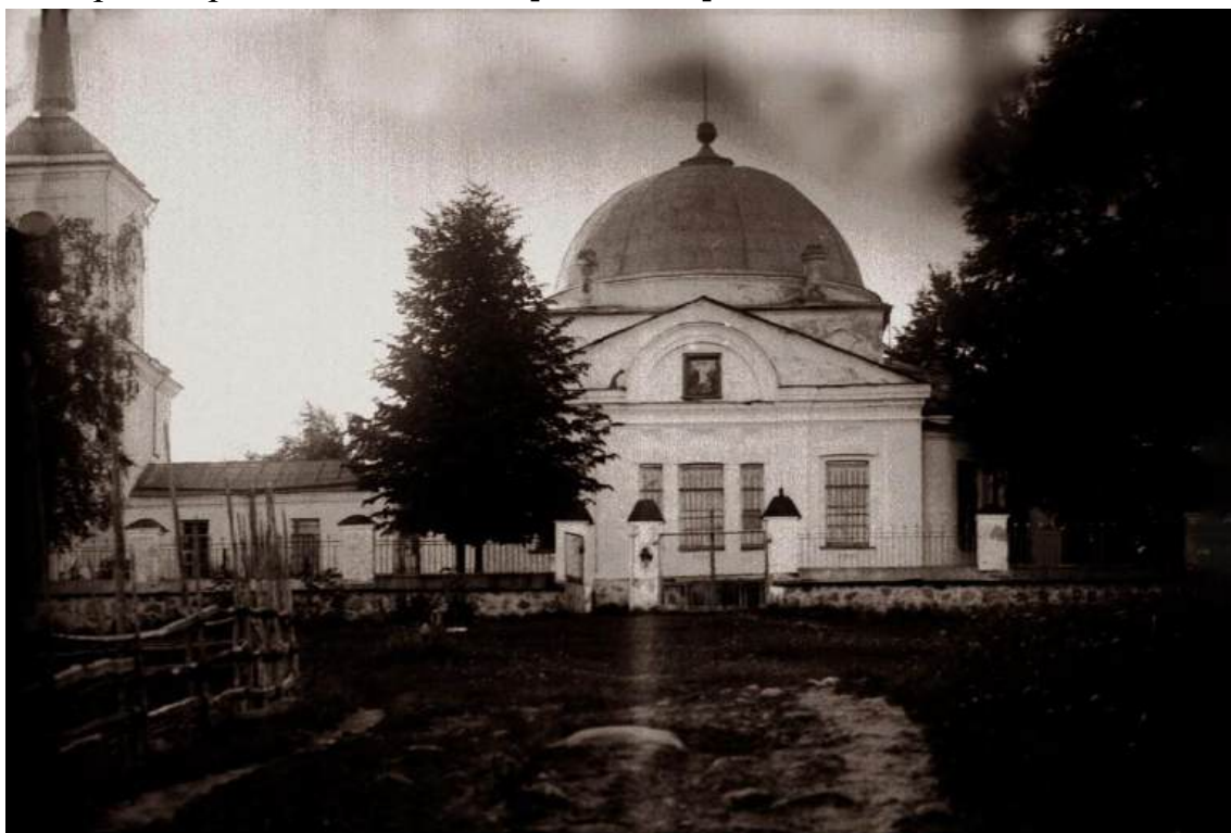
Илл. 37. Поддубье. Церковь Рождества Иоанна Предтечи (каменная). Фото 1928 г. Фотоархив ИИМК РАН. [Электронный ресурс] // URL: https://sobory.ru/photo/497305 .
