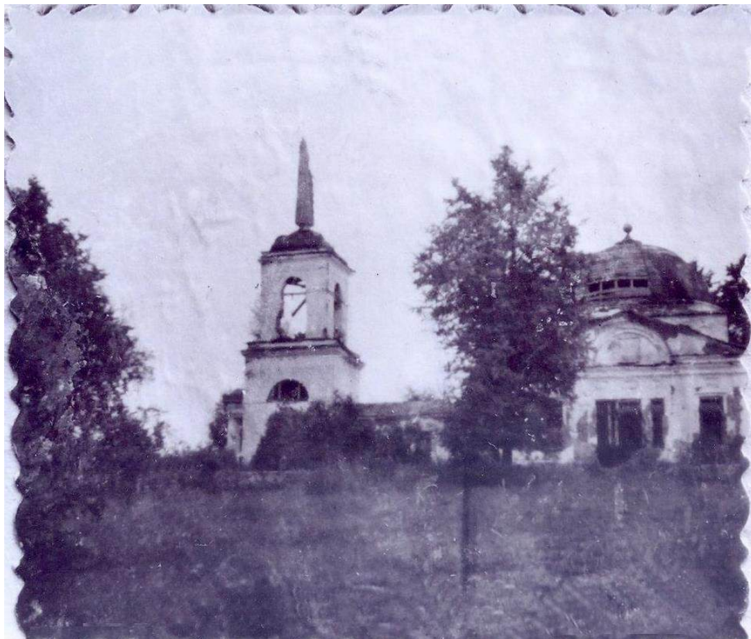
Илл. 38. Поддубье. Церковь Рождества Иоанна Предтечи (каменная). Фото 1950-х годов из Архива Санкт-Петербургской епархии. [Электронный ресурс] // URL: https://sobory.ru/photo/500247 .
