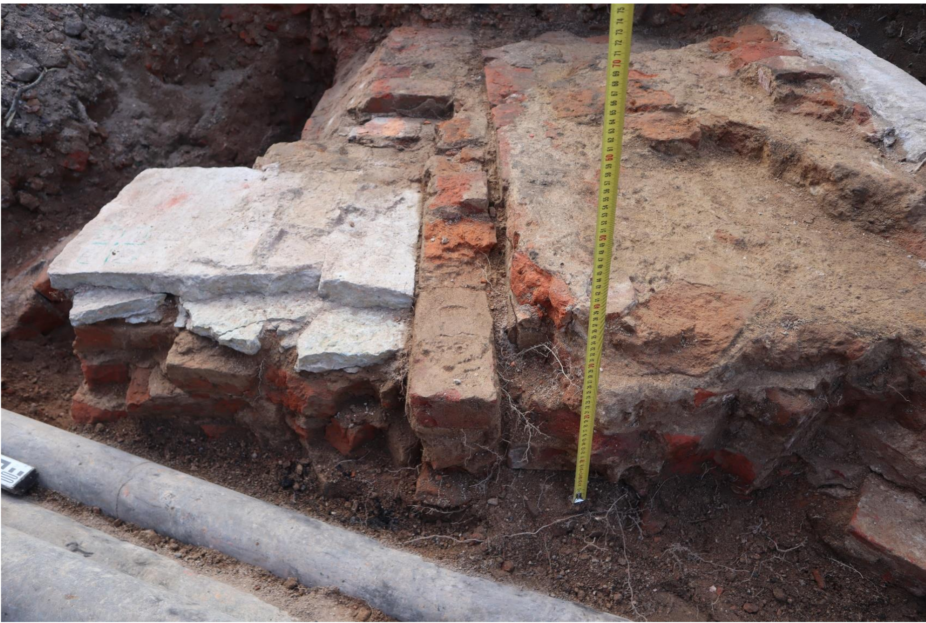
Рис. 36. 2026. Ленинградская область, Тосненский район, пос. Шапки. Шурф 2. Кирпичный столб – несущая конструкция юго-западной части южной апсиды. Вид с юга
