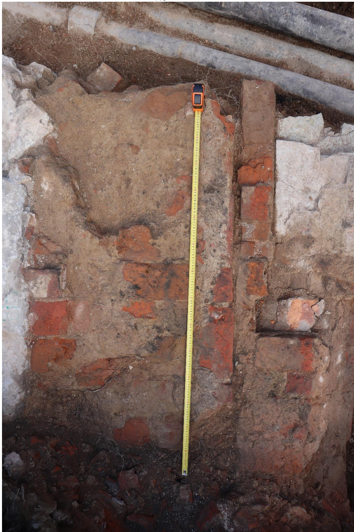
Рис. 34. 2026. Ленинградская область, Тосненский район, пос. Шапки. Шурф 2. Кирпичный столб – несущая конструкция юго-западной части южной апсиды. Вид с востока
