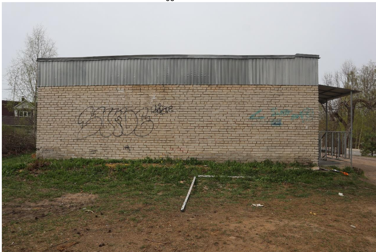
Рис. 11. 2026. Шурф 1. Ленинградская область, Тосненский район, пос. Шапки. Общий вид перед началом работ. Вид с востока
