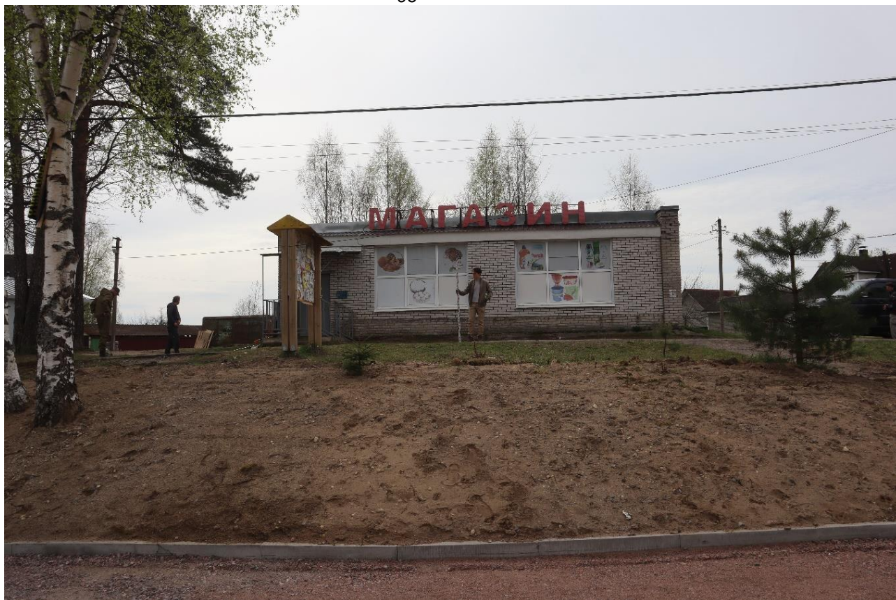
Рис. 6. 2026. Ленинградская область, Тосненский район, пос. Шапки. Общий вид на участок обследования с севера
