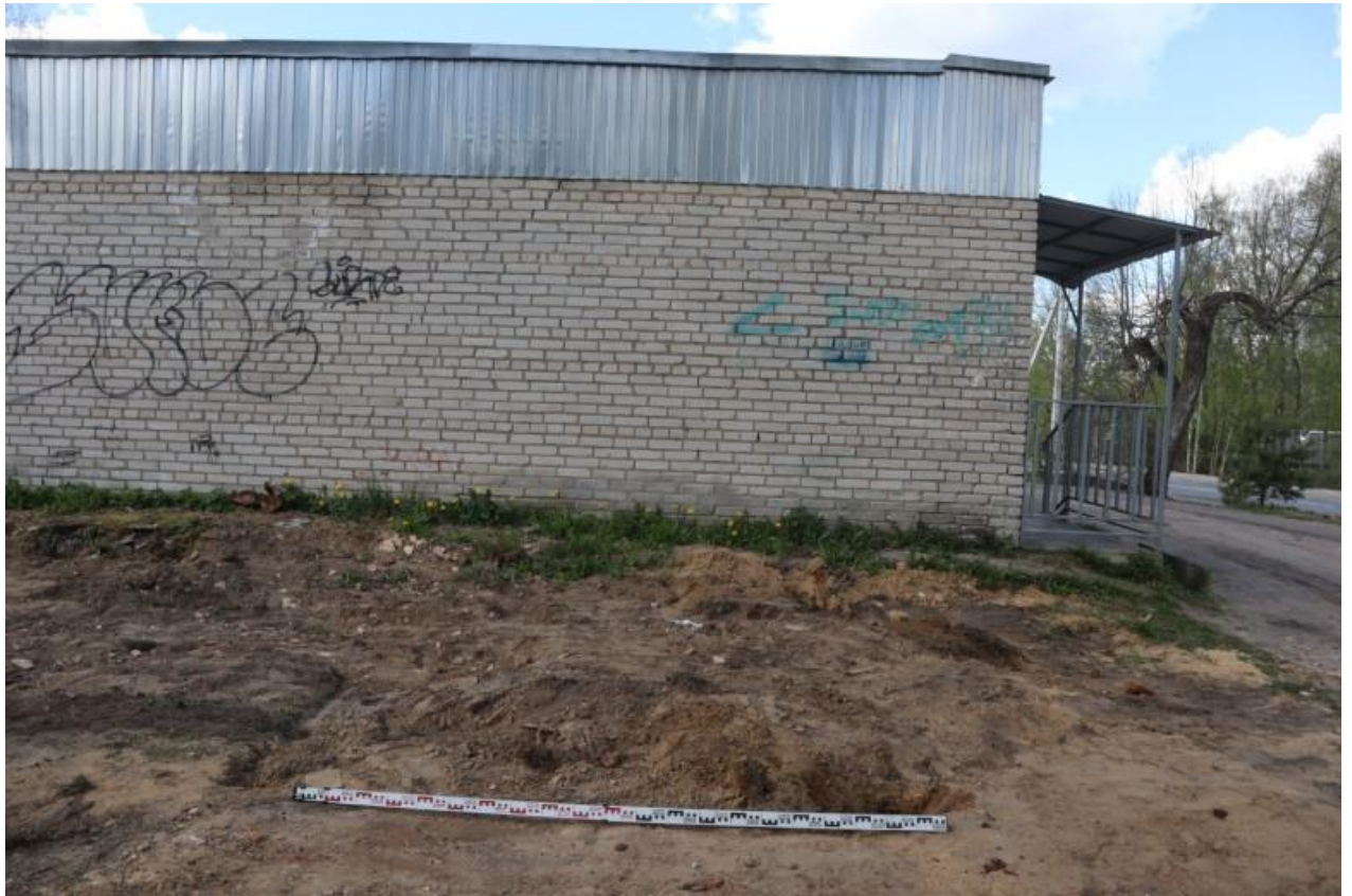
Рис. 17. 2026. Ленинградская область, Тосненский район, пос. Шапки. Шурф 1. Рекультивация. Вид с востока
