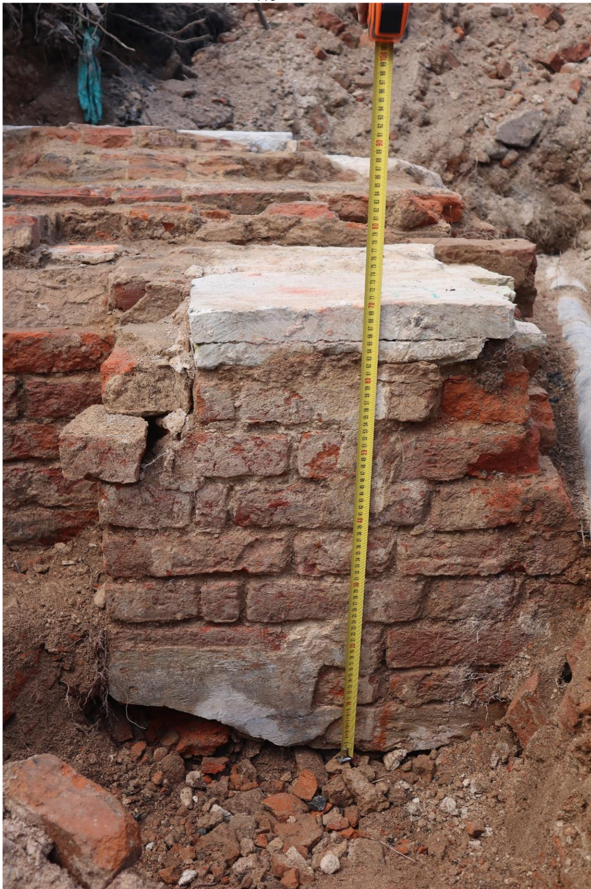
Рис. 32. 2026. Ленинградская область, Тосненский район, пос. Шапки. Шурф 2. Кирпичный столб – несущая конструкция юго-западной части южной апсиды. Вид с востока
