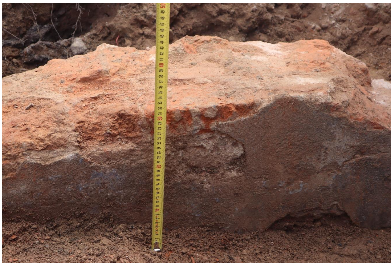
Рис. 30. 2026. Ленинградская область, Тосненский район, пос. Шапки. Шурф 2. Остатки штукатурки во внутреннем объеме южной апсиды
