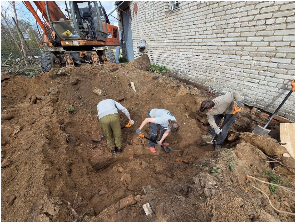
Рис. 19. 2026. Ленинградская область, Тосненский район, пос. Шапки. Шурф 2. Процесс разборки строительного мусора. Вид с юго-востока
