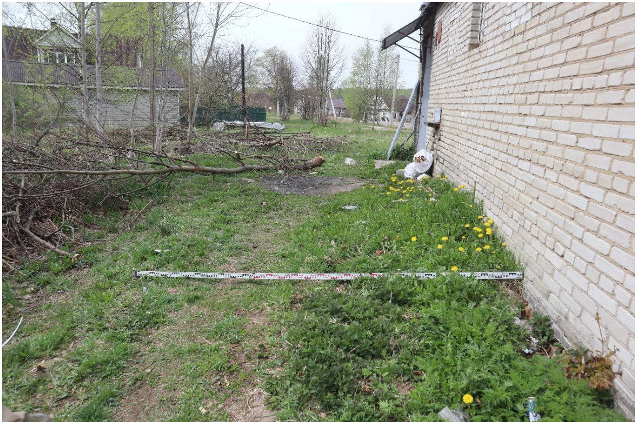
Рис. 18. 2026. Ленинградская область, Тосненский район, пос. Шапки. Шурф 2. Общий вид перед началом работ. Вид с востока
