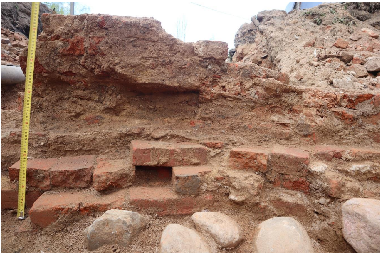
Рис. 28. 2026. Ленинградская область, Тосненский район, пос. Шапки. Шурф 2. Кирпичная кладка фундамента и каменный фундамент, западный фас южной апсиды
