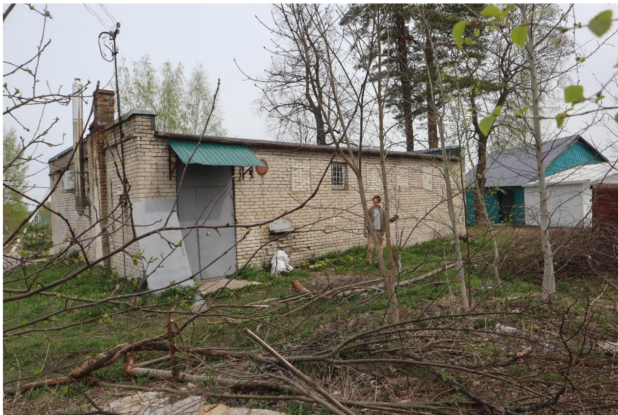
Рис. 9. 2026. Ленинградская область, Тосненский район, пос. Шапки. Общий вид на участок обследования с юго-запада
