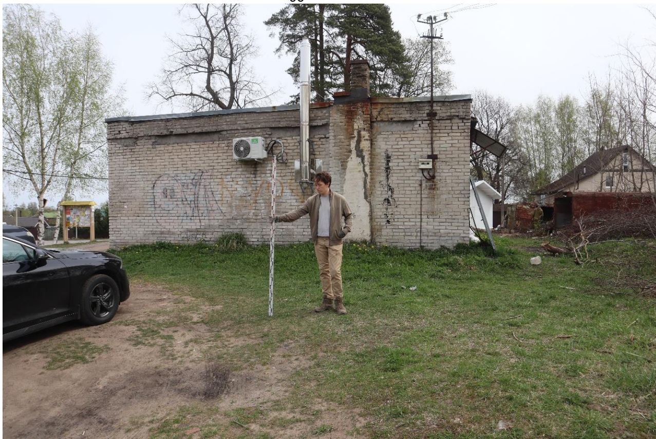
Рис. 8. 2026. Ленинградская область, Тосненский район, пос. Шапки. Общий вид на участок обследования с запада
