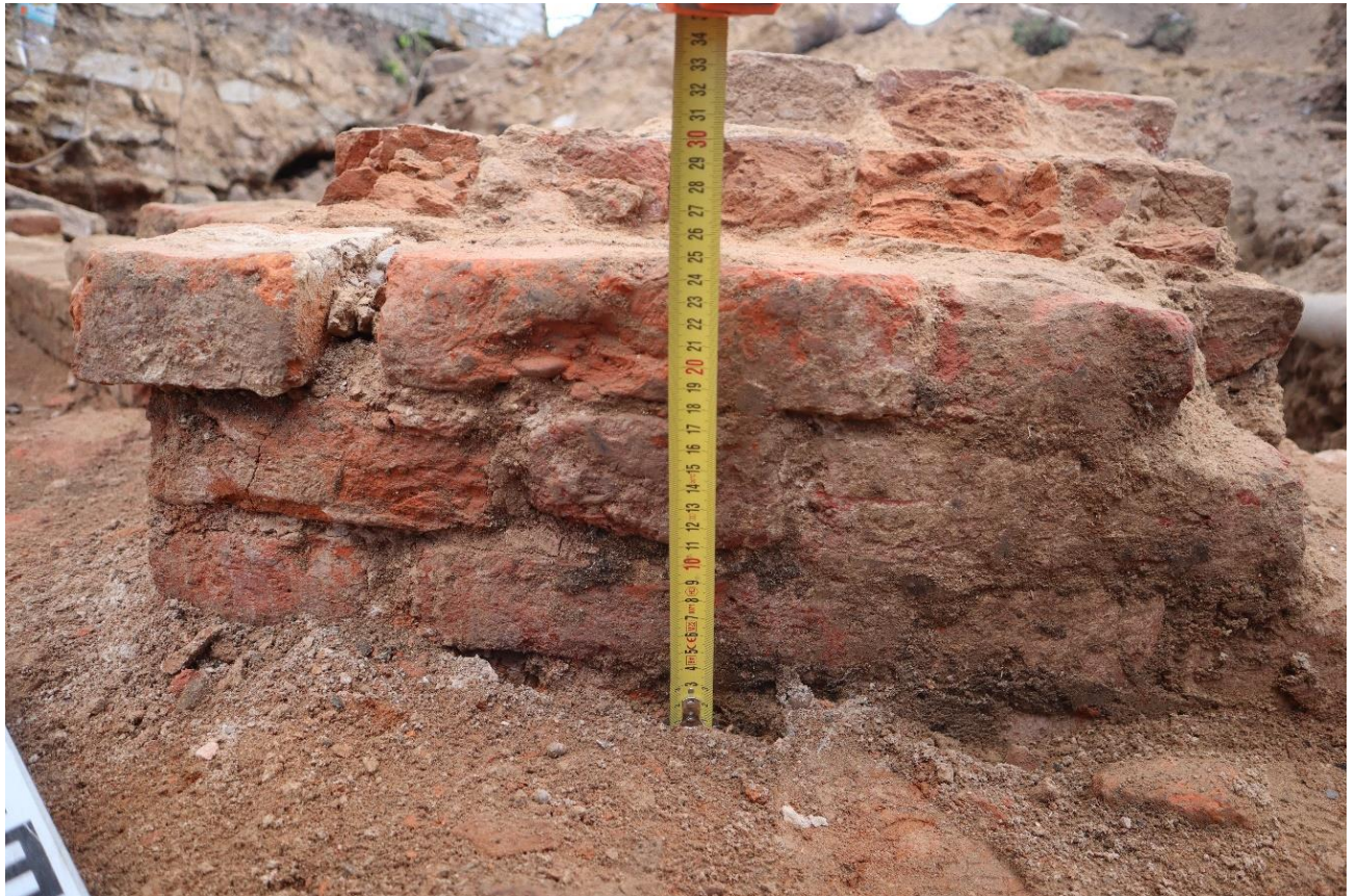
Рис. 27. 2026. Ленинградская область, Тосненский район, пос. Шапки. Шурф 2. Кирпичный столб – несущая конструкция. Вид с юга
