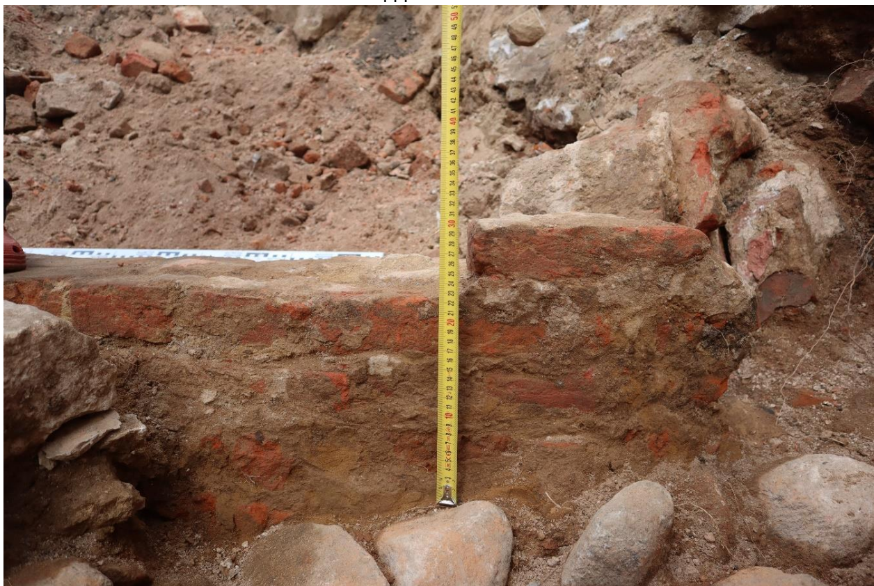
Рис. 29. 2026. Ленинградская область, Тосненский район, пос. Шапки. Шурф 2. Кирпичная кладка фундамента и каменный фундамент, западный фас южной апсиды
