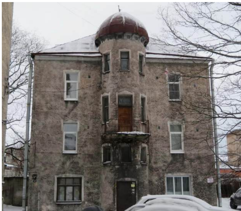
Илл. 23. Вид на дом № 24а по Морской набережной. Дата: 2019 г. Источник: wikimapia.org.
