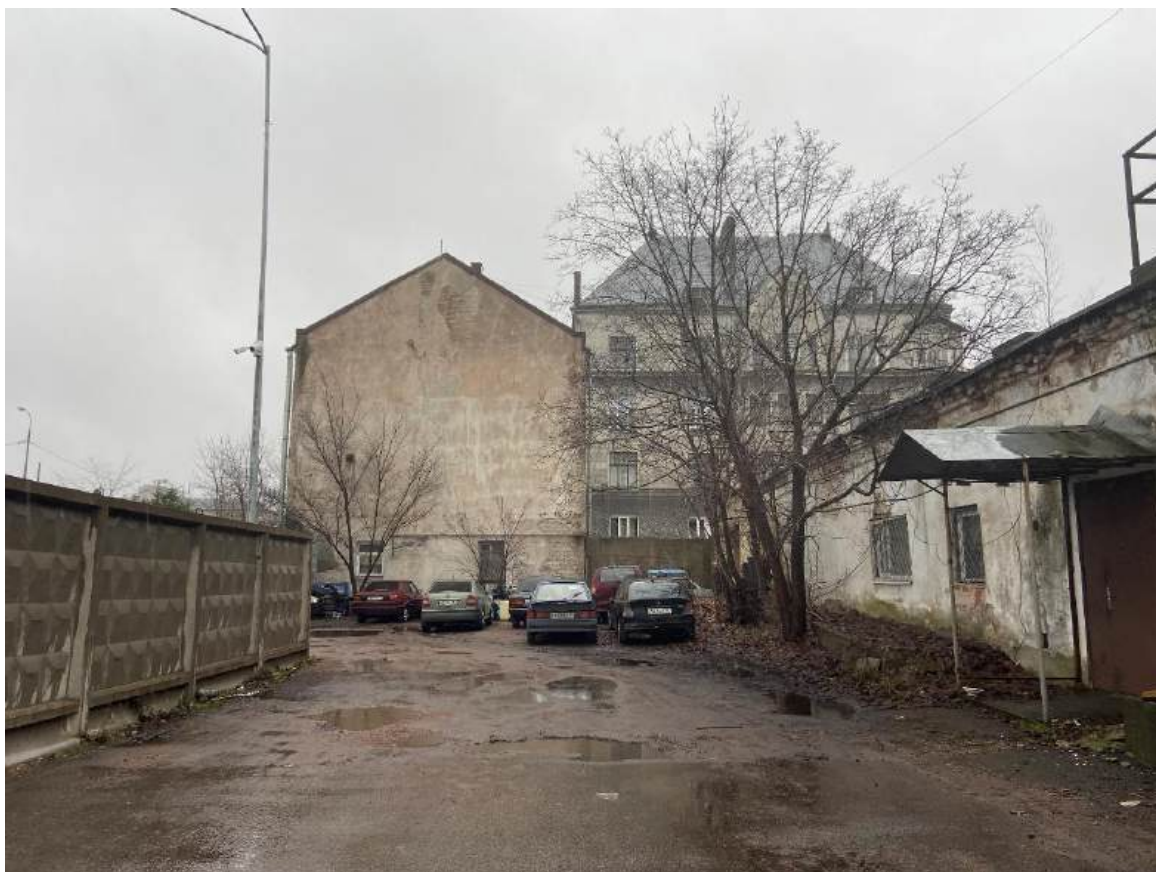
Фото 7. Вид на северо-западный фасад с Советской улицы.
