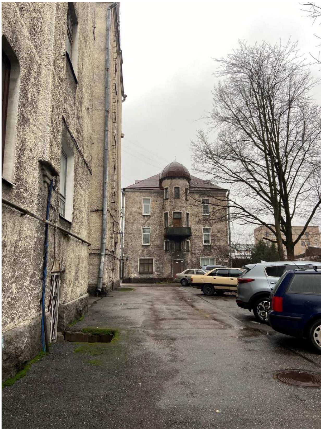
Фото 1. Вид на юго-восточный фасад с улицы Пушкина.
