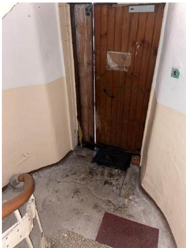
Фото 10. Вид на входную дверь.
