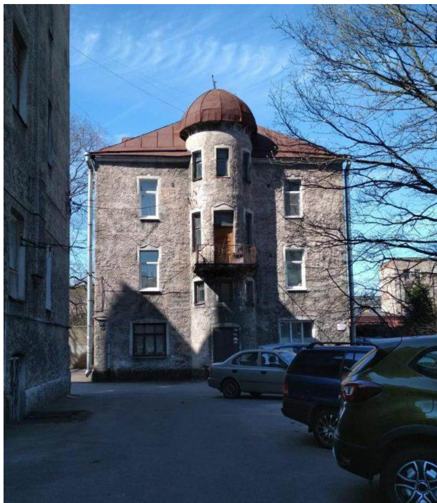
Илл. 22. Вид на дом № 24а по Морской набережной. Дата: 2018 г. Источник: wikimapia.org.
