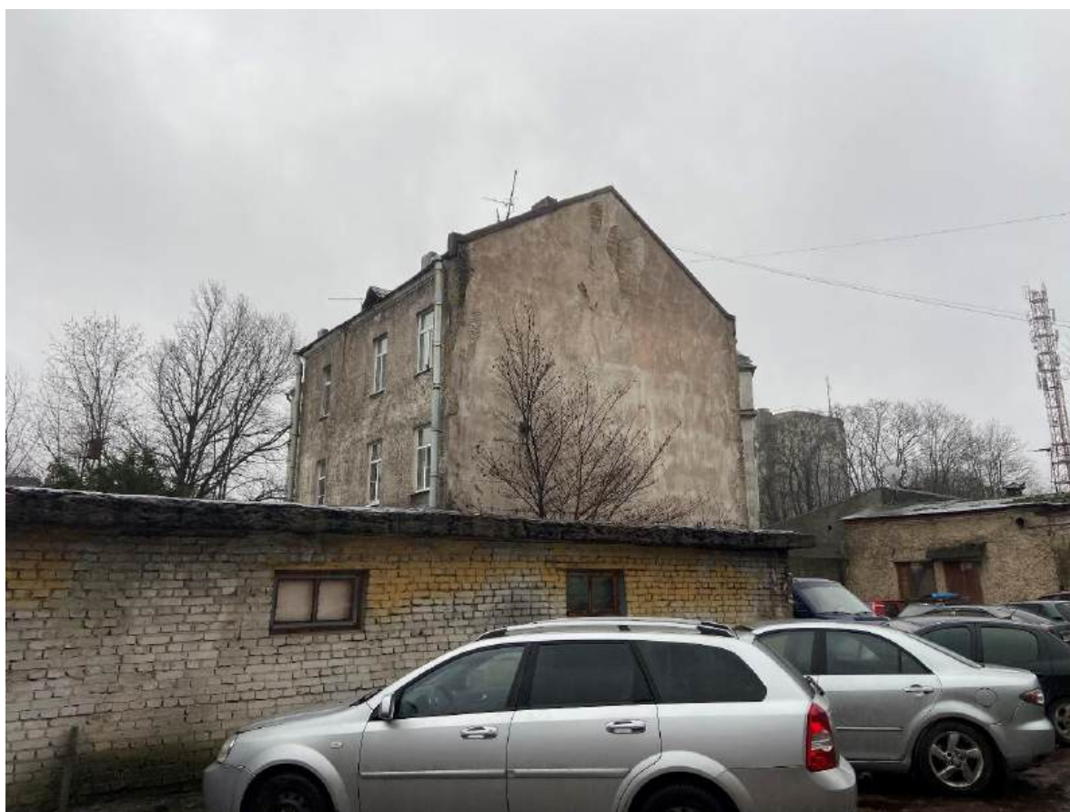
Фото 8. Вид на угол северо-западного и северо-восточного фасадов.
