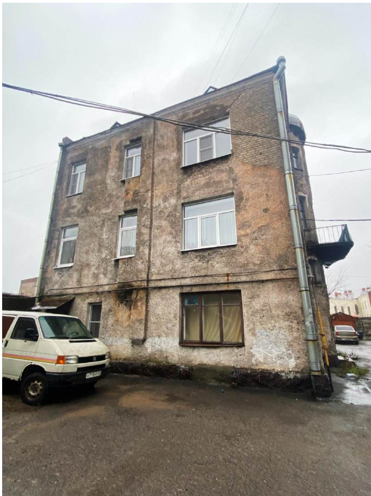
Фото 6. Вид на юго-западный фасад.
