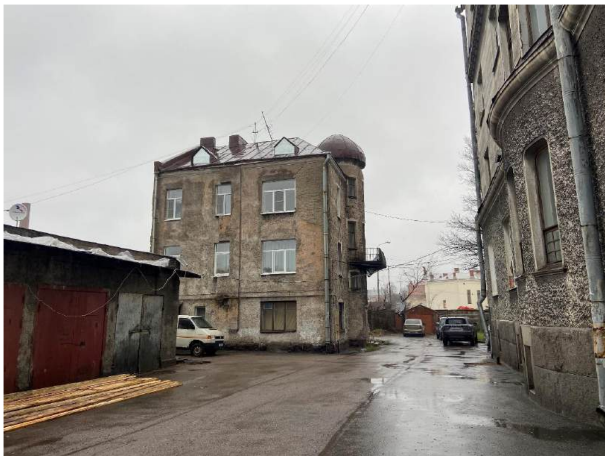
Фото 5. Вид на юго-западный фасад с Морской набережной.
