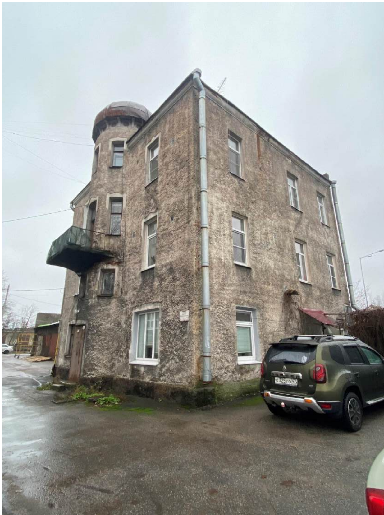
Фото 3. Вид на угол юго-восточного и северо-восточного фасадов.
