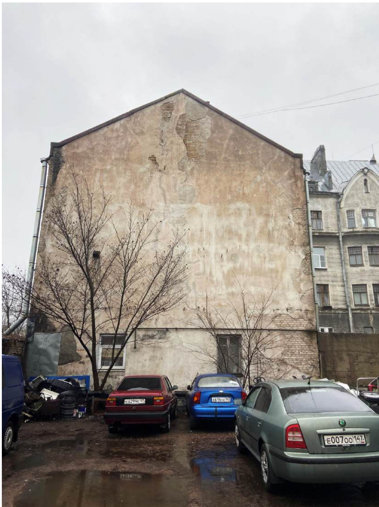
Фото 9. Вид на северо-западный фасад.
