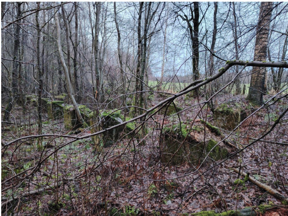
30. Ряды бетонных надолбов.
