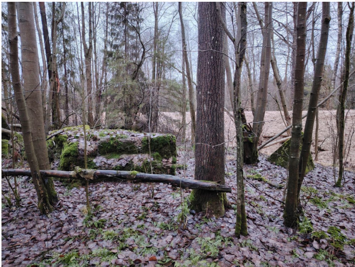
17. Фрагмент восточной части сооружений у дороги.
