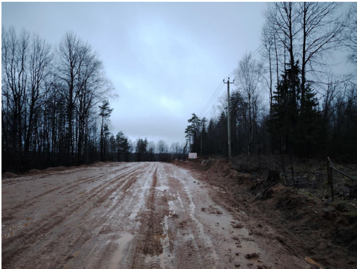
73. Вид вдоль дороги, на запад.
