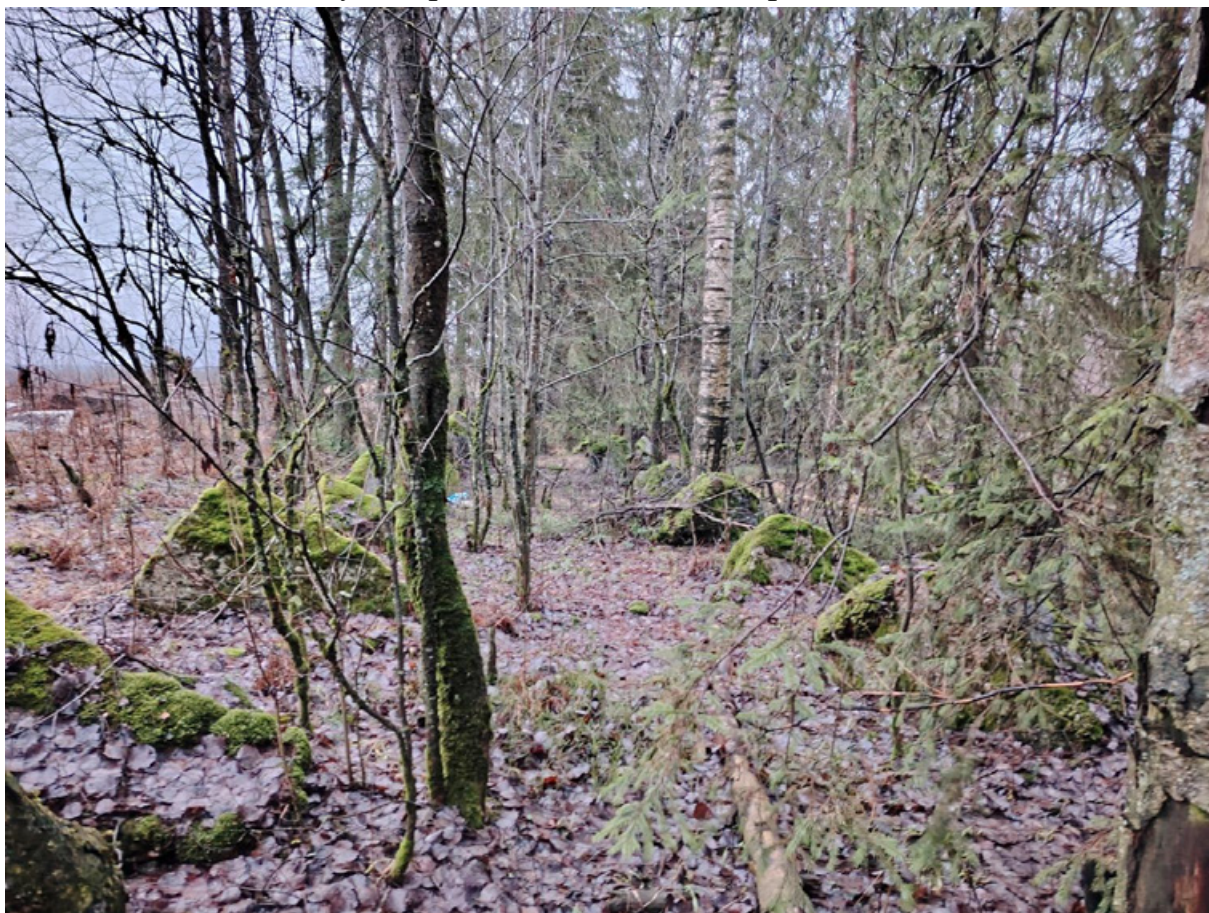
58. Руины северной части бетонных надолбов.
