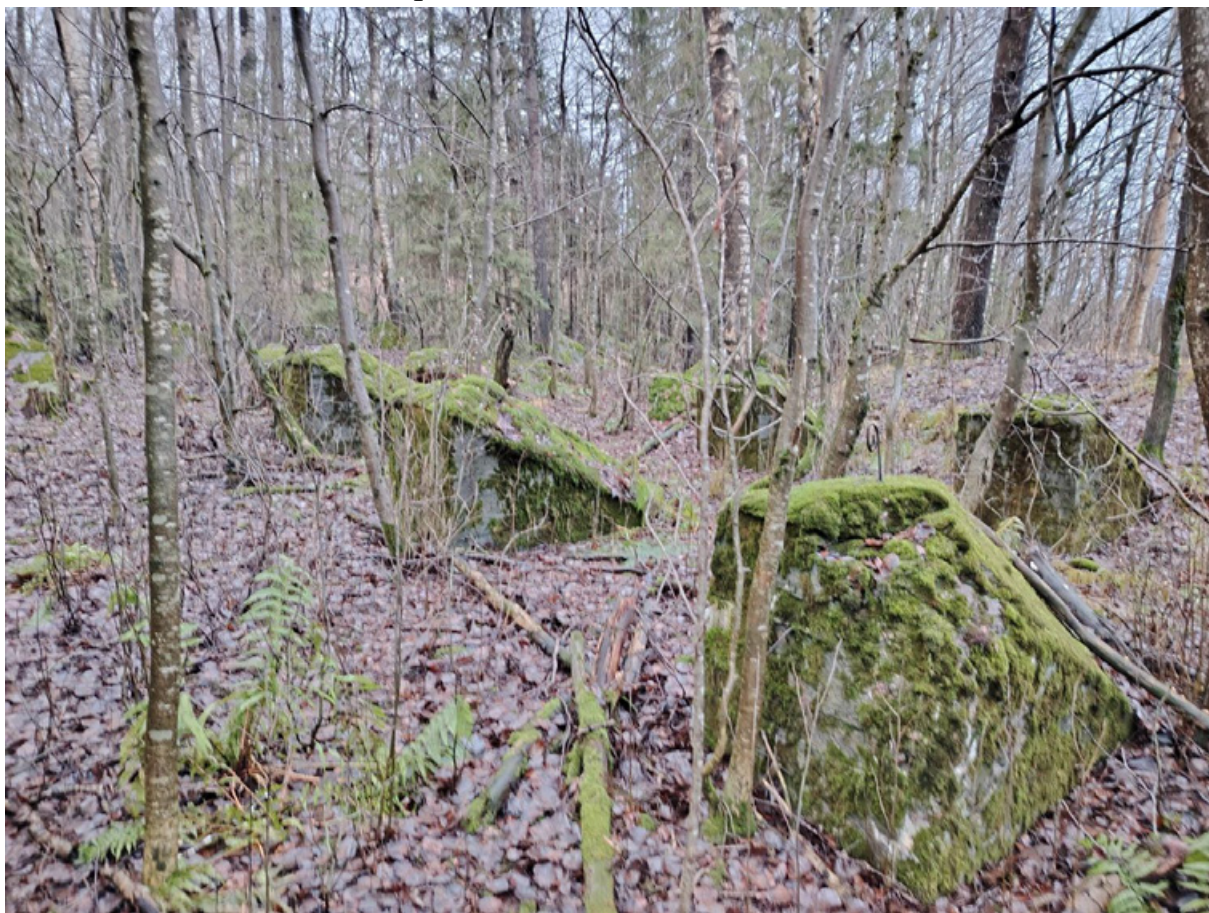
36. Восточная часть оборонительных сооружений.
