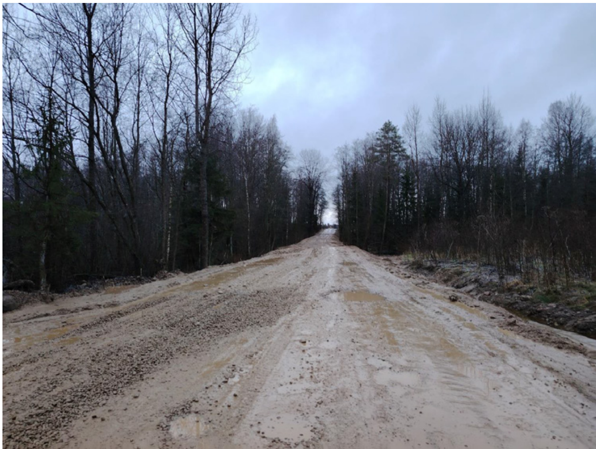
5. Дорога поперек сооружений.
