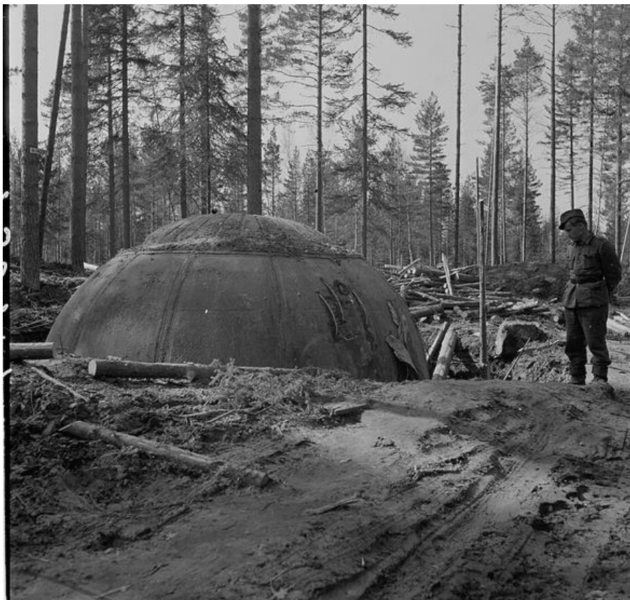
Илл. 50. Бронекопак № К-4097 в районе п Серово. 1944 г. [Электронный ресурс] // URL: http://sa-kuva.fi/neo?tem=webneo_image_preview_max&lang=ENG&doc_id=7aa7d22261274717031e2ccaf1b3e0a7&archive=&zoom=YES
