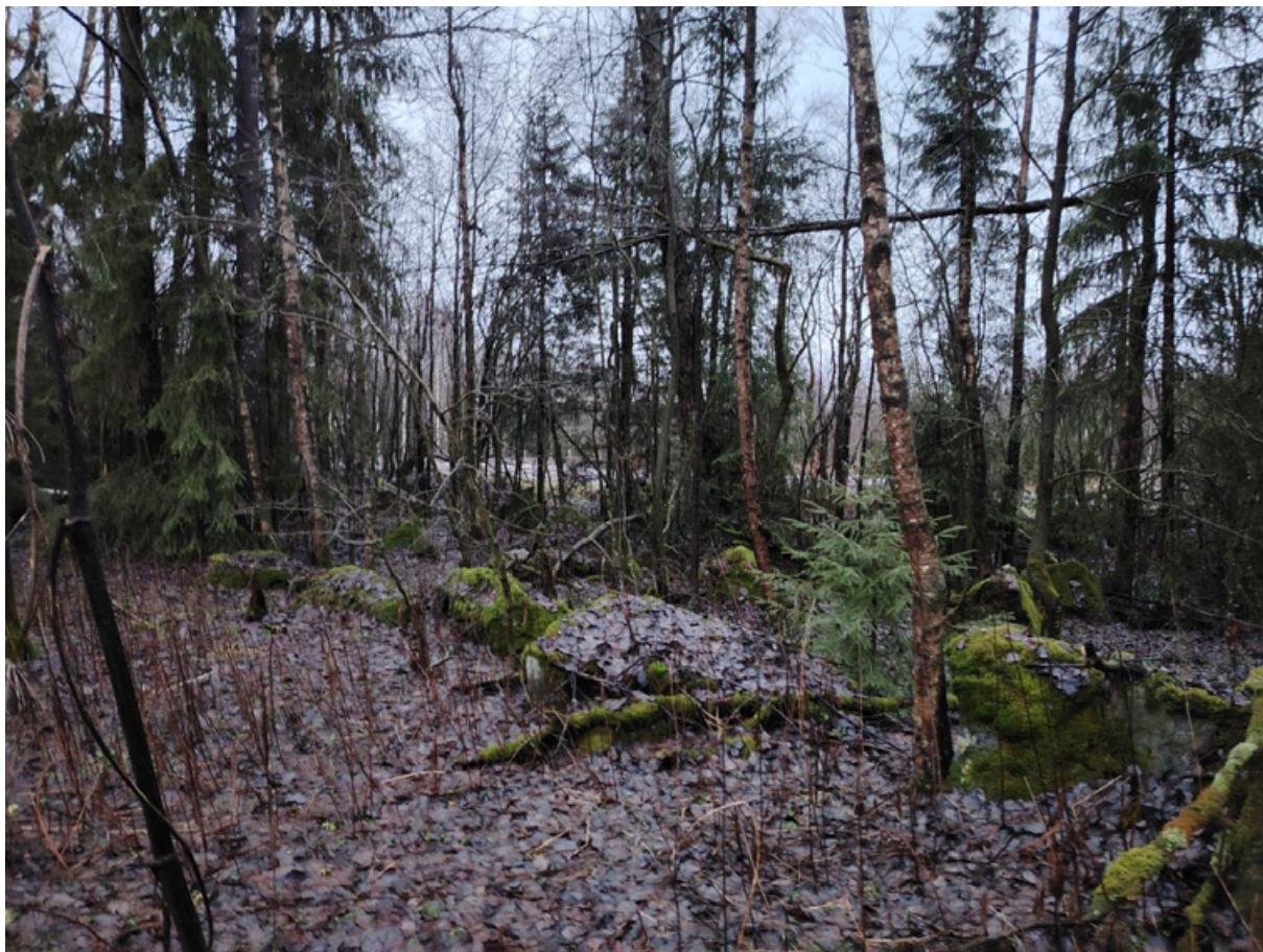
47. Восточная часть оборонительных сооружений.
