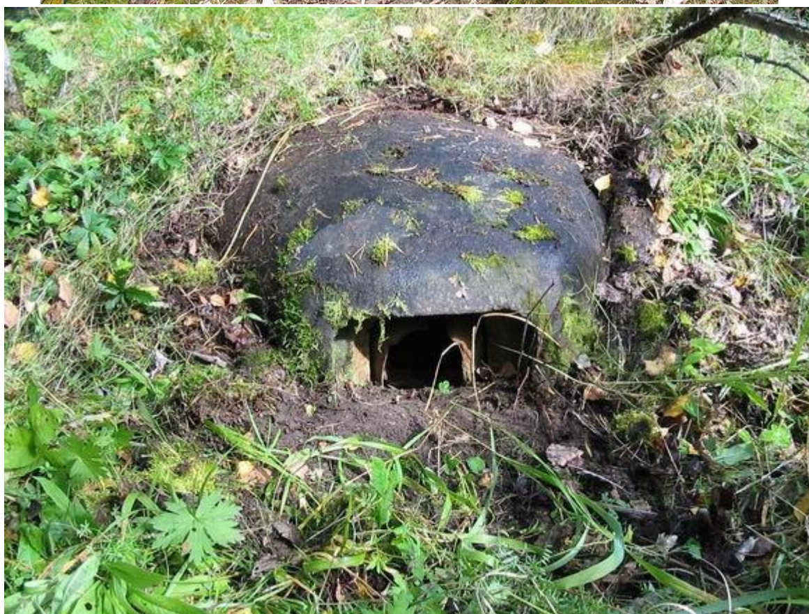
Илл. 81. Бетонированное убежище для личного состава. Пулеметный бронеколпак. [Электронный ресурс] // URL: https://vk.com/album52065691_284318366?ysclid=mjcmycvl2b742303544 .
