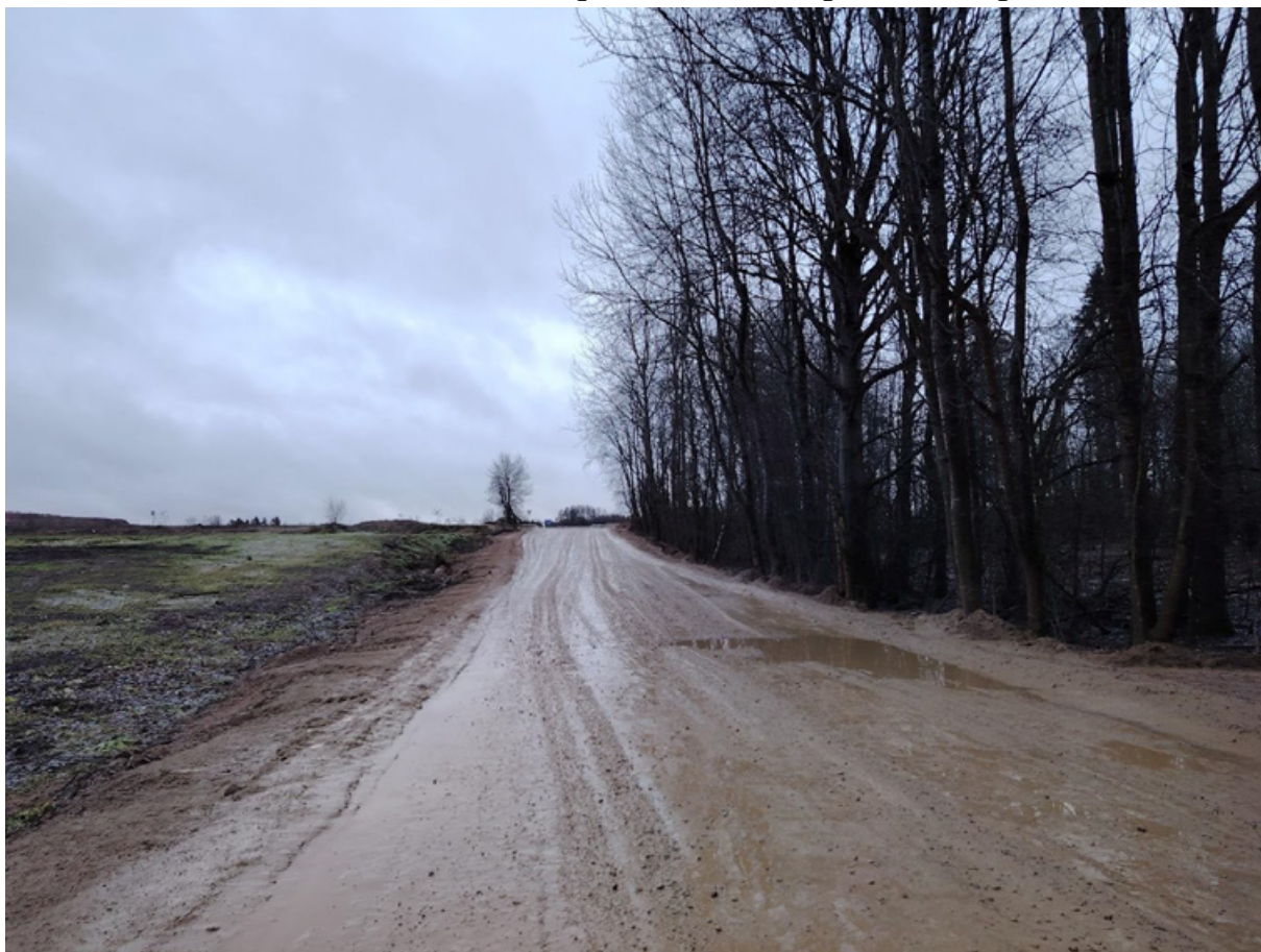
2. Вид дороги в сторону оборонительных сооружений.
