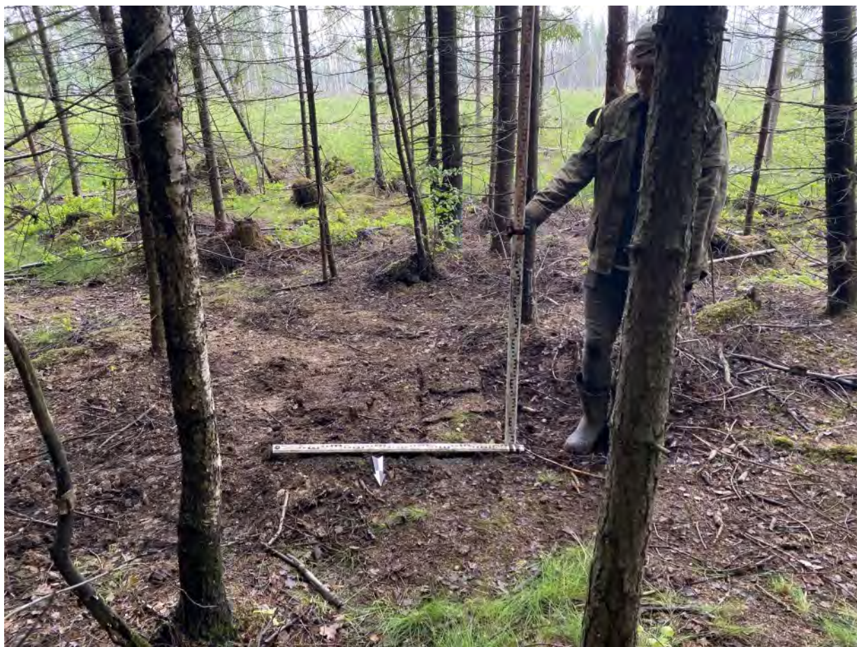
Рис. 260. «Проектирование и строительство улично-дорожной сети» в г. Мурино. Шурф № 16. Вид после засыпки и рекультивации шурфа. Вид с севера.
