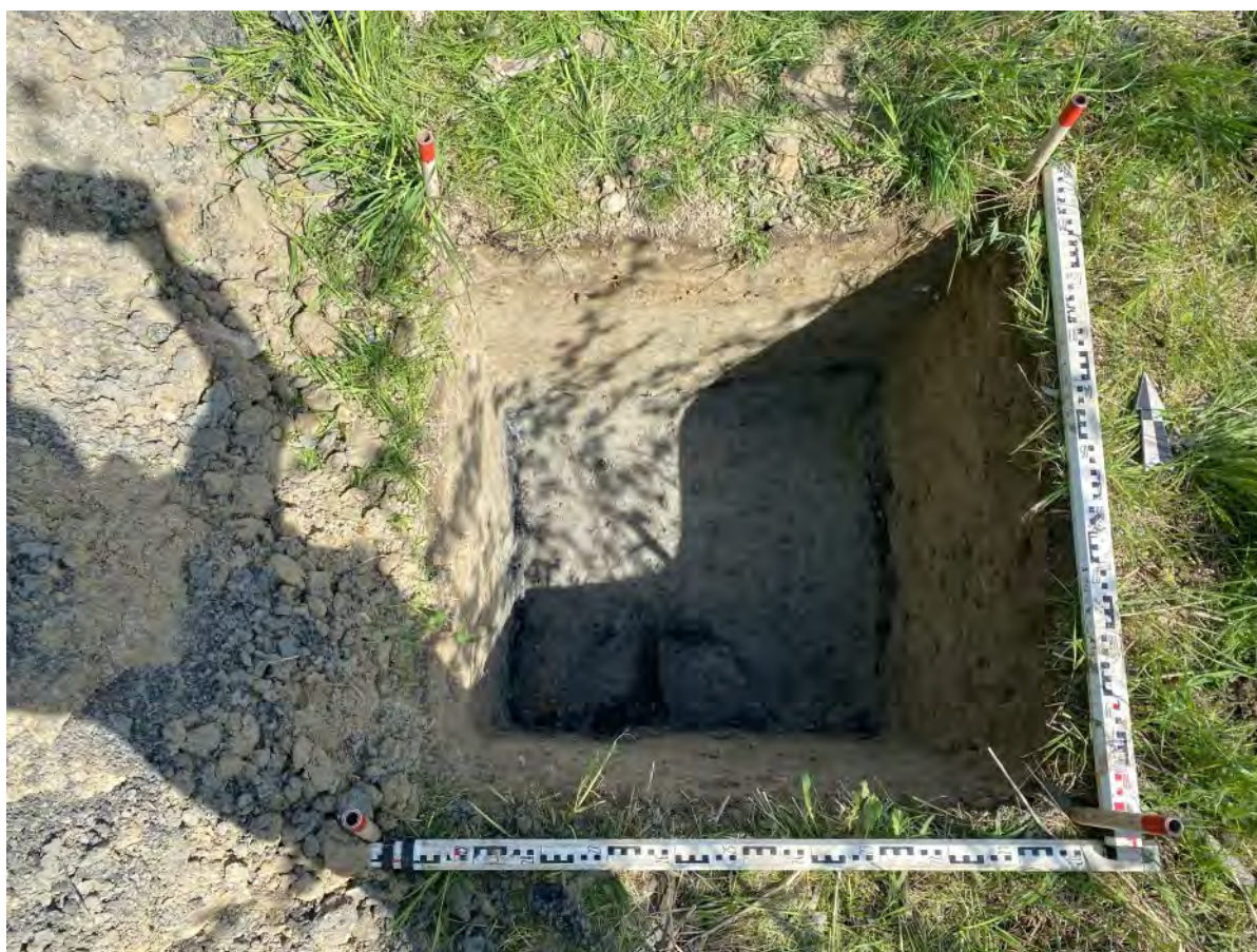
Рис. 158. «Проектирование и строительство улично-дорожной сети» в г. Мурино. Шурф № 5. Вид на раскопанный шурф. Вид с юга.
