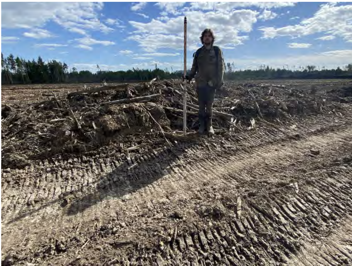
Рис. 93. «Проектирование и строительство улично-дорожной сети» в г. Мурино. Точка фотофиксации № 21. Вид с севера.
