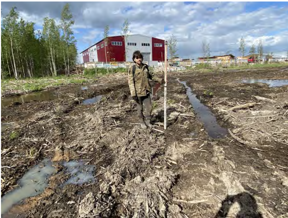
Рис. 99. «Проектирование и строительство улично-дорожной сети» в г. Мурино. Точка фотофиксации № 22. Вид с юга.
