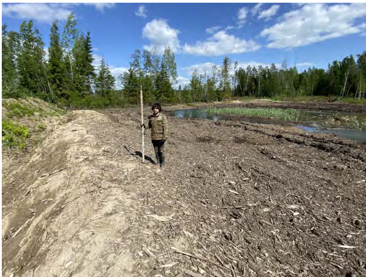
Рис. 92. «Проектирование и строительство улично-дорожной сети» в г. Мурино. Точка фотофиксации № 20. Вид с запада.
