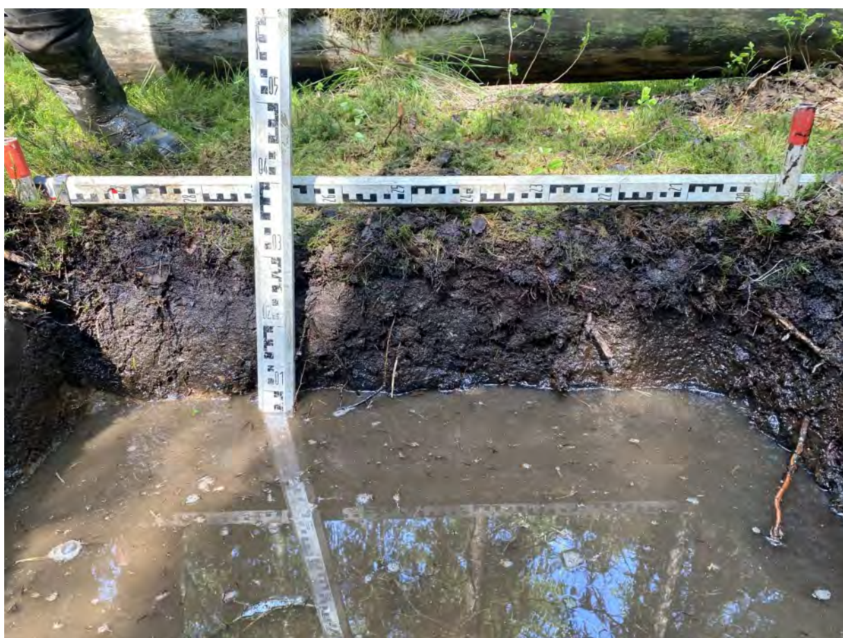
Рис. 232. «Проектирование и строительство улично-дорожной сети» в г. Мурино. Шурф № 13. Вид на северную стенку. Вид с юга.
