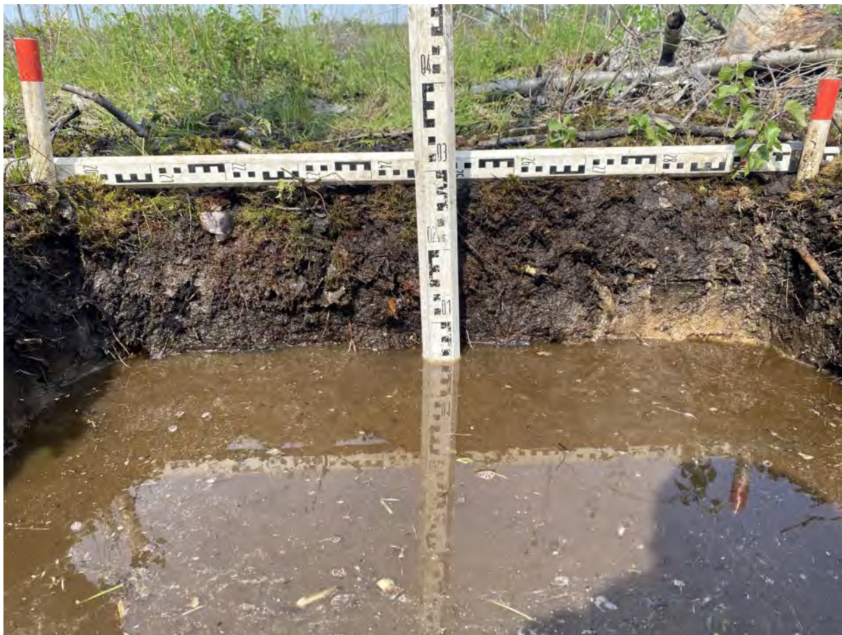
Рис. 177. «Проектирование и строительство улично-дорожной сети» в г. Мурино. Шурф № 7. Вид на северную стенку. Вид с юга.
