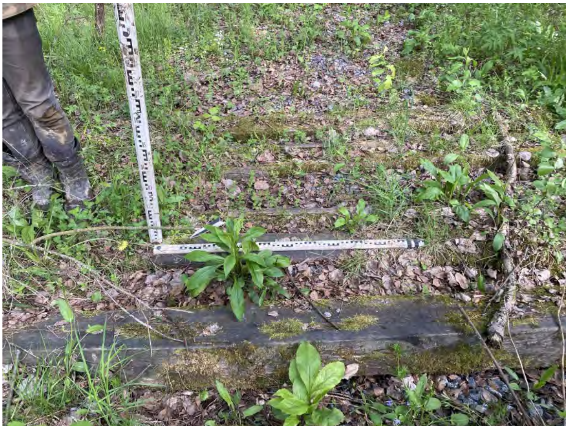
Рис. 109. «Проектирование и строительство улично-дорожной сети» в г. Мурино. Зброшенна залезнодорожна насыпь. Деревянные шпалы. Вид с северо-запада.
