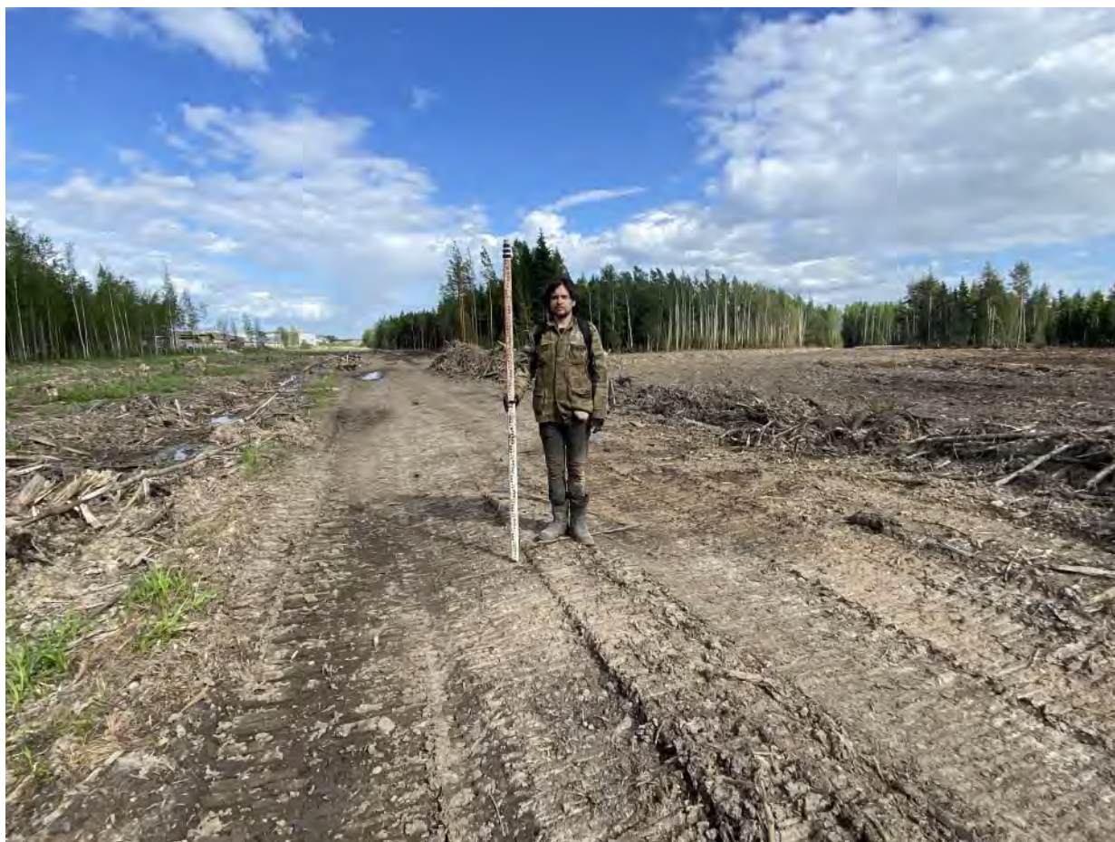
Рис. 96. «Проектирование и строительство улично-дорожной сети» в г. Мурино. Точка фотофиксации № 21. Вид с запада.
