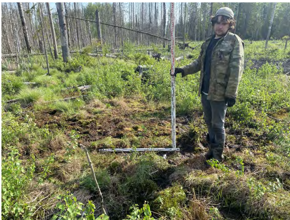
Рис. 196. «Проектирование и строительство улично-дорожной сети» в г. Мурино. Шурф № 9. Вид после засыпки и рекультивации шурфа. Вид с севера.
