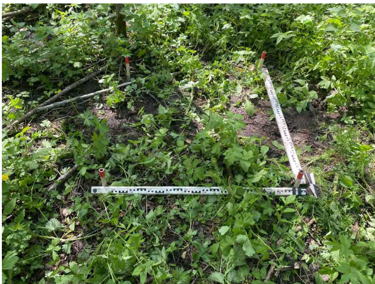
Рис. 164. «Проектирование и строительство улично-дорожной сети» в г. Мурино. Шурф № 6. Вид на размеченный шурф. Вид с севера.
