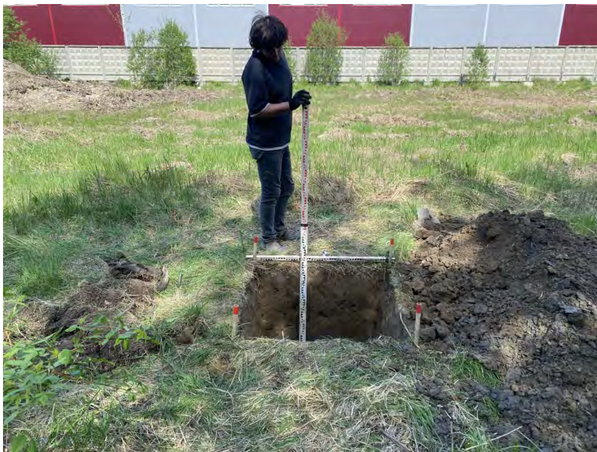
Рис. 120. «Проектирование и строительство улично-дорожной сети» в г. Мурино. Шурф № 1. Вид на раскопанный шурф. Вид с юга.
