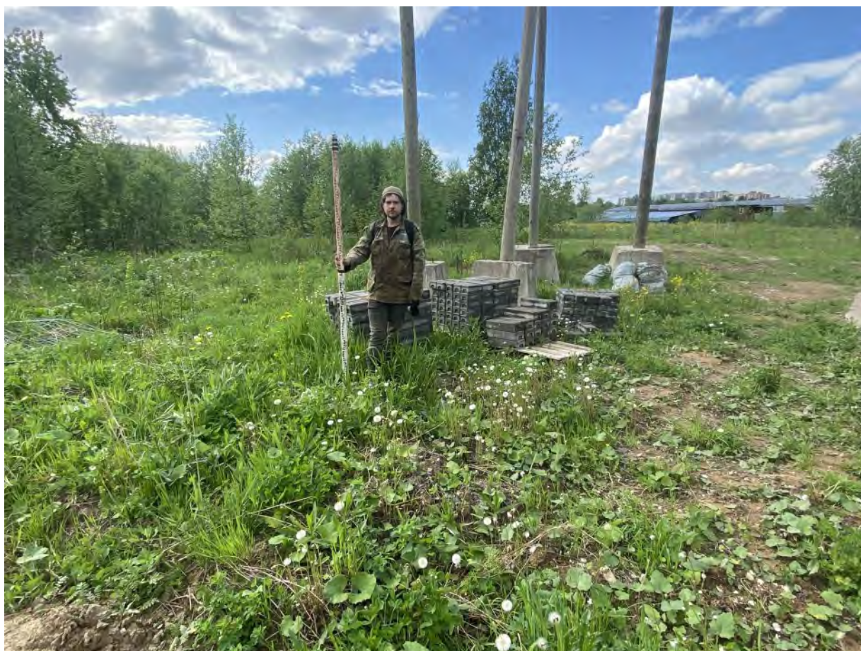
Рис. 78. «Проектирование и строительство улично-дорожной сети» в г. Мурино. Точка фиксации № 17. Вид с востока.
