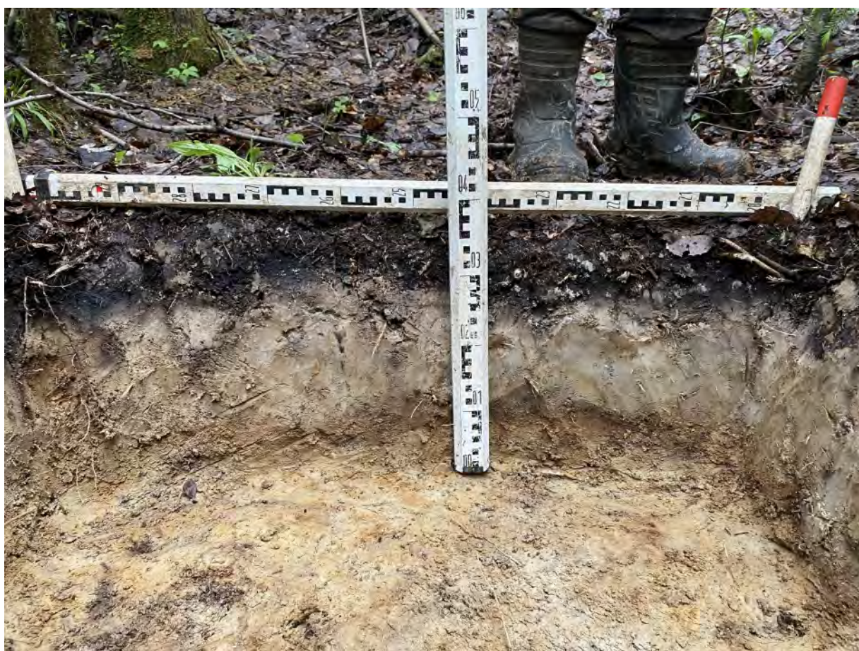
Рис. 278. «Проектирование и строительство улично-дорожной сети» в г. Мурино. Шурф № 18. Вид на северную стенку. Вид с юга.
