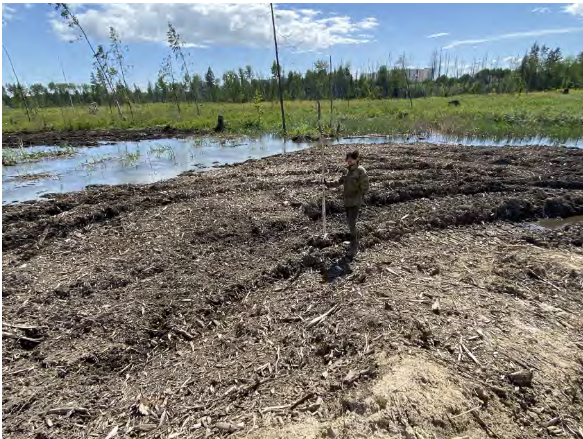
Рис. 89. «Проектирование и строительство улично-дорожной сети» в г. Мурино. Точка фотофиксации № 20. Вид с севера.
