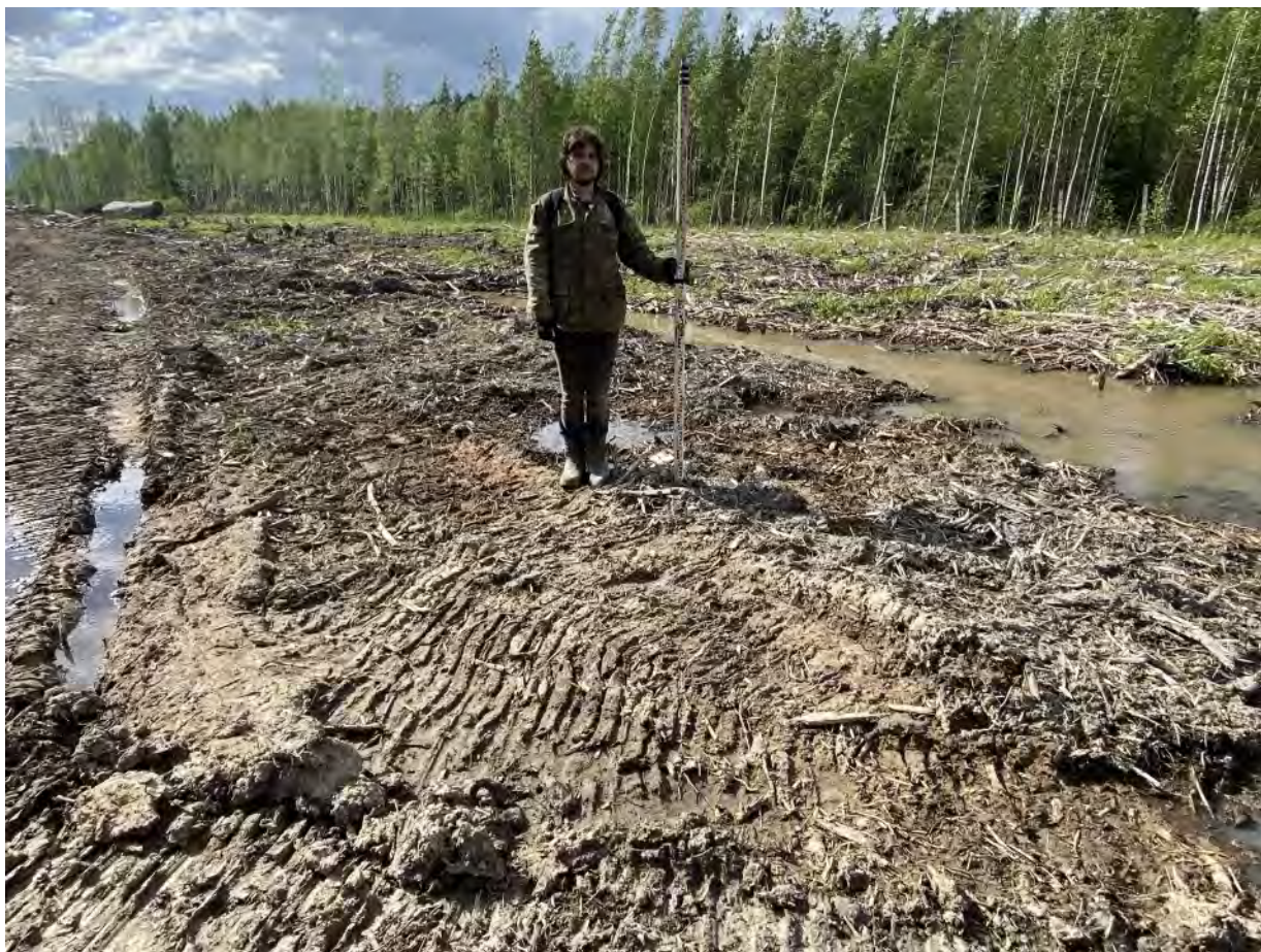
Рис. 98. «Проектирование и строительство улично-дорожной сети» в г. Мурино. Точка фиксации № 22. Вид с востока.
