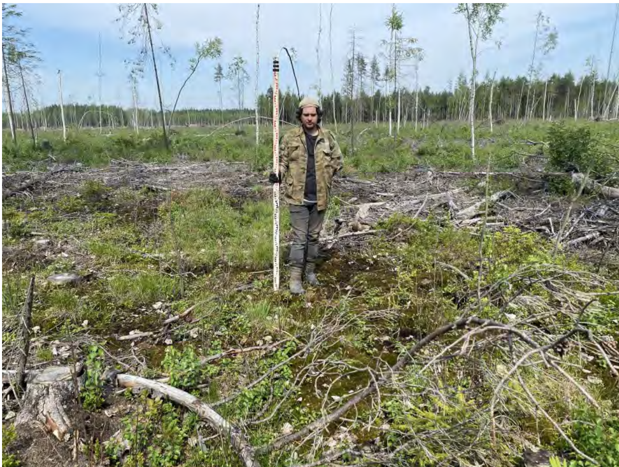
Рис. 171. «Проектирование и строительство улично-дорожной сети» в г. Мурино. Шурф № 7. Вид на место закладки шурфа до начала работ. Вид с юга.
