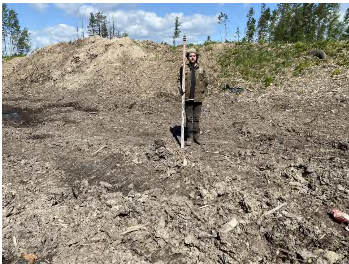
Рис. 318. «Проектирование и строительство улично-дорожной сети» в г. Мурино. Шурф № 23. Вид на место закладки шурфа до начала работ. Вид с юга.
