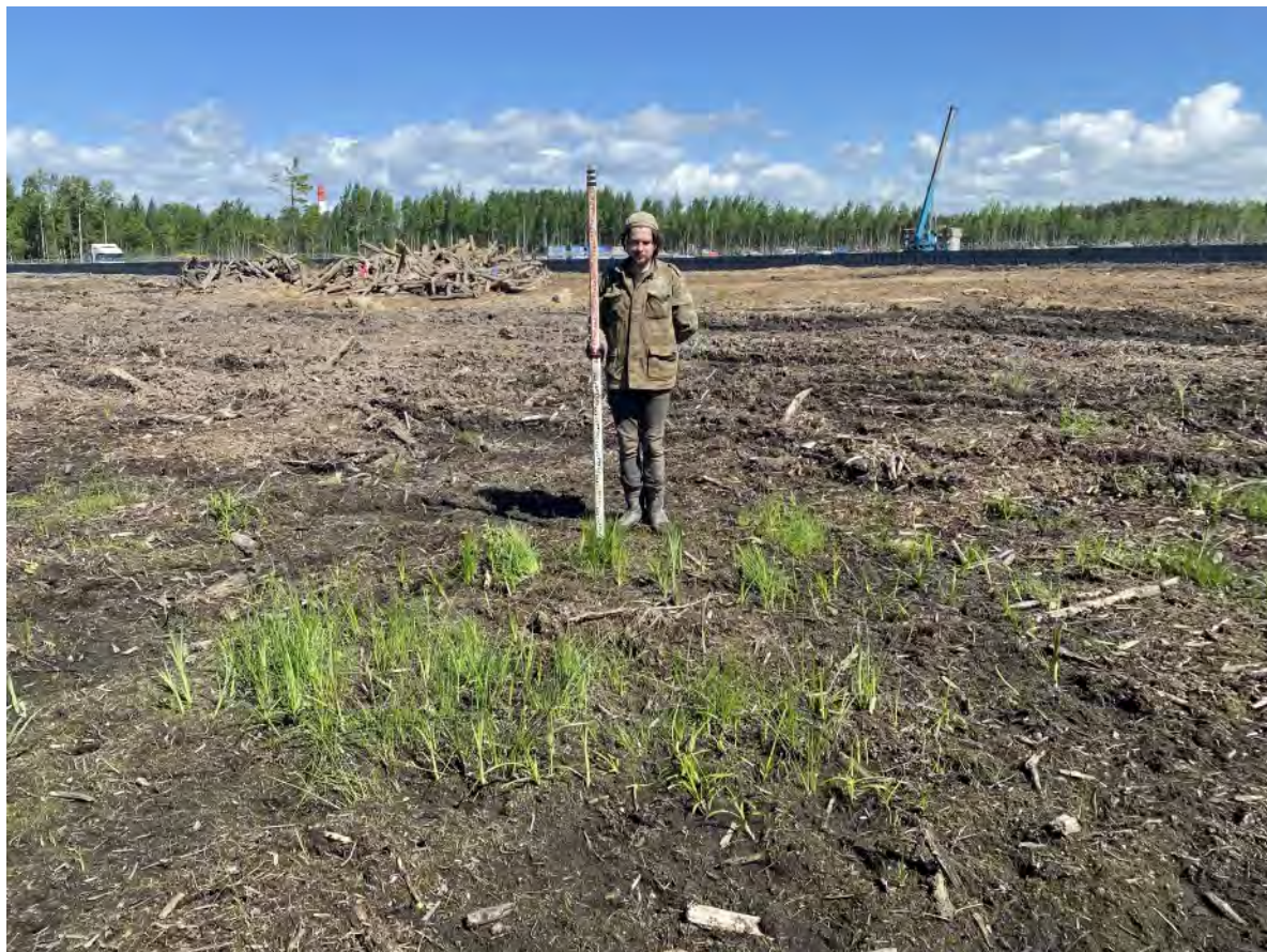
Рис. 309. «Проектирование и строительство улично-дорожной сети» в г. Мурино. Шурф № 22. Вид на место закладки шурфа до начала работ. Вид с юга.
