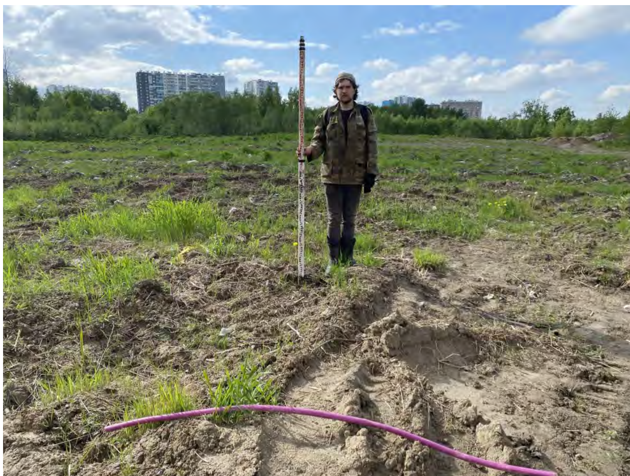
Рис. 74. «Проектирование и строительство улично-дорожной сети» в г. Мурино. Точка фотофиксации № 16. Вид с востока.
