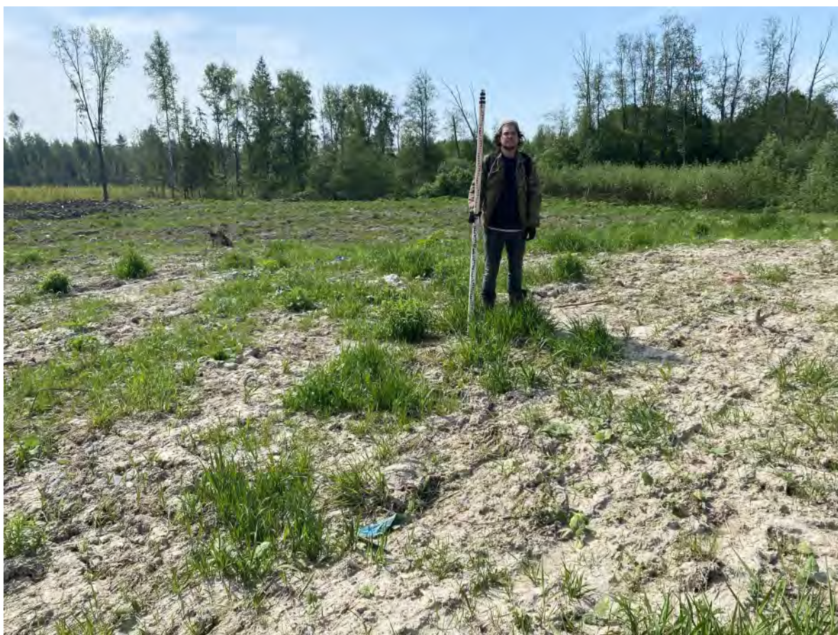
Рис. 28. «Проектирование и строительство улично-дорожной сети» в г. Мурино. Точка фиксации № 4. Вид с севера.
