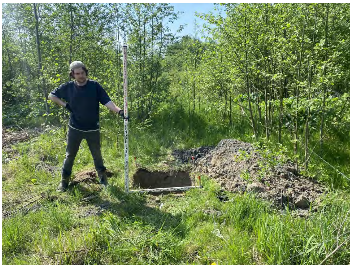
Рис. 156. «Проектирование и строительство улично-дорожной сети» в г. Мурино. Шурф № 5. Вид на раскопанный шурф. Вид с севера.
