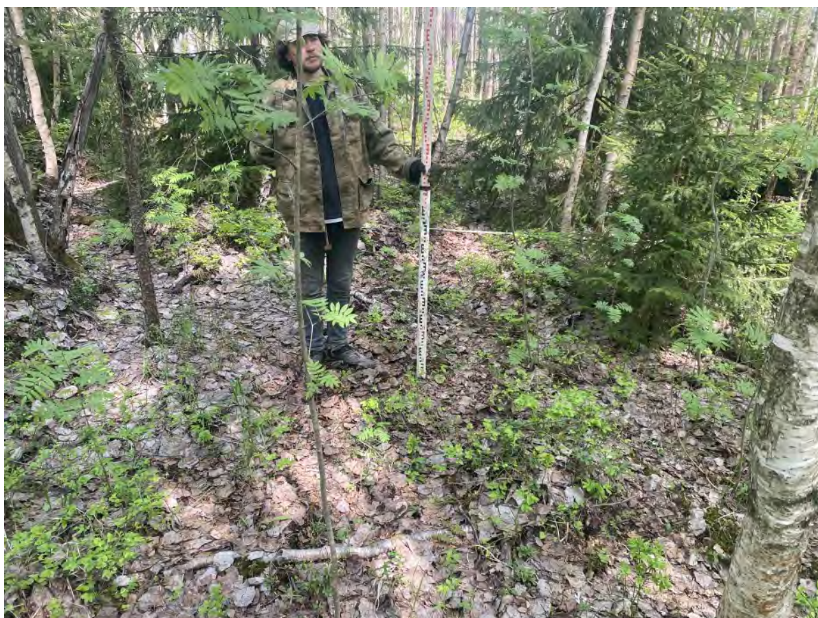
Рис. 134. «Проектирование и строительство улично-дорожной сети» в г. Мурино. Шурф № 3. Вид на место закладки шурфа до начала работ. Вид с юга.
