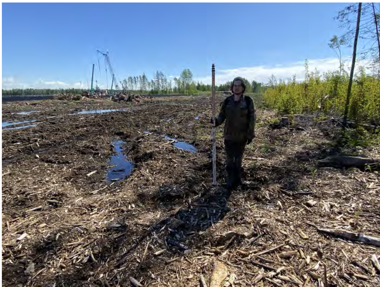
Рис. 88. «Проектирование и строительство улично-дорожной сети» в г. Мурино. Точка фотофиксации № 19. Вид с запада.
