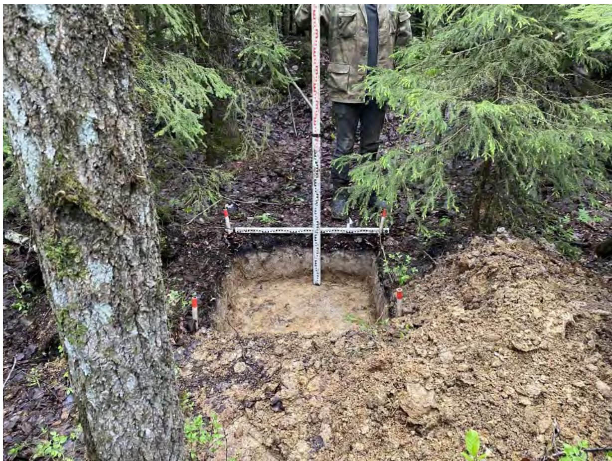
Рис. 276. «Проектирование и строительство улично-дорожной сети» в г. Мурино. Шурф № 18. Вид на раскопанный шурф. Вид с юга.
