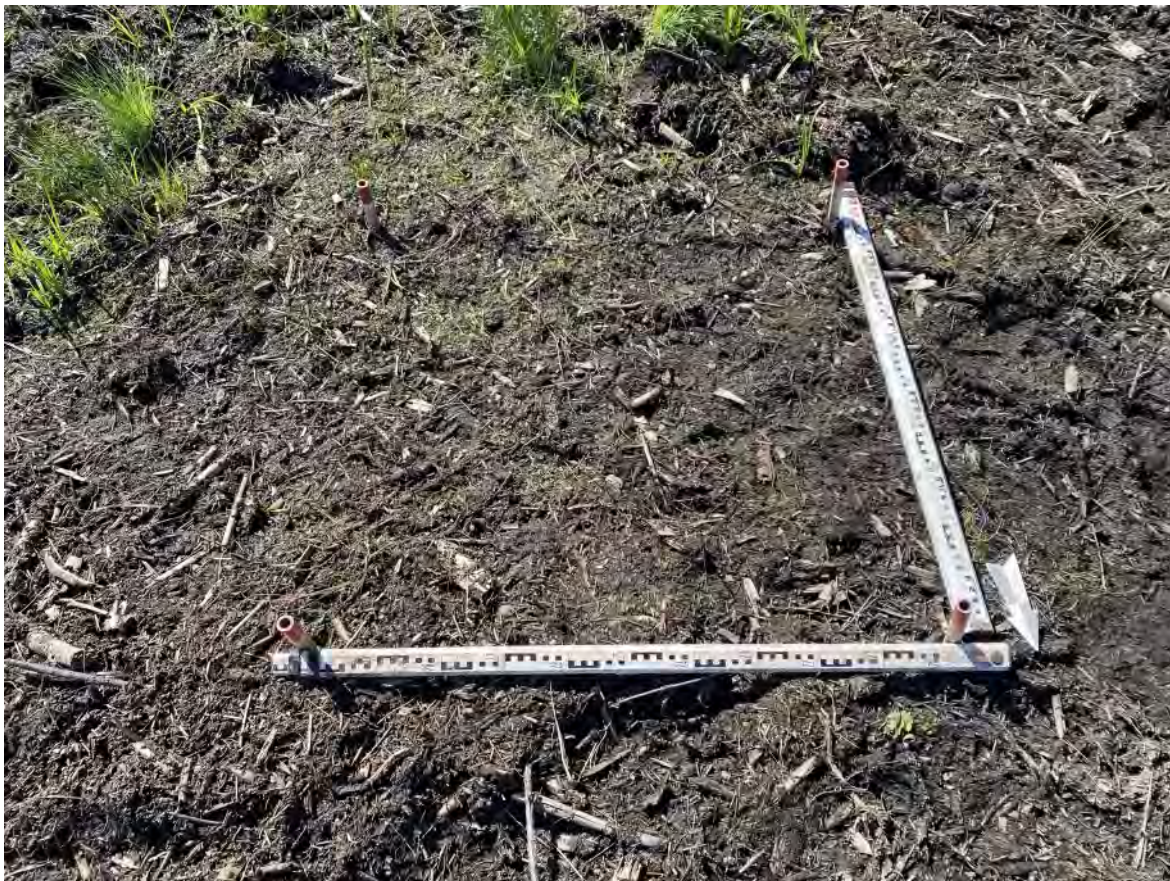
Рис. 311. «Проектирование и строительство улично-дорожной сети» в г. Мурино. Шурф № 22. Вид на размеченный шурф. Вид с севера.
