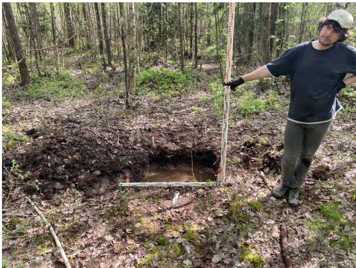
Рис. 146. «Проектирование и строительство улично-дорожной сети» в г. Мурино. Шурф № 4. Вид на раскопанный шурф. Вид с севера.
