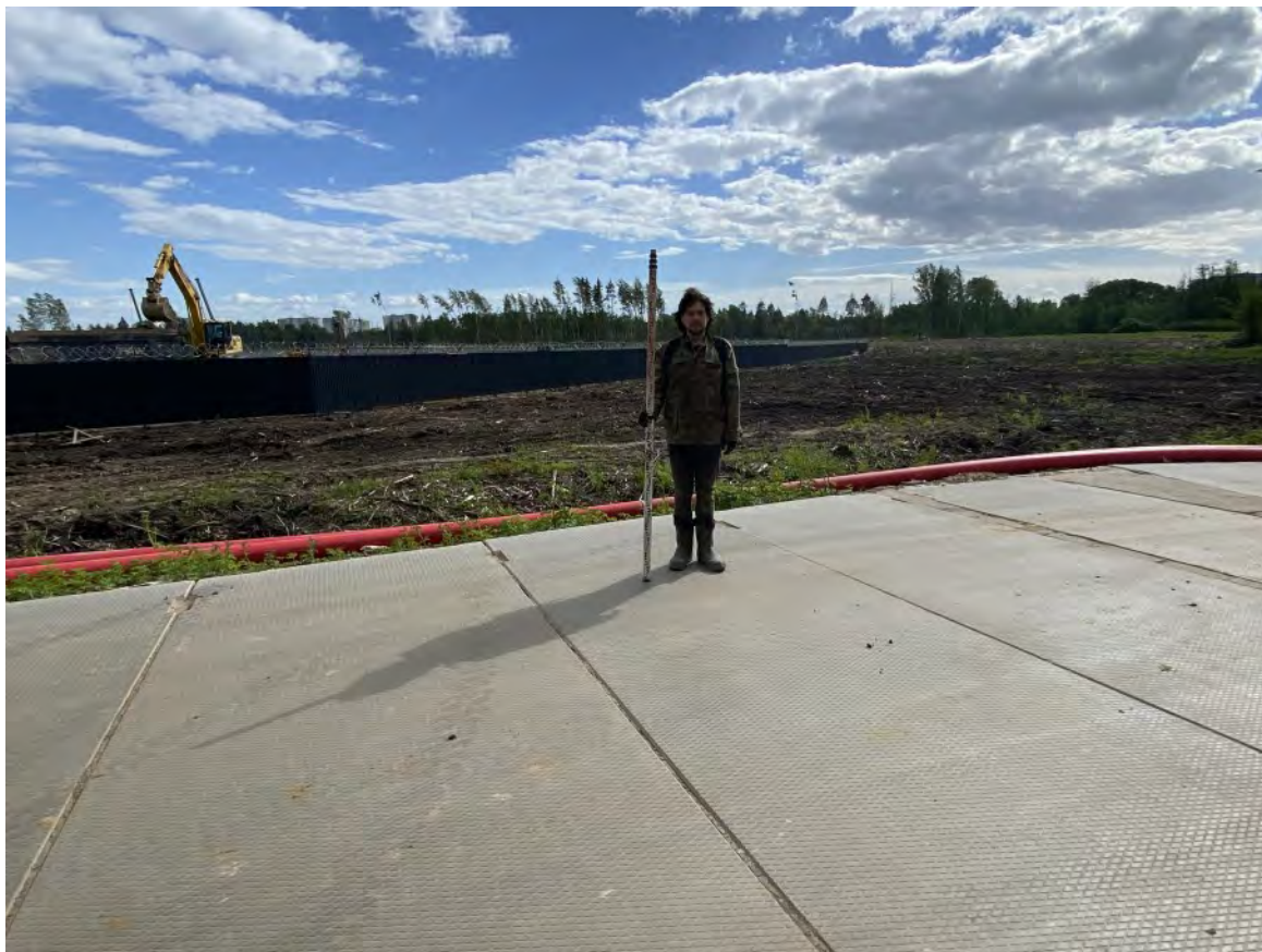
Рис. 101. «Проектирование и строительство улично-дорожной сети» в г. Мурино. Точка фотофиксации № 23. Вид с севера.
