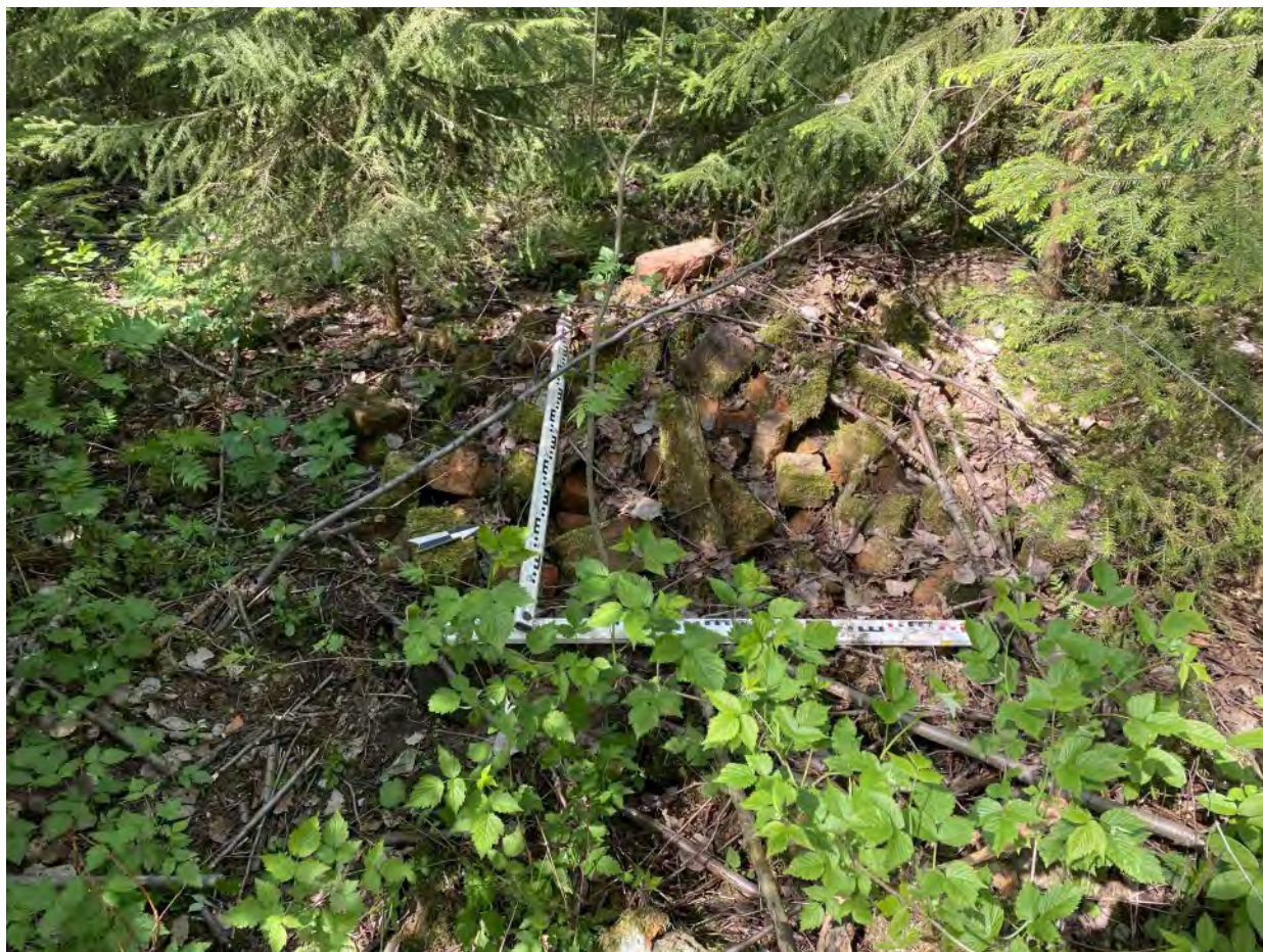
Рис. 106. «Проектирование и строительство улично-дорожной сети» в г. Мурино. Скопление битого кирпича. Вид с юго-востока.
