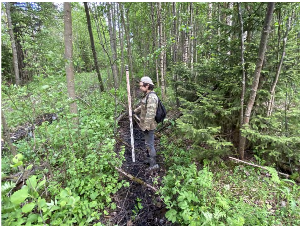
Рис. 110. «Проектирование и строительство улично-дорожной сети» в г. Мурино. Канавка между дорогой и залезнодорожной насыпью. Вид с северо-запада.
