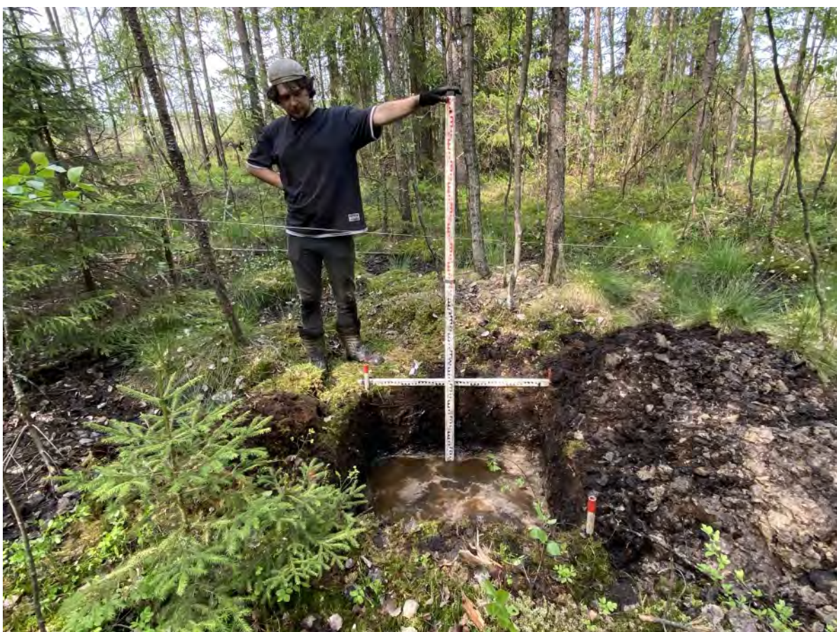
Рис. 184. «Проектирование и строительство улично-дорожной сети» в г. Мурино. Шурф № 8. Вид на раскопанный шурф. Вид с юга.
