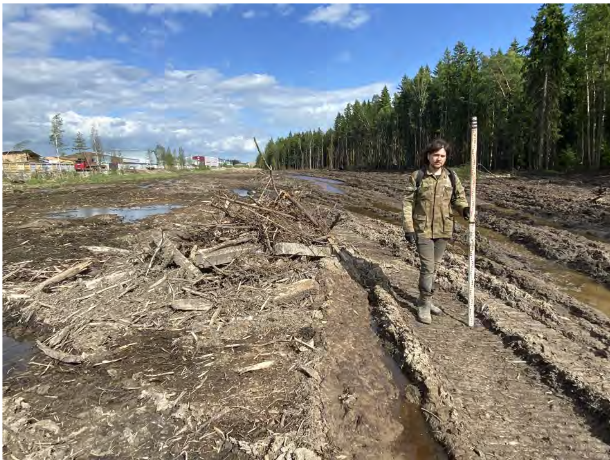
Рис. 100. «Проектирование и строительство улично-дорожной сети» в г. Мурино. Точка фотофиксации № 22. Вид с запада.
