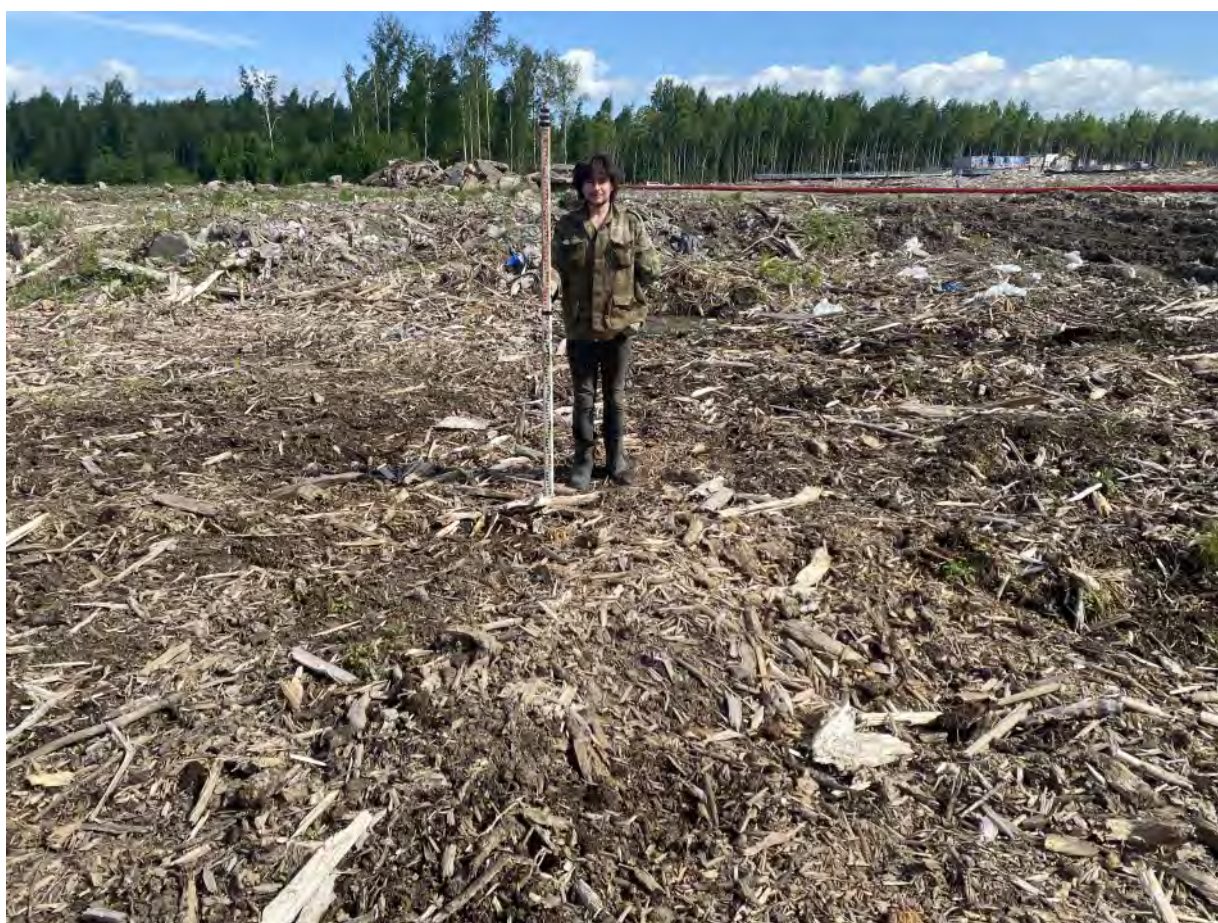
Рис. 300. «Проектирование и строительство улично-дорожной сети» в г. Мурино. Шурф № 21. Вид на место закладки шурфа до начала работ. Вид с юга.
