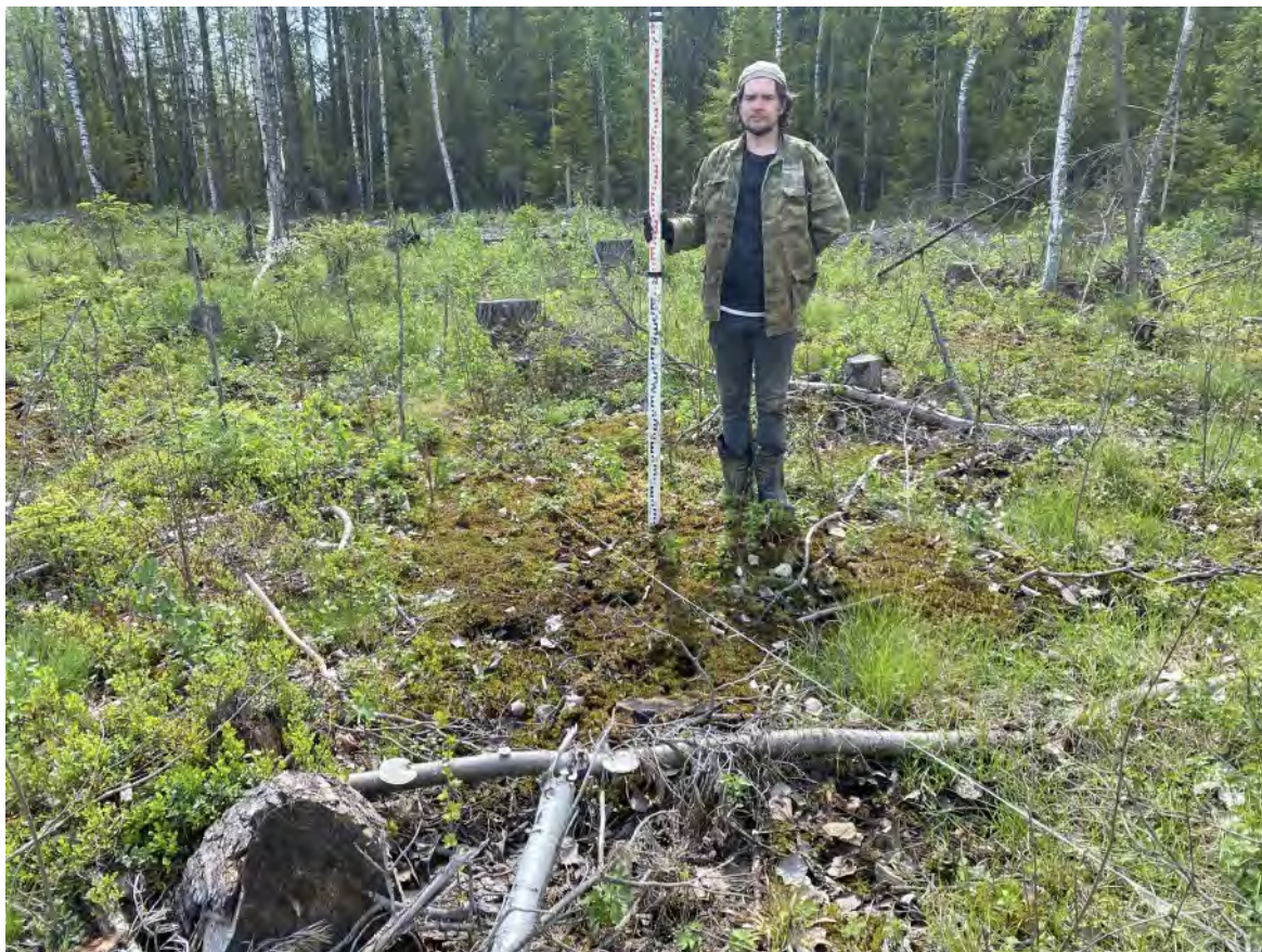
Рис. 170. «Проектирование и строительство улично-дорожной сети» в г. Мурино. Шурф № 7. Вид на место закладки шурфа до начала работ. Вид с севера.
