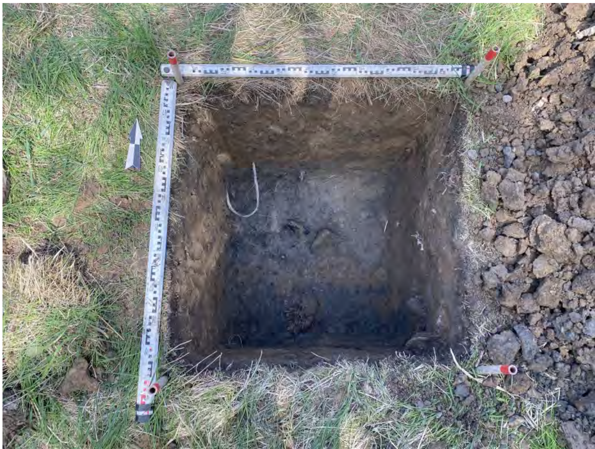
Рис. 121. «Проектирование и строительство улично-дорожной сети» в г. Мурино. Шурф № 1. Вид на раскопанный шурф. Вид с юга.
