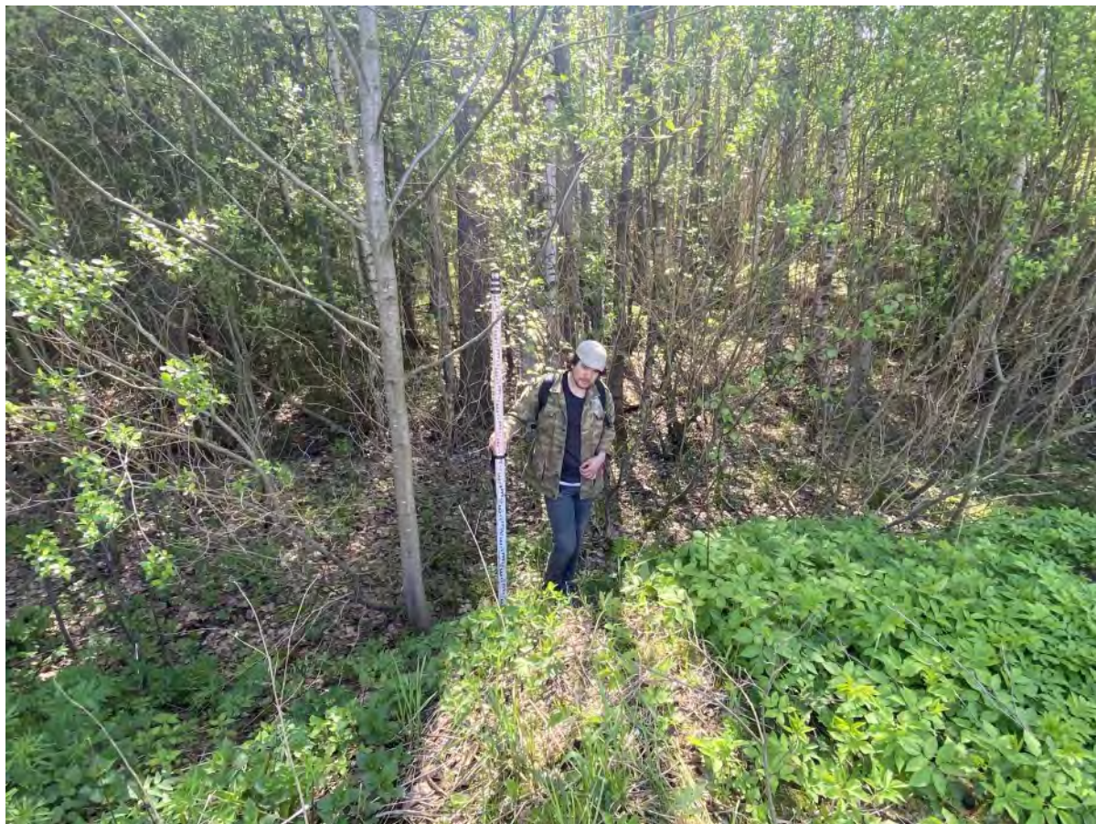
Рис. 19. «Проектирование и строительство улично-дорожной сети» в г. Мурино. Точка фиксации № 1. Вид с севера.
