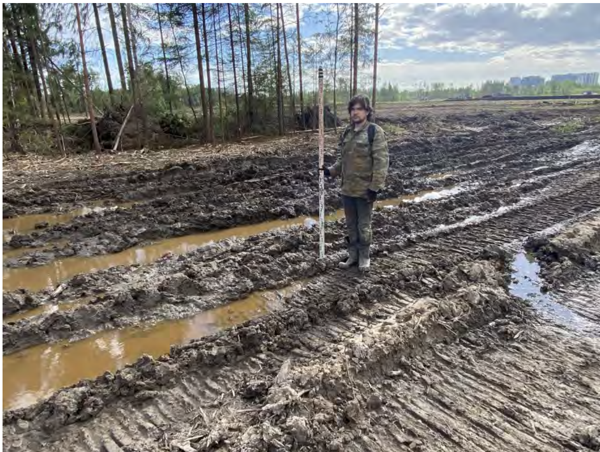
Рис. 97. «Проектирование и строительство улично-дорожной сети» в г. Мурино. Точка фиксации № 22. Вид с севера.
