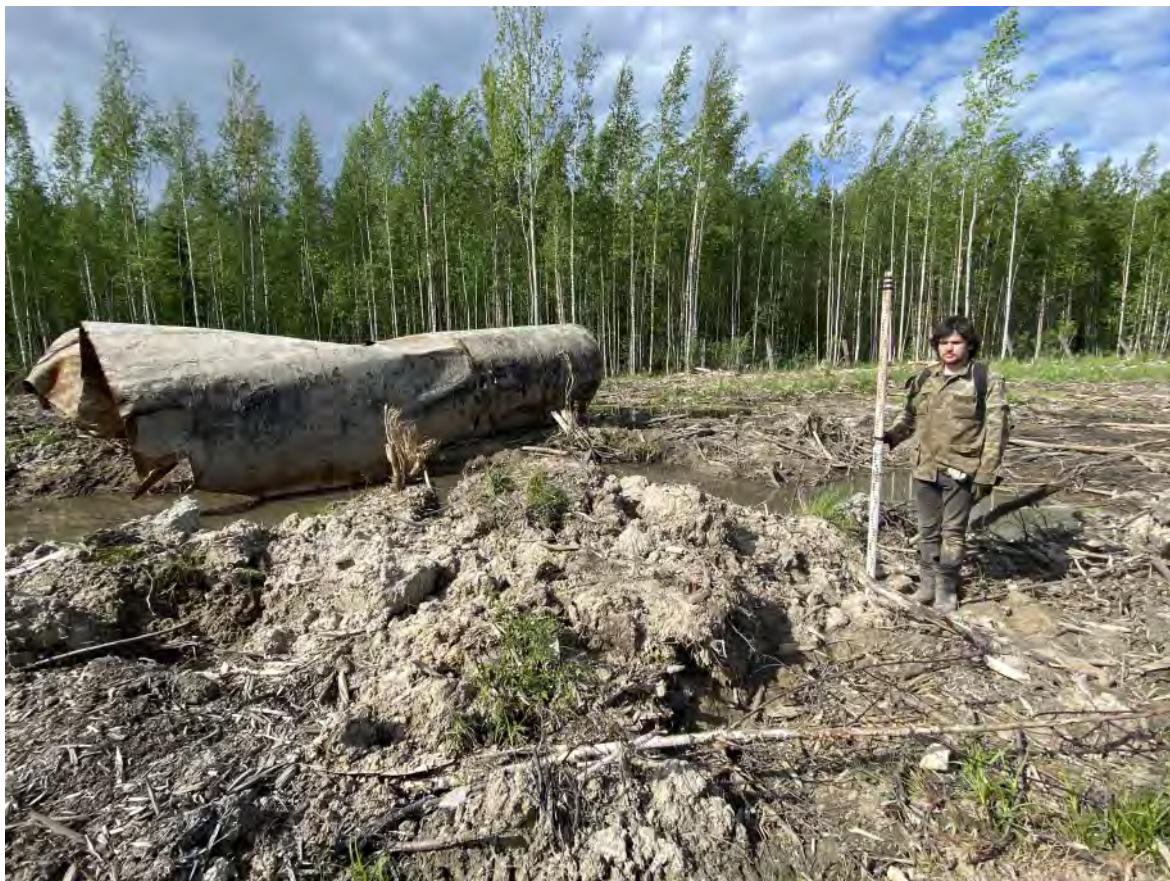
Рис. 95. «Проектирование и строительство улично-дорожной сети» в г. Мурино. Точка фотофиксации № 21. Вид с юга.
