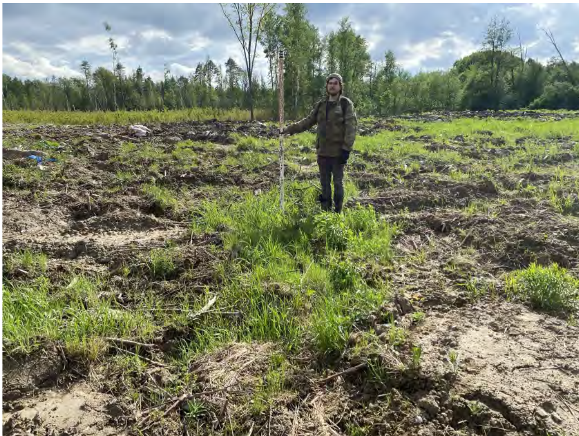
Рис. 73. «Проектирование и строительство улично-дорожной сети» в г. Мурино. Точка фотофиксации № 16. Вид с севера.
