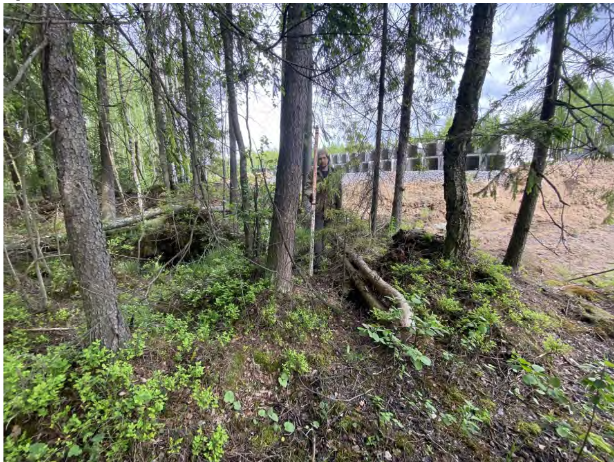
Рис. 72. «Проектирование и строительство улично-дорожной сети» в г. Мурино. Точка фотофиксации № 15. Вид с запада.
