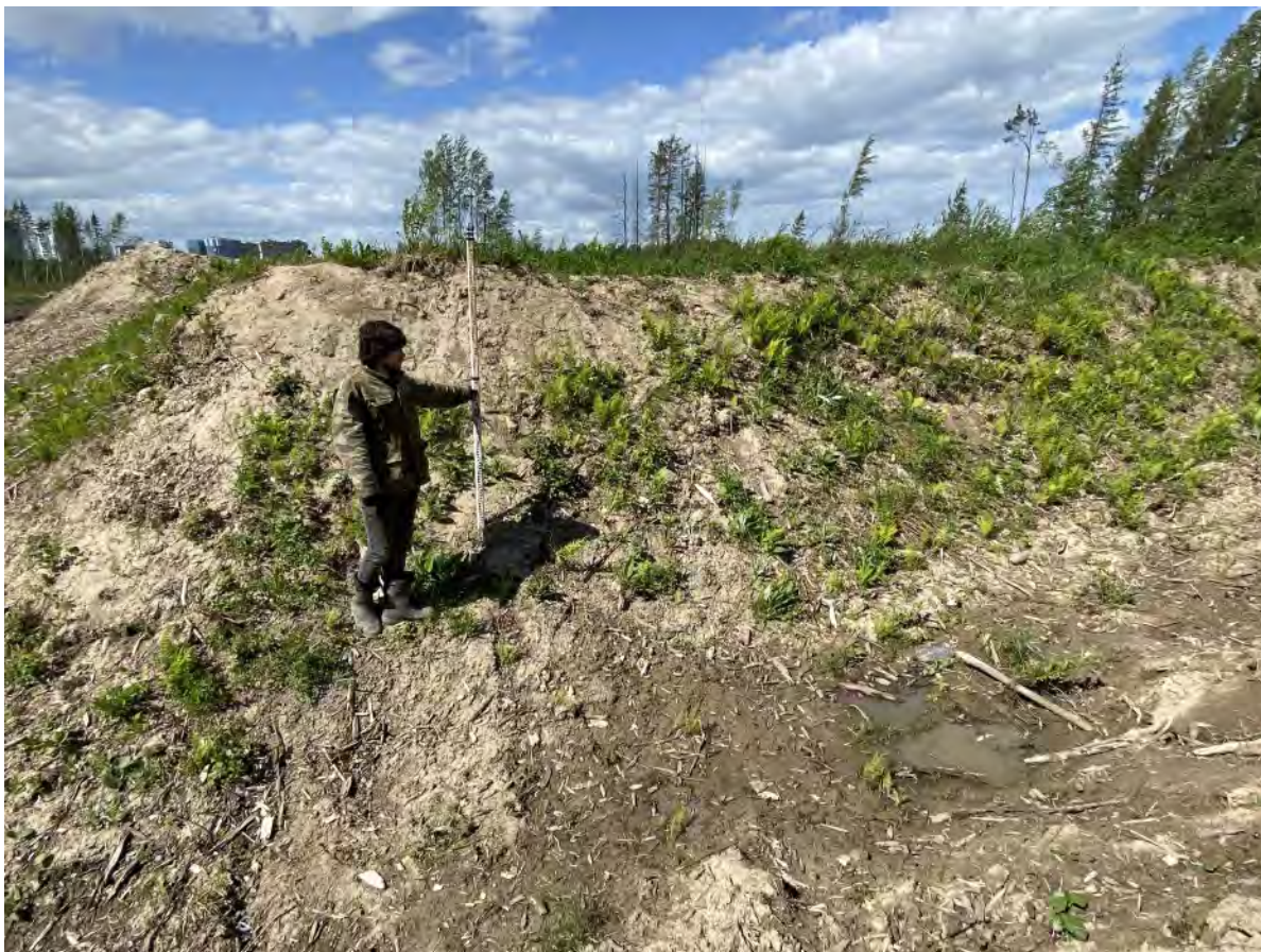
Рис. 91. «Проектирование и строительство улично-дорожной сети» в г. Мурино. Точка фотофиксации № 20. Вид с юга.
