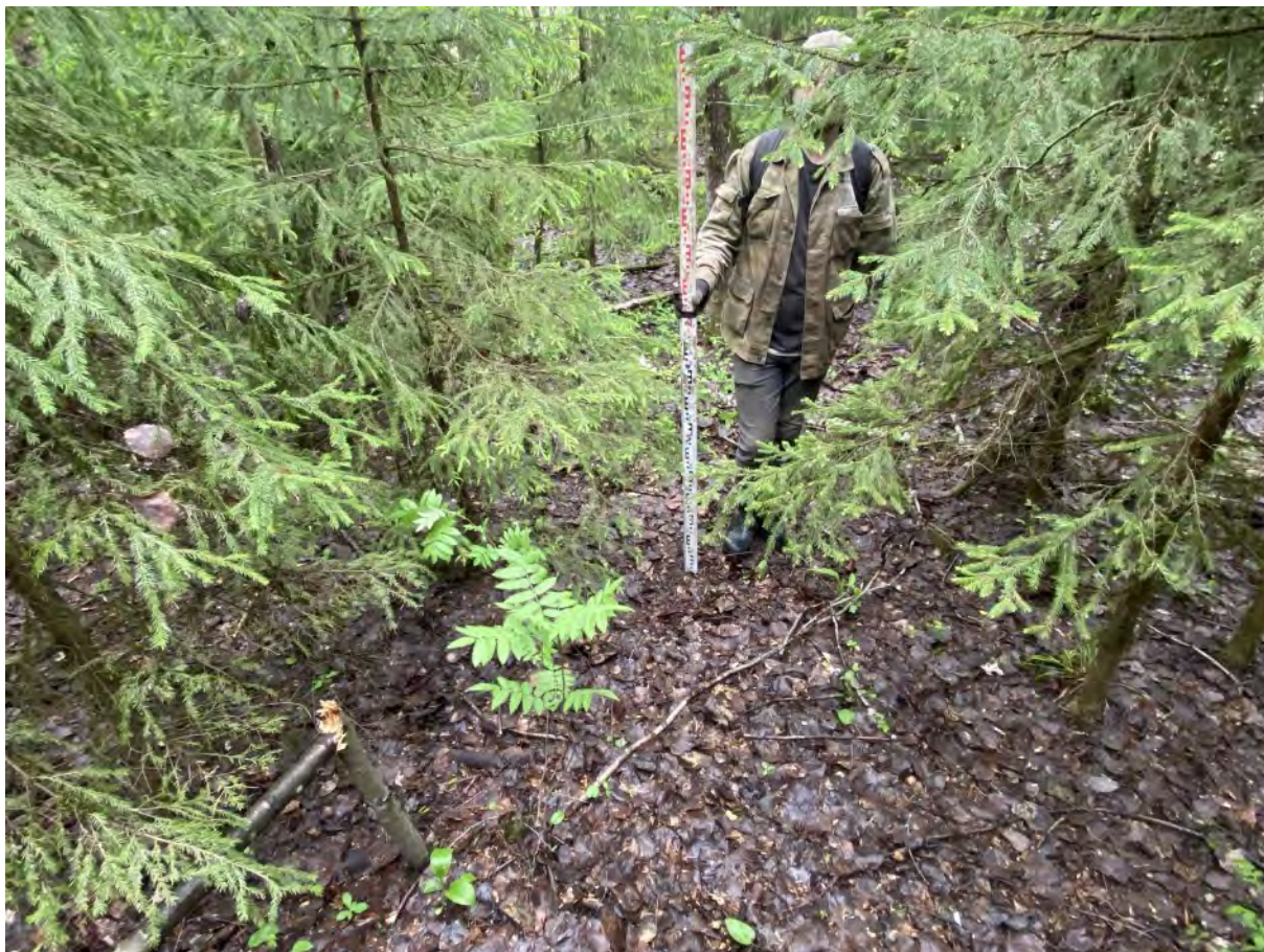
Рис. 271. «Проектирование и строительство улично-дорожной сети» в г. Мурино. Шурф № 18. Вид на место закладки шурфа до начала работ. Вид с севера.
