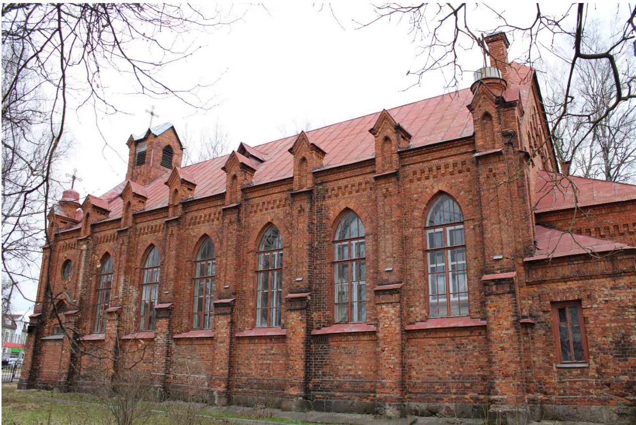
Илл. 7. Юго-западный фасад. Общий вид. Дата фотофиксации: 14.04.26.
