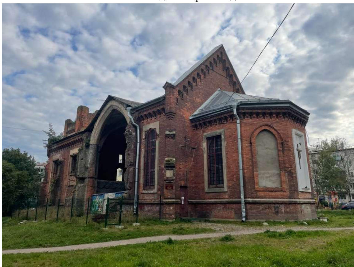
2. Вид с северо-запада
