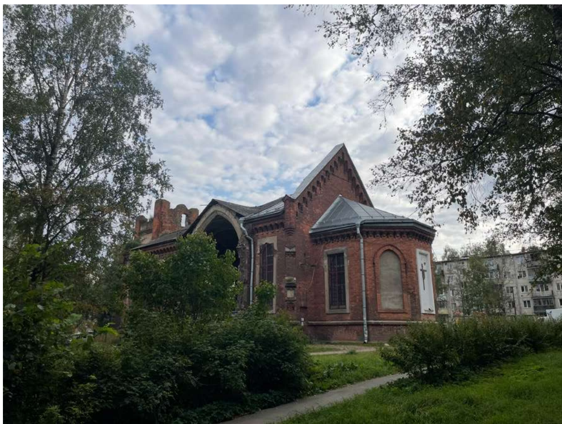
1. Вид с северо-запада
