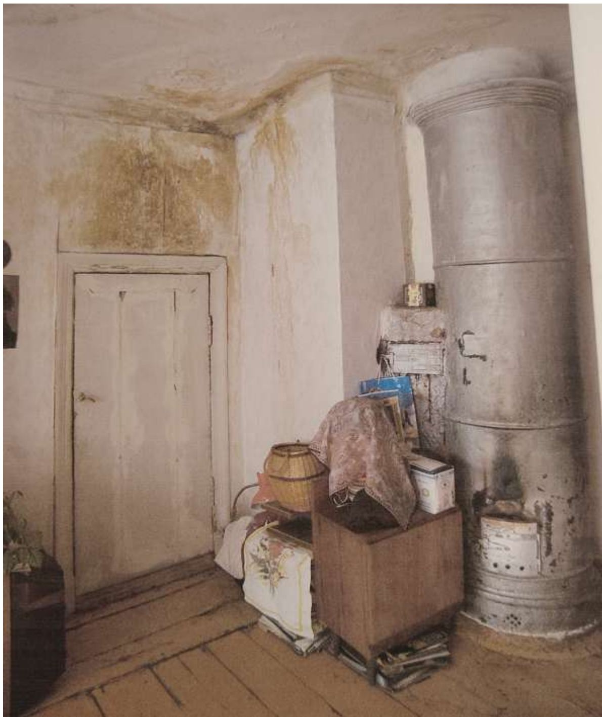
17. Интерьер усадебного дома, северная комната мезонина, вид на печь с севера. 2009 г. Историко-культурная экспертиза выявленного объекта культурного наследия «Усадьба Клодницкой с дворовыми постройками», 2-я пол. 19 - нач. 20 вв. по адресу: Ленинградская область, г. Гатчина, ул. Достоевского, д. 20/14
