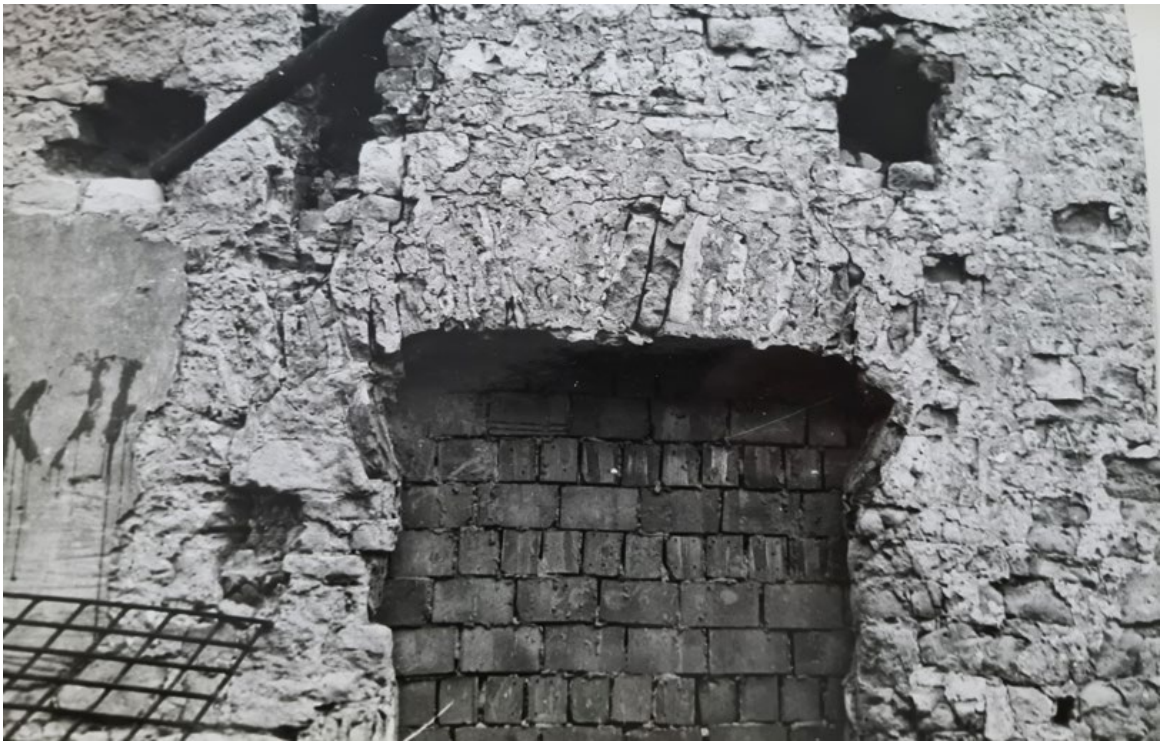
Рис. 93. Круглая рига. Фотофиксация 1988 года. Источник: Архив комитета по сохранению объектов культурного наследия Ленинградской области.
