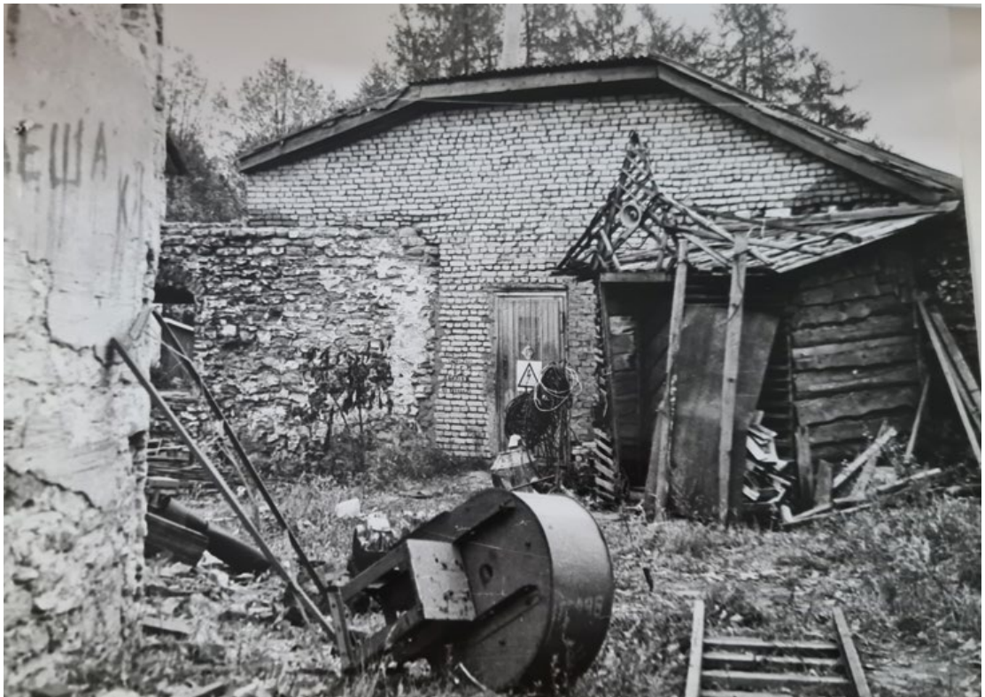
Рис. 79. Круглая рига. Фотофиксация 1988 года. Источник: Архив комитета по сохранению объектов культурного наследия Ленинградской области.
