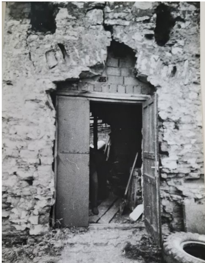
Рис. 94. Круглая рига. Фотофиксация 1988 года. Источник: Архив комитета по сохранению объектов культурного наследия Ленинградской области.
