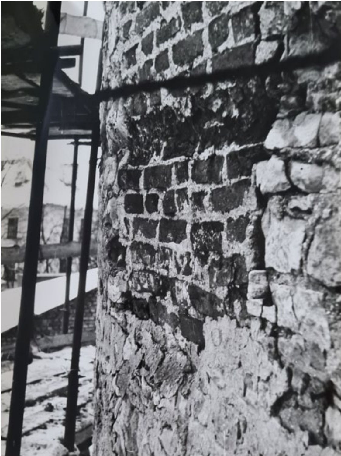
Рис. 98. Круглая рига. Фотофиксация 1988 года. Источник: Архив комитета по сохранению объектов культурного наследия Ленинградской области.
