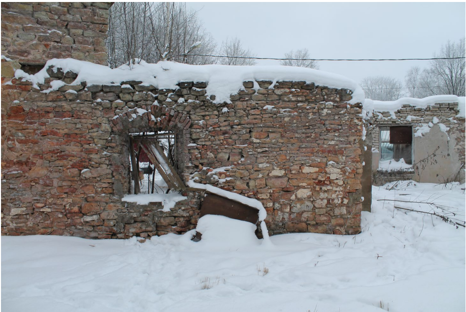
Фото 2.12 Фрагмент наружного кольца стен и южная пристройка. Дата съёмки: январь 2026г. Автор съёмки: Ведерникова В.В.
