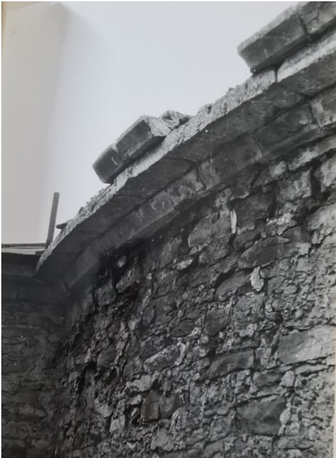
Рис. 107. Круглая рига. Фотофиксация 1988 года. Источник: Архив комитета по сохранению объектов культурного наследия Ленинградской области.
