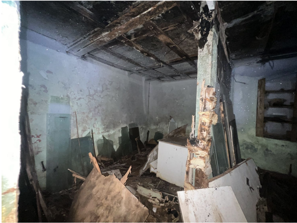
Фото 2.7 Двухэтажная пристройка, 1 этаж. Дальнее помещение справа. Дата съёмки: январь 2026г. Автор съёмки: Ведерникова В.В.
