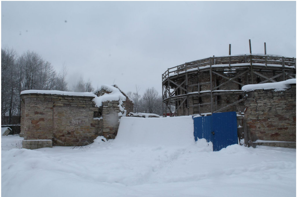
Фото 1.10 Северо-восточный фасад, вид с северо-востока. Дата съёмки: январь 2026г. Автор съёмки: Ведерникова В.В.
