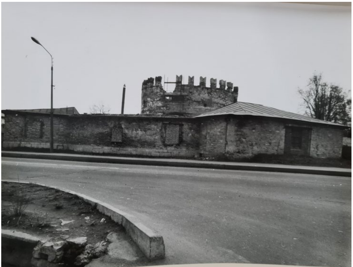
Рис. 60. Круглая рига. Фотофиксация 1988 года. Источник: Архив комитета по сохранению объектов культурного наследия Ленинградской области.
