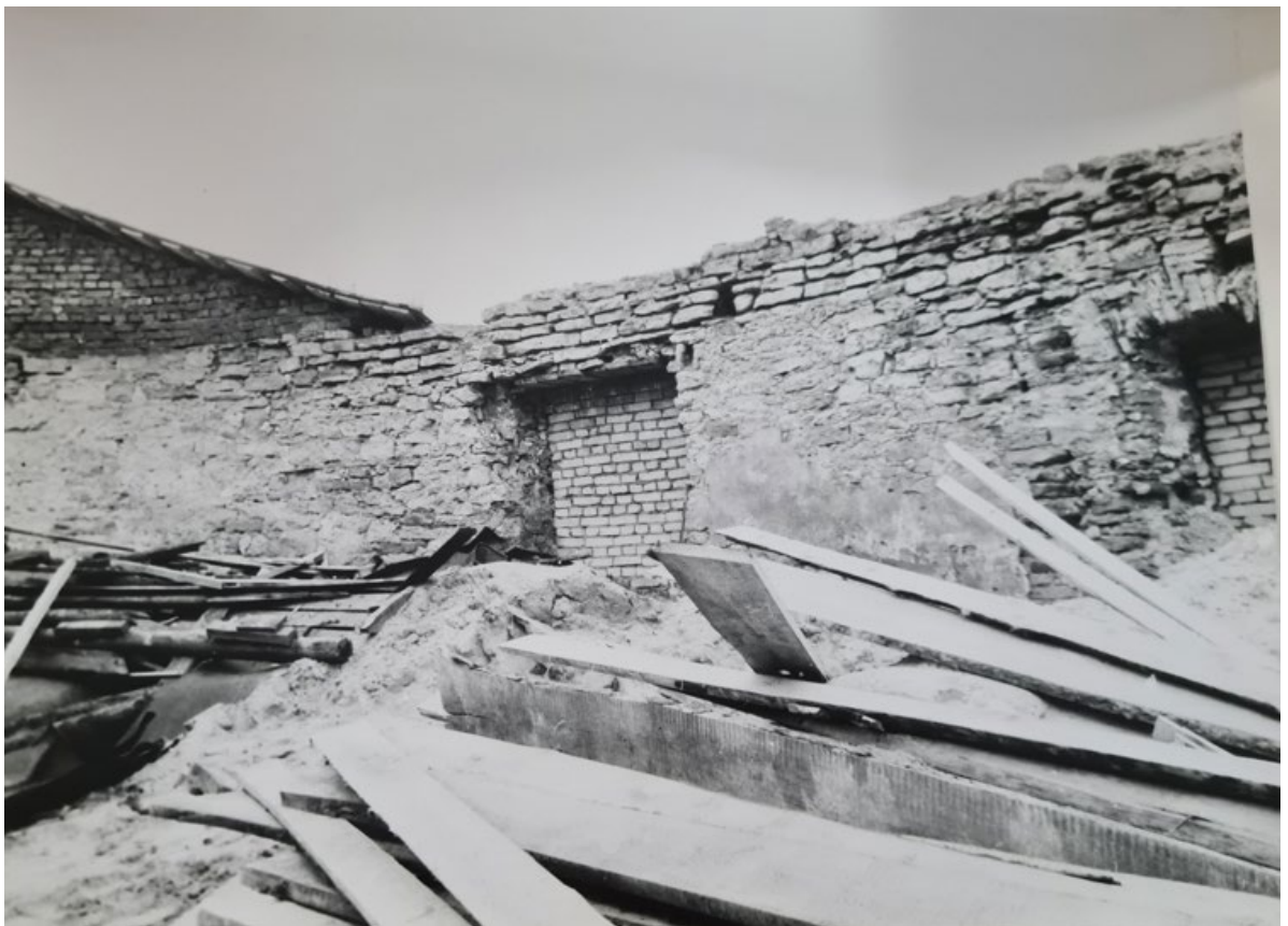
Рис. 82. Круглая рига. Фотофиксация 1988 года. Источник: Архив комитета по сохранению объектов культурного наследия Ленинградской области.
