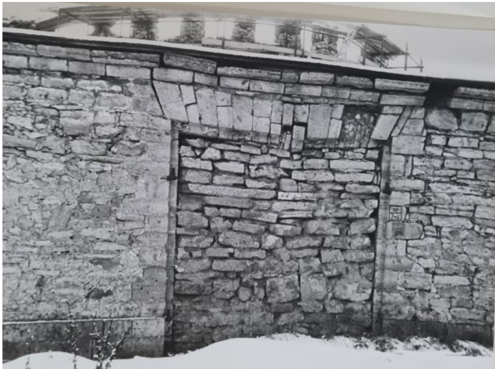
Рис. 72. Круглая рига. Фотофиксация 1988 года. Источник: Архив комитета по сохранению объектов культурного наследия Ленинградской области.
