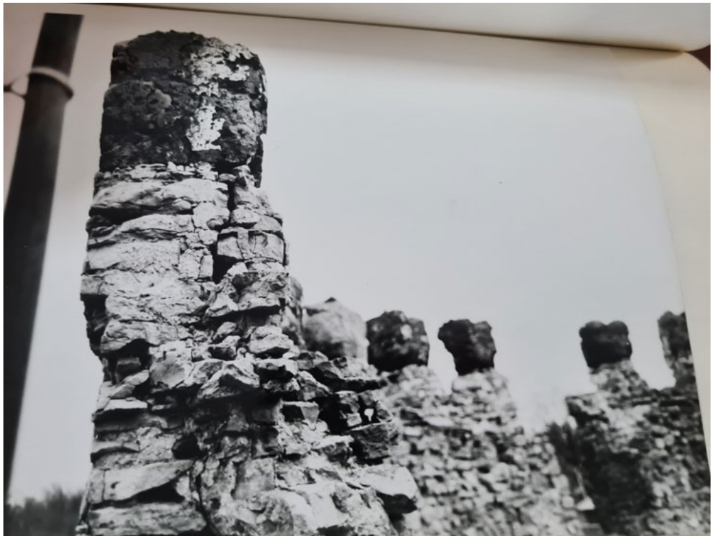
Рис. 105. Круглая рига. Фотофиксация 1988 года. Источник: Архив комитета по сохранению объектов культурного наследия Ленинградской области.
