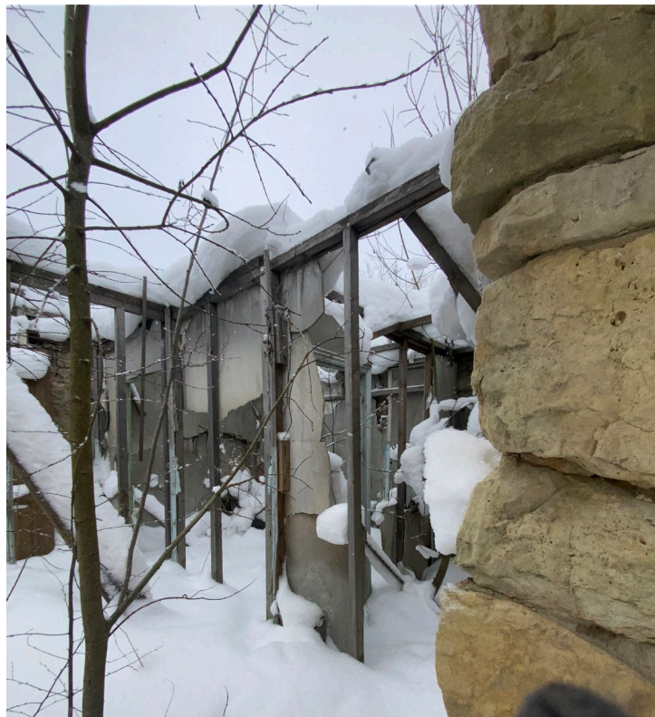
Фото 2.15 Западная пристройка. Вид из проема направо. Дата съёмки: январь 2026г. Автор съёмки: Ведерникова В.В.
