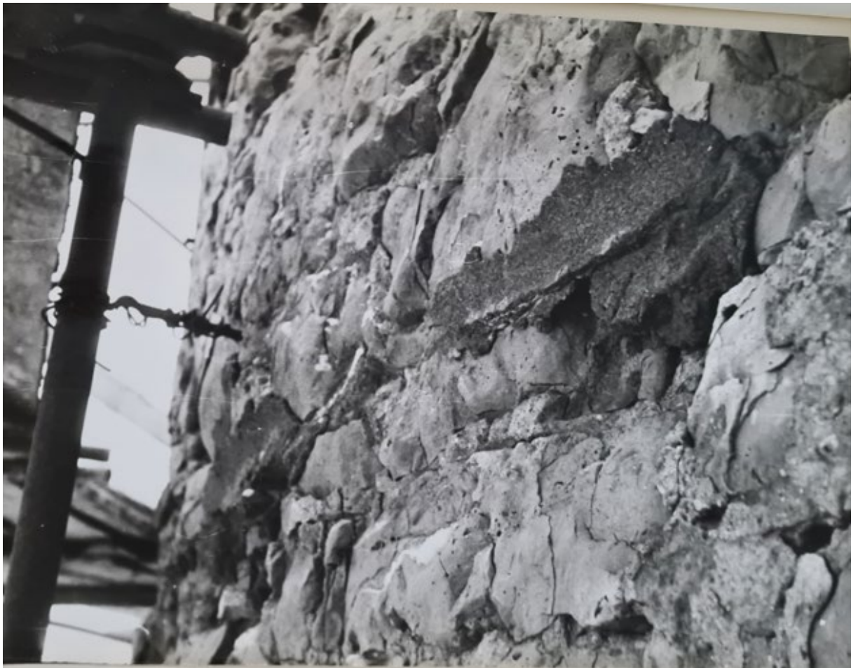
Рис. 97. Круглая рига. Фотофиксация 1988 года. Источник: Архив комитета по сохранению объектов культурного наследия Ленинградской области.
