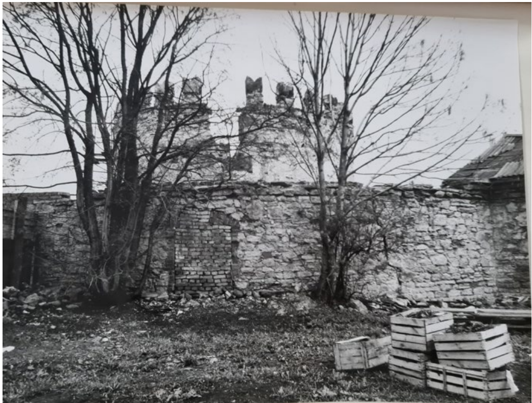
Рис. 63. Круглая рига. Фотофиксация 1988 года. Источник: Архив комитета по сохранению объектов культурного наследия Ленинградской области.
