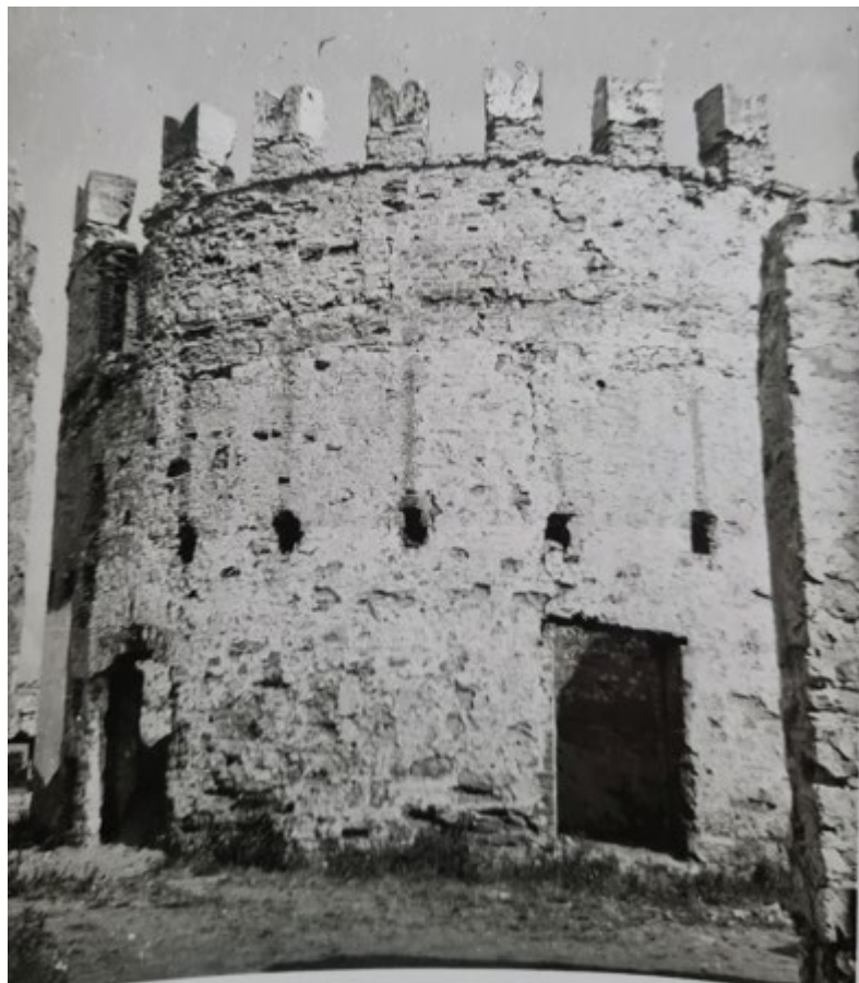
Рис. 49. Круглая рига. Фотофиксация 1948 года. Источник: Архив комитета по сохранению объектов культурного наследия Ленинградской области.
