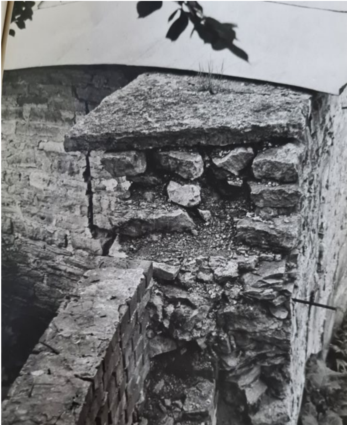
Рис. 110. Круглая рига. Фотофиксация 1988 года. Источник: Архив комитета по сохранению объектов культурного наследия Ленинградской области.
