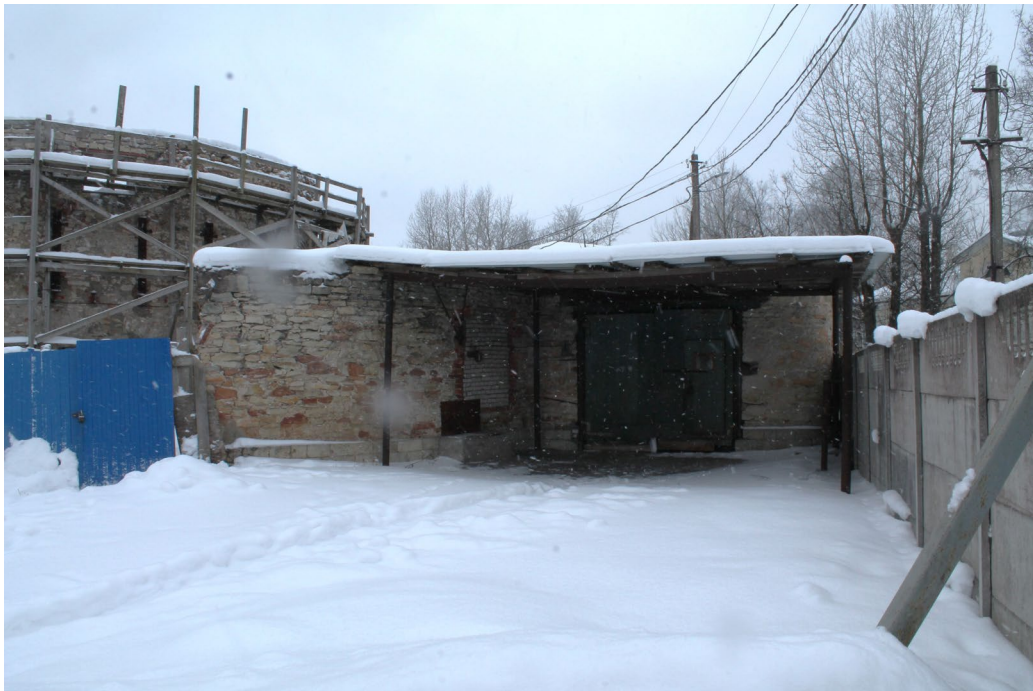
Фото 1.11 Фрагмент северо-восточного фасада, вид с востока. Дата съёмки: январь 2026г. Автор съёмки: Ведерникова В.В.
