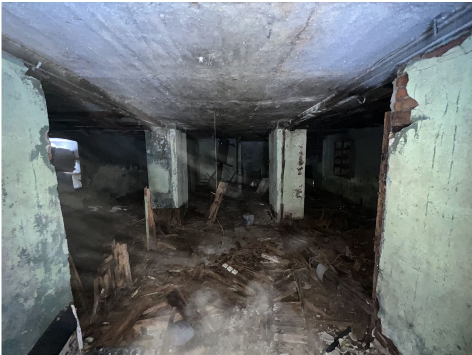
Фото 2.6 Двухэтажная пристройка, 1 этаж. Общий вид этажа. Дата съёмки: январь 2026г. Автор съёмки: Ведерникова В.В.
