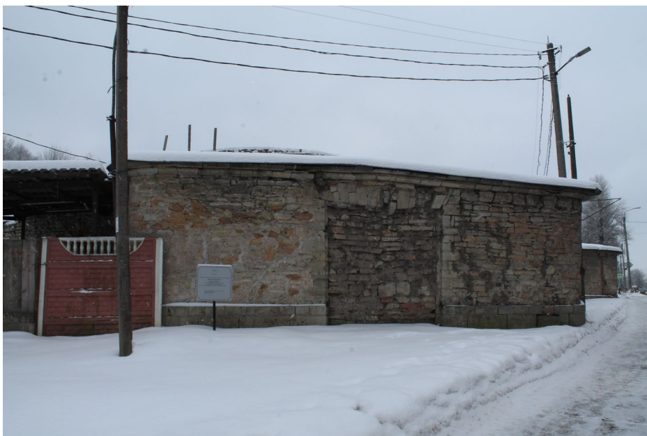
Фото 2.22 Северная пристройка. Дата съёмки: январь 2026г. Автор съёмки: Ведерникова В.В.
