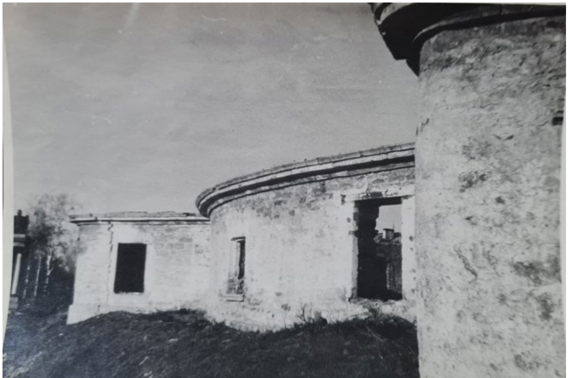
Рис. 45. Круглая рига. Фотофиксация 1948 года. Источник: Архив комитета по сохранению объектов культурного наследия Ленинградской области.
