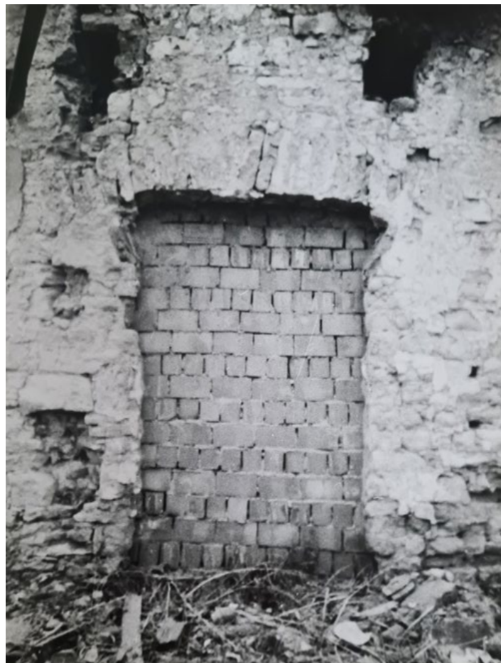
Рис. 92. Круглая рига. Фотофиксация 1988 года. Источник: Архив комитета по сохранению объектов культурного наследия Ленинградской области.
