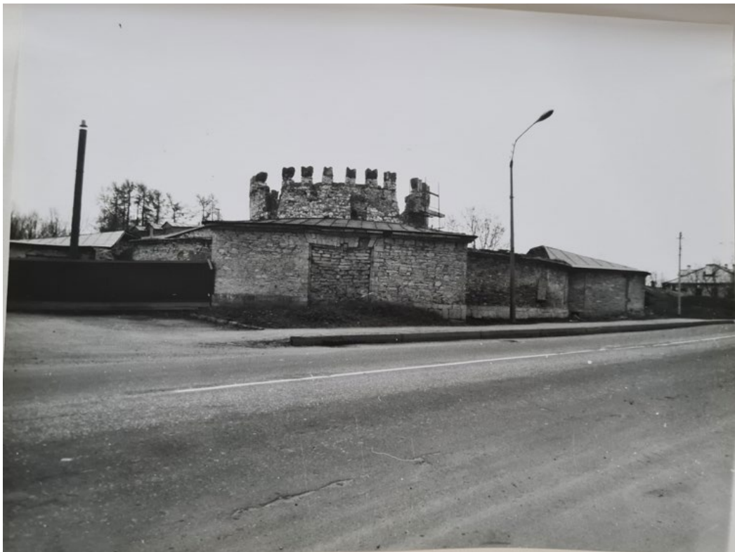
Рис. 62. Круглая рига. Фотофиксация 1988 года. Источник: Архив комитета по сохранению объектов культурного наследия Ленинградской области.
