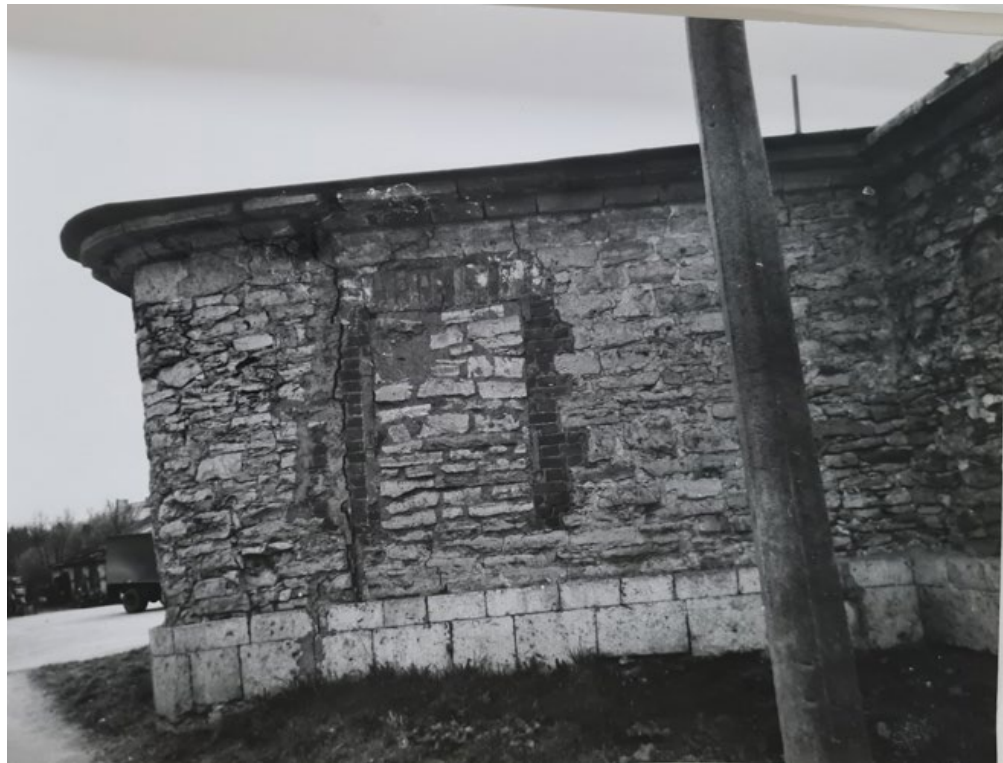
Рис. 71. Круглая рига. Фотофиксация 1988 года. Источник: Архив комитета по сохранению объектов культурного наследия Ленинградской области.
