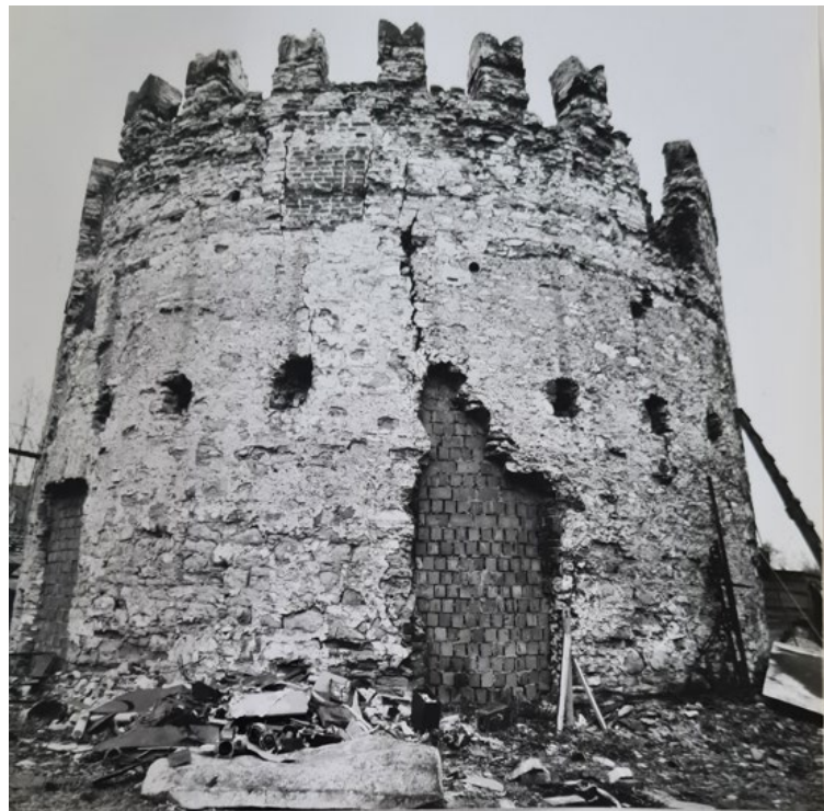
Рис. 90. Круглая рига. Фотофиксация 1988 года. Источник: Архив комитета по сохранению объектов культурного наследия Ленинградской области.
