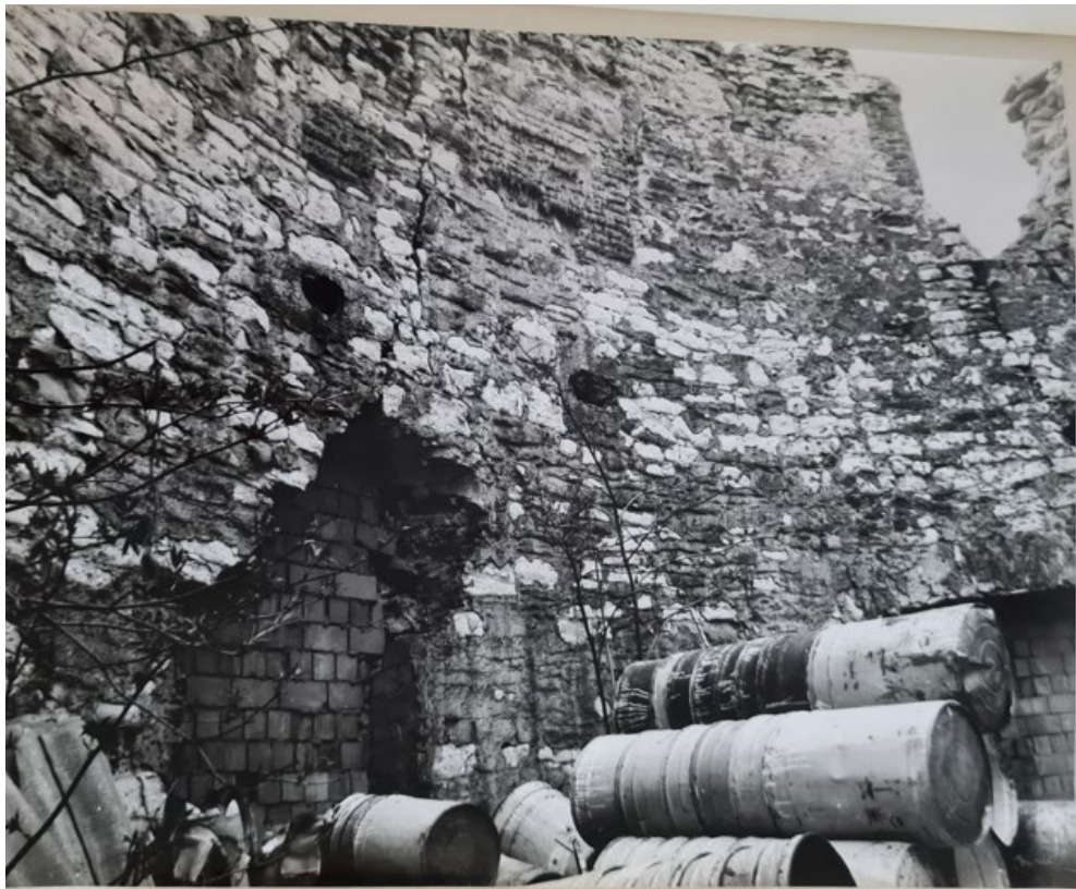
Рис. 99. Круглая рига. Фотофиксация 1988 года. Источник: Архив комитета по сохранению объектов культурного наследия Ленинградской области.
