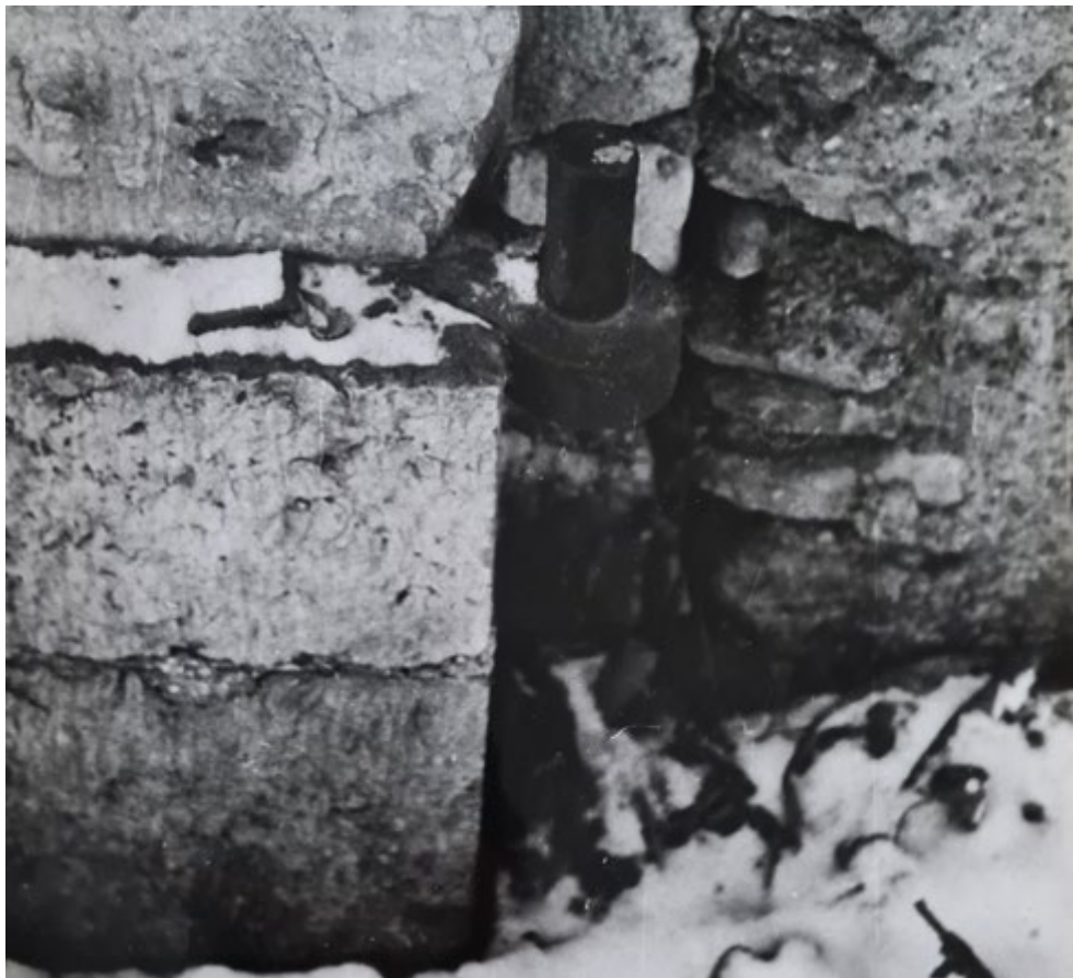
Рис. 78. Круглая рига. Фотофиксация 1988 года. Источник: Архив комитета по сохранению объектов культурного наследия Ленинградской области.
