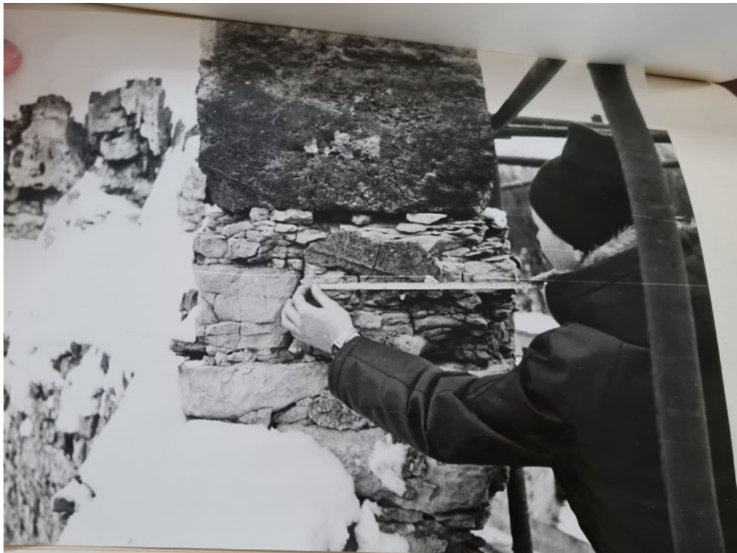
Рис. 106. Круглая рига. Фотофиксация 1988 года. Источник: Архив комитета по сохранению объектов культурного наследия Ленинградской области.
