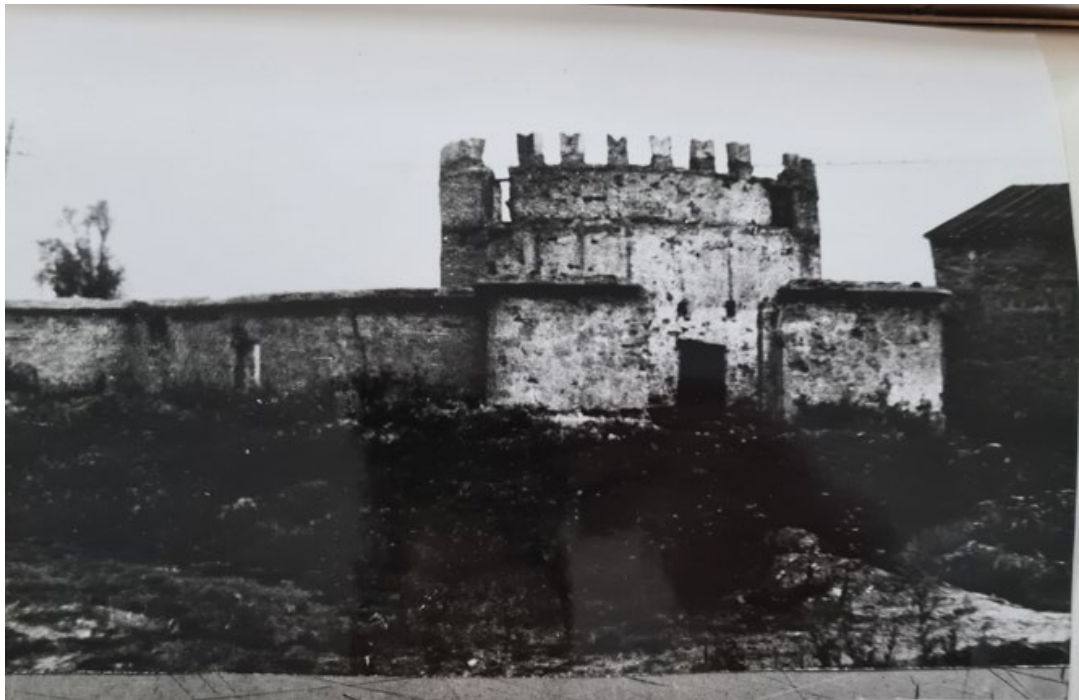
Рис. 50. Пересъемка с фотографии 1950-х годов, фрагмент фасада. Вид с юга. Источник: Архив комитета по сохранению объектов культурного наследия Ленинградской области.
