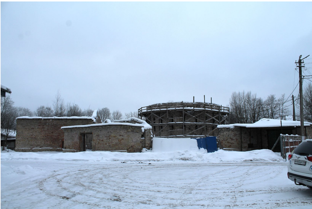
Фото 1.1 Северо-восточный фасад, вид с северо-востока. Дата съёмки: январь 2026г. Автор съёмки: Ведерникова В.В.
