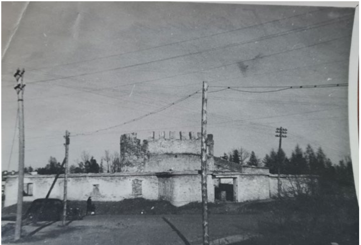
Рис. 47. Круглая рига. Фотофиксация 1948 года. Источник: Архив комитета по сохранению объектов культурного наследия Ленинградской области.
