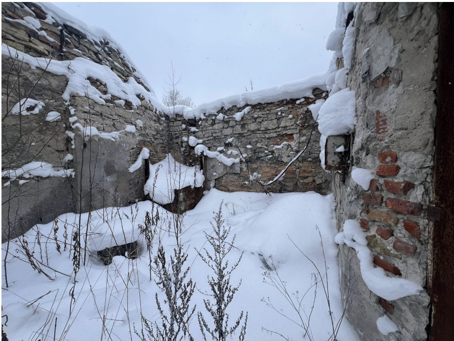
Фото 2.4 Восточная пристройка, вид изнутри. Дата съёмки: январь 2026г. Автор съёмки: Ведерникова В.В.
