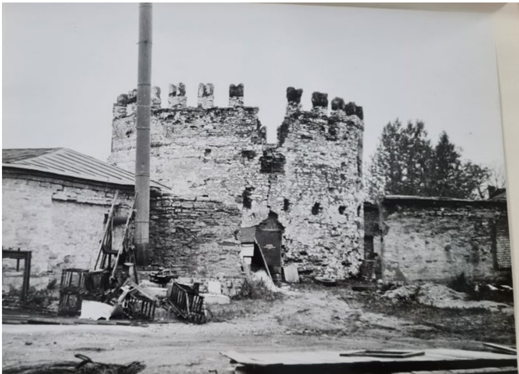
Рис. 64. Круглая рига. Фотофиксация 1988 года. Источник: Архив комитета по сохранению объектов культурного наследия Ленинградской области.
