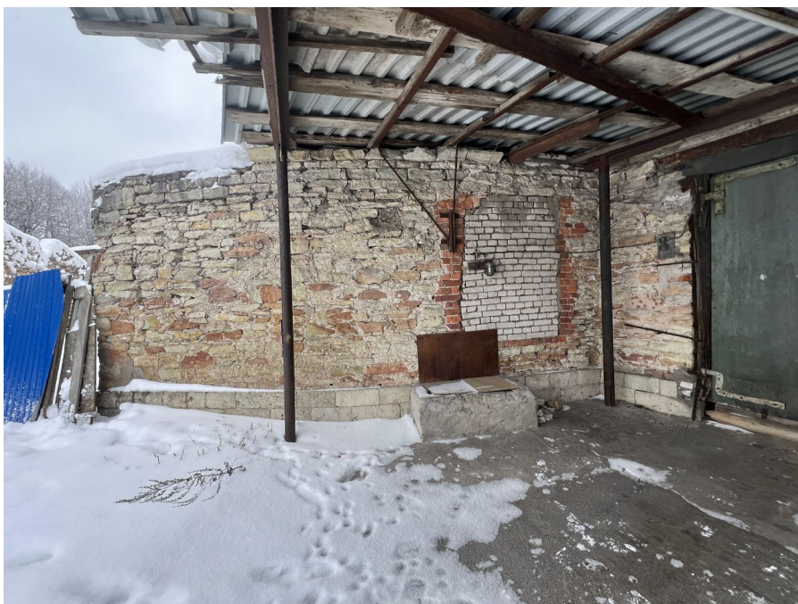
Поздний навес из профлиста по металлокаркасу у входа в пристройку, опирается на парапет стены уже без карнизных плит. В наружной радиальной стене поздний проем с краснокирпичными откосами заложен силикатным кирпичом. Под ним устроен поздний кирпичный приямок. В воротном проеме установлена металлические воротные створки с калиткой.
