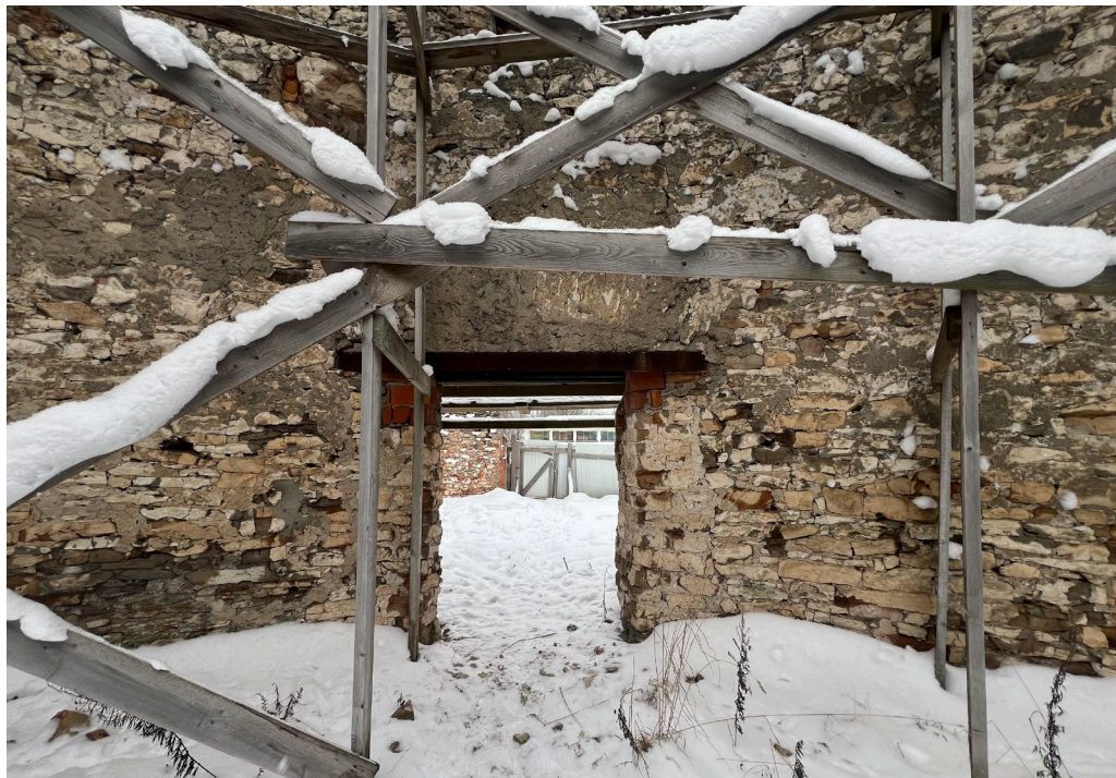
Фото 1.20 Внутреннее кольцо стен, вид изнутри. Дата съёмки: январь 2026г. Автор съёмки: Ведерникова В.В.
