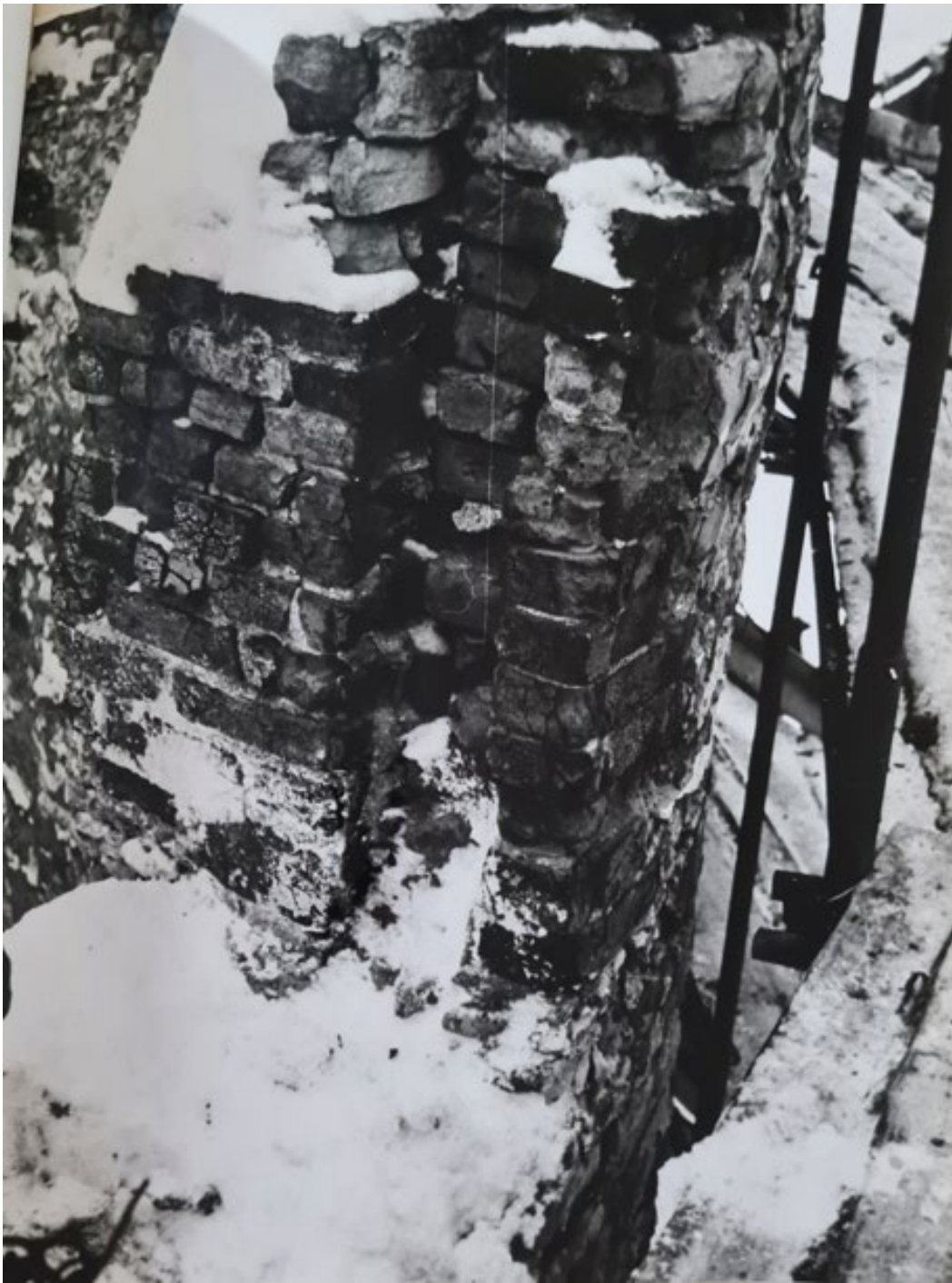
Рис. 103. Круглая рига. Фотофиксация 1988 года. Источник: Архив комитета по сохранению объектов культурного наследия Ленинградской области.
