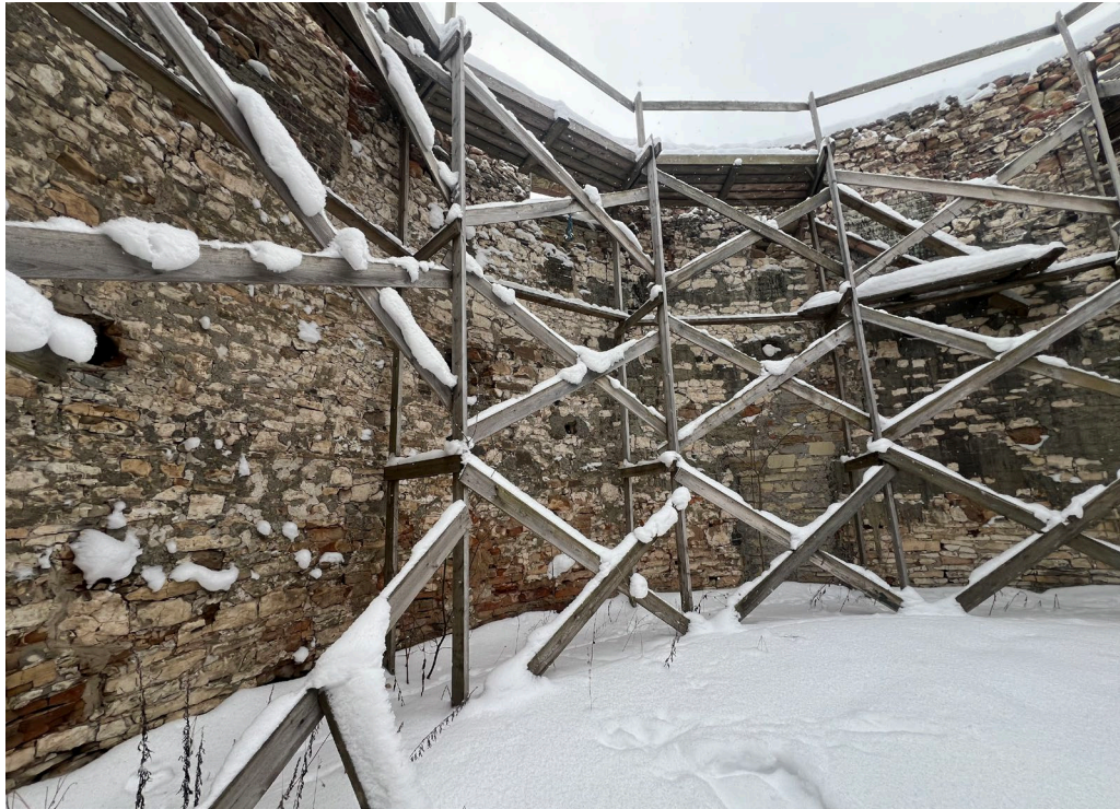
Фото 1.19 Внутреннее кольцо стен, вид изнутри. Дата съёмки: январь 2026г. Автор съёмки: Ведерникова В.В.
