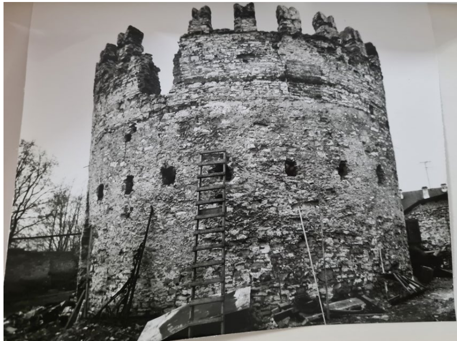
Рис. 91. Круглая рига. Фотофиксация 1988 года. Источник: Архив комитета по сохранению объектов культурного наследия Ленинградской области.
