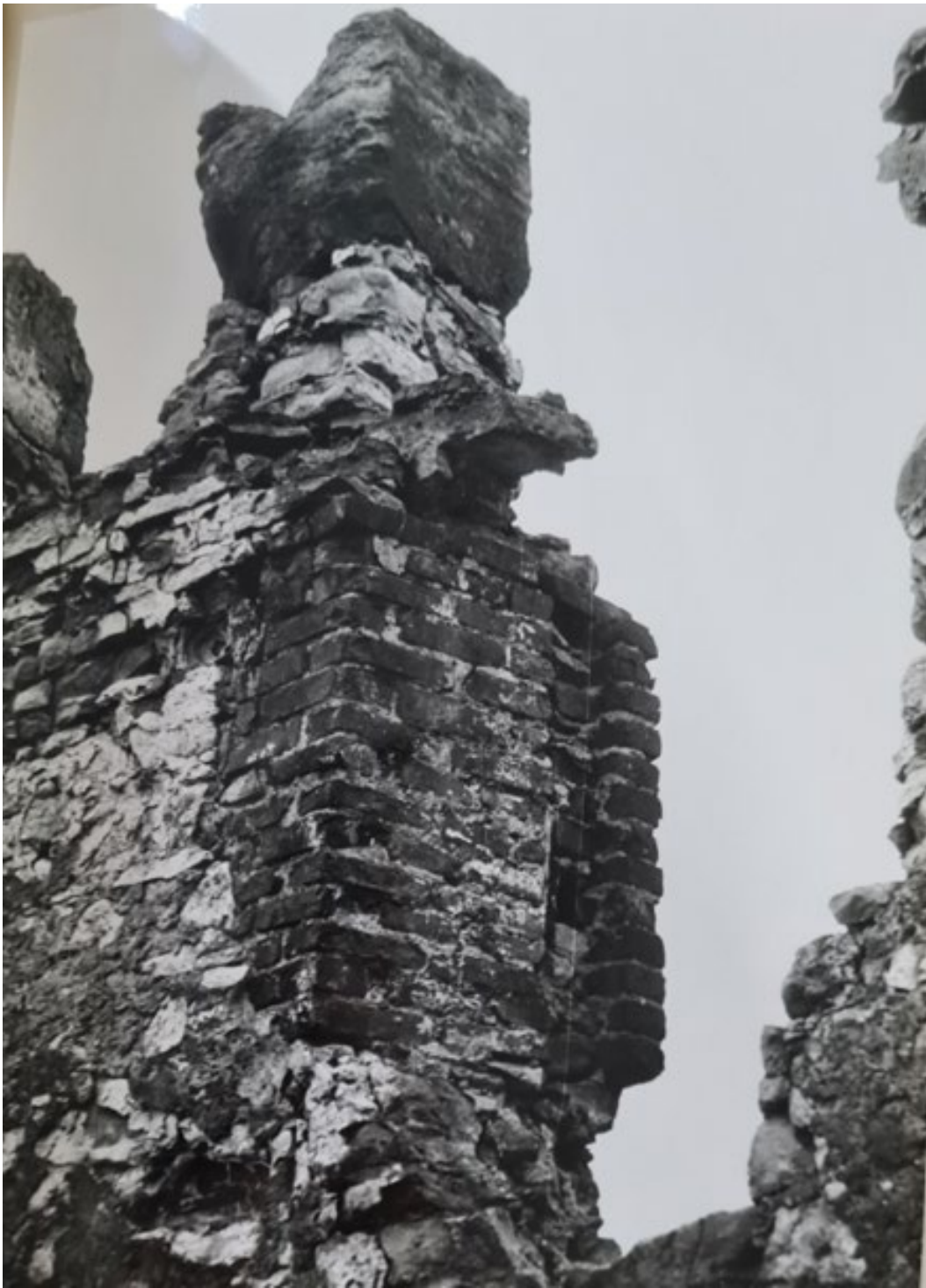
Рис. 104. Круглая рига. Фотофиксация 1988 года. Источник: Архив комитета по сохранению объектов культурного наследия Ленинградской области.
