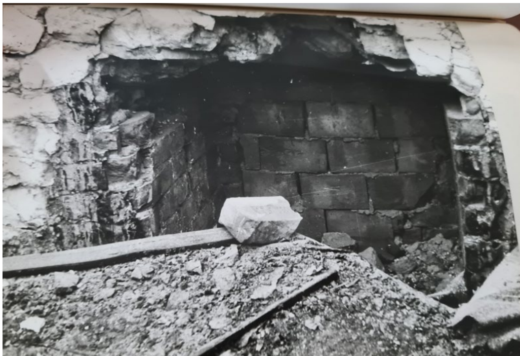
Рис. 102. Круглая рига. Фотофиксация 1988 года. Источник: Архив комитета по сохранению объектов культурного наследия Ленинградской области.
