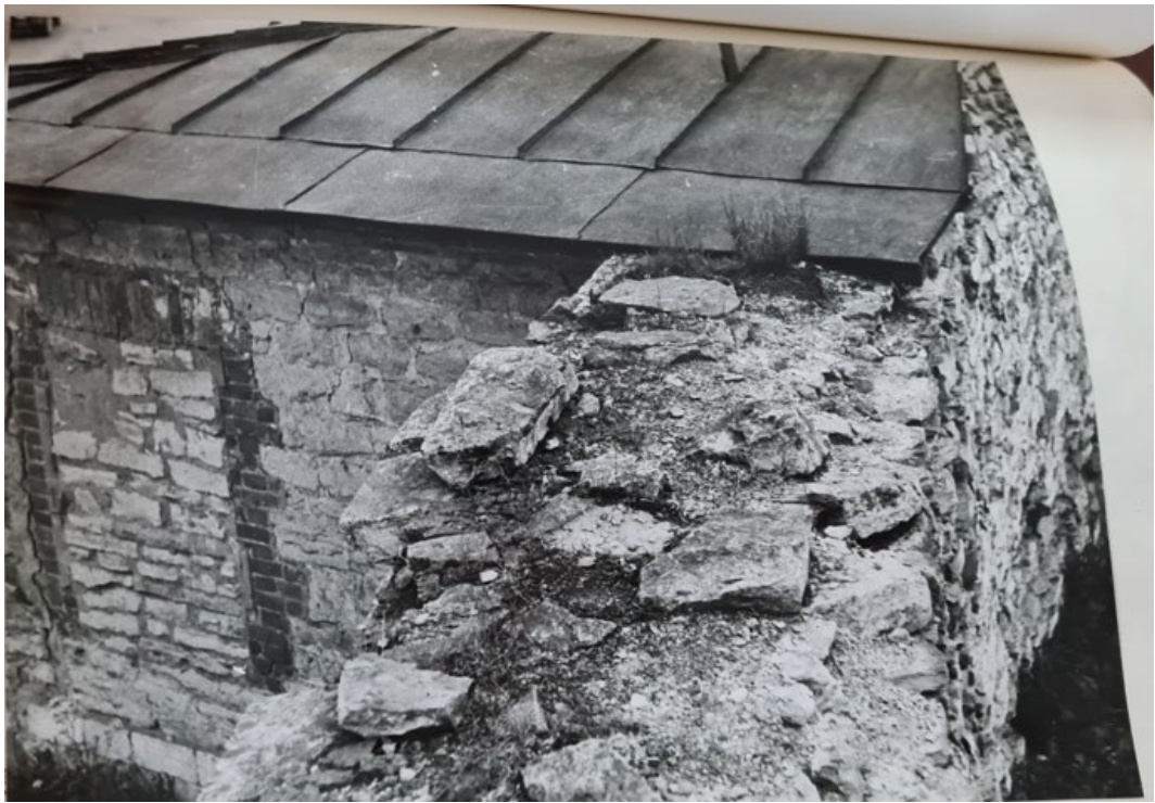
Рис. 108. Круглая рига. Фотофиксация 1988 года. Источник: Архив комитета по сохранению объектов культурного наследия Ленинградской области.
