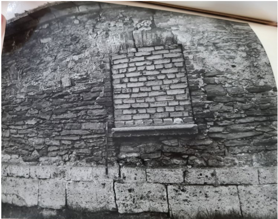
Рис. 109. Круглая рига. Фотофиксация 1988 года. Источник: Архив комитета по сохранению объектов культурного наследия Ленинградской области.
