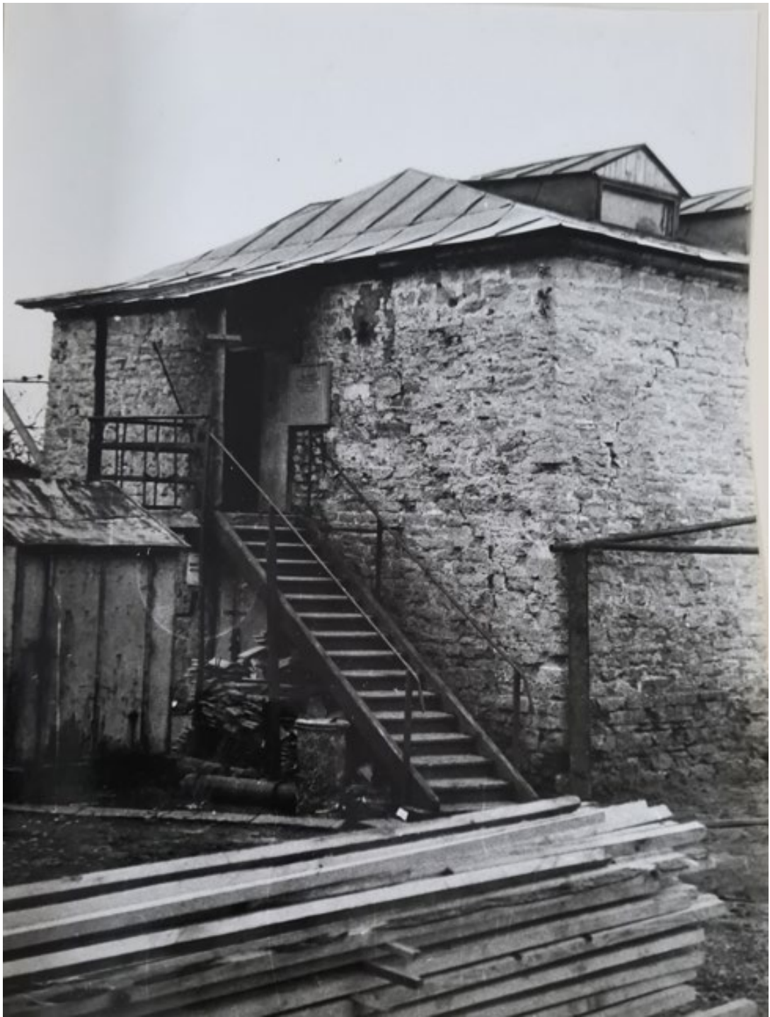
Рис. 76. Круглая рига. Фотофиксация 1988 года. Источник: Архив комитета по сохранению объектов культурного наследия Ленинградской области.
