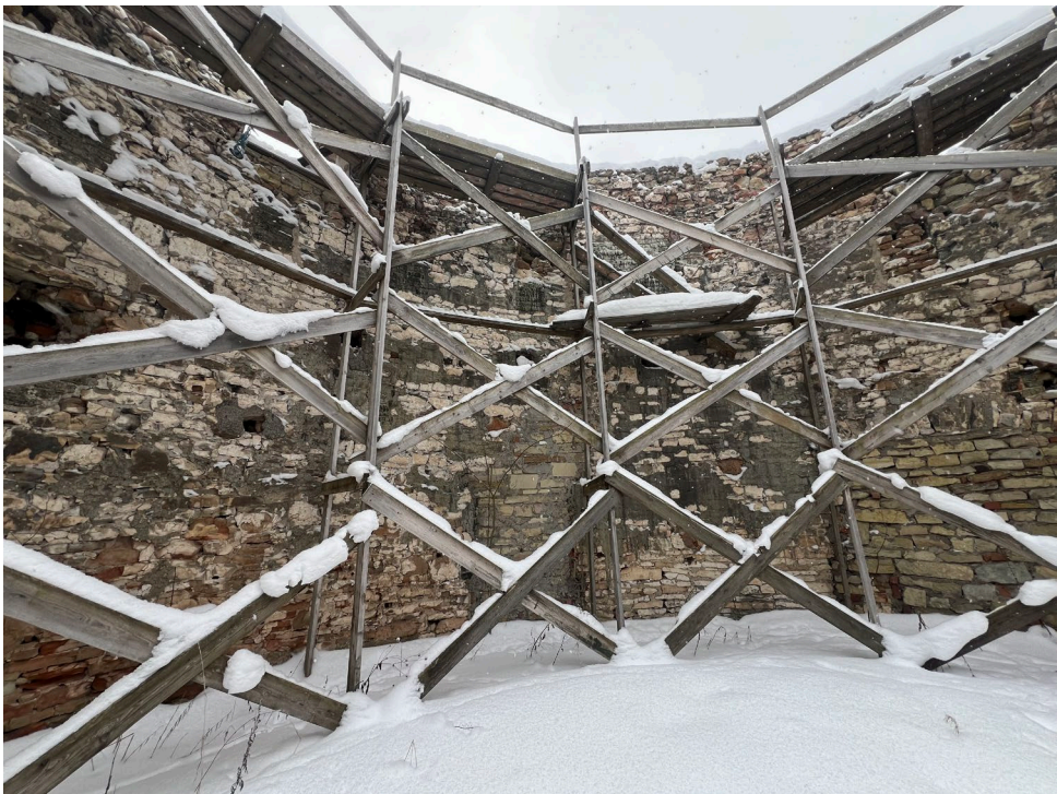
Фото 1.18 Внутреннее кольцо стен, вид изнутри. Дата съёмки: январь 2026г. Автор съёмки: Ведерникова В.В.
