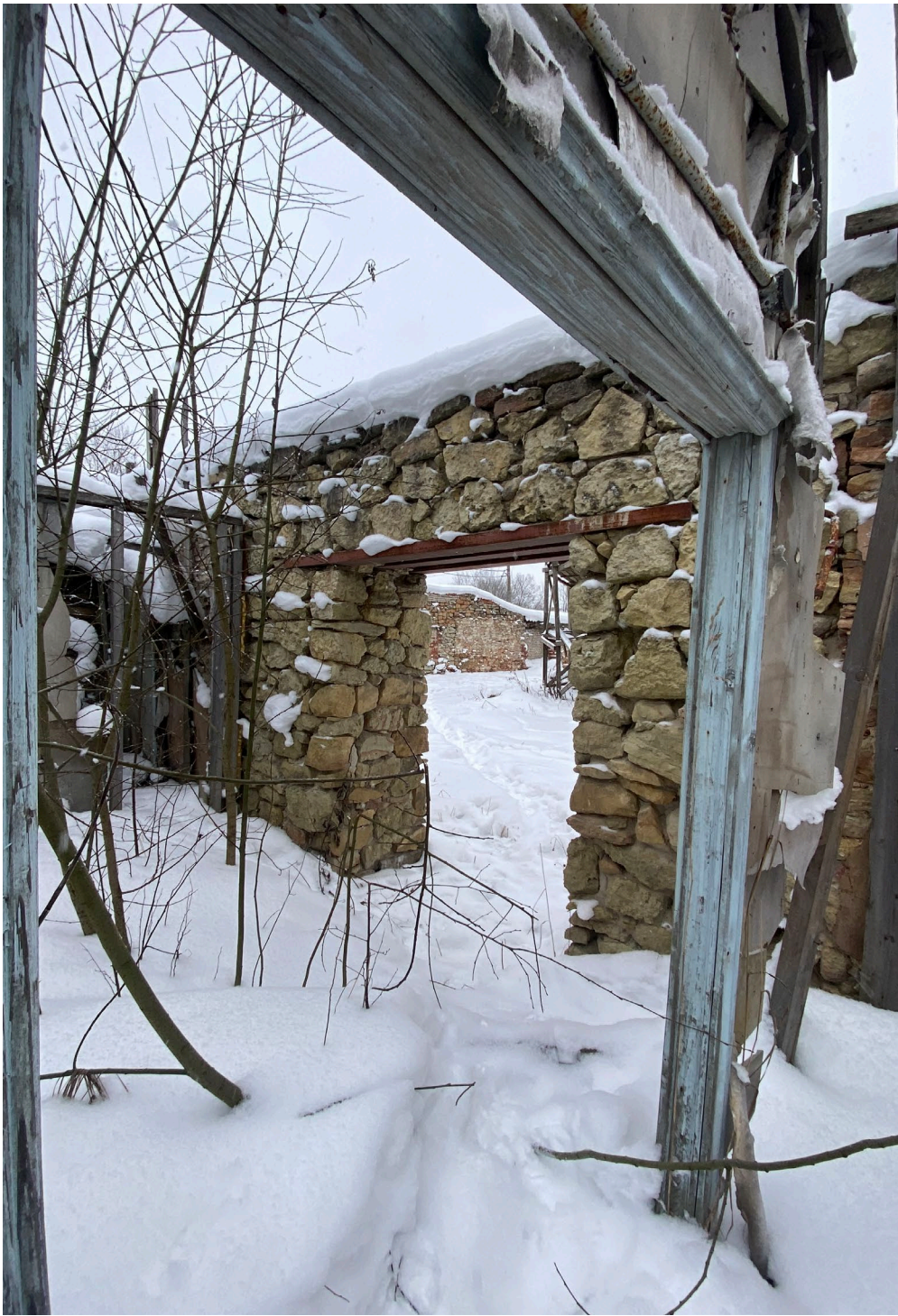
Фото 2.17 Западная пристройка. Дата съёмки: январь 2026г. Автор съёмки: Ведерникова В.В.
