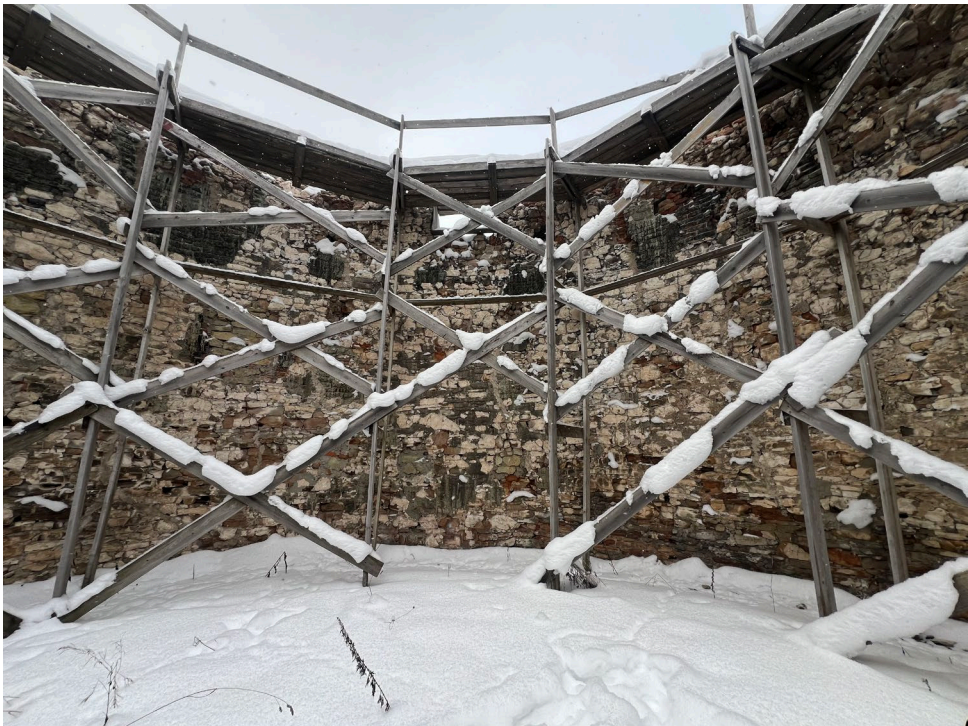
Фото 1.17 Внутреннее кольцо стен, вид изнутри. Дата съёмки: январь 2026г. Автор съёмки: Ведерникова В.В.
