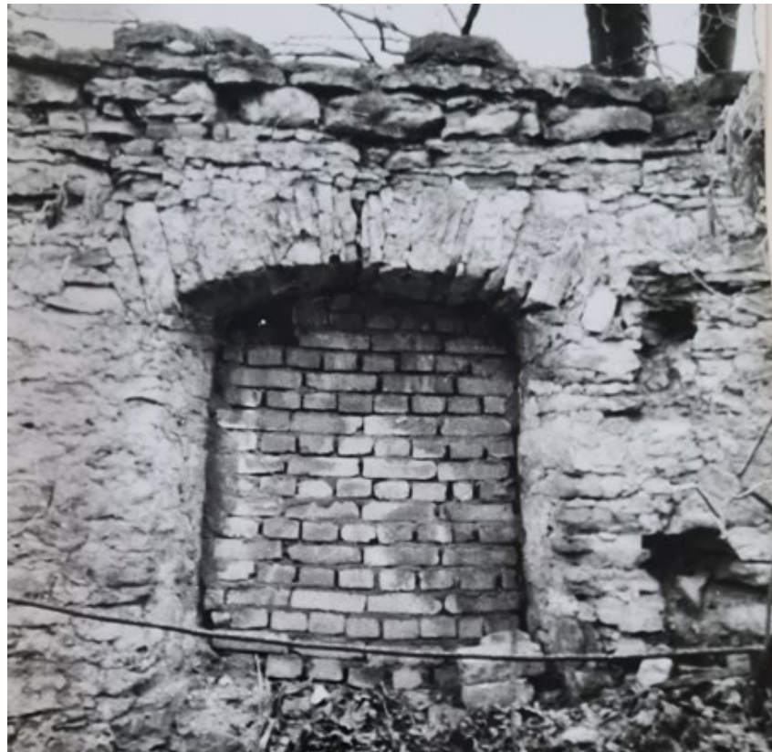
Рис. 80. Круглая рига. Фотофиксация 1988 года. Источник: Архив комитета по сохранению объектов культурного наследия Ленинградской области.
