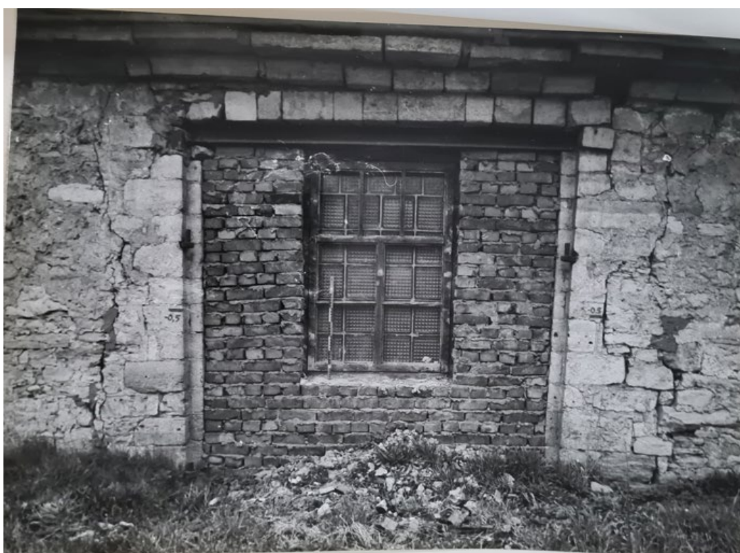
Рис. 70. Круглая рига. Фотофиксация 1988 года. Источник: Архив комитета по сохранению объектов культурного наследия Ленинградской области.
