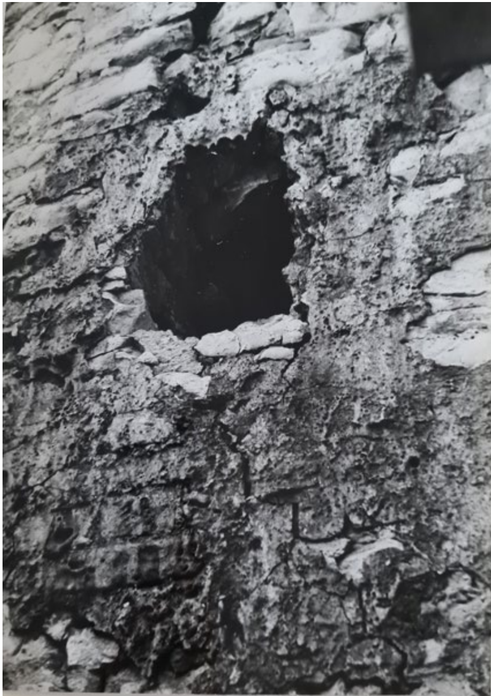
Рис. 95. Круглая рига. Фотофиксация 1988 года. Источник: Архив комитета по сохранению объектов культурного наследия Ленинградской области.
