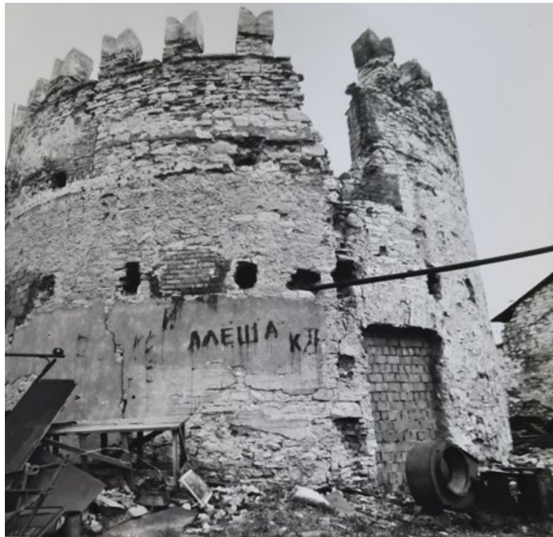
Рис. 88. Круглая рига. Фотофиксация 1988 года. Источник: Архив комитета по сохранению объектов культурного наследия Ленинградской области.
