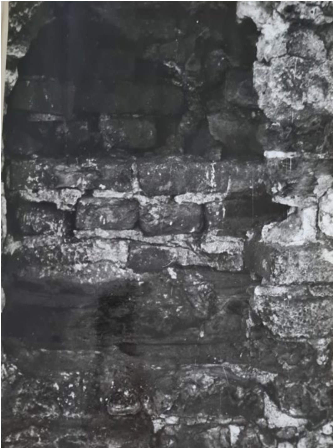
Рис. 96. Круглая рига. Фотофиксация 1988 года. Источник: Архив комитета по сохранению объектов культурного наследия Ленинградской области.
