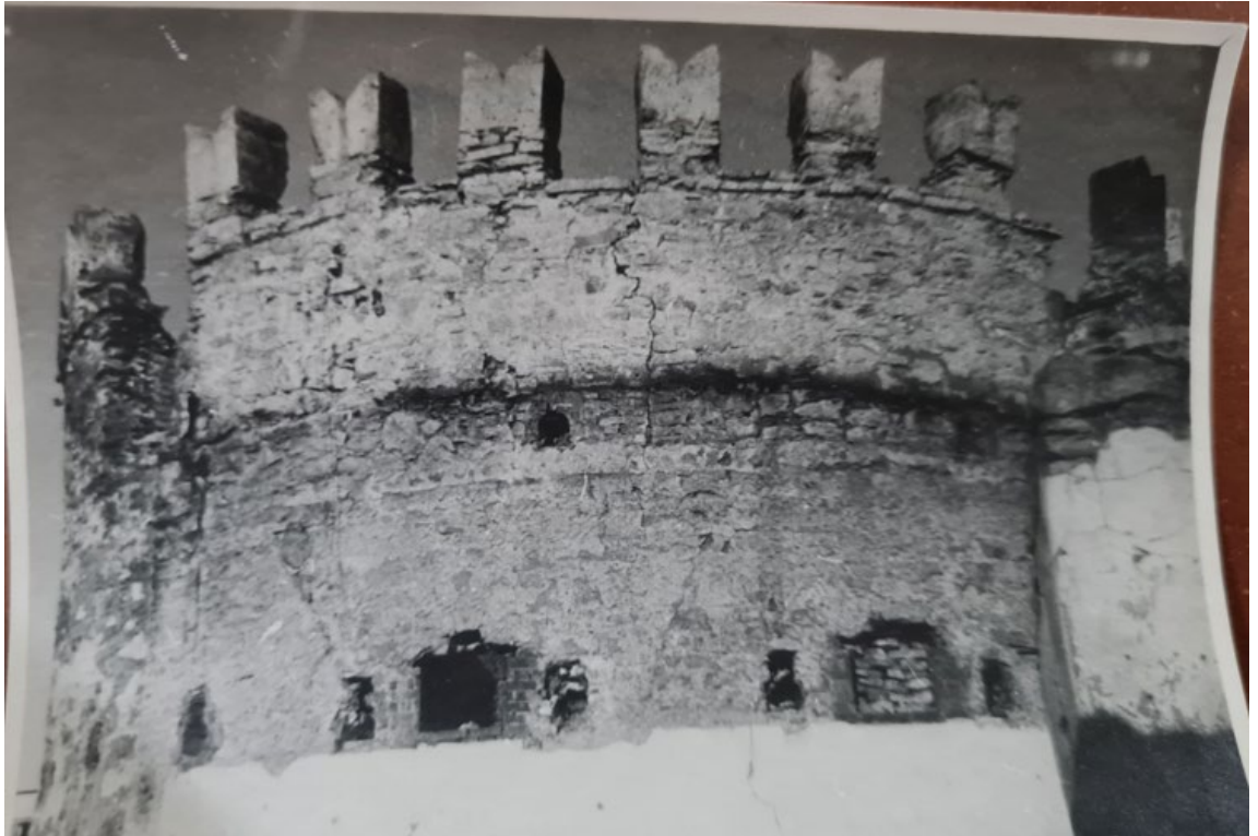
Рис. 46. Круглая рига. Фотофиксация 1948 года. Источник: Архив комитета по сохранению объектов культурного наследия Ленинградской области.
