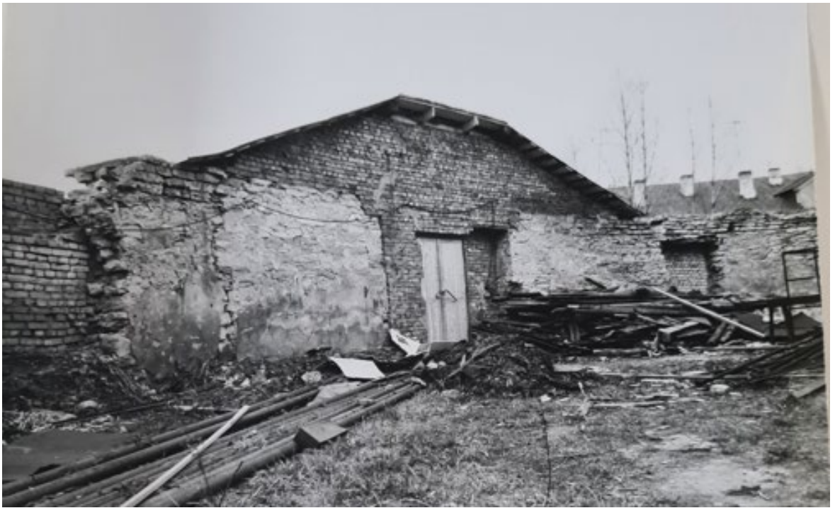
Рис. 81. Круглая рига. Фотофиксация 1988 года. Источник: Архив комитета по сохранению объектов культурного наследия Ленинградской области.
