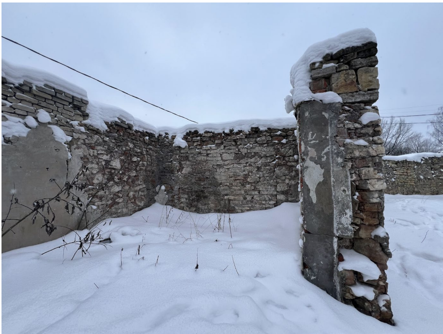
Фото 2.11 Южная пристройка. Торцевая стена Дата съёмки: январь 2026г. Автор съёмки: Ведерникова В.В.
