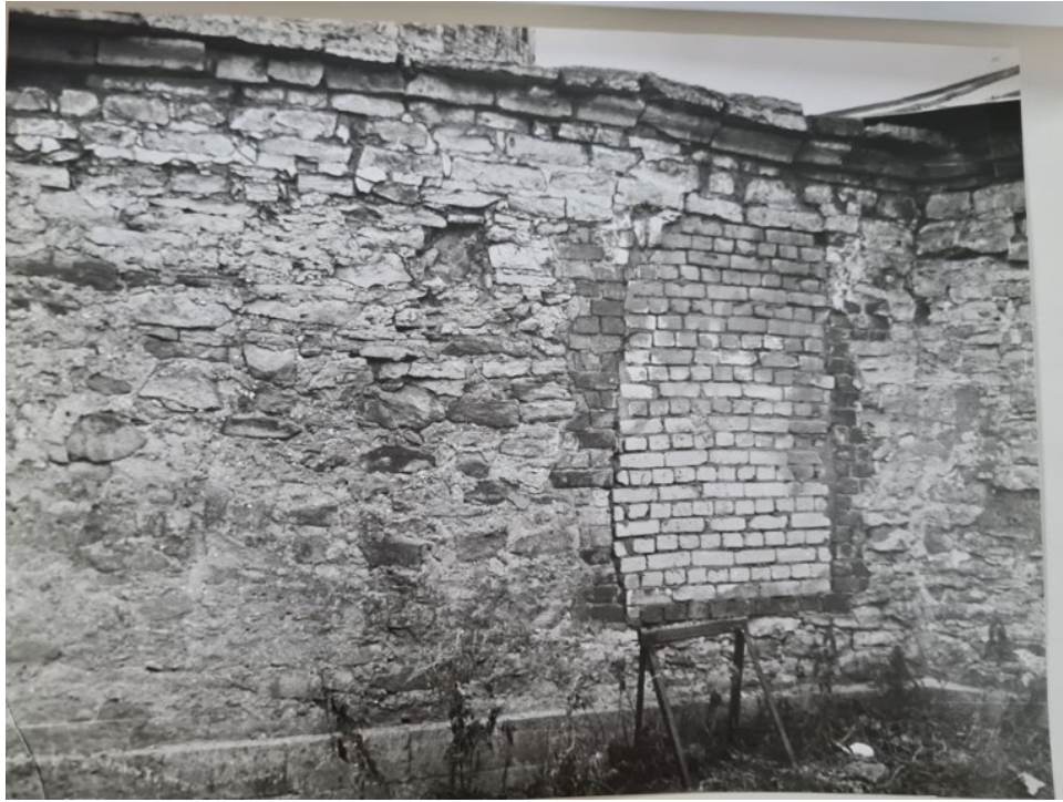
Рис. 77. Круглая рига. Фотофиксация 1988 года. Источник: Архив комитета по сохранению объектов культурного наследия Ленинградской области.
