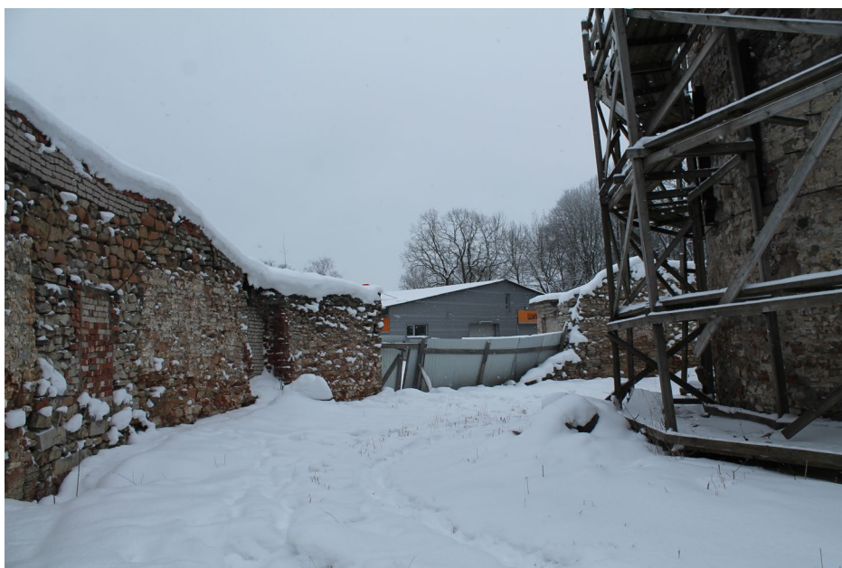
С последних работ по сохранению здания остались деревянные леса и металлические балки, усиливающие кладку стен. Большая часть кладки замазана известковой штукатуркой. В нижней части стены заложен проем. В кладке присутствуют поздние включения из кирпича.
