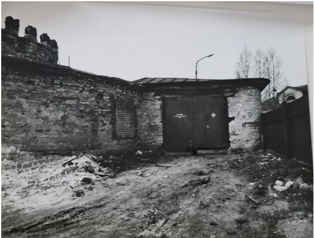
Рис. 73. Круглая рига. Фотофиксация 1988 года. Источник: Архив комитета по сохранению объектов культурного наследия Ленинградской области.
