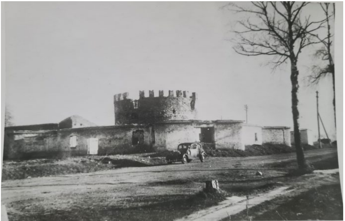
Рис. 48. Круглая рига. Фотофиксация 1948 года. Источник: Архив комитета по сохранению объектов культурного наследия Ленинградской области.
