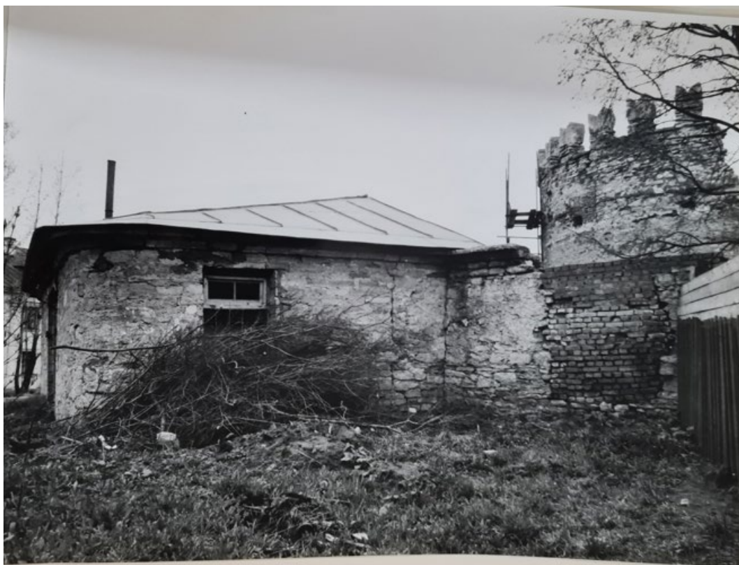
Рис. 69. Круглая рига. Фотофиксация 1988 года. Источник: Архив комитета по сохранению объектов культурного наследия Ленинградской области.
