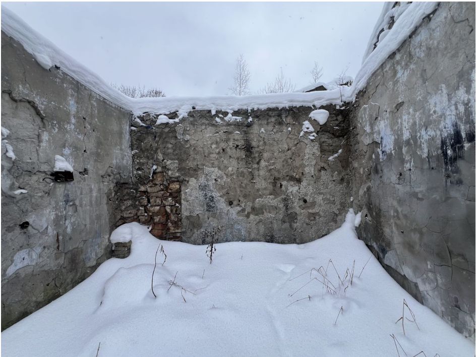
Фото 2.3 Восточная пристройка, вид изнутри. Дата съёмки: январь 2026г. Автор съёмки: Ведерникова В.В.
