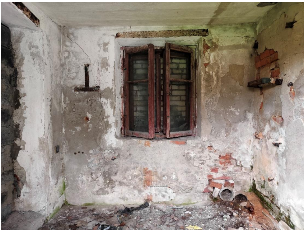
4. «Большая дворцовая оранжерея», 1790-е гг., 1884 г., входящая в состав объекта культурного наследия федерального значения «Ансамбль Гатчинского дворца и парка», Ленинградская область, Гатчинский муниципальный район, Гатчинское городское поселение город Гатчина, Красноармейский пр., д.1, лит. А, Дворцовый парк. Фрагмент. Фото 10.06.2026г.
