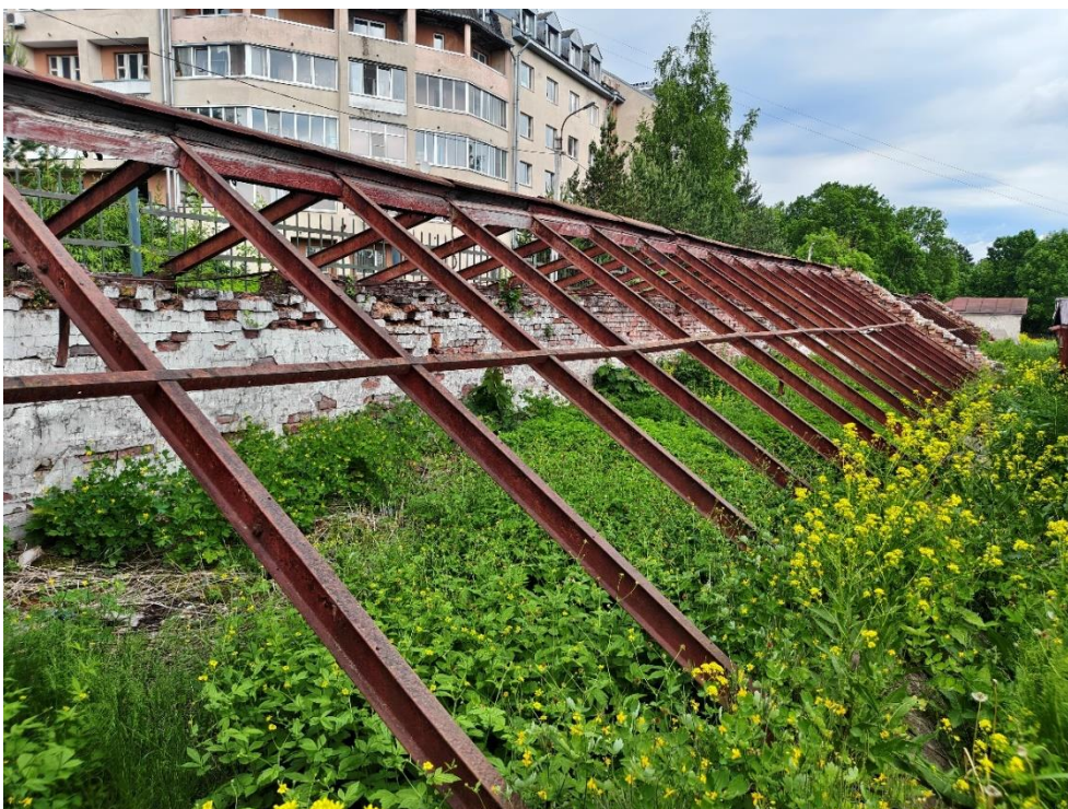
2. «Большая дворцовая оранжерея», 1790-е гг., 1884 г., входящая в состав объекта культурного наследия федерального значения «Ансамбль Гатчинского дворца и парка», Ленинградская область, Гатчинский муниципальный район, Гатчинское городское поселение город Гатчина, Красноармейский пр., д.1, лит. А, Дворцовый парк. Общий вид. Фото 10.06.2026г.
