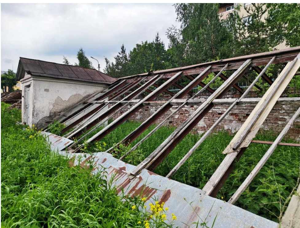
16. «Большая дворцовая оранжерея», 1790-е гг., 1884 г., входящая в состав объекта культурного наследия федерального значения «Ансамбль Гатчинского дворца и парка», Ленинградская область, Гатчинский муниципальный район, Гатчинское городское поселение город Гатчина, Красноармейский пр., д.1, лит. А, Дворцовый парк. Общий вид. Фото 10.06.2026г.
