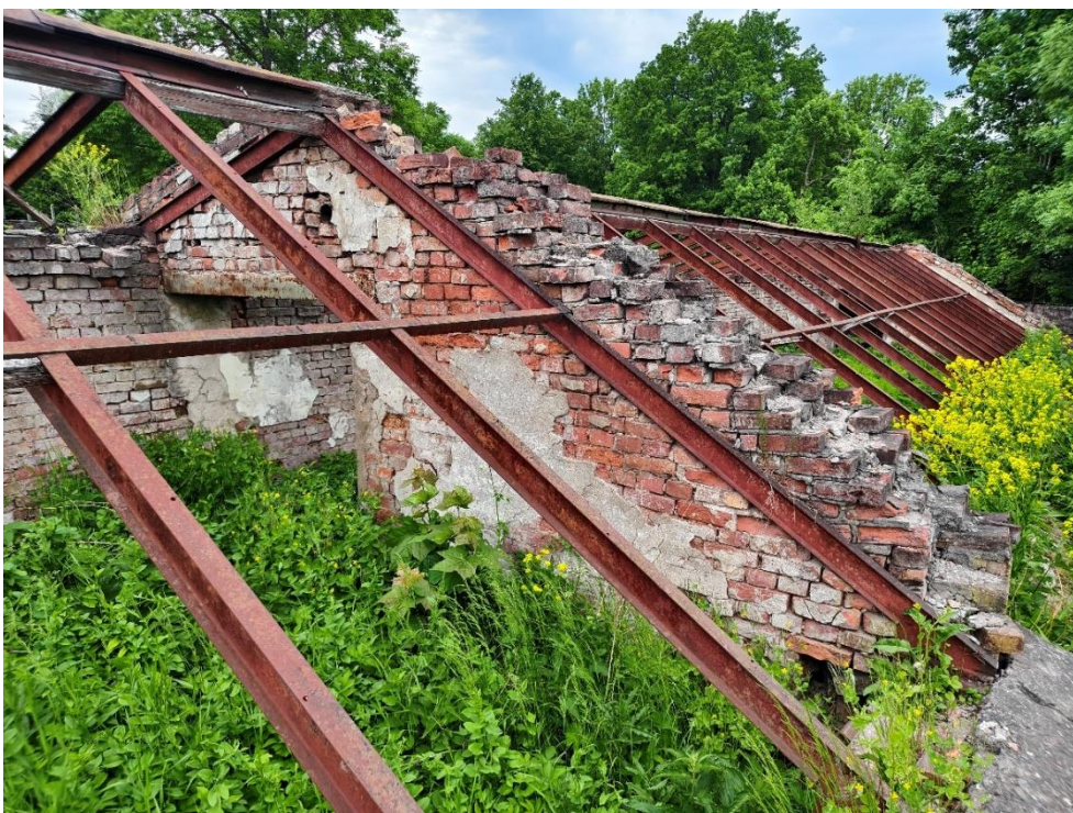
18. «Большая дворцовая оранжерея», 1790-е гг., 1884 г., входящая в состав объекта культурного наследия федерального значения «Ансамбль Гатчинского дворца и парка», Ленинградская область, Гатчинский муниципальный район, Гатчинское городское поселение город Гатчина, Красноармейский пр., д.1, лит. А, Дворцовый парк. Общий вид. Фото 10.06.2026г.
