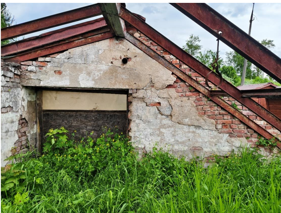
10. «Большая дворцовая оранжерея», 1790-е гг., 1884 г., входящая в состав объекта культурного наследия федерального значения «Ансамбль Гатчинского дворца и парка», Ленинградская область, Гатчинский муниципальный район, Гатчинское городское поселение город Гатчина, Красноармейский пр., д.1, лит. А, Дворцовый парк. Общий вид. Фото 10.06.2026г.
