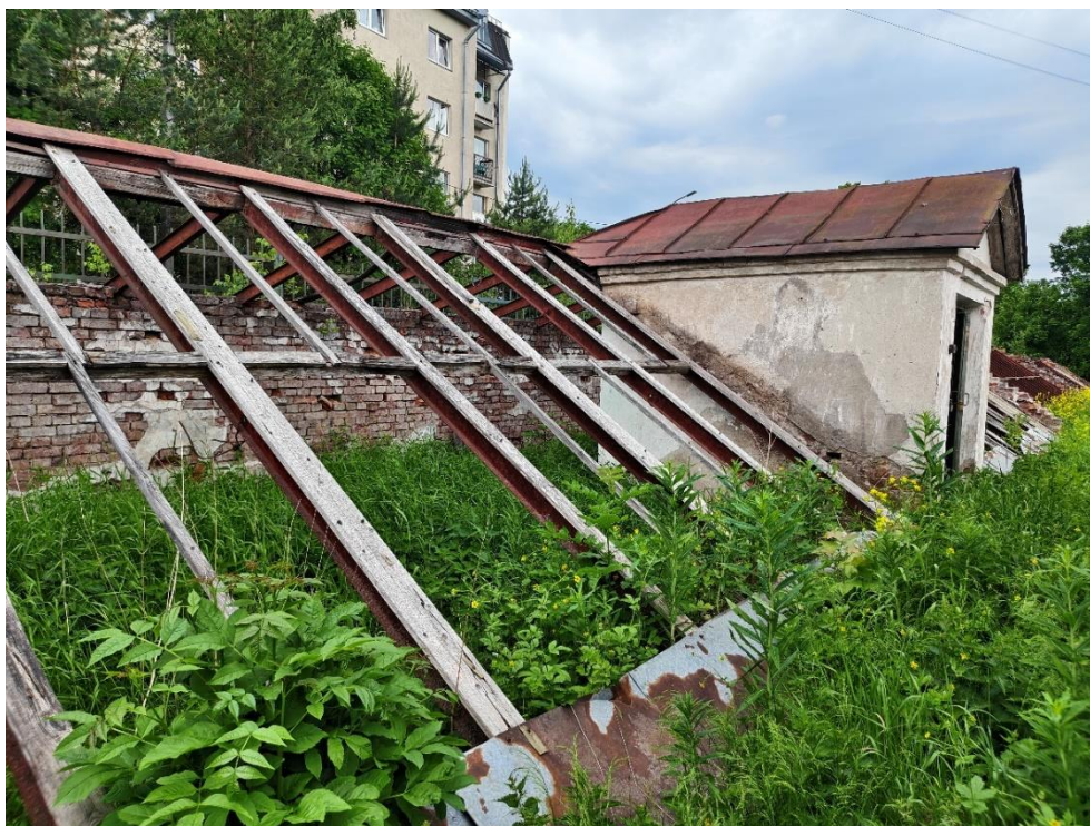
13. «Большая дворцовая оранжерея», 1790-е гг., 1884 г., входящая в состав объекта культурного наследия федерального значения «Ансамбль Гатчинского дворца и парка», Ленинградская область, Гатчинский муниципальный район, Гатчинское городское поселение город Гатчина, Красноармейский пр., д.1, лит. А, Дворцовый парк. Общий вид. Фото 10.06.2026г.
