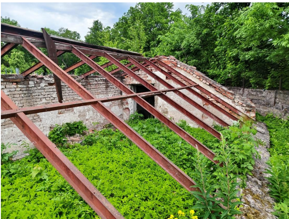
20. «Большая дворцовая оранжерея», 1790-е гг., 1884 г., входящая в состав объекта культурного наследия федерального значения «Ансамбль Гатчинского дворца и парка», Ленинградская область, Гатчинский муниципальный район, Гатчинское городское поселение город Гатчина, Красноармейский пр., д.1, лит. А, Дворцовый парк. Общий вид. Фото 10.06.2026г.
