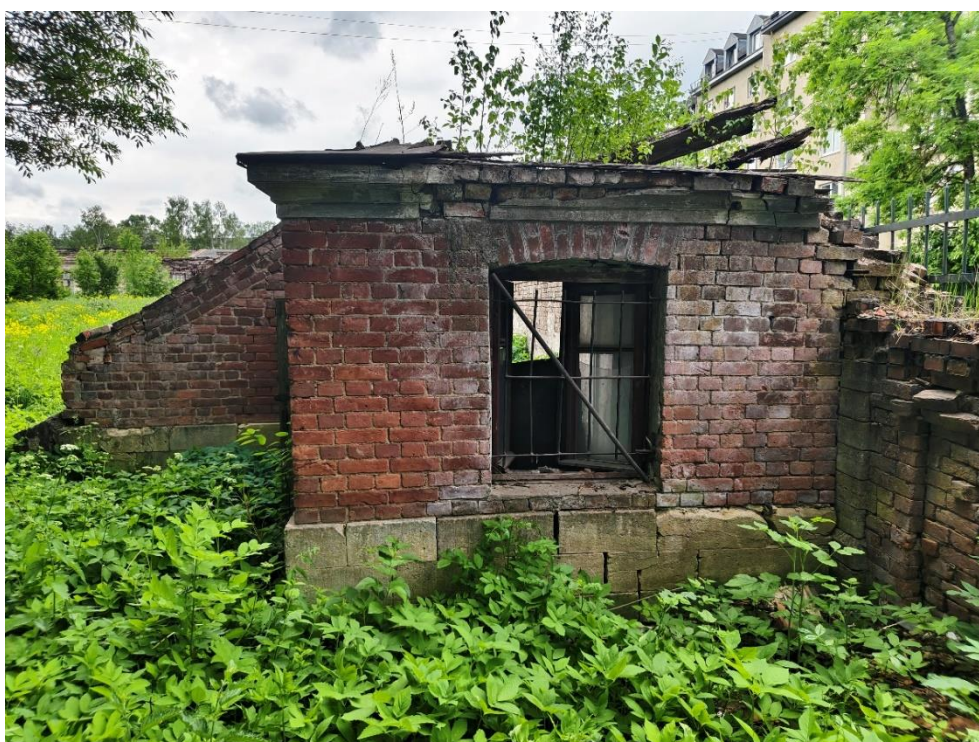
22. «Большая дворцовая оранжерея», 1790-е гг., 1884 г., входящая в состав объекта культурного наследия федерального значения «Ансамбль Гатчинского дворца и парка», Ленинградская область, Гатчинский муниципальный район, Гатчинское городское поселение город Гатчина, Красноармейский пр., д.1, лит. А, Дворцовый парк. Фрагмент. Фото 10.06.2026г.
