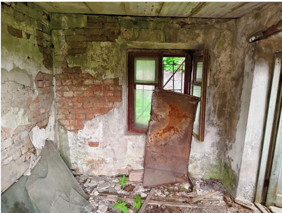
24. «Большая дворцовая оранжерея», 1790-е гг., 1884 г., входящая в состав объекта культурного наследия федерального значения «Ансамбль Гатчинского дворца и парка», Ленинградская область, Гатчинский муниципальный район, Гатчинское городское поселение город Гатчина, Красноармейский пр., д.1, лит. А, Дворцовый парк. Фрагмент. Фото 10.06.2026г.
