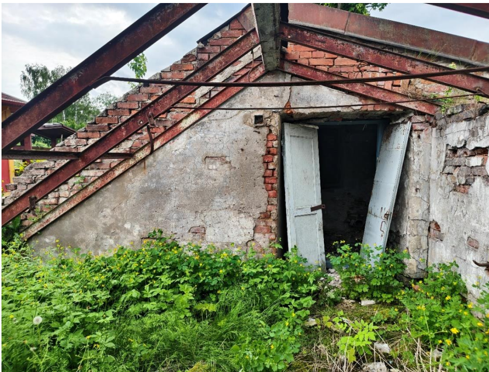
3. «Большая дворцовая оранжерея», 1790-е гг., 1884 г., входящая в состав объекта культурного наследия федерального значения «Ансамбль Гатчинского дворца и парка», Ленинградская область, Гатчинский муниципальный район, Гатчинское городское поселение город Гатчина, Красноармейский пр., д.1, лит. А, Дворцовый парк. Фрагмент. Фото 10.06.2026г.
