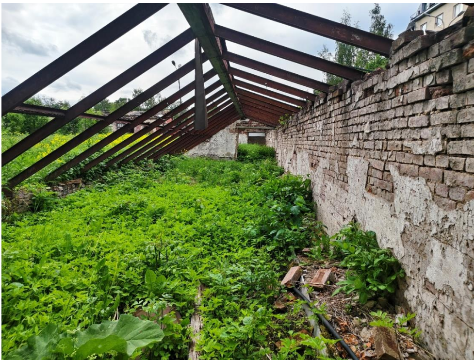
25. «Большая дворцовая оранжерея», 1790-е гг., 1884 г., входящая в состав объекта культурного наследия федерального значения «Ансамбль Гатчинского дворца и парка», Ленинградская область, Гатчинский муниципальный район, Гатчинское городское поселение город Гатчина, Красноармейский пр., д.1, лит. А, Дворцовый парк. Общий вид. Фото 10.06.2026г.
