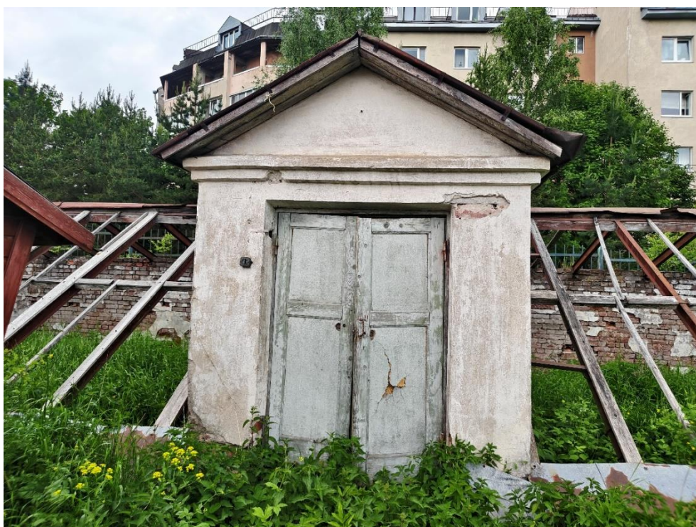
14. «Большая дворцовая оранжерея», 1790-е гг., 1884 г., входящая в состав объекта культурного наследия федерального значения «Ансамбль Гатчинского дворца и парка», Ленинградская область, Гатчинский муниципальный район, Гатчинское городское поселение город Гатчина, Красноармейский пр., д.1, лит. А, Дворцовый парк. Фрагмент. Фото 10.06.2026г.
