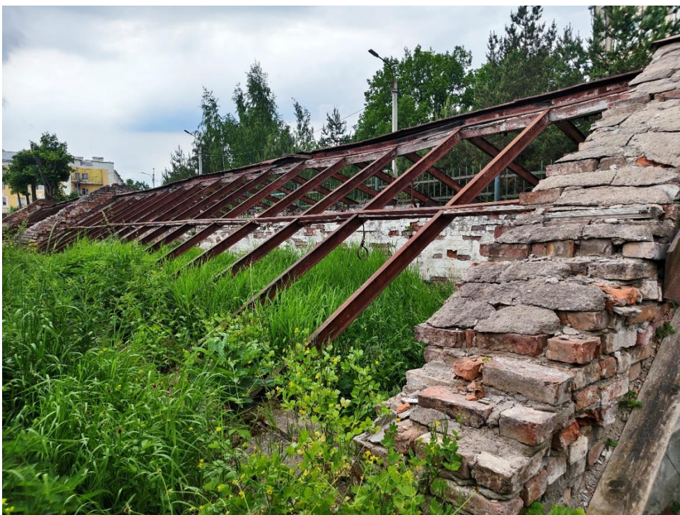
12. «Большая дворцовая оранжерея», 1790-е гг., 1884 г., входящая в состав объекта культурного наследия федерального значения «Ансамбль Гатчинского дворца и парка», Ленинградская область, Гатчинский муниципальный район, Гатчинское городское поселение город Гатчина, Красноармейский пр., д.1, лит. А, Дворцовый парк. Общий вид. Фото 10.06.2026г.
