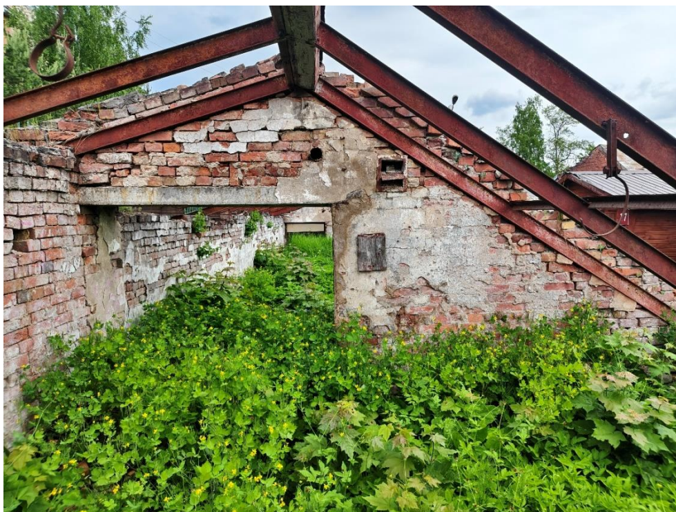
7. «Большая дворцовая оранжерея», 1790-е гг., 1884 г., входящая в состав объекта культурного наследия федерального значения «Ансамбль Гатчинского дворца и парка», Ленинградская область, Гатчинский муниципальный район, Гатчинское городское поселение город Гатчина, Красноармейский пр., д.1, лит. А, Дворцовый парк. Общий вид. Фото 10.06.2026г.
