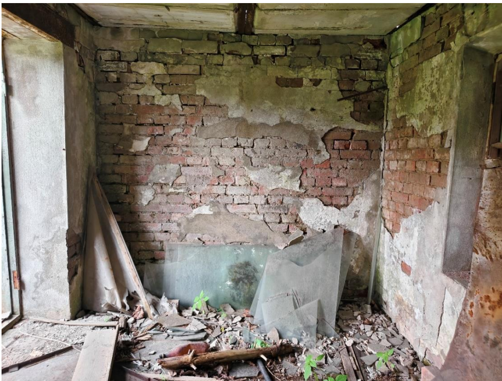
23. «Большая дворцовая оранжерея», 1790-е гг., 1884 г., входящая в состав объекта культурного наследия федерального значения «Ансамбль Гатчинского дворца и парка», Ленинградская область, Гатчинский муниципальный район, Гатчинское городское поселение город Гатчина, Красноармейский пр., д.1, лит. А, Дворцовый парк. Фрагмент. Фото 10.06.2026г.
