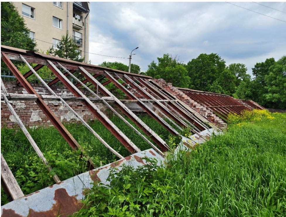
15. «Большая дворцовая оранжерея», 1790-е гг., 1884 г., входящая в состав объекта культурного наследия федерального значения «Ансамбль Гатчинского дворца и парка», Ленинградская область, Гатчинский муниципальный район, Гатчинское городское поселение город Гатчина, Красноармейский пр., д.1, лит. А, Дворцовый парк. Общий вид. Фото 10.06.2026г.
