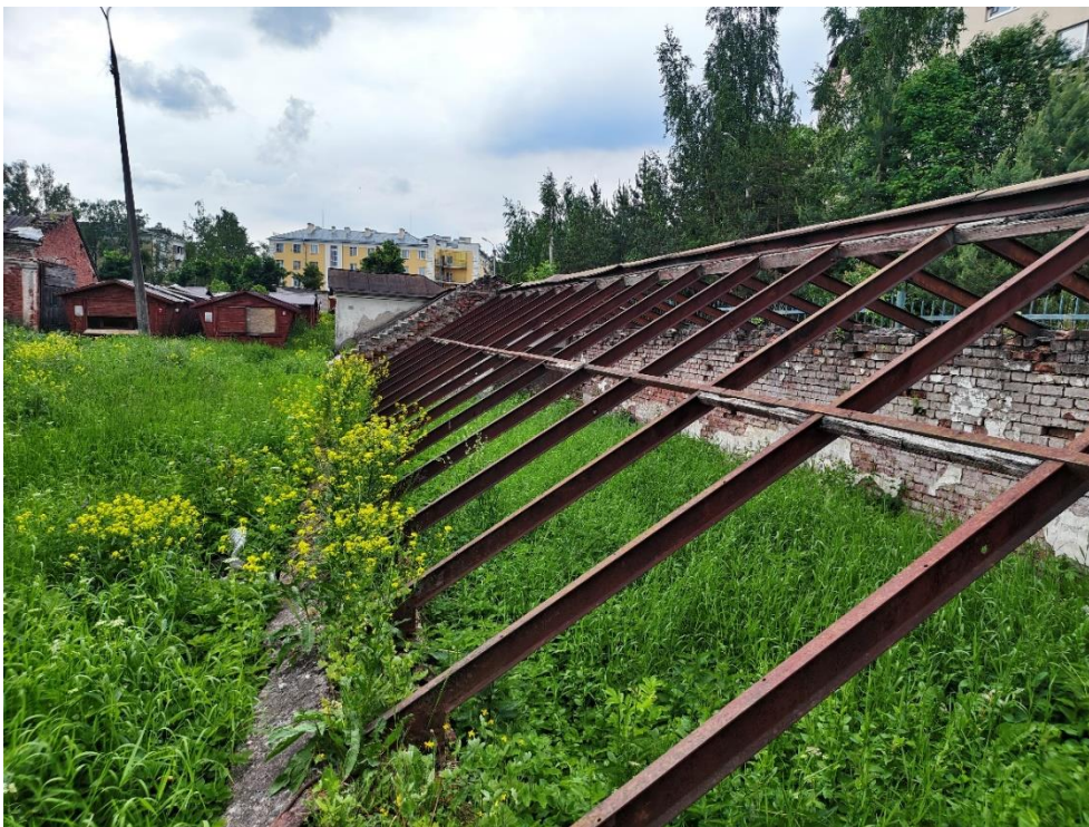
19. «Большая дворцовая оранжерея», 1790-е гг., 1884 г., входящая в состав объекта культурного наследия федерального значения «Ансамбль Гатчинского дворца и парка», Ленинградская область, Гатчинский муниципальный район, Гатчинское городское поселение город Гатчина, Красноармейский пр., д.1, лит. А, Дворцовый парк. Общий вид. Фото 10.06.2026г.
