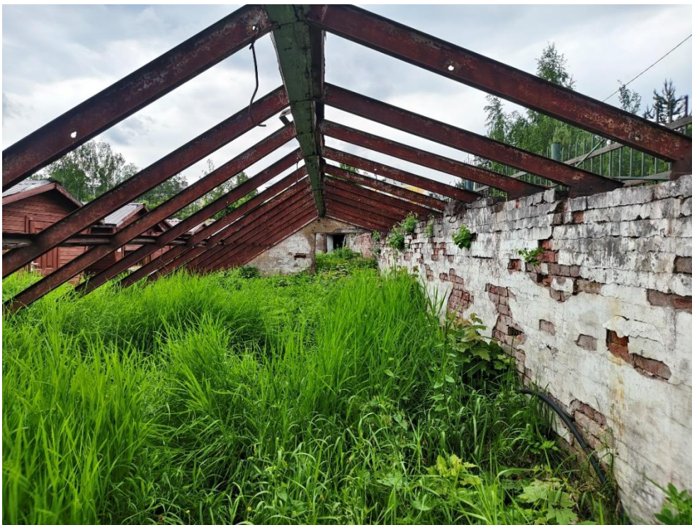
11. «Большая дворцовая оранжерея», 1790-е гг., 1884 г., входящая в состав объекта культурного наследия федерального значения «Ансамбль Гатчинского дворца и парка», Ленинградская область, Гатчинский муниципальный район, Гатчинское городское поселение город Гатчина, Красноармейский пр., д.1, лит. А, Дворцовый парк. Общий вид. Фото 10.06.2026г.
