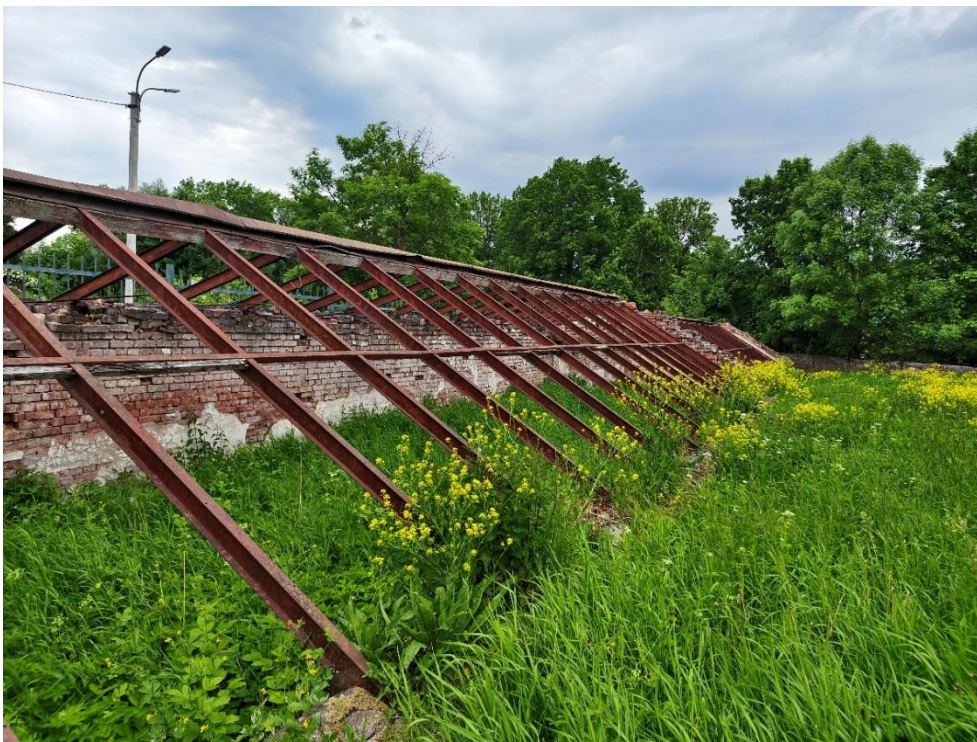
17. «Большая дворцовая оранжерея», 1790-е гг., 1884 г., входящая в состав объекта культурного наследия федерального значения «Ансамбль Гатчинского дворца и парка», Ленинградская область, Гатчинский муниципальный район, Гатчинское городское поселение город Гатчина, Красноармейский пр., д.1, лит. А, Дворцовый парк. Общий вид. Фото 10.06.2026г.
