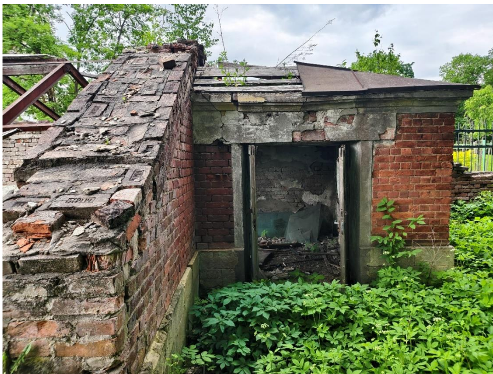
21. «Большая дворцовая оранжерея», 1790-е гг., 1884 г., входящая в состав объекта культурного наследия федерального значения «Ансамбль Гатчинского дворца и парка», Ленинградская область, Гатчинский муниципальный район, Гатчинское городское поселение город Гатчина, Красноармейский пр., д.1, лит. А, Дворцовый парк. Фрагмент. Фото 10.06.2026г.
