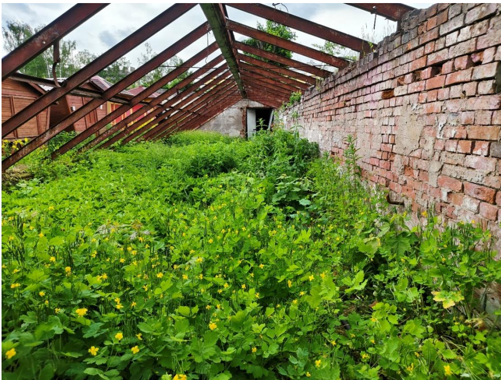
9. «Большая дворцовая оранжерея», 1790-е гг., 1884 г., входящая в состав объекта культурного наследия федерального значения «Ансамбль Гатчинского дворца и парка», Ленинградская область, Гатчинский муниципальный район, Гатчинское городское поселение город Гатчина, Красноармейский пр., д.1, лит. А, Дворцовый парк. Общий вид. Фото 10.06.2026г.
