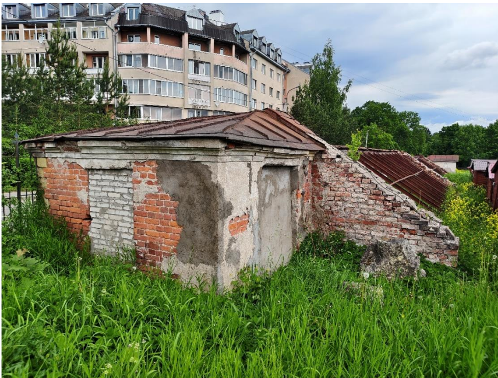
1. «Большая дворцовая оранжерея», 1790-е гг., 1884 г., входящая в состав объекта культурного наследия федерального значения «Ансамбль Гатчинского дворца и парка», Ленинградская область, Гатчинский муниципальный район, Гатчинское городское поселение город Гатчина, Красноармейский пр., д.1, лит. А, Дворцовый парк. Общий вид с юга. Фото 10.06.2026г.
