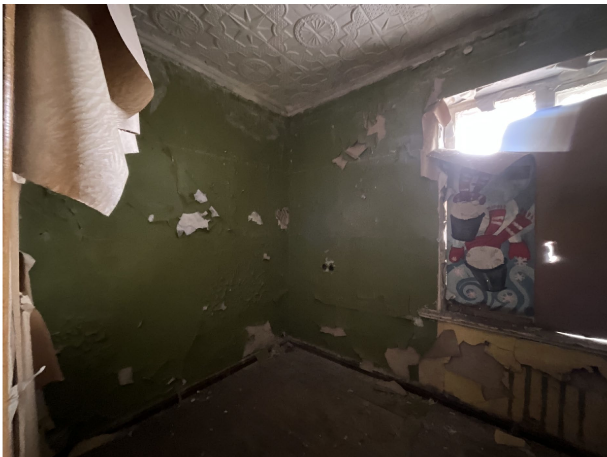
Фото №25. От 27 марта 2025 г. Помещение №2.15
