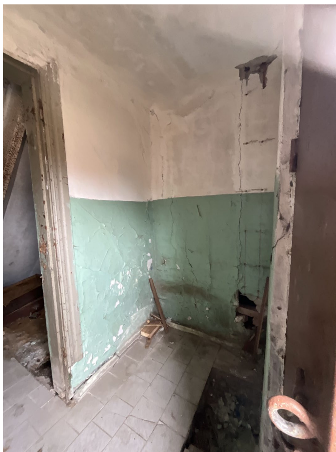
Фото №6. От 27 марта 2025 г. Помещение №1.1
