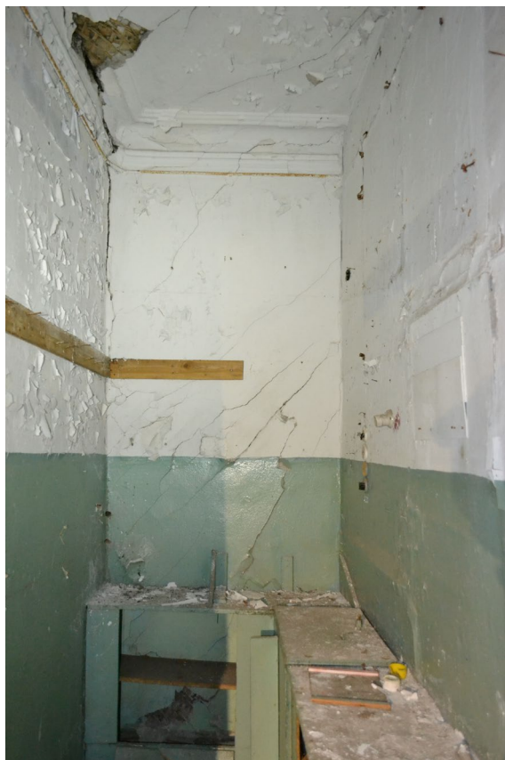
Фото №29. От 27 марта 2025 г. Помещение №2.18
