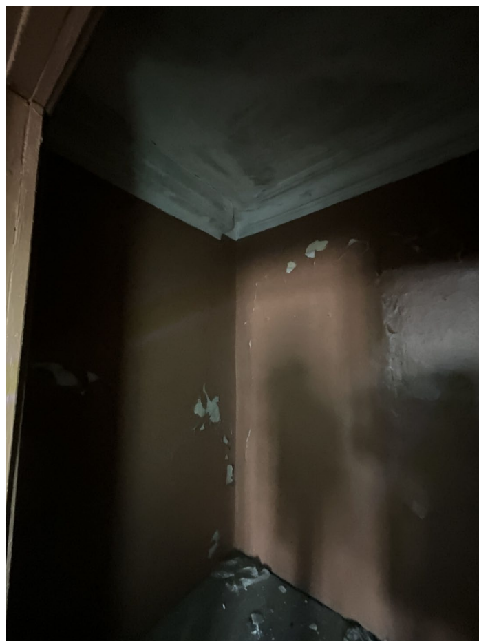
Фото №6. От 27 марта 2025 г. Помещение №2.3
