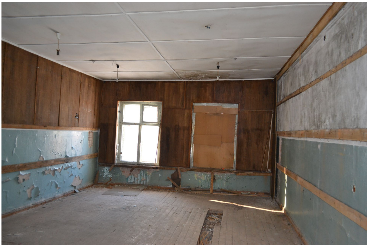
Фото №27. От 27 марта 2025 г. Помещение №2.17
