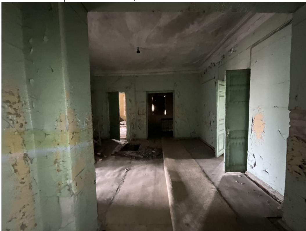
Фото №10. От 27 марта 2025 г. Помещение №2.7
