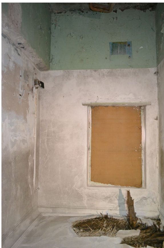
Фото №30. От 27 марта 2025 г. Помещение №2.13
