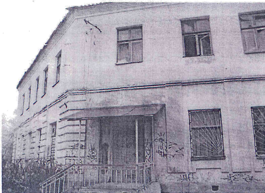
Главный (скошенный) фасад. Вид с востока. Фрагмент восточного фасада у юго-восточного угла, современный главный вход в здание. 2008г.
