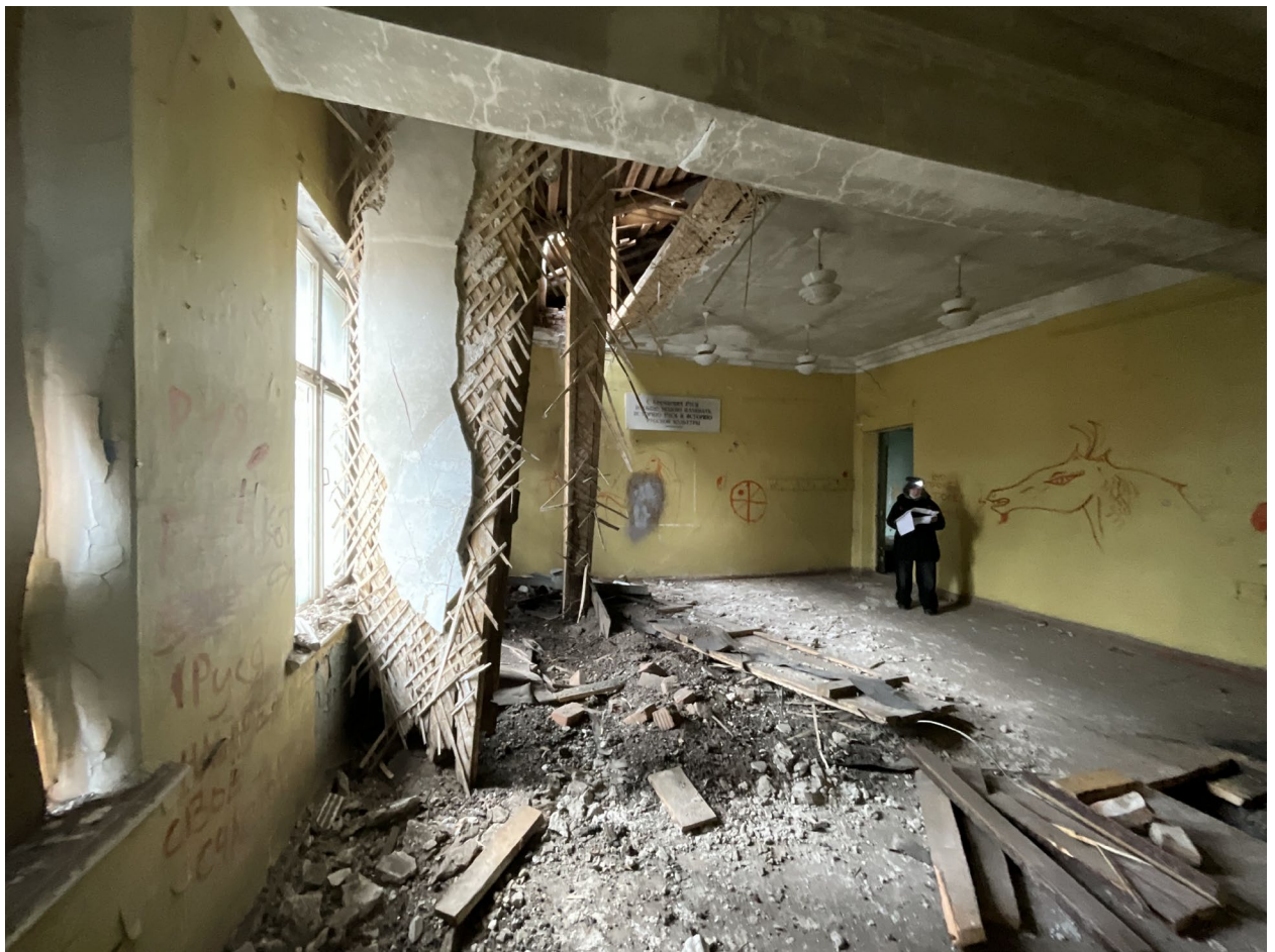
Фото №20. От 27 марта 2025 г. Помещение №2.6
