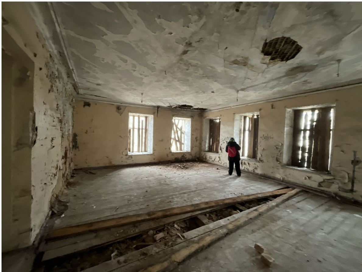
Фото №13. От 27 марта 2025 г. Помещение №2.3
