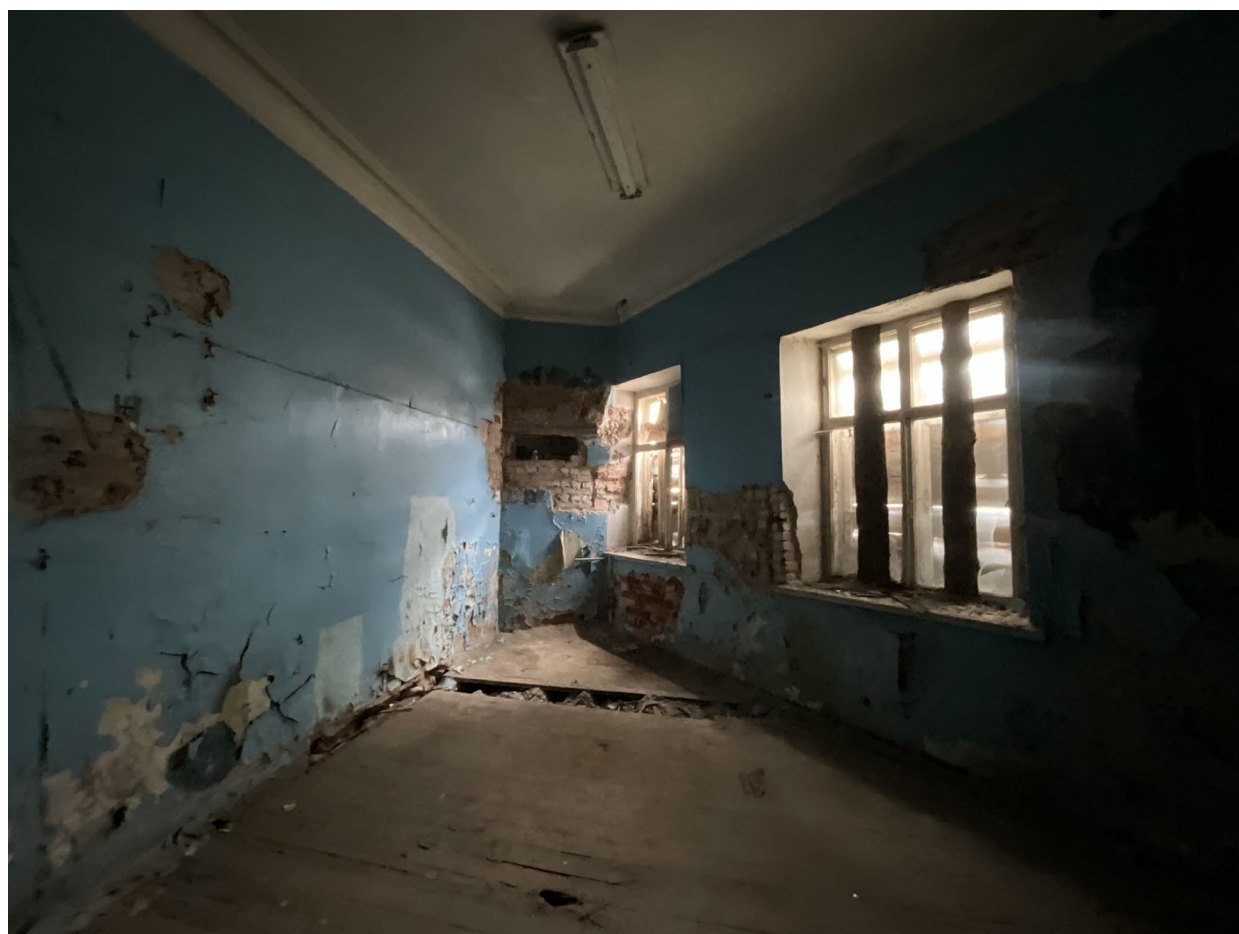
Фото №16. От 27 марта 2025 г. Помещение №1.7
