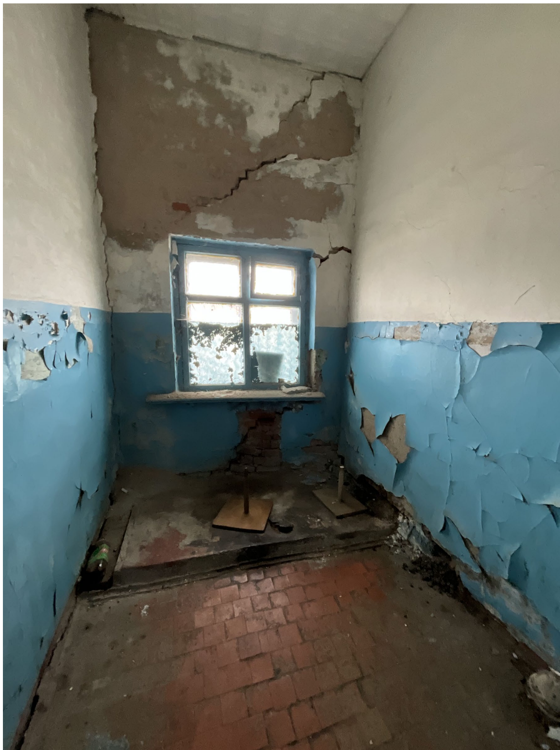
Фото №25. От 27 марта 2025 г. Помещение №1.12
