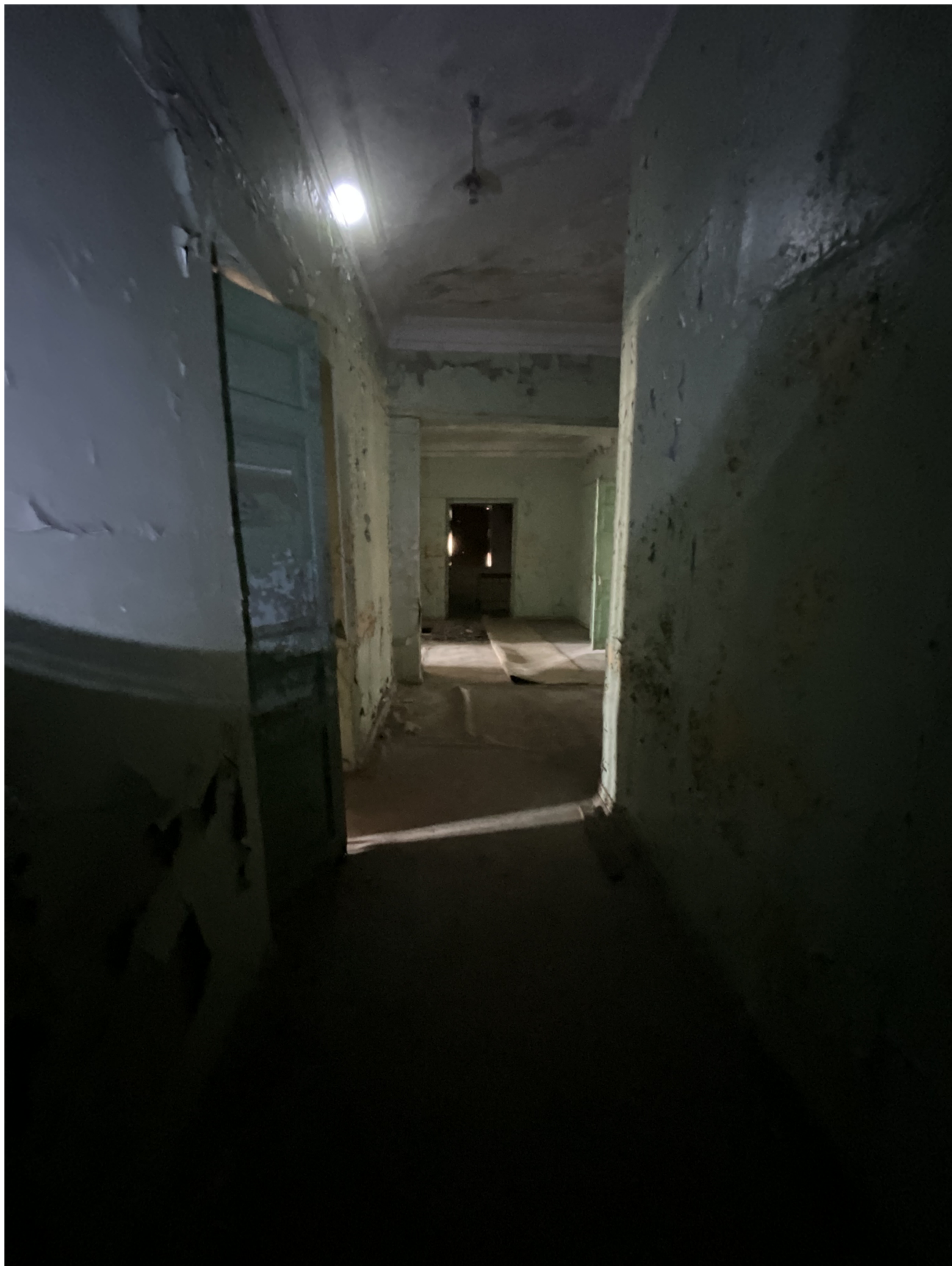
Фото №2. От 27 марта 2025 г. Помещение №2.1
