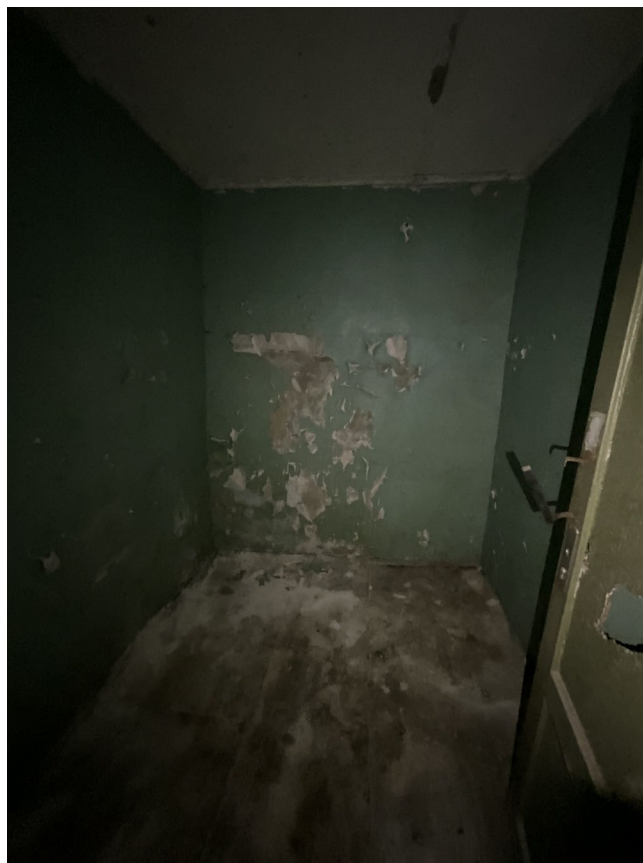
Фото №15. От 27 марта 2025 г. Помещение №1.12
