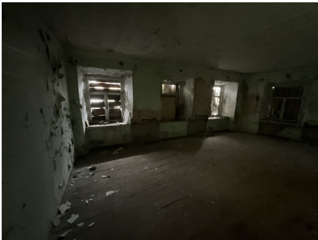
Фото №10. От 27 марта 2025 г. Помещение №1.7
