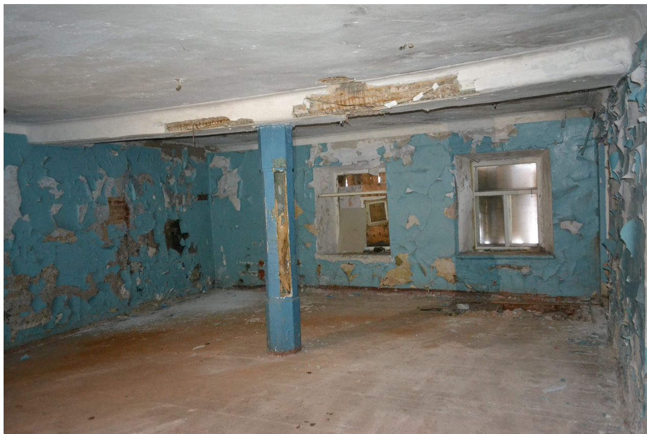
Фото №20. От 27 марта 2025 г. Помещение №1.3
