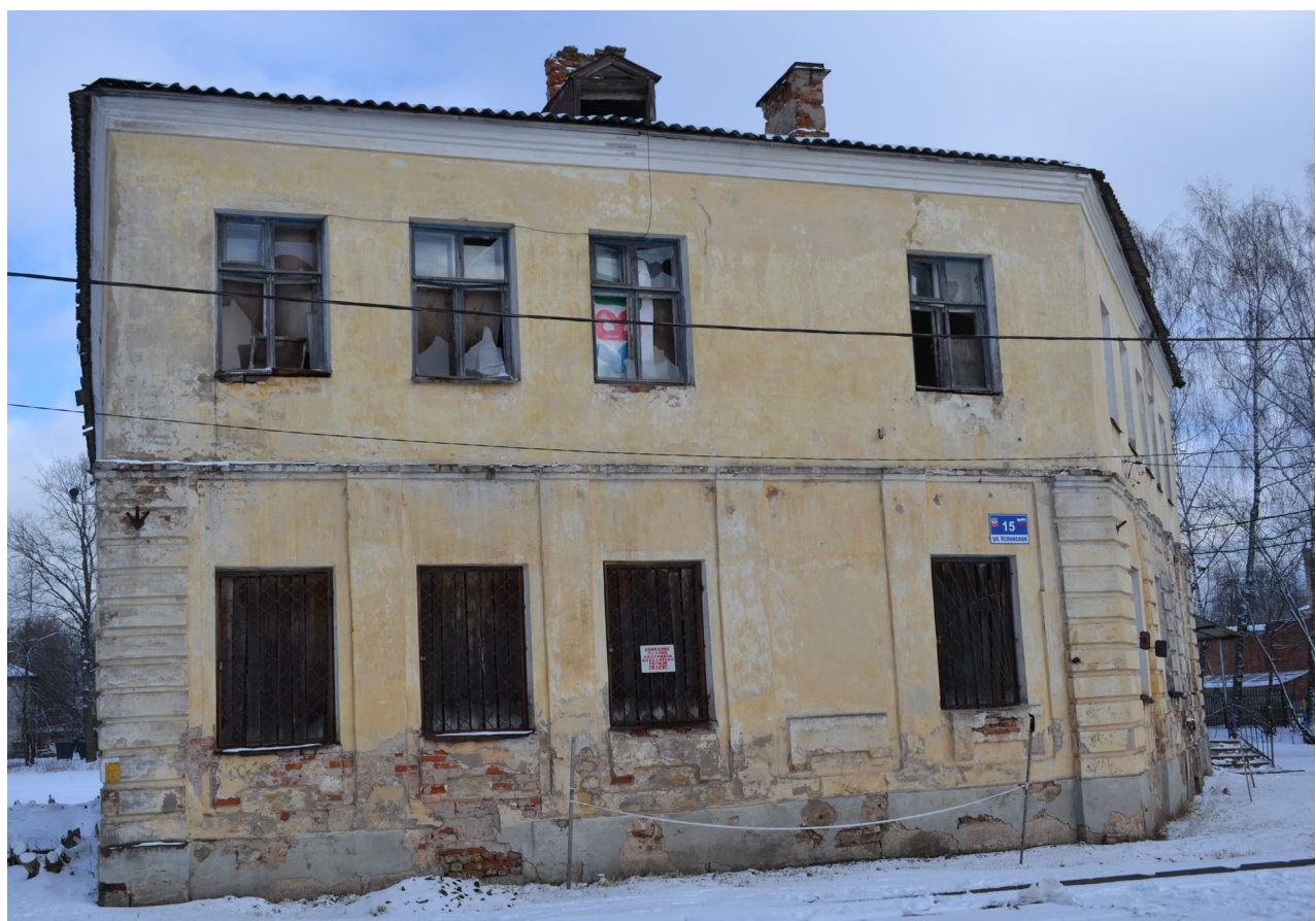
Фото №2. От 27 марта 2025 г. Фасад
