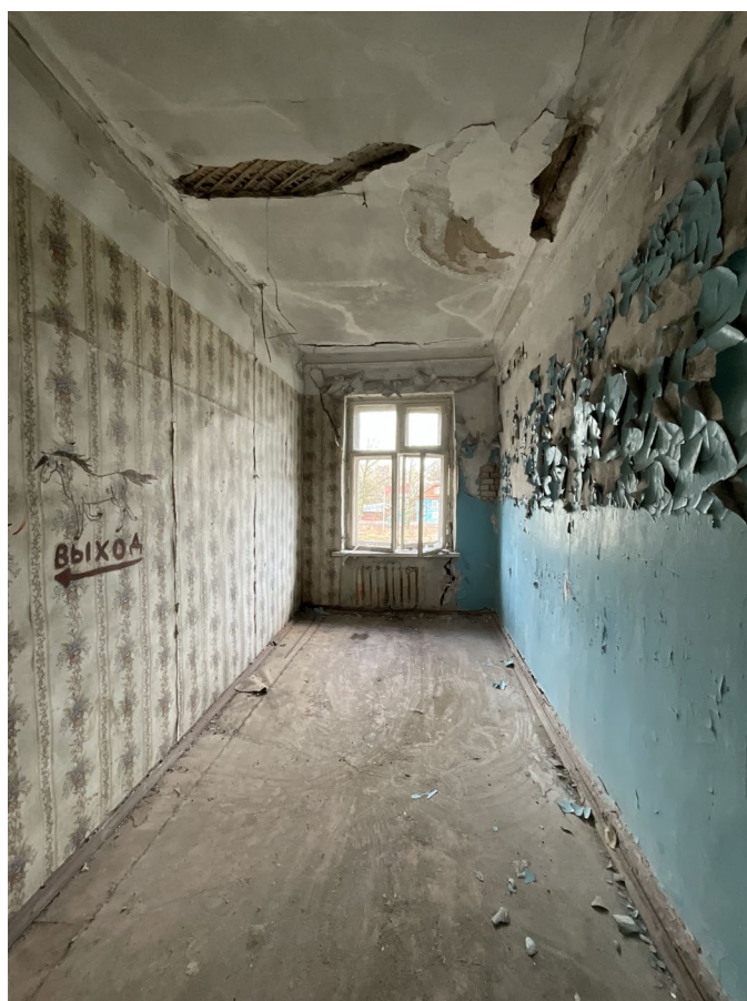
Фото №8. От 27 марта 2025 г. Помещение №2.5
