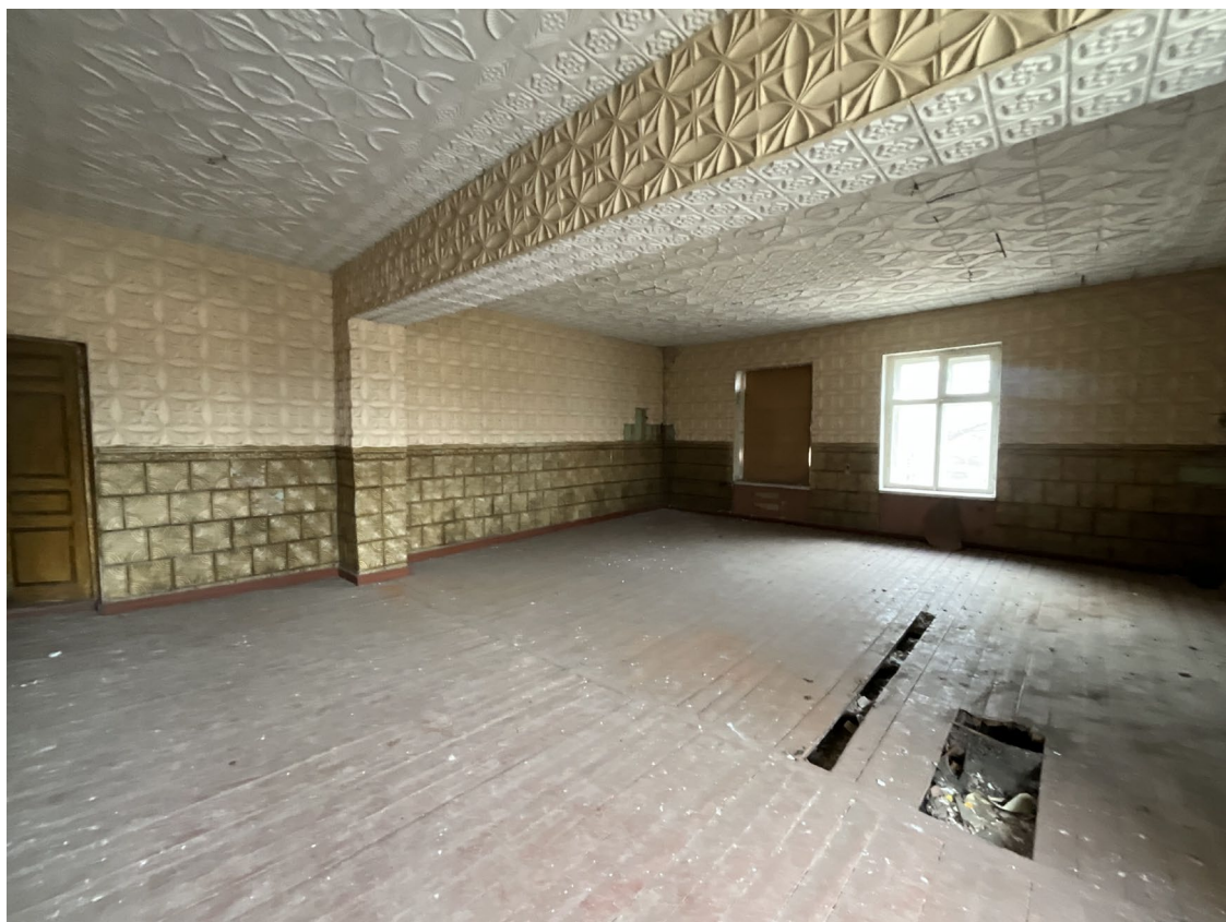
Фото №5. От 27 марта 2025 г. Помещение №2.2
