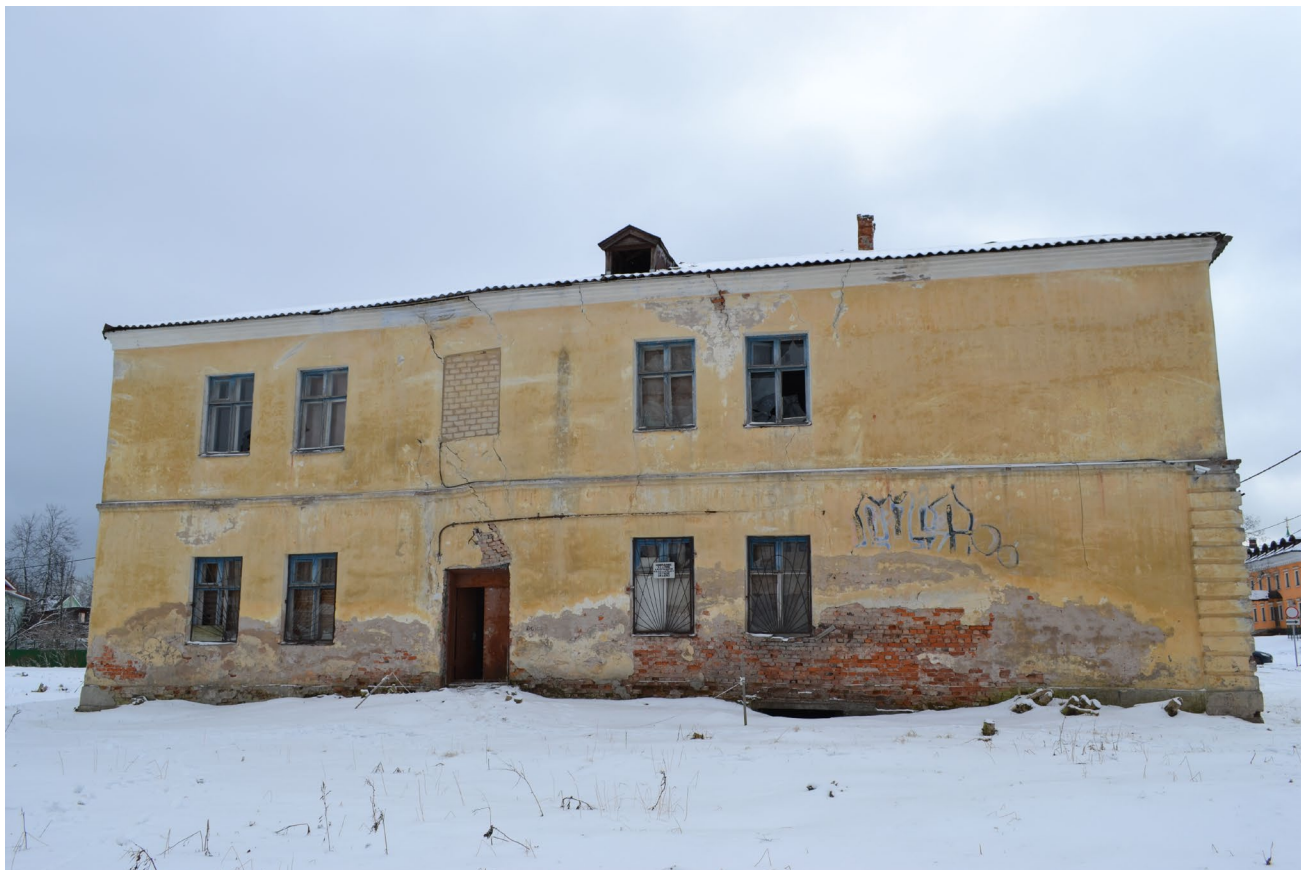
Фото №5. От 27 марта 2025 г. Фасад
