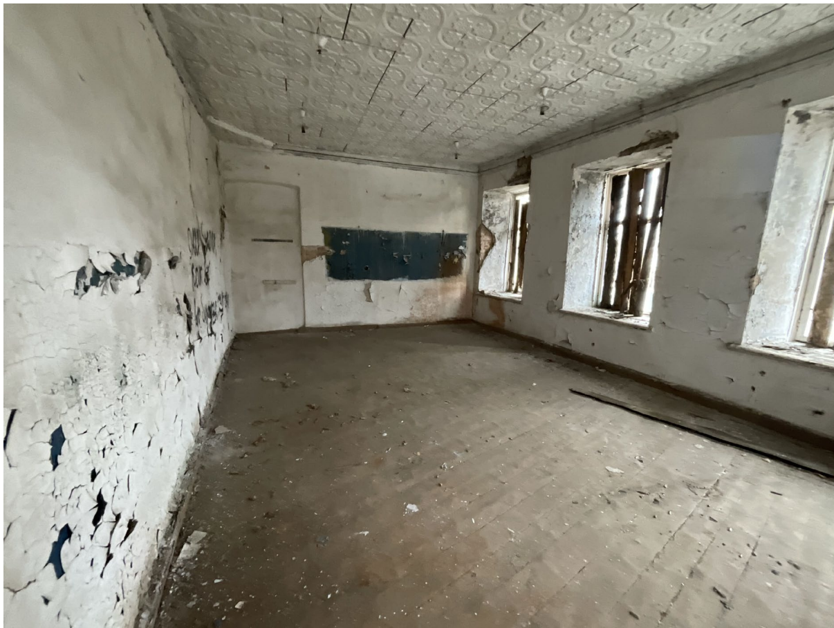
Фото №11. От 27 марта 2025 г. Помещение №2.6
