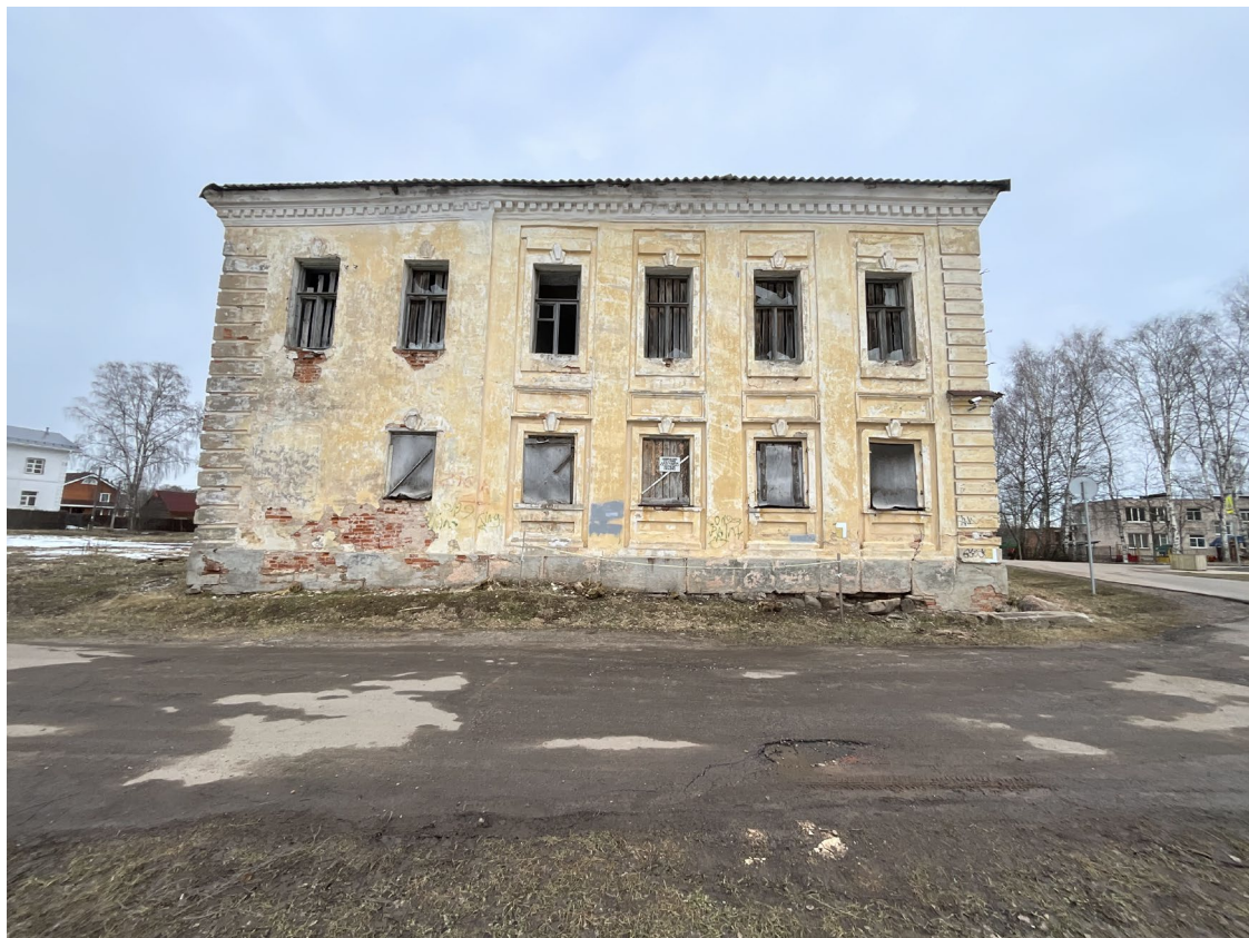
Фото №5. От 27 марта 2025 г. Фасад
