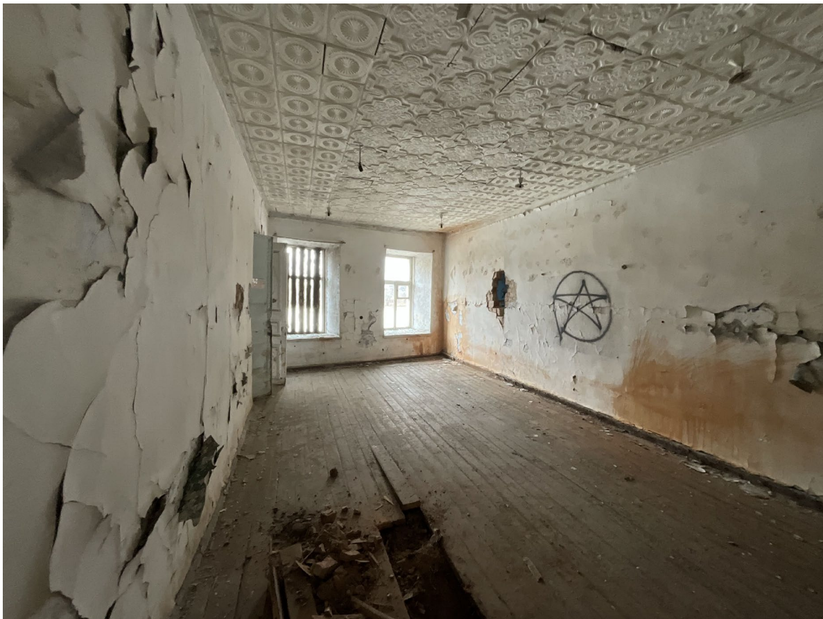
Фото №9. От 27 марта 2025 г. Помещение №2.7
