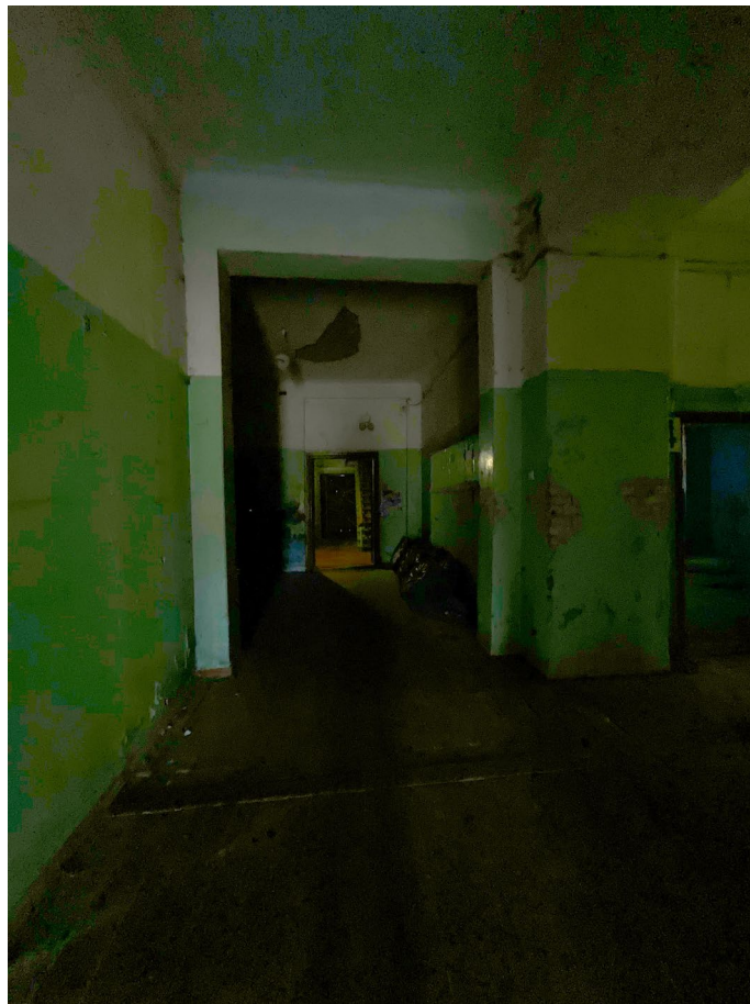
Фото №12. От 27 марта 2025 г. Помещение №1.2
