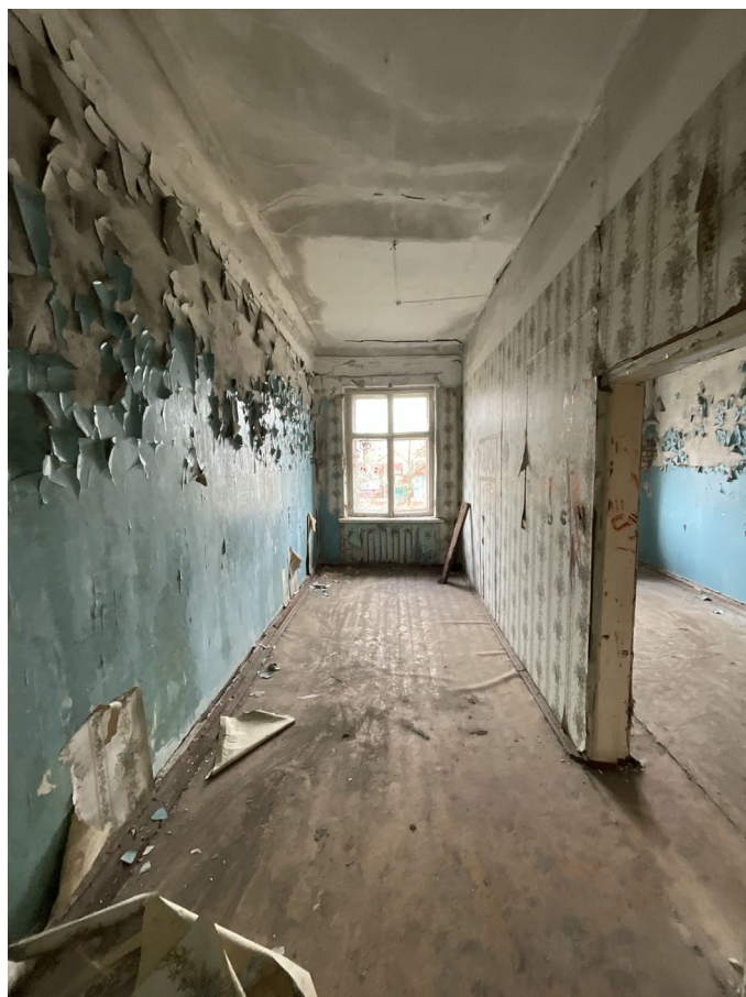
Фото №7. От 27 марта 2025 г. Помещение №2.4
