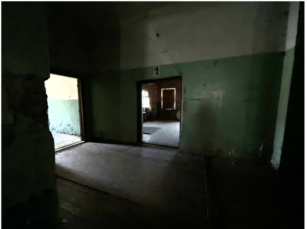
Фото №11. От 27 марта 2025 г. Помещение №1.2
