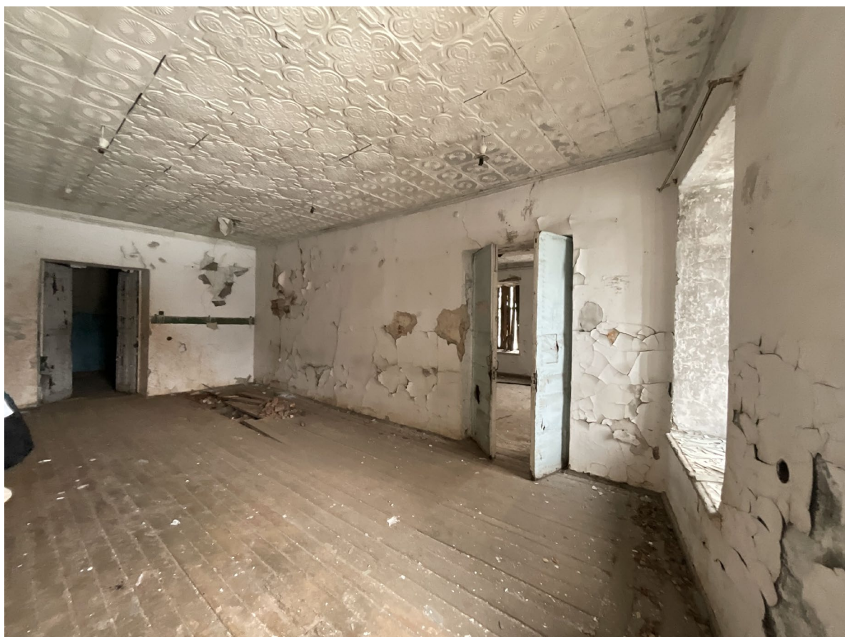
Фото №10. От 27 марта 2025 г. Помещение №2.7
