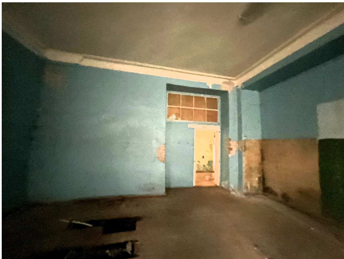
Фото №15. От 27 марта 2025 г. Помещение №1.7
