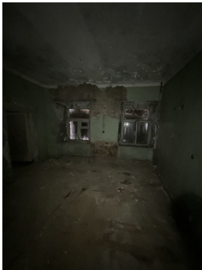
Фото №8. От 27 марта 2025 г. Помещение №1.5
