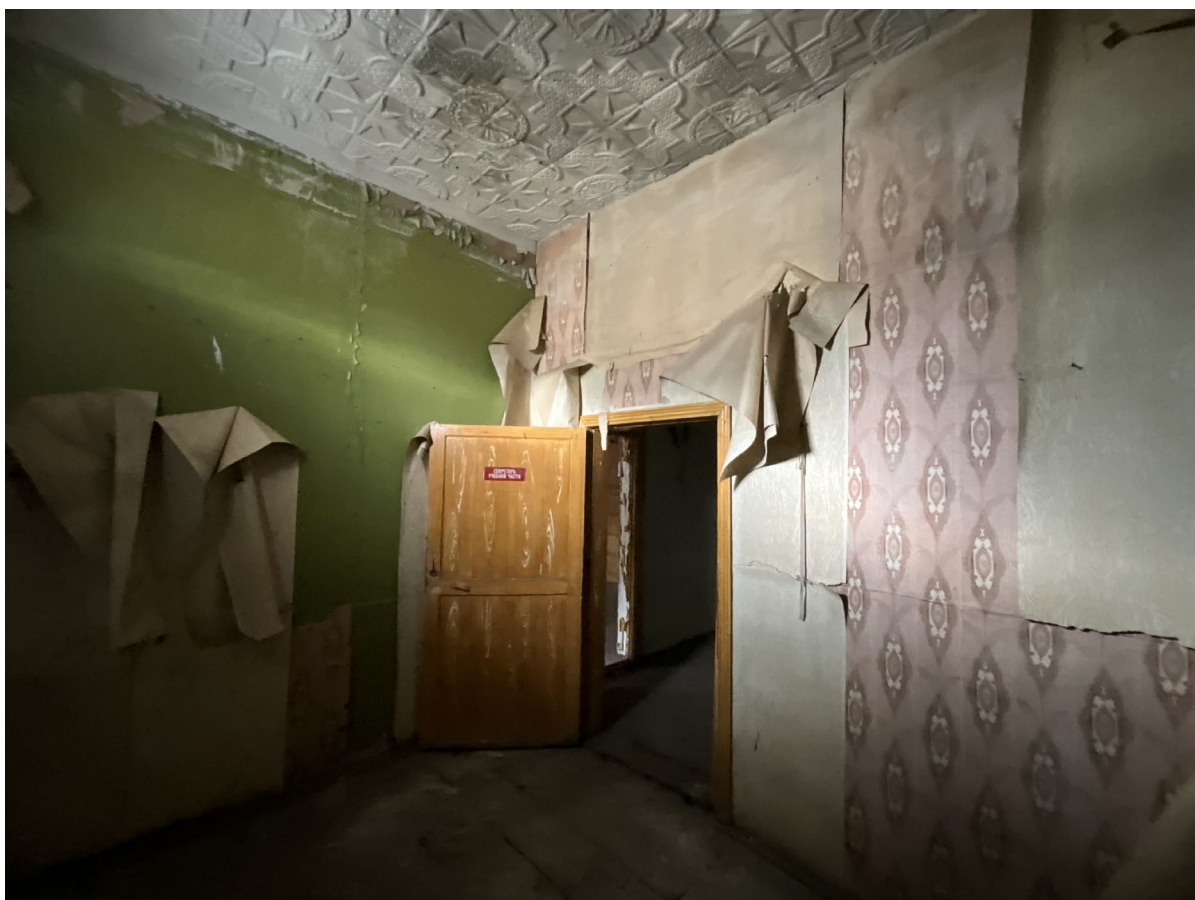
Фото №26. От 27 марта 2025 г. Помещение №2.15
