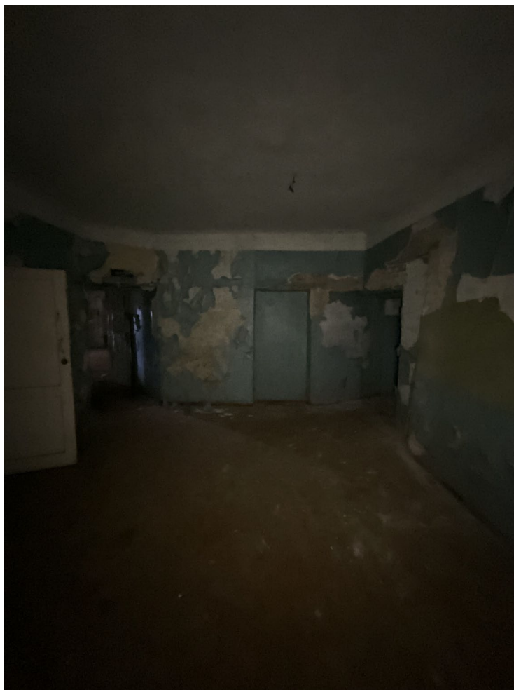
Фото №9. От 27 марта 2025 г. Помещение №1.2
