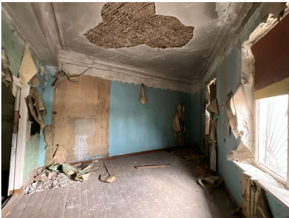
Фото №17. От 27 марта 2025 г. Помещение №2.8
