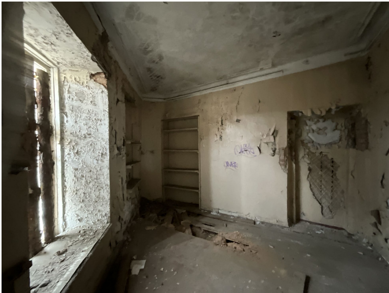
Фото №15. От 27 марта 2025 г. Помещение №2.4
