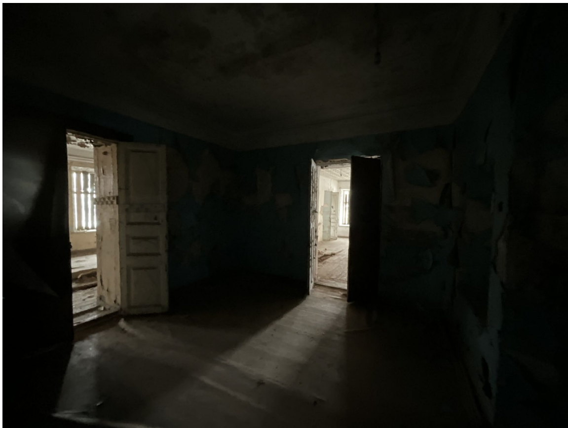
Фото №7. От 27 марта 2025 г. Помещение №2.2
