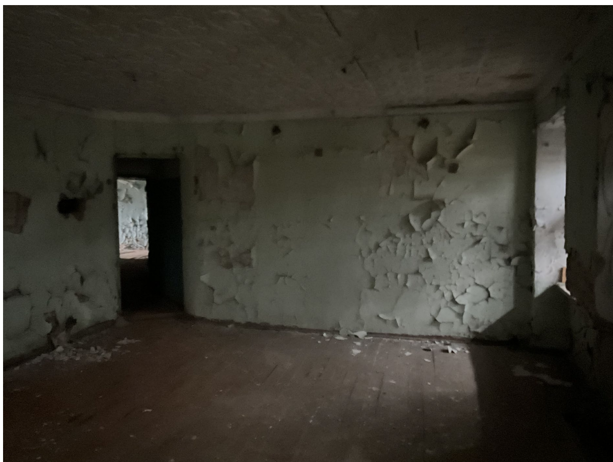
Фото №12. От 27 марта 2025 г. Помещение №1.7
