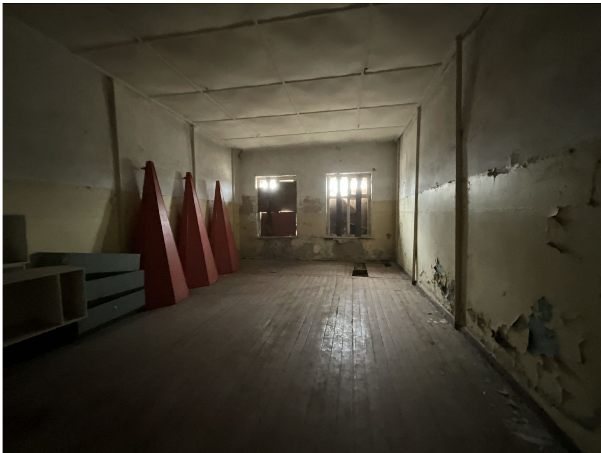
Фото №21. От 27 марта 2025 г. Помещение №1.11
