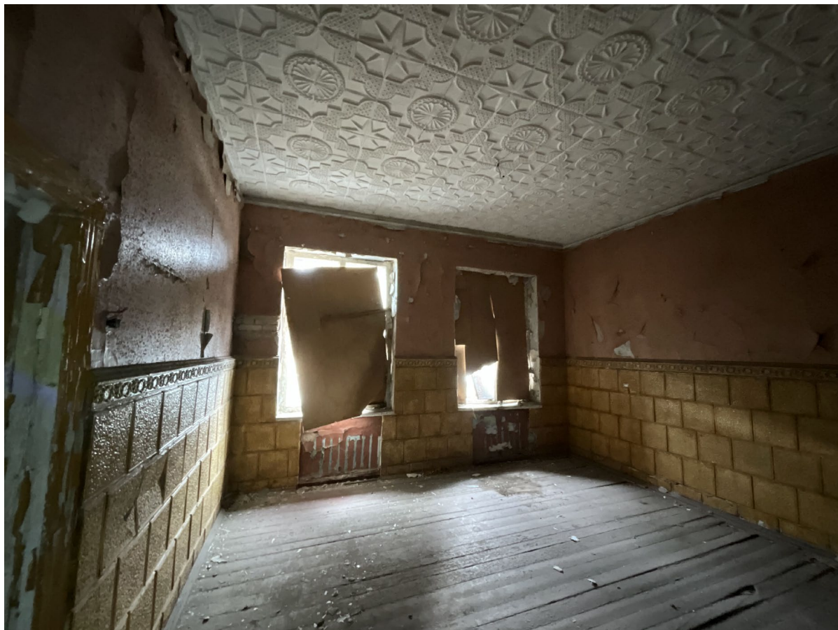
Фото №23. От 27 марта 2025 г. Помещение №2.16
