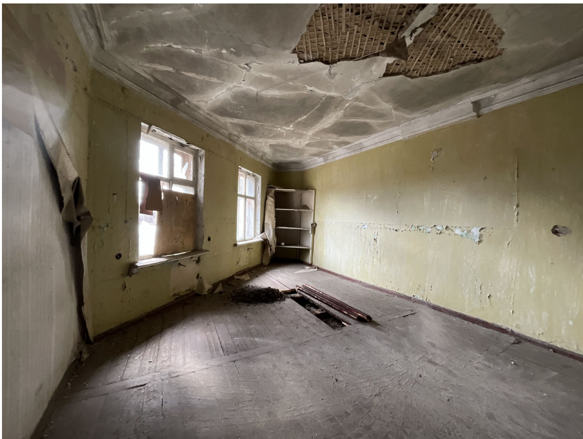
Фото №13. От 27 марта 2025 г. Помещение №2.9
