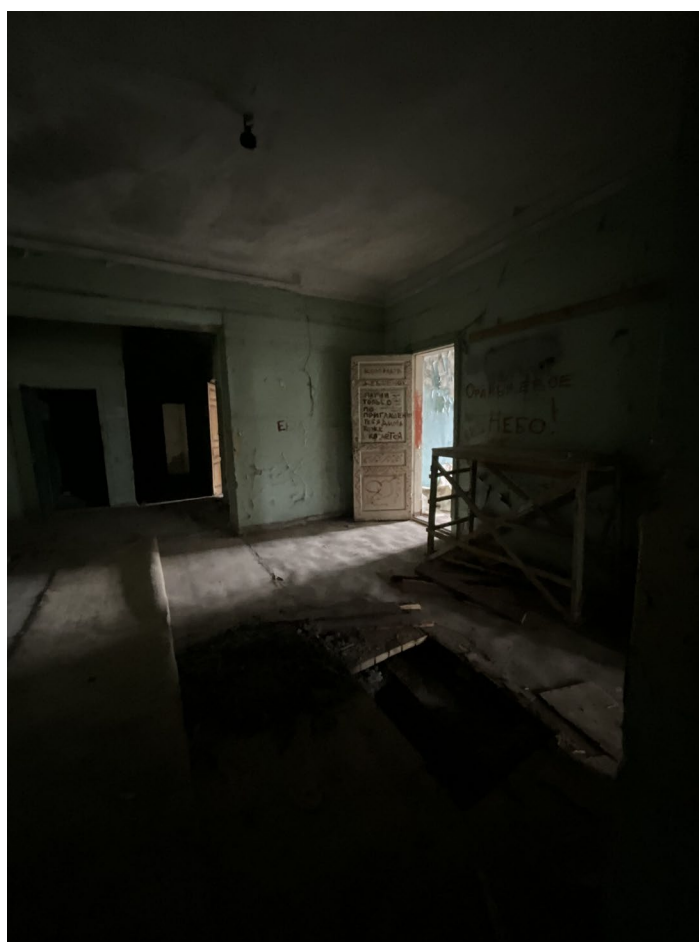
Фото №22. От 27 марта 2025 г. Помещение №2.7
