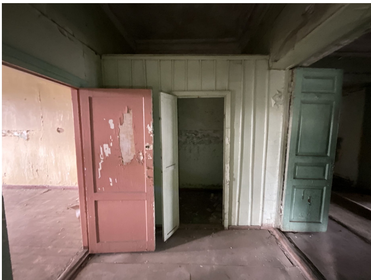
Фото №14. От 27 марта 2025 г. Помещение №2.10
