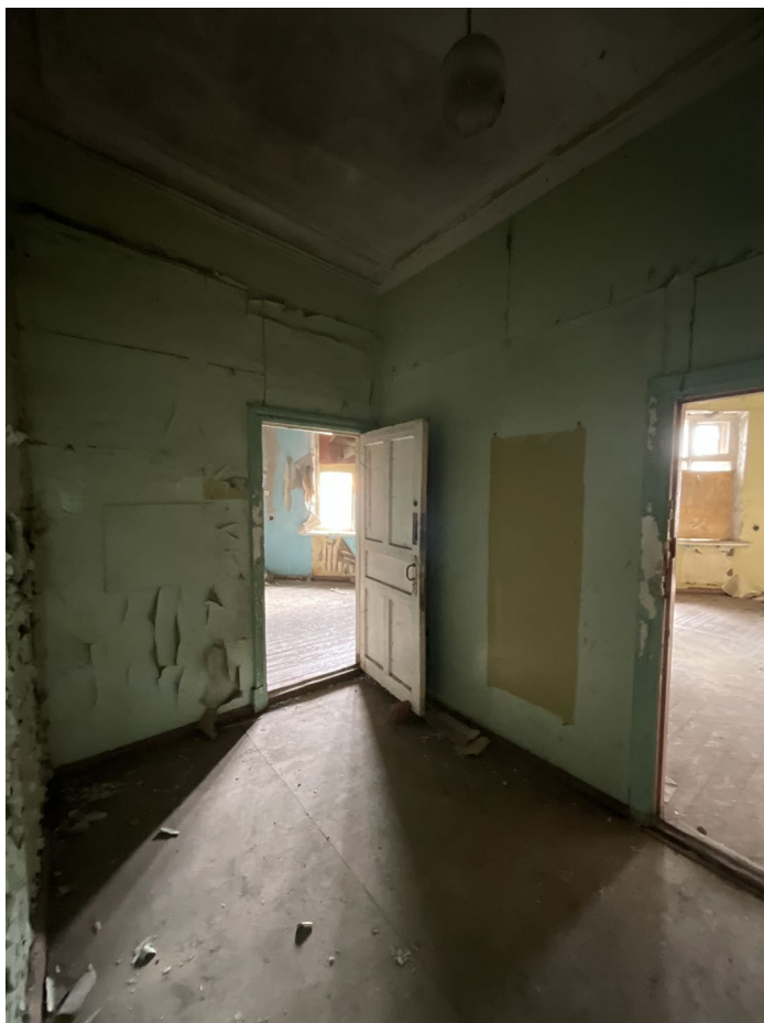
Фото №11. От 27 марта 2025 г. Помещение №2.10
