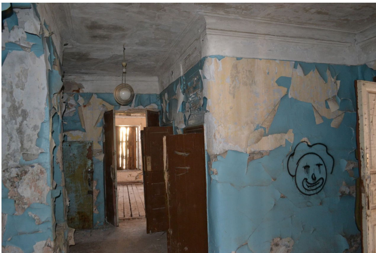
Фото №18. От 27 марта 2025 г. Помещение №2.2
