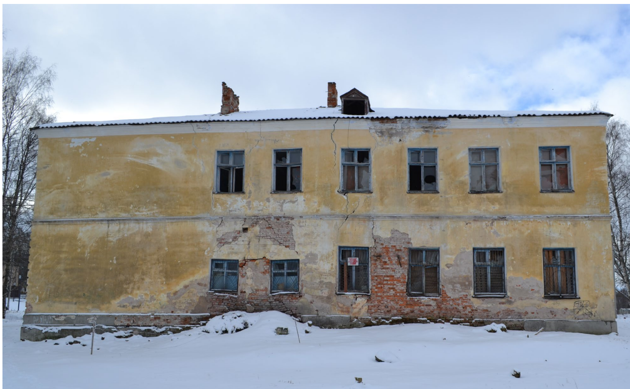
Фото №1. От 27 марта 2025 г. Фасад
