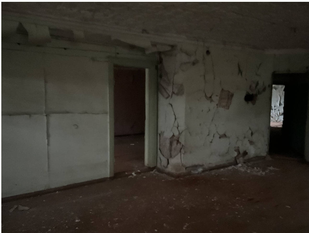
Фото №11. От 27 марта 2025 г. Помещение №1.7
