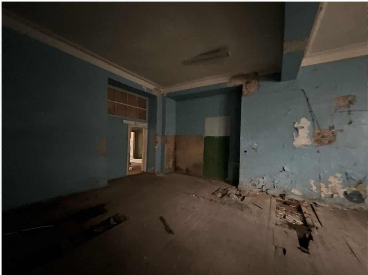
Фото №17. От 27 марта 2025 г. Помещение №1.7
