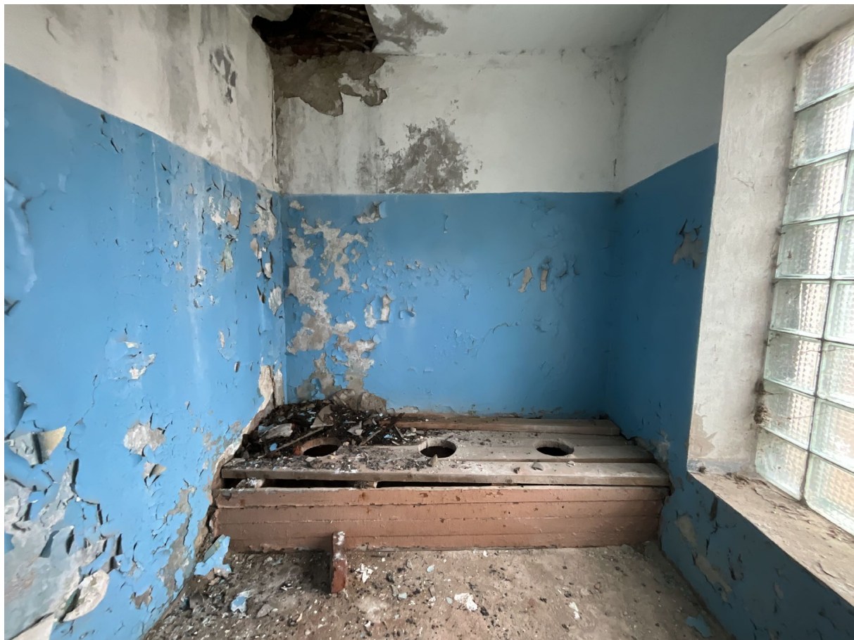
Фото №5. От 27 марта 2025 г. Помещение №2.11
