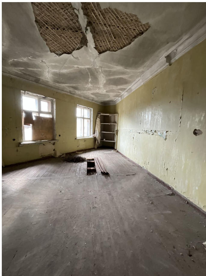
Фото №12. От 27 марта 2025 г. Помещение №2.9
