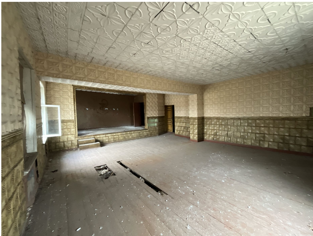
Фото №4. От 27 марта 2025 г. Помещение №2.2
