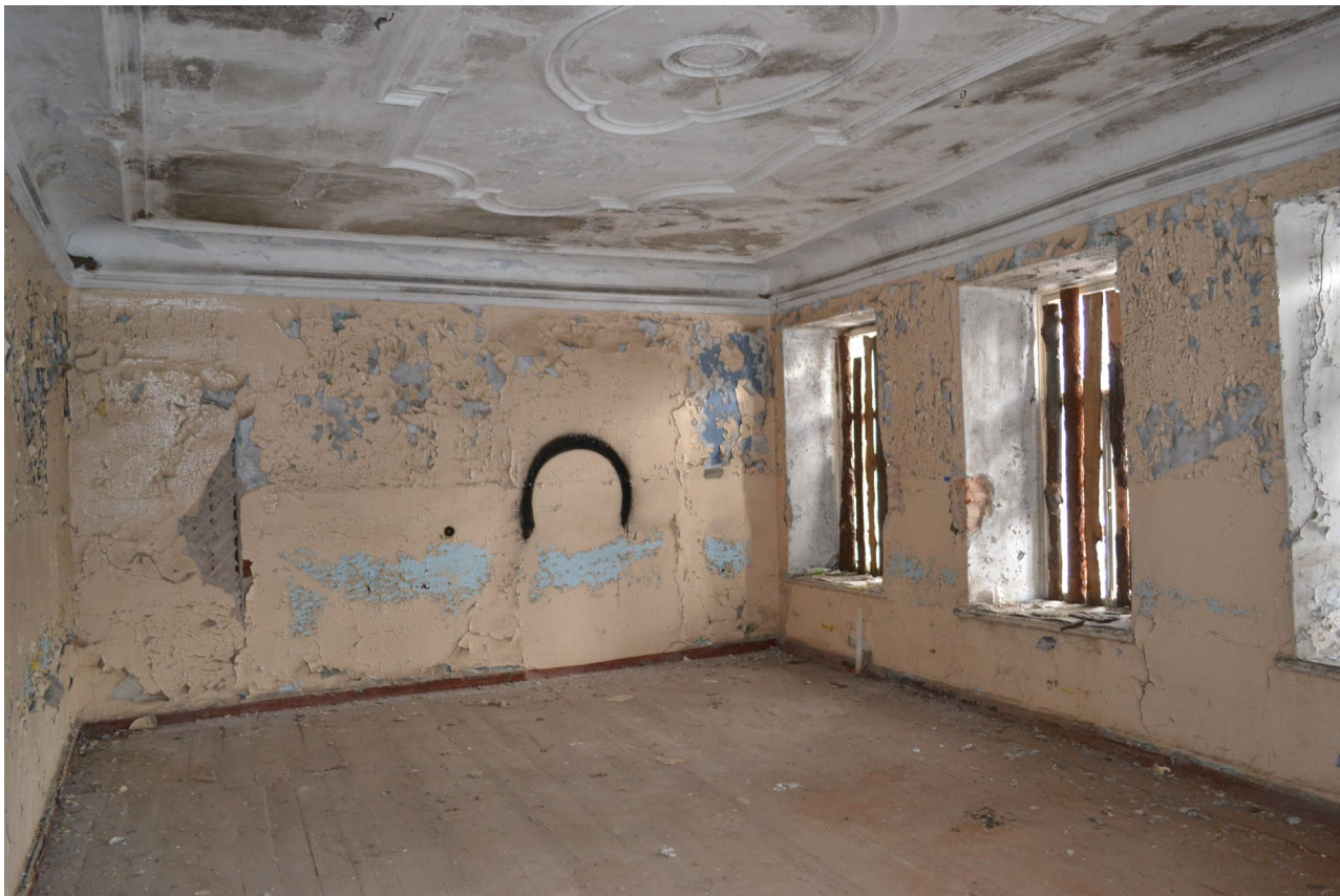
Фото №17. От 27 марта 2025 г. Помещение №2.5
