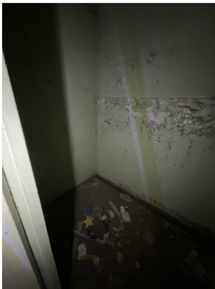
Фото №18. От 27 марта 2025 г. Помещение №2.11
