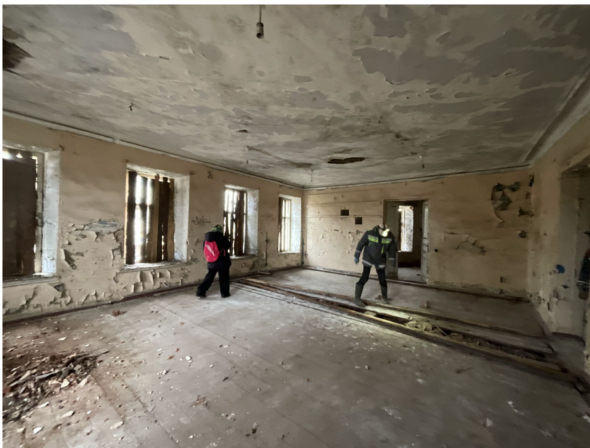
Фото №14. От 27 марта 2025 г. Помещение №2.3
