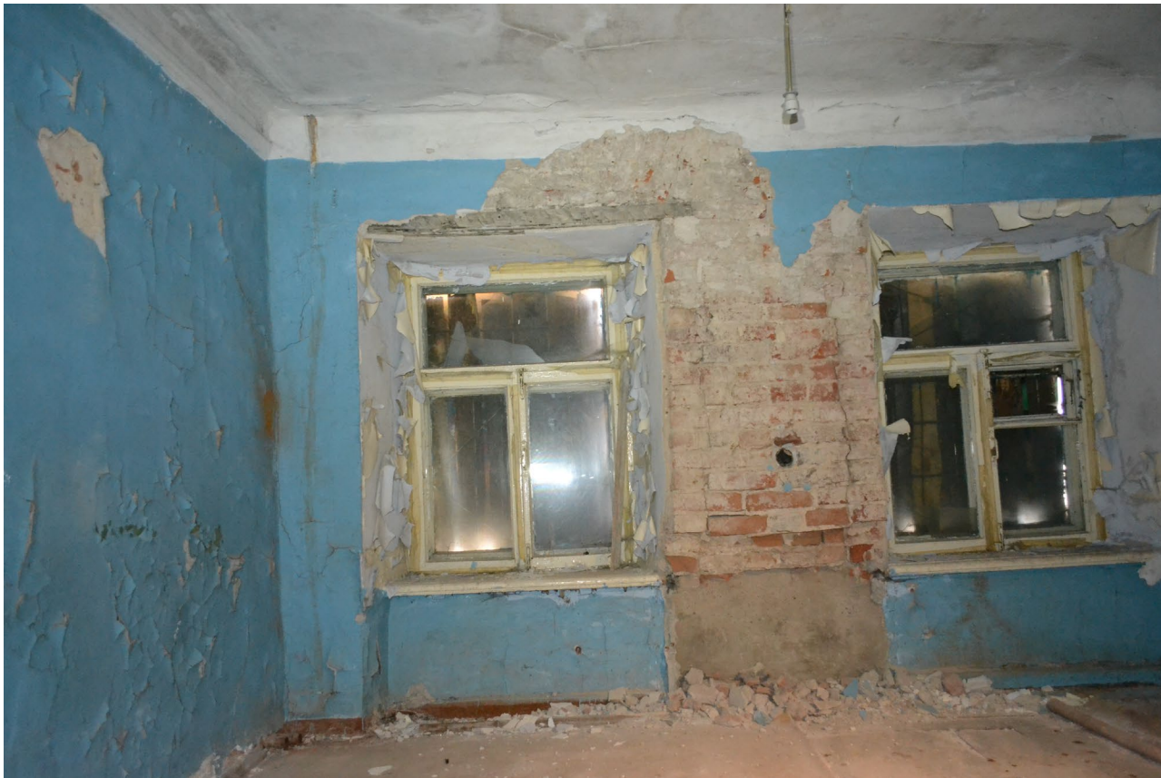
Фото №19. От 27 марта 2025 г. Помещение №1.6
