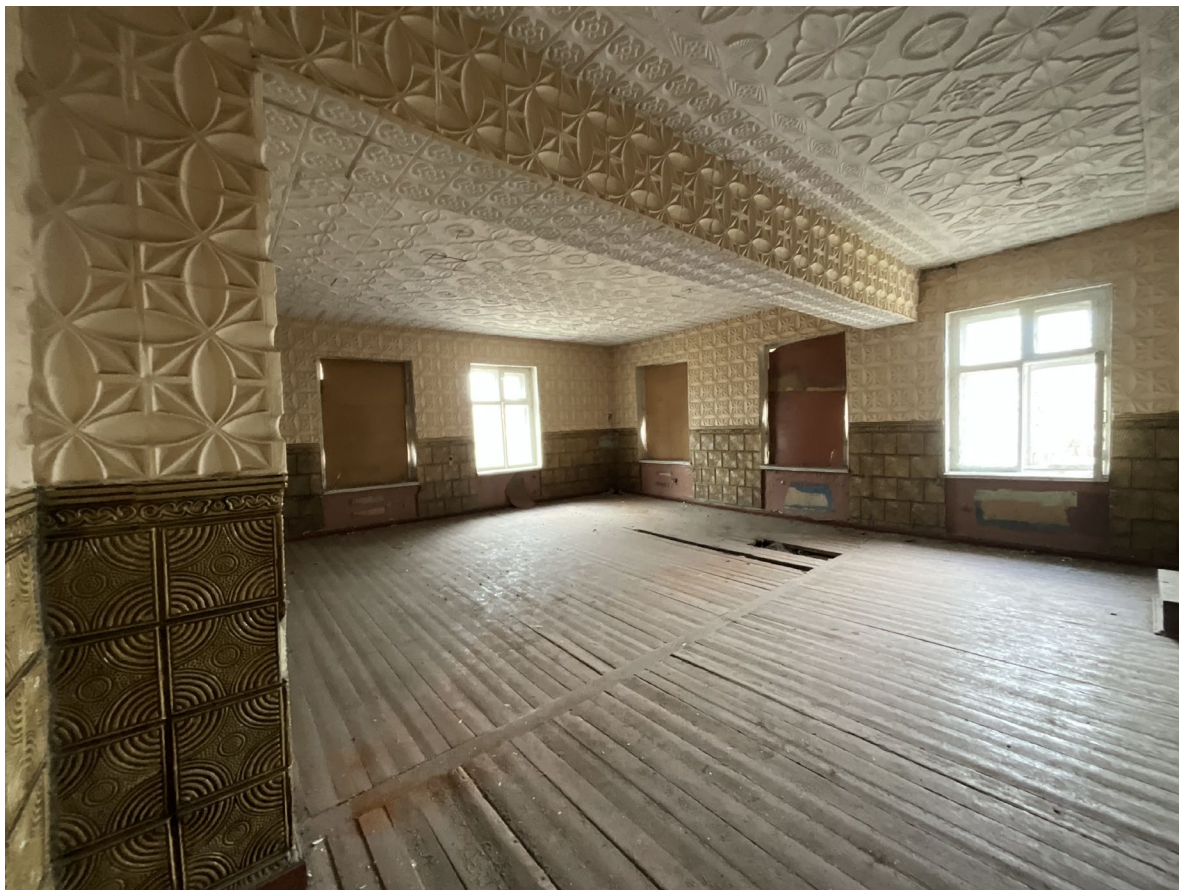
Фото №3. От 27 марта 2025 г. Помещение №2.2
