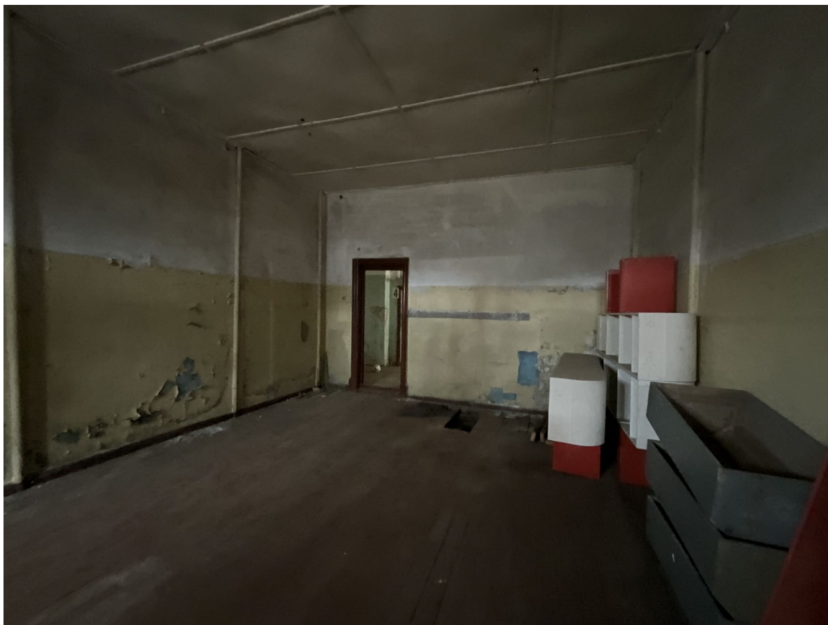
Фото №22. От 27 марта 2025 г. Помещение №1.11
