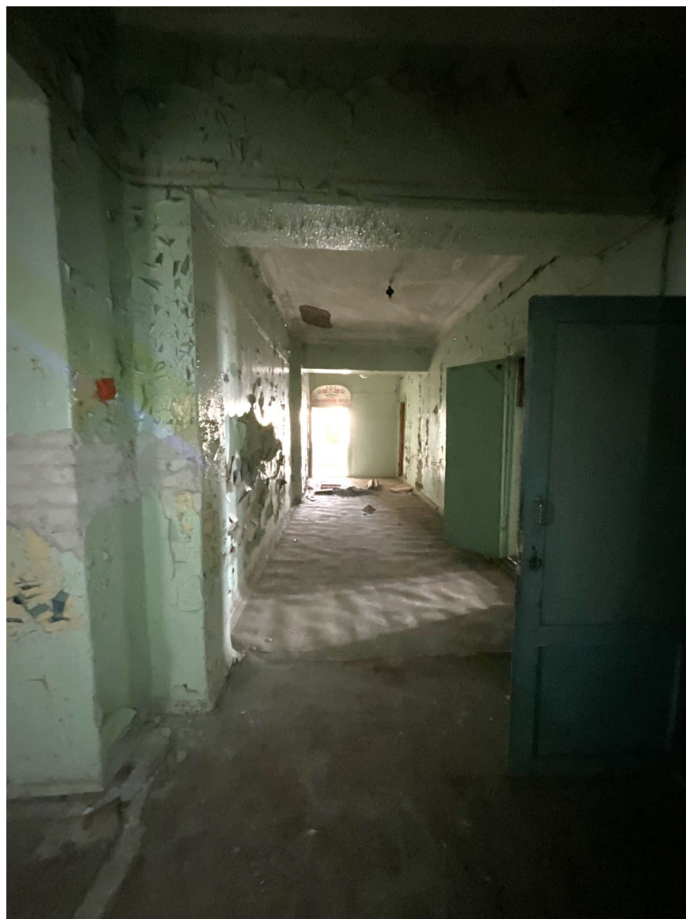
Фото №9. От 27 марта 2025 г. Помещение №2.12
