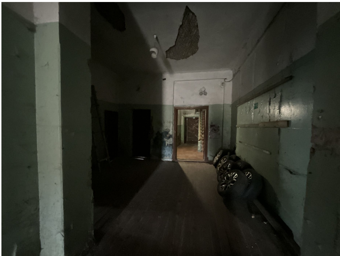
Фото №23. От 27 марта 2025 г. Помещение №1.6
