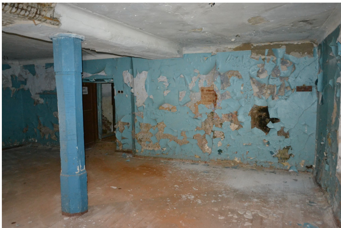
Фото №22. От 27 марта 2025 г. Помещение №1.3
