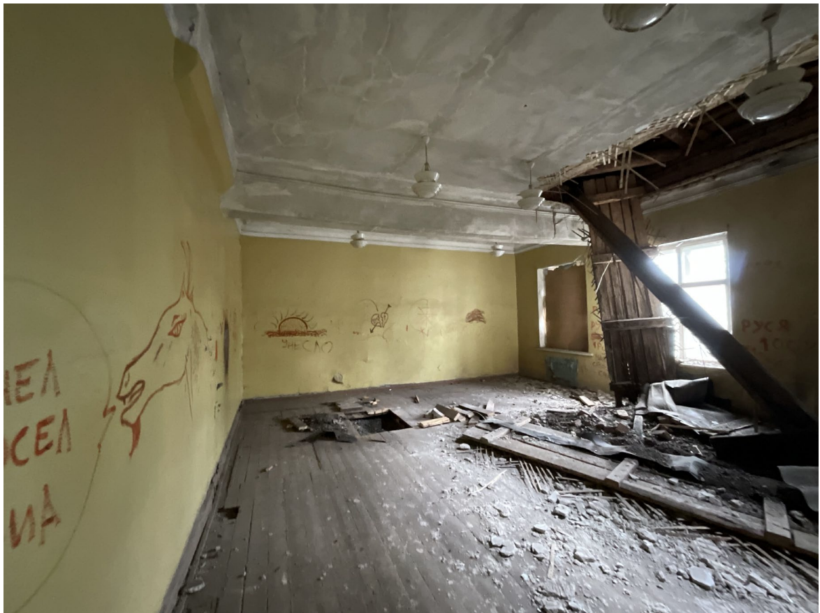
Фото №19. От 27 марта 2025 г. Помещение №2.6
