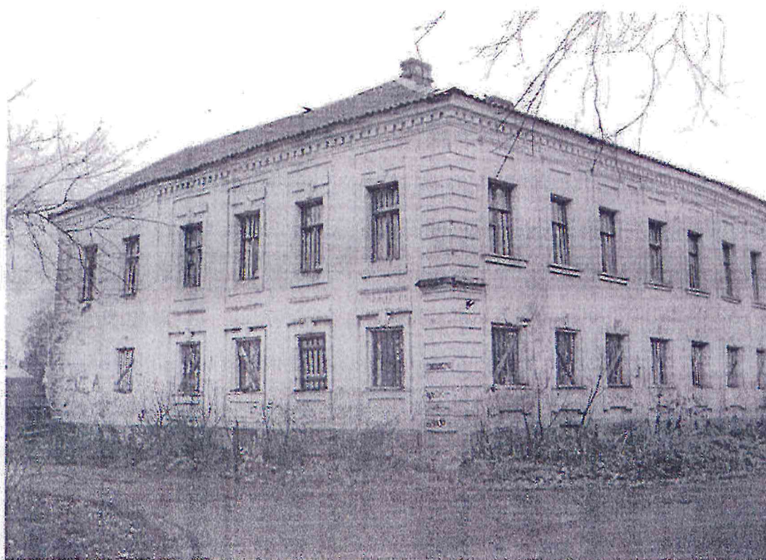
«Начальное училище» 1770-90 гг. Вид с юго-востока, от Летнего сада. Фасады на ул. Васильева и ул. Красную
