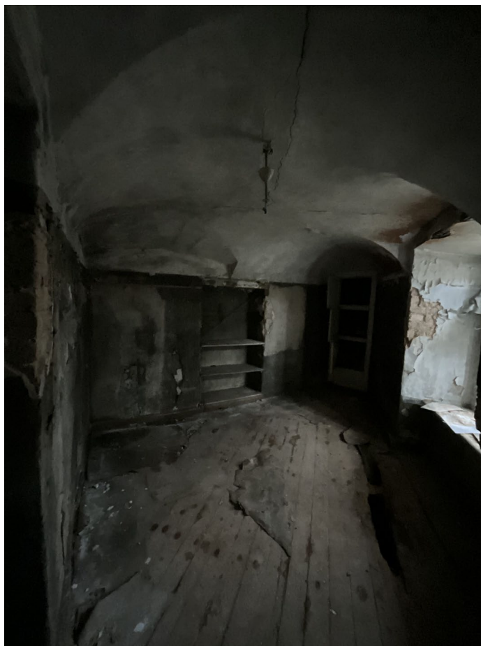
Фото №6. От 27 марта 2025 г. Помещение №1.4
