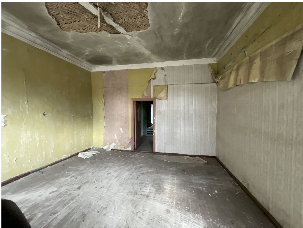
Фото №28. От 27 марта 2025 г. Помещение №2.9
