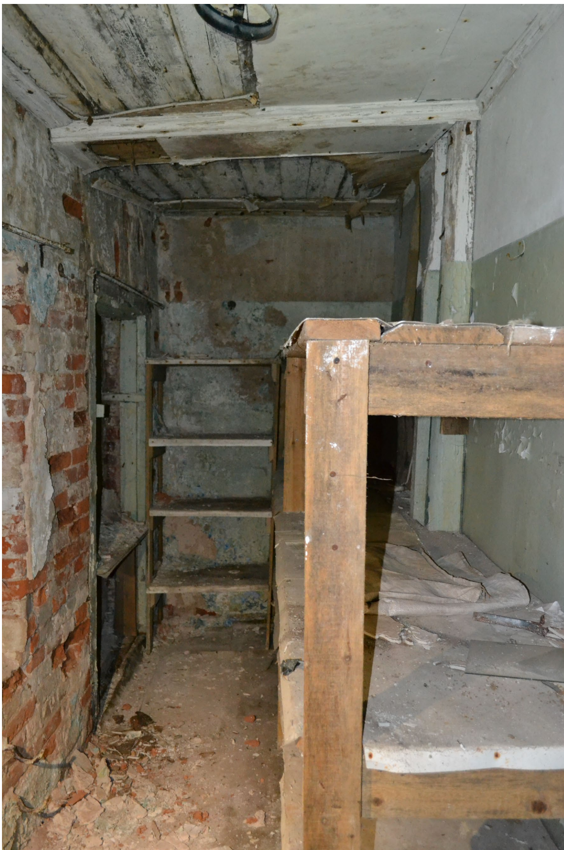
Фото №23. От 27 марта 2025 г. Помещение №1.11
