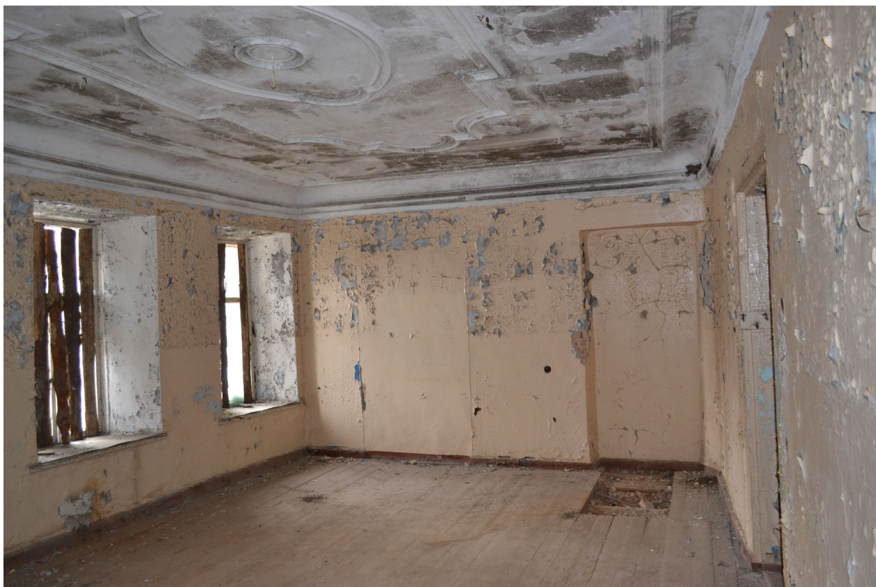
Фото №16. От 27 марта 2025 г. Помещение №2.5
