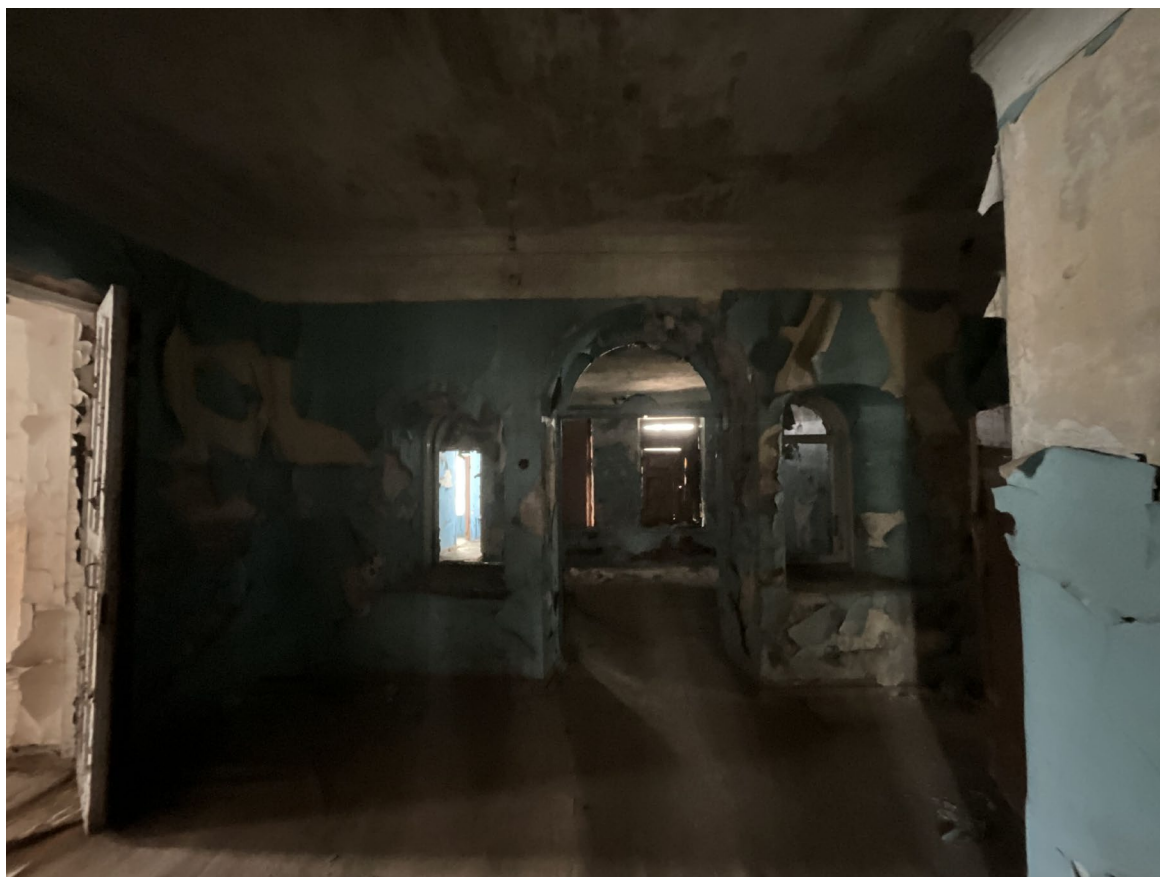
Фото №8. От 27 марта 2025 г. Помещение №2.2
