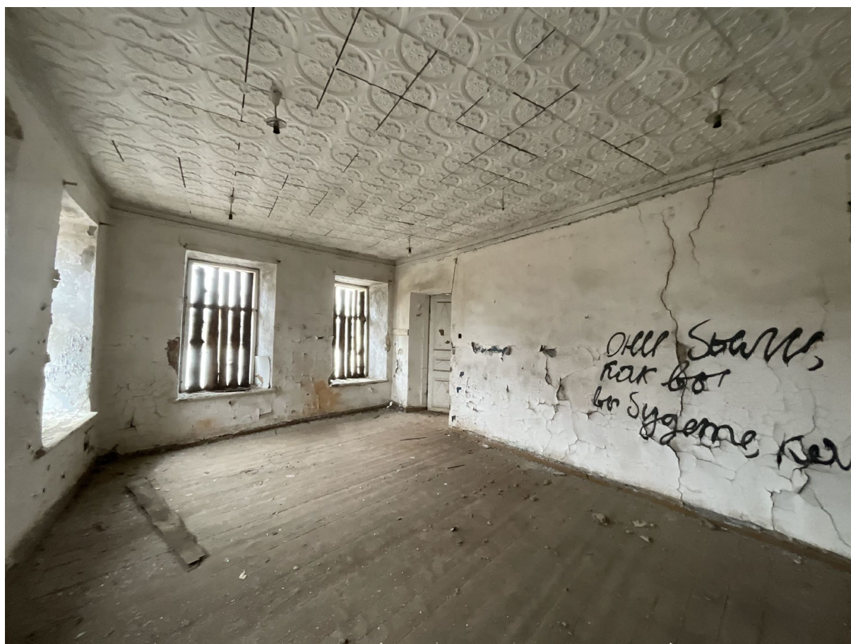
Фото №12. От 27 марта 2025 г. Помещение №2.6
