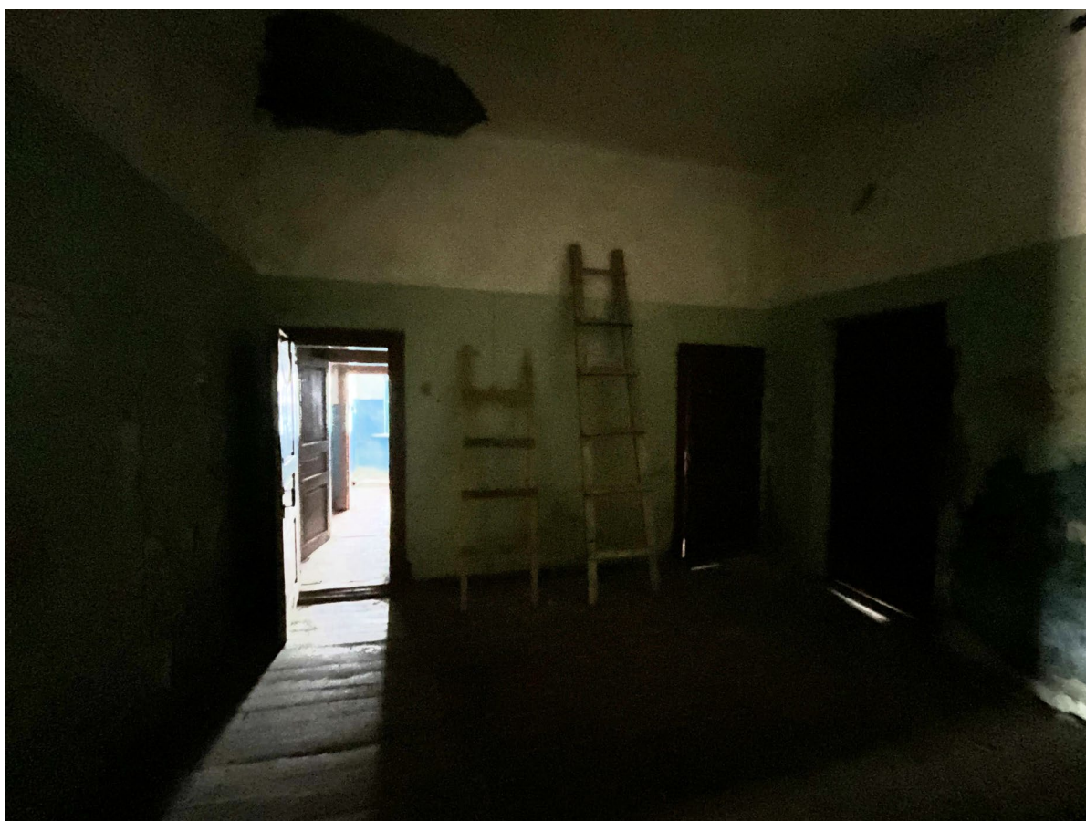
Фото №24. От 27 марта 2025 г. Помещение №1.6
