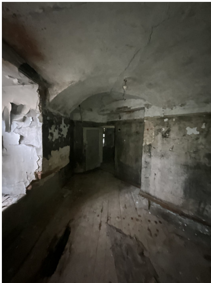
Фото №7. От 27 марта 2025 г. Помещение №1.4
