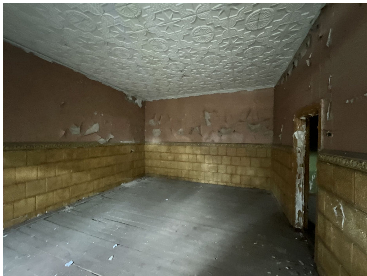
Фото №24. От 27 марта 2025 г. Помещение №2.16
