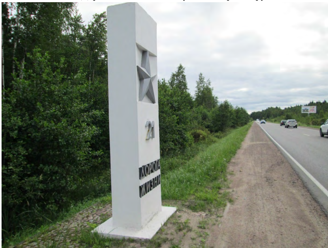
Фото 5. Точка фотофиксации Ф2. Вид севера на территорию ОКН «Достопримечательное место «Дорога Жизни», территорию и охранную зону ОКН «Ансамбль «Зеленый пояс Славы Ленинграда. Памятные километровые столбы на Дороге жизни» (21-й км) и полосу отвода проектируемого объекта.
