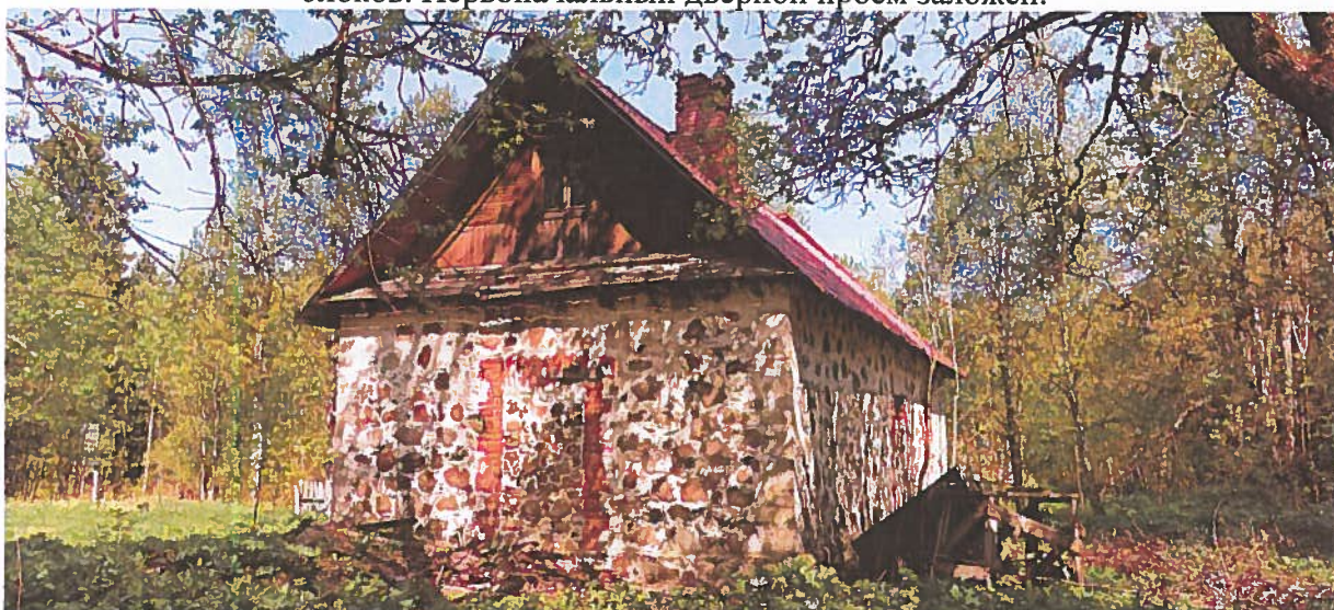
Фото 16. Общий вид на южный фасад.
