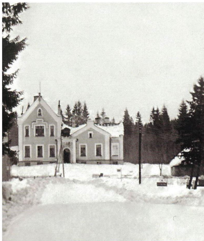
14. Вид на усадьбу со стороны главного подъезда к имению. 1950-е. Опубликовано: «По древней Ямбургской земле», Кингисепп, 2004 г.
