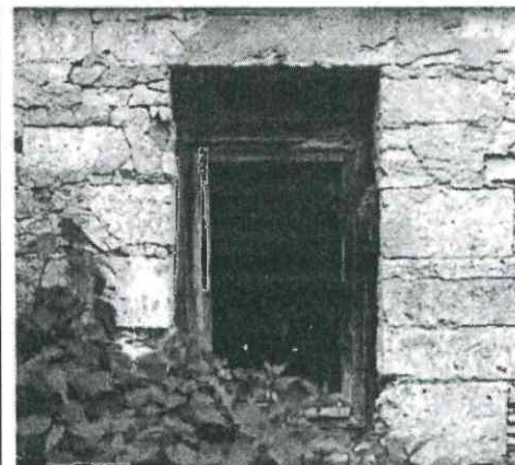
Оконные проемы цоколя террасы
