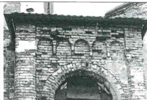
Лопатка и аркатурный пояс ризалита главного входа
