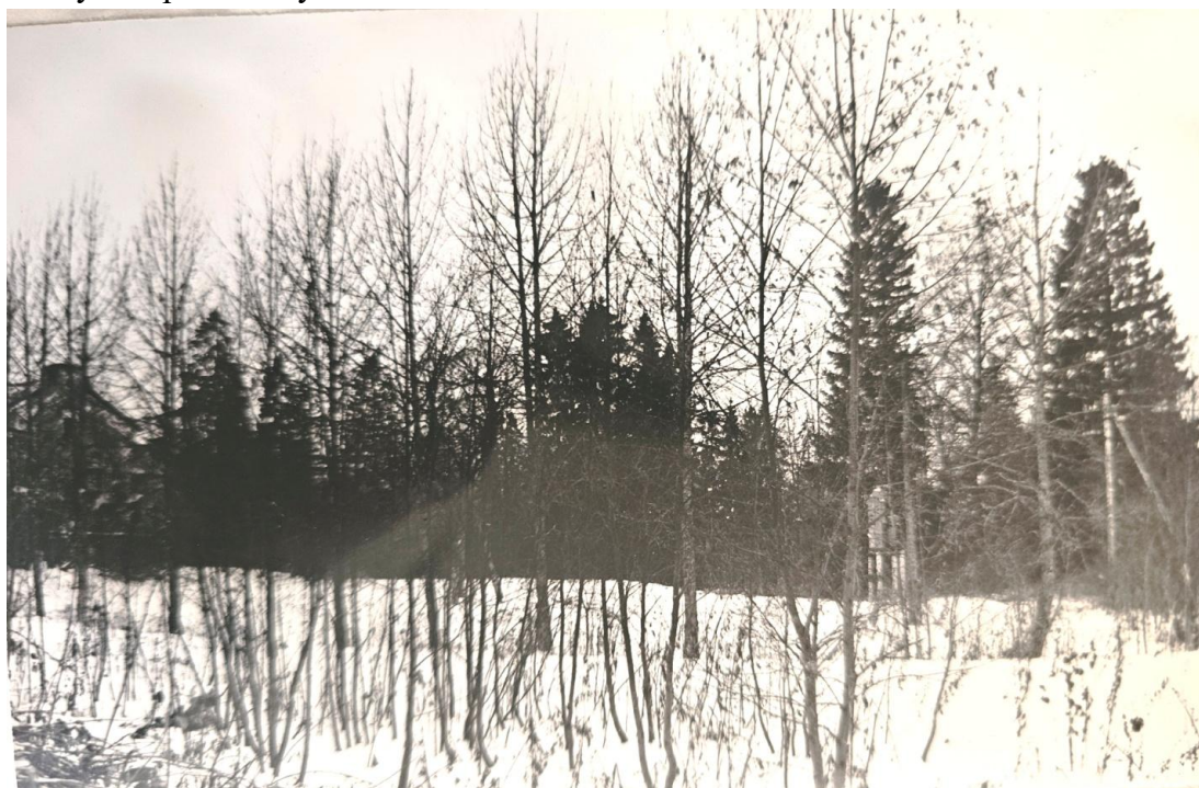
34. 614-1 ИНЭНКО РАН Проведение предварительного обследования Усадьбы Альбрехтов «Утешение» (Кингисеппского района) и составление тезисной программы для проведения комплексной реконструкции и плана первоочередных противоаварийных работ. Предварительное обследование. 1992г. Тоже. Зеленое обрамление партера перед господским домом.
