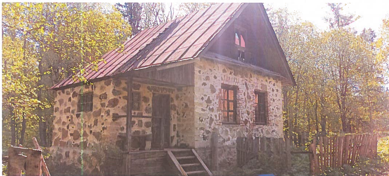
Фото 18. Общий вид с северо-запада.
