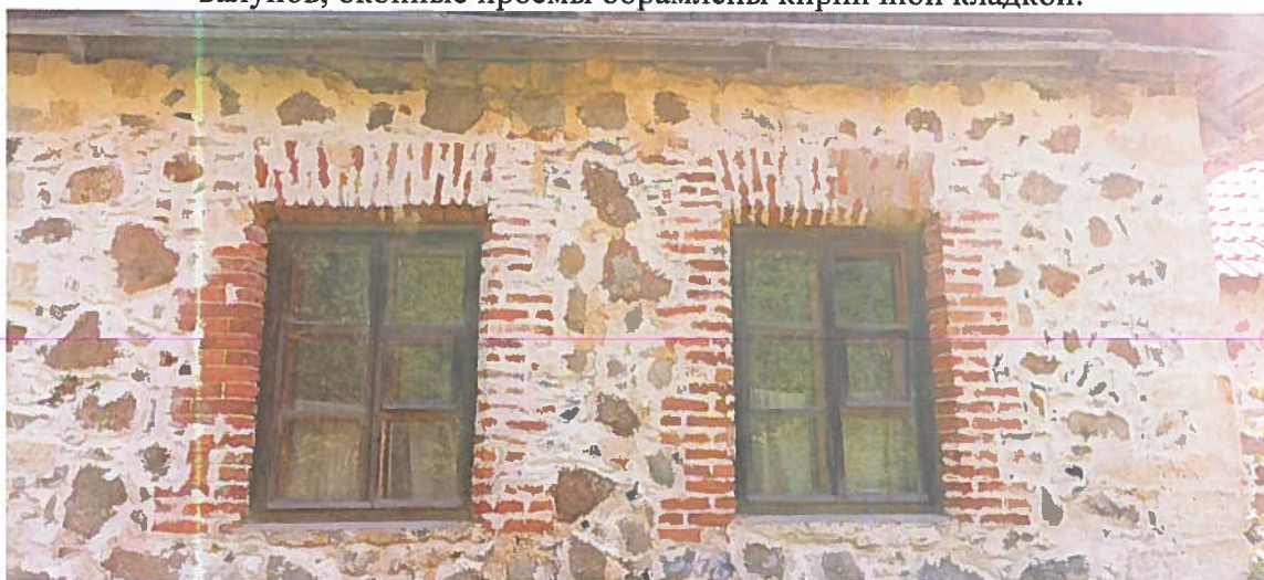
Фото 10. Вид на оконные проемы ризалита западного фасада. Стены выполнены из крупных гранитных валунов, оконные проемы обрамлены кирпичной кладкой. Углы здания выполнены из обработанных каменных блоков.
