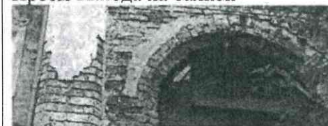
Оформление проема главного входа
