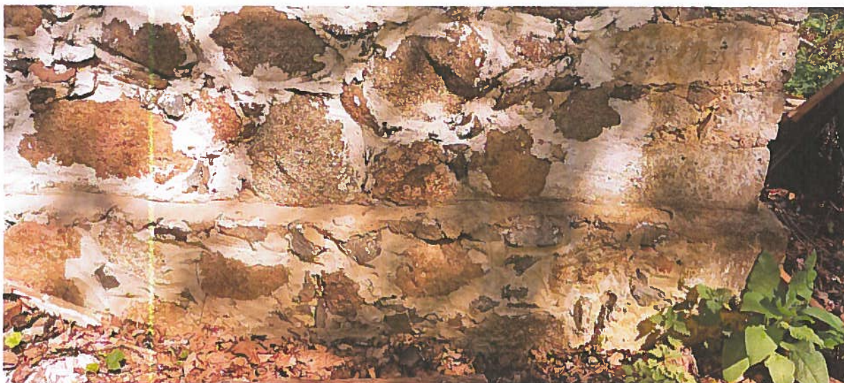
Фото 3. Вид на цоколь и отмостку. Цоколь выполнен из крупных каменных валунов без обработки на известково-песчаном связующем растворе. Фрагменты утраты межшовного заполнения восполнены цементно-песчаным раствором в современном исполнении.
