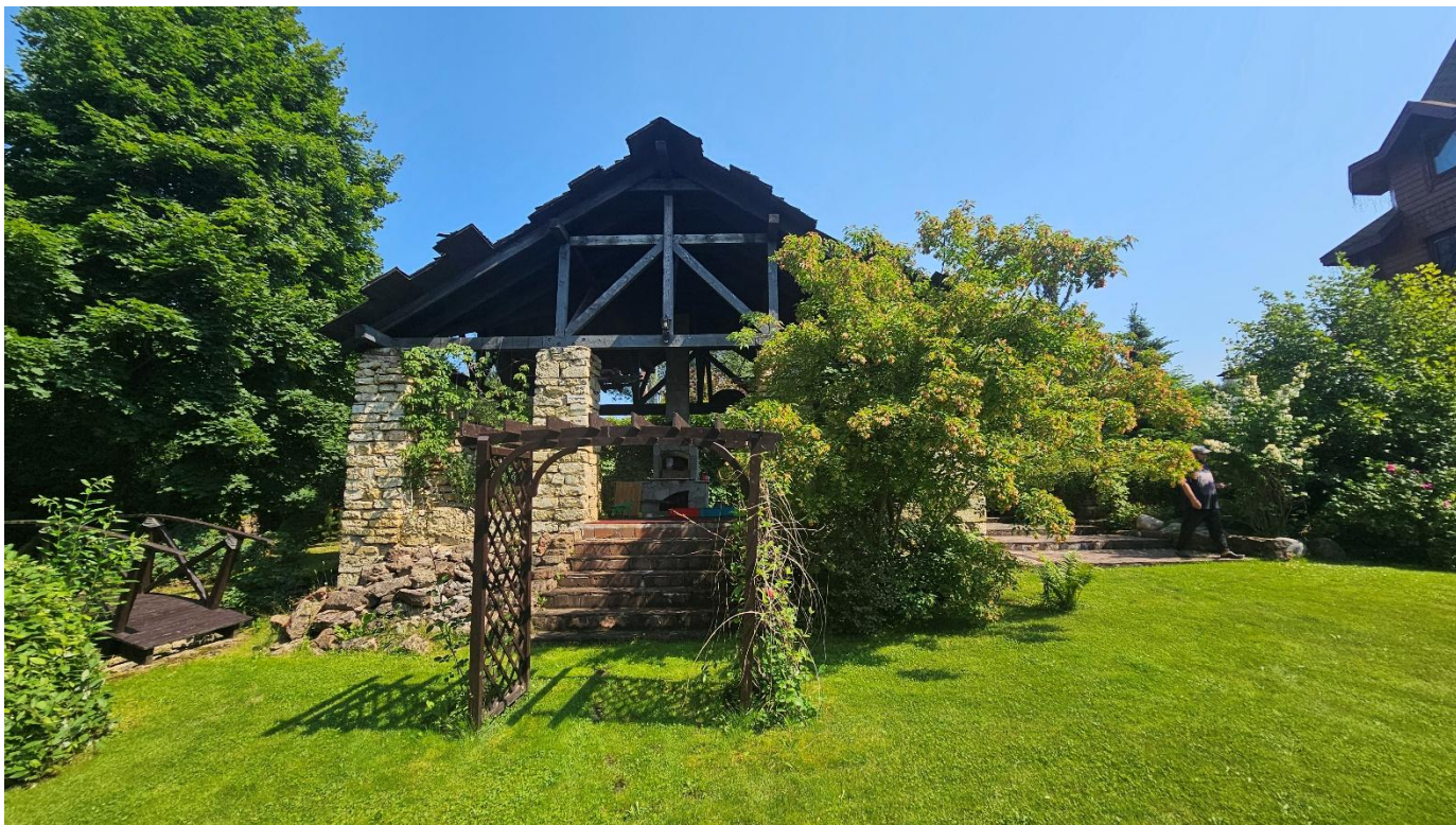
Фото 38. Мельница. Вид с запада
