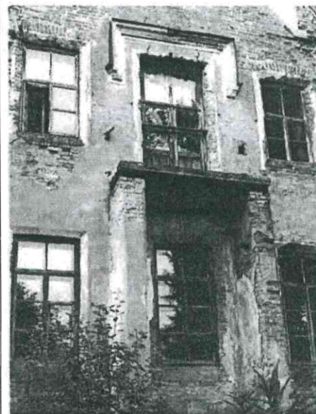
опоры для балкона
