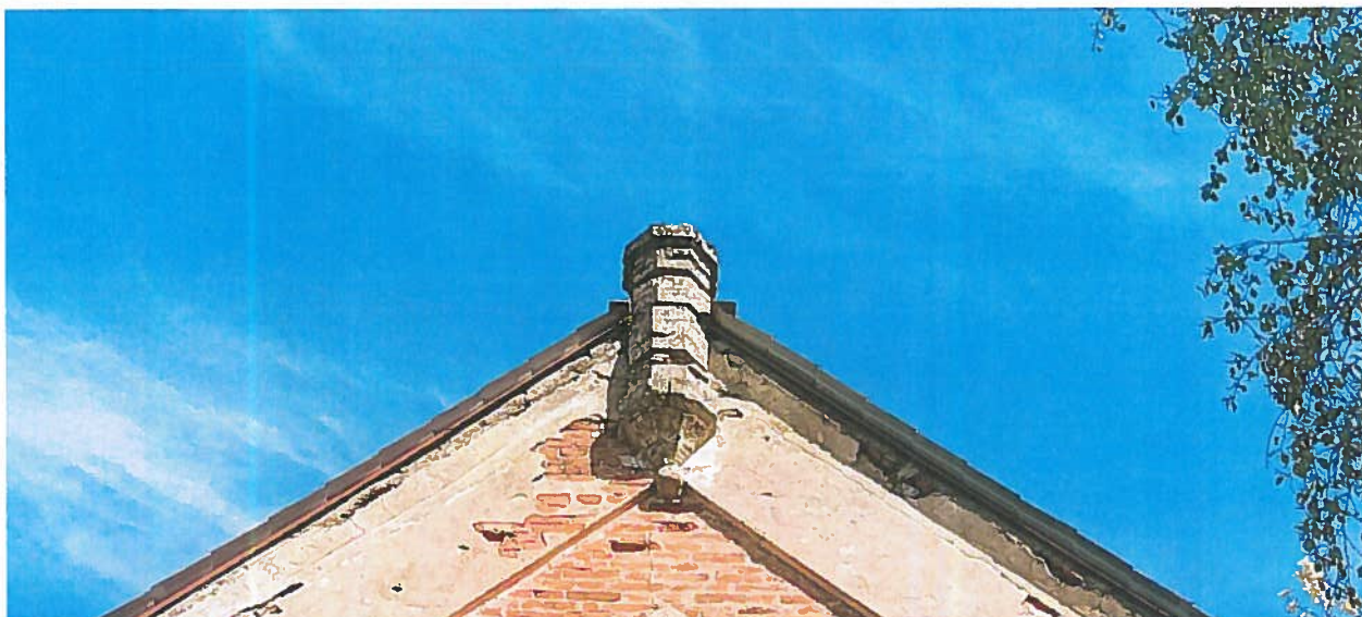
Фото 18. Вид на турель шипца двухэтажной части южного фасада.
