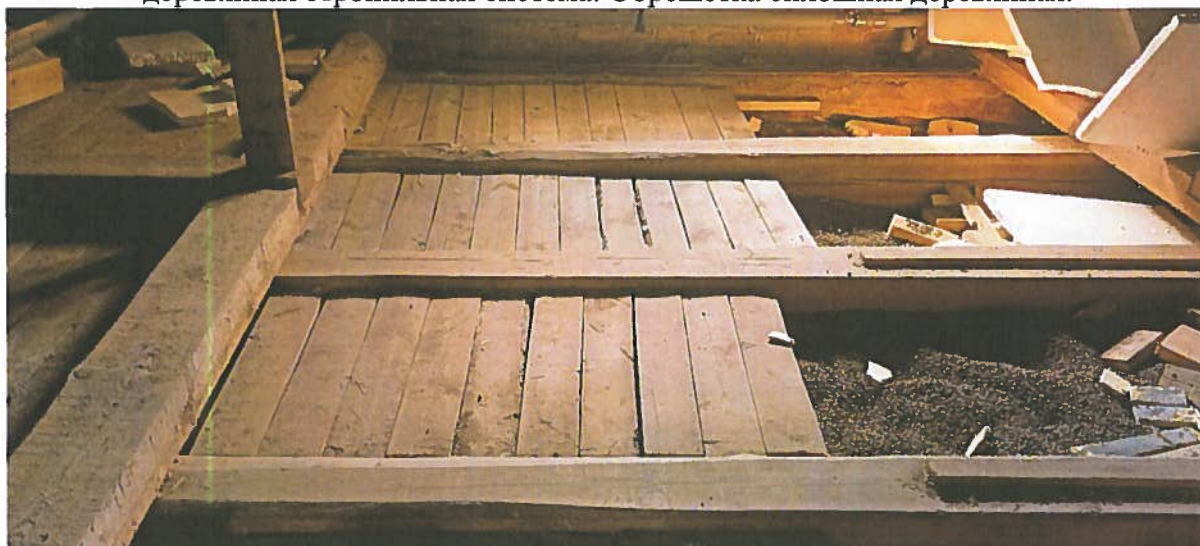
Фото 44. Вид на чердачное перекрытие. Конструкция перекрытия – по деревянным балкам с подбором из доски, пространство между балками заполнено керамзитом в качестве утеплителя.
