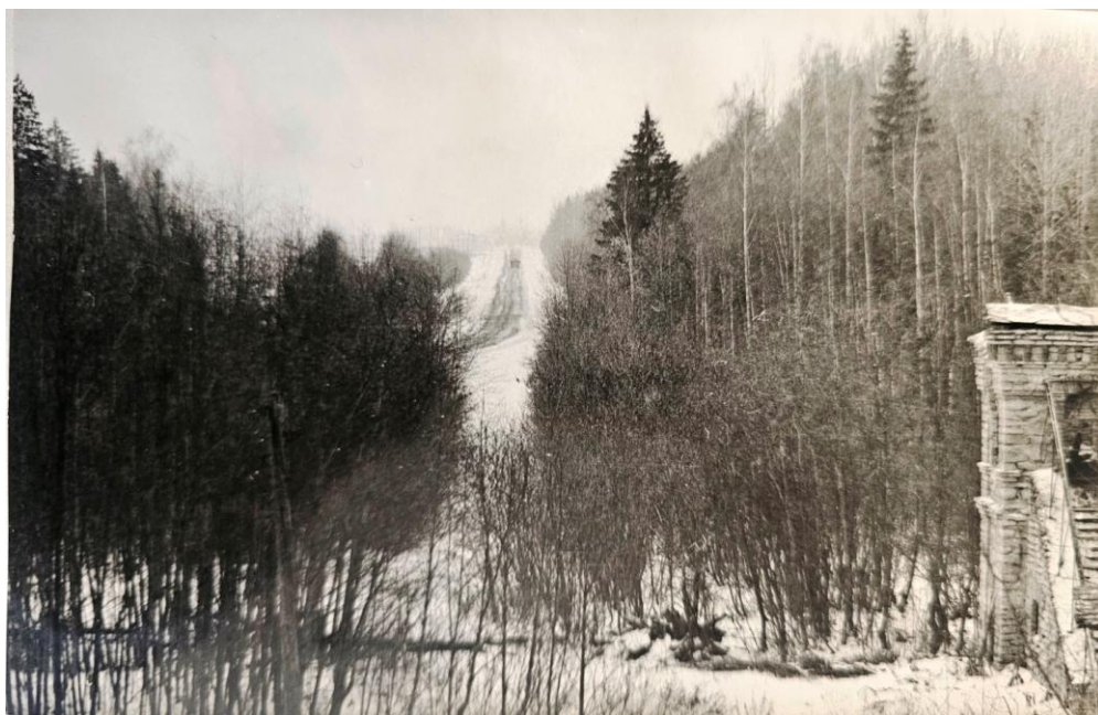
33. 614-1 ИНЭНКО РАН Проведение предварительного обследования Усадьбы Альбрехтов «Утешение» (Кингисеппского района) и составление тезисной программы для проведения комплексной реконструкции и плана первоочередных противоаварийных работ. Предварительное обследование. 1992г. Вид с крыши господского дома на партер и центральную перспективу.
