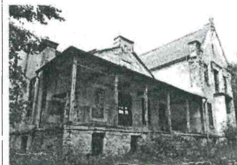
Терраса южного фасада
