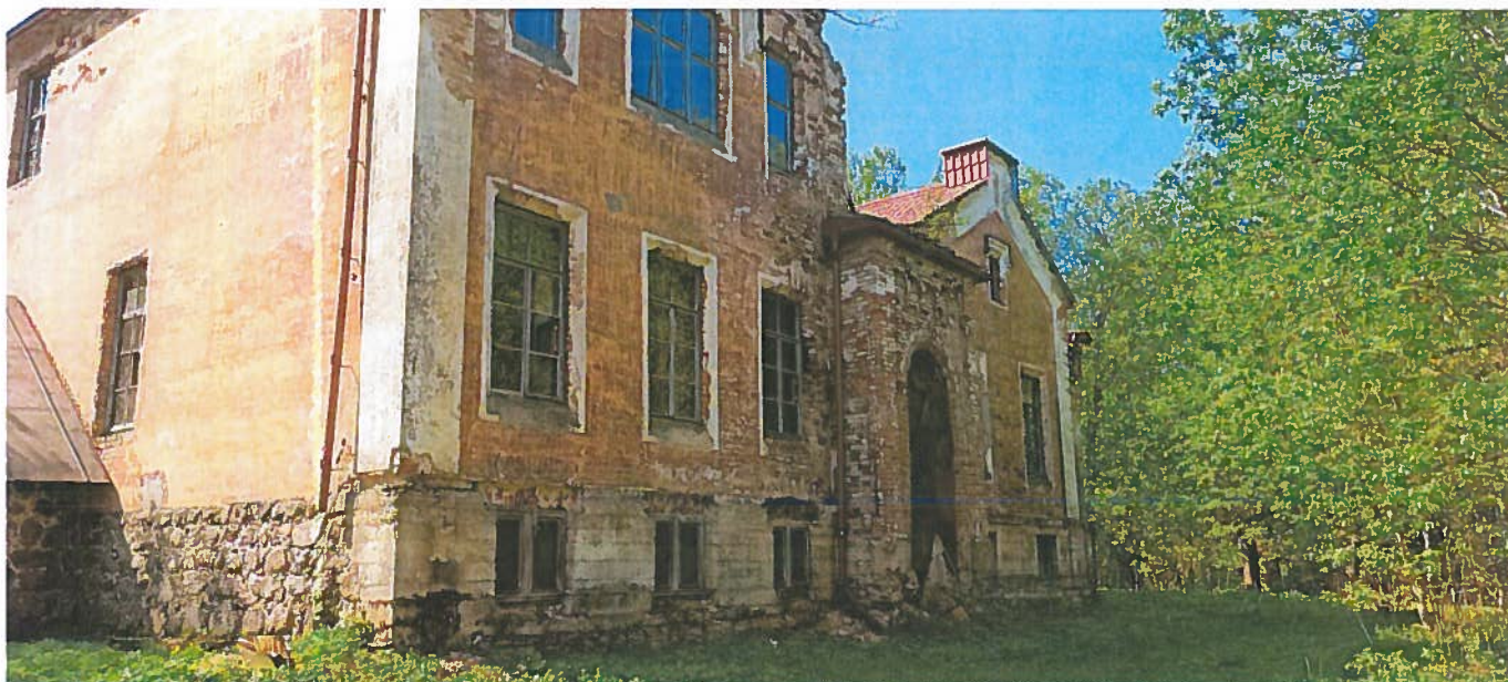
Фото 46. Прилегающая территория к северному фасаду.
