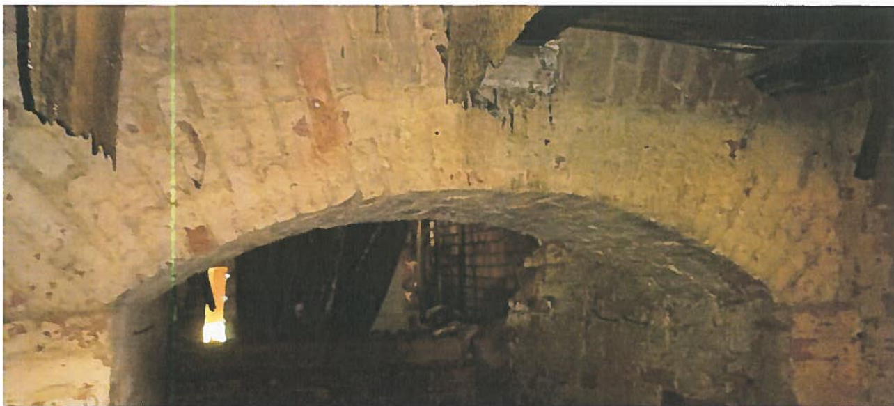
Фото 29. Арочная кирпичная перемычка проема подвального этажа.
