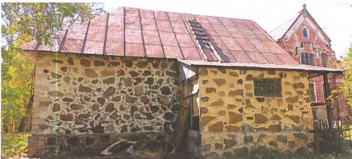
Фото 12. Вид на северный фасад. Материал кровельного покрытия – металлические листы, соединенные в фальц.
