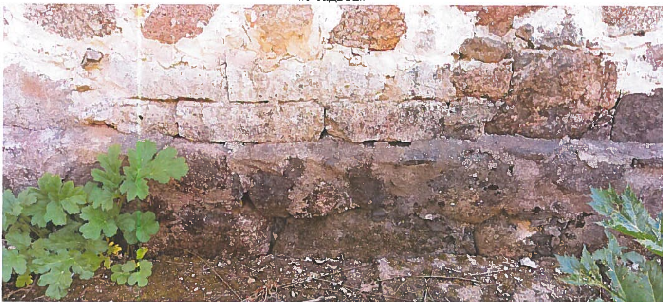
Фото 1. Вид на цоколь и отмостку. Цоколь выполнен из крупных каменных валунов без обработки на известково-песчаном связующем растворе. Фрагменты утраты межшовного заполнения восполнены цементно-песчаным раствором в современном исполнении.
