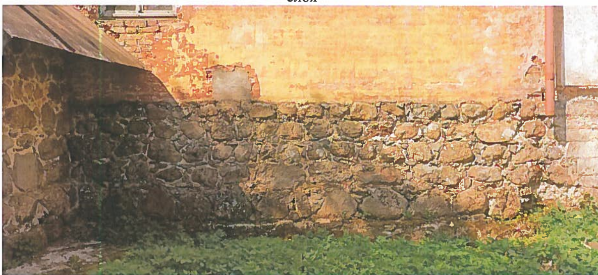
Фото 10. Вид на цоколь восточного фасада. Характер облицовки – крупные гранитные валуны без обработки на известняково-песчаном связующем растворе.
