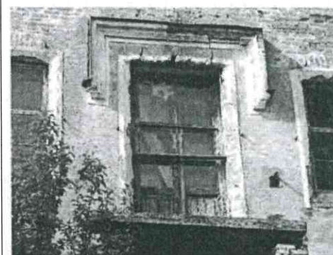
Проем выхода на балкон
