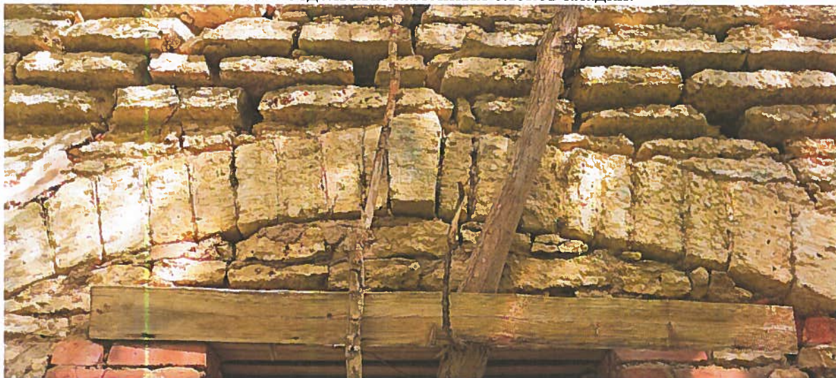
Фото 16. Каменная клинчатая перемычка с замковым камнем главного входа южного фасада.
