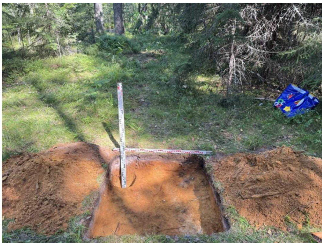
Рис. 519. Лен. область, Ломоносовский р-н. Шурф 81. Общий вид шурфа. Вид с Ю.
