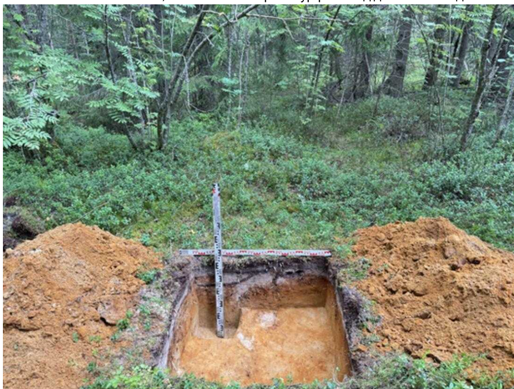
Рис. 554. Лен. область, Ломоносовский р-н. Шурф 88. Общий вид шурфа. Вид с Ю.
