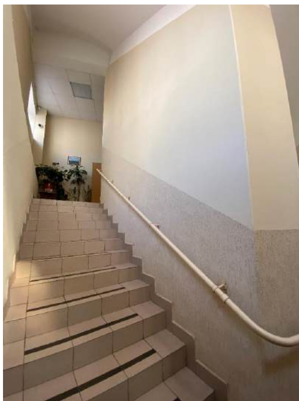
Фото 37. Лестница в западной части здания.
