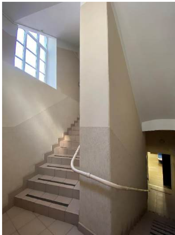
Фото 36. Лестница в западной части здания.
