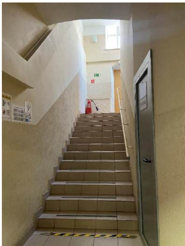
Фото 35. Лестница в западной части здания.
