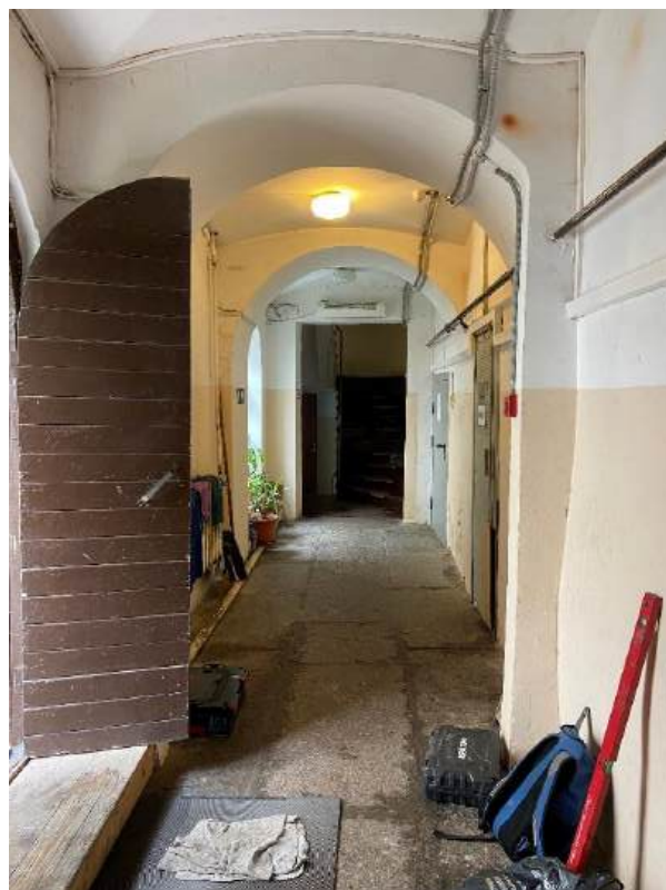
Фото 45. Коридор в уровне 1-го этажа.
