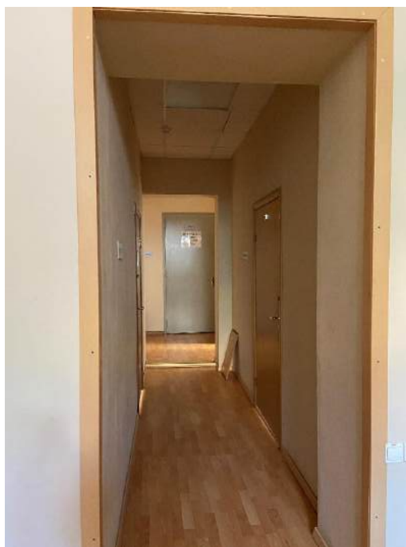
Фото 38. Помещение 10 на третьем этаже.
