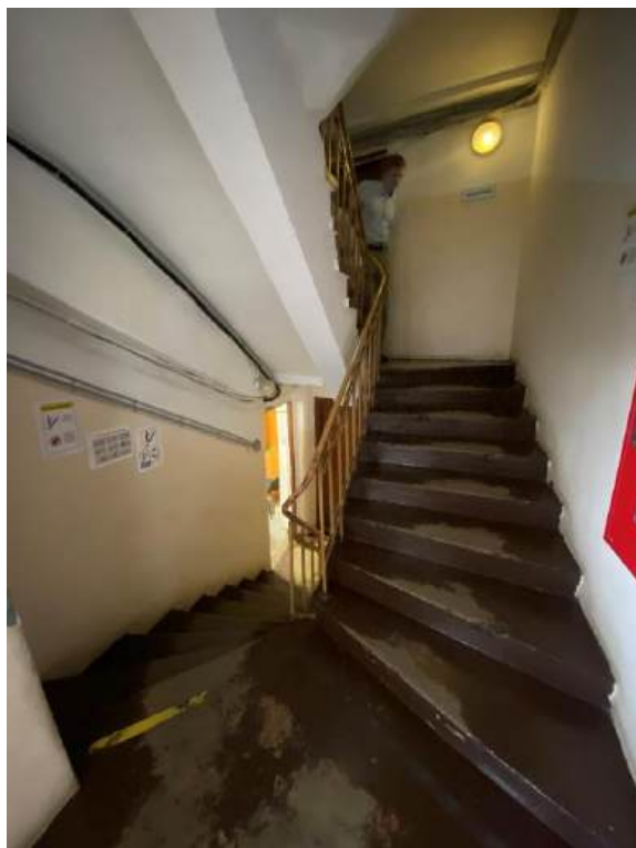
Фото 27. Лестница в восточной части здания.
