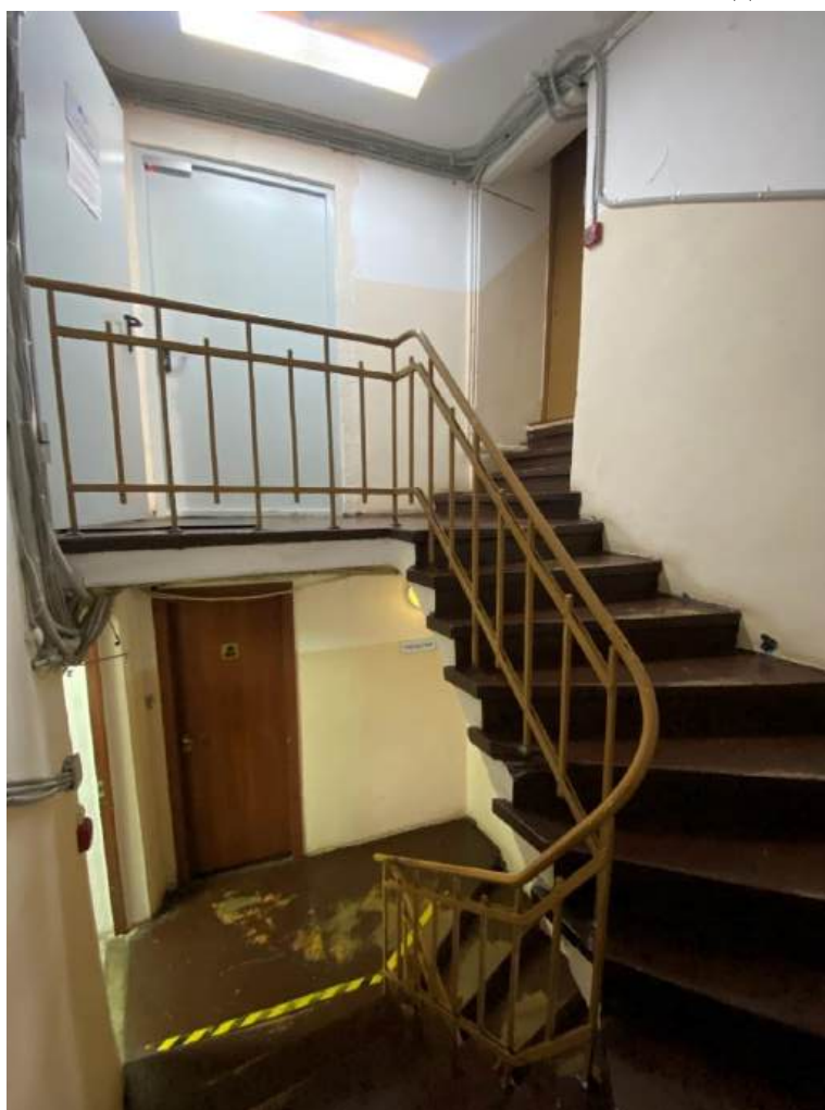
Фото 29. Лестница в восточной части здания.
