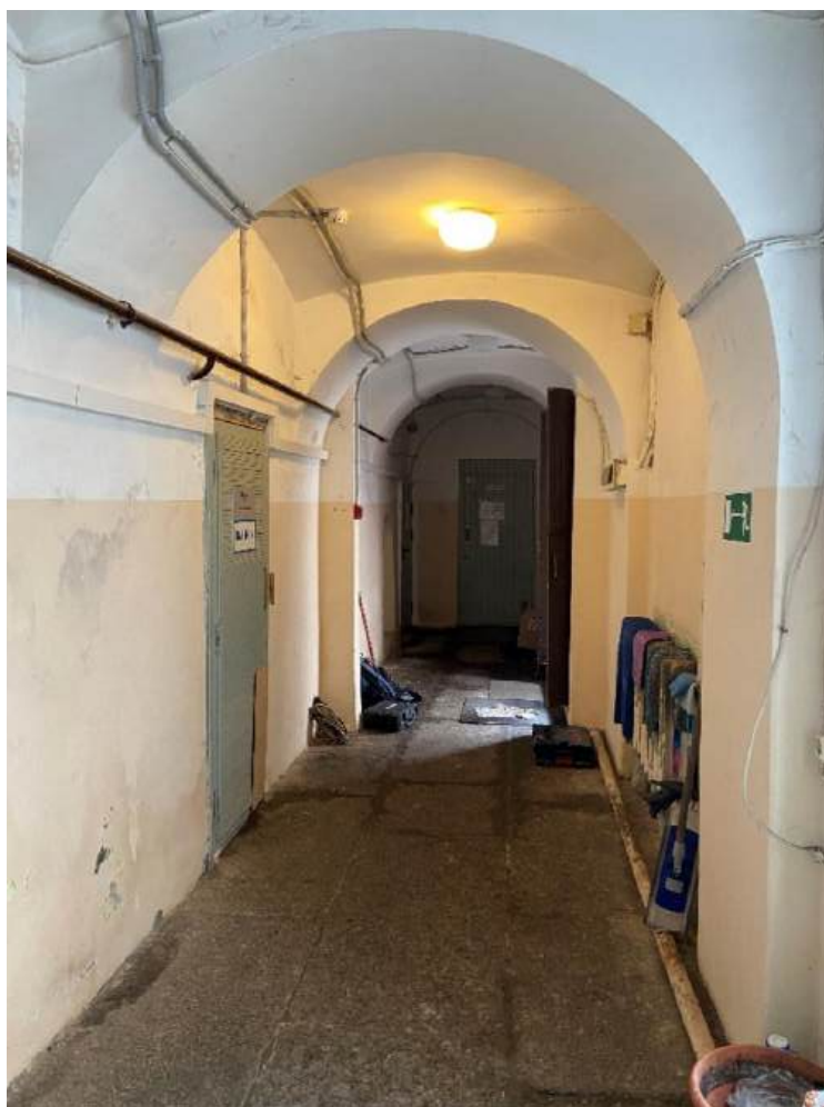
Фото 41. Коридор в уровне 1-го этажа.
