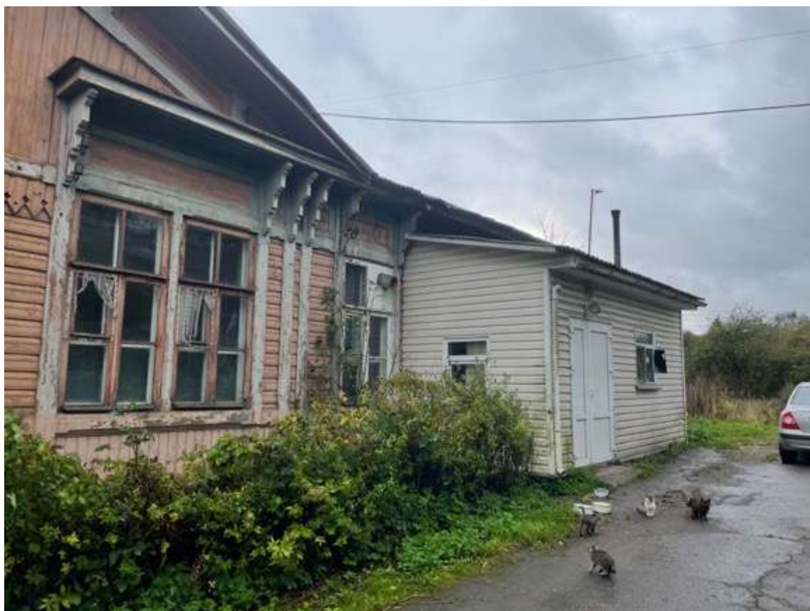
7. Фрагмент северного фасада
