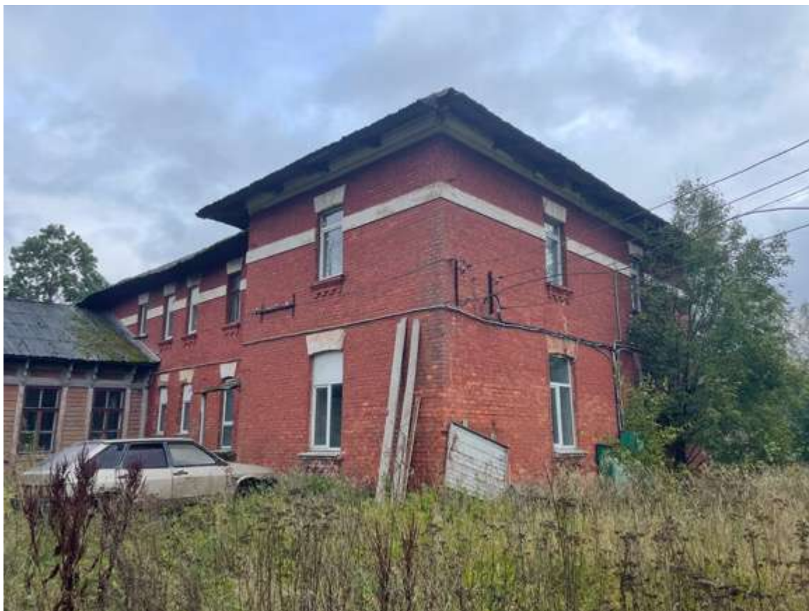
23. Вид западного фасада
