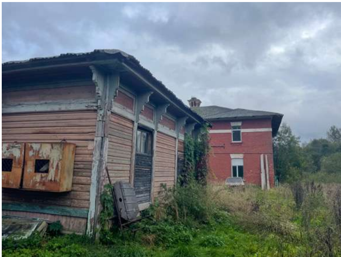
27. Вид с северо-запада
