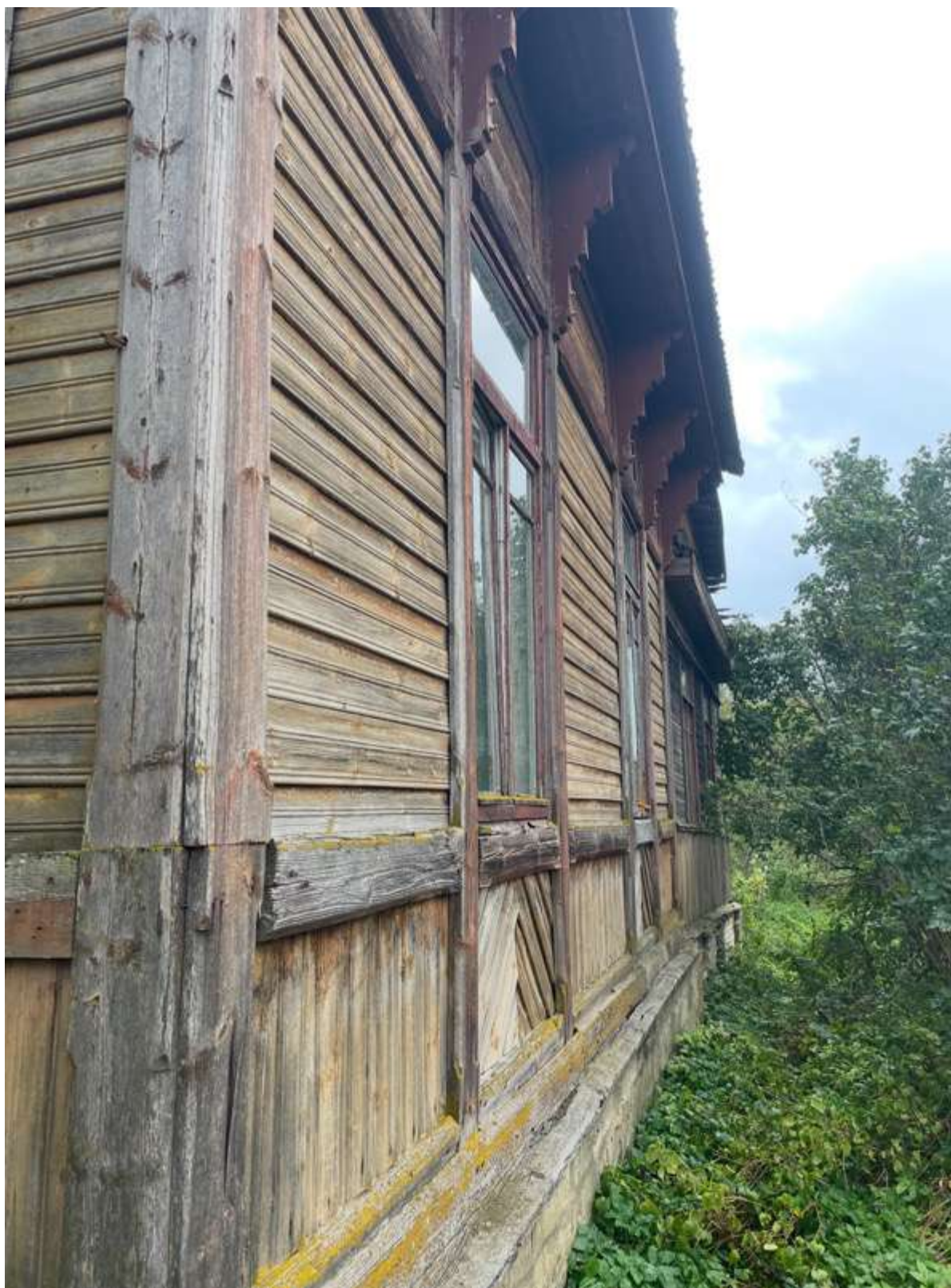
18. Вид западного фасада
