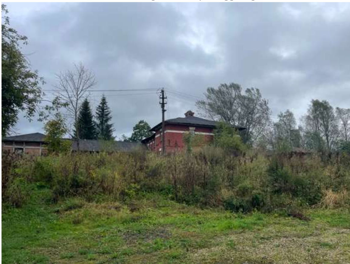
34. Вид западного фасада
