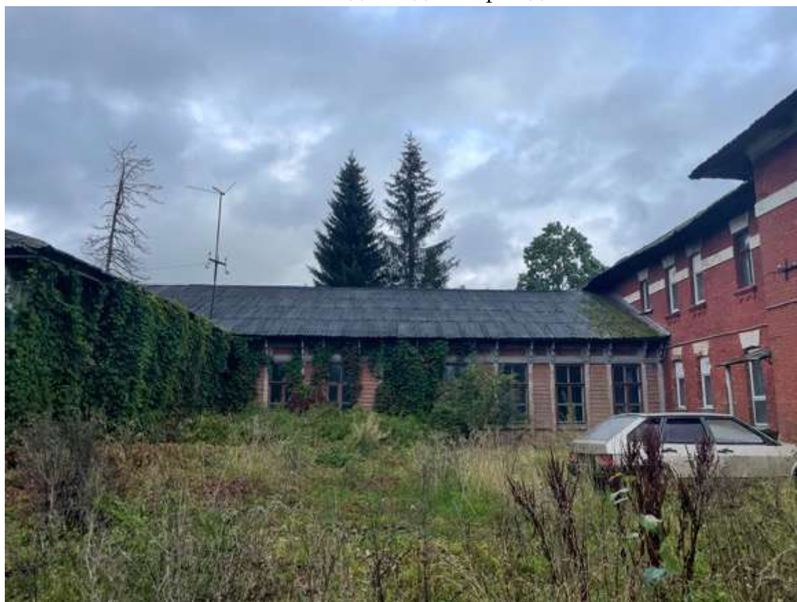
24. Вид западного фасада
