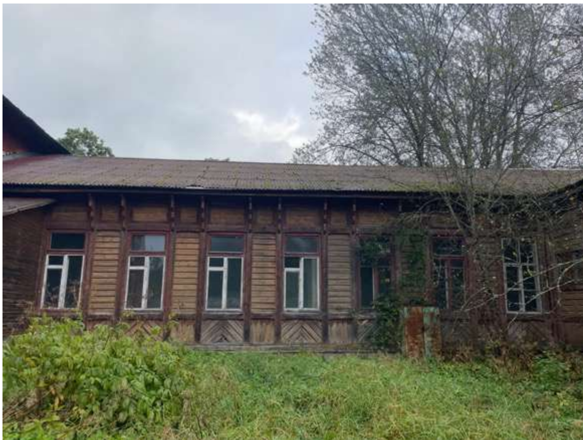
19. Вид западного фасада
