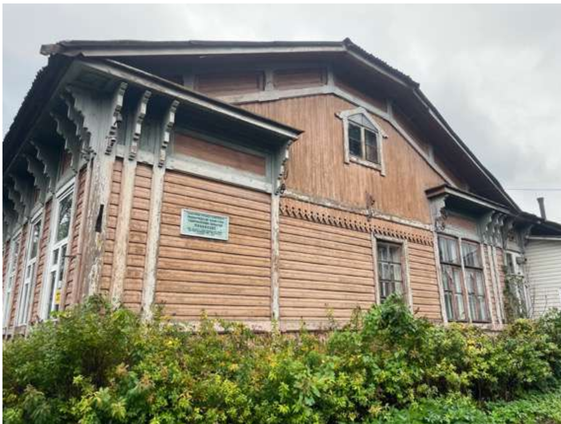
5. Фрагмент северного фасада
