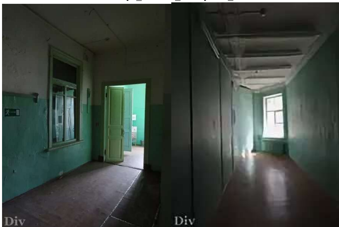
15. Зброшенная областная туберкулезная больница (Мануйлово). 2017 г. [Электронный ресурс] URL: http://hiddenside.ru/photos/industrial/lo/zabroshennaya_oblastnaya_tuberkuleznaya_bolnitsa_manuylovo_2017.htm
