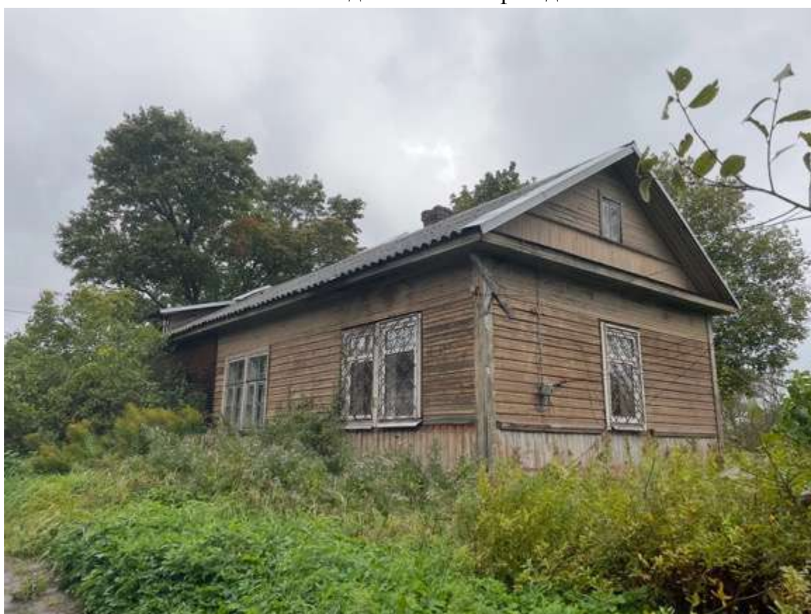
4. Вид на соседнее здание
