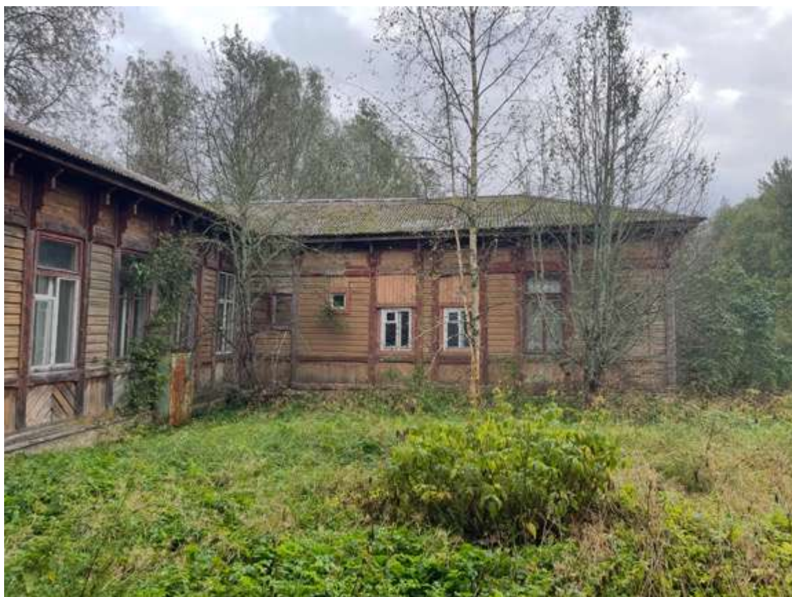
21. Вид западного фасада
