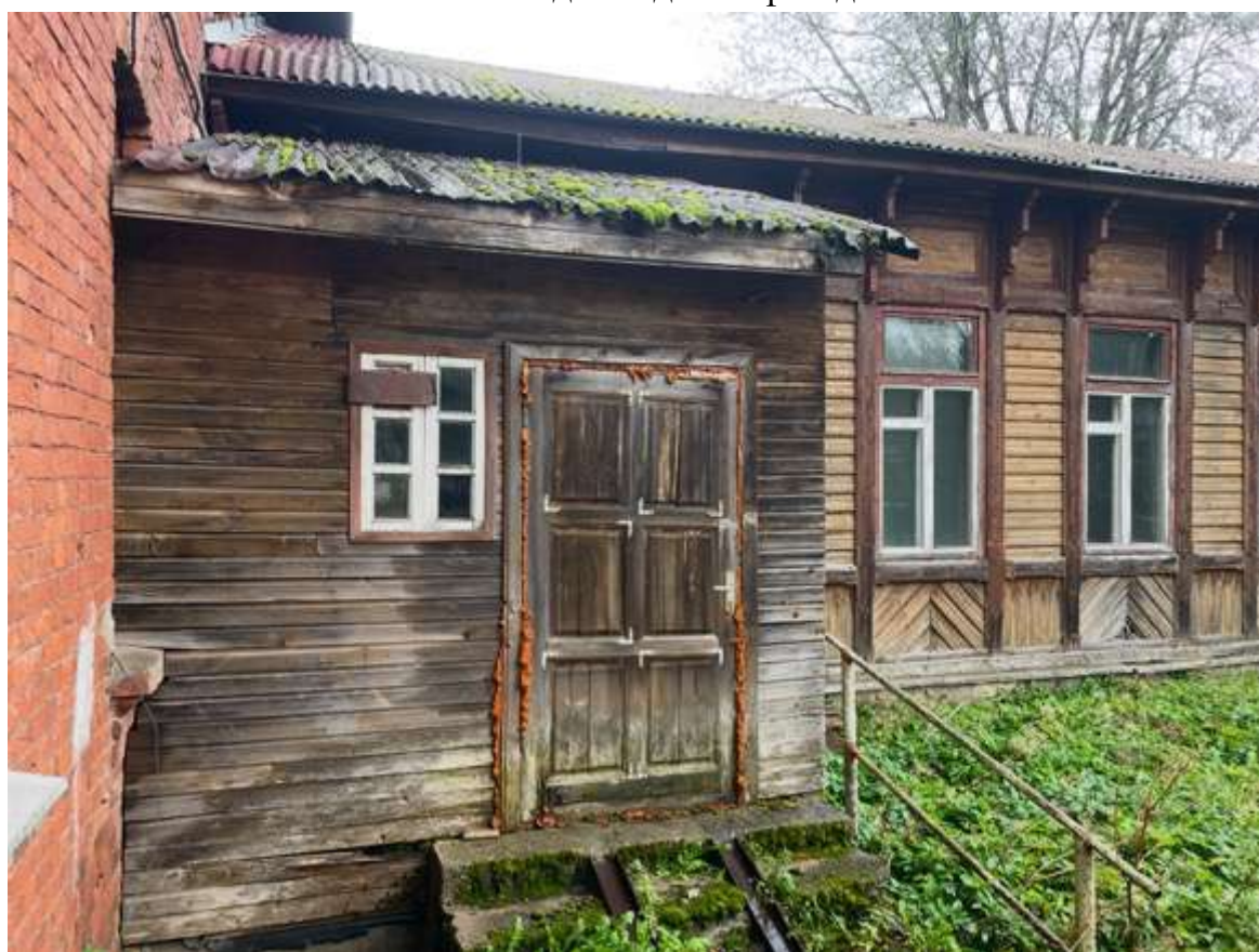
22. Вид западного фасада
