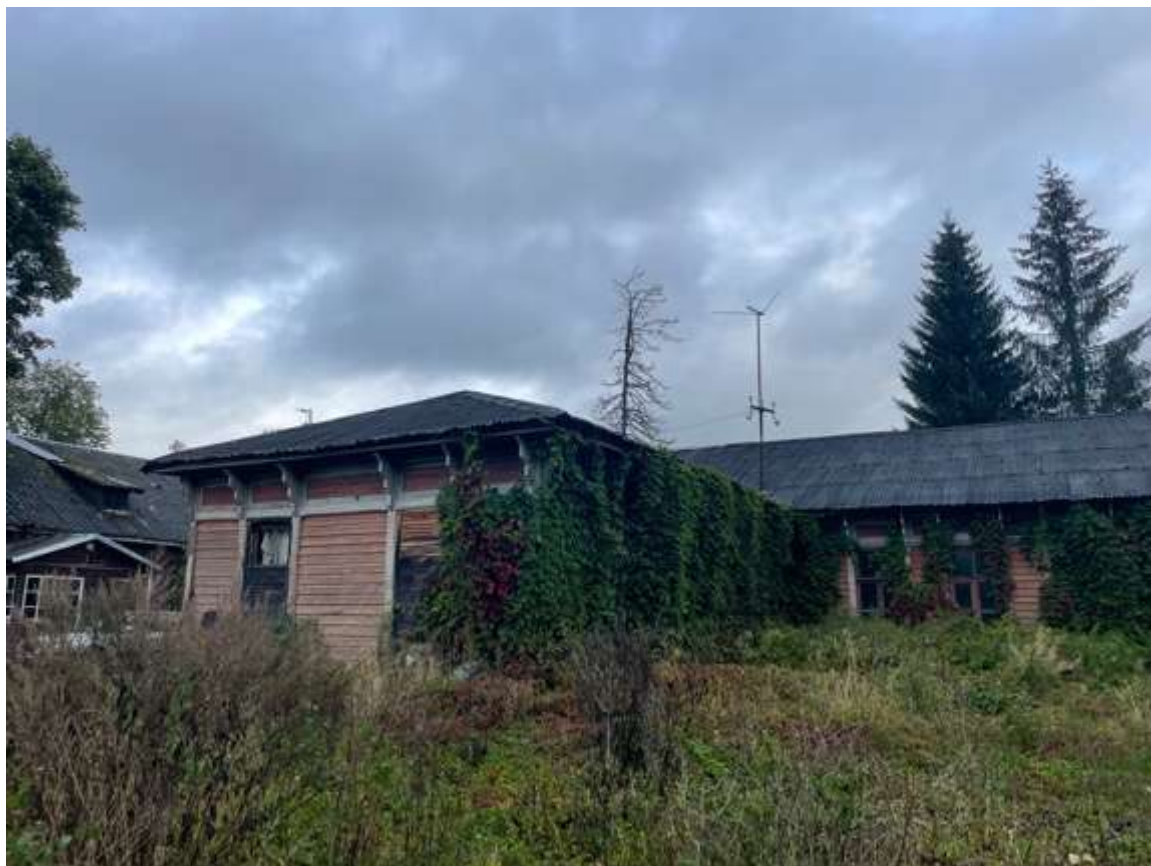
25. Вид западного фасада
