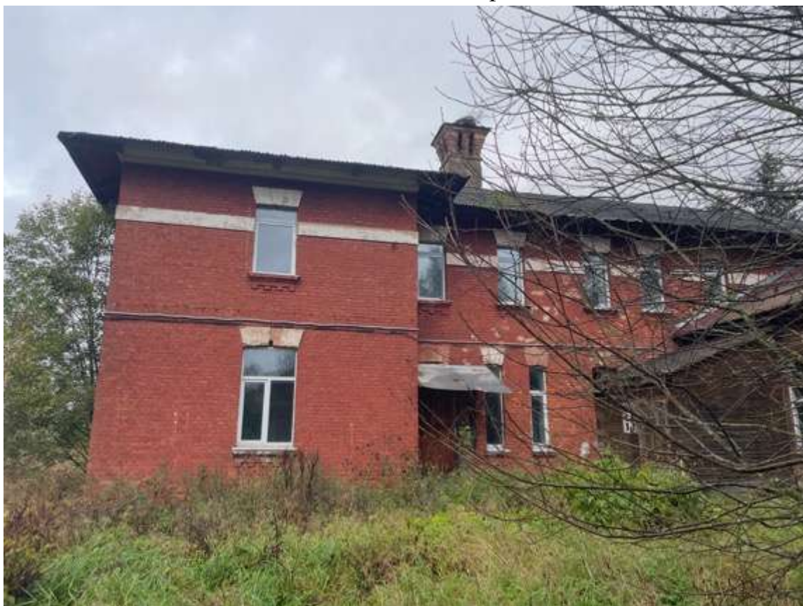
20. Вид западного фасада
