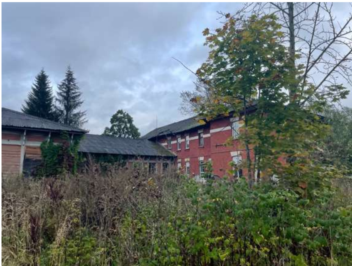
31. Вид западного фасада
