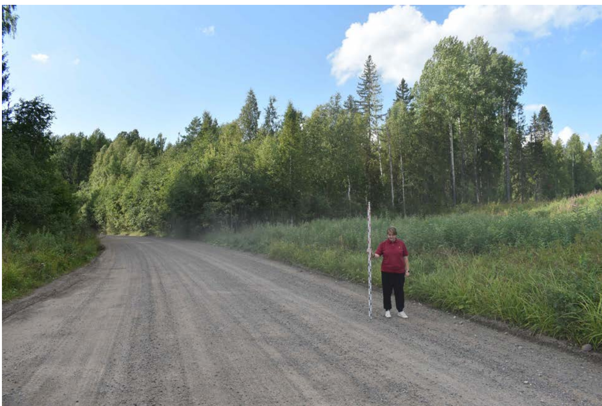
Рис. 35. Ленинградская обл., Подпорожский р-н, Токари – 2026. Точка фотофиксации-1. Вид с востока. Для масштаба использована рейка длиной 2 м.
