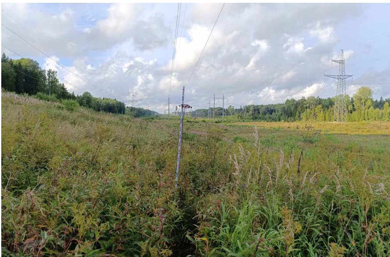
Рис. 56. Ленинградская обл., Подпорожский р-н, Токари – 2026. Точка фотофиксации-4. Вид с юга. Для масштаба использована фоторулетка длиной 2 м.
