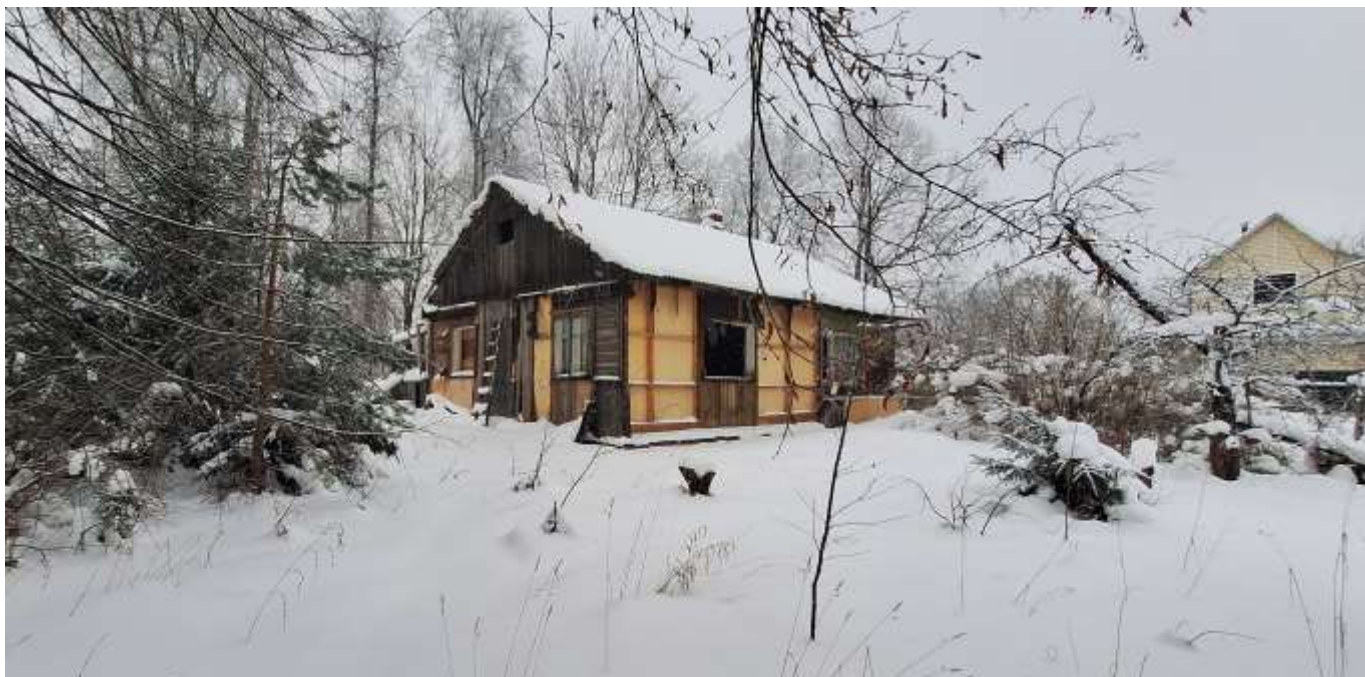
Фото 15. Общий вид на юго-западный и юго-восточный фасады одноэтажного жилого дома по адресу: Большой проспект, 1А.
