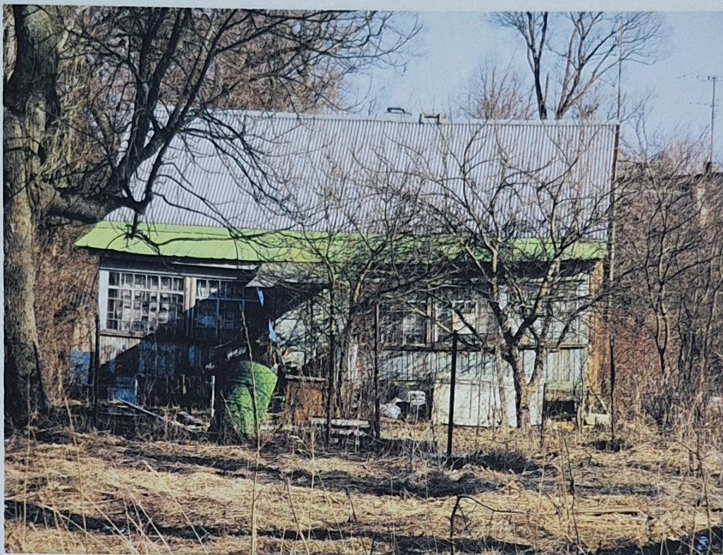
Общий вид дома со стороны Большого проспекта, с запада.
