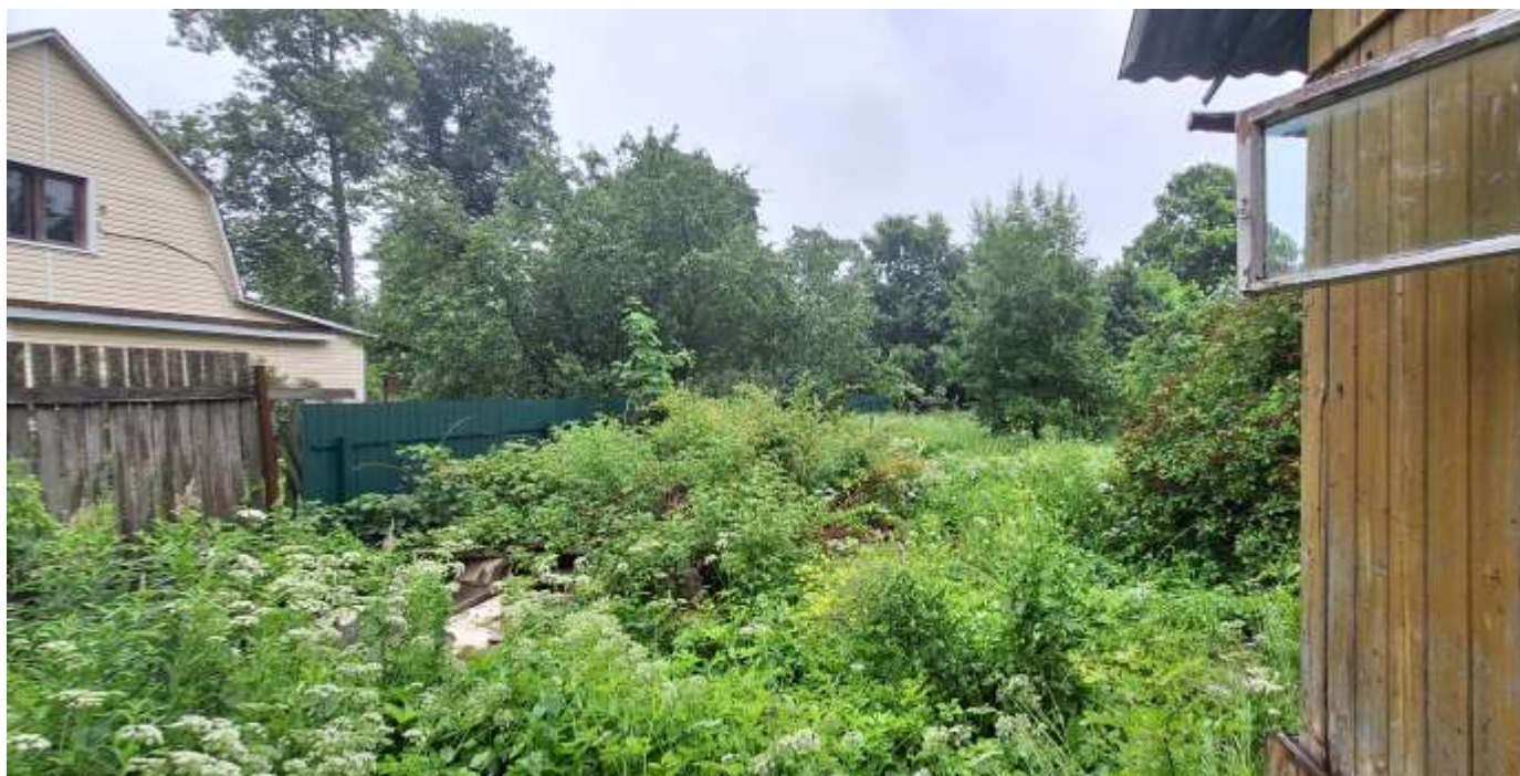
Фото 35. Общий вид на земельный участок с кадастровым номером 47:23:0905004:525 и двухэтажный жилой дом по адресу: Большой проспект, 5, в юго-восточном направлении.
