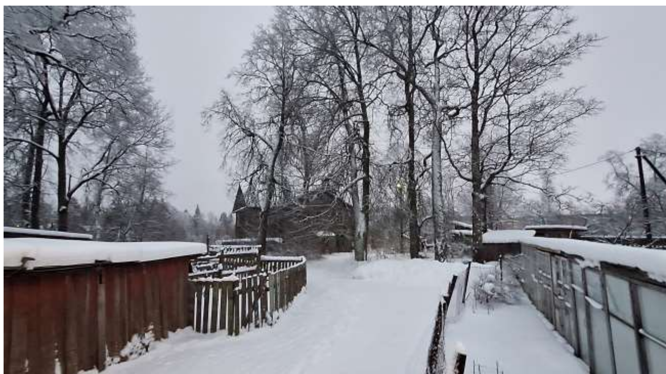
Фото 24. Общий вид на земельный участок с кадастровым номером 47:23:0905004:525, северо-восточный и юго-восточный фасады двухэтажного жилого дома по адресу: Большой проспект, 5, в южном направлении.
