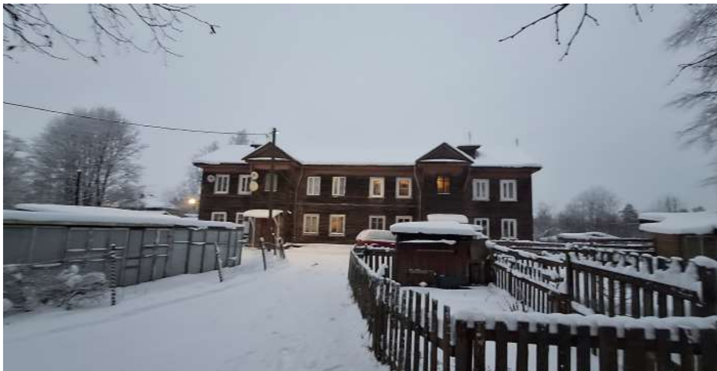
Фото 25. Общий вид на юго-западный фасад двухэтажного жилого дома по адресу: Большой проспект, 15.
