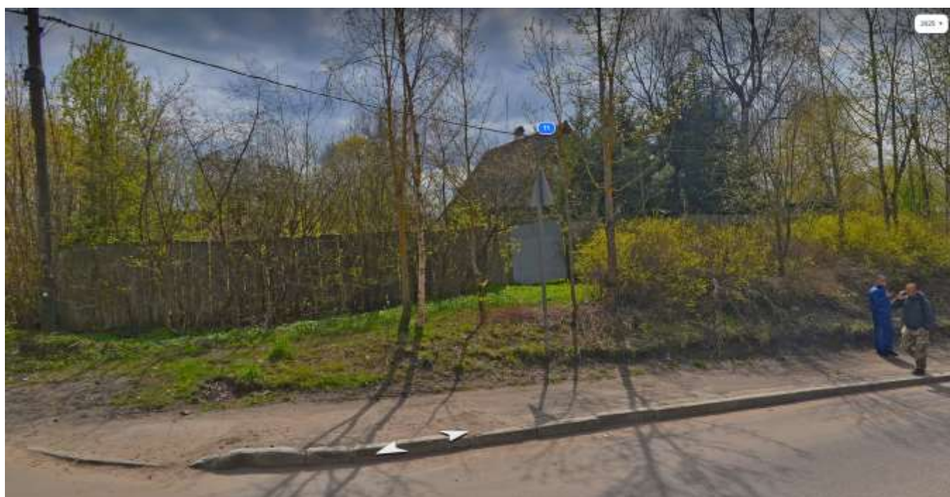
Рис. 37. Фотография. Вид на одноэтажный жилой дом по адресу: д. Старосиверская, Большой проспект, 9, в южном направлении, на Яндекс-панораме. 2025 г. 37
