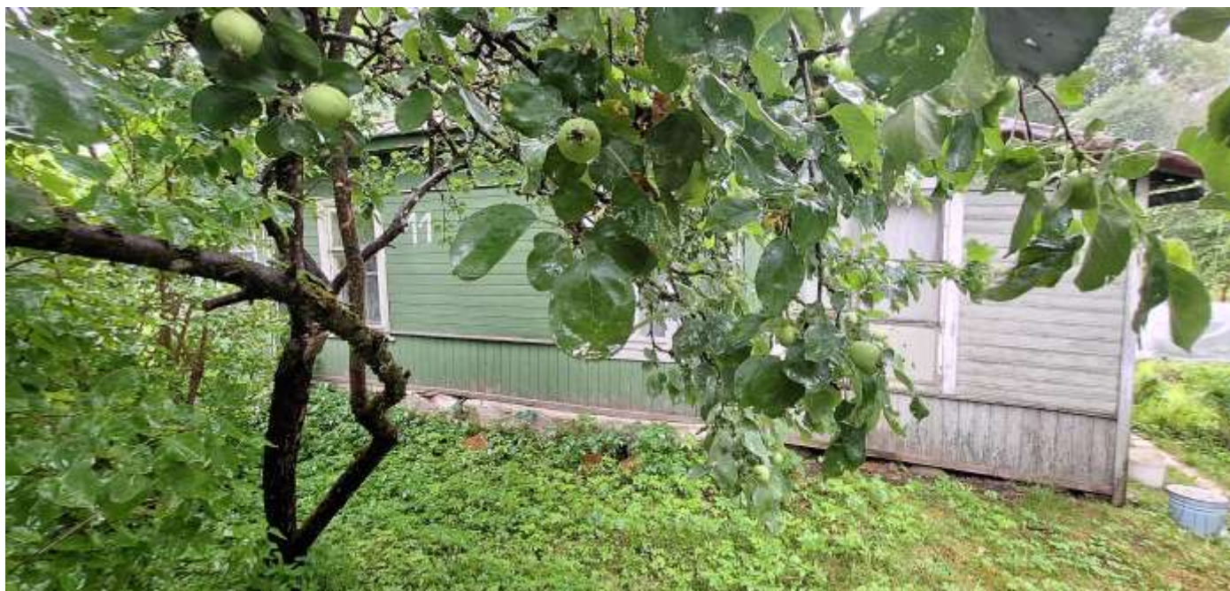
Фото 41. Общий вид на северо-восточный фасад одноэтажного жилого дома по адресу: Большой проспект, 11.
