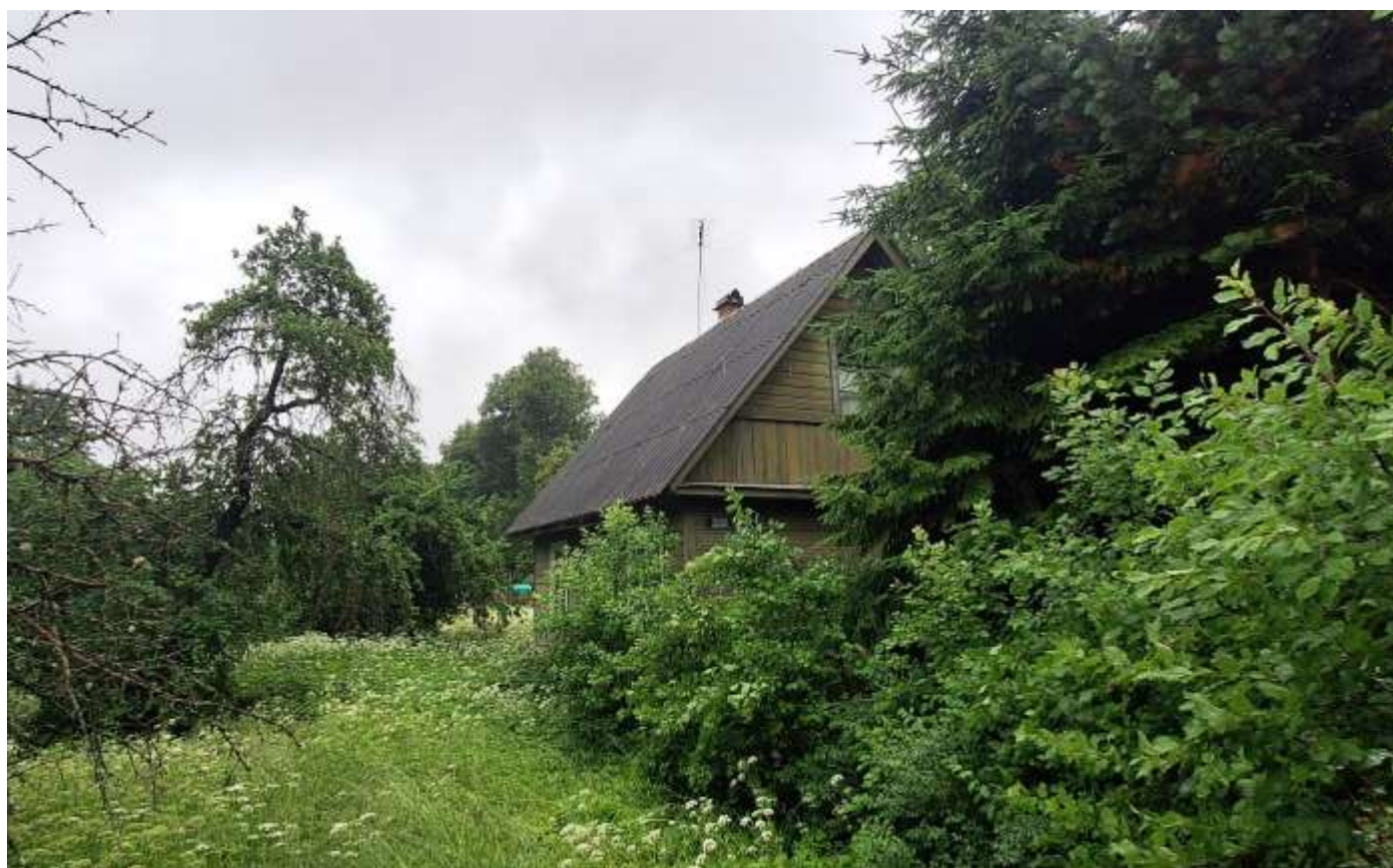
Фото 30. Общий вид на северо-восточный и северо-западный фасады одноэтажного жилого дома по адресу: Большой проспект, 9.
