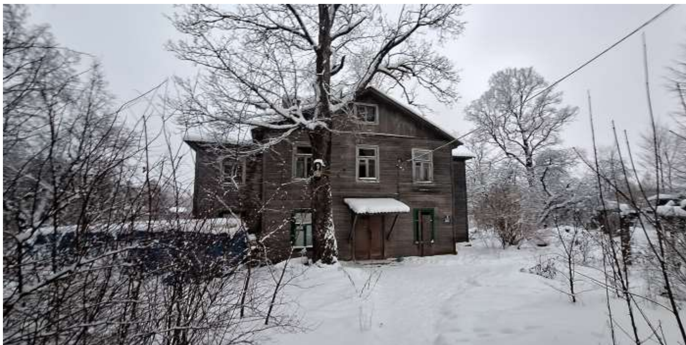
Фото 18. Общий вид на земельный участок с кадастровым номером 47:23:0905004:525 и северо-восточный фасад двухэтажного жилого дома по адресу: Большой проспект, 5.
