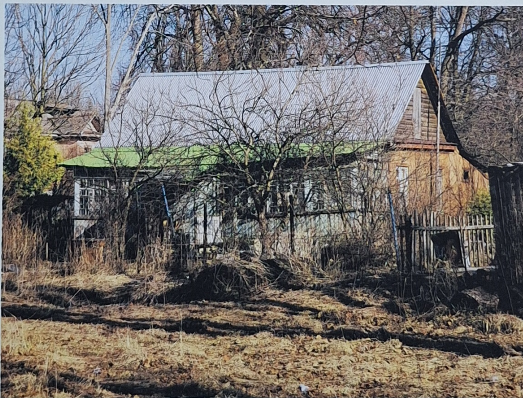
Общий вид дома со стороны Большого проспекта, с юго-запада.
