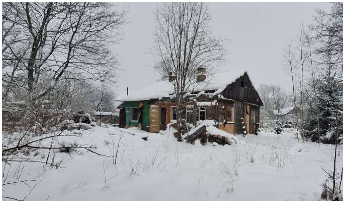
Фото 14. Общий вид на северо-западный и юго-западный фасады одноэтажного жилого дома по адресу: Большой проспект, 1А.
