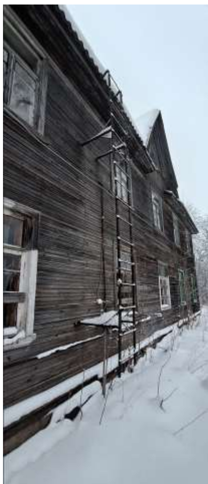
Фото 20. Фрагмент юго-западного фасада двухэтажного жилого дома по адресу: Большой проспект, 5.
