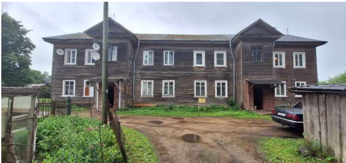
Фото 39. Общий вид на юго-западный фасад двухэтажного жилого дома по адресу: Большой проспект, 15.
