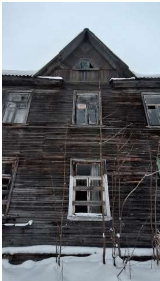
Фото 21. Фрагмент юго-западного фасада двухэтажного жилого дома по адресу: Большой проспект, 5.
