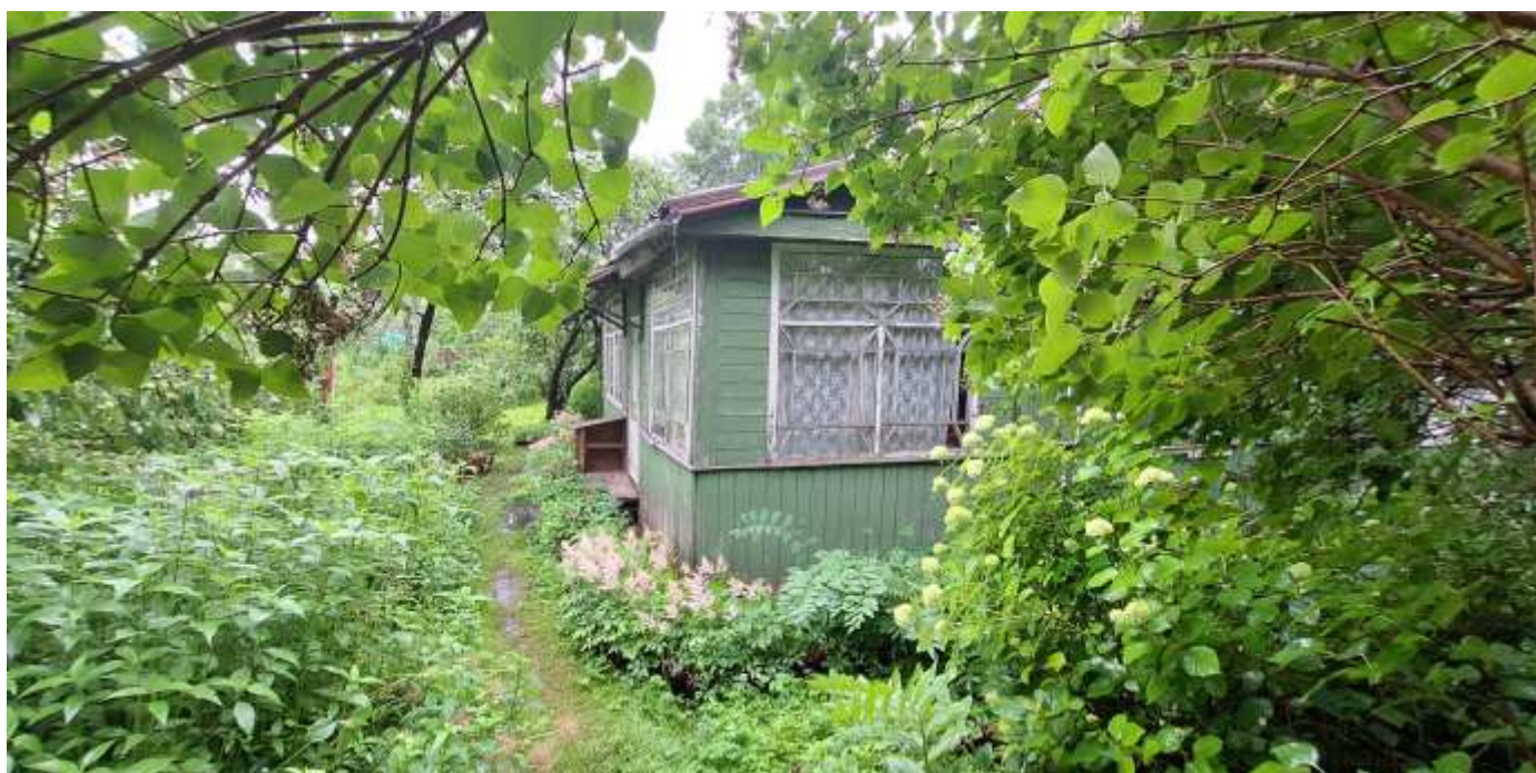
Фото 40. Общий вид на юго-восточный и северо-восточный фасады одноэтажного жилого дома по адресу: Большой проспект, 11.
