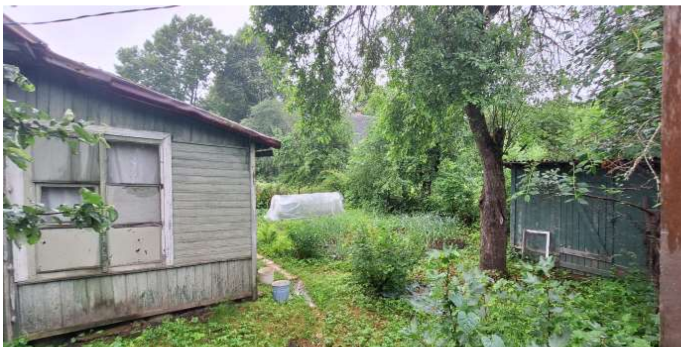
Фото 42. Фрагмент северо-восточного фасада одноэтажного жилого дома по адресу: Большой проспект, 11. На втором плане – фрагмент крыши одноэтажного жилого дома по адресу: Большой проспект, 9.
