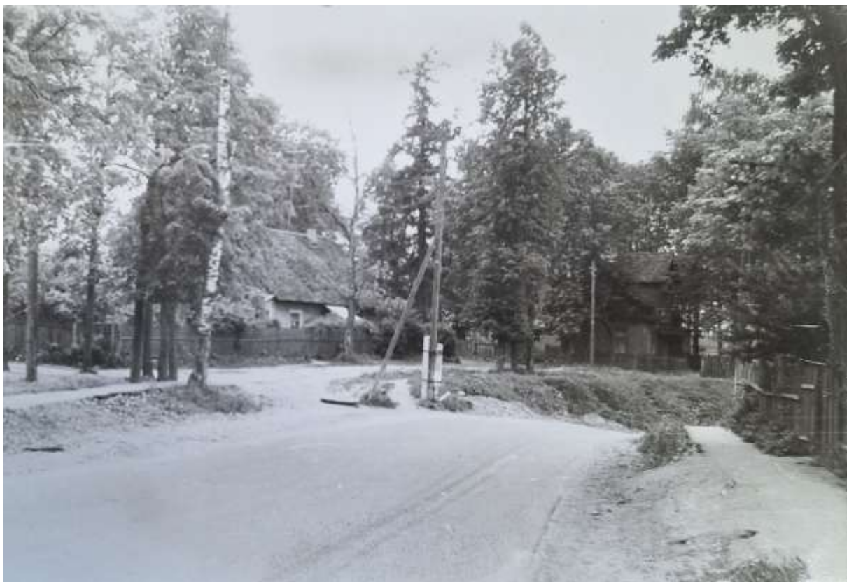
Рис. 26. Фотография. Дача поэта А.Н. Плещеева. Начало Большого проспекта Старо-Сиверский. Слева – «дача Плещеева», справа – дом «№ 1». пос. Старо-Сиверская, Большой проспект, № 9. Автор Ефимов. Июнь 1971 г. 26
