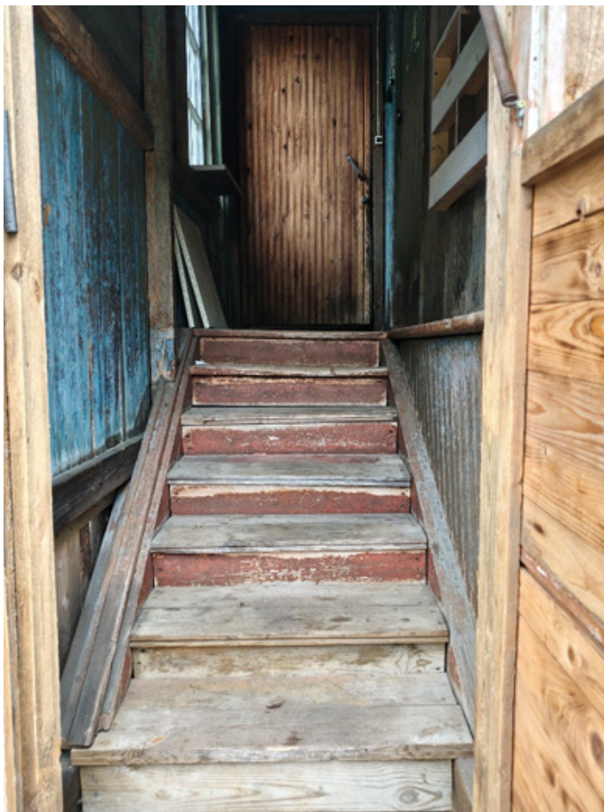
Фото 12. Входное крыльцо с востока (кв. 4).
