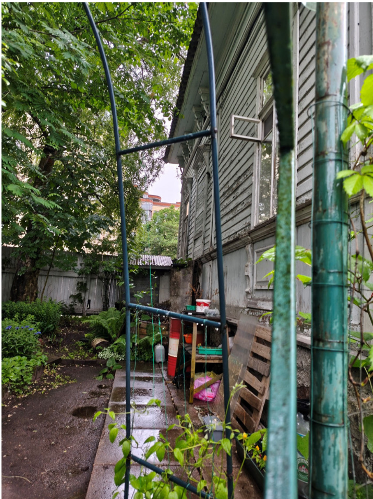
Фото 11. Вид вдоль восточного фасада.
