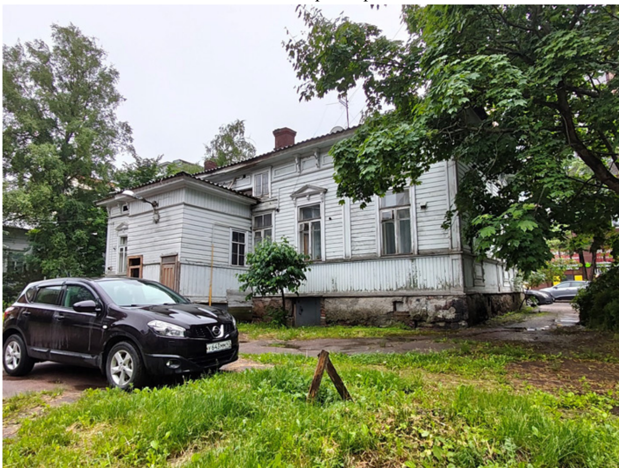
Фото 6. Вид с севера.
