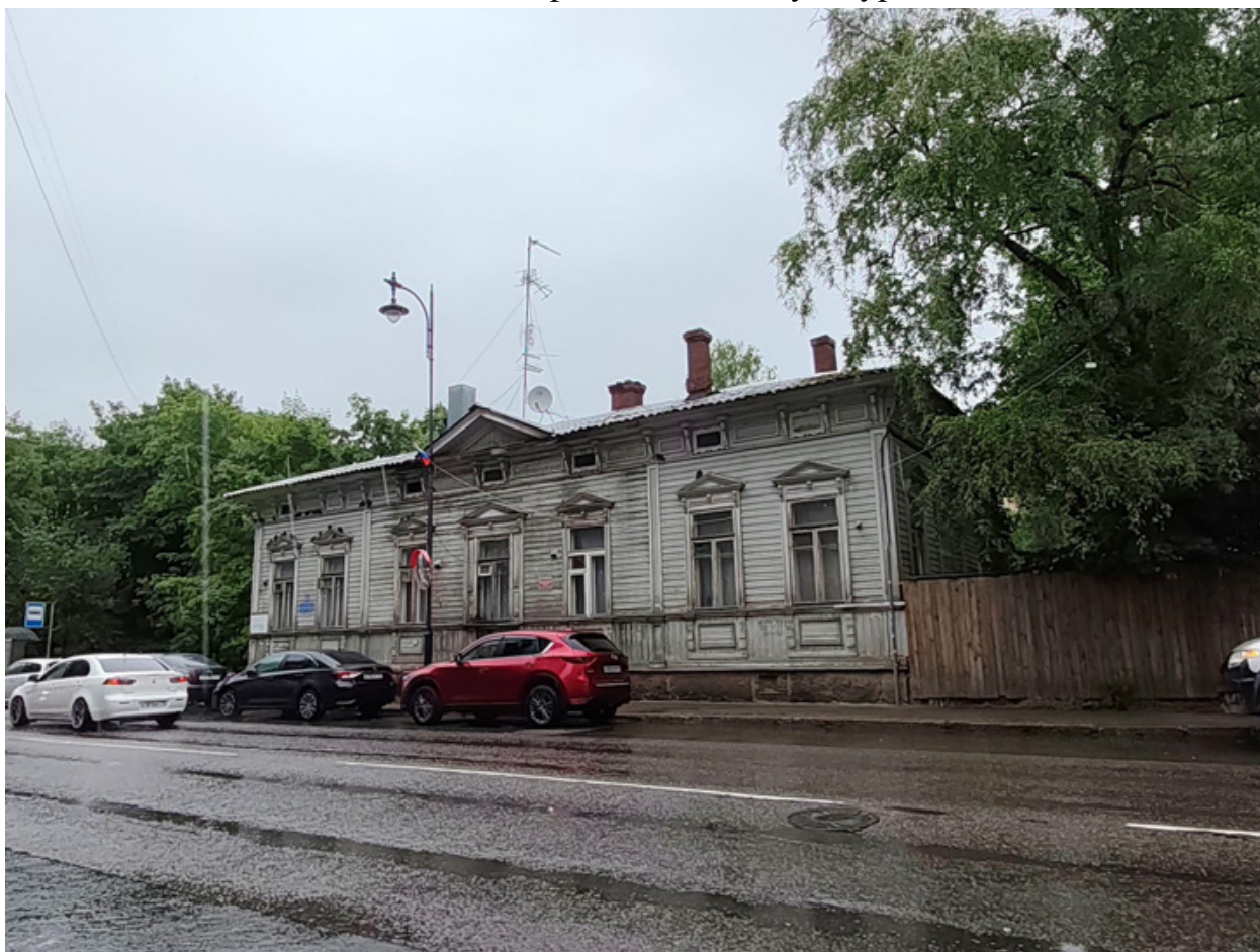
Фото 2. Общий вид объекта с юга.
