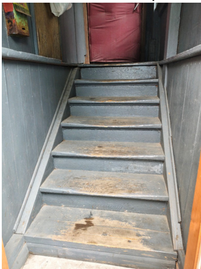
Фото 15. Входное крыльцо с запада (кв. 3).
