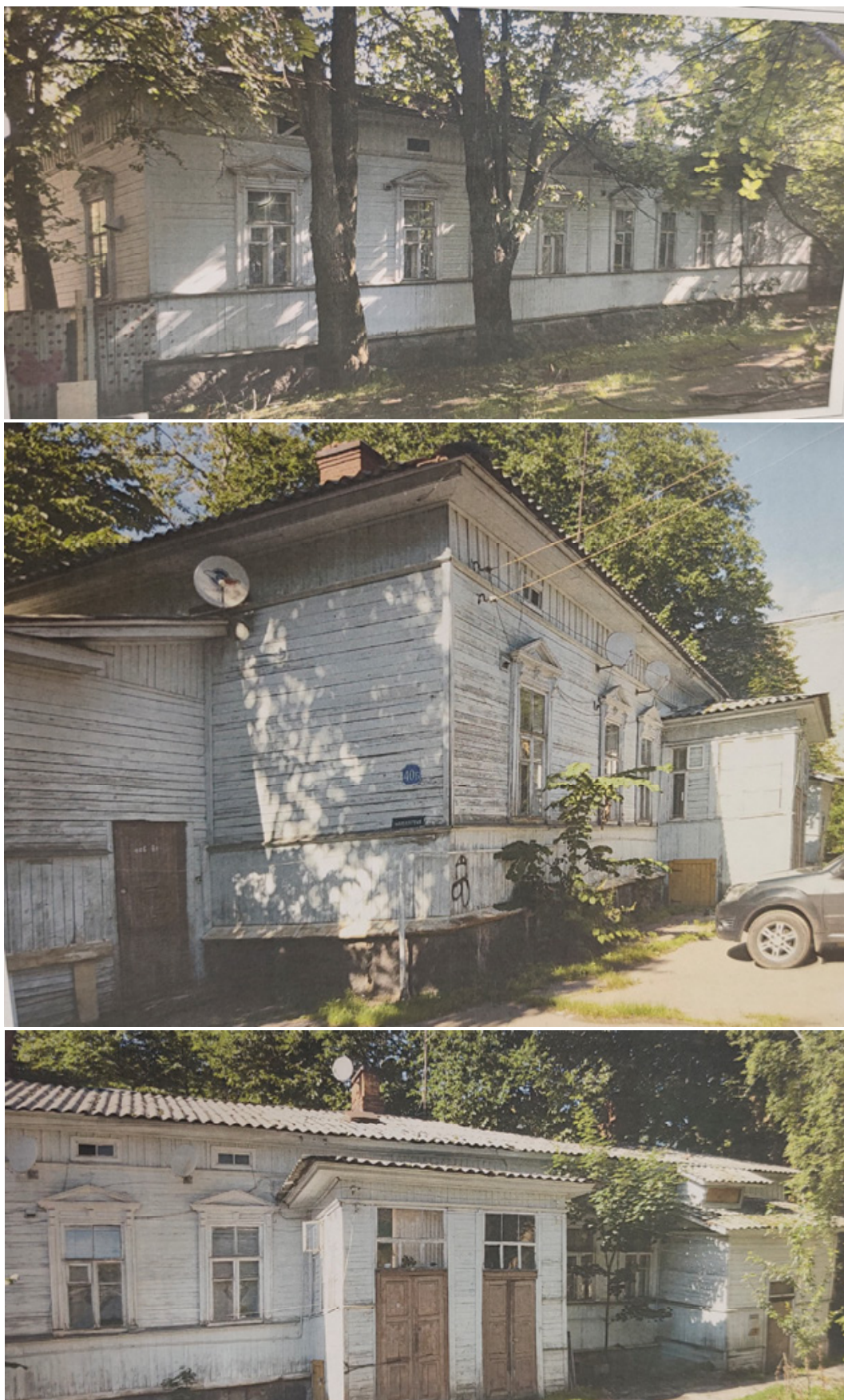
Илл. 71. Дом 406. Фотофиксация из Акта по результатам ГИКЭ выявленного объекта культурного наследия «Усадьба городская». ООО «ТемплГрупп». Архив Комитета по сохранению культурного наследия Ленинградской области. Оп. 14665. Д. 2137-1 (рег. № 01-10-35/2017 от 22.09.2017).
