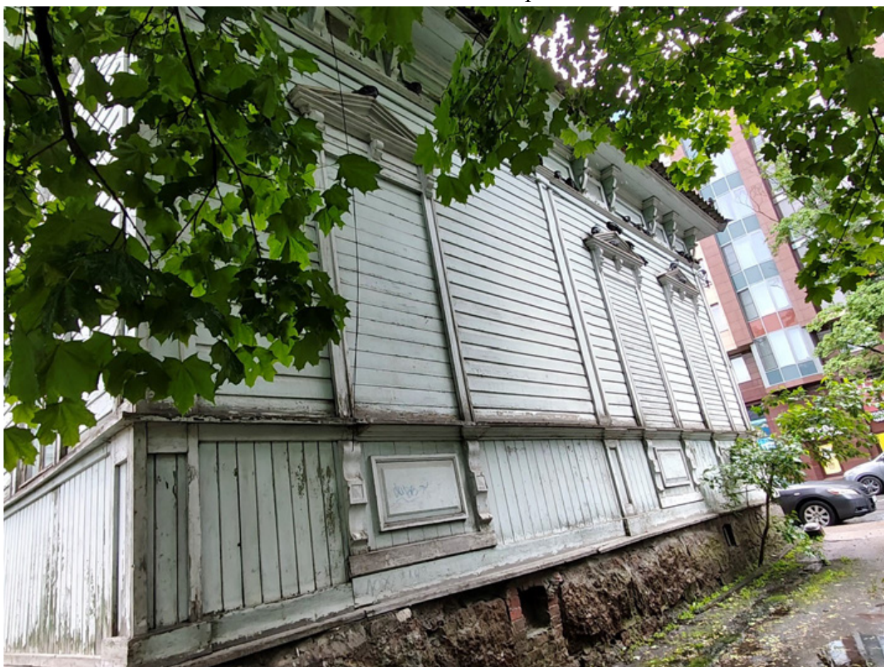
Фото 8. Вид вдоль западного фасада.
