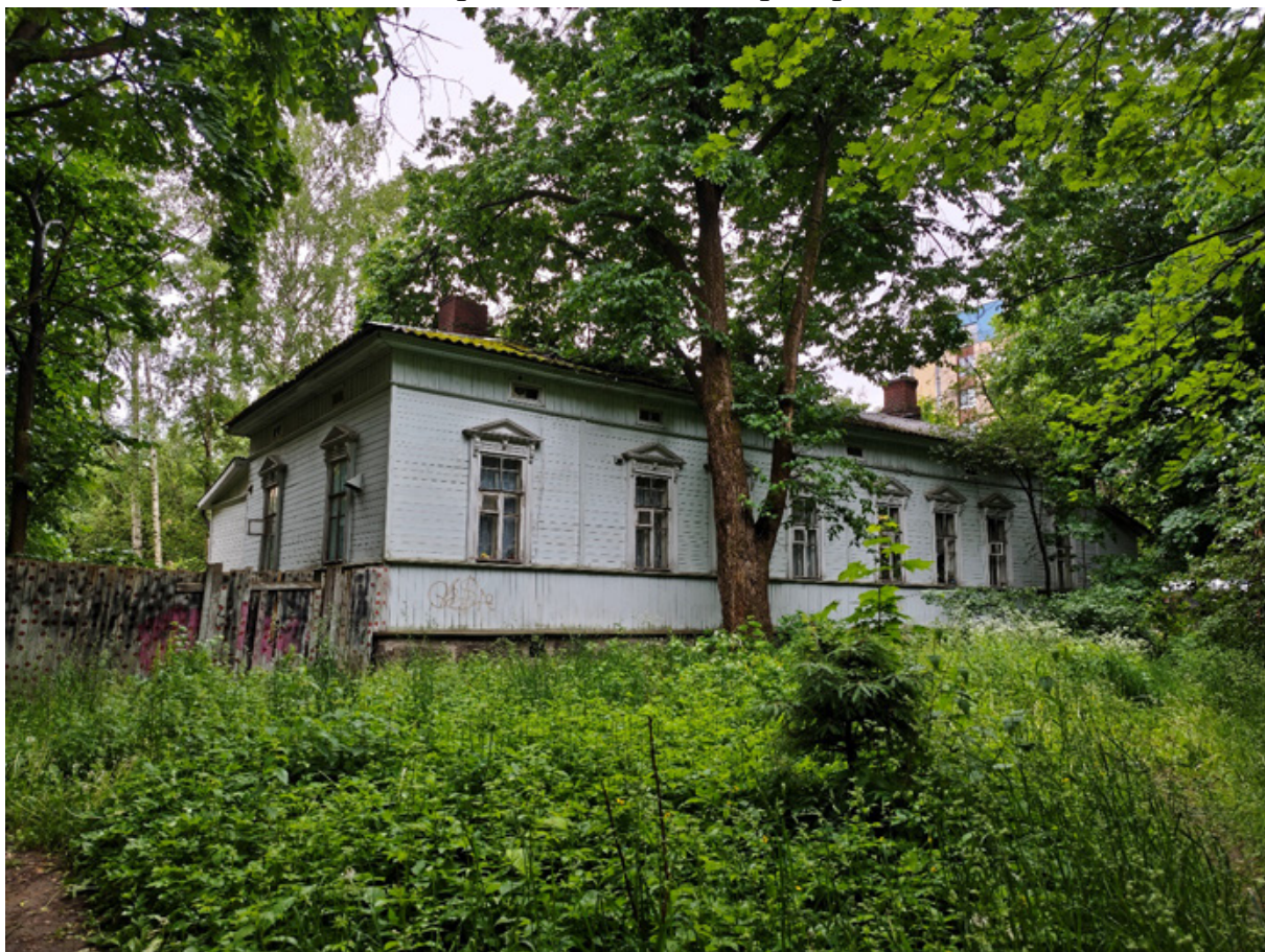
Фото 10. Общий вид объекта с севера.
