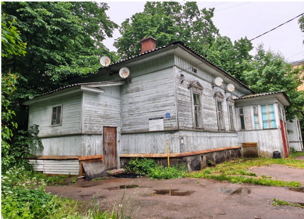
Фото 1. Общий вид объекта культурного наследия с юга.
