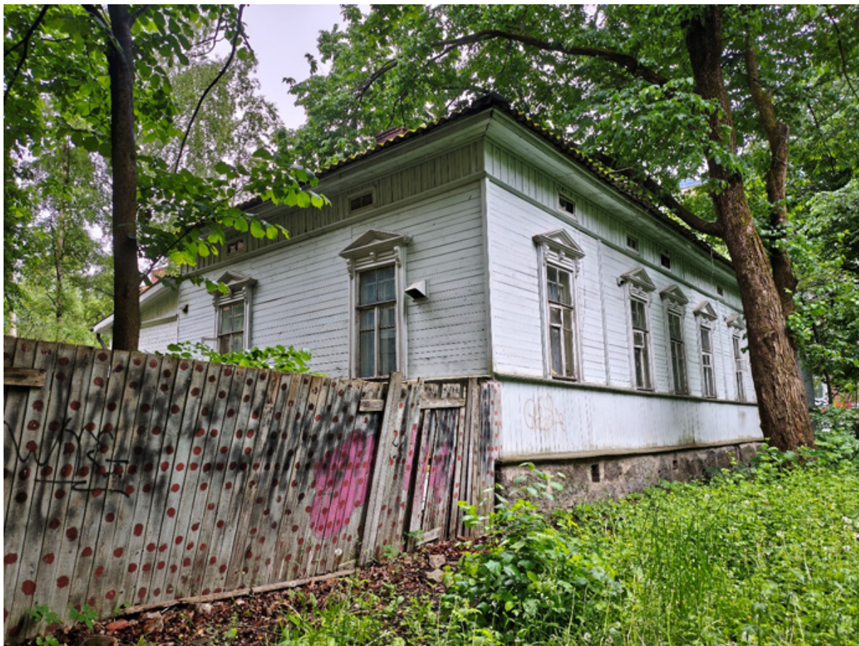
Фото 13. Вид вдоль западного фасада.
