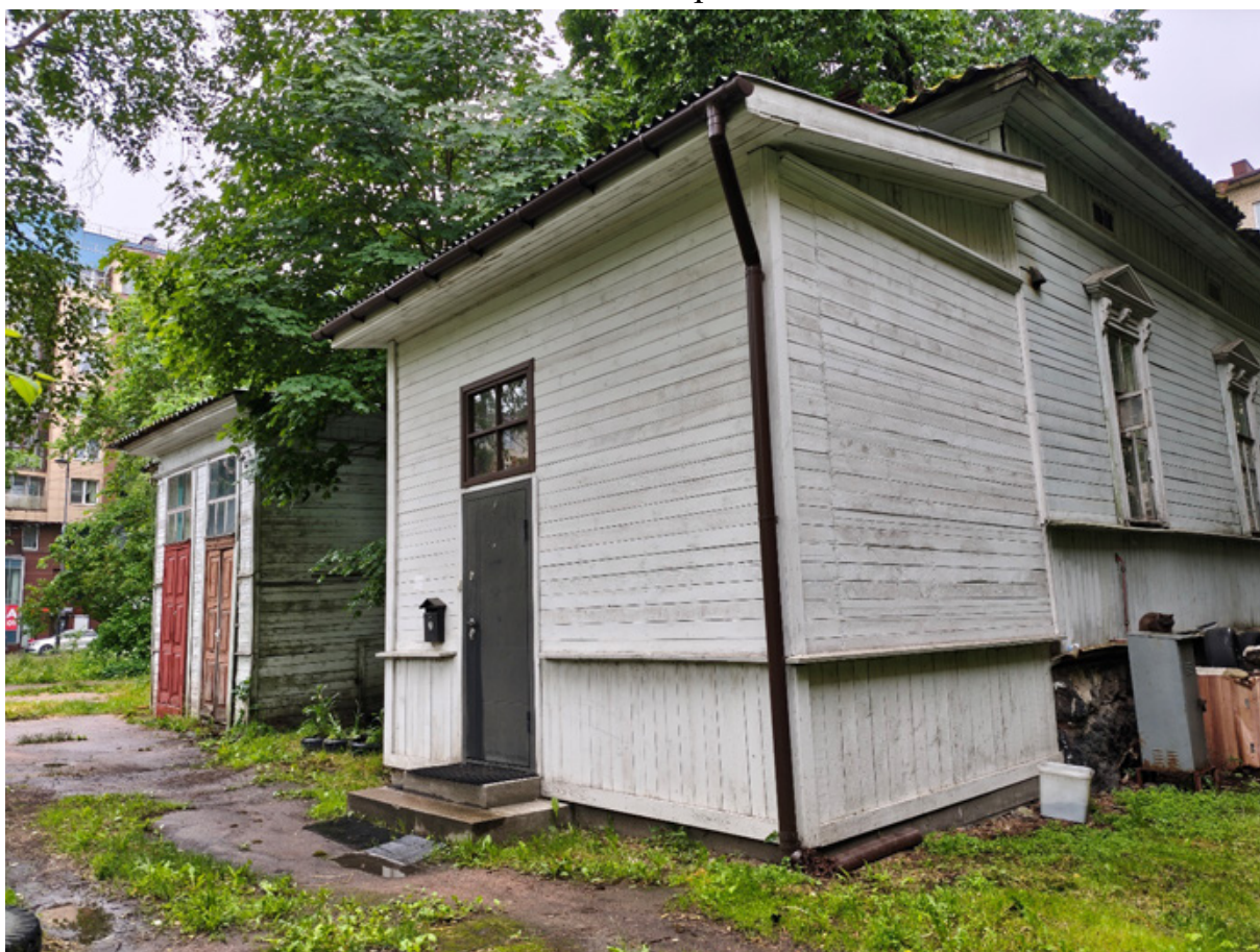
Фото 6. Вид пристроек со стороны восточного фасада.
