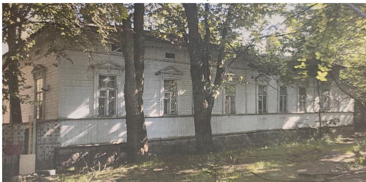
Илл. 68. Западный фасад дом 40б. Фотофиксация из Акта по результатам ГИКЭ выявленного объекта культурного наследия «Усадьба городская». ООО «ТемплГрупп». Архив Комитета по сохранению культурного наследия Ленинградской области. Оп. 14665. Д. 2137-1 (рег. № 01-10-35/2017 от 22.09.2017).
