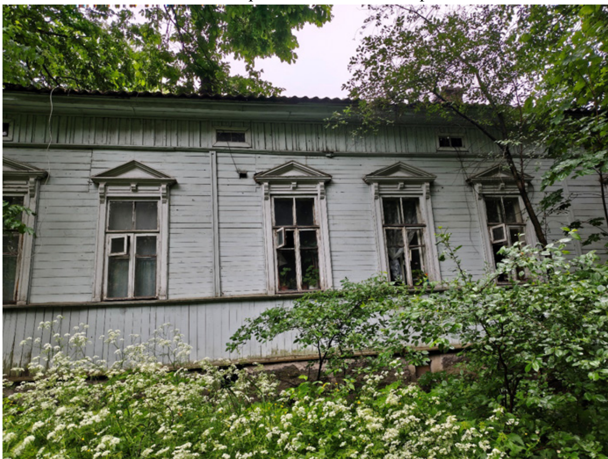
Фото 12. Центральная часть западного фасада.
