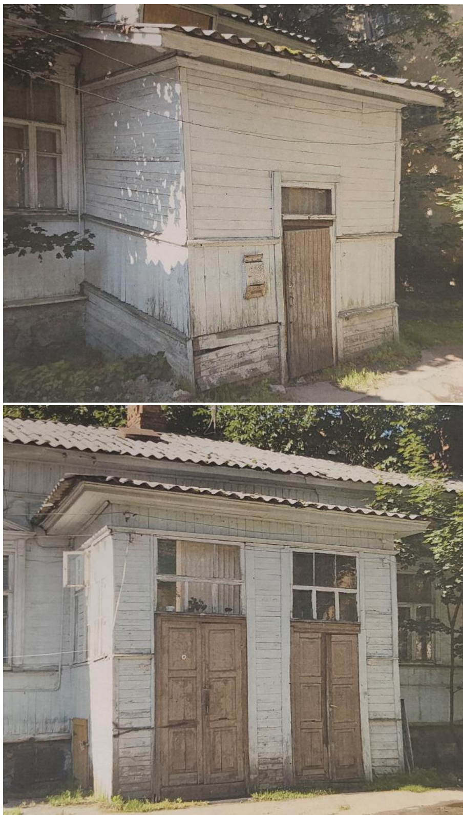
Илл. 71. Восточные пристройки дома 406. Фотофиксация из Акта по результатам ГИКЭ выявленного объекта культурного наследия «Усадьба городская». ООО «ТемплГрупп». Архив Комитета по сохранению культурного наследия Ленинградской области. Оп. 14665. Д. 2137-1 (рег. № 01-10-35/2017 от 22.09.2017).
