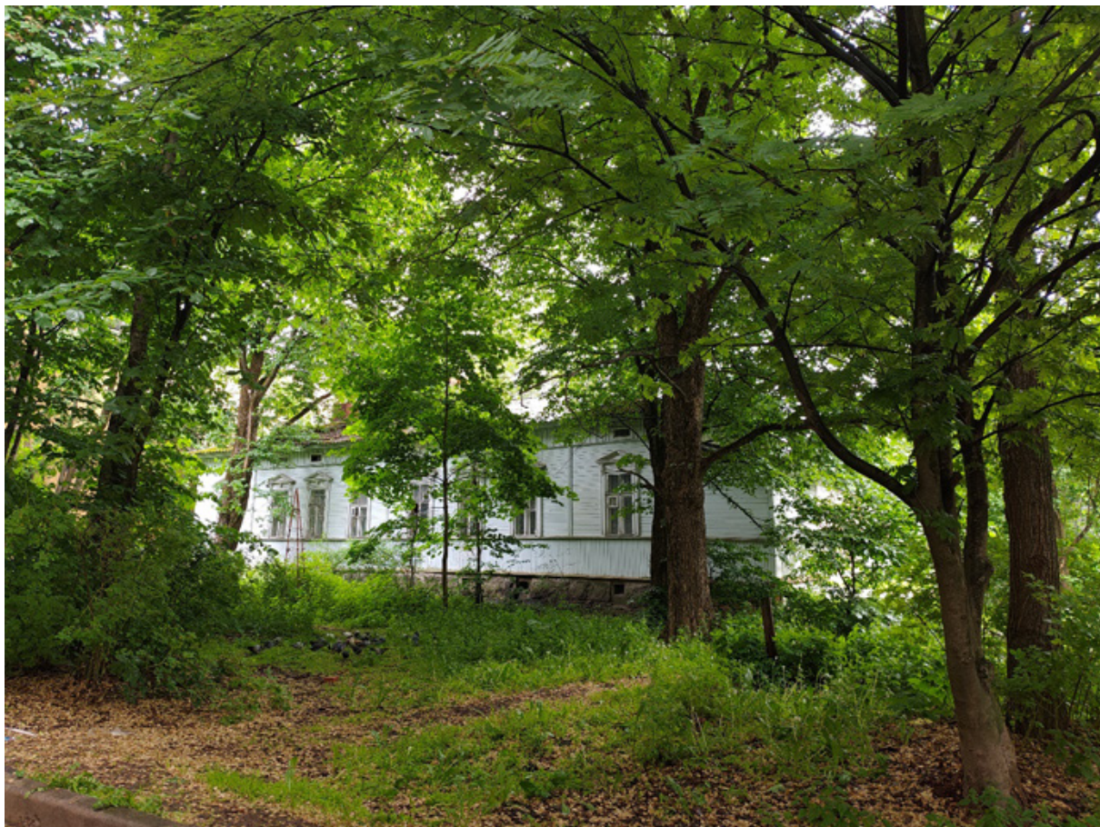
Фото 3. Общий вид с запада.
