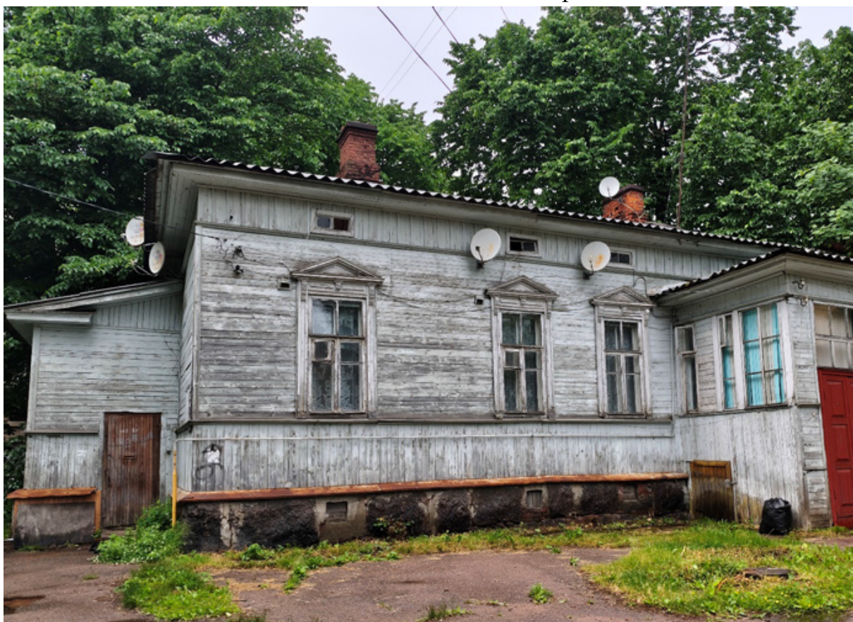
Фото 14. Южный фрагмент восточного фасада.
