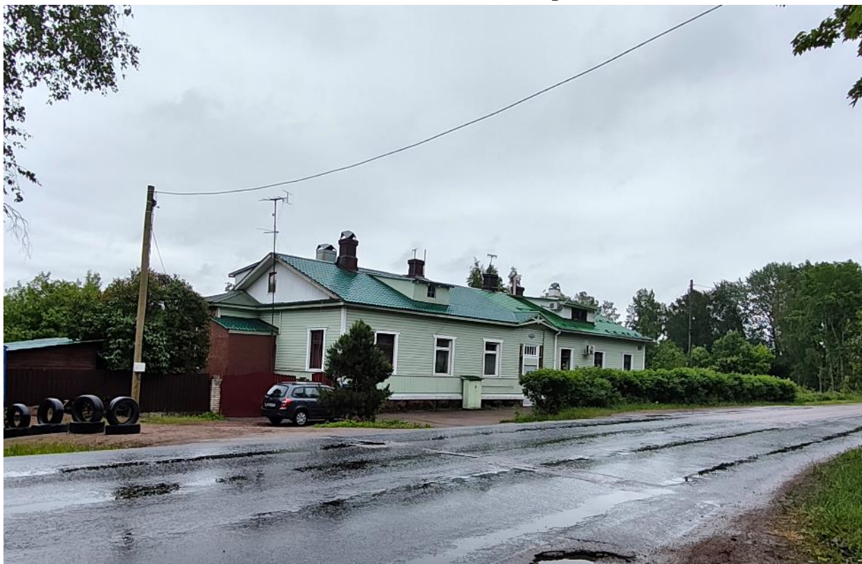
Фото 4. Общий вид с северо-запада.
