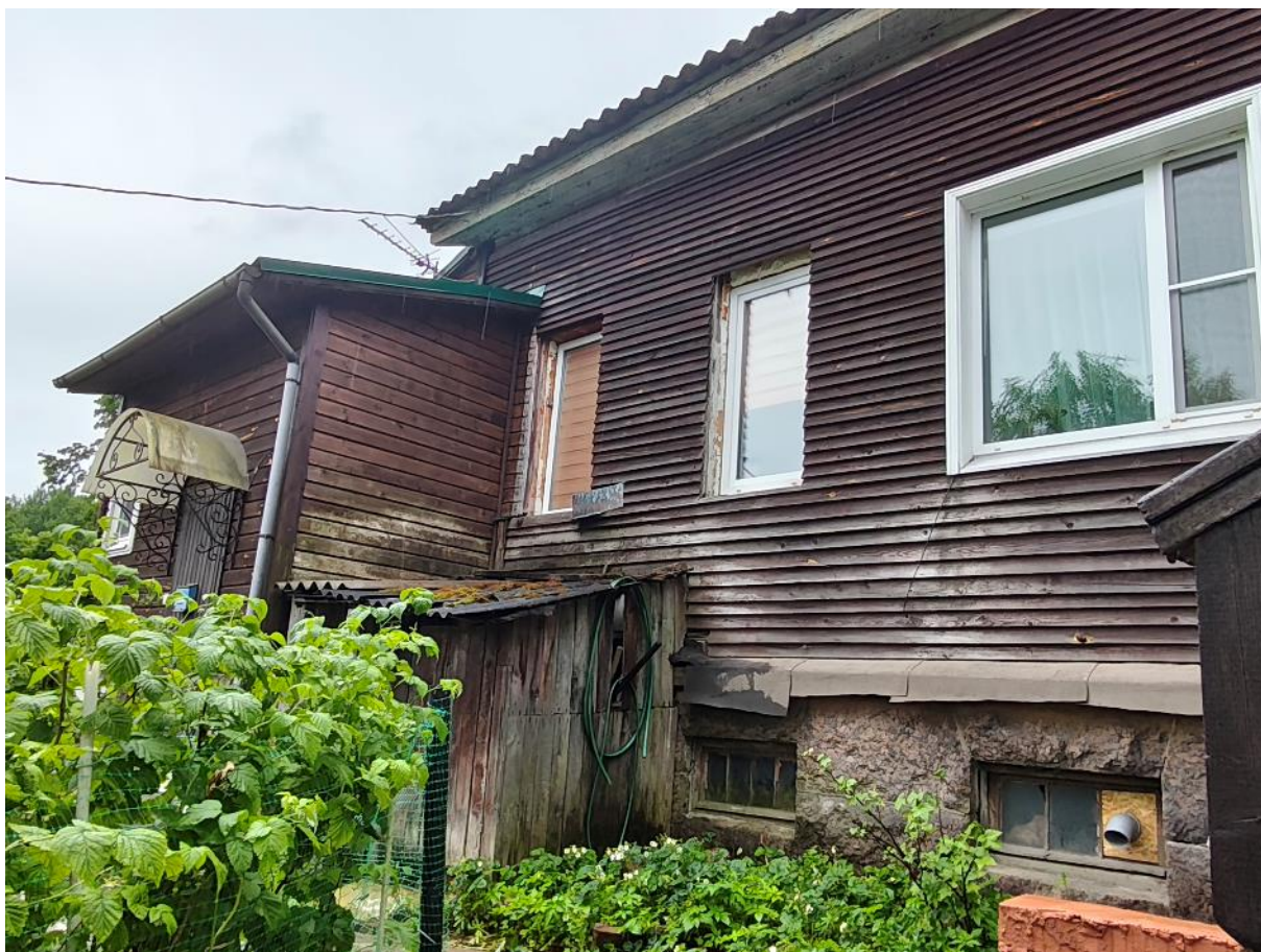
Фото 11. Южная часть восточного фасада.
