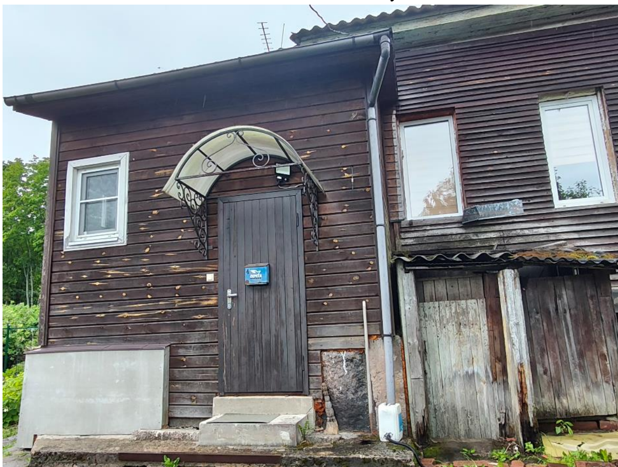
Фото 10. Фрагмент восточного фасада.
