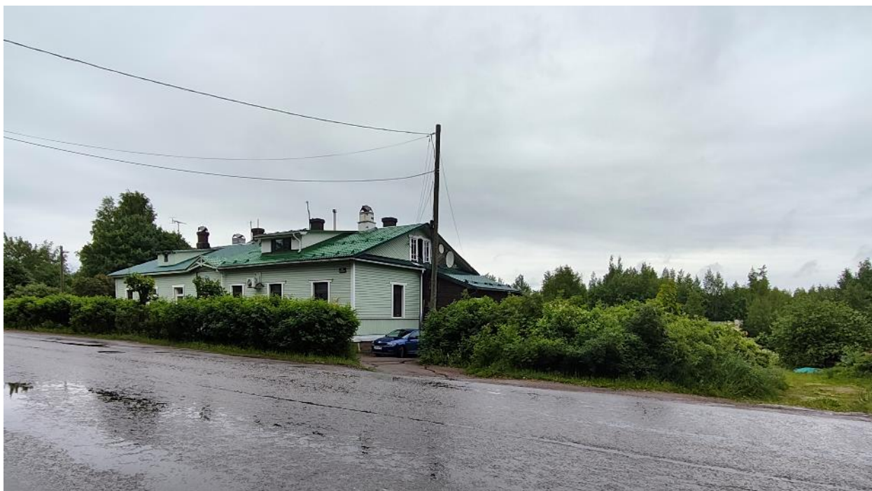
Фото 1. Общий вид с юго-запада.
