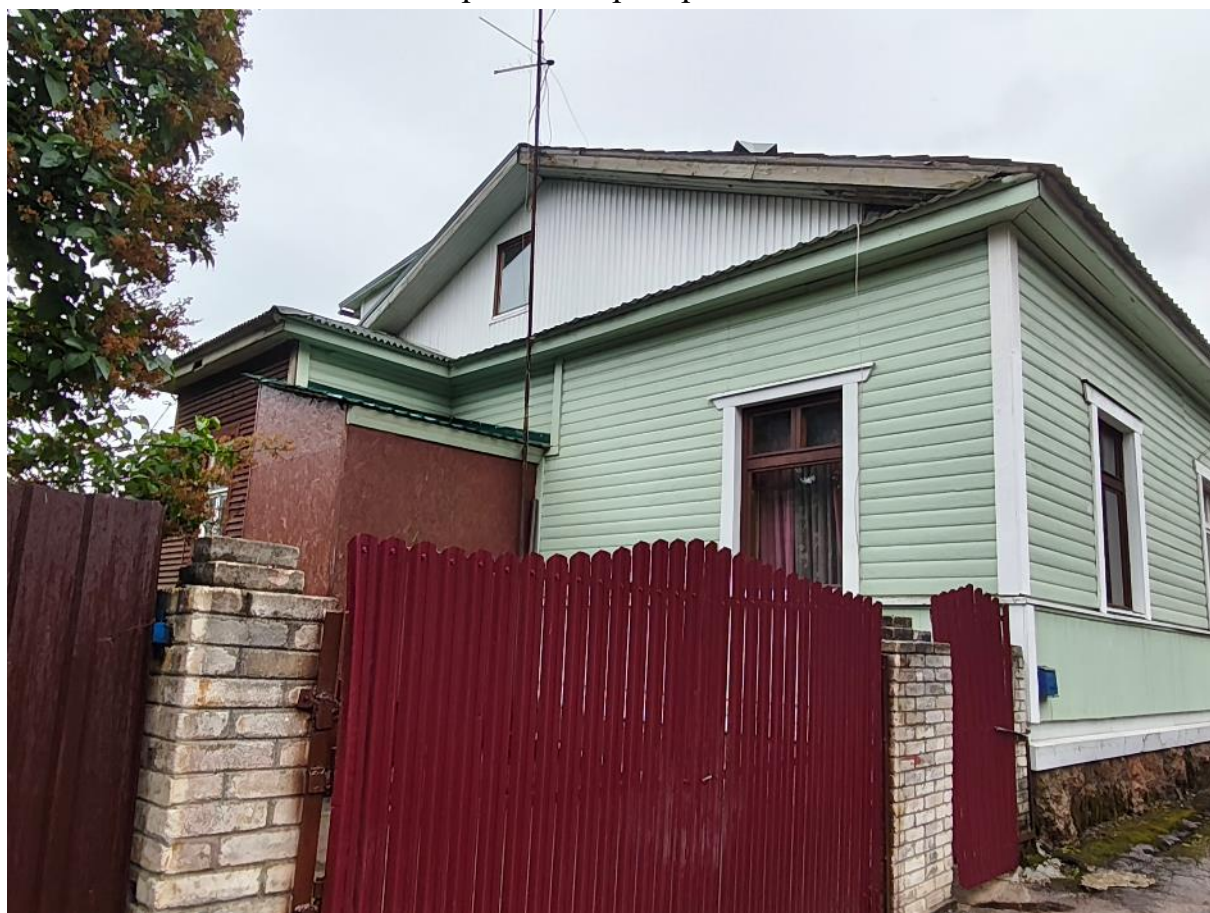
Фото 14. Северный фасад и пристройки.
