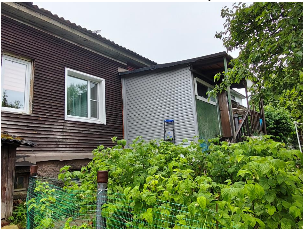
Фото 12. Вид вдоль восточного фасада.
