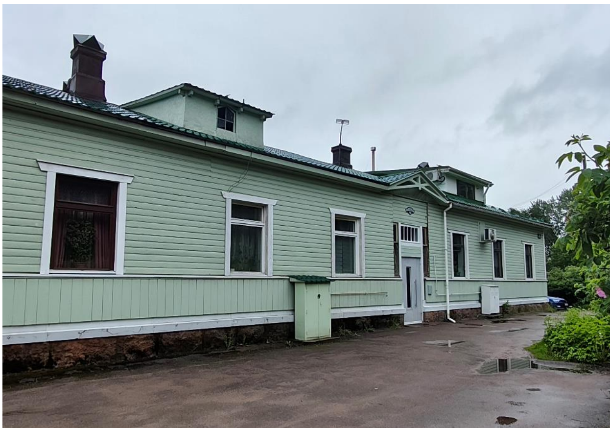
Фото 5. Вид лицевого фасада.
