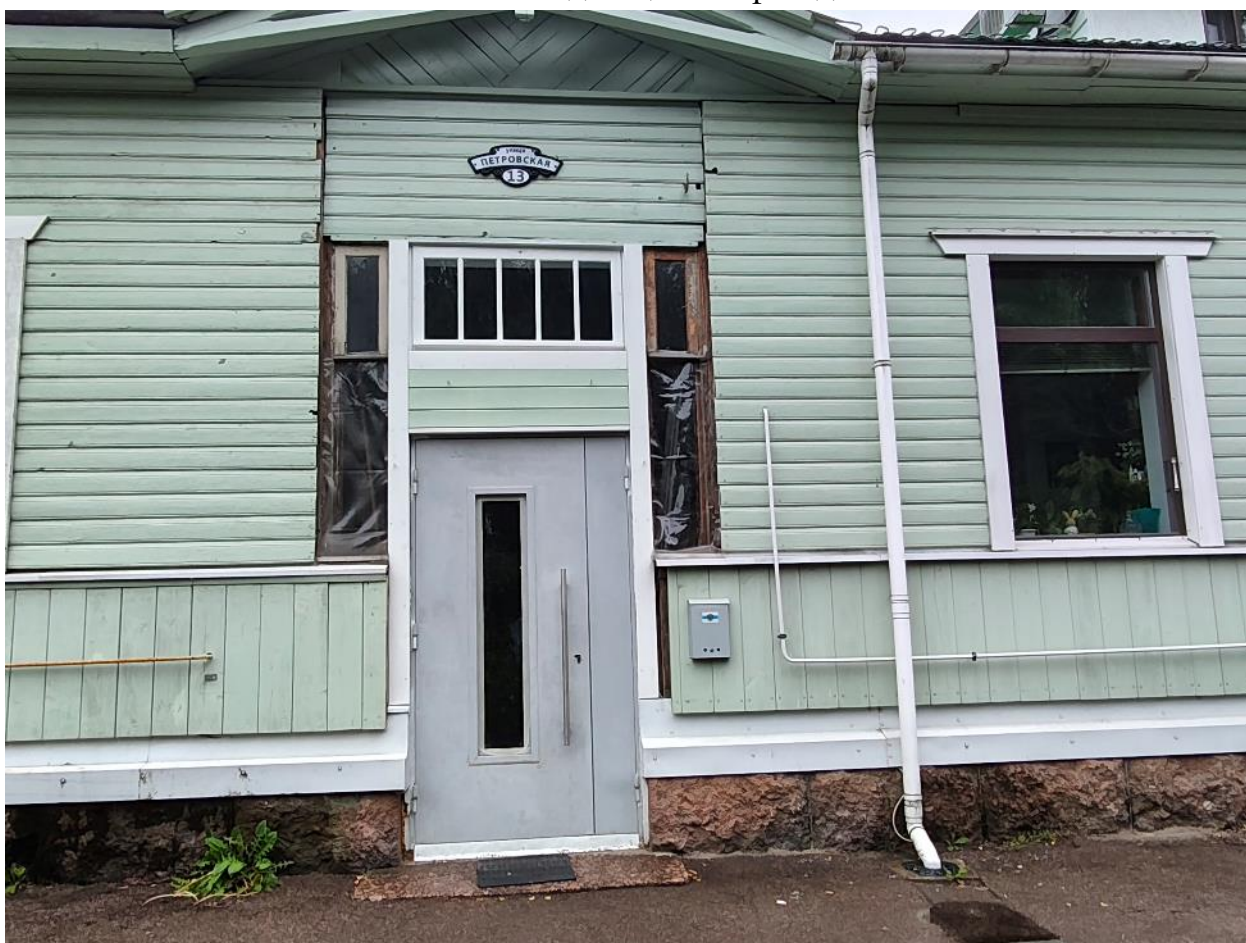
Фото 6. Вид лицевого входа.
