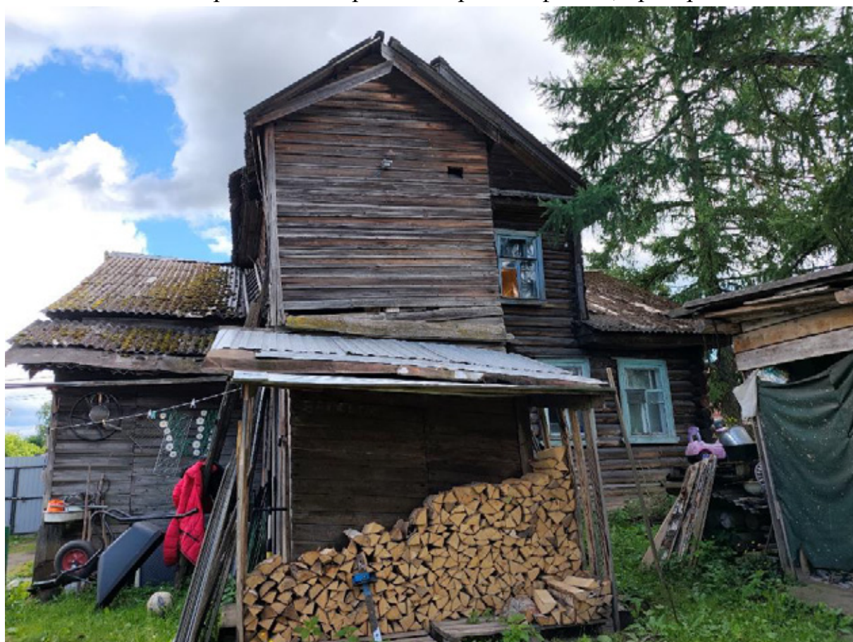
Фото 8. Западный фасад, пристройки.
