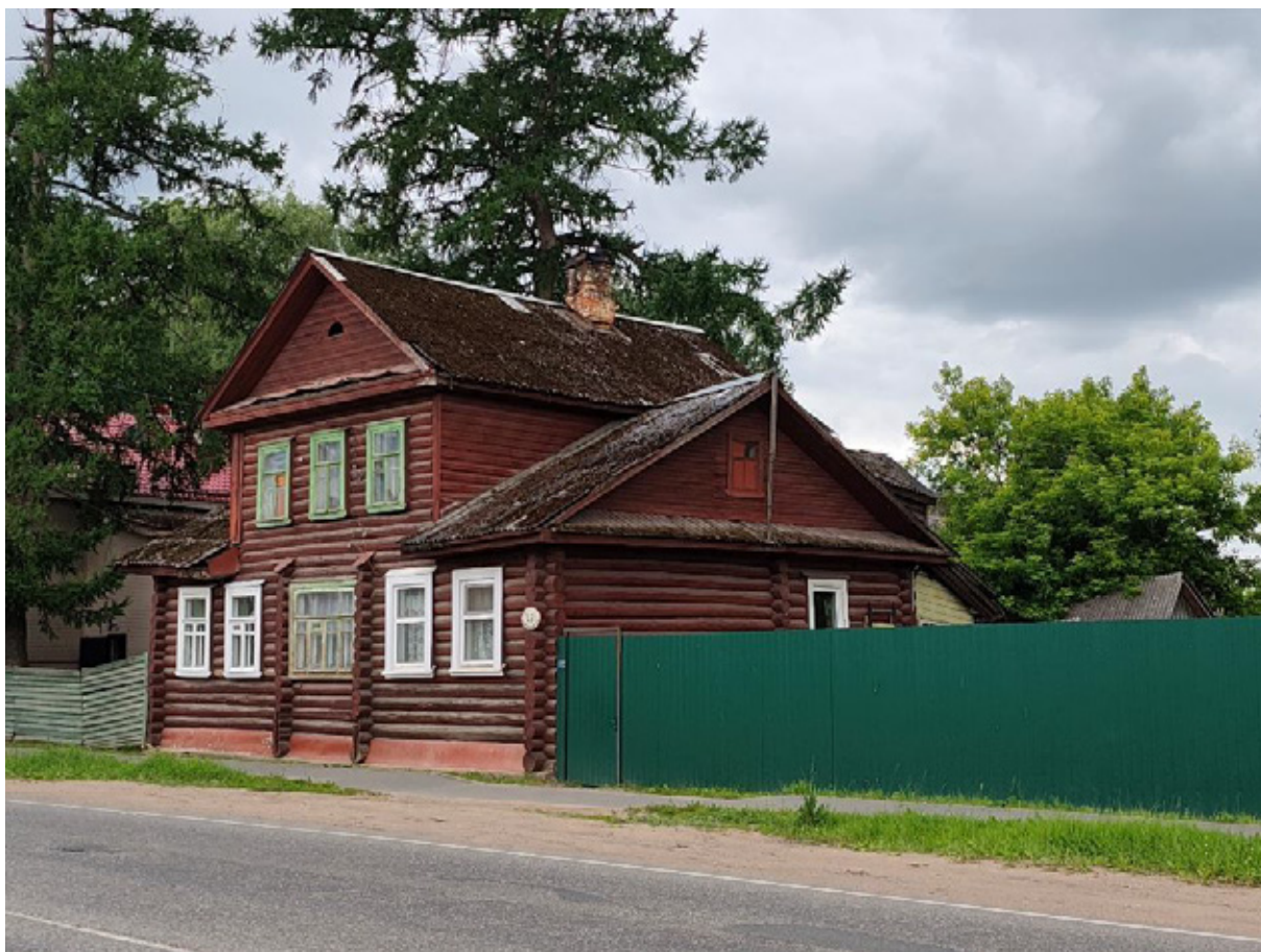
Фото 3. Общий вид объекта с северо-востока.
