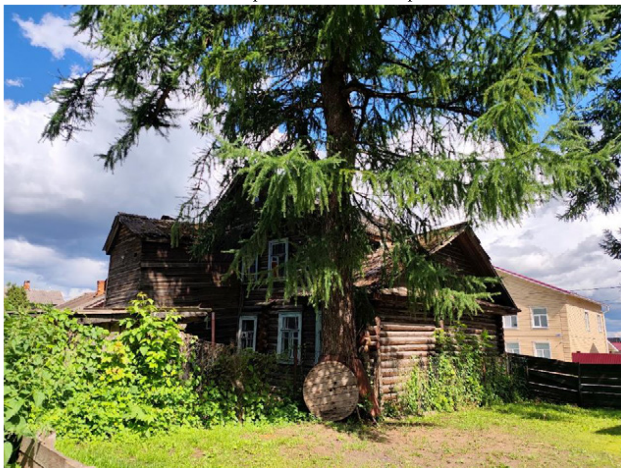
Фото 12. Общий вид с запада.
