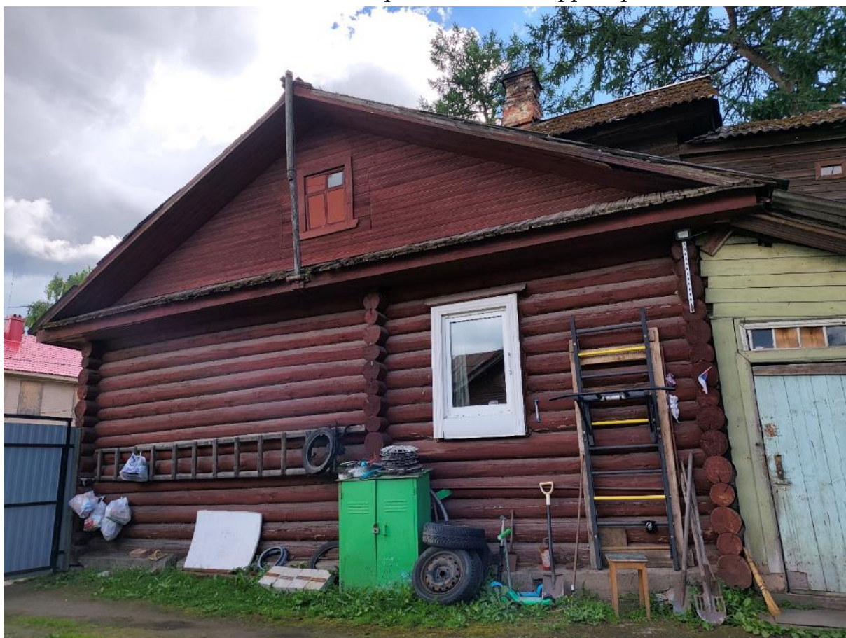
Фото 6. Северный дворовой фасад.
