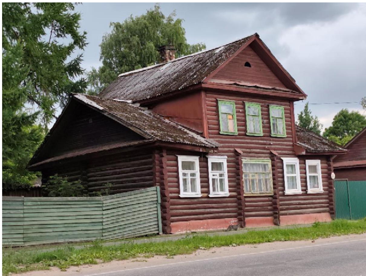
Фото 1. Общий вид объекта с юга.
