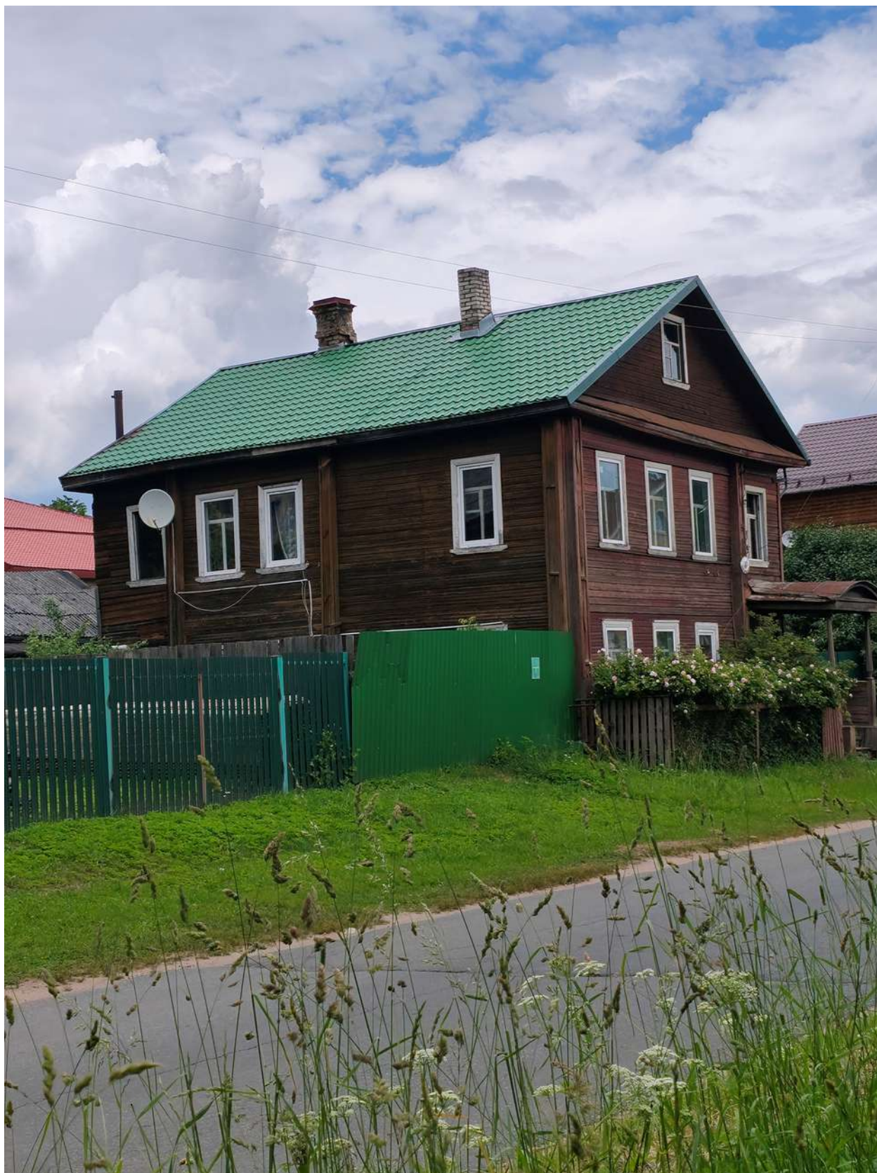
1. Юго-восточный и северо-восточный фасады.
