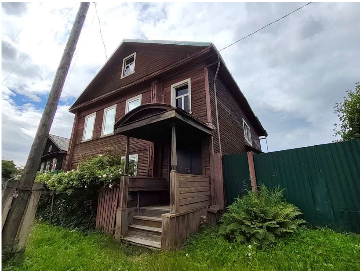
4. Северо-восточный и северо-западный. фасады
