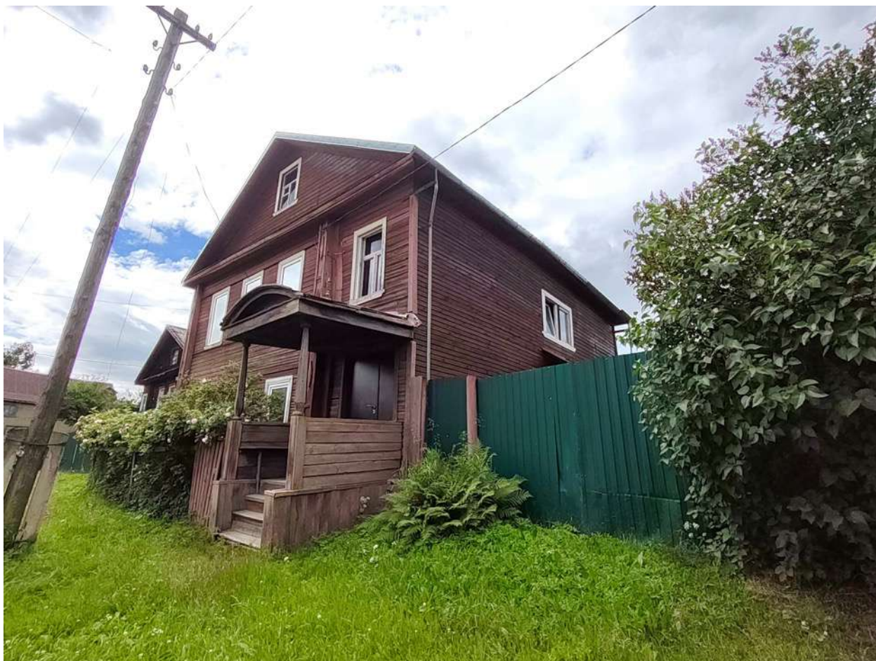
3. Северо-восточный и северо-западный фасады.
