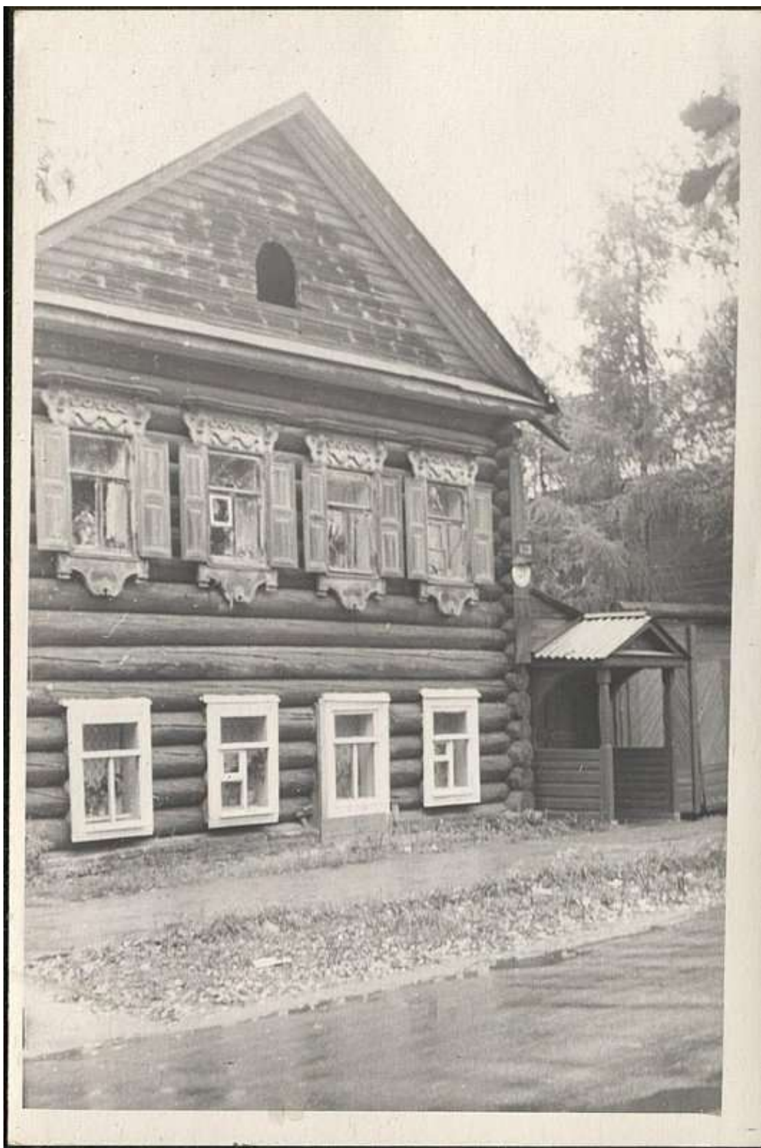
20. Тихвин. Дом в старом городе (Ул. Новгородская, д. 29). 1973 г.
