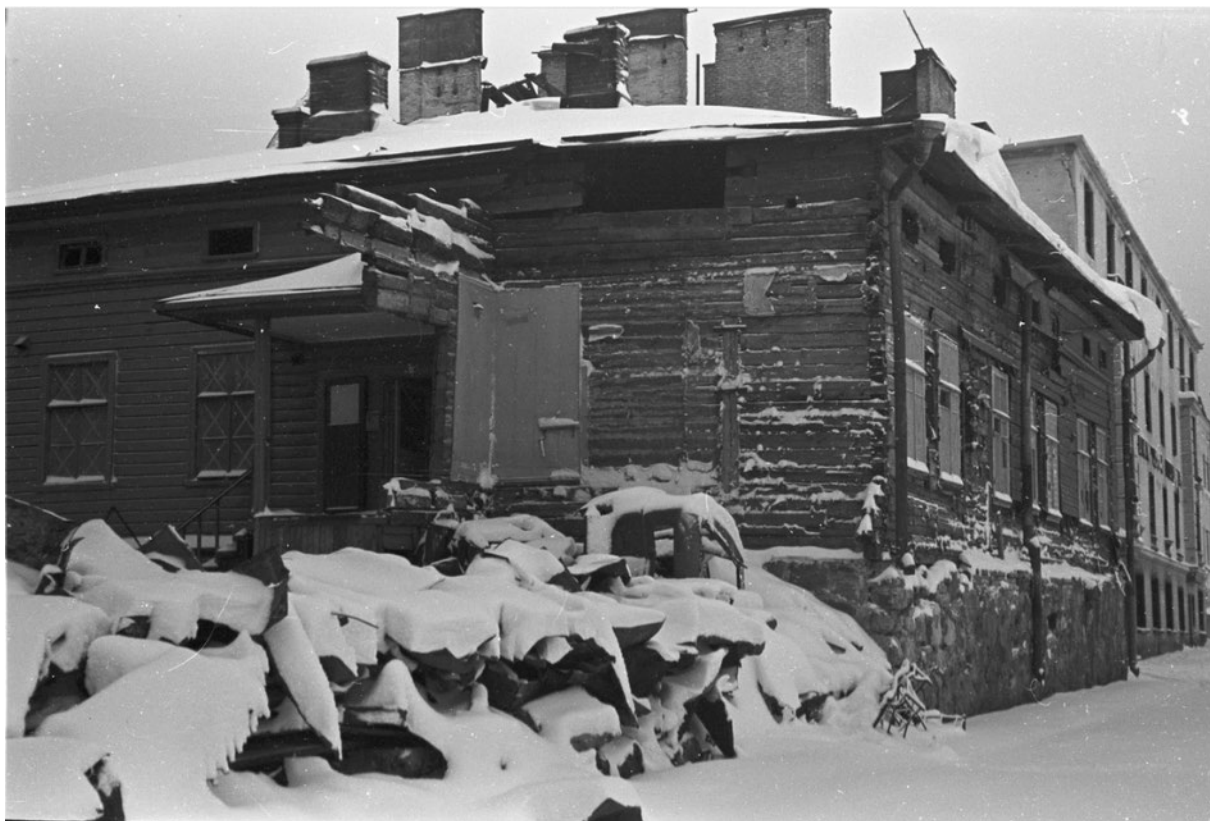
Илл. 61. Поврежденный жилой дом на пересечении улиц Этелявалли и Памппаланкату. 1941-1942 гг. Коллекция Юхи Ланкинена. [Электронный портал] URL: https://finna.fi/Record/lappeenrannanmuseot.1F5BA669-BD34-47CB-B8AC-B1E51E9AC4CA?sid=5455099720 .
