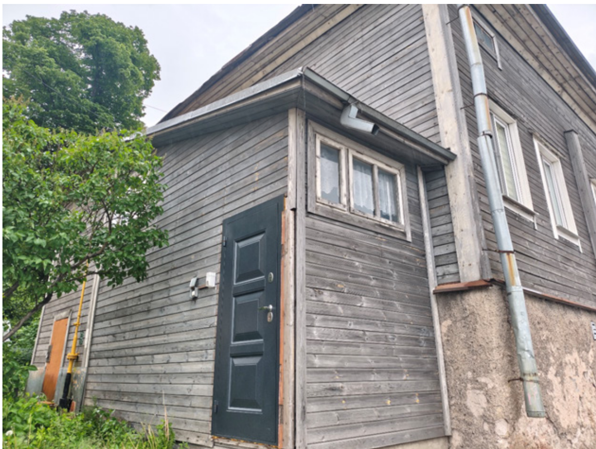
Фото 5. Крыльцо у юго-западного угла.
