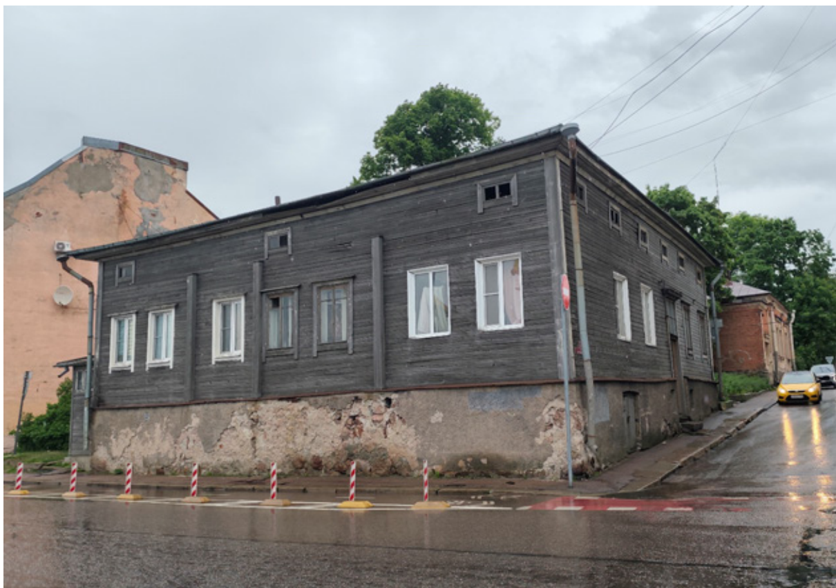
Фото 7. Общий вид с юго-востока.
