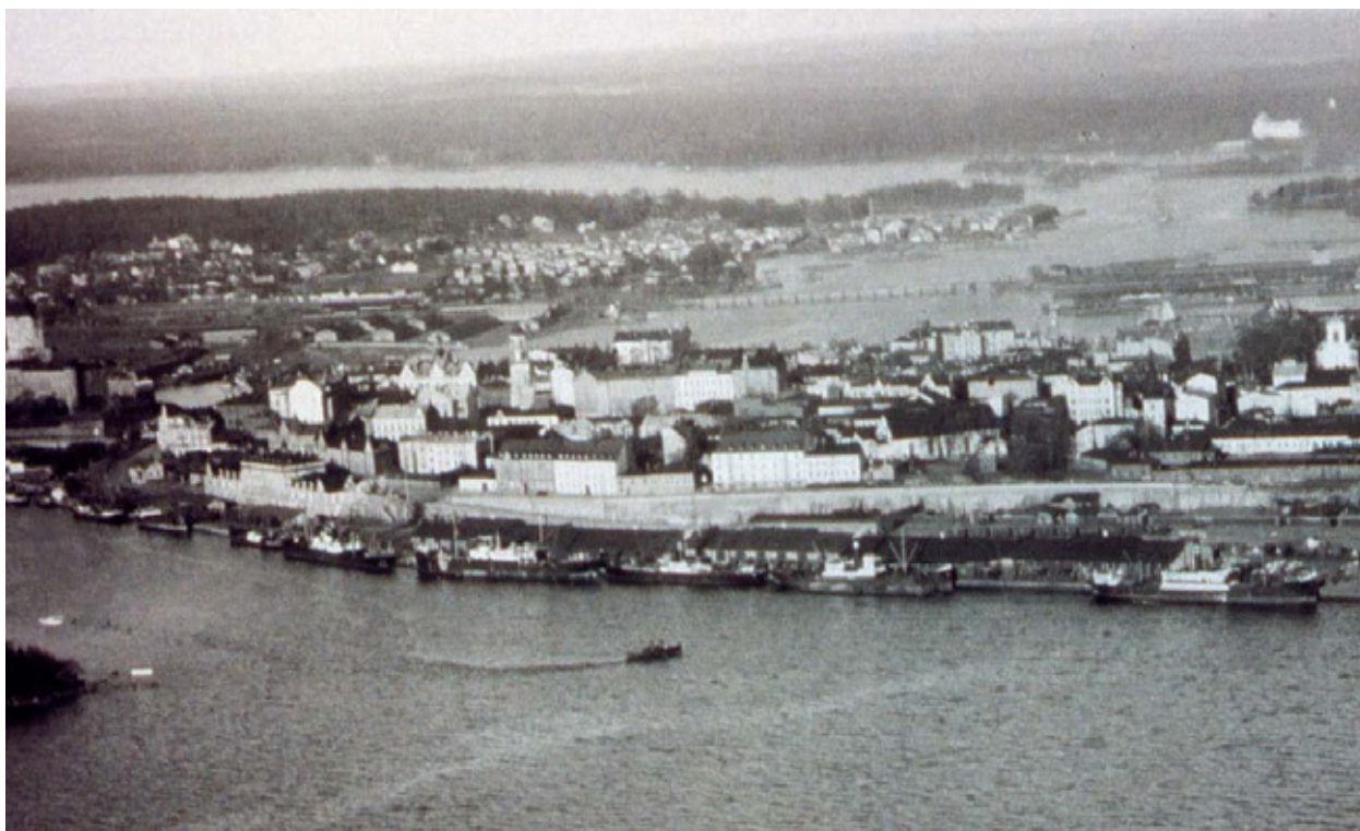
Илл. 48. Вид с воздуха на Южную гавань. 14.10.1930-е гг. [Электронный портал] URL: https://wiipuri.fi/kuvat/etelasatama/ .
