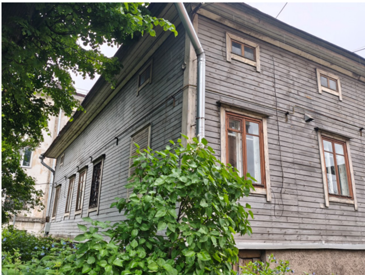
Фото 3. Вид с северо-запада.
