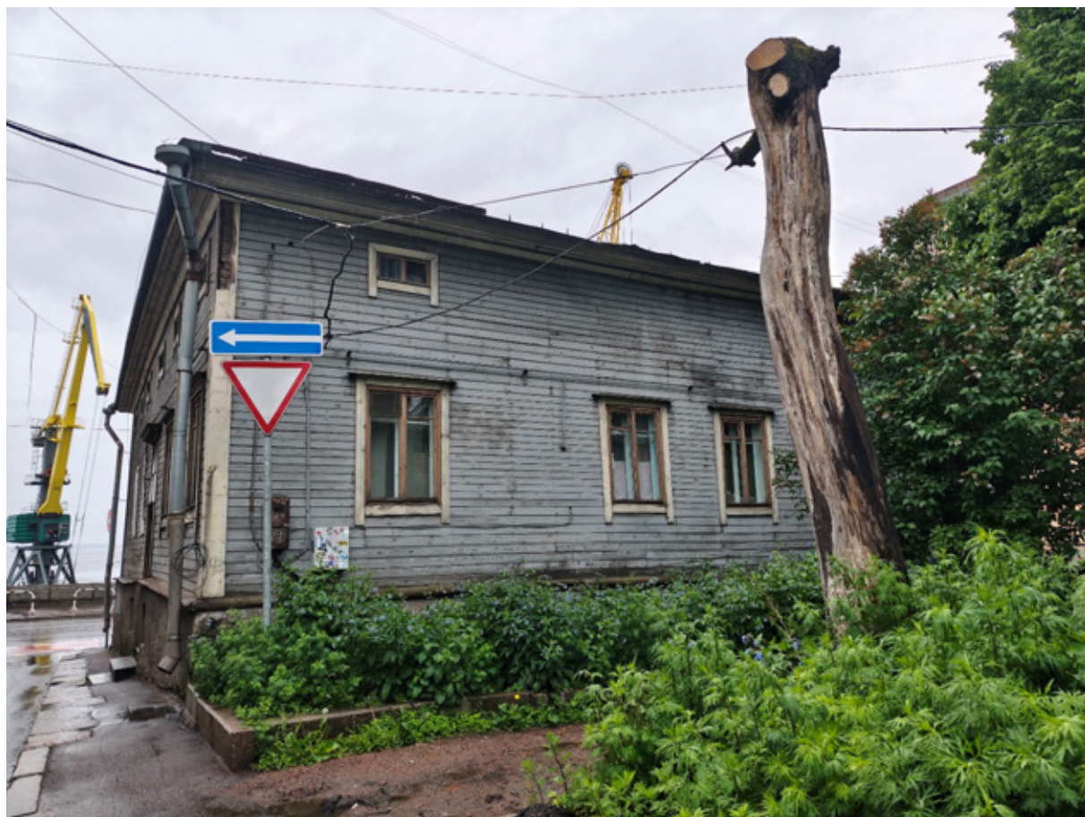
Фото 1. Вид объекта с северо-востока.
