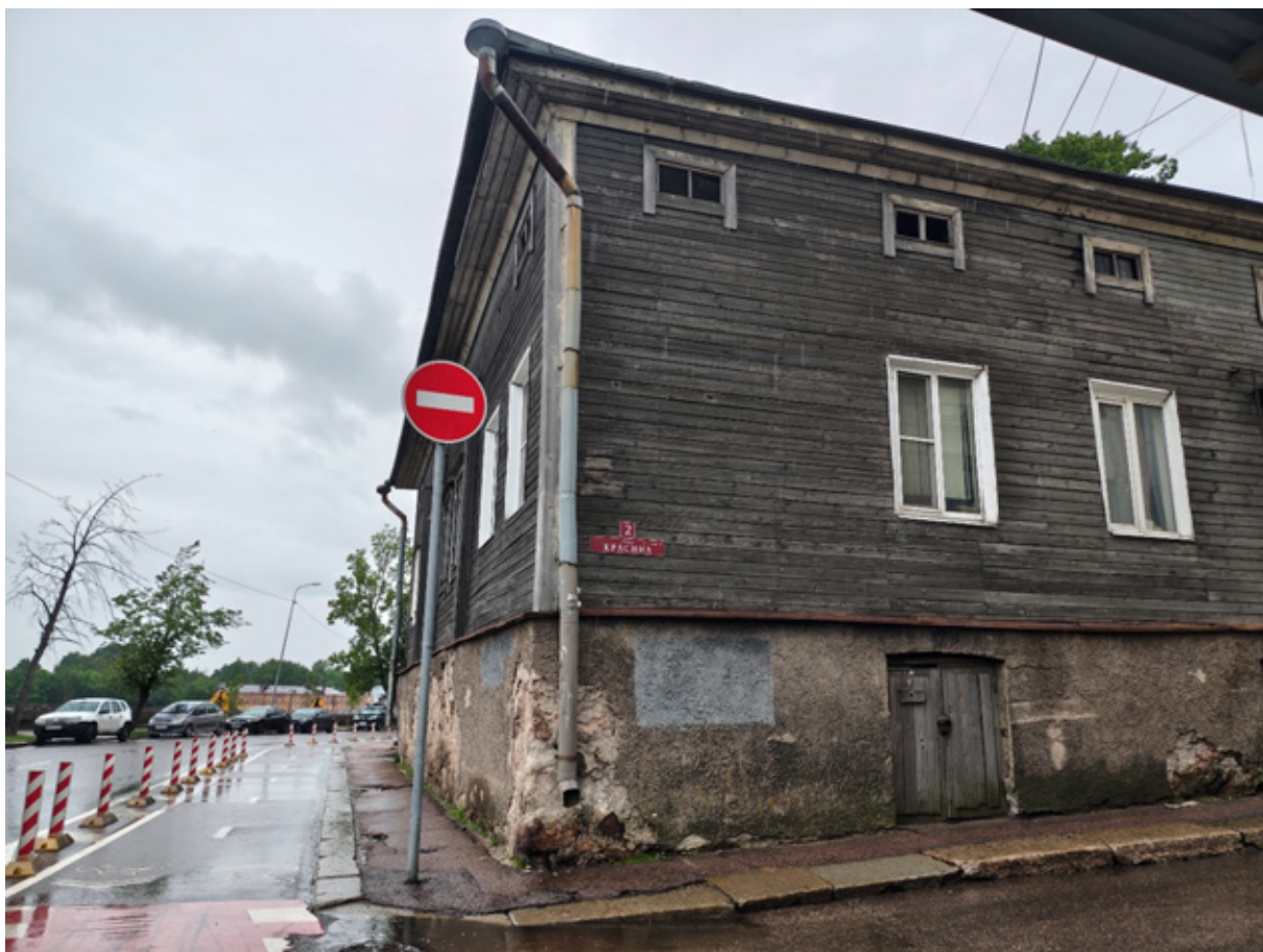
Фото 9. Вид вдоль лицевого фасада с юго-востока.
