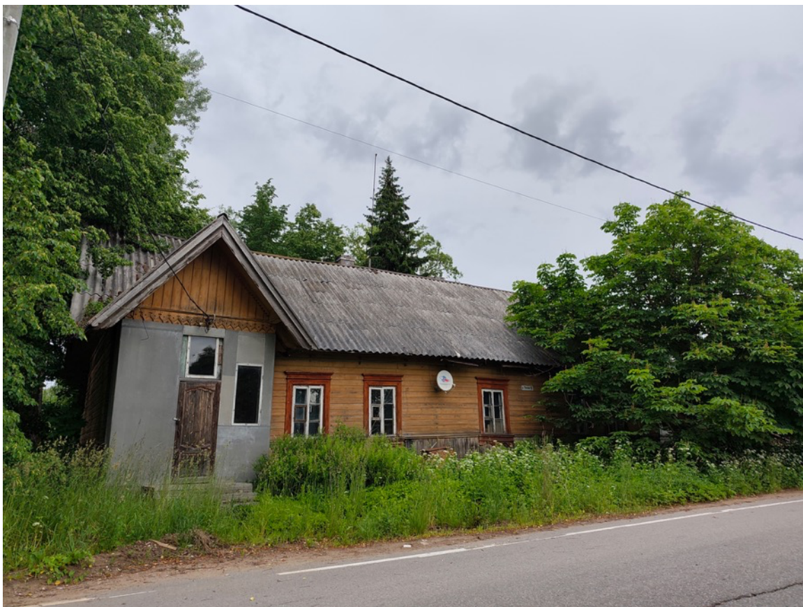
5. Фасад по улице Ленина
