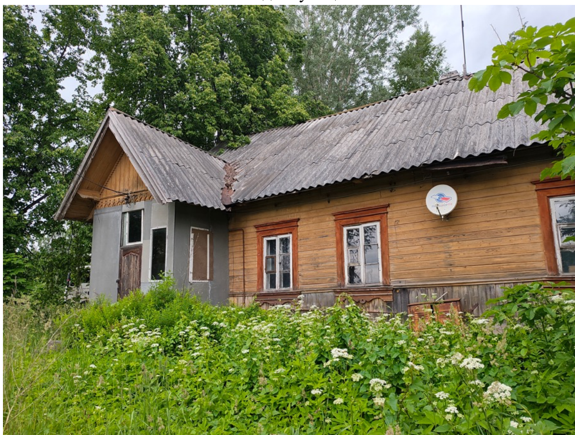
4. Фасад по улице Ленина
