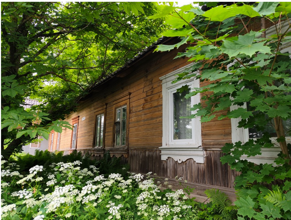
3. Фасад по улице Ленина
