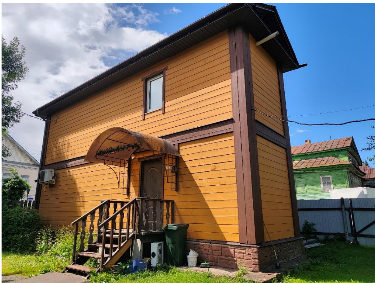
Фото 6. Восточный фасад, вид с северо-востока.
