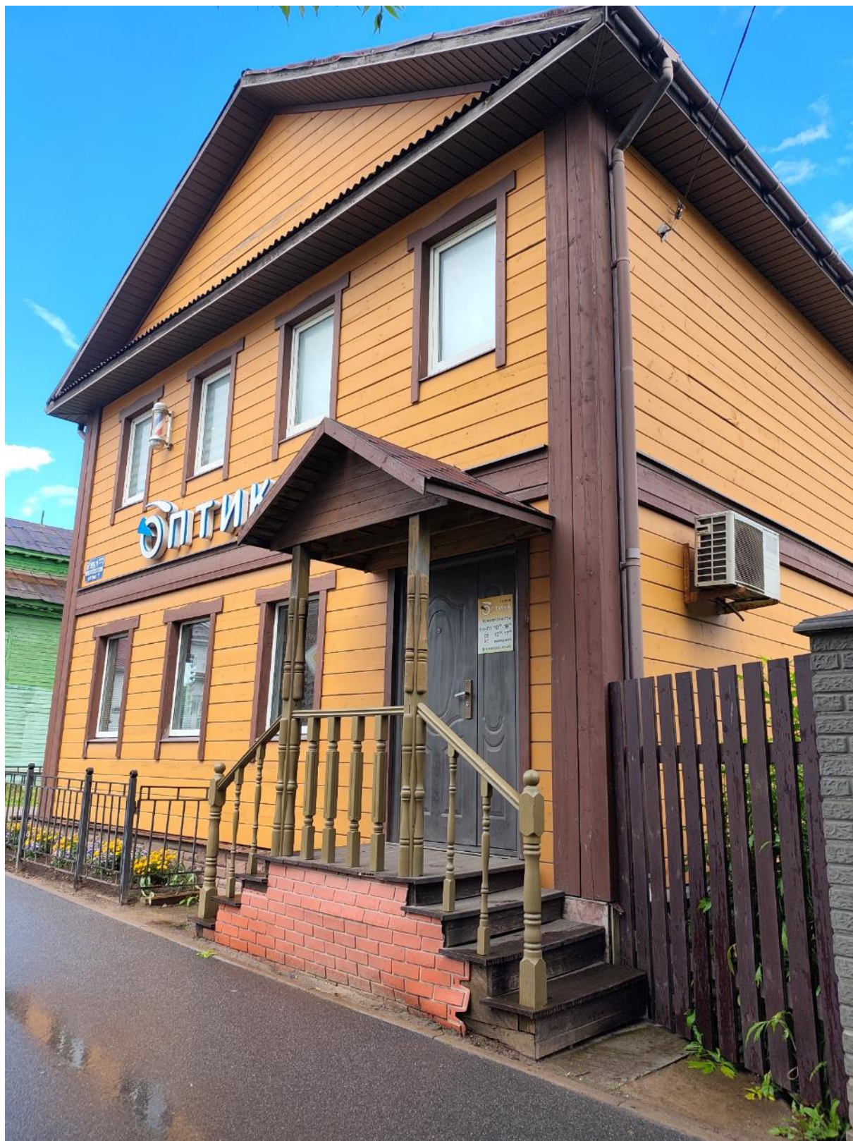
Фото 9. Южный лицевой фасад, вид с юго-востока.
