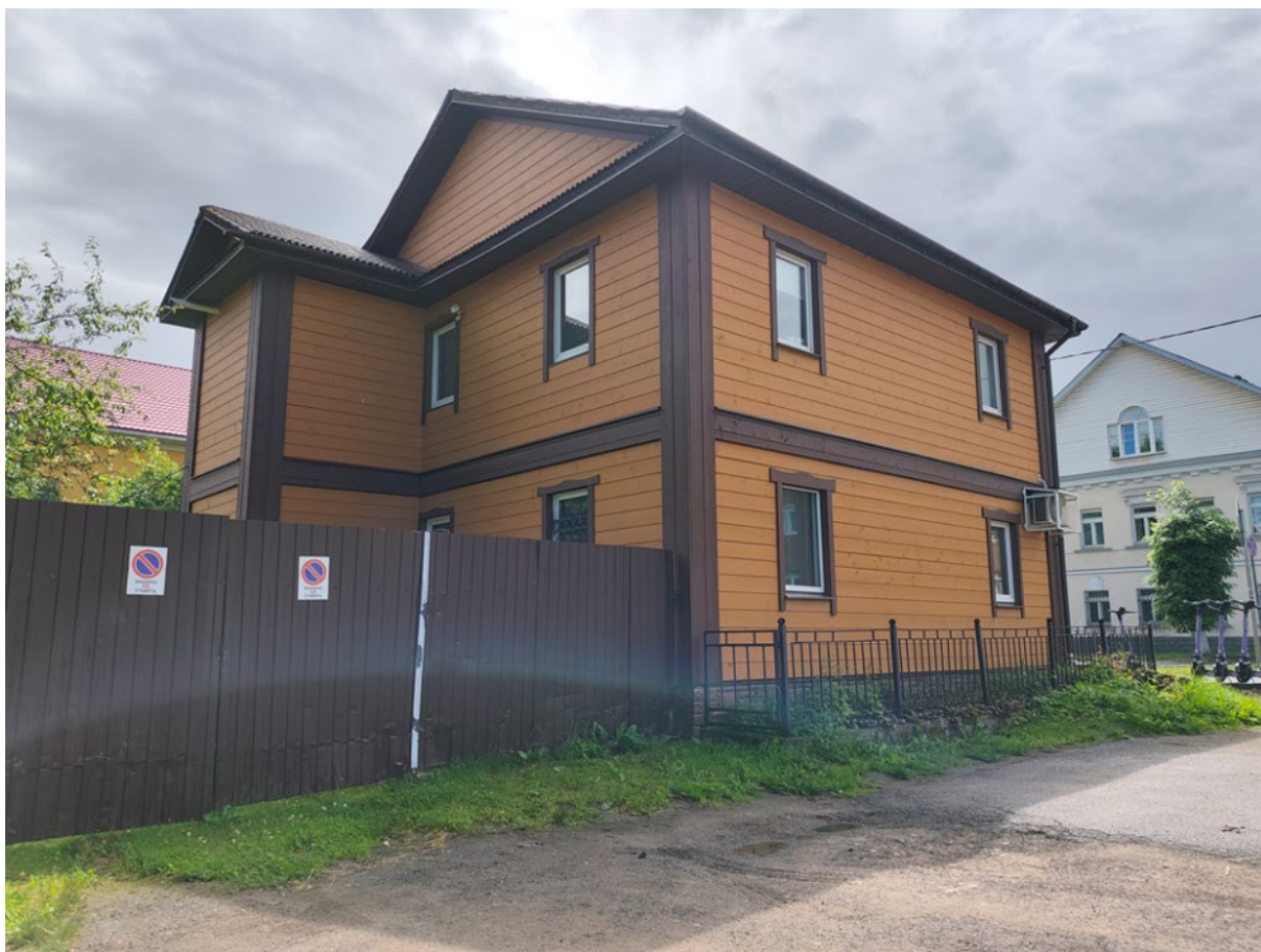
Фото 3. Общий вид объекта с севера.
