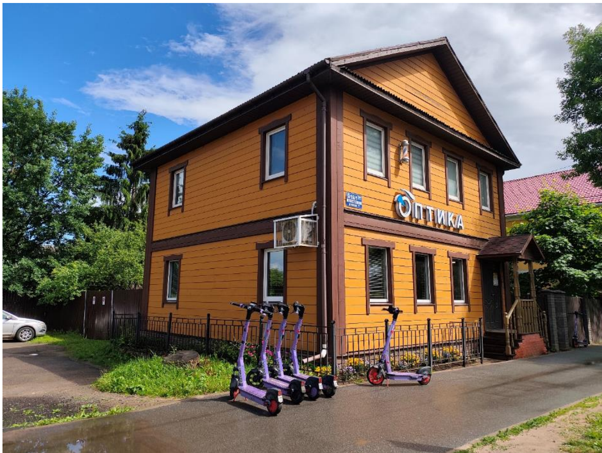
Фото 1. Общий вид объекта с запада.
