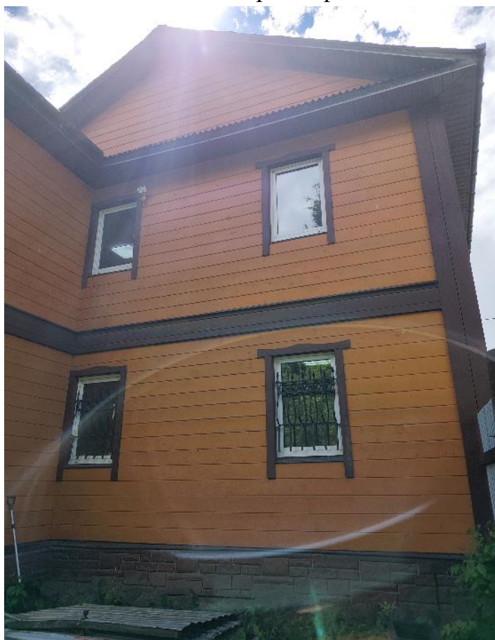
Фото 8. Фрагмент северного фасада.
